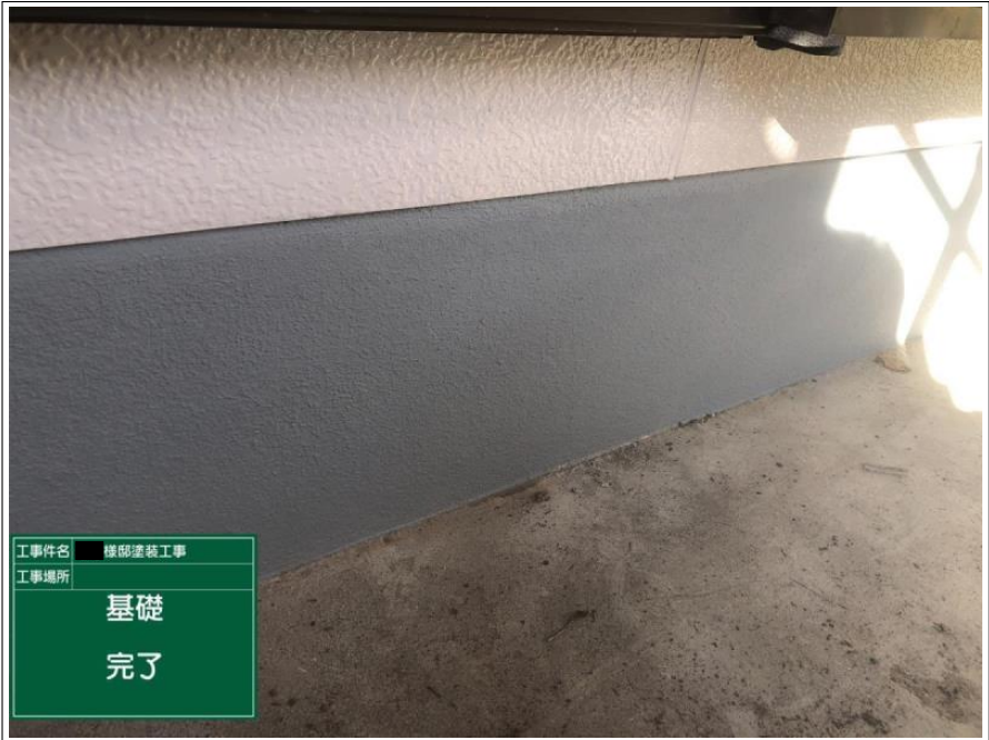
工事件名 様邸塗装工事 工事場所 基礎 上塗り2回目
