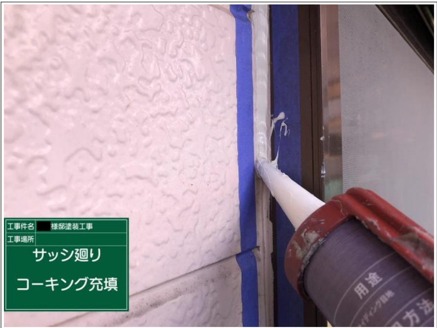
工事件名 様邸塗装工事 工事場所 サッシ廻り コーキング充填
