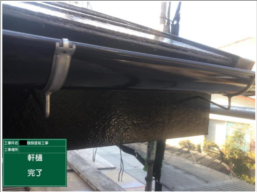
工事件名 様邸塗装工事 工事場所 軒樋 上塗り2回目
