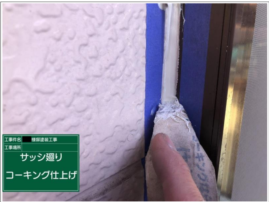
工事件名 様邸塗装工事 工事場所 入隅 コーキング充填
