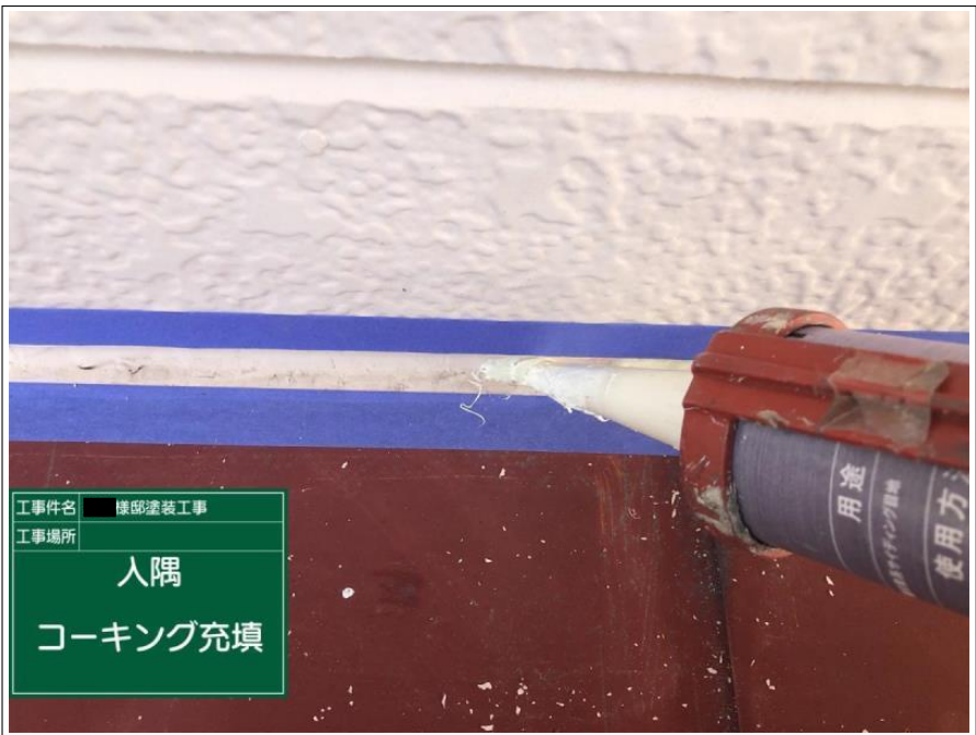
工事件名 様邸塗装工事 工事場所 入隅 コーキング充填
