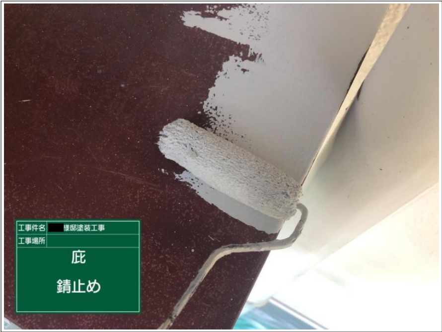
工事件名 機殻塗装工事 工事場所 庇 錆止め
