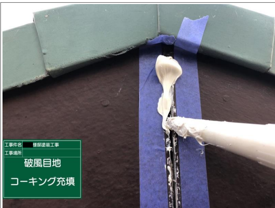
工事件名 棟部塗装工事 工事場所 破風目地 コーキング充填
