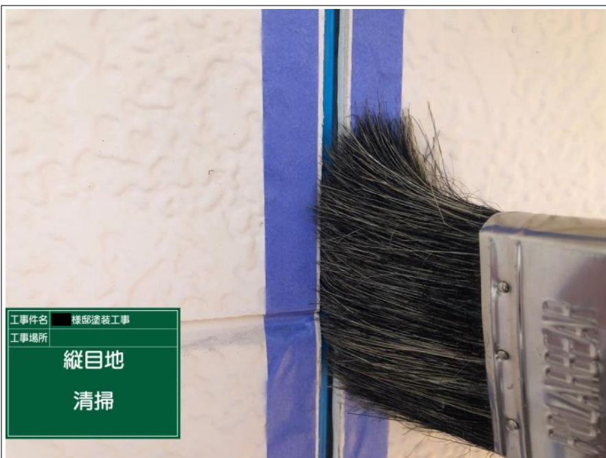
工事件名 様邸塗装工事 工事場所 縦目地 清掃
