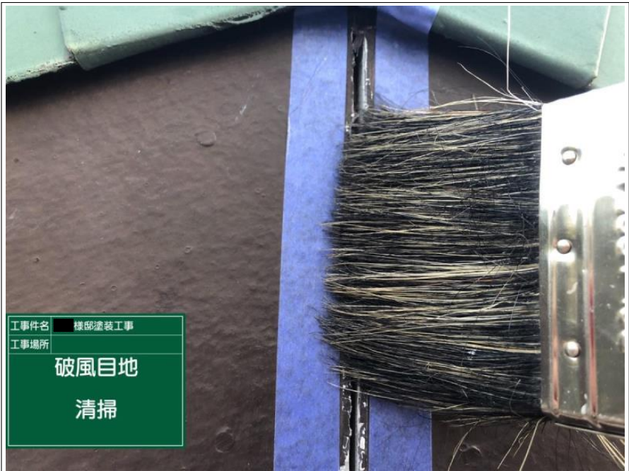
工事件名 棟部塗装工事 工事場所 破風目地 清掃
