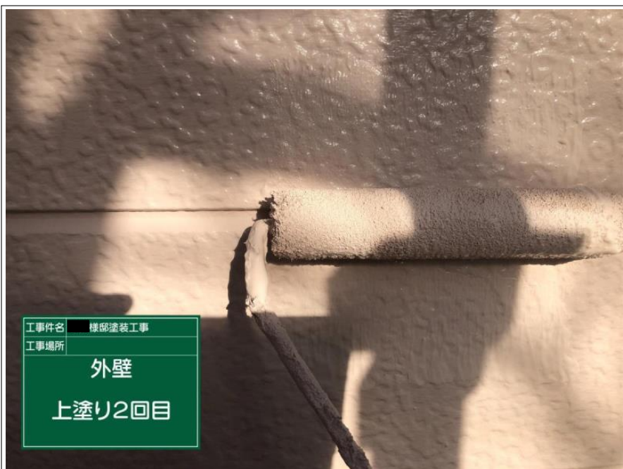
工事件名 様邸塗装工事 工事場所 外壁 上塗り2回目
