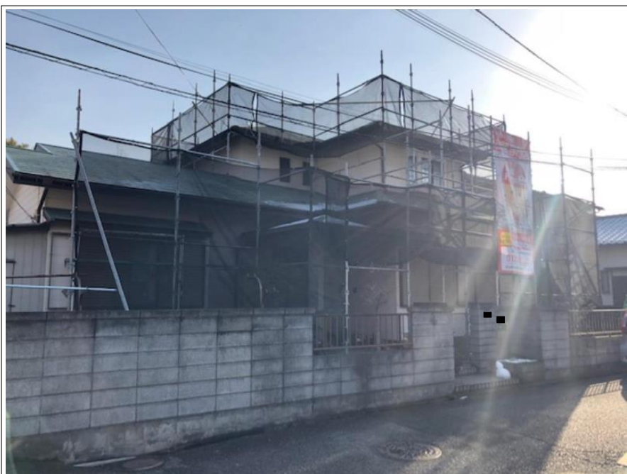
足場組立 完了
