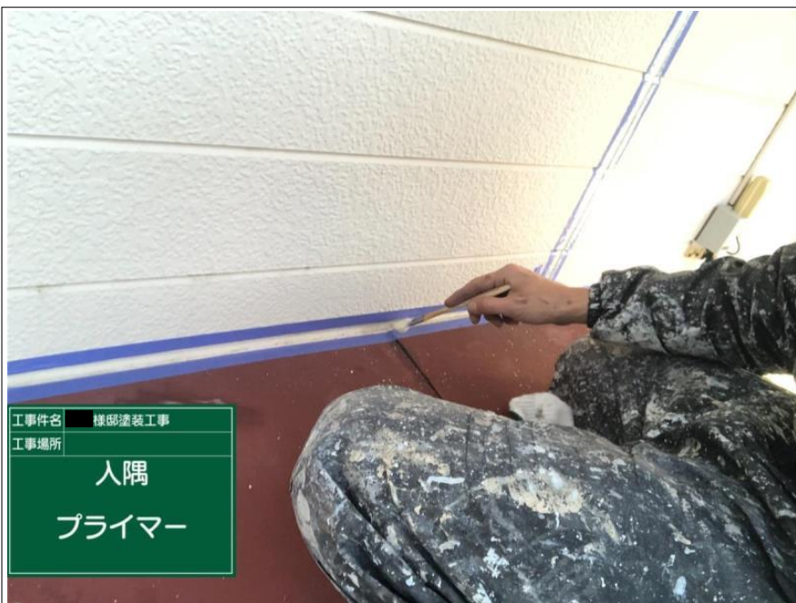
工事件名 様邸塗装工事 工事場所 サッシ廻り プライマー
