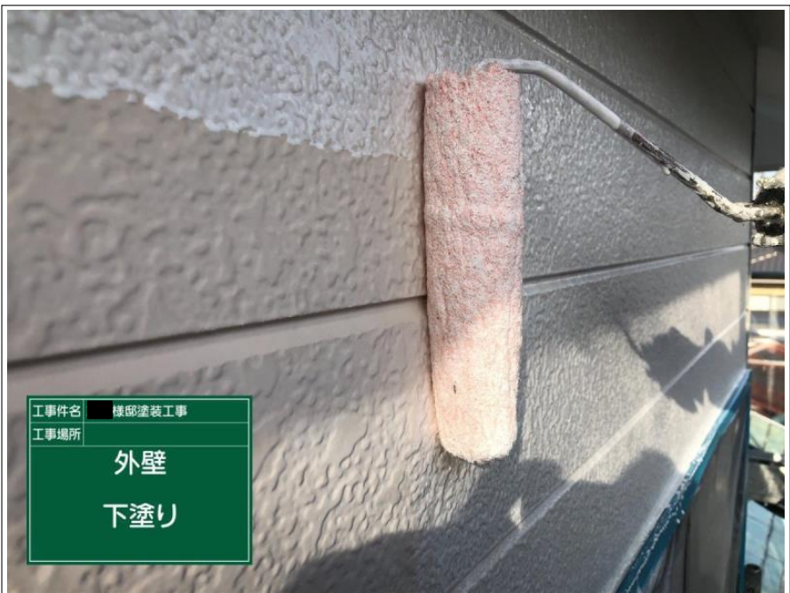
工事件名 棟梁塗装工事 工事場所 外壁 下塗り
