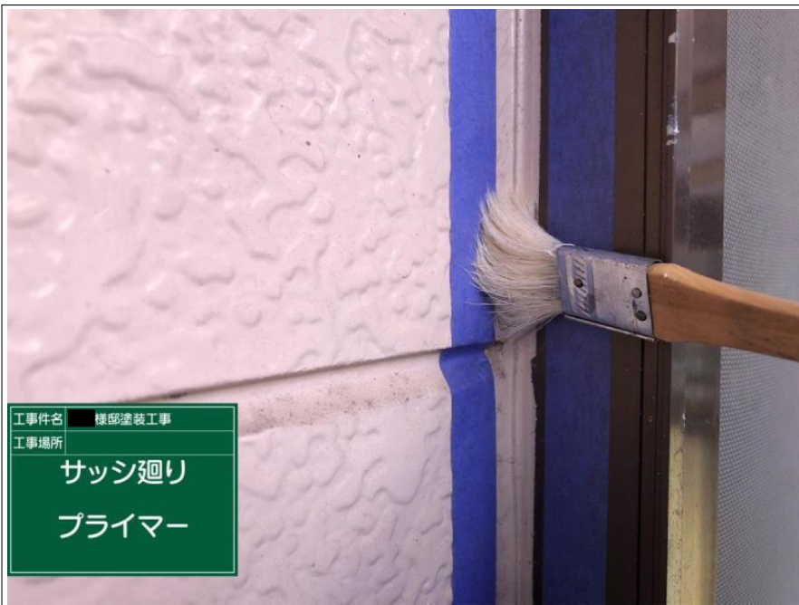
工事件名 様邸塗装工事 工事場所 サッシ廻り プライマー
