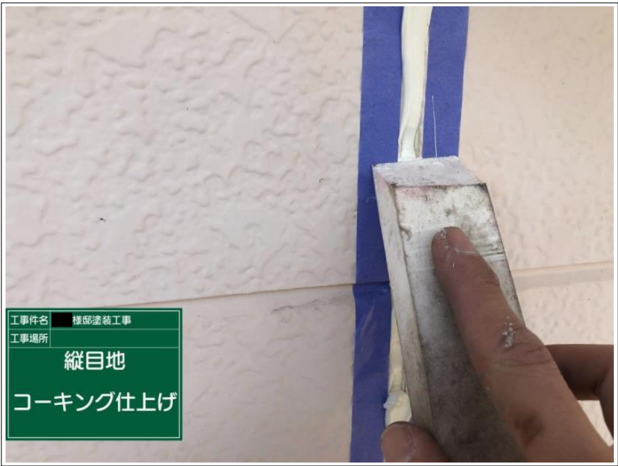
工事件名 棟部塗装工事 工事場所 縦目地 コーキング仕上げ
