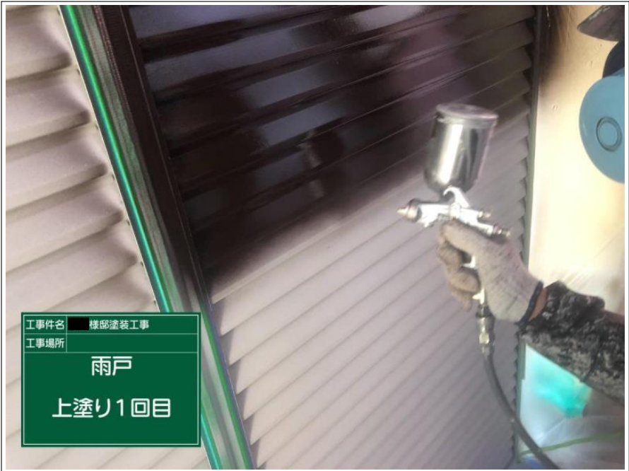
工事件名 ■ 機殻塗装工事 工事場所 雨戸 上塗り1回目
