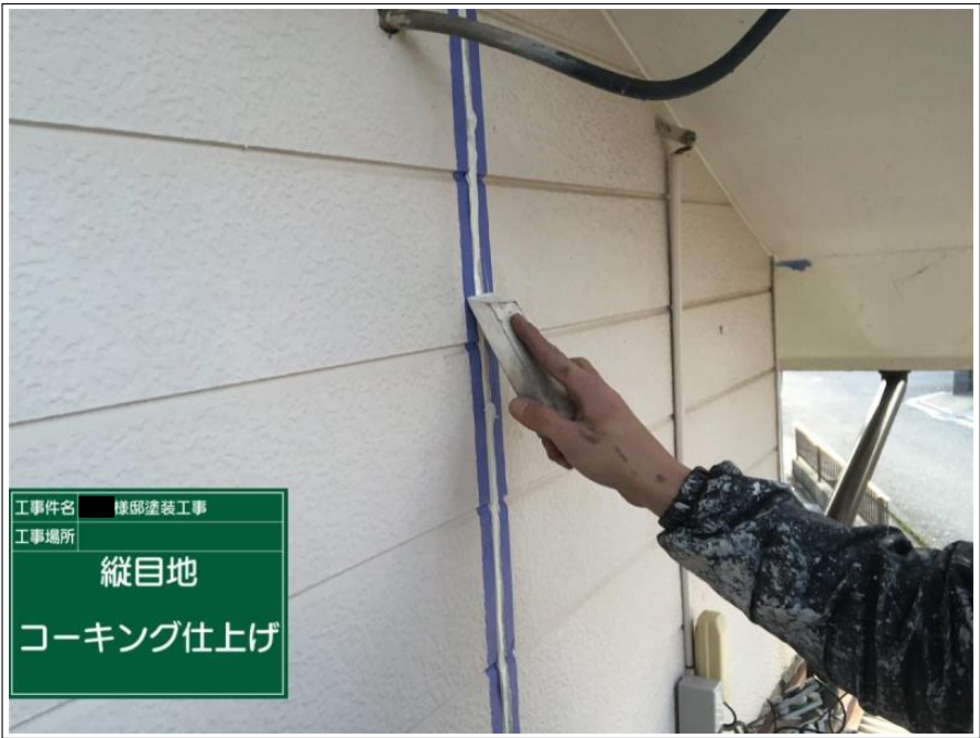
工事件名 棟部塗装工事 工事場所 縦目地 コーキング充填
