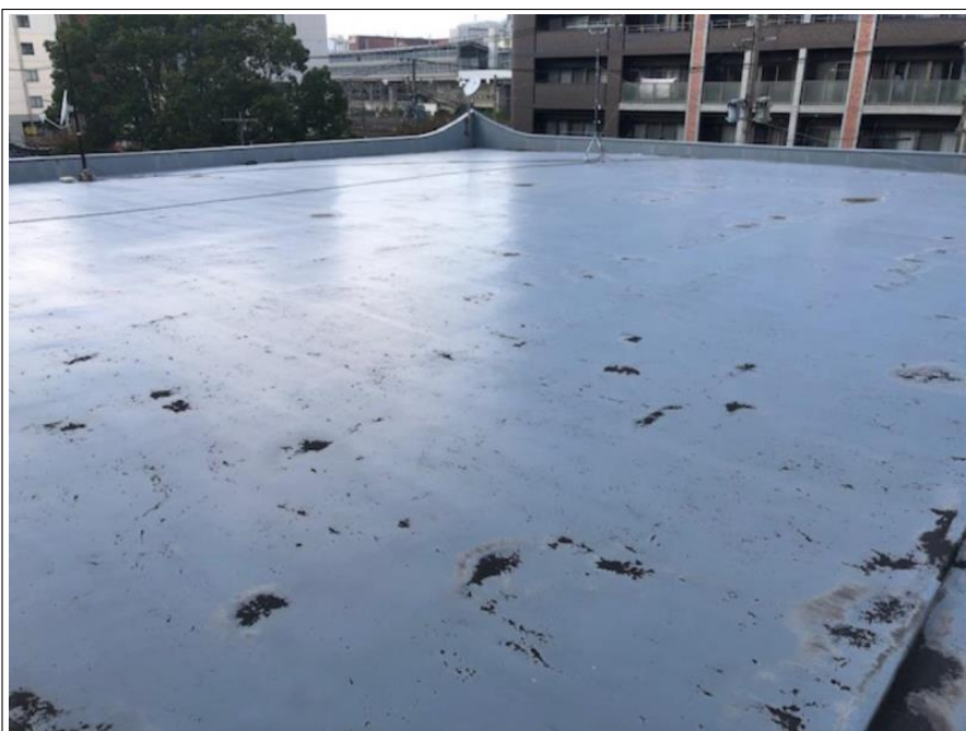
本堂 塗膜防水部
