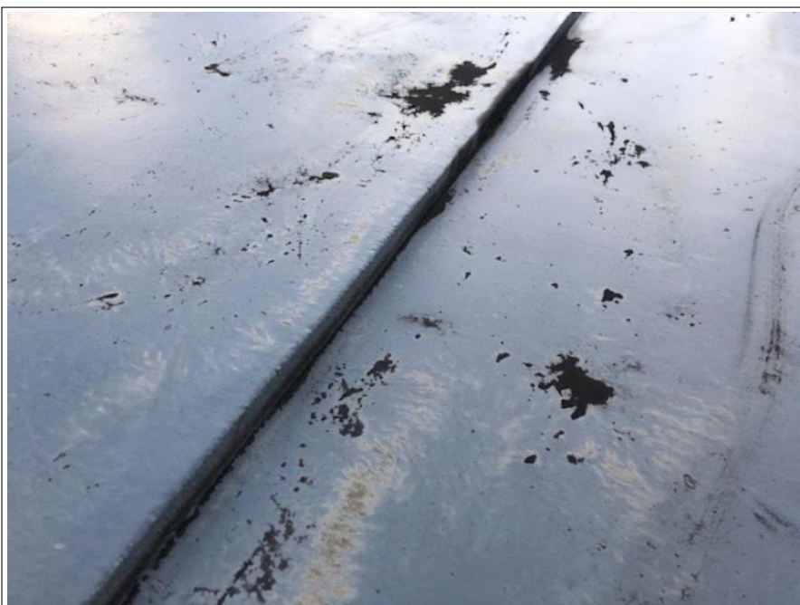
本堂 塗膜防水部
