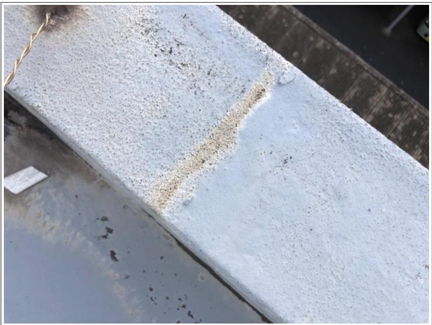
本堂 塗膜防水部
