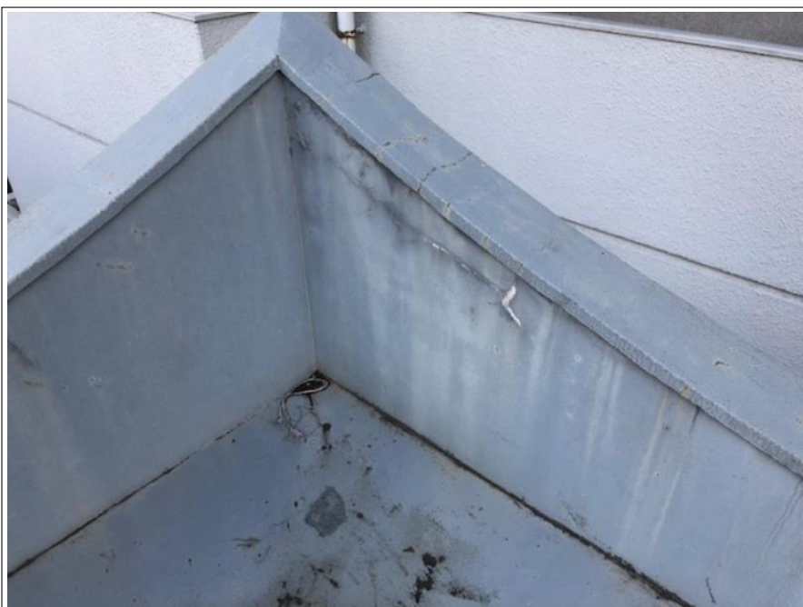
本堂 塗膜防水部
