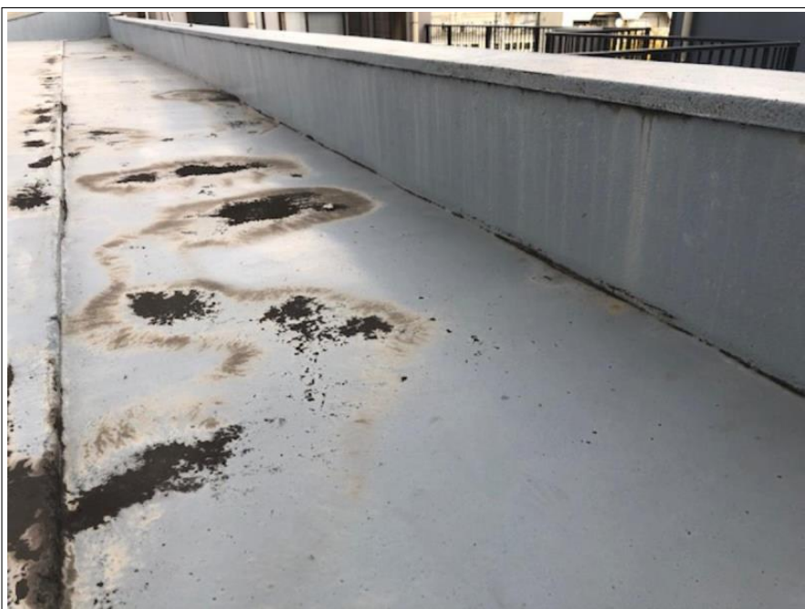
本堂 塗膜防水部
