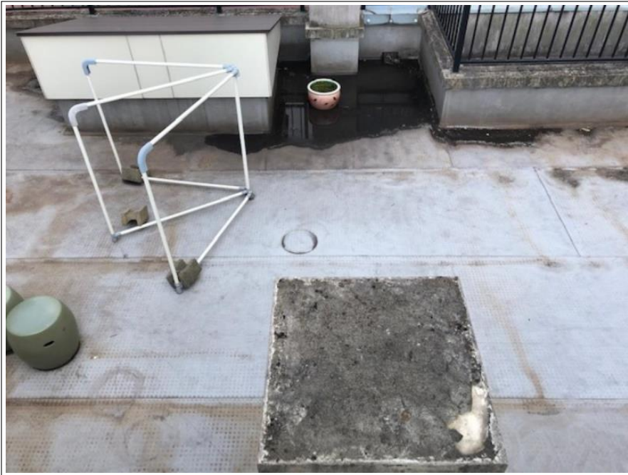
2F シート防水部
