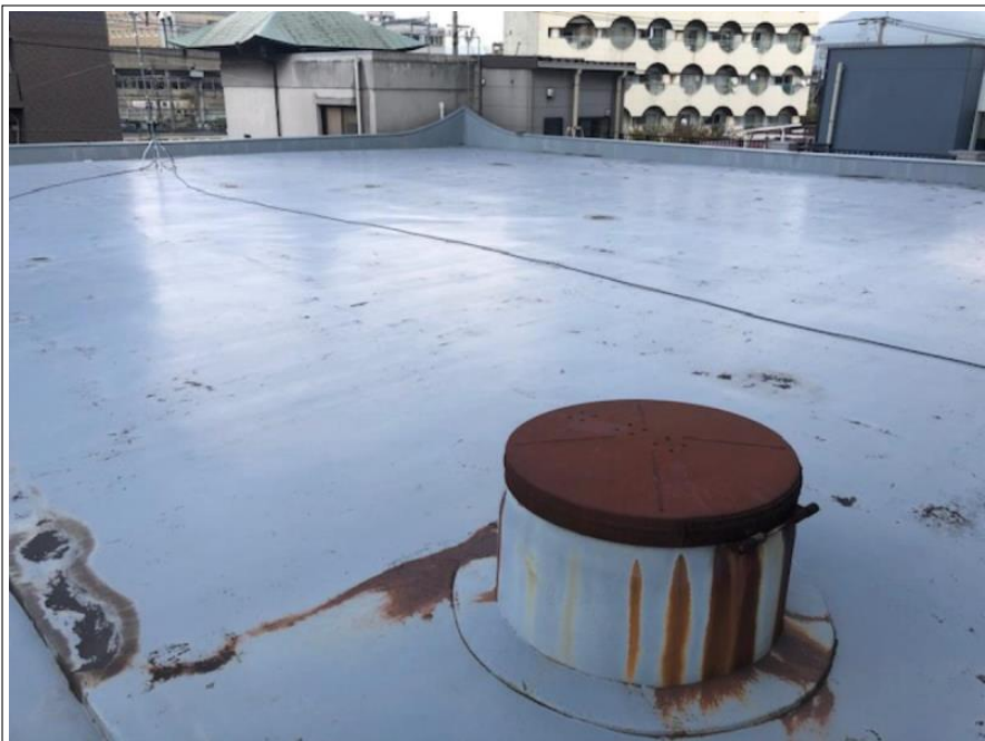
本堂 塗膜防水部
