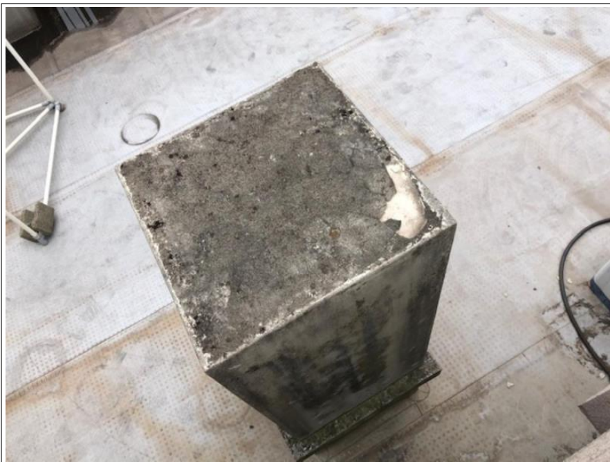
2F シート防水部
