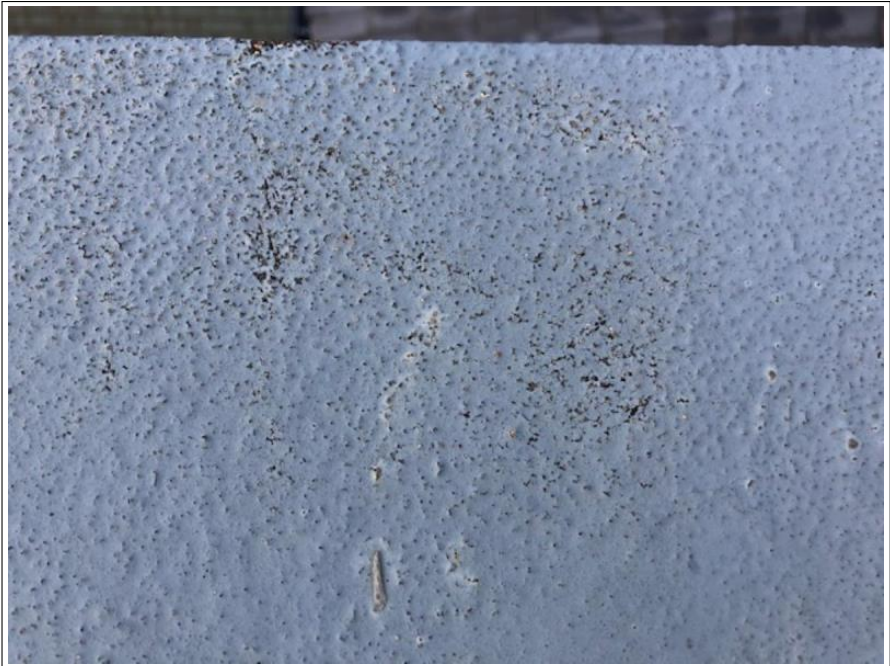
本堂 塗膜防水部
