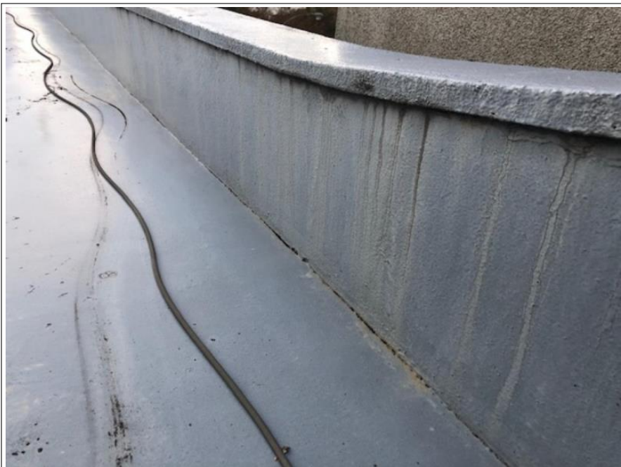
本堂 塗膜防水部
