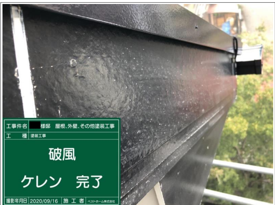
工事件名 様邸 屋根、外壁、その他塗装工事 工種 塗装工事 破風 ケレン 撮影年月日 2020/09/16 施工者 ベストホーム株式会社
