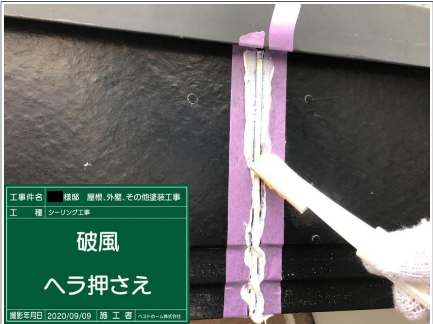
工 事 名 様邸 屋根、外壁、その他塗装工事 工 種 シーリング工事 破風 シーリング打ち 完了 撮影年月日 2020/09/09 施 工 者 ベストホーム株式会社
