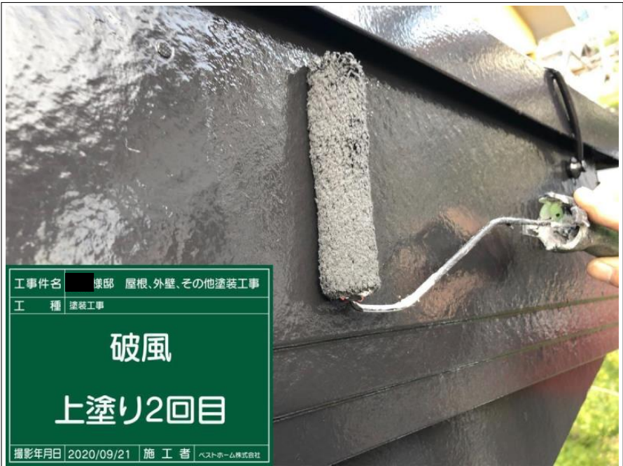
工事件名 様邸 屋根、外壁、その他塗装工事 工種 塗装工事 破風 上塗り2回目 撮影年月日 2020/09/21 施工者 ベストホーム株式会社
