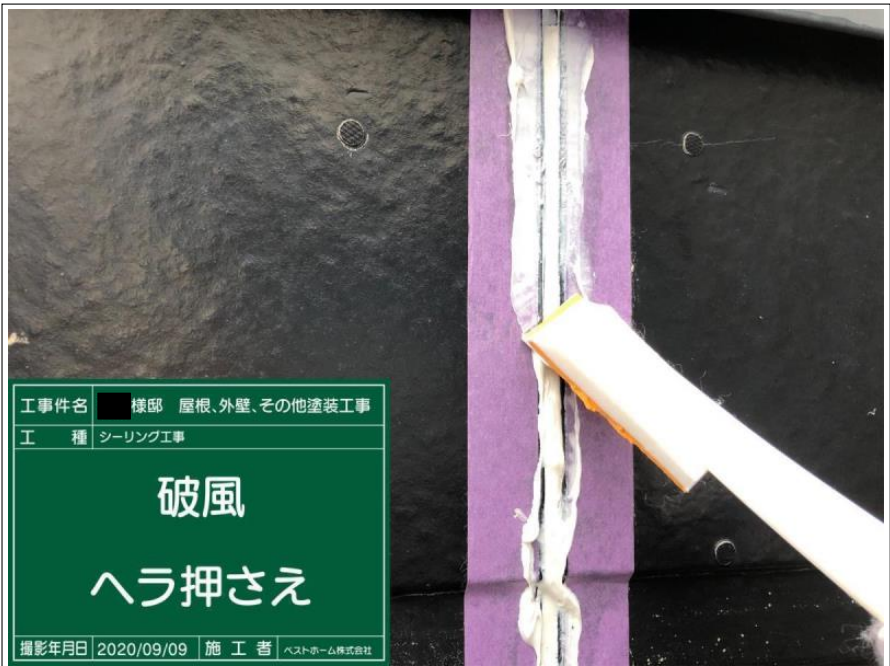
工 事 名 様邸 屋根、外壁、その他塗装工事 工 種 シーリング工事 破風 ヘラ押さえ 撮影年月日 2020/09/09 施 工 者 ベストホーム株式会社
