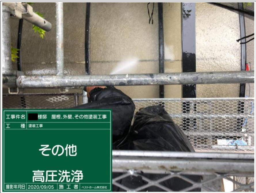
工事件名 ■ 様邸 屋根、外壁、その他塗装工事 工 種 塗装工事 基礎 高圧洗浄 撮影年月日 2020/09/05 施 工 者 ベストホーム株式会社
