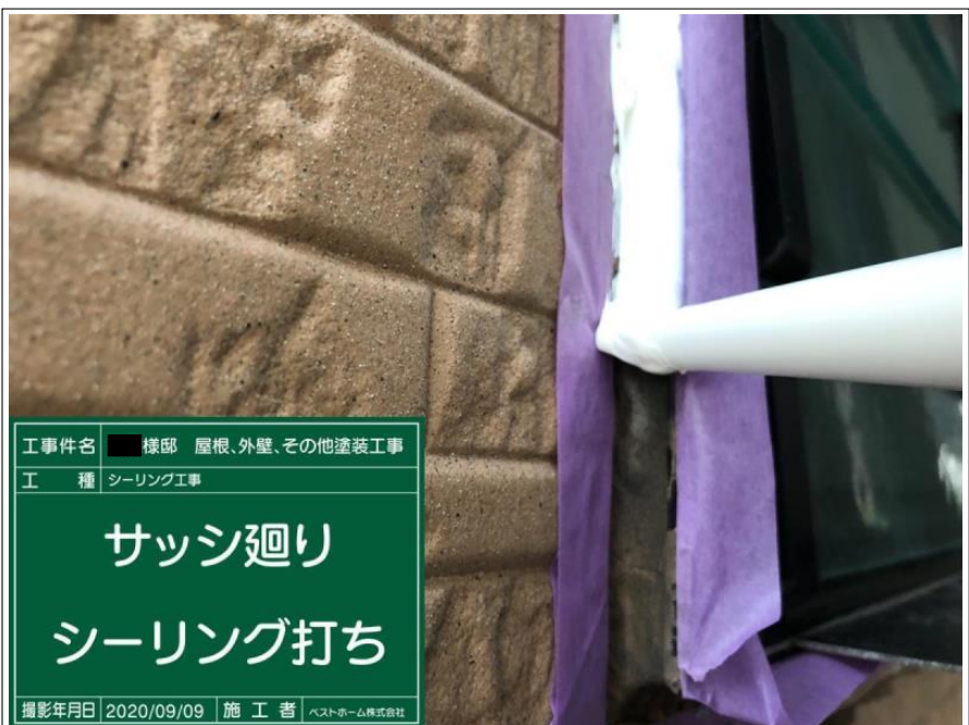
工事件名 ■ 様邸 屋根、外壁、その他塗装工事 工 種 シーリング工事 サッシ廻り シーリング打ち 撮影年月日 2020/09/09 施 工 者 ベストホーム株式会社
