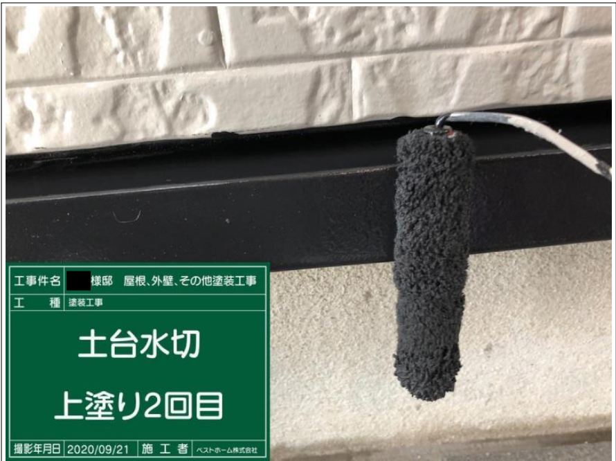
工事件名 ■ 様邸 屋根、外壁、その他塗装工事 工 種 塗装工事 土台水切 上塗り2回目 撮影年月日 2020/09/21 施 工 者 ベストホーム株式会社
