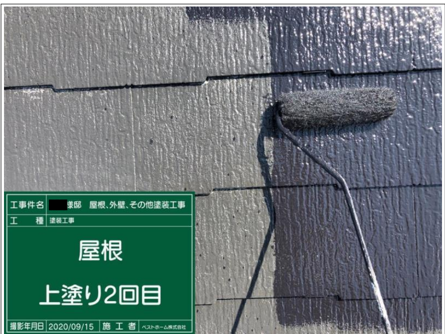
工事件名 ■ 様邸 屋根、外壁、その他塗装工事 工 種 塗装工事 屋根 上塗り2回目 撮影年月日 2020/09/15 施 工 者 ベストホーム株式会社
