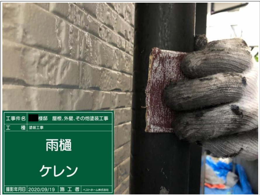
工 事 件 名 ■ 様邸 屋根、外壁、その他塗装工事 工 種 塗装工事 雨樋 ケレン 撮影年月日 2020/09/19 施 工 者 ベストホーム株式会社
