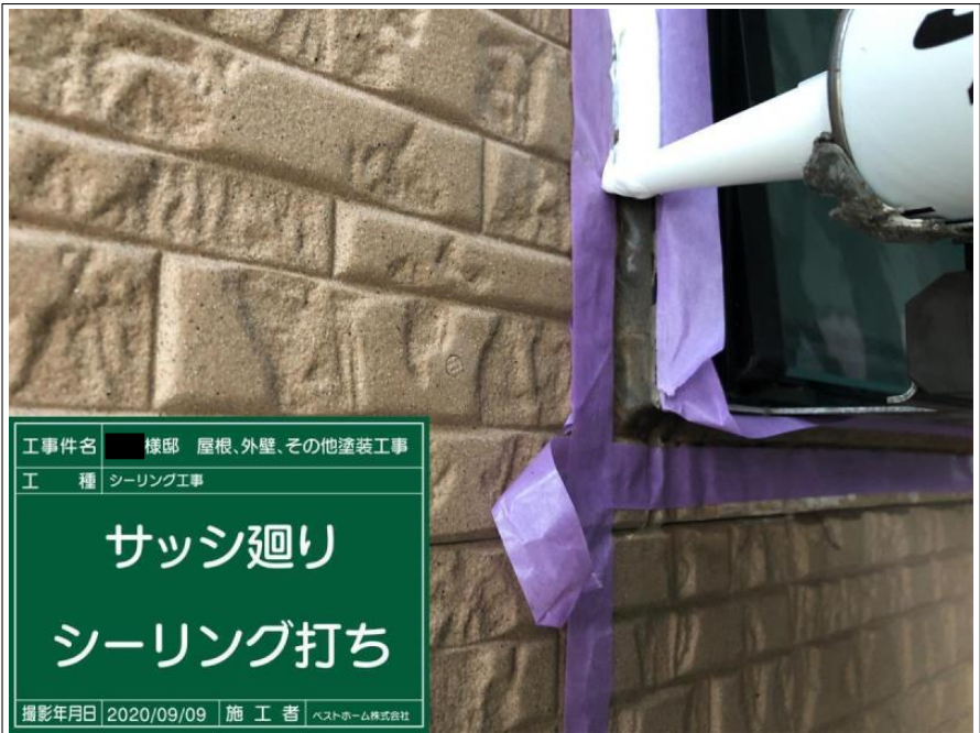
工事件名 ■ 様邸 屋根、外壁、その他塗装工事 工 種 シーリング工事 サッシ廻り プライマー塗布 完了 撮影年月日 2020/09/09 施 工 者 ベストホーム株式会社
