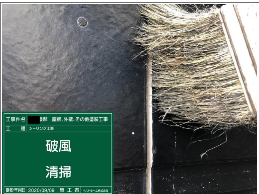
工事件名 様邸 屋根、外壁、その他塗装工事 工種 シーリング工事 破風 清掃 撮影年月日 2020/09/09 施工者 ベストホーム株式会社
