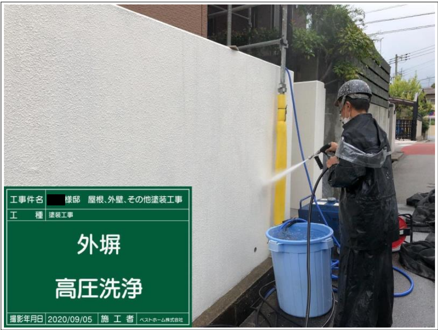
工事件名 ■ 様邸 屋根、外壁、その他塗装工事 工 種 塗装工事 その他 高圧洗浄 撮影年月日 2020/09/05 施 工 者 ベストホーム株式会社
