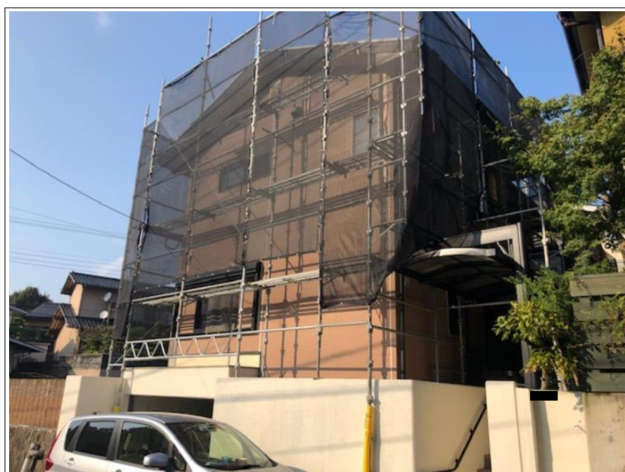
足場組立完了
