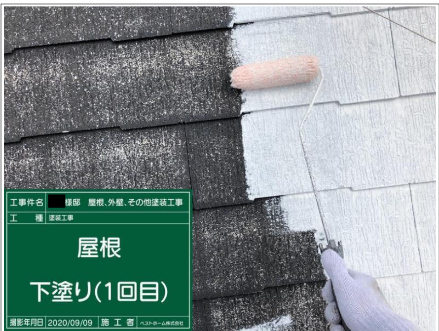
工事件名 ■ 様邸 屋根、外壁、その他塗装工事 工 種 塗装工事 屋根 下塗り(1回目) 撮影年月日 2020/09/09 施 工 者 ベストホーム株式会社
