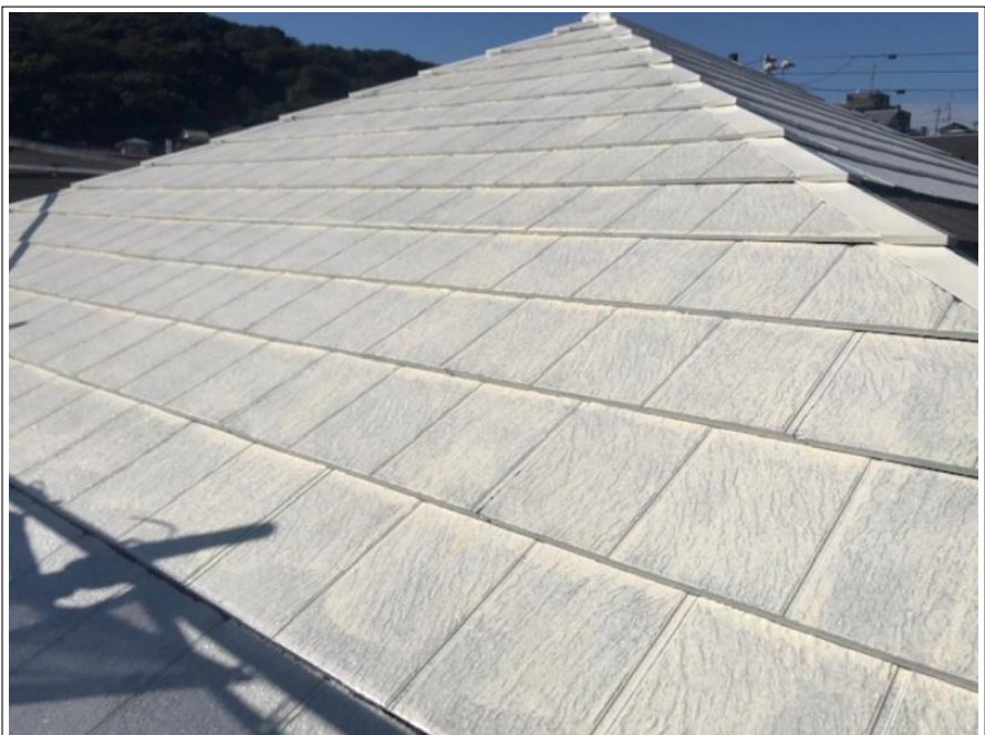
工 事 名 棟 邸 屋根、外壁その他塗装工事 工 種 塗装工事 屋根 下塗り(シーラー) 1回目 完了 撮影年月日 2020/10/08 施 工 者 ベストホーム株式会社
