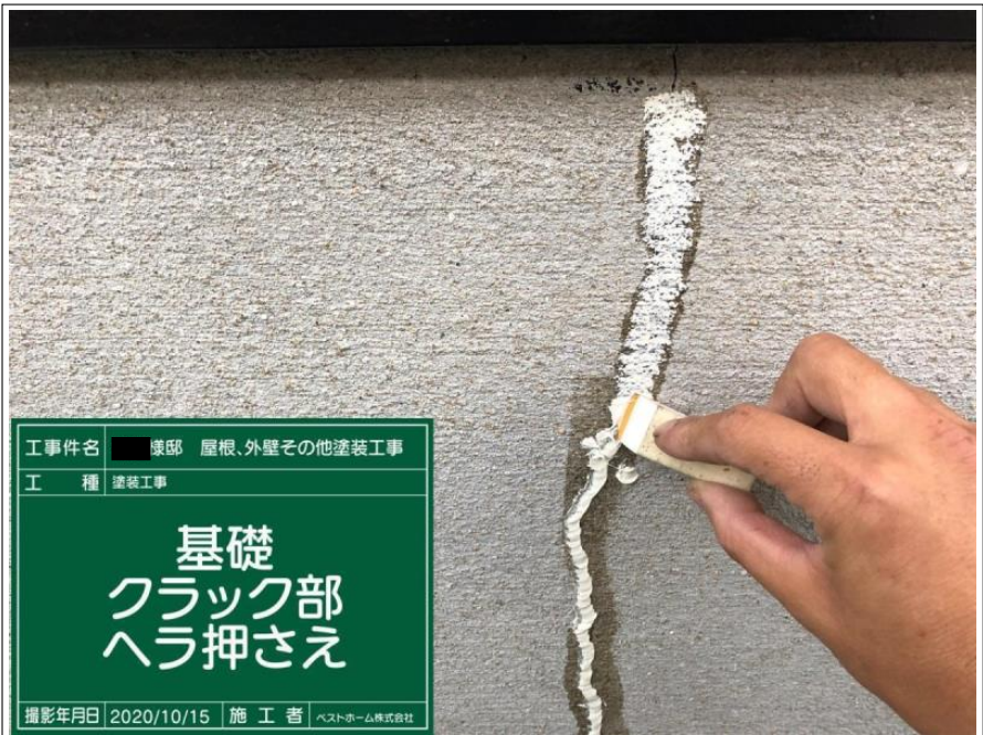
工事件名 ■ 様邸 屋根、外壁その他塗装工事 工 種 塗装工事 基礎 クラック部 シーリング打ち 完了 撮影年月日 2020/10/15 | 施 工 者 ベストホーム株式会社
