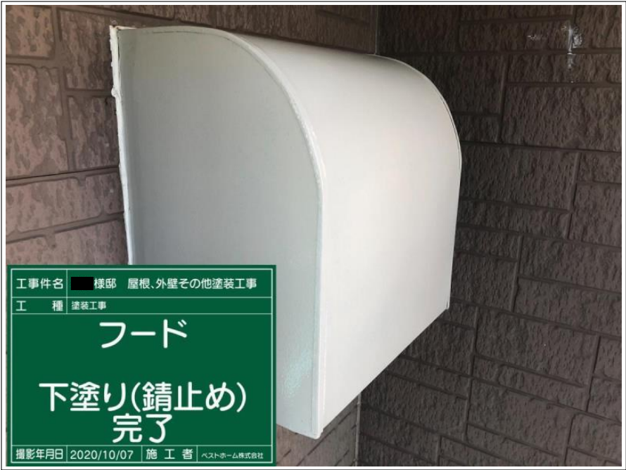
工事件名 ■ 棟邸 屋根、外壁その他塗装工事 工 種 塗装工事 フード 下塗り(錆止め) 撮影年月日 2020/10/07 施 工 者 ベストホーム株式会社
