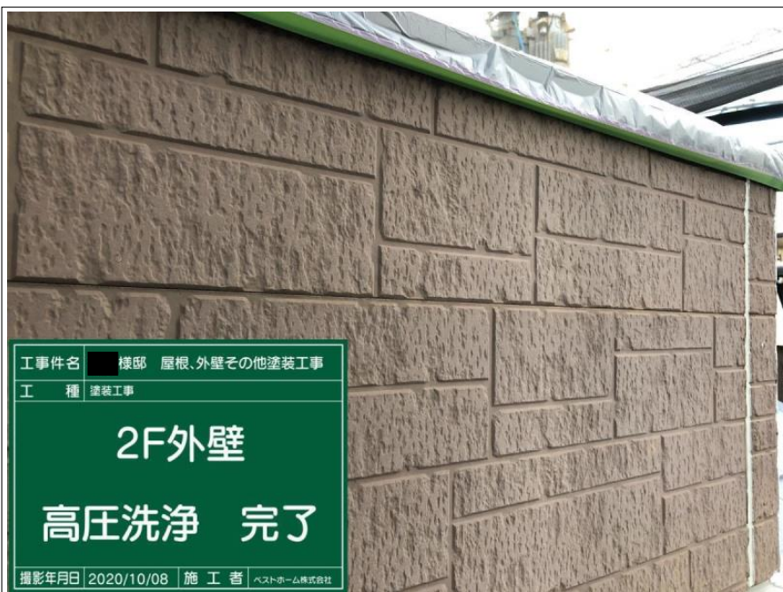
工 事 件 名 棟 号 屋 根、外 壁 其 他 塗 装 工 事 工 種 塗 装 工 事 2F外壁 高圧洗浄 撮 影 年 月 日 2020/10/05 施 工 者 ベストホーム株式会社
