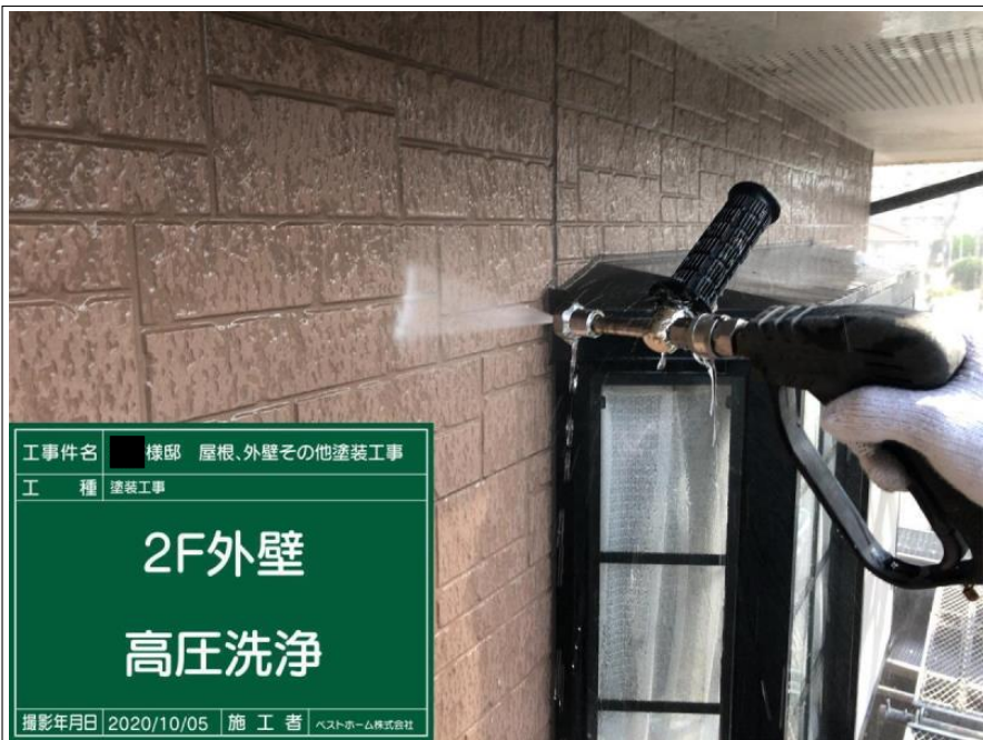
工 事 件 名 棟 号 屋 根、外 壁 其 他 塗 装 工 事 工 種 塗 装 工 事 2F外壁 高圧洗浄 撮 影 年 月 日 2020/10/05 施 工 者 ベストホーム株式会社
