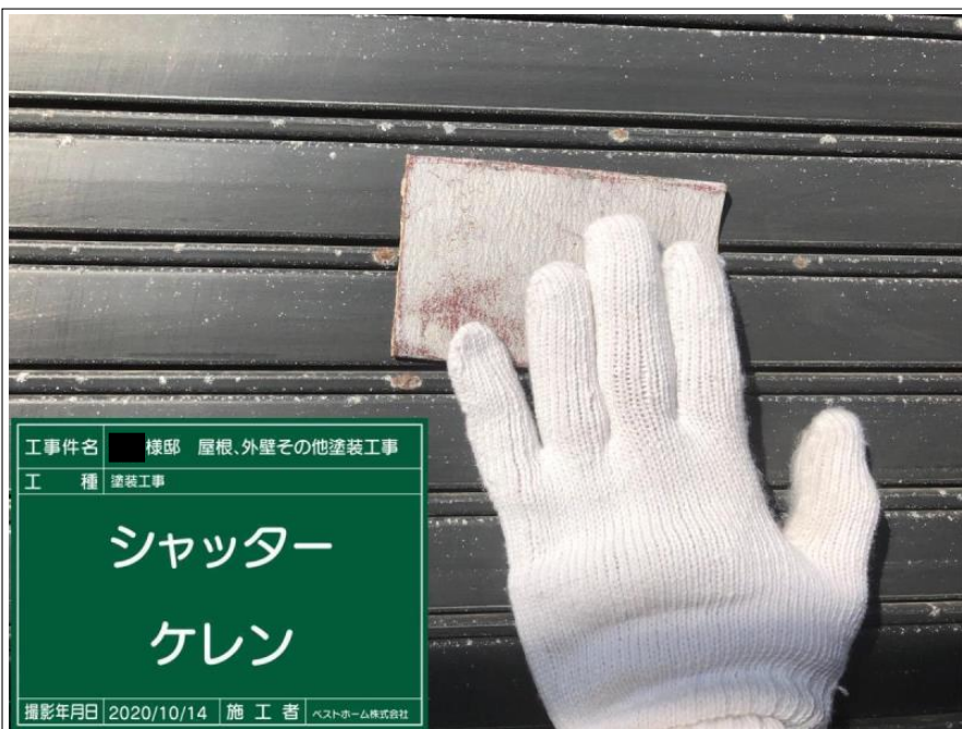
工 事 名 棟 邸 屋 根、外 壁 其 他 塗 装 工 事 工 種 塗 装 工 事 シャッター ケレン 撮 影 年 月 日 2020/10/14 施 工 者 ベストホーム株式会社
