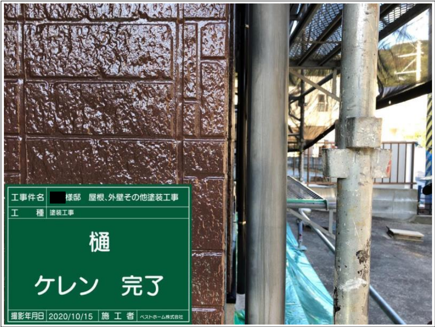
工事件名 棟邸 屋根、外壁その他塗装工事 工種 塗装工事 樋 ケレン 撮影年月日 2020/10/15 施工者 ベストホーム株式会社
