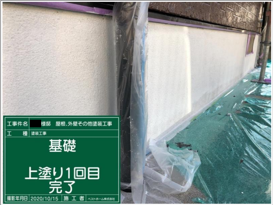
工事件名 ■ 棟部 屋根、外壁その他塗装工事 工 種 塗装工事 基礎 上塗り1回目 撮影年月日 2020/10/15 施 工 者 ベストホーム株式会社
