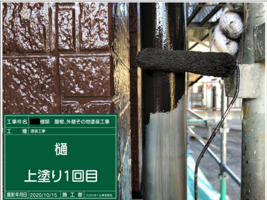
工事件名 ■ 棟部 屋根、外壁その他塗装工事 工 種 塗装工事 樋 上塗り1回目 撮影年月日 2020/10/15 施 工 者 ベストホーム株式会社
