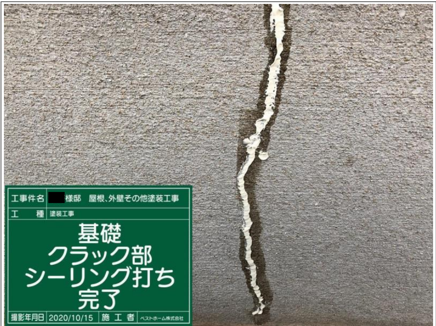
工事件名 ■ 様邸 屋根、外壁その他塗装工事 工 種 塗装工事 基礎 クラック部 シーリング打ち 撮影年月日 2020/10/15 | 施 工 者 ベストホーム株式会社
