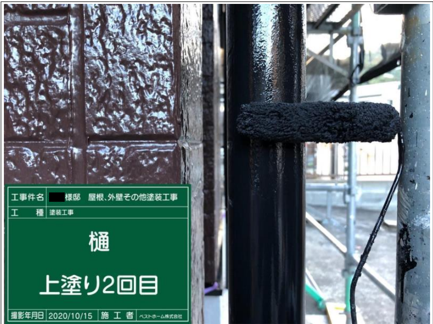
工 事 名 棟 号 屋根、外壁その他塗装工事 工 種 塗装工事 樋 上塗り2回目 撮影年月日 2020/10/15 施 工 者 ベストホーム株式会社
