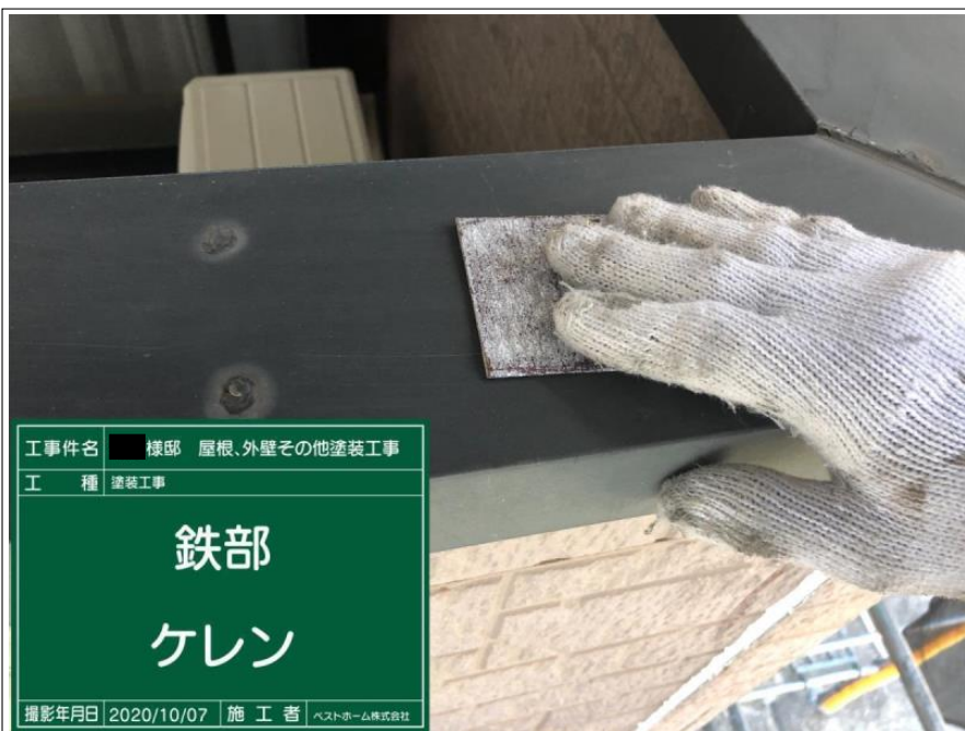
工事件名 棟部 屋根、外壁その他塗装工事 工種 塗装工事 鉄部 ケレン 撮影年月日 2020/10/07 施工者 ベストホーム株式会社
