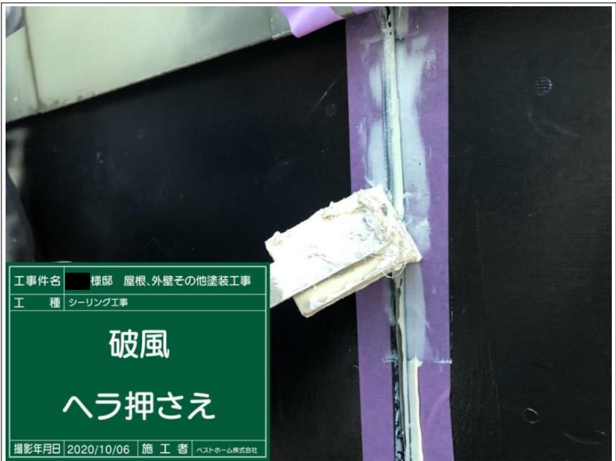
工事件名 様邸 屋根、外壁その他塗装工事 工種 シーリング工事 破風 シーリング打ち 完了 撮影年月日 2020/10/06 施工者 ベストホーム株式会社
