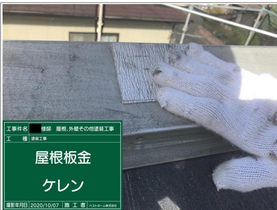
工事件名 ■ 様邸 屋根、外壁その他塗装工事 工 種 塗装工事 屋根板金 ケレン 撮影年月日 2020/10/07 施 工 者 ベストホーム株式会社
