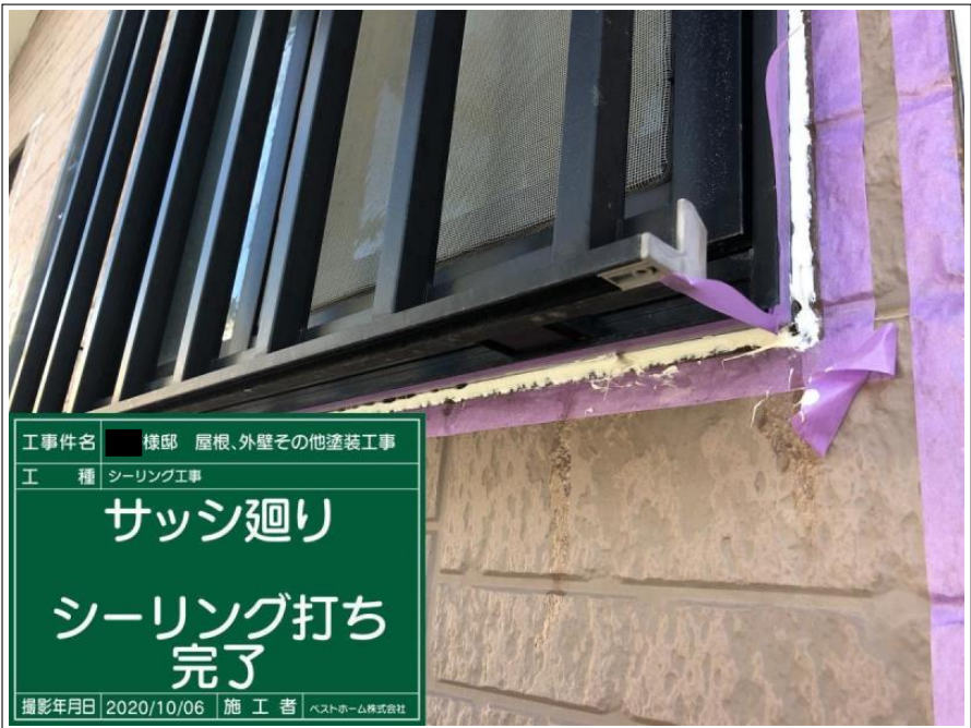
工事件名 ■ 様邸 屋根、外壁その他塗装工事 工 種 シーリング工事 サッシ廻り シーリング打ち 撮影年月日 2020/10/06 施 工 者 ベストホーム株式会社
