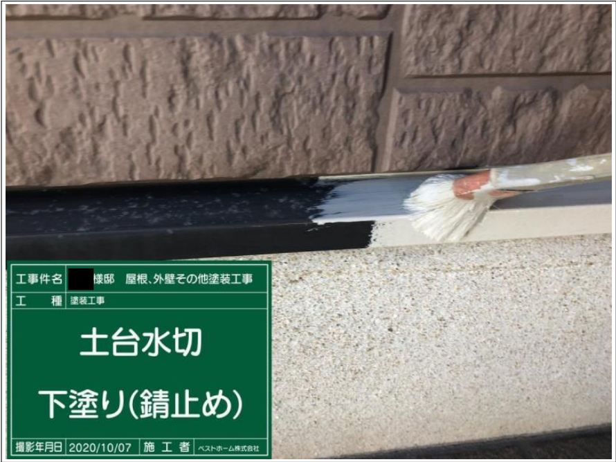
工事件名 ■ 棟部 屋根、外壁その他塗装工事 工 種 塗装工事 土台水切 下塗り(錆止め) 撮影年月日 2020/10/07 施 工 者 ベストホーム株式会社
