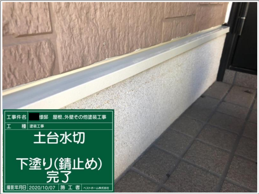
工事件名 ■ 棟部 屋根、外壁その他塗装工事 工 種 塗装工事 土台水切 下塗り(錆止め) 撮影年月日 2020/10/07 施 工 者 ベストホーム株式会社
