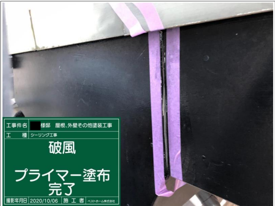
工 事 件 名 様邸 屋根、外壁その他塗装工事 工 種 シーリング工事 破風 プライマー塗布 撮影年月日 2020/10/06 施 工 者 ベストホーム株式会社
