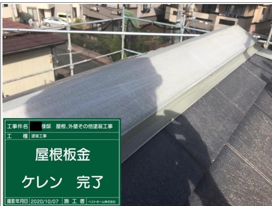
工事件名 ■ 様邸 屋根、外壁その他塗装工事 工 種 塗装工事 屋根板金 ケレン 撮影年月日 2020/10/07 施 工 者 ベストホーム株式会社
