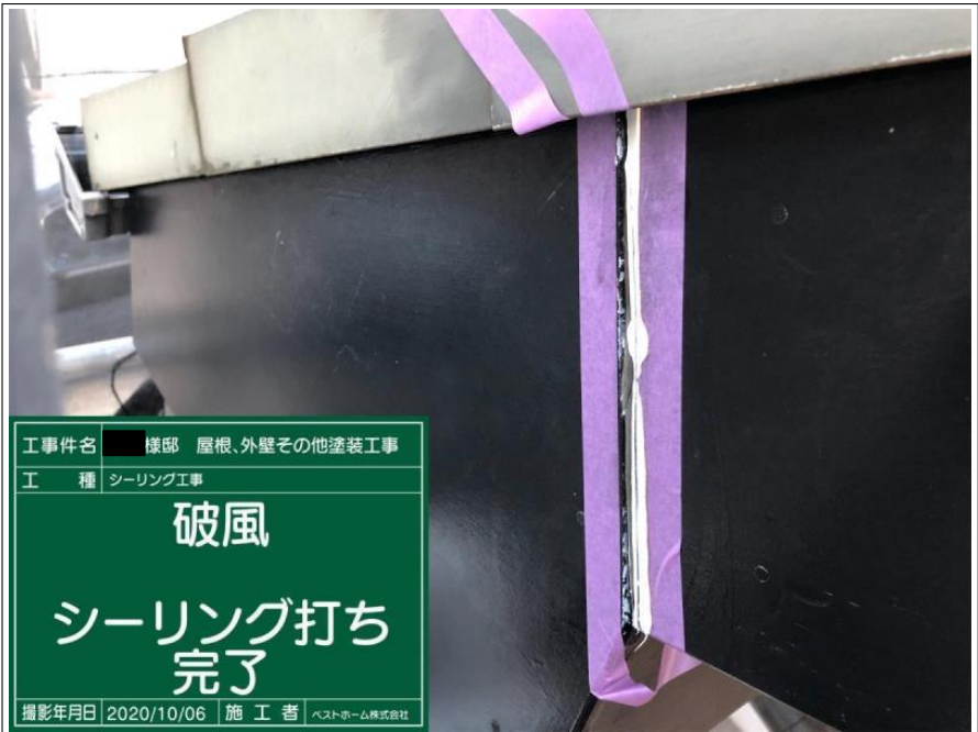
工事件名 様邸 屋根、外壁その他塗装工事 工種 シーリング工事 破風 シーリング打ち 撮影年月日 2020/10/06 施工者 ベストホーム株式会社
