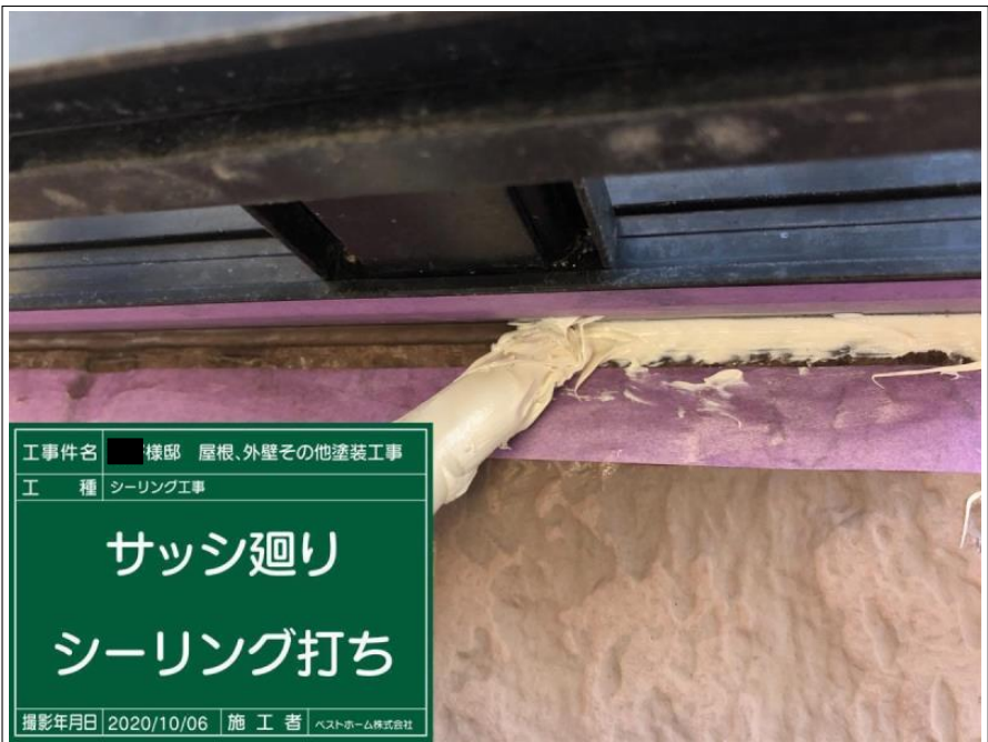
工事件名 ■ 様邸 屋根、外壁その他塗装工事 工 種 シーリング工事 サッシ廻り シーリング打ち 撮影年月日 2020/10/06 施 工 者 ベストホーム株式会社
