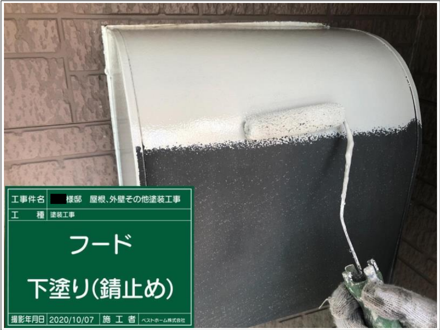
工事件名 ■ 棟邸 屋根、外壁その他塗装工事 工 種 塗装工事 フード 下塗り(錆止め) 撮影年月日 2020/10/07 施 工 者 ベストホーム株式会社
