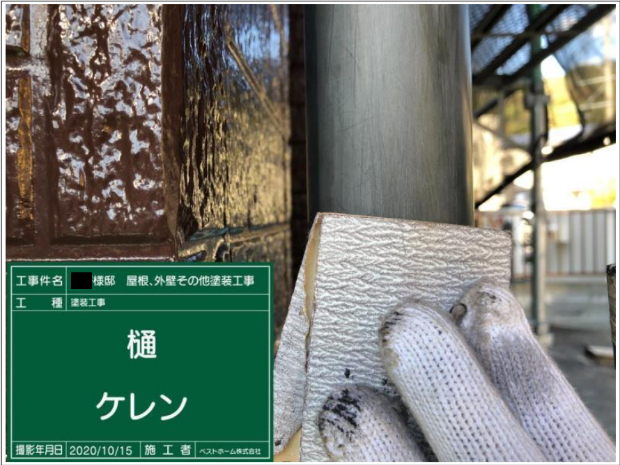
工事件名 棟邸 屋根、外壁その他塗装工事 工種 塗装工事 樋 ケレン 撮影年月日 2020/10/15 施工者 ベストホーム株式会社
