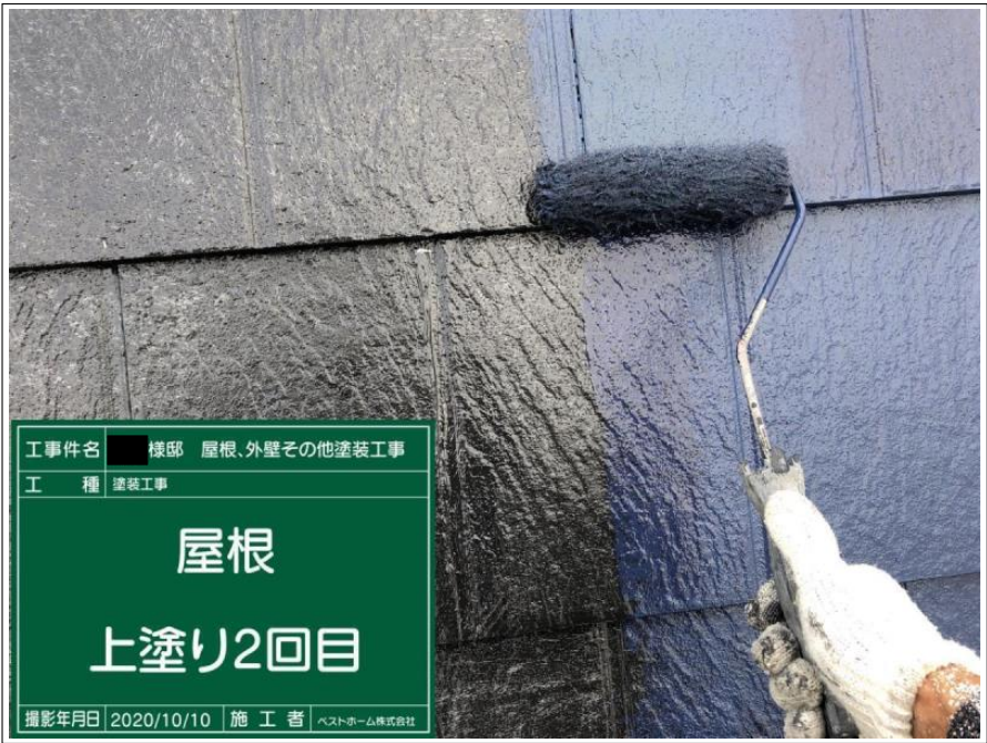
工事件名 ■ 棟邸 屋根、外壁その他塗装工事 工 種 塗装工事 屋根 上塗り2回目 撮影年月日 2020/10/10 施 工 者 ベストホーム株式会社
