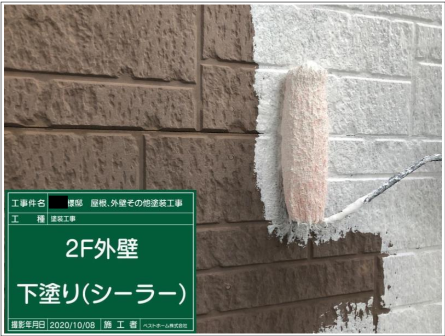
工事件名 ■ 様邸 屋根、外壁その他塗装工事 工 種 塗装工事 2F外壁 下塗り(シーラー) 撮影年月日 2020/10/08 施 工 者 ベストホーム株式会社
