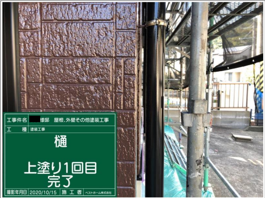
工事件名 ■ 棟部 屋根、外壁その他塗装工事 工 種 塗装工事 樋 上塗り1回目 撮影年月日 2020/10/15 施 工 者 ベストホーム株式会社
