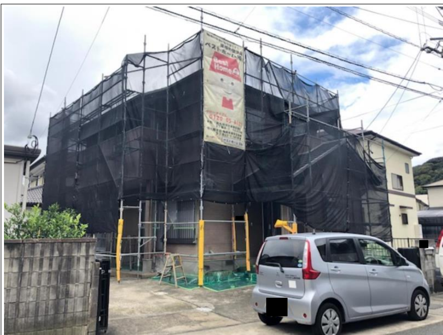
足場組立 完了
