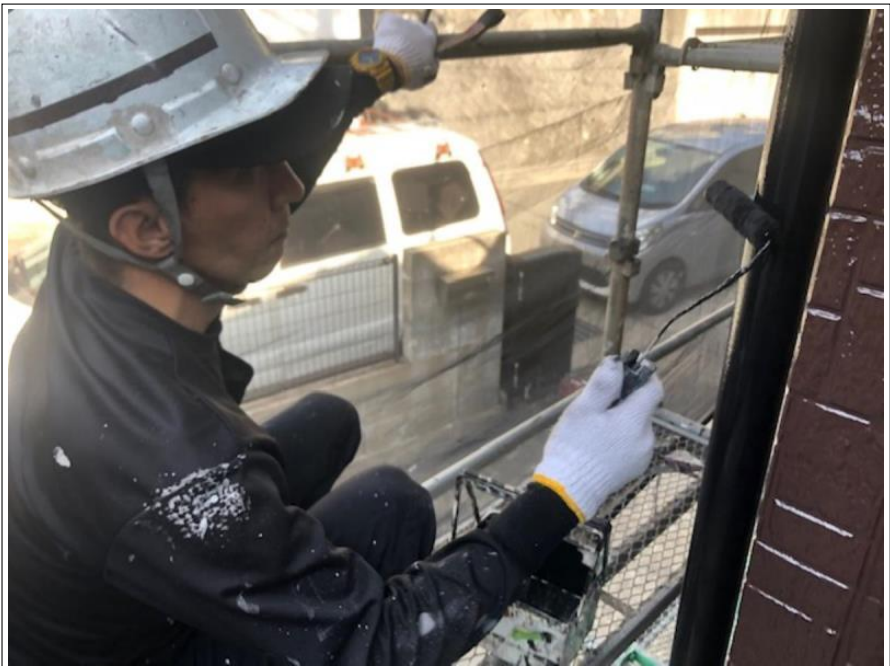
工 事 名 棟 号 屋根、外壁その他塗装工事 工 種 塗装工事 樋 上塗り2回目 撮影年月日 2020/10/15 施 工 者 ベストホーム株式会社
