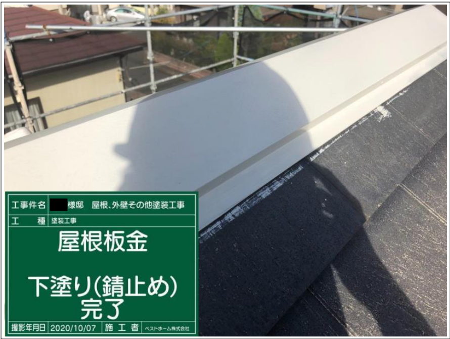
工事件名 ■ 棟部 屋根、外壁その他塗装工事 工 種 塗装工事 屋根板金 下塗り(錆止め) 撮影年月日 2020/10/07 施 工 者 ベストホーム株式会社
