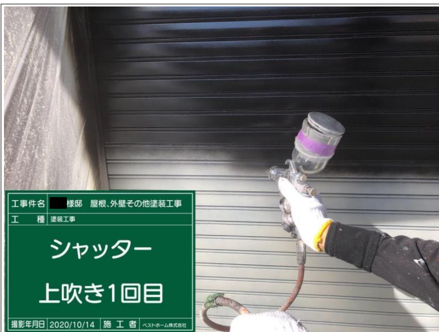
工 事 件 名 棟 号 屋 根、外 壁 其 他 塗 装 工 事 工 種 塗 装 工 事 シャッター 上 吹 き 1 回 目 撮 影 年 月 日 2020/10/14 施 工 者 ベストホーム株式会社
