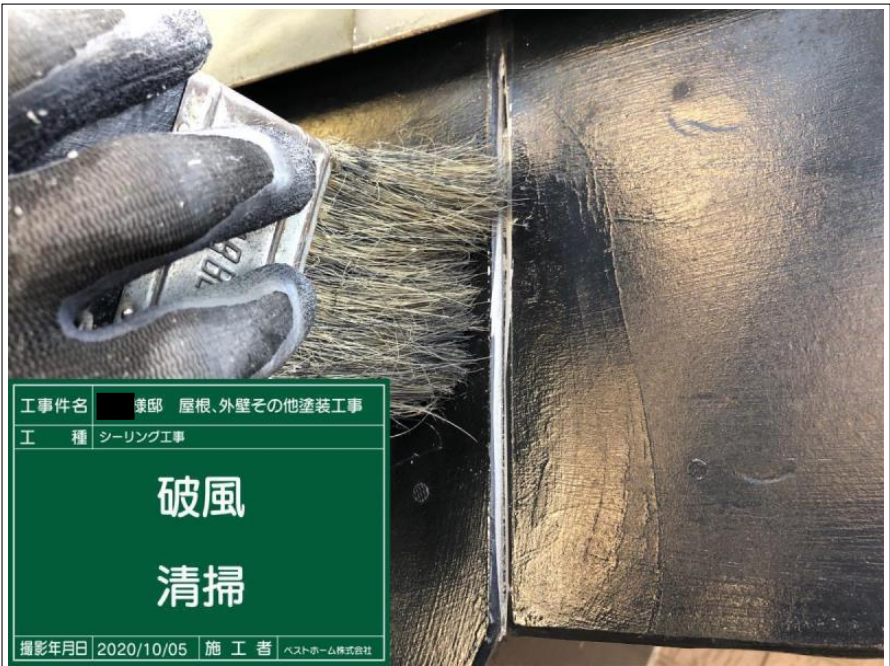
工 事 名 様邸 屋根、外壁その他塗装工事 工 種 シーリング工事 破風 シーリング撤去 完了 撮影年月日 2020/10/05 施 工 者 ベストホーム株式会社
