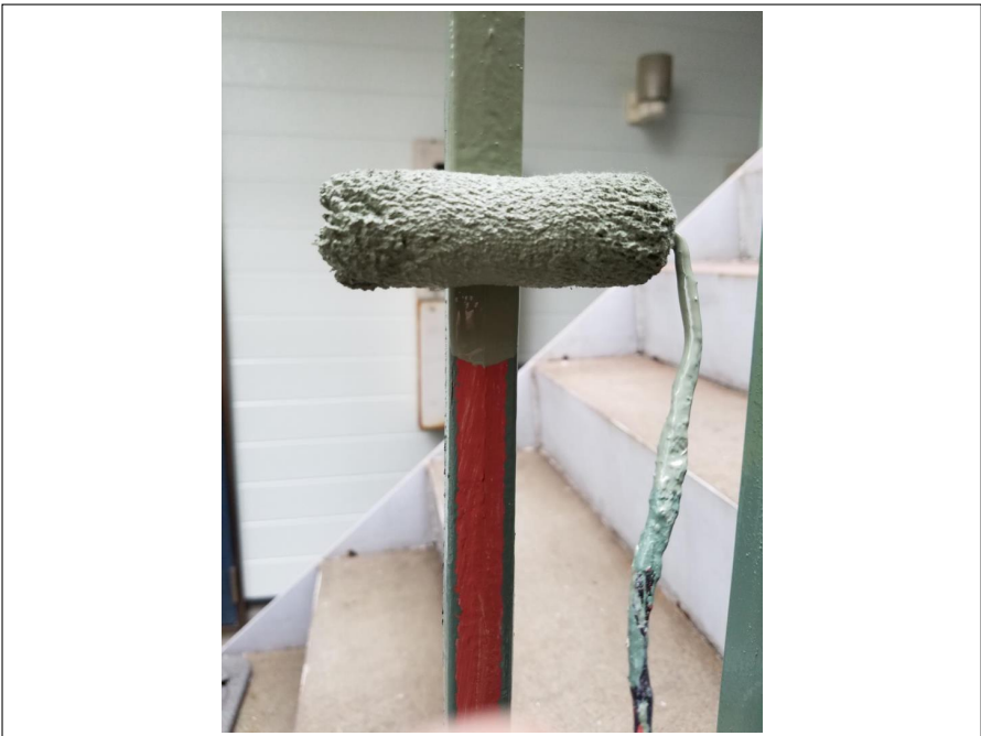
共用部通路・階段
