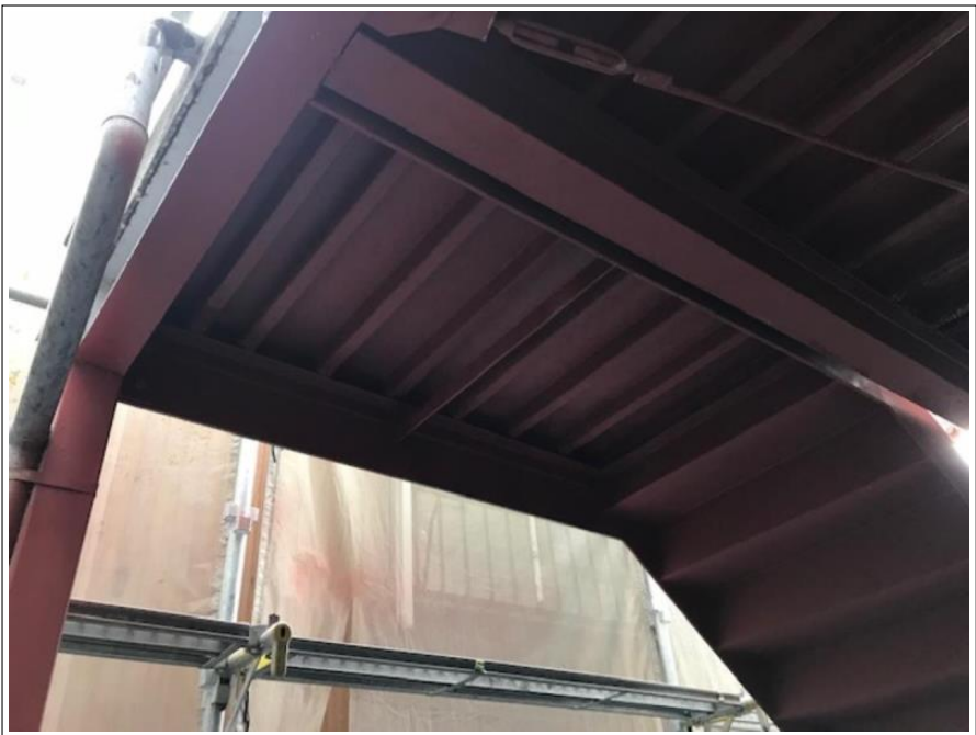
共用部通路・階段
