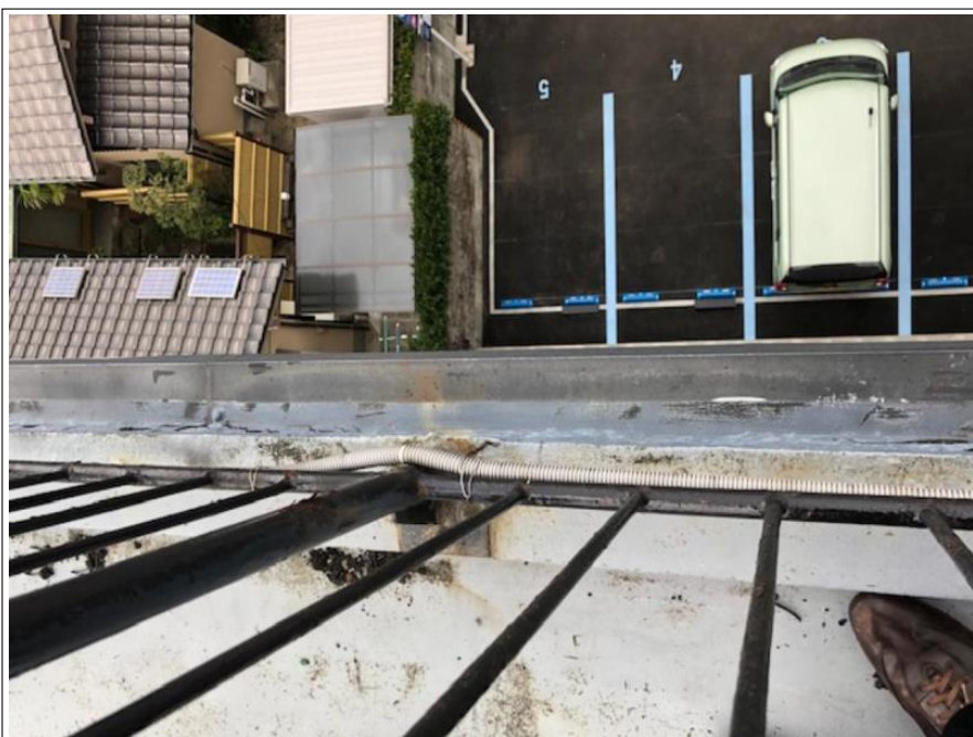
外部シーリング
