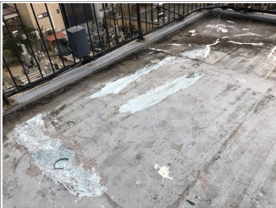
屋上・バルコニー 平場
