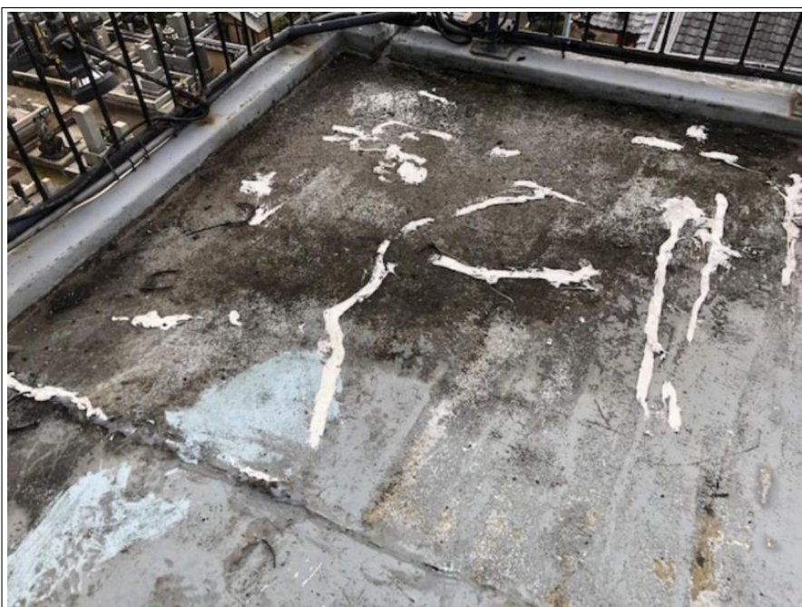
屋上・バルコニー 平場
