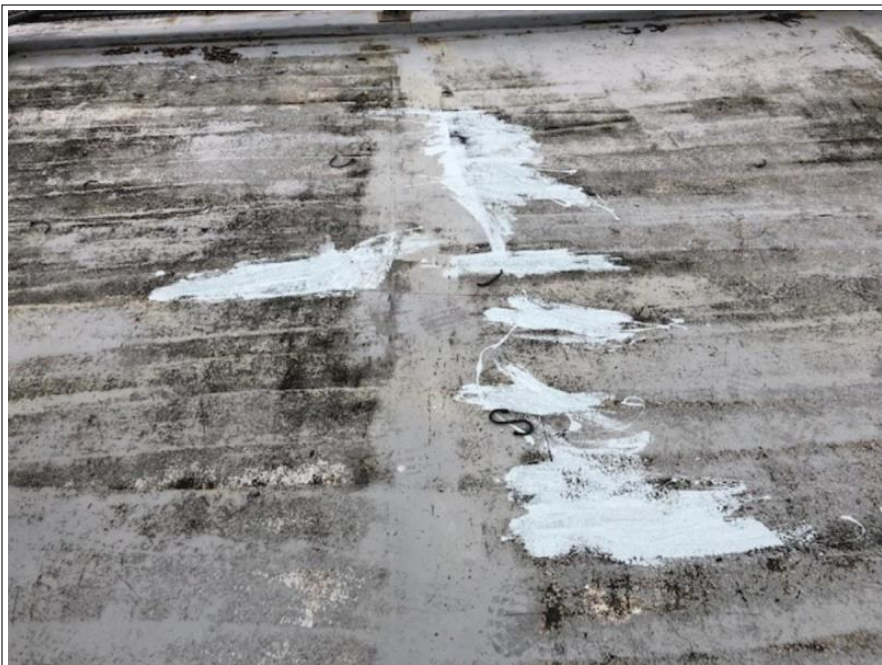
屋上・バルコニー 平場
