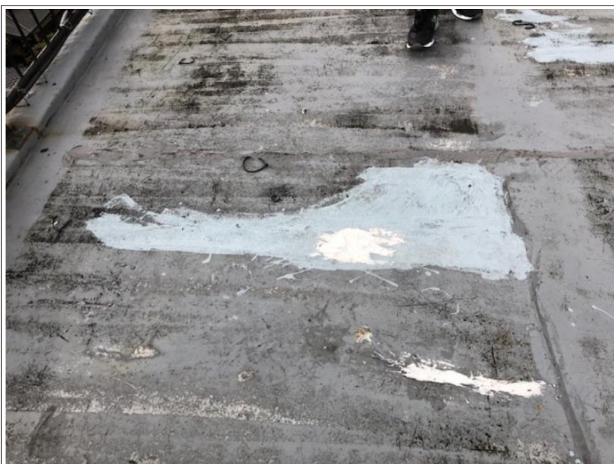
屋上・バルコニー 平場
