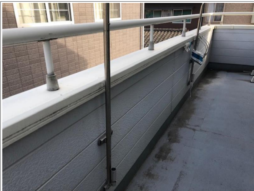
外壁 ベランダ部 現状
