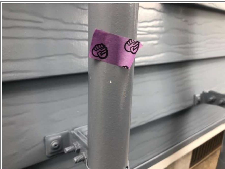
足場解体前チェック
