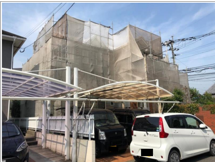
足場組立完了
