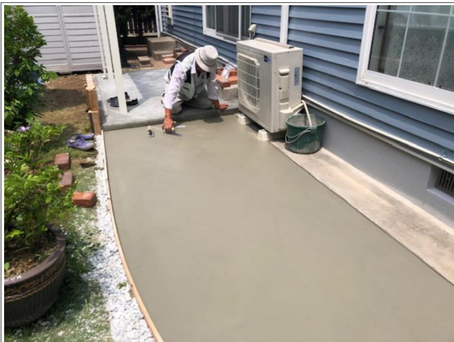
外構土間工事
