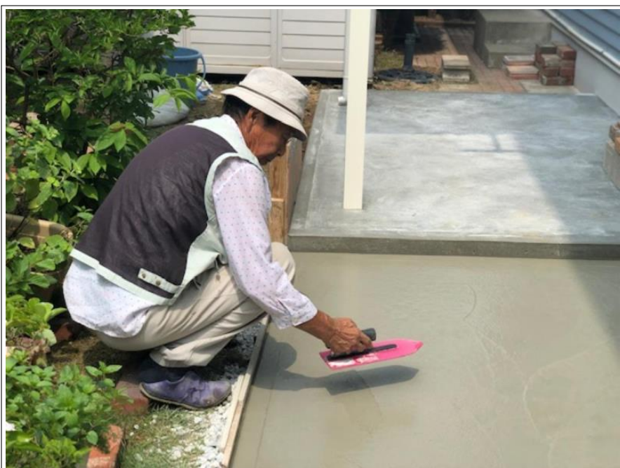
外構土間工事
