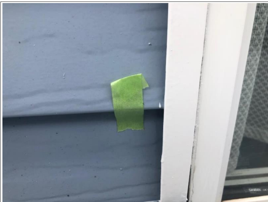
足場解体前チェック
