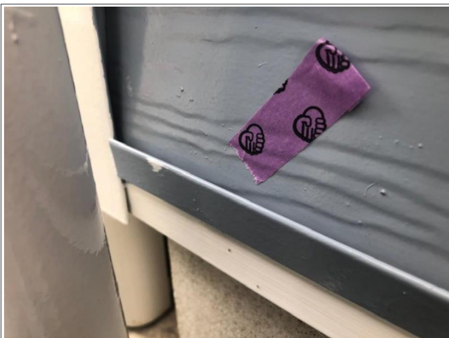
足場解体前チェック
