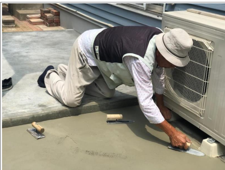
外構土間工事
