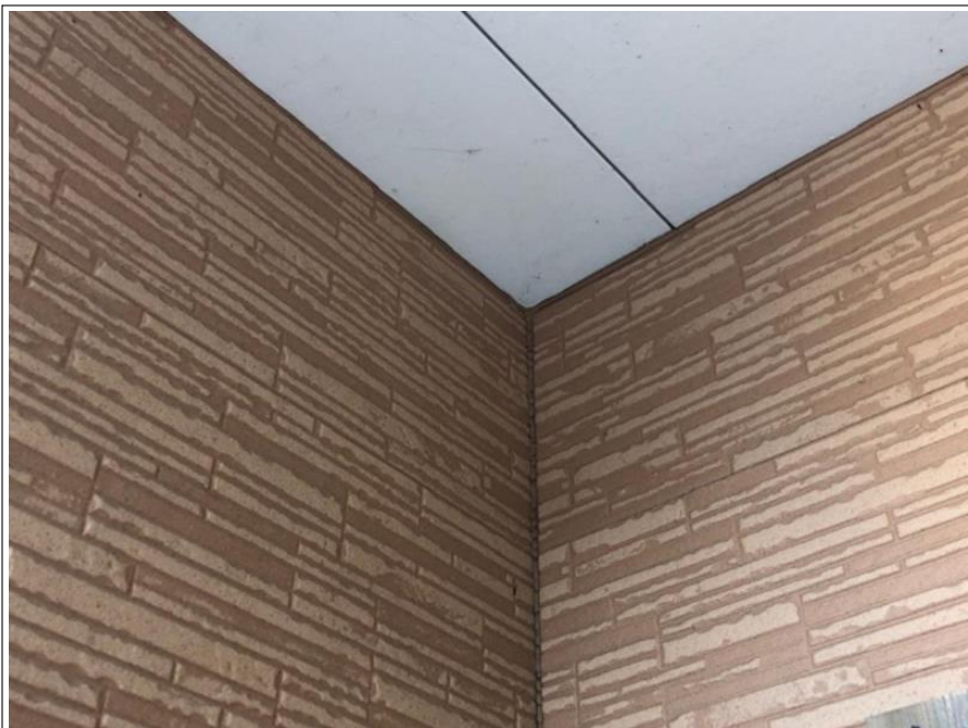
外壁 入隅シーリング部
