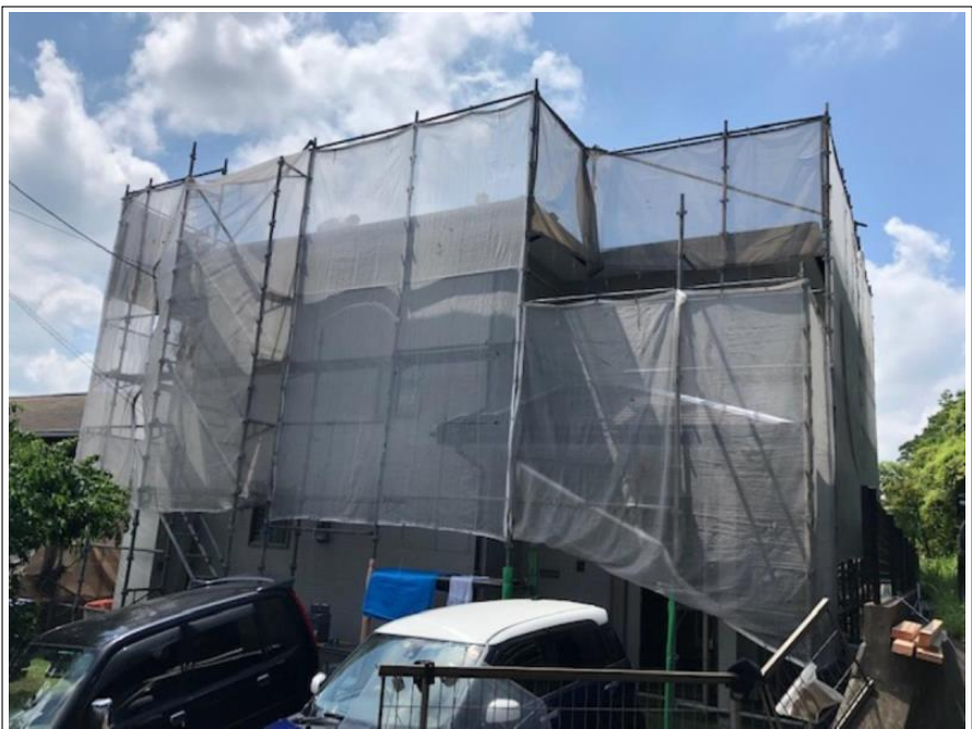
足場組立完了
