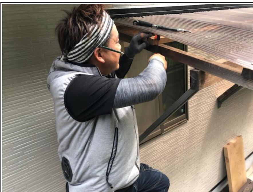
木テラス垂木破損部取替
