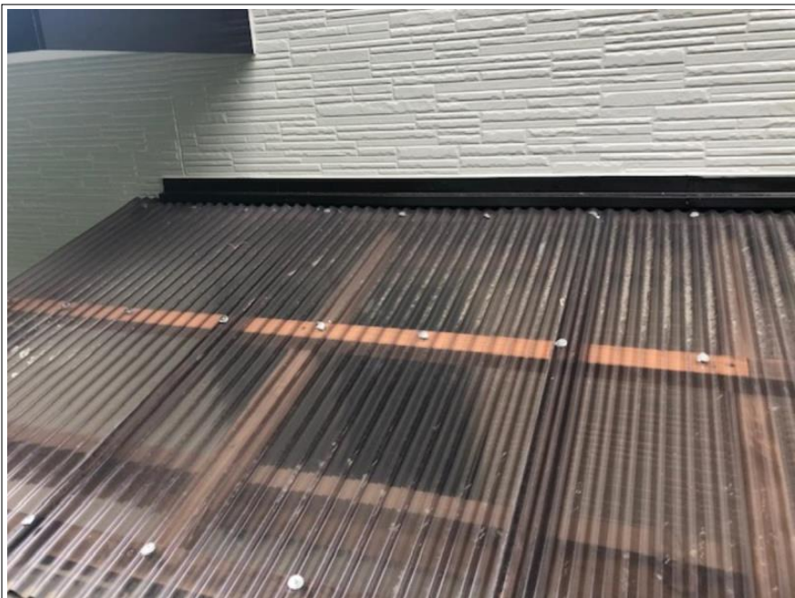
木テラス垂木破損部取替
