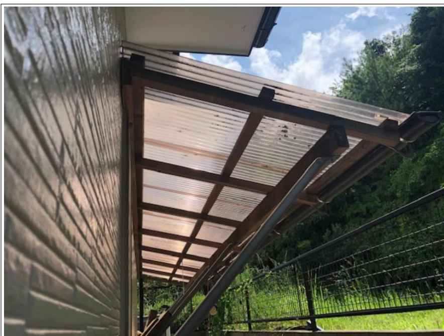
木テラス垂木破損部取替
