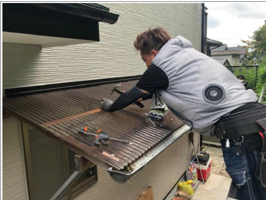
木テラス垂木破損部取替
