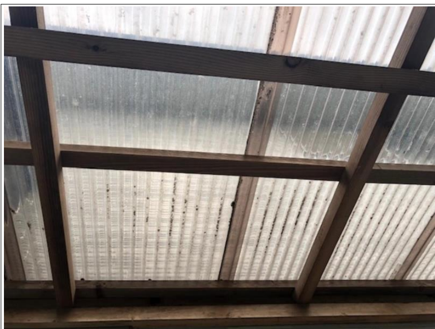
木テラス垂木破損部取替
