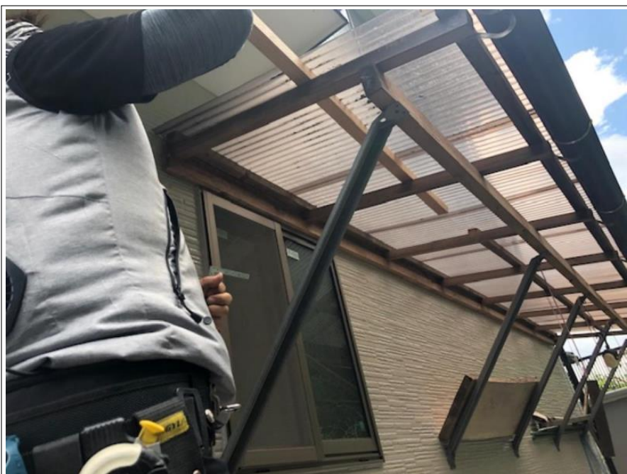
木テラス垂木破損部取替
