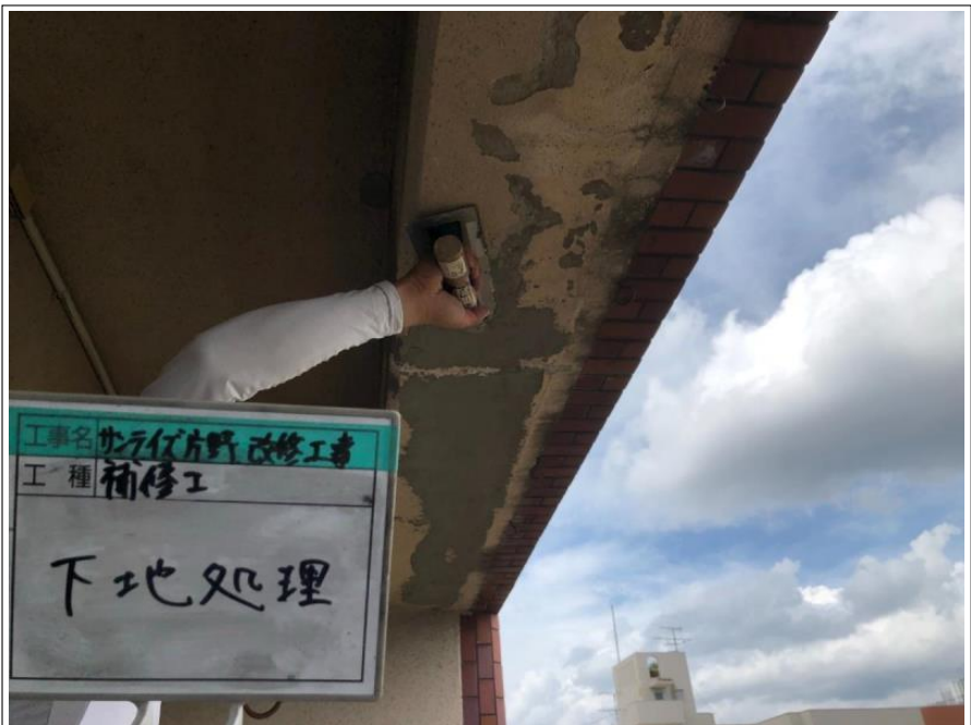
バルコニー 下地補修
