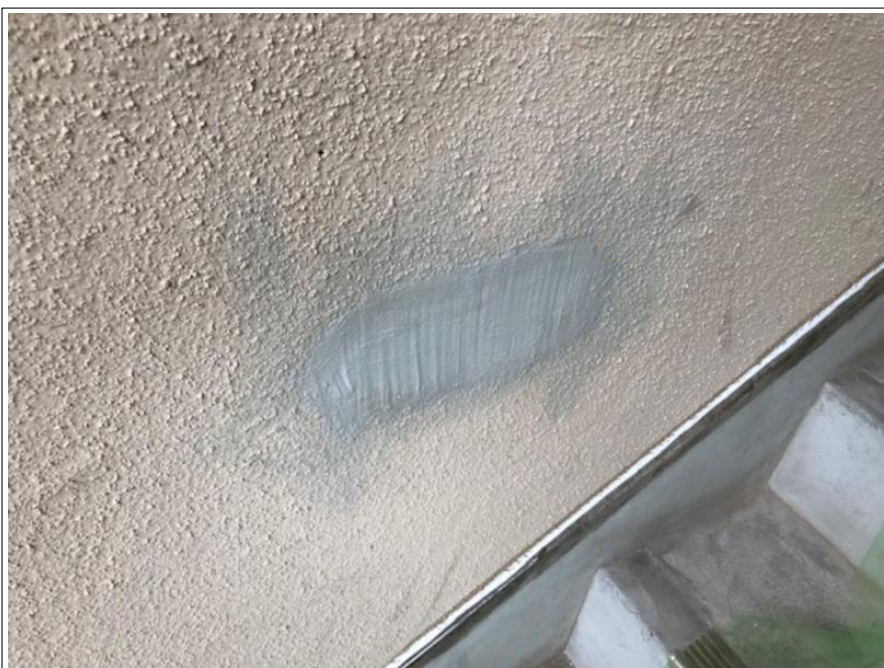
階段室 下地補修
