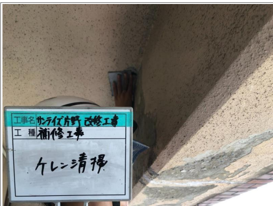
バルコニー 下地補修
