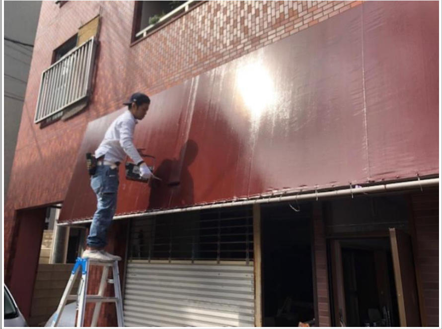
工事件名 サンライズ片野改修工事 工事場所 塗装工 テント 塗装2回目
