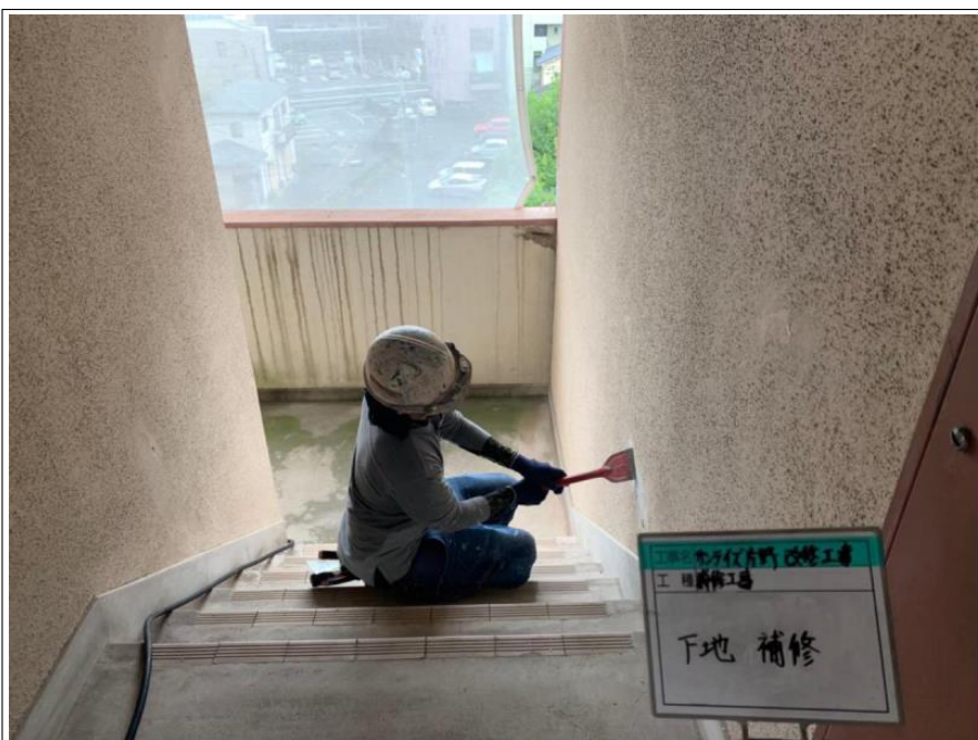
階段室 下地補修
