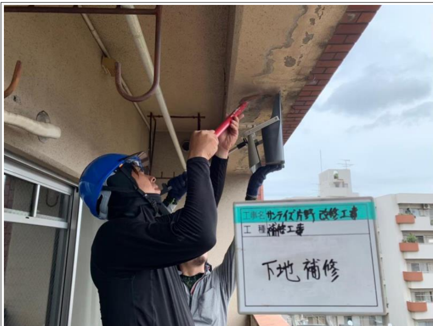
バルコニー 下地補修
