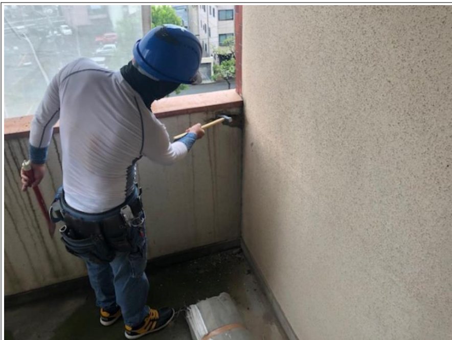
階段室 下地補修
