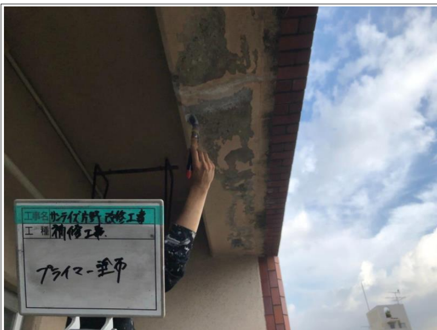
バルコニー 下地補修
