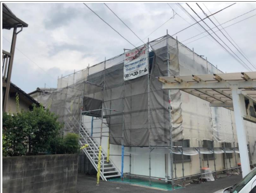
足場組立完了
