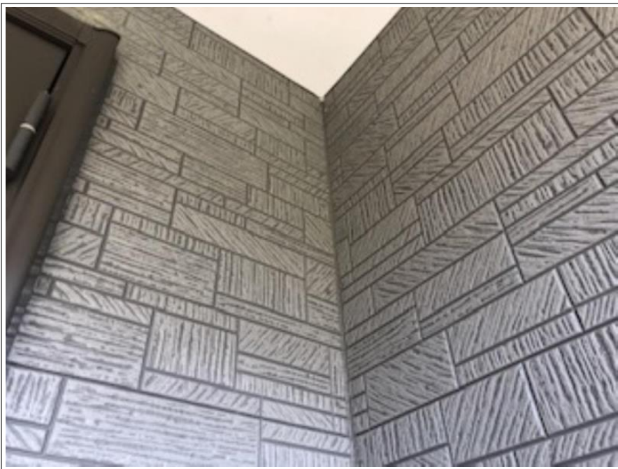
外壁 入隅シーリング部
