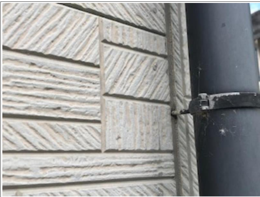
外壁 樋裏シーリング部
