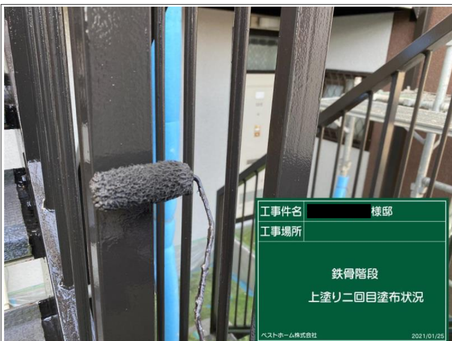
工事件名 様邸 工事場所 鉄骨階段 上塗り二回目塗布状況 ベストホーム株式会社 2021/01/25
