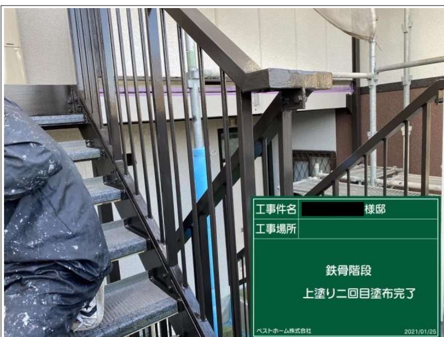
工事件名 様邸 工事場所 鉄骨階段 上塗り二回目塗布状況 ベストホーム株式会社 2021/01/25
