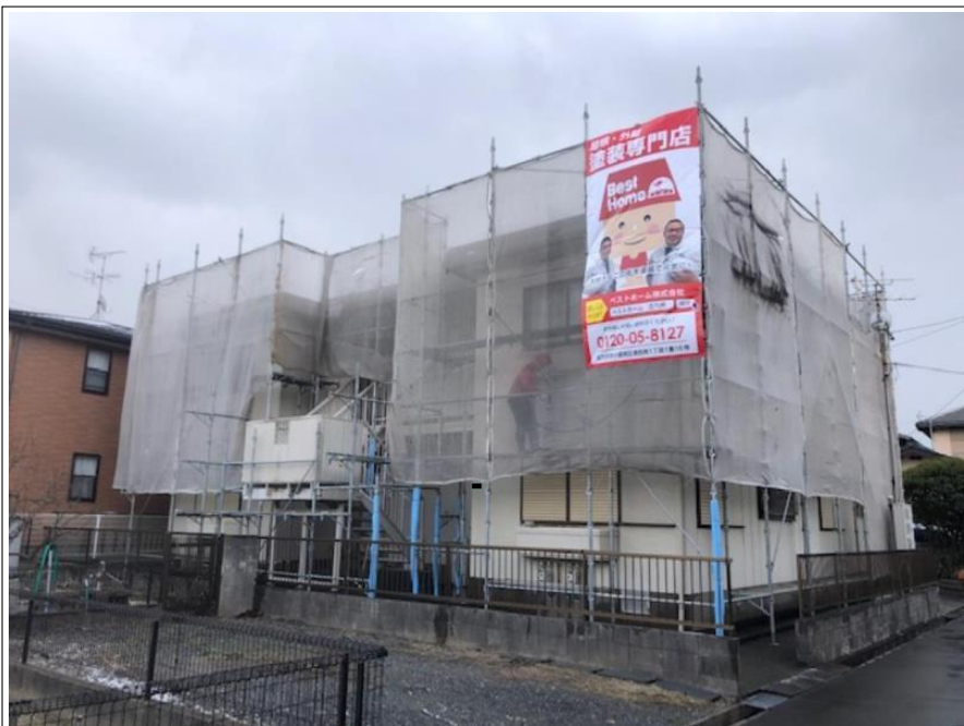
足場組立 完了
