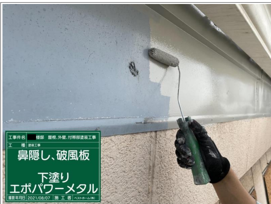
工事件名 ■ 棟部 屋根、外壁、付帯部塗装工事 工 種 塗装工事 鼻隠し、破風板 下塗り エポパワーメタル 撮影年月日 2021/08/07 施工者 ヘストホーム(株)
