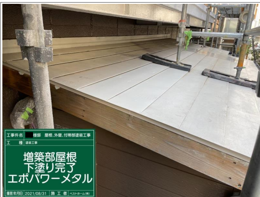
工事件名 ■ 棟部 屋根、外壁、付帯部塗装工事 工 種 塗装工事 増築部屋根 下塗り完了 エポパワーメタル 撮影年月日 2021/08/31 | 施 工 者 | ベストホーム(株)
