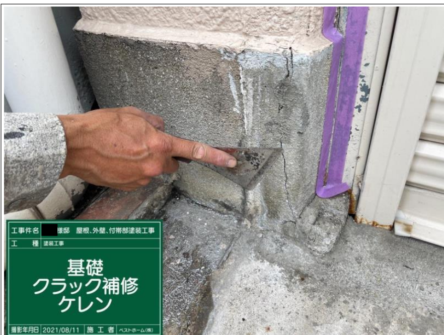
工事件名 様邸 屋根、外壁、付帯部塗装工事 工 種 塗装工事 基礎 クラック補修 ケレン 撮影年月日 2021/08/11 施 工 者 ベストホーム(株)
