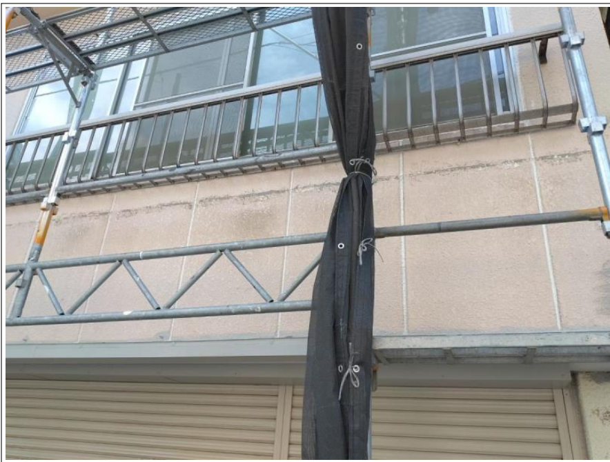
ボード目地シーリング部
