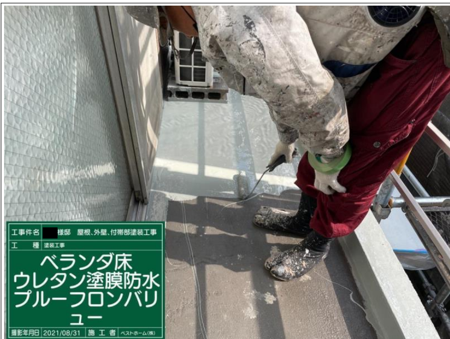
工事件名 ■ 様邸 屋根、外壁、付帯部塗装工事 工 種 塗装工事 ベランダ床 下塗り完了 プルーフロンプラ イマー 撮影年月日 2021/08/31 | 施 工 者 | ベストホーム(株)
