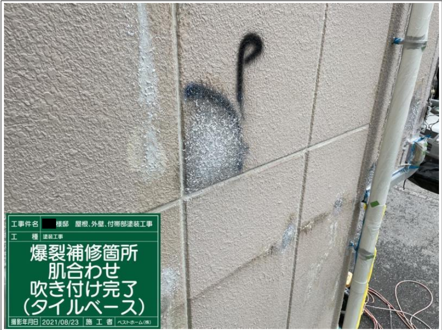
工事件名 ■ 様邸 屋根、外壁、付帯部塗装工事 工 種 塗装工事 爆裂補修箇所 肌合わせ 吹き付け完了 (タイルベース) 撮影年月日 2021/08/23 | 施 工 者 | ベストホーム(株)
