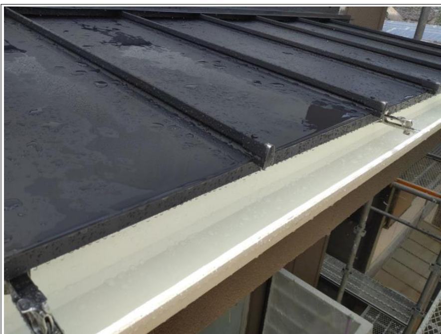
ベランダ庇取替工事
