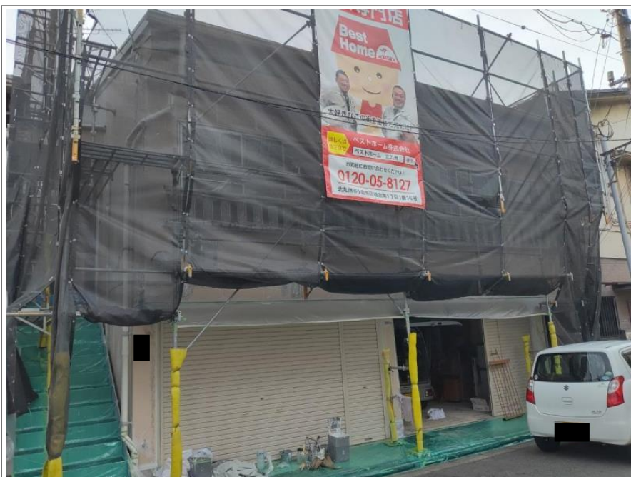
足場組立 完了
