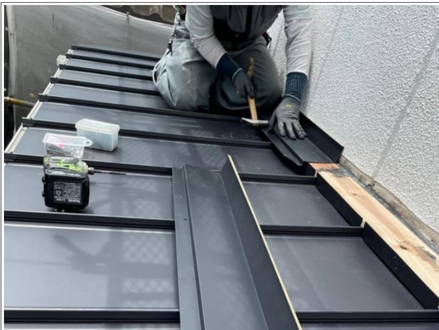
ベランダ庇取替工事
