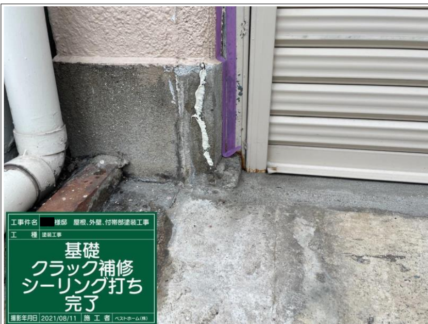
工事件名 ■ 様邸 屋根、外壁、付帯部塗装工事 工 種 塗装工事 基礎 クラック補修 シーリング打ち 完了 撮影年月日 2021/08/11 | 施 工 者 | ベストホーム(株)
