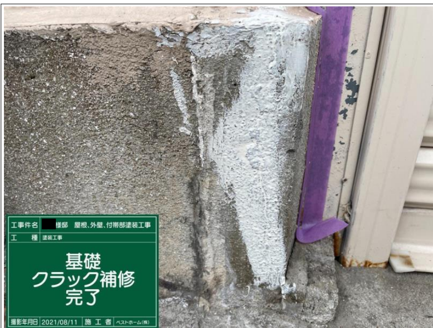
工事件名 様邸 屋根、外壁、付帯部塗装工事 工 種 塗装工事 基礎 クラック補修 ヘラ押さえ 撮影年月日 2021/08/11 施 工 者 ベストホーム(株)
