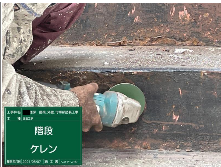
工事件名 棟部 屋根、外壁、付帯部塗装工事 工 種 塗装工事 階段 ケレン 撮影年月日 2021/08/07 施工者 ベストホーム(株)
