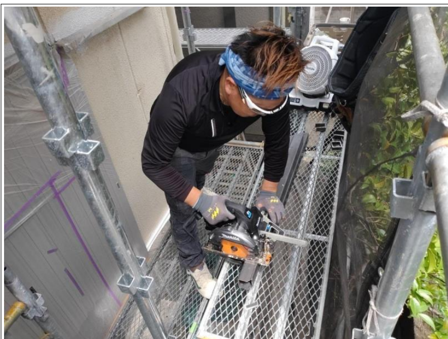
ベランダデッキ裏補強工事
