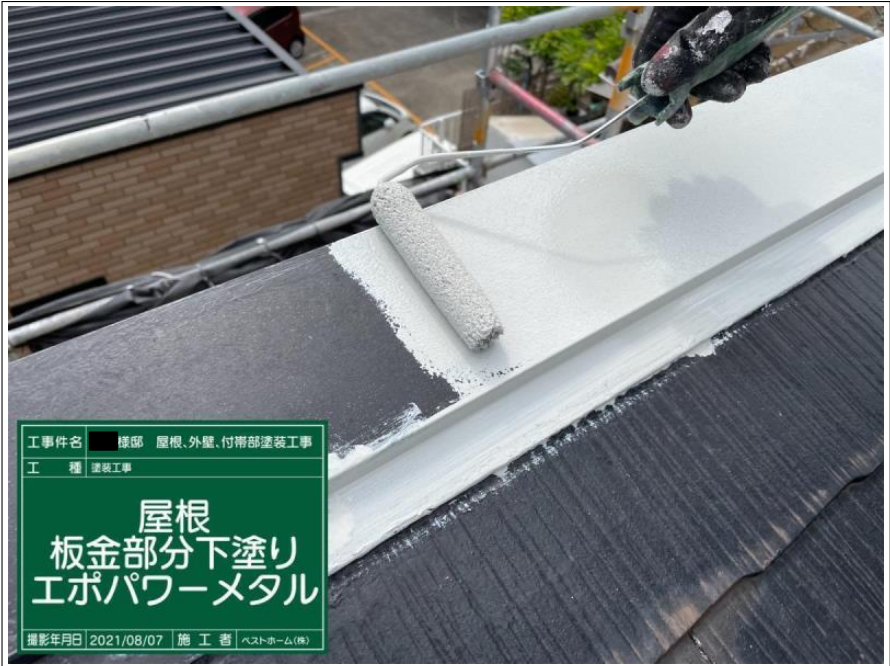
工事件名 様邸 屋根、外壁、付帯部塗装工事 工 種 塗装工事 屋根 板金部分下塗り エポパワーメタル 撮影年月日 2021/08/07 施工者 ヘストホーム(株)
