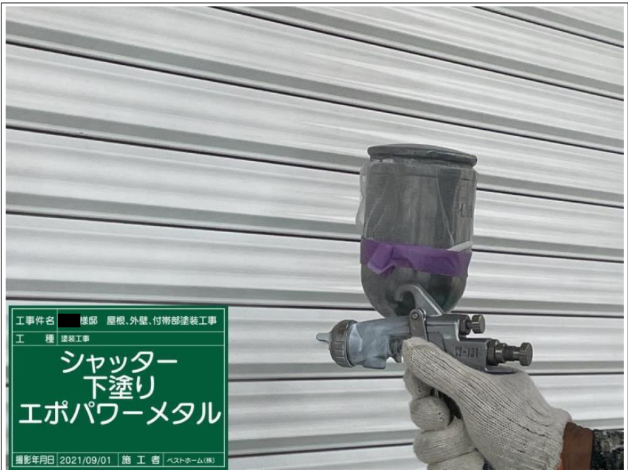
工事件名 ■ 様邸 屋根、外壁、付帯部塗装工事 工 種 塗装工事 シャッター 下塗り エポパワーメタル 撮影年月日 2021/09/01 | 施 工 者 ベストホーム(株)
