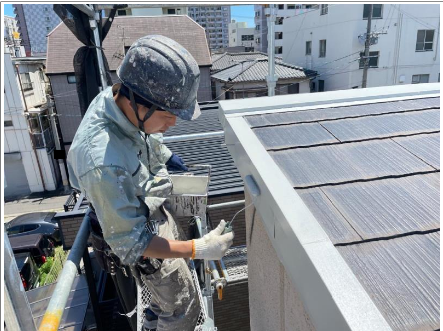
工事件名 様邸 屋根、外壁、付帯部塗装工事 工 種 塗装工事 屋根 板金部分下塗り エポパワーメタル 撮影年月日 2021/08/07 施工者 ヘストホーム(株)
