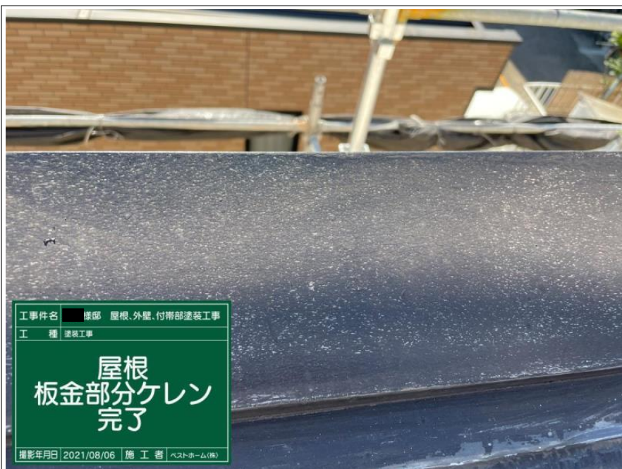
工事件名 様邸 屋根、外壁、付帯部塗装工事 工 種 塗装工事 屋根 板金部分ケレン 撮影年月日 2021/08/06 施 工 者 ベストホーム(株)
