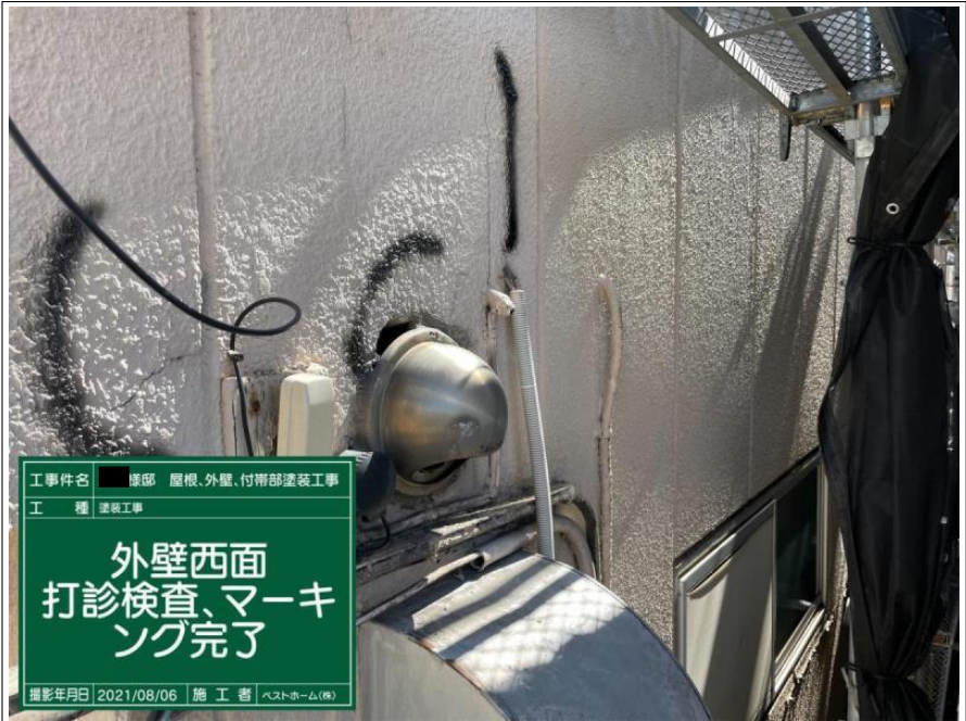
工事件名 ■ 様邸 屋根、外壁、付帯部塗装工事 工 種 塗装工事 外壁西面 補修箇所 マーキング 撮影年月日 2021/08/06 施 工 者 ベストホーム(株)
