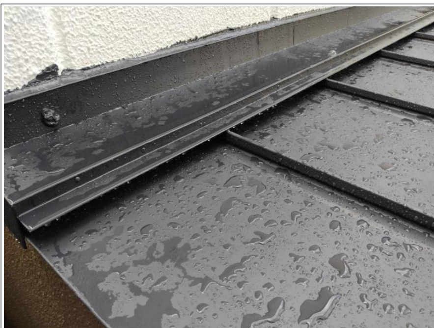
ベランダ庇取替工事
