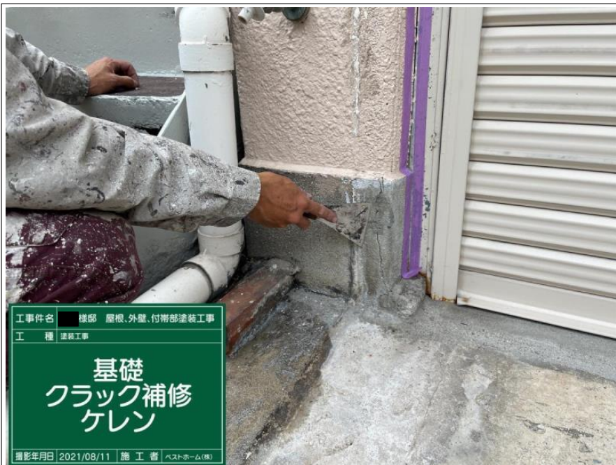
工事件名 様邸 屋根、外壁、付帯部塗装工事 工 種 塗装工事 基礎 クラック補修 着工前 撮影年月日 2021/08/11 施 工 者 ベストホーム(株)
