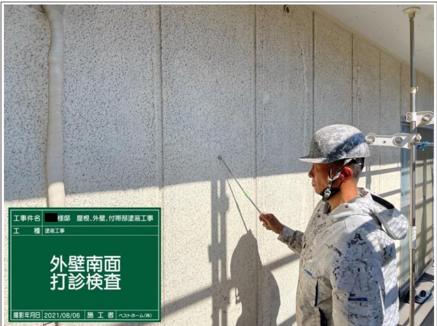
工事件名 ■ 様邸 屋根、外壁、付帯部塗装工事 工 種 塗装工事 外壁西面 打診検査、マーキ ング完了 撮影年月日 2021/08/06 施 工 者 ベストホーム(株)
