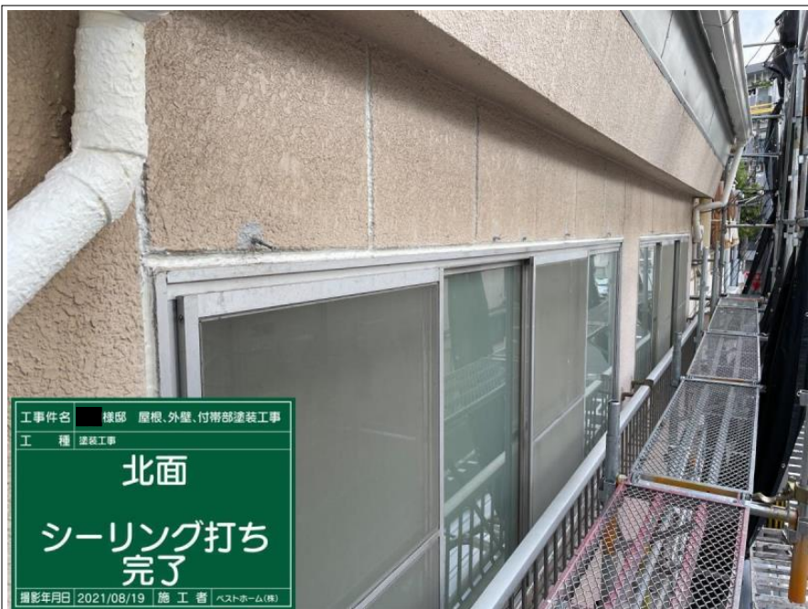
シーリング工事 北面
