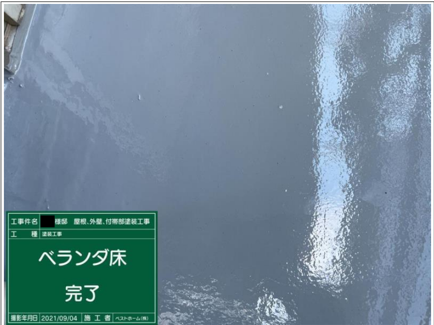
工事件名 様邸 屋根、外壁、付帯部塗装工事 工 種 塗装工事 ベランダ床 トップコート塗り GRTopp 撮影年月日 2021/09/01 施 工 者 ベストホーム(株)
