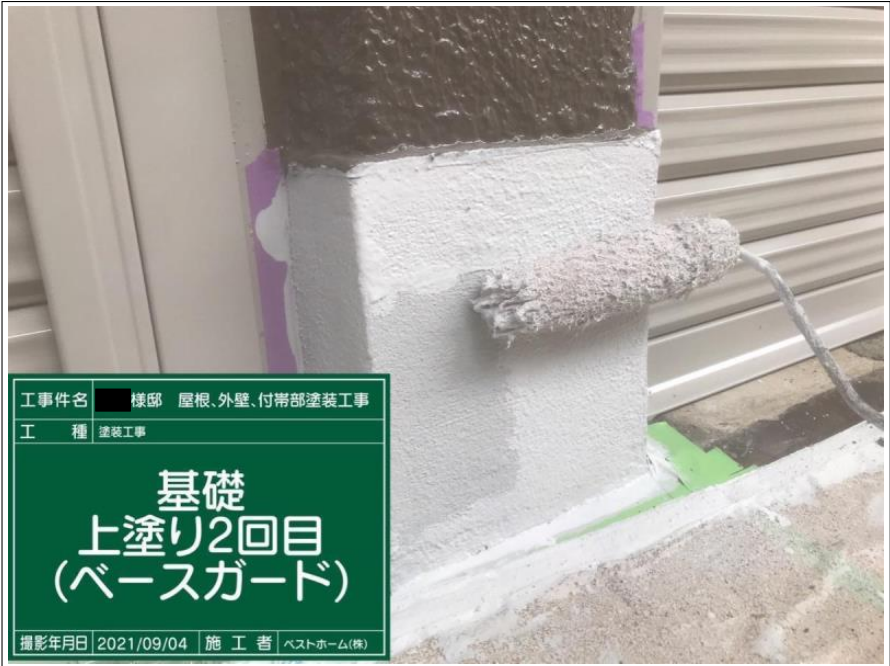
工事件名 ■ 様邸 屋根、外壁、付帯部塗装工事 工 種 塗装工事 基礎 上塗り2回目 (ベースガード) 撮影年月日 2021/09/04 施工者 ベストホーム(株)
