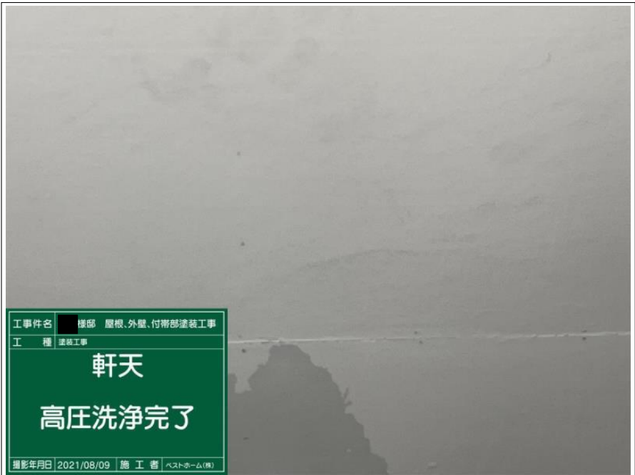
工事件名 棟部 屋根、外壁、付帯部塗装工事 工種 塗装工事 軒天 高圧洗浄完了 撮影年月日 2021/08/09 施工者 ベストホーム(株)
