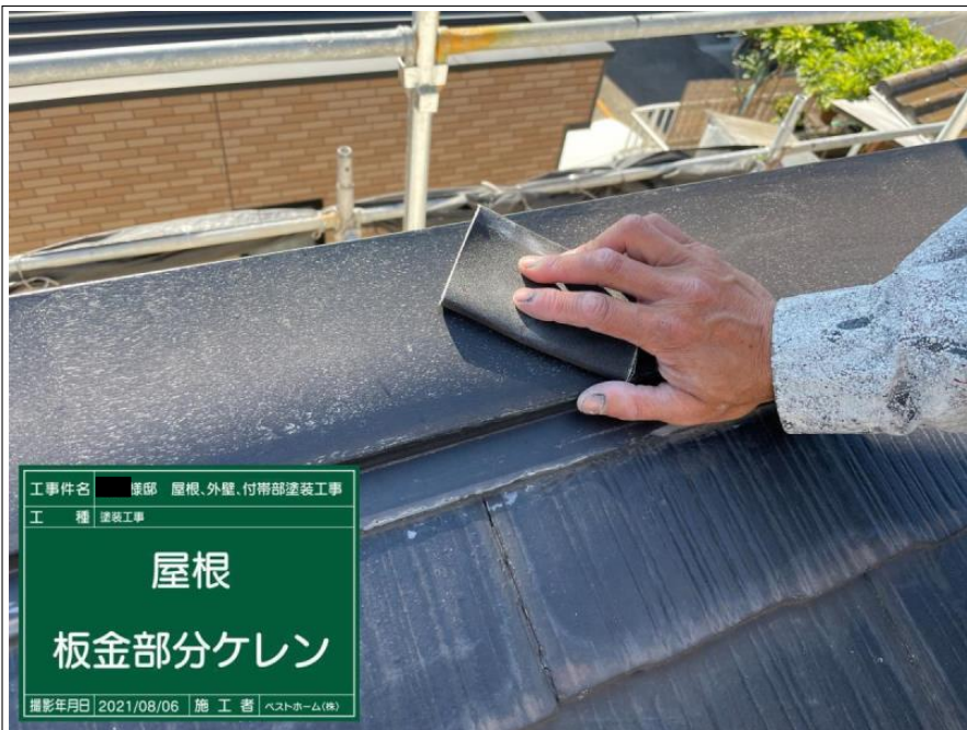
工事件名 様邸 屋根、外壁、付帯部塗装工事 工 種 塗装工事 屋根 板金部分ケレン 撮影年月日 2021/08/06 施 工 者 ベストホーム(株)
