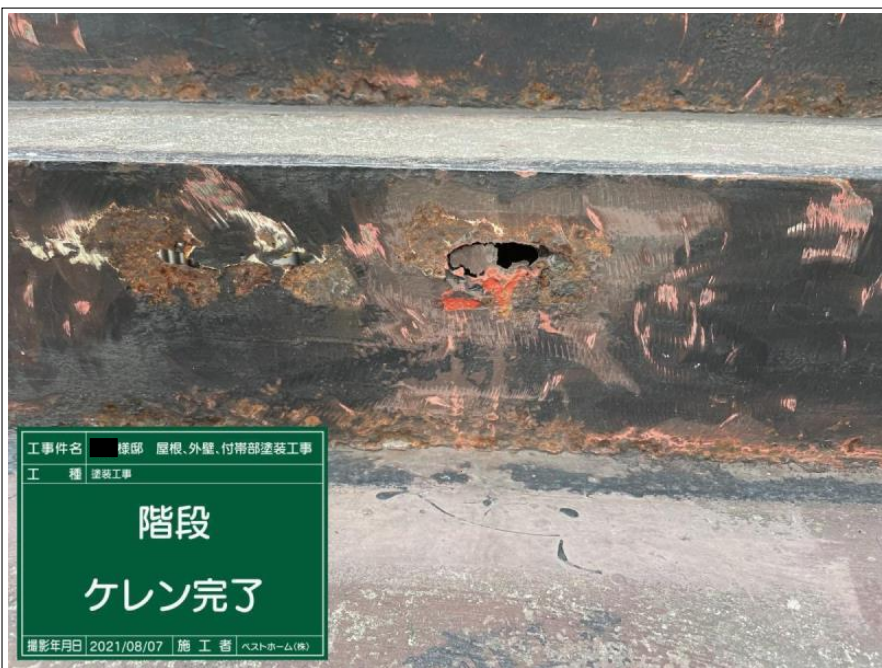
工事件名 棟部 屋根、外壁、付帯部塗装工事 工 種 塗装工事 階段 ケレン 撮影年月日 2021/08/07 施工者 ベストホーム(株)
