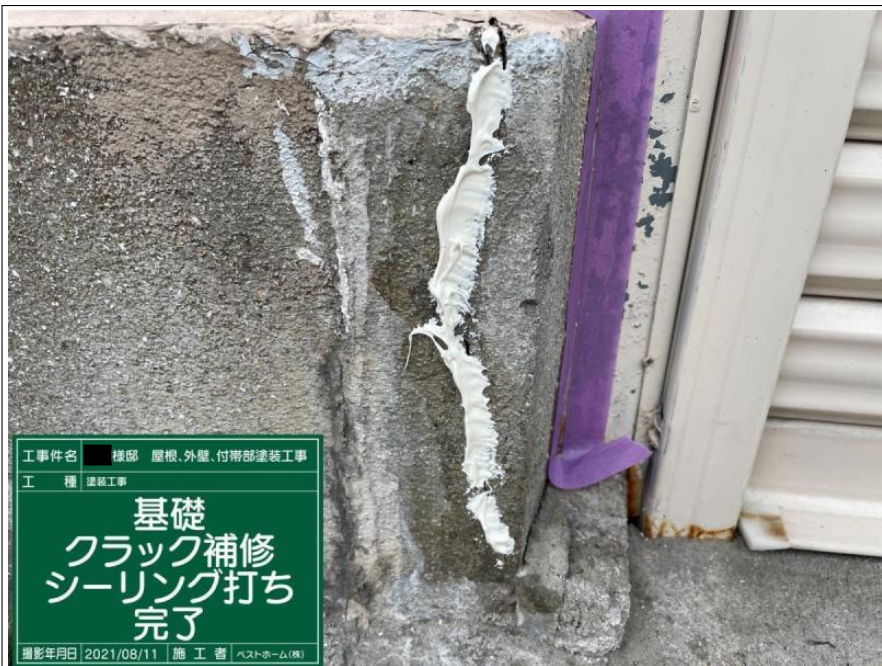
工事件名 ■ 様邸 屋根、外壁、付帯部塗装工事 工 種 塗装工事 基礎 クラック補修 シーリング打ち 撮影年月日 2021/08/11 | 施 工 者 | ベストホーム(株)
