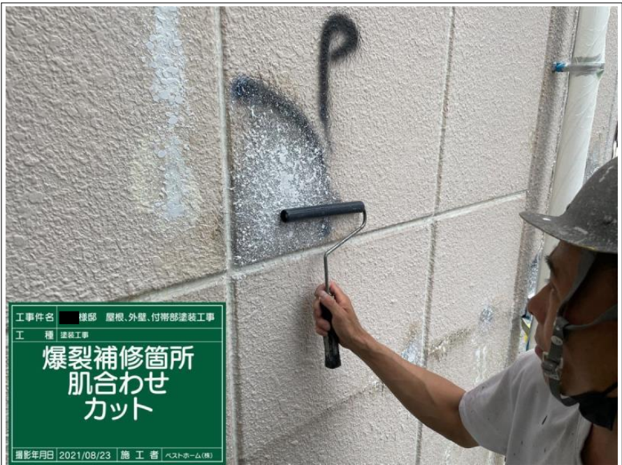
工事件名 ■ 様邸 屋根、外壁、付帯部塗装工事 工 種 塗装工事 爆裂補修箇所 肌合わせ 吹き付け完了 (タイルベース) 撮影年月日 2021/08/23 | 施 工 者 | ベストホーム(株)
