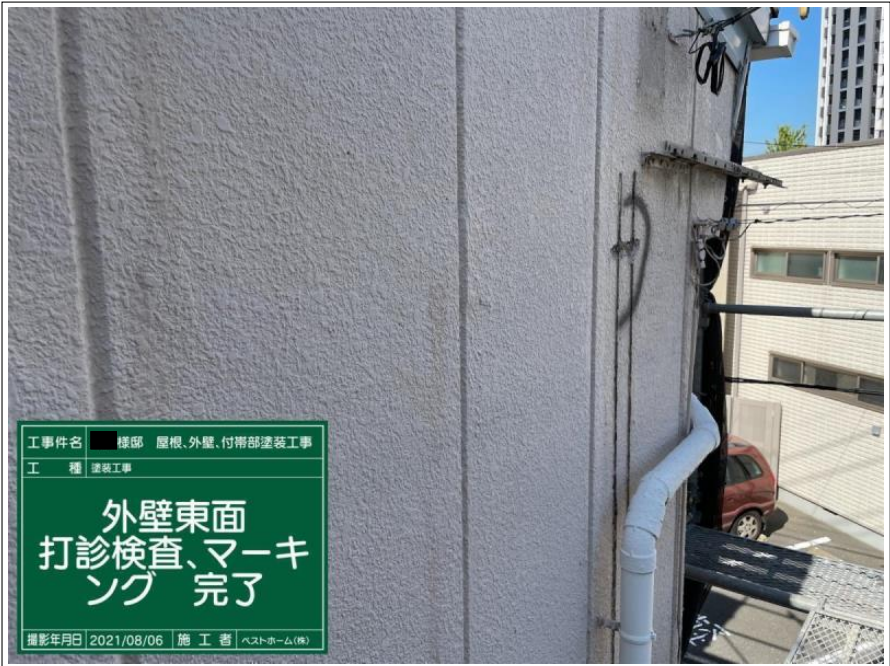
工事件名 ■ 棟部 屋根、外壁、付帯部塗装工事 工 種 塗装工事 外壁東面 補修箇所 マーキング 撮影年月日 2021/08/06 施工者 ペストホーム(株)
