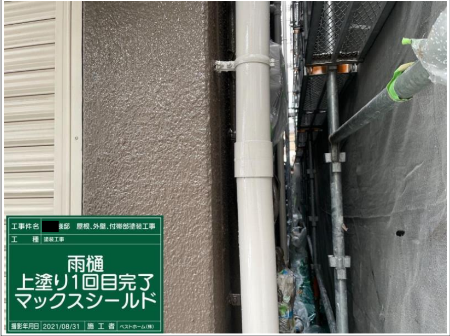
工事件名 ■ 棟部 屋根、外壁、付帯部塗装工事 工 種 塗装工事 雨樋 上塗り1回目完了 マックスシールド 撮影年月日 2021/08/31 施 工 者 ベストホーム(株)
