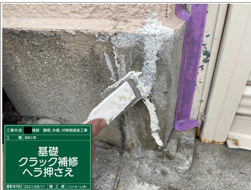
工事件名 様邸 屋根、外壁、付帯部塗装工事 工 種 塗装工事 基礎 クラック補修 ヘラ押さえ 撮影年月日 2021/08/11 施 工 者 ベストホーム(株)
