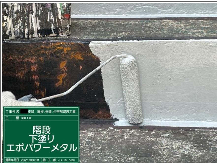
工事件名 様邸 屋根、外壁、付帯部塗装工事 工 種 塗装工事 階段 下塗り エポパワーメタル 撮影年月日 2021/08/10 施 工 者 ベストホーム(株)
