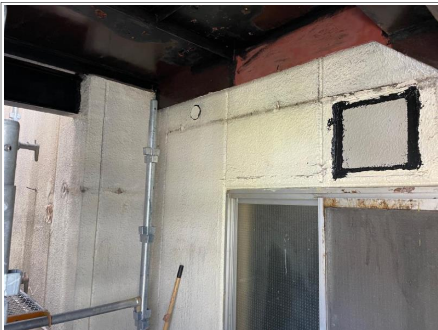
既存換気扇撤去工事
