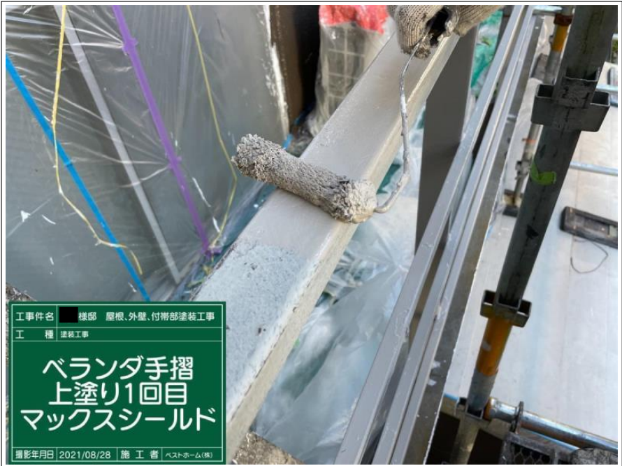
工事件名 ■ 様邸 屋根、外壁、付帯部塗装工事 工 種 塗装工事 ベランダ手摺 上塗り1回目 マックスシールド 撮影年月日 2021/08/28 施 工 者 ベストホーム(株)
