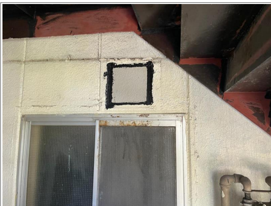
既存換気扇撤去工事
