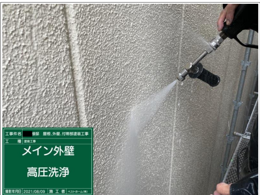
工 事 件 名 様邸 屋根、外壁、付帯部塗装工事 工 種 塗装工事 メイン外壁 高圧洗浄 撮影年月日 2021/08/09 施 工 者 ベストホーム(株)
