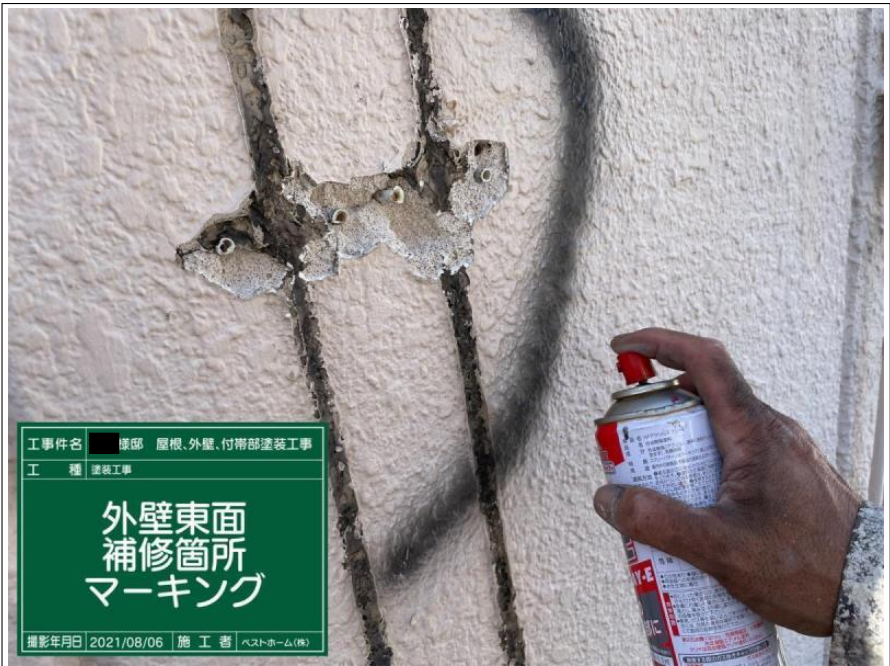
工事件名 ■ 棟部 屋根、外壁、付帯部塗装工事 工 種 塗装工事 外壁東面 補修箇所 マーキング 撮影年月日 2021/08/06 施工者 ペストホーム(株)
