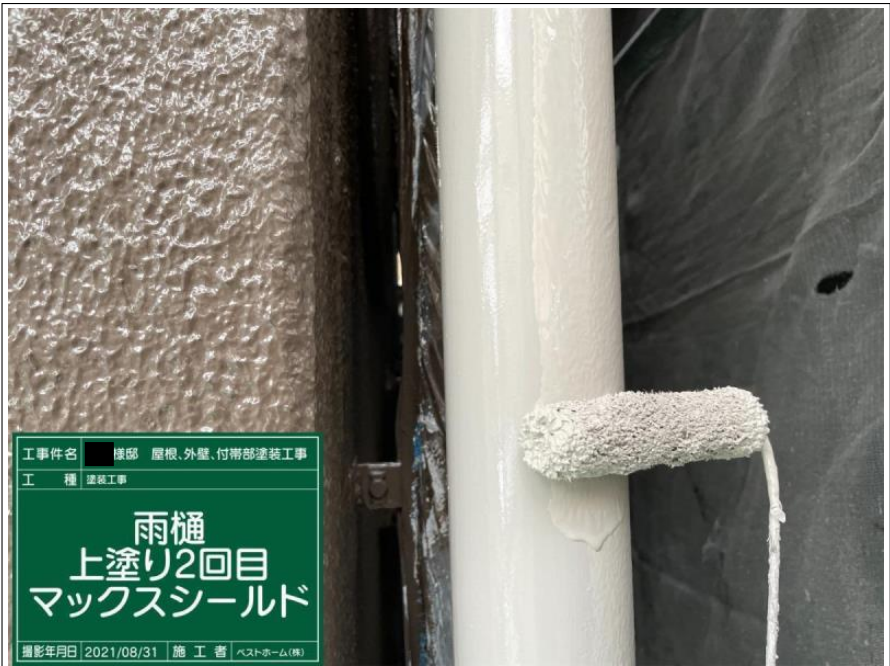
工事件名 棟部 屋根、外壁、付帯部塗装工事 工 種 塗装工事 雨樋 上塗り2回目 マックスシールド 撮影年月日 2021/08/31 施 工 者 ベストホーム(株)
