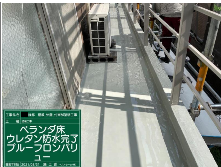
工事件名 様邸 屋根、外壁、付帯部塗装工事 工 種 塗装工事 ベランダ床 ウレタン防水完了 プルーフロンバリ ュー 撮影年月日 2021/08/31 施 工 者 ベストホーム(株)
