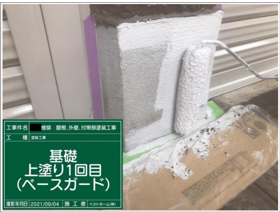
工事件名 ■ 様邸 屋根、外壁、付帯部塗装工事 工 種 塗装工事 基礎 上塗り1回目 (ベースガード) 撮影年月日 2021/09/04 施 工 者 ベストホーム(株)
