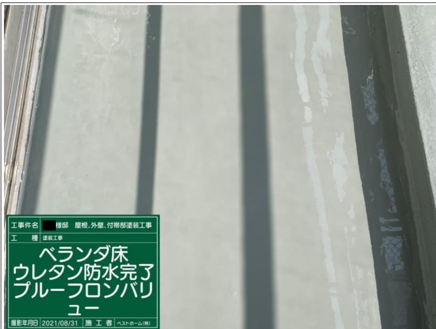
工事件名 様邸 屋根、外壁、付帯部塗装工事 工 種 塗装工事 ベランダ床 ウレタン塗膜防水 プルーフロンバリ ュー 撮影年月日 2021/08/31 施 工 者 ベストホーム(株)
