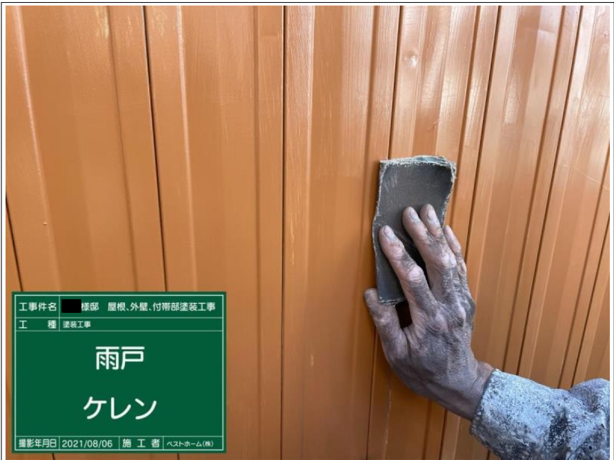
工事件名 様邸 屋根、外壁、付帯部塗装工事 工 種 塗装工事 雨戸 ケレン 撮影年月日 2021/08/06 施 工 者 ベストホーム(株)
