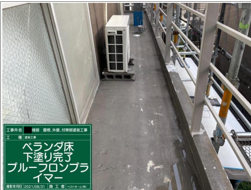
工事件名 ■ 様邸 屋根、外壁、付帯部塗装工事 工 種 塗装工事 ベランダ床 下塗り プルーフロンプラ イマー 撮影年月日 2021/08/30 | 施 工 者 | ベストホーム(株)
