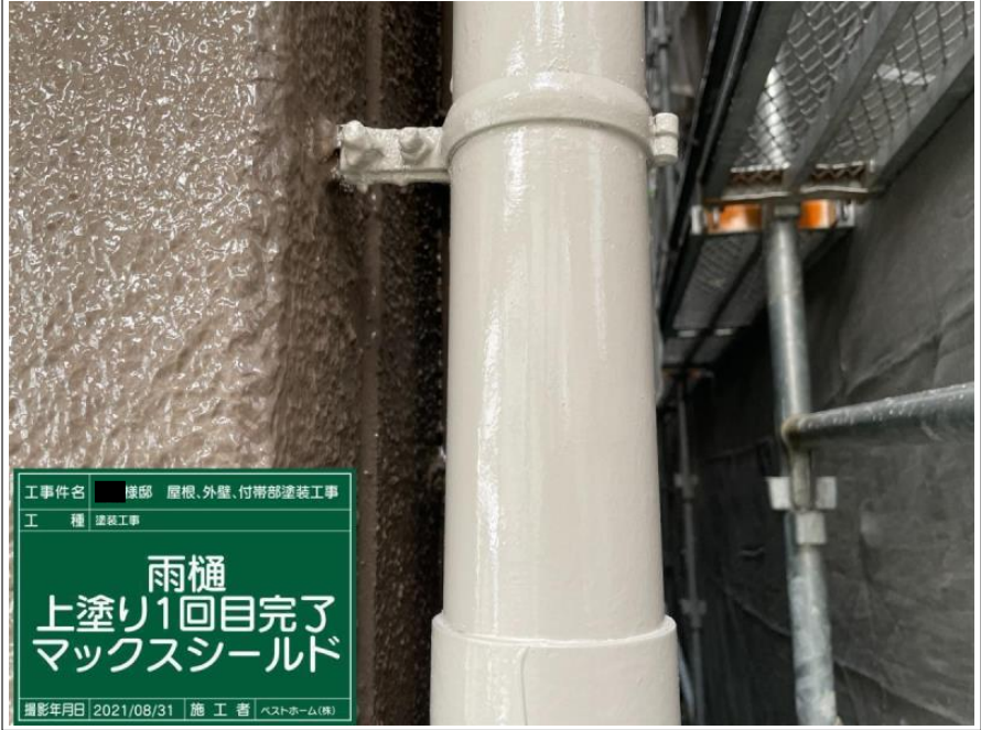
工事件名 ■ 棟部 屋根、外壁、付帯部塗装工事 工 種 塗装工事 雨樋 上塗り1回目 マックスシールド 撮影年月日 2021/08/31 施 工 者 ベストホーム(株)
