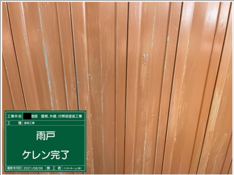
工事件名 様邸 屋根、外壁、付帯部塗装工事 工 種 塗装工事 雨戸 ケレン 撮影年月日 2021/08/06 施 工 者 ベストホーム(株)
