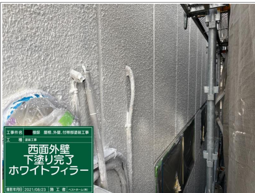
工事件名 棟部 屋根、外壁、付帯部塗装工事 工 種 塗装工事 北面外壁 下塗り完了 ホワイトフィラー 撮影年月日 2021/08/23 施 工 者 ベストホーム(株)
