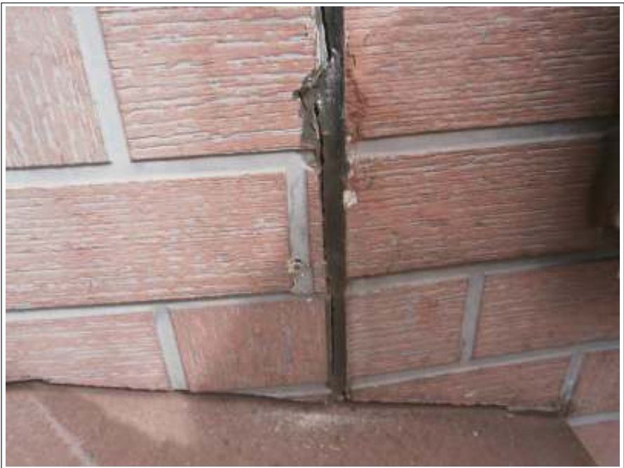
コーキング補修施工前
