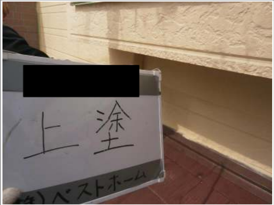
外壁上塗り施工完了 (2階)
