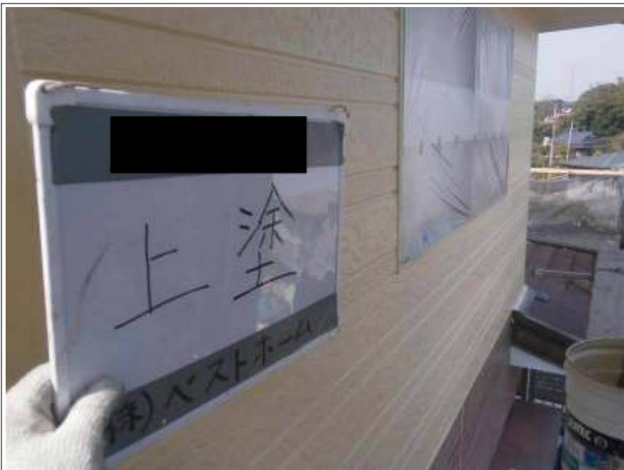
外壁上塗り施工完了 (2階)
