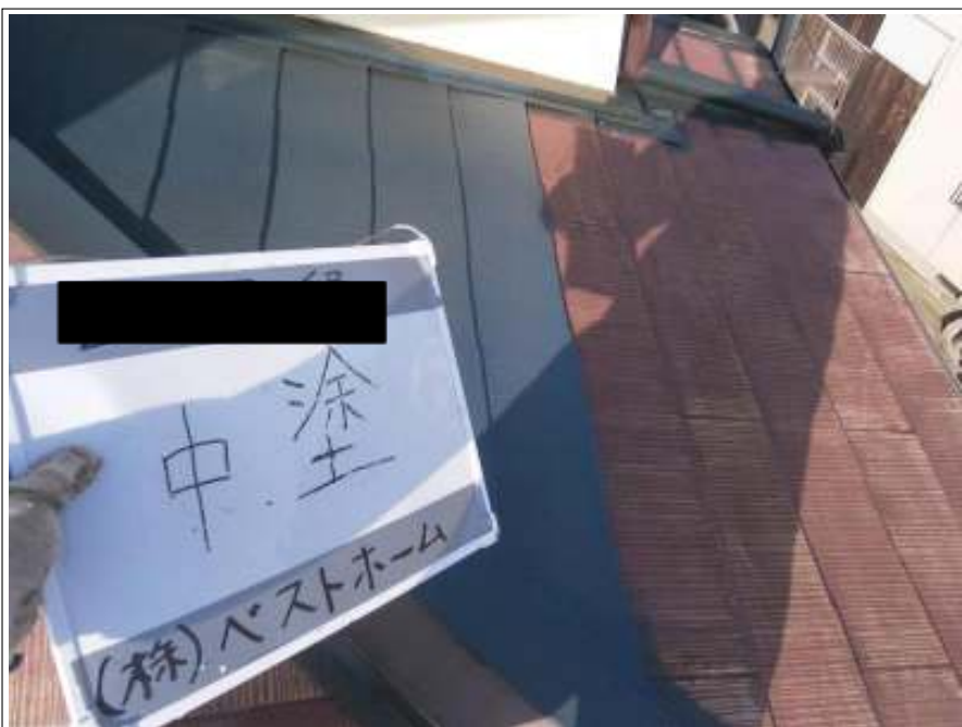
屋根中塗り施工中
