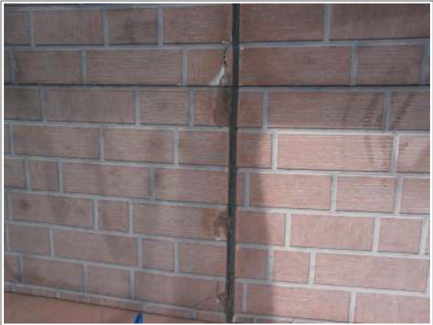
コーキング補修施工前
