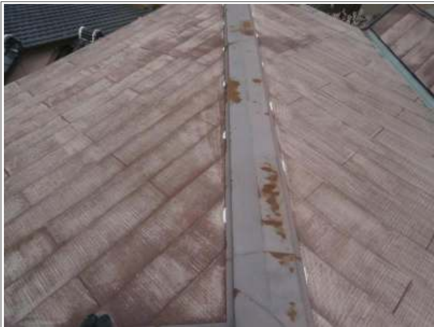
屋根ラバー止め施工完了
