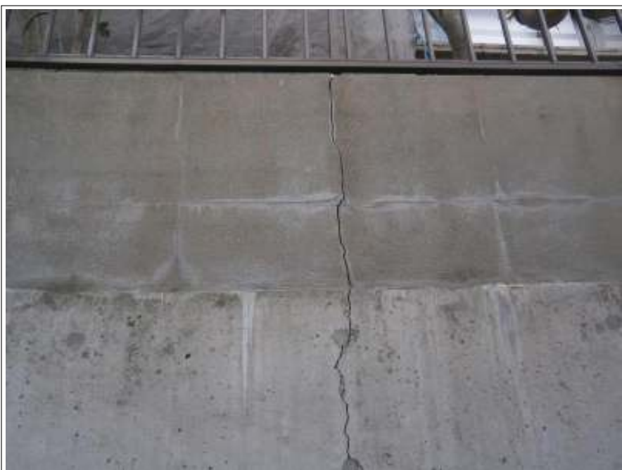
塀補修施工前
