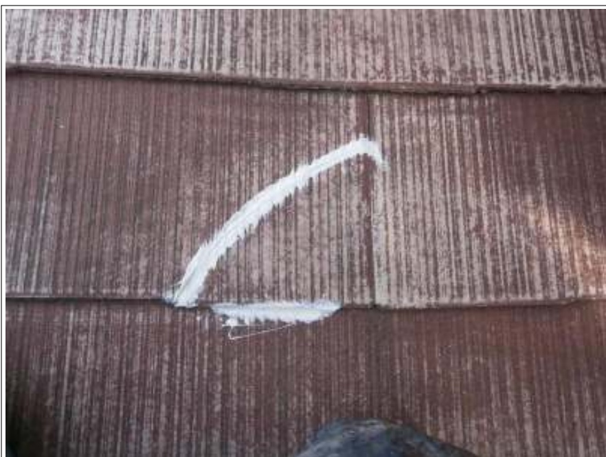
屋根破損部補修施工完了
