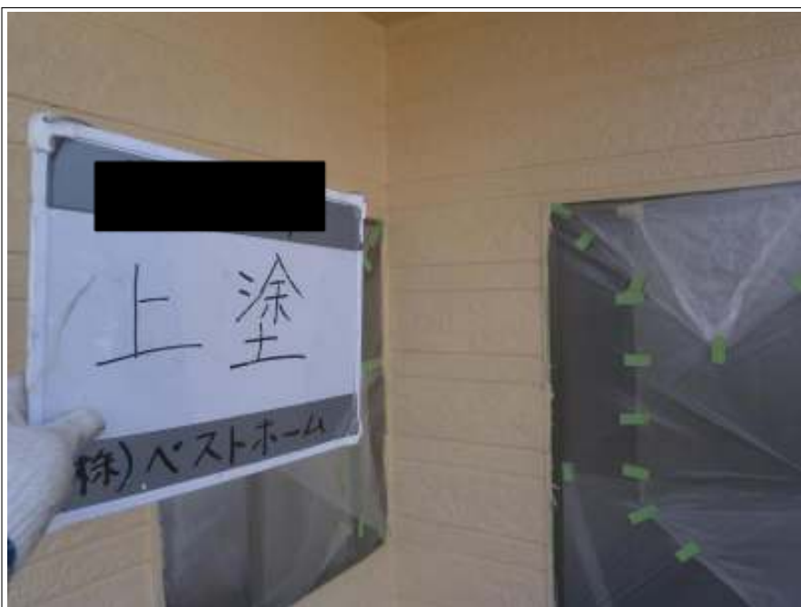
外壁上塗り施工完了 (2階)
