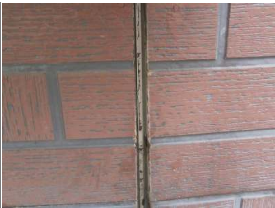
コーキング補修施工前
