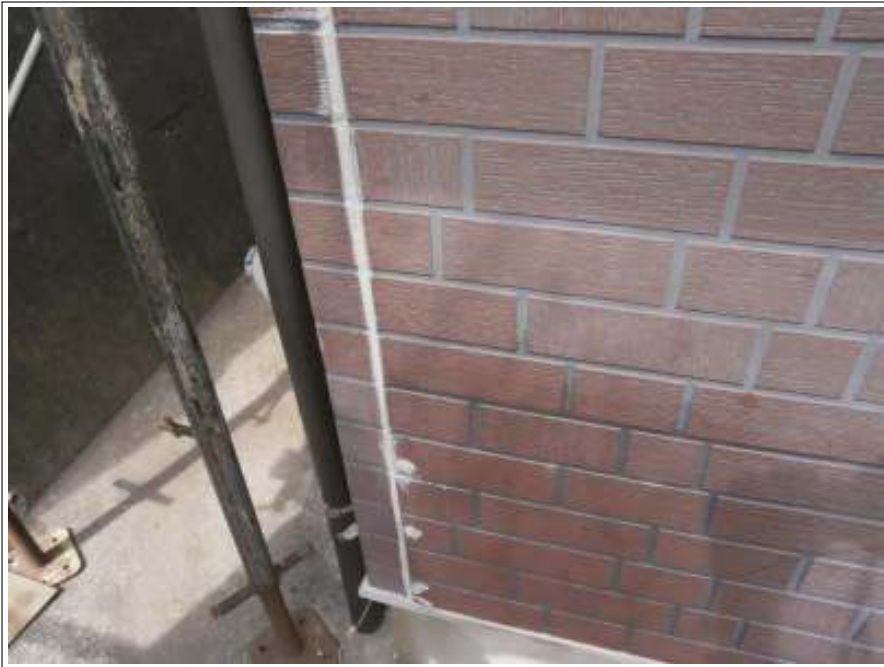
コーキング補修施工完了
