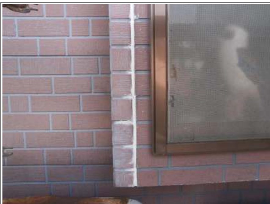
コーキング補修施工完了
