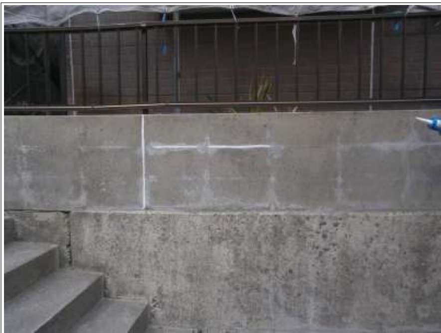
塀補修施工完了
