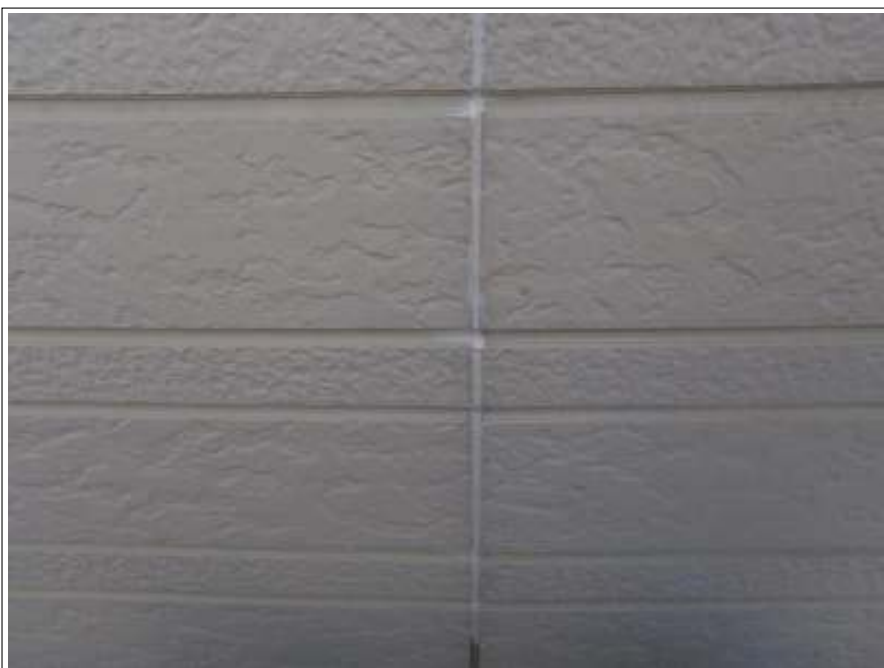
コーキング補修施工完了
