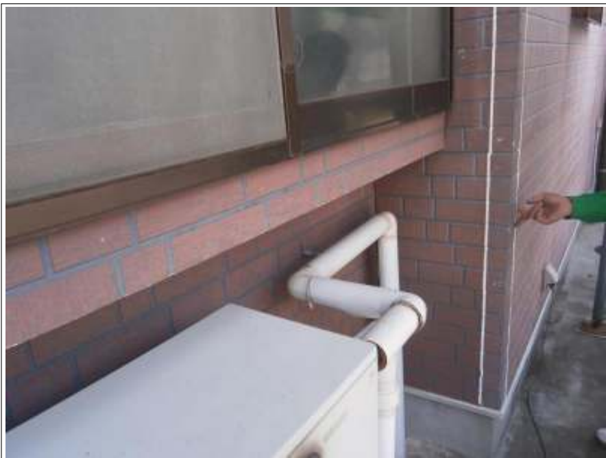
コーキング補修施工完了
