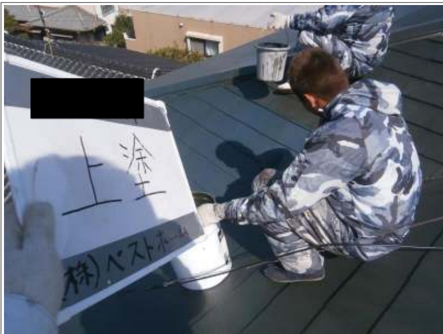
屋根上塗り施工状況
