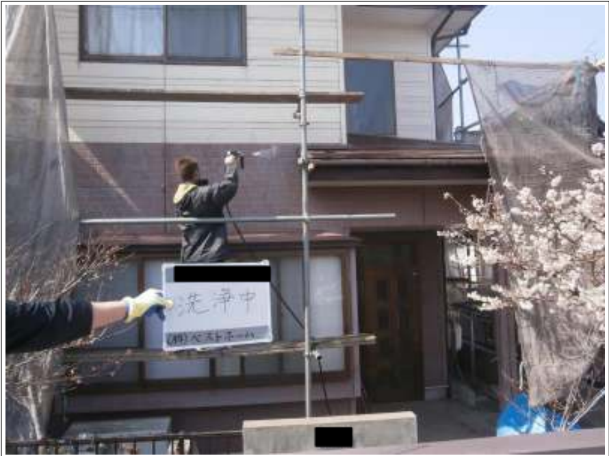
外壁高圧洗浄施工状況
