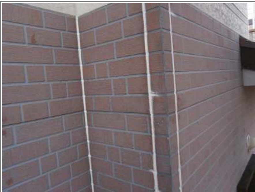
コーキング補修施工完了
