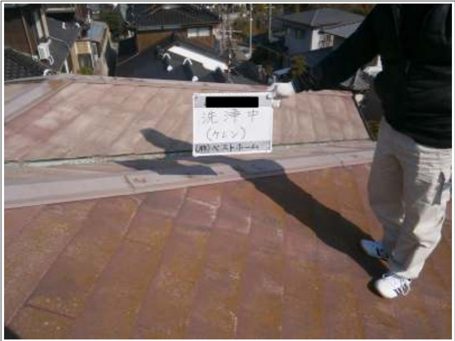
屋根ケレン作業施工状況
