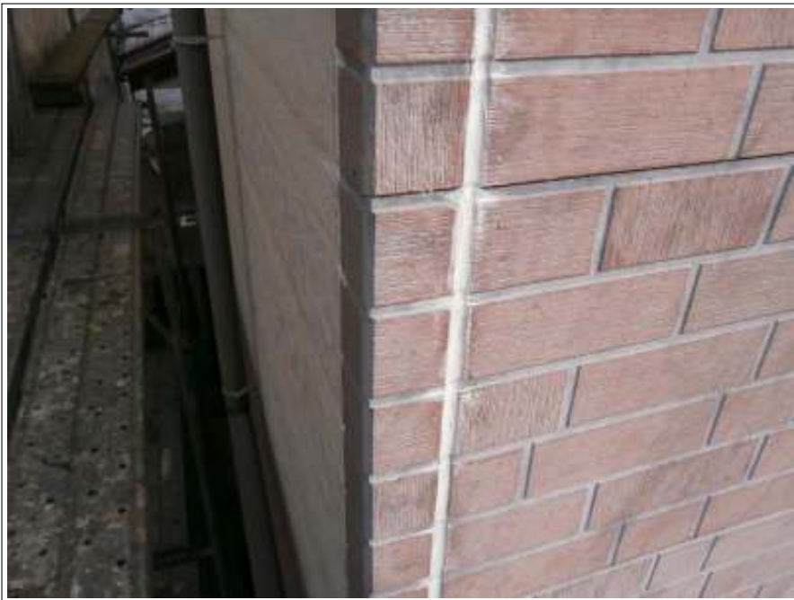
コーキング補修施工完了
