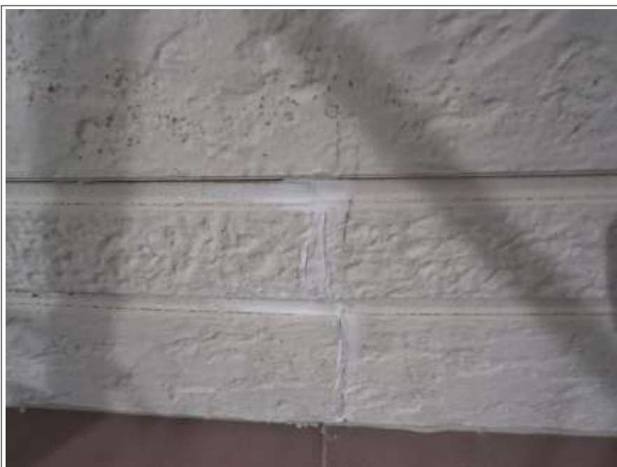
コーキング補修施工完了
