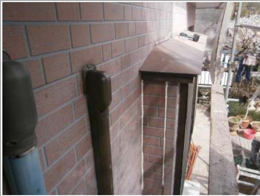
コーキング補修施工完了
