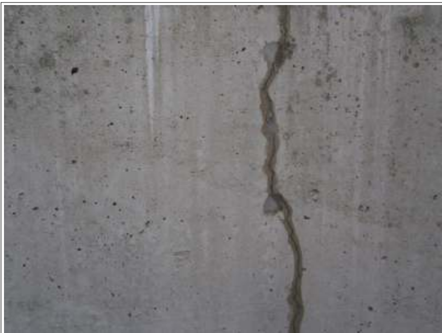
塀補修施工完了
