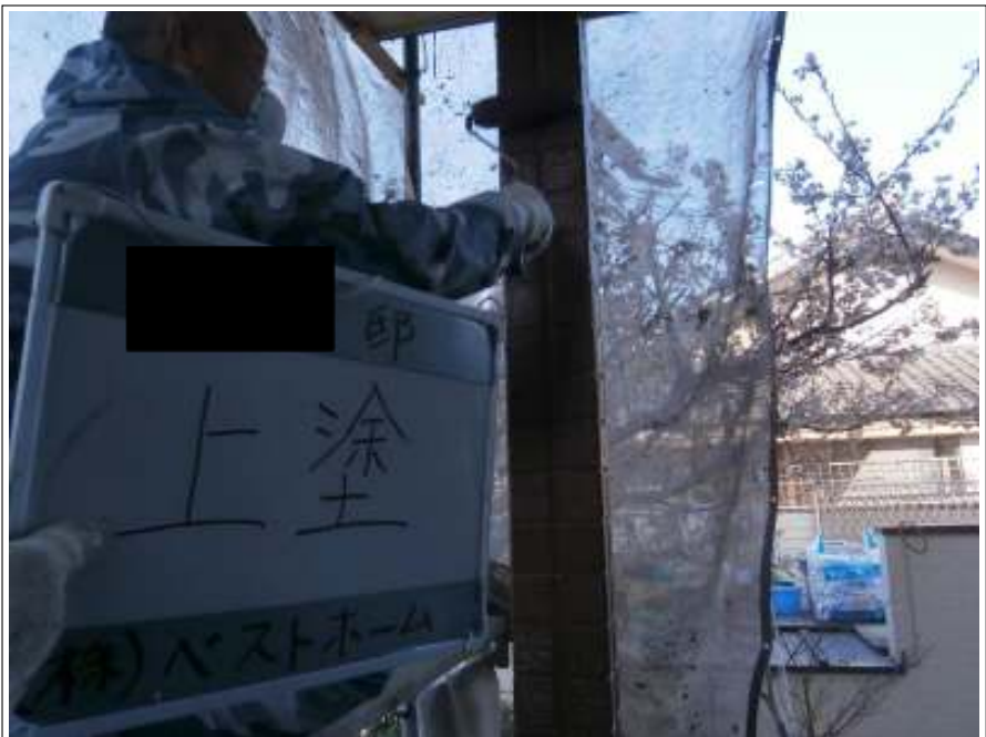
外壁上塗り施工中 (1階)
