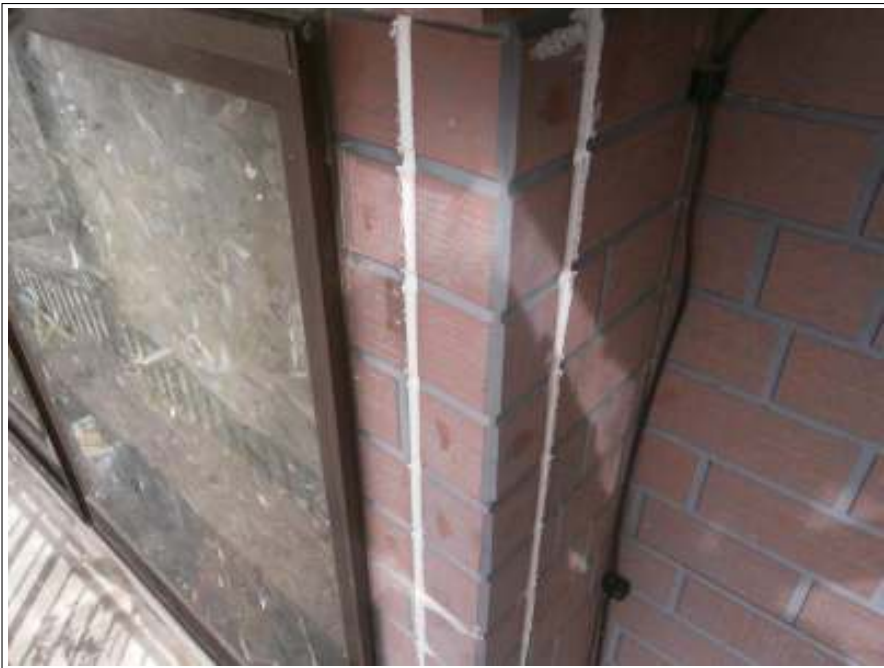
コーキング補修施工完了
