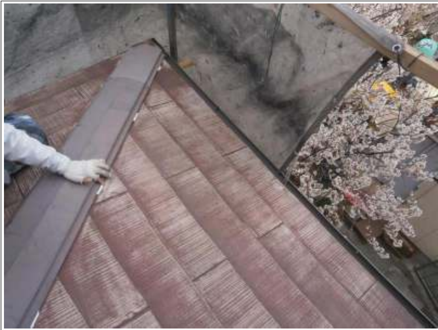
屋根ラバー止め施工状況
