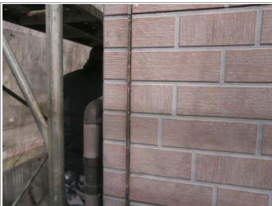
コーキング補修施工前
