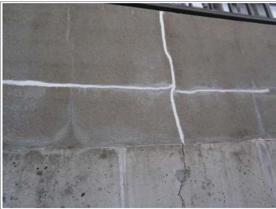
塀補修施工完了
