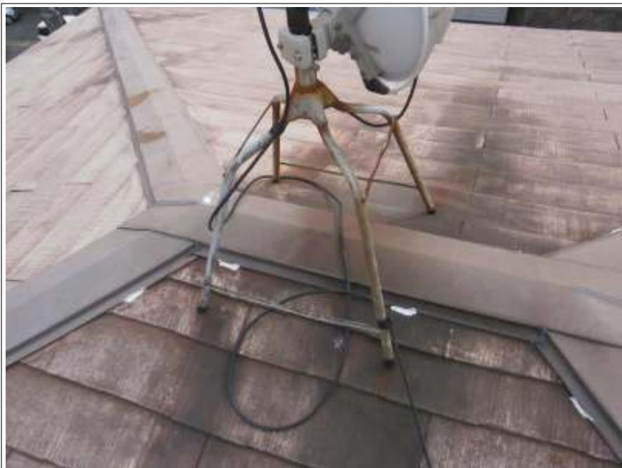
屋根ラバー止め施工完了
