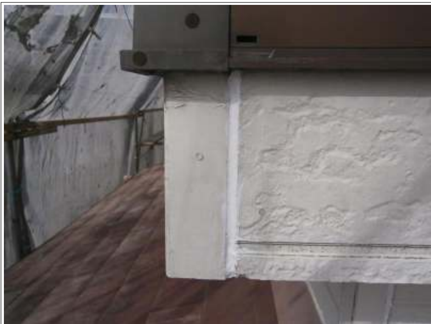
コーキング補修施工完了
