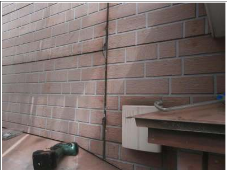
コーキング補修施工前
