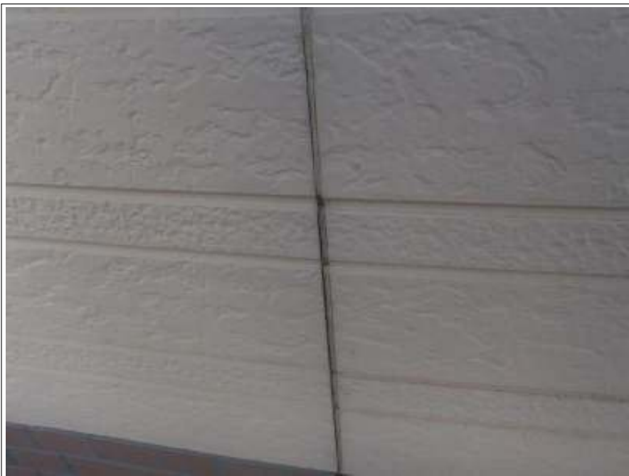
コーキング補修施工前
