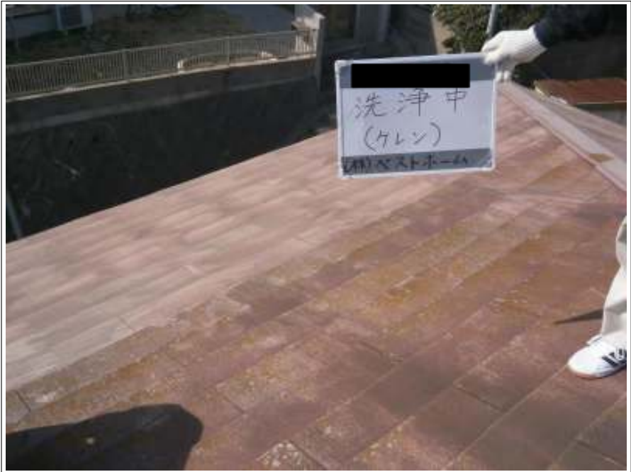
屋根ケレン作業施工中
