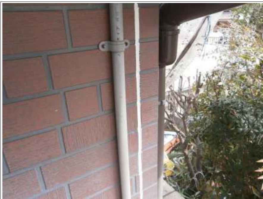
コーキング補修施工完了
