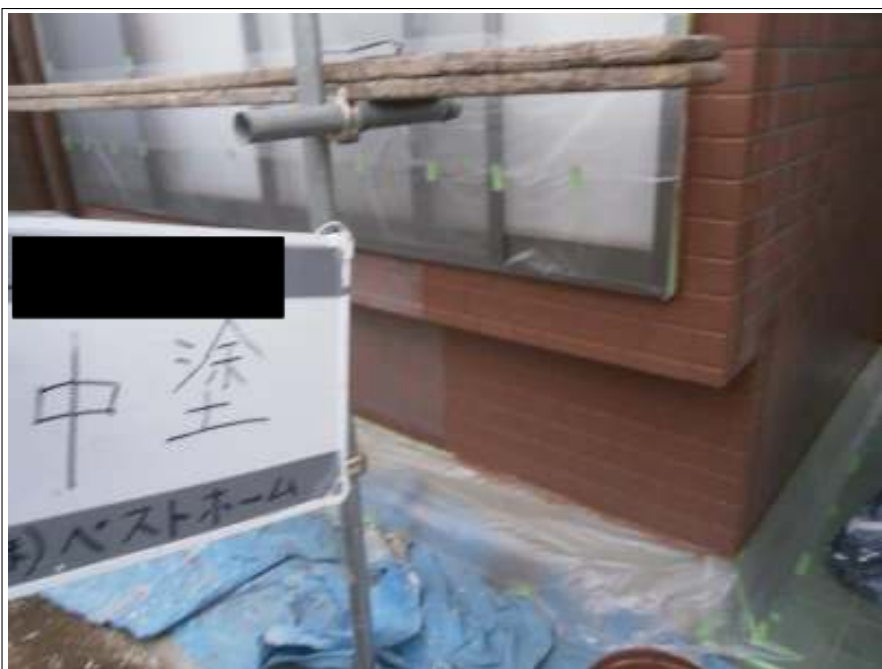
外壁中塗り施工状況 (1階)
