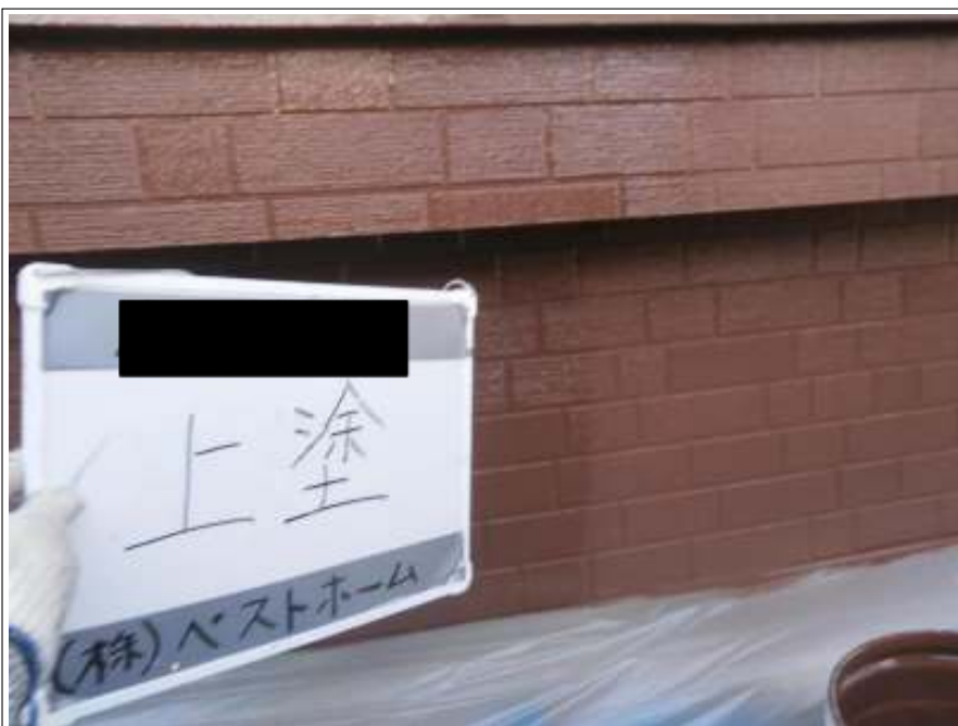
外壁上塗り施工状況 (1階)
