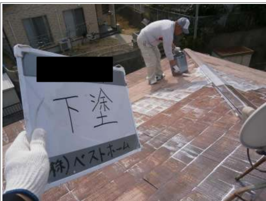
屋根下塗り施工状況
