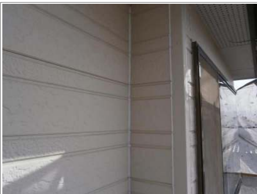
コーキング補修施工完了
