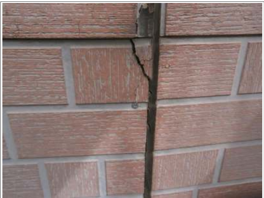
コーキング補修施工前
