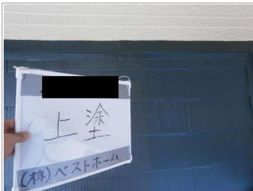
屋根上塗り施工完了
