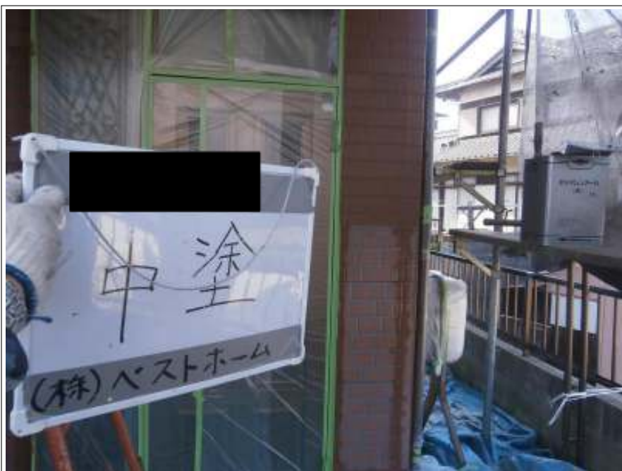
外壁中塗り施工中 (1階)
