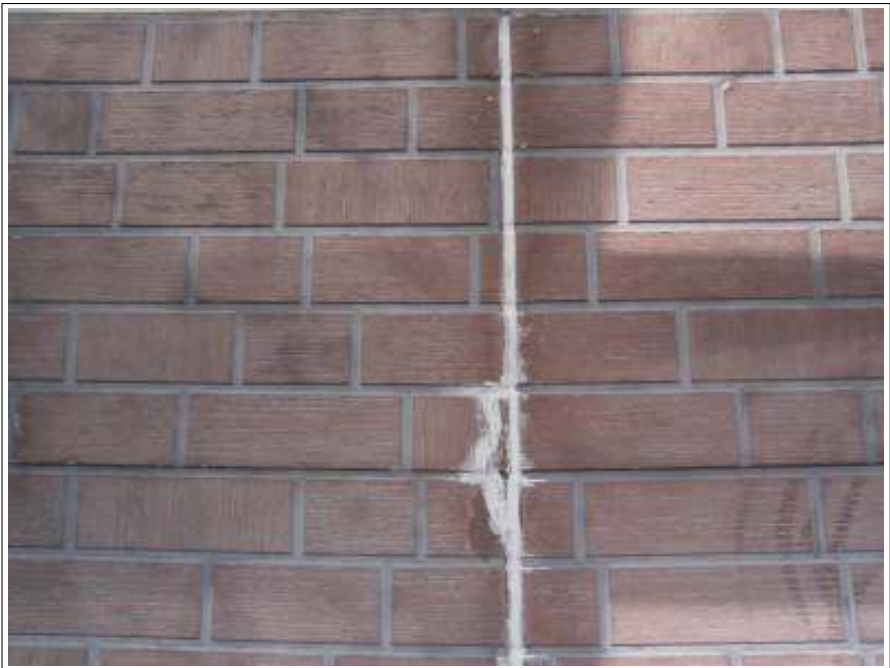
コーキング補修施工完了
