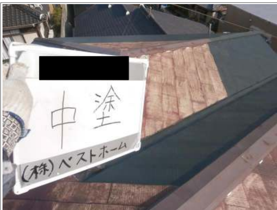
屋根中塗り施工中
