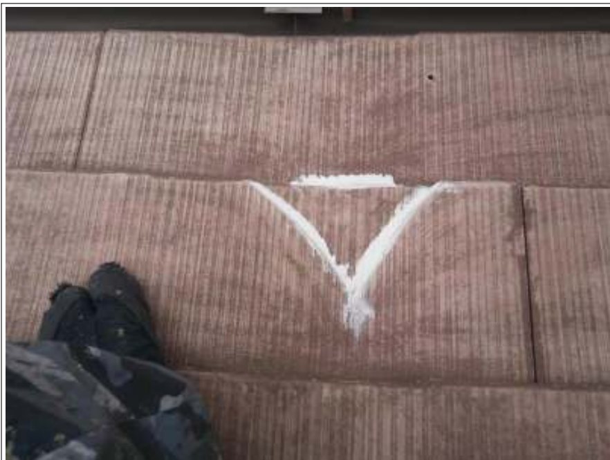
屋根破損部補修施工完了
