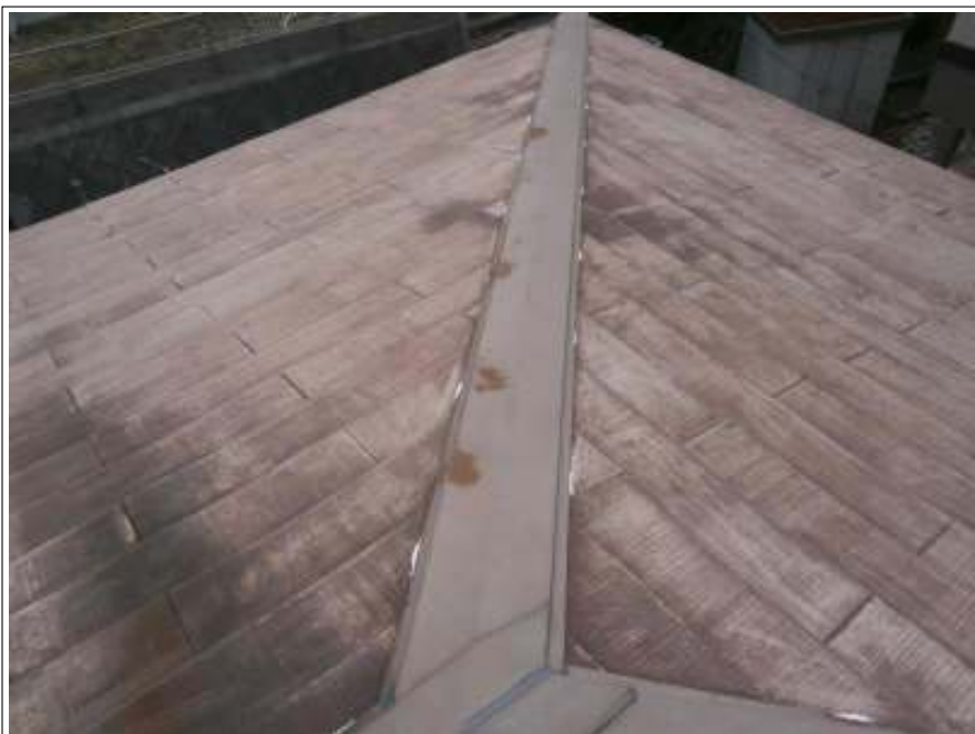
屋根ラバー止め施工完了
