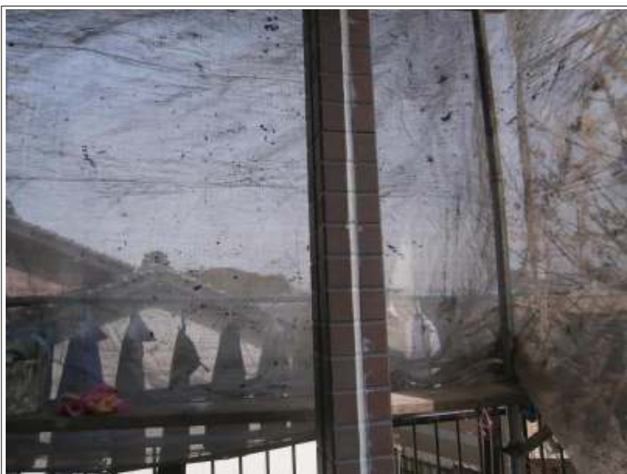
コーキング補修施工完了
