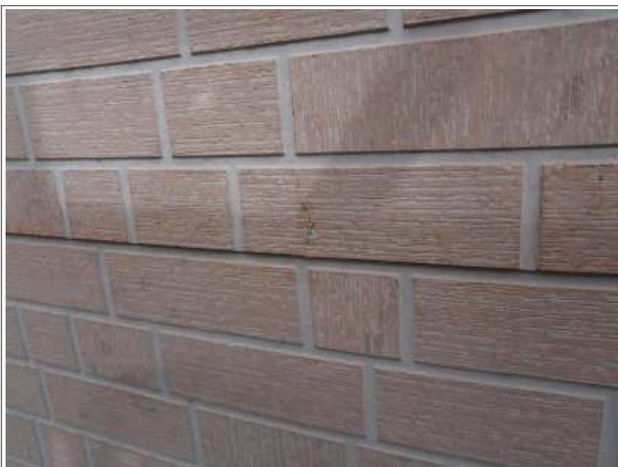
コーキング補修施工前
