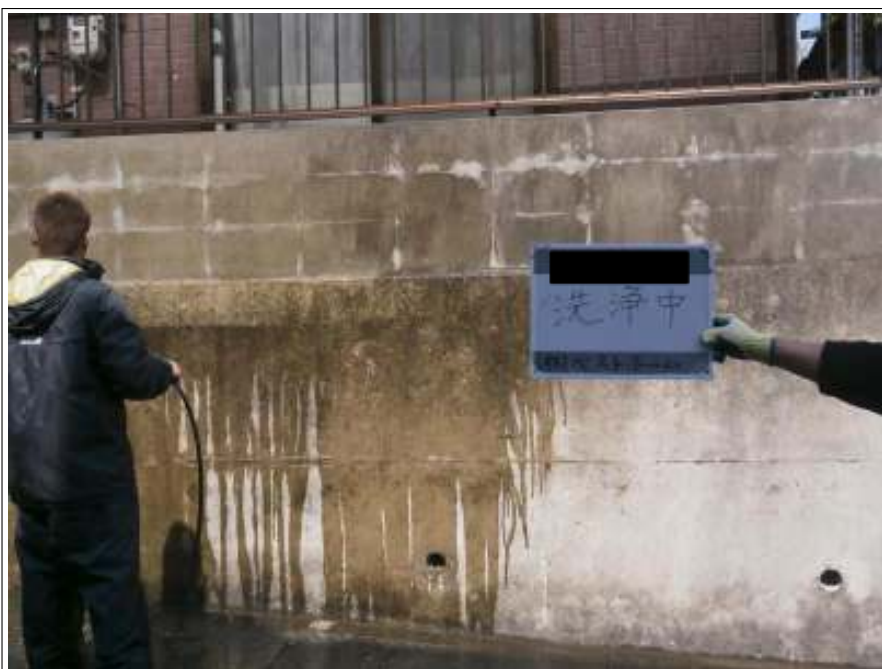
塀高圧洗浄施工状況
