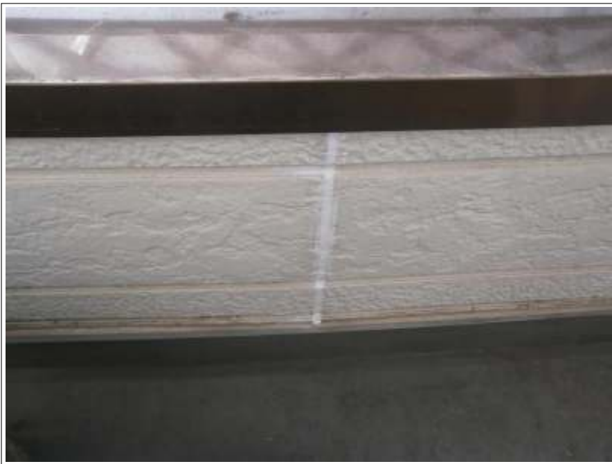
コーキング補修施工完了
