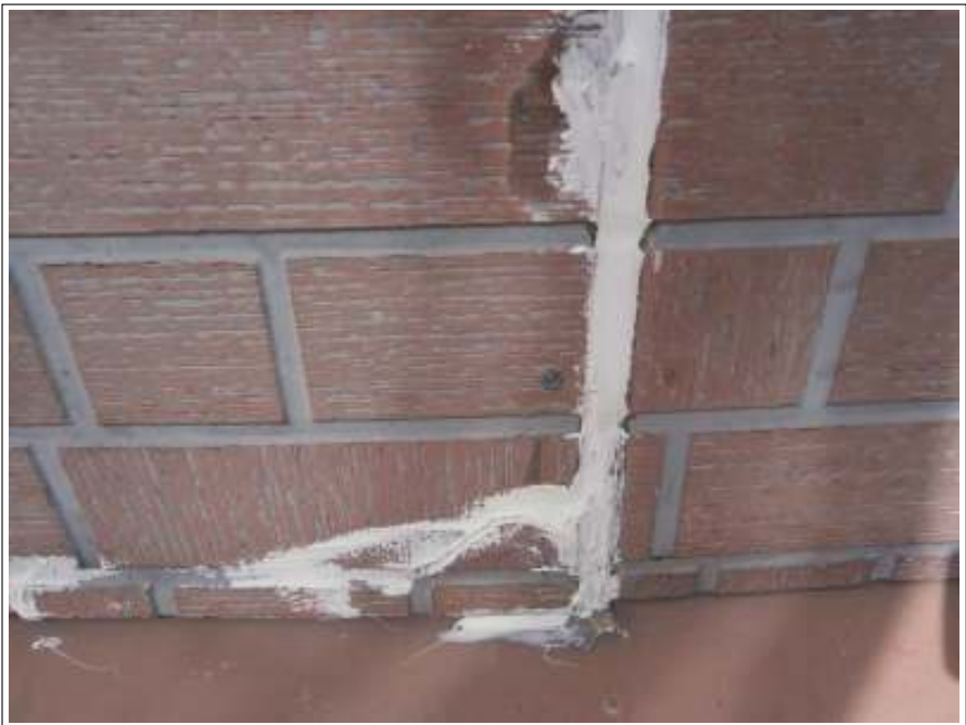
コーキング補修施工完了
