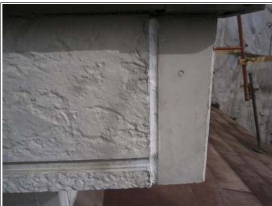
コーキング補修施工完了
