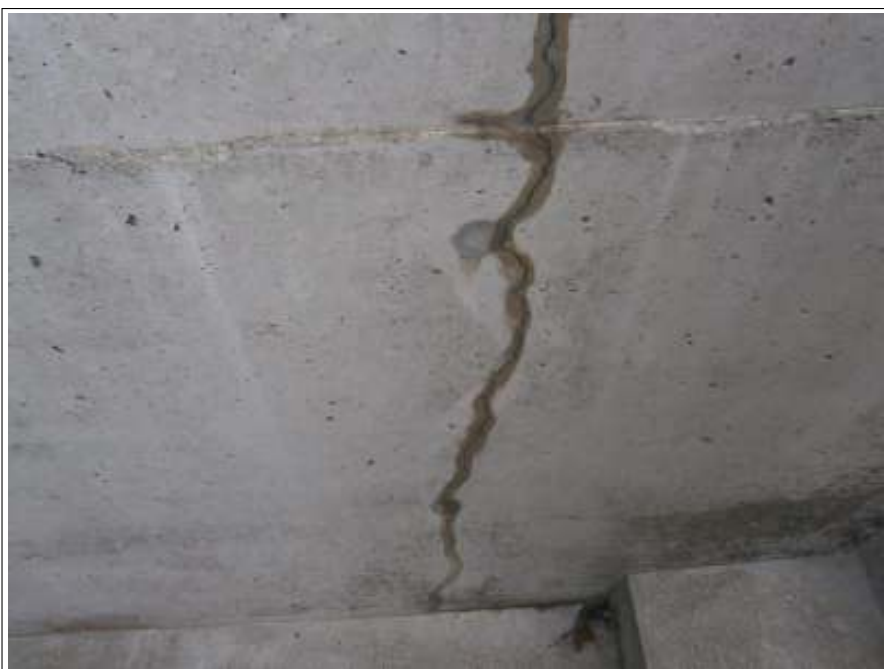
塀補修施工完了
