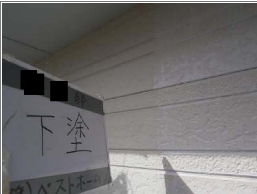
外壁下塗り施工状況
