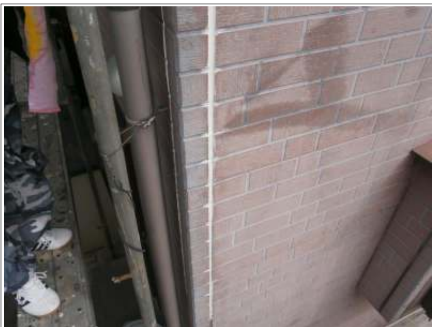
コーキング補修施工完了
