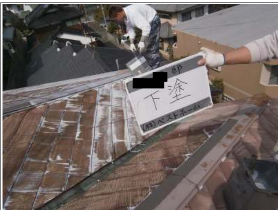
屋根下塗り施工中
