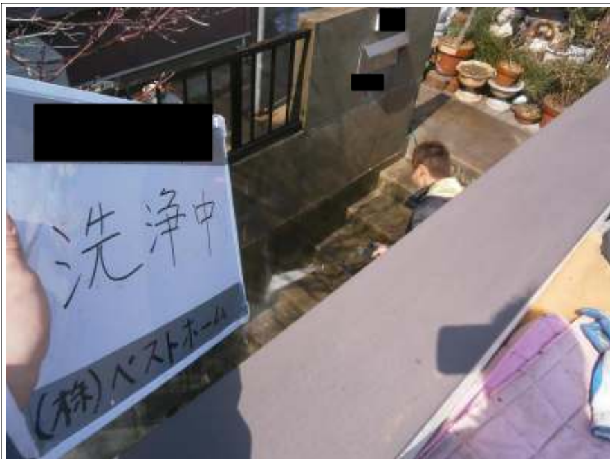
階段部高圧洗浄施工状況
