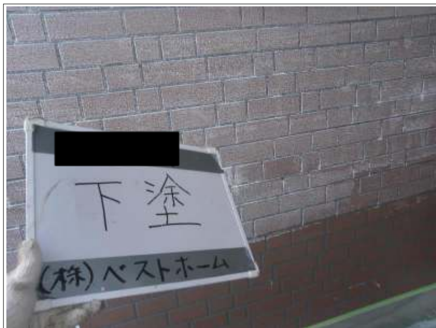
外壁下塗り施工状況
