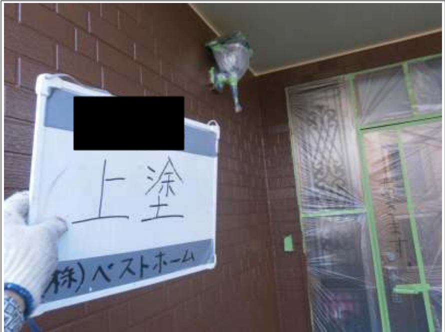
外壁上塗り施工完了 (1階)
