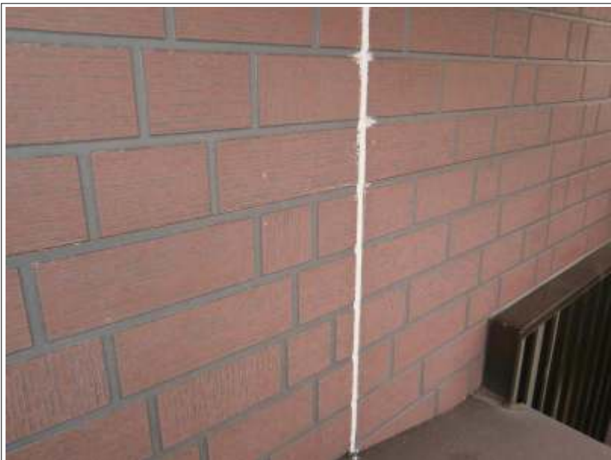
コーキング補修施工完了
