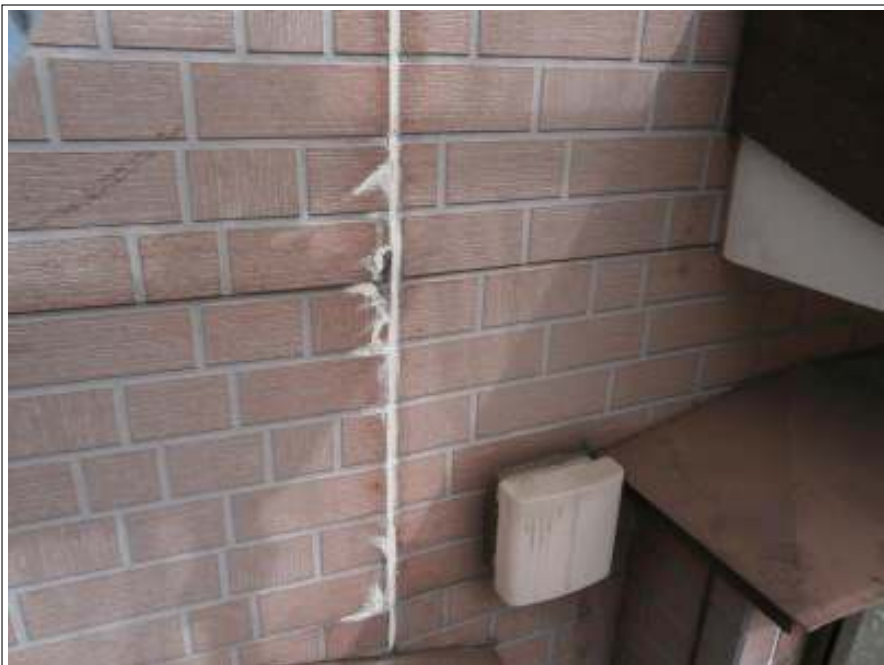
コーキング補修施工完了
