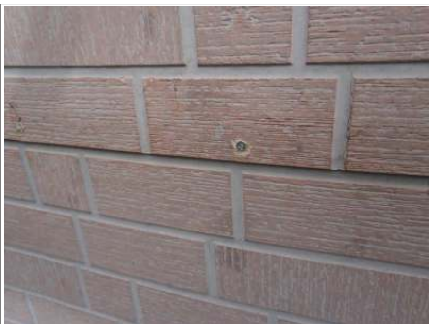
コーキング補修施工前
