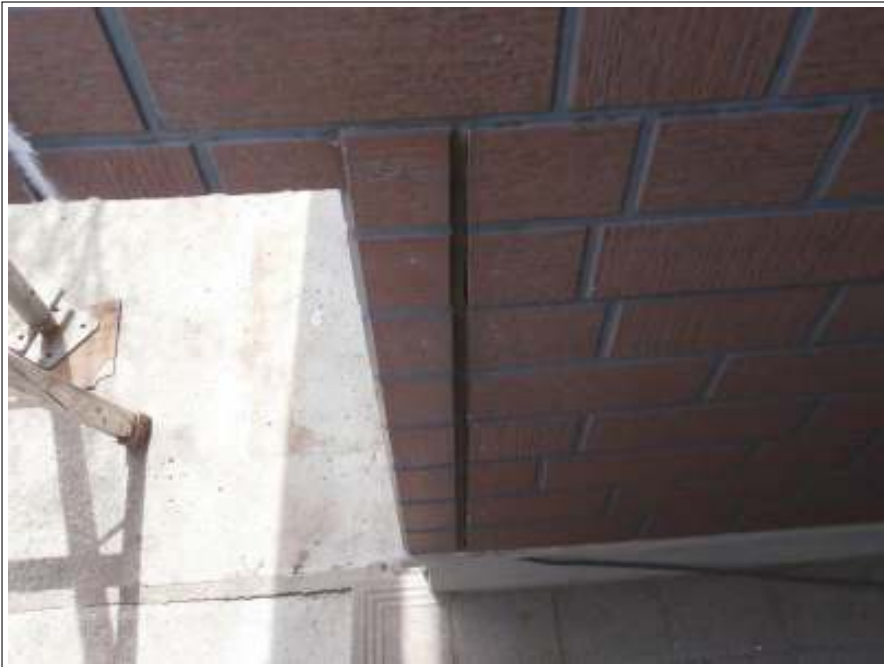
コーキング補修施工前
