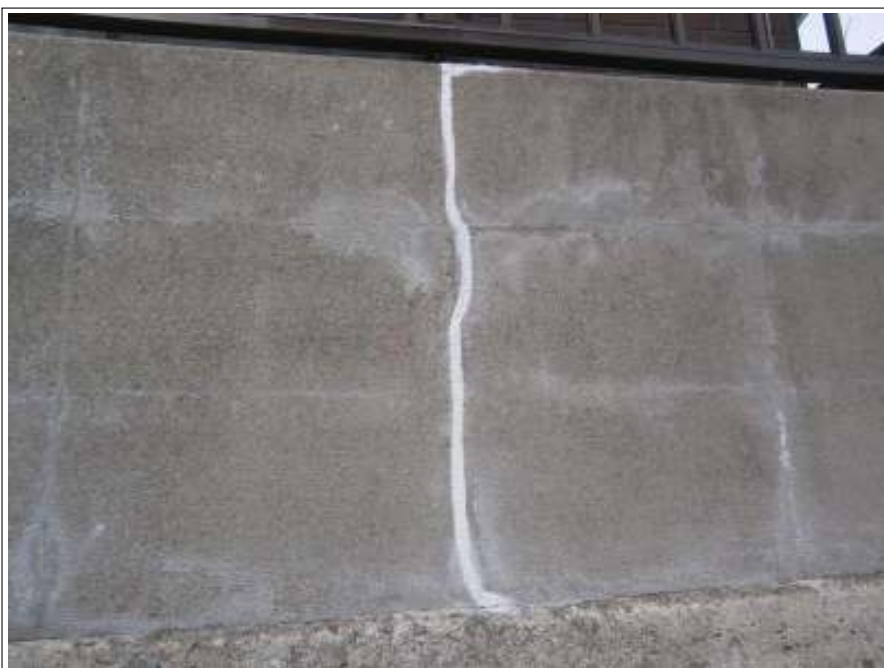
塀補修施工完了
