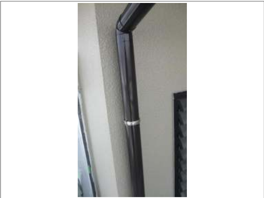
樋塗装施工完了
