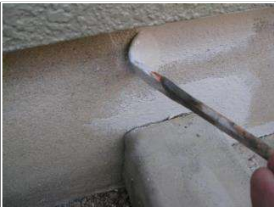
基礎塗装施工中
