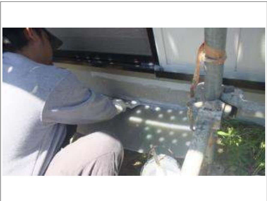
基礎塗装施工中
