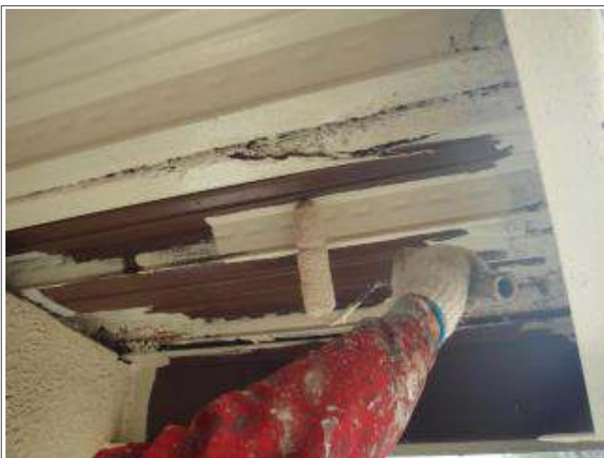
鉄部錆止め施工中
