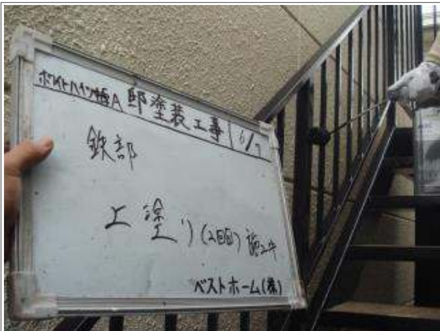
鉄部（階段）上塗り施工中（2回目）
