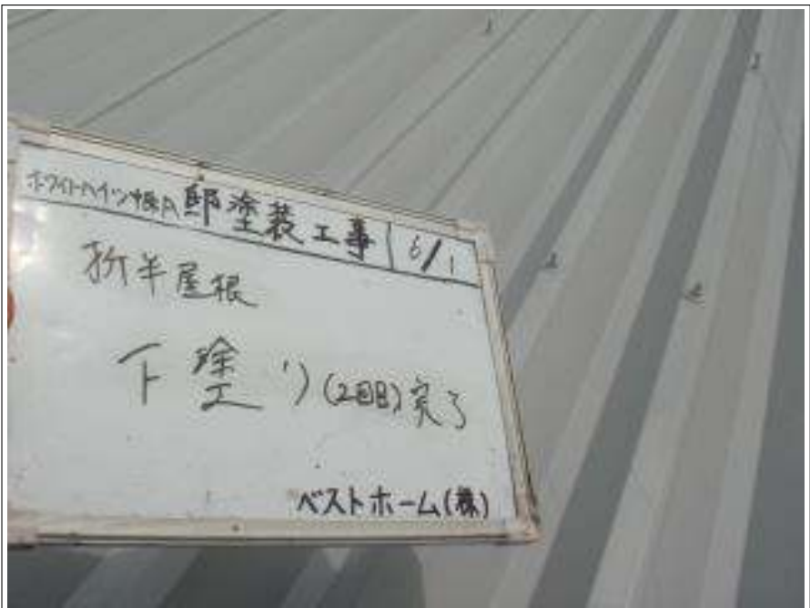
屋根下塗り施工完了（2回目）
