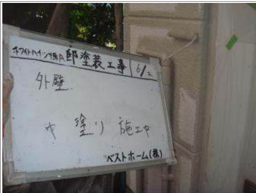
外壁中塗り施工中
