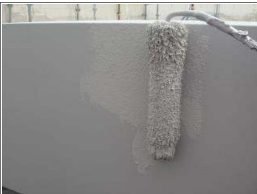
パラペット下塗り施工中(2回目)
