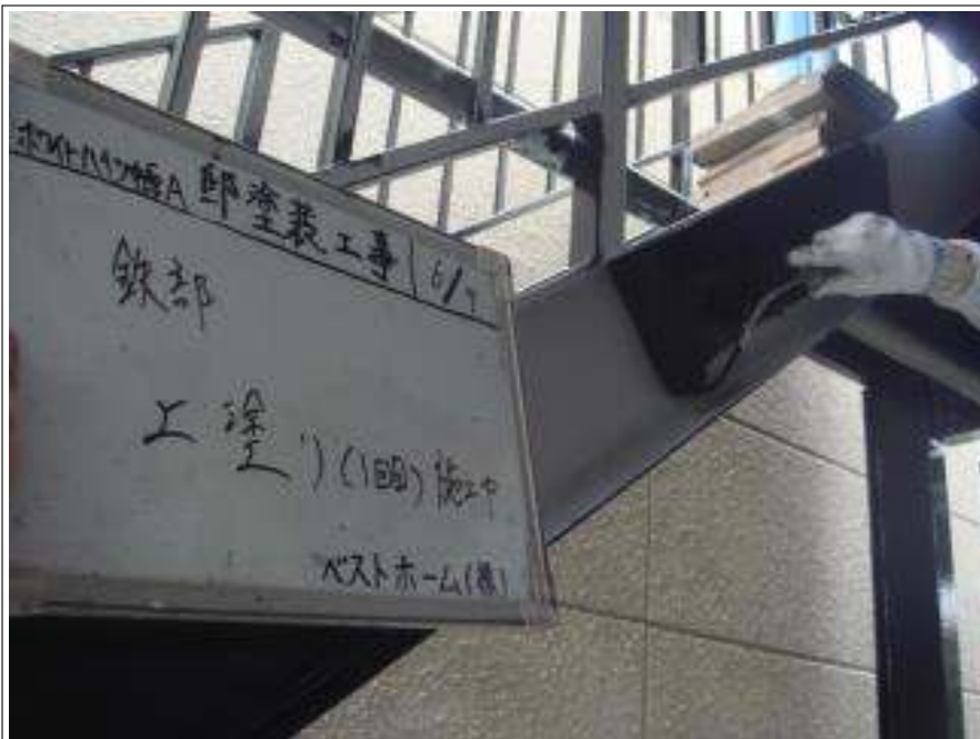
鉄部（階段）上塗り施工中
