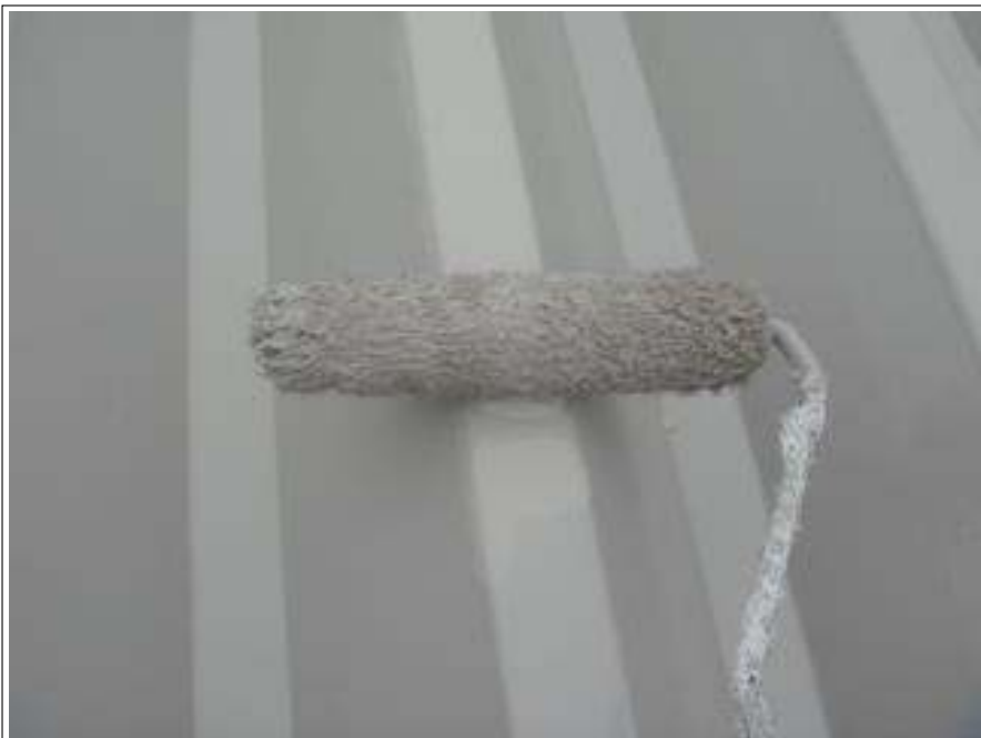
屋根上塗り施工中
