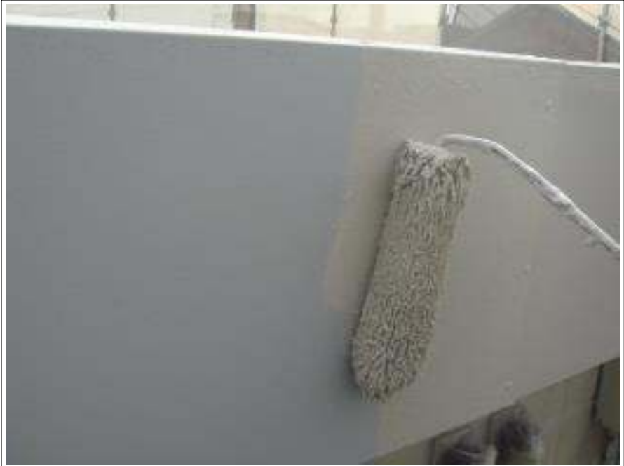
パラペット中塗り施工中
