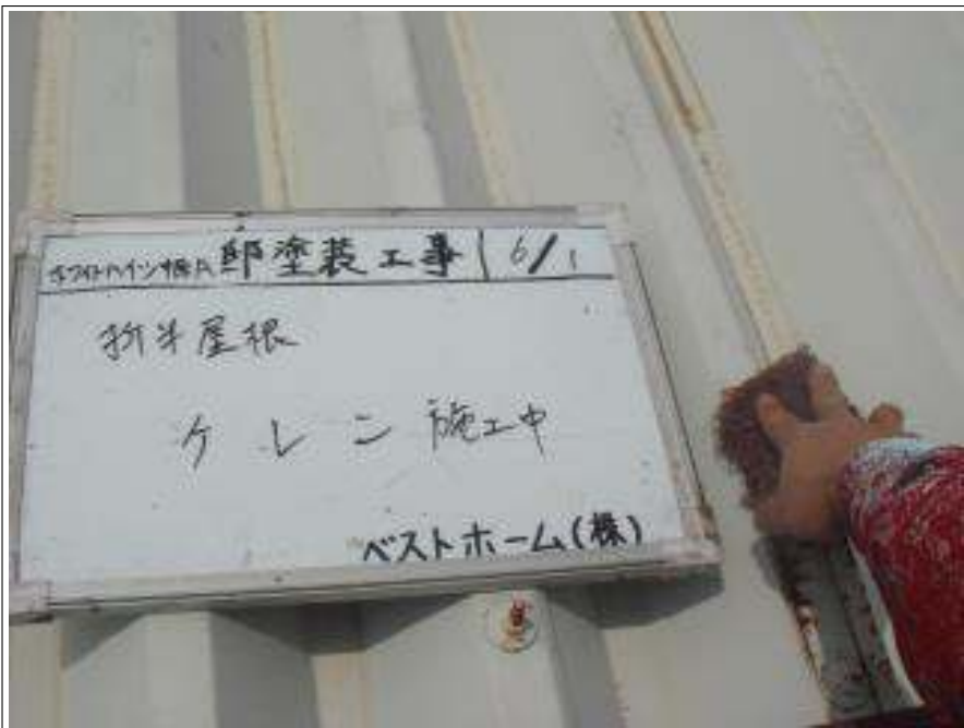
屋根ケレン施工中
