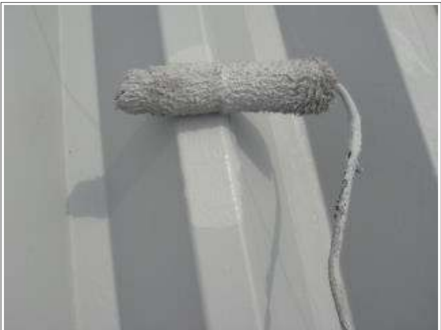
屋根下塗り施工中（2回目）
