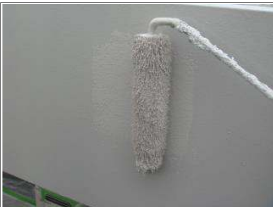
パラペット上塗り施工中
