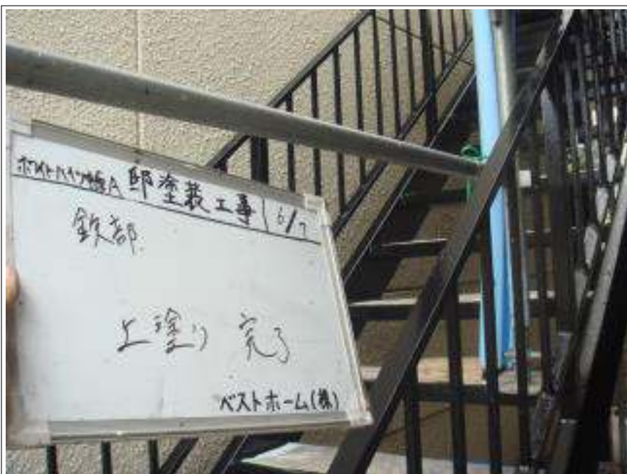
鉄部（階段）上塗り施工完了（2回目）
