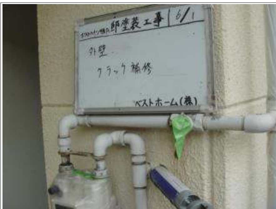
クラック補修中
