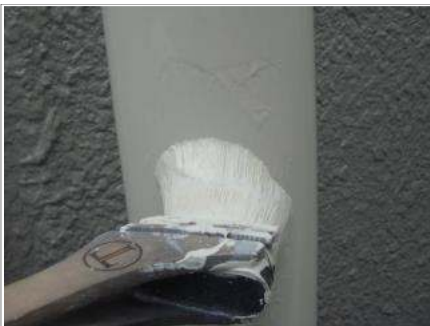
雨樋施工中 (2回目)
