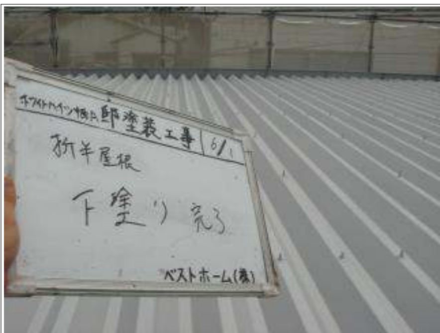
屋根下塗り施工完了
