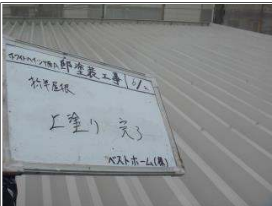
屋根上塗り施工完了
