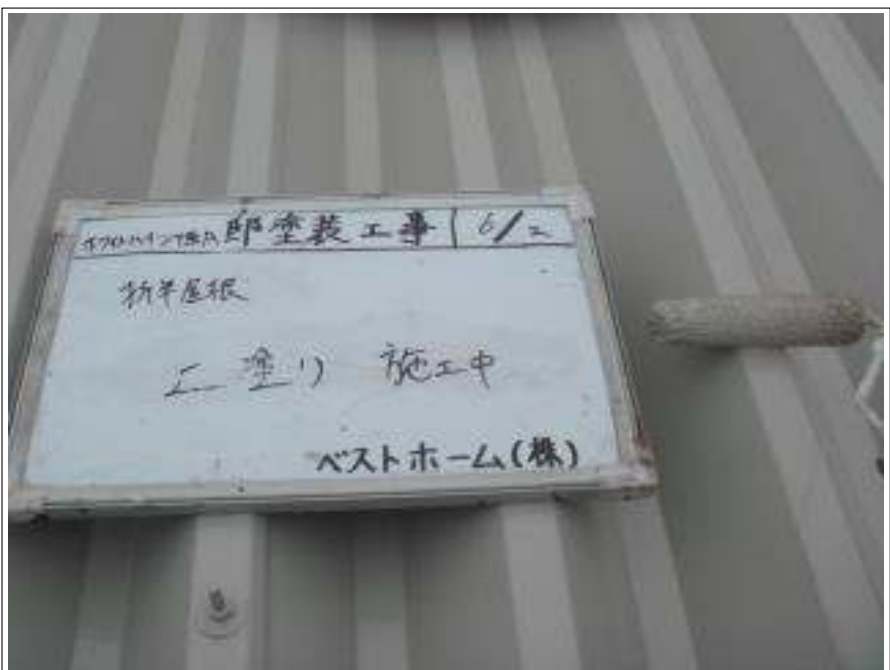
屋根上塗り施工中
