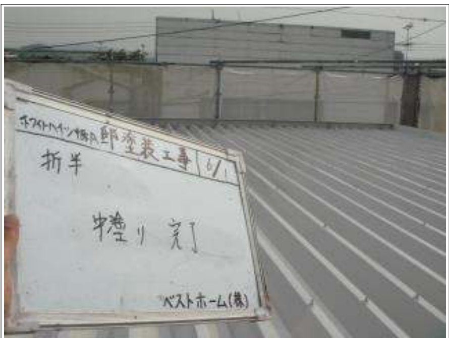
屋根中塗り施工完了
