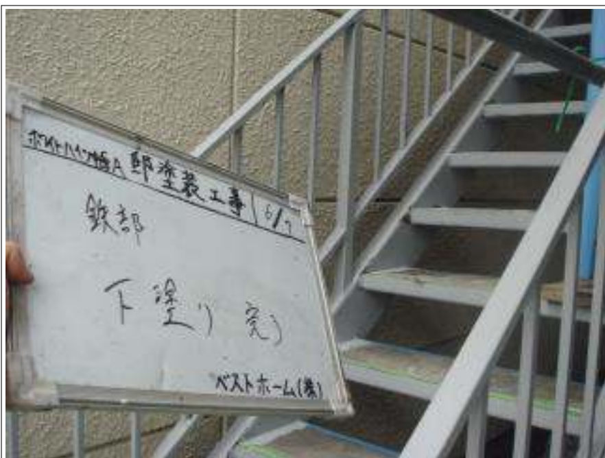
鉄部（階段）下塗り完了
