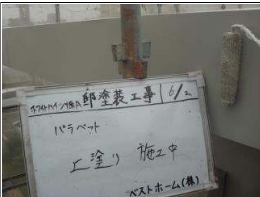
パラペット上塗り施工中
