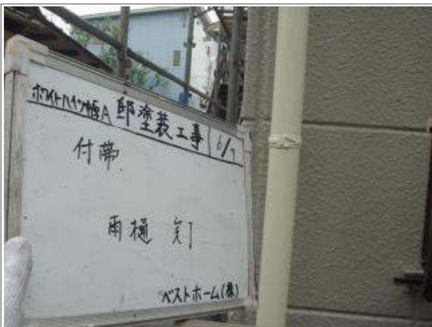
雨樋施工完了 (2回目)
