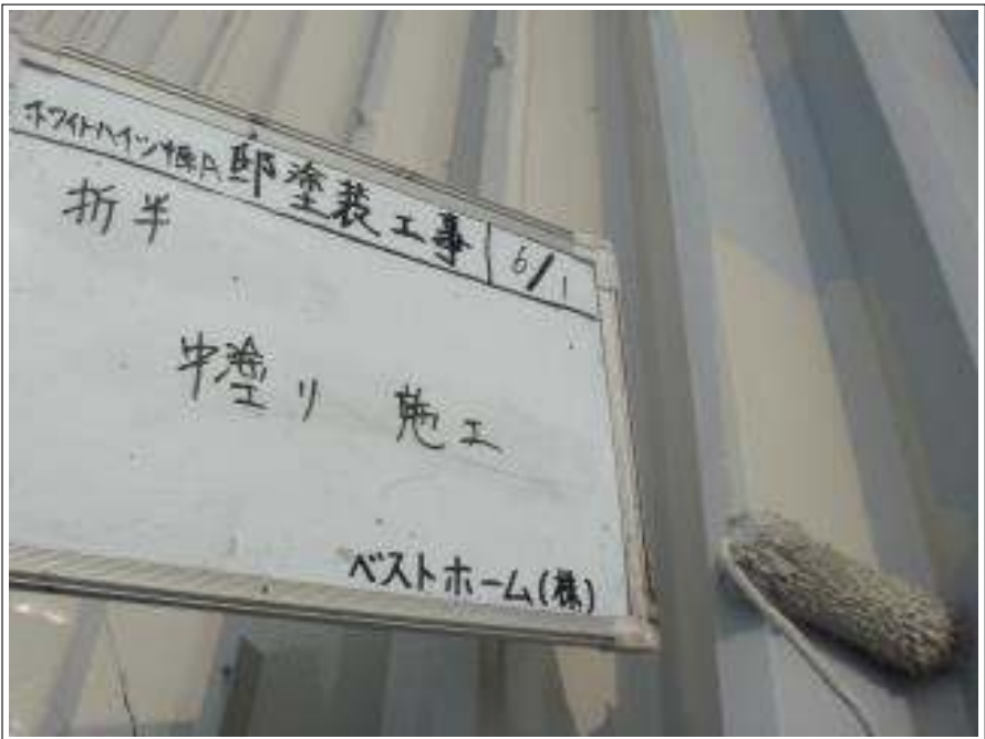
屋根中塗り施工中
