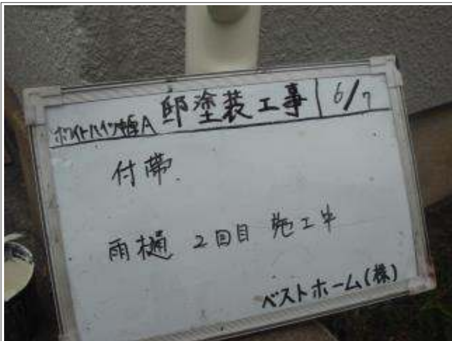
雨樋施工中 (2回目)
