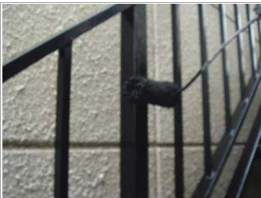
鉄部（階段）上塗り施工中（2回目）
