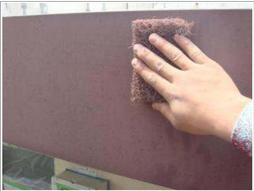
パラペットケレン施工中
