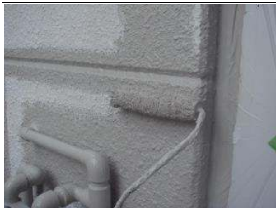
外壁中塗り施工中
