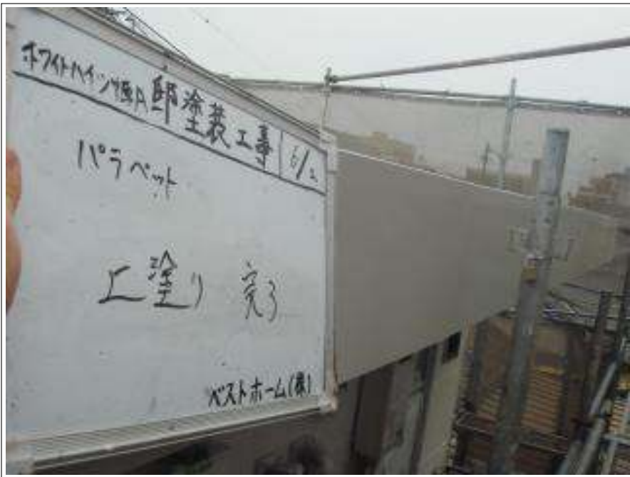
パラペット上塗り施工完了
