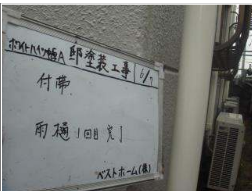
雨樋施工完了
