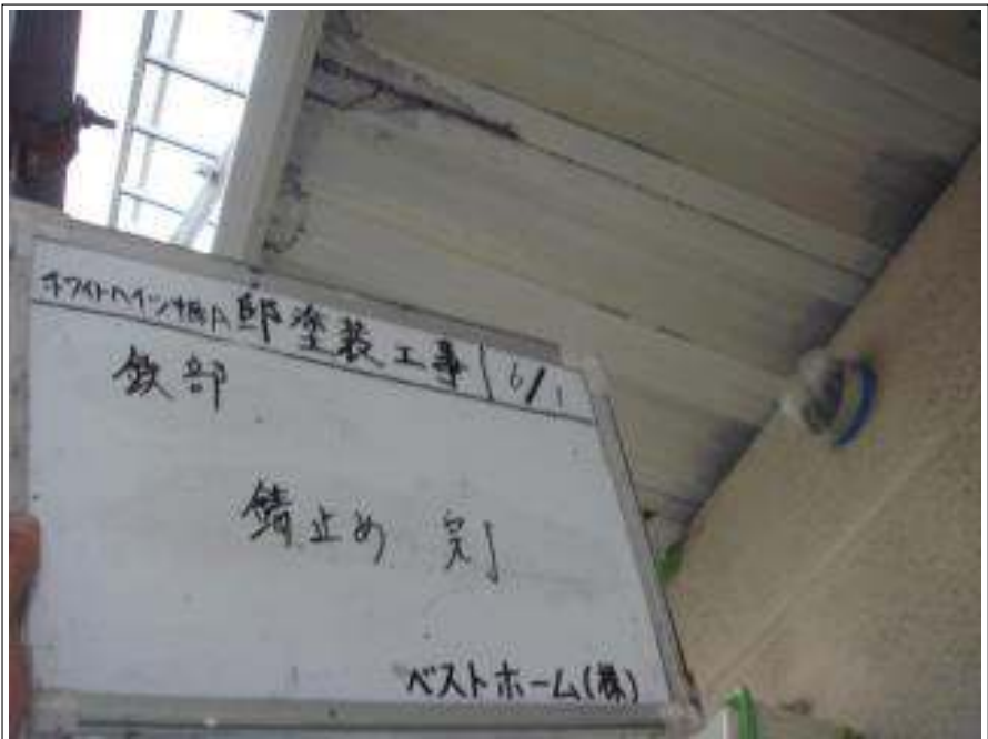
鉄部錆止め施工完了（2回目）
