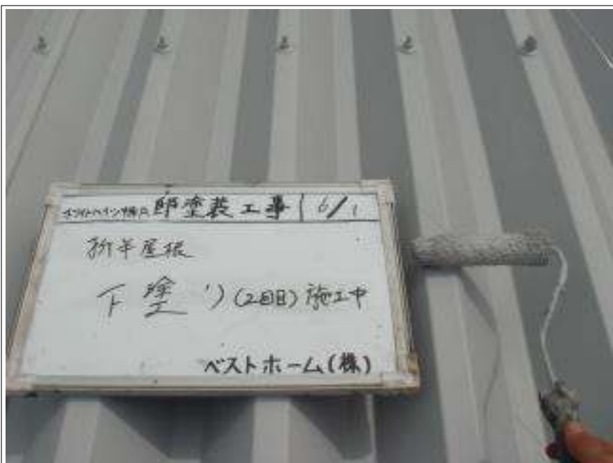
屋根下塗り施工中 (2回目)
