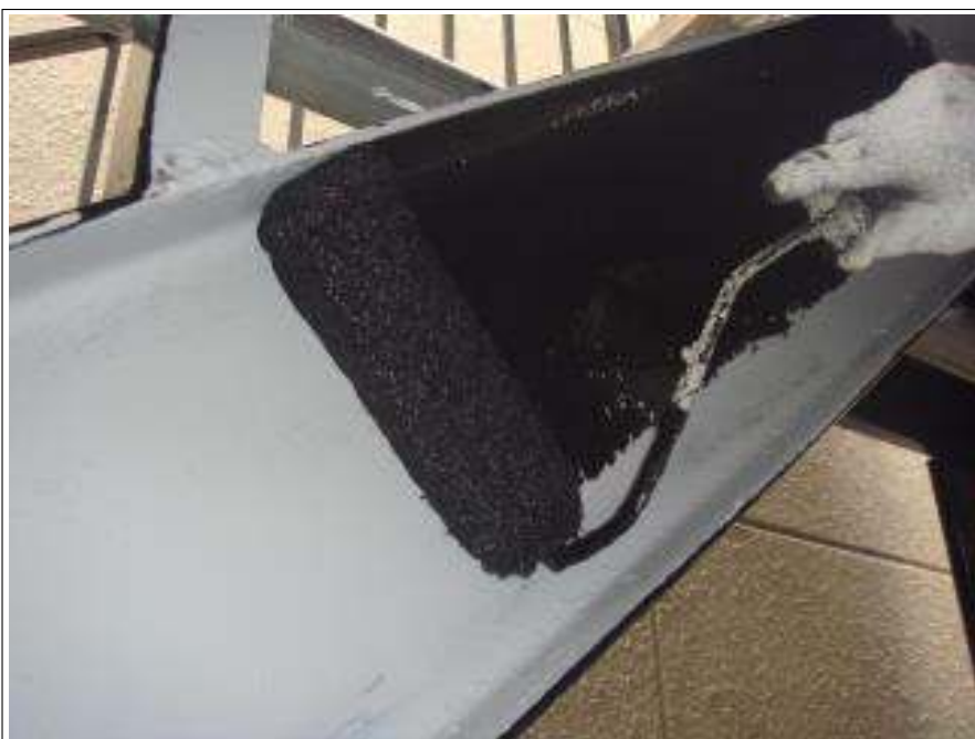
鉄部（階段）上塗り施工中
