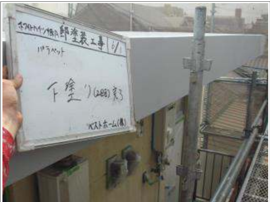
パラペット下塗り施工完了 (2回目)
