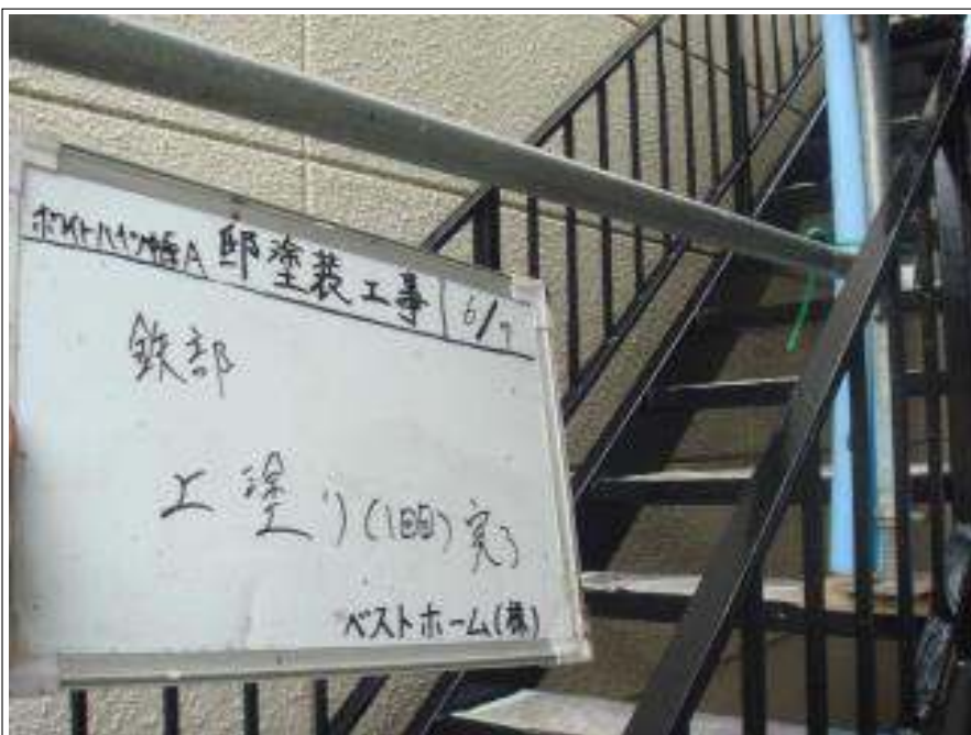
鉄部（階段）上塗り施工完了
