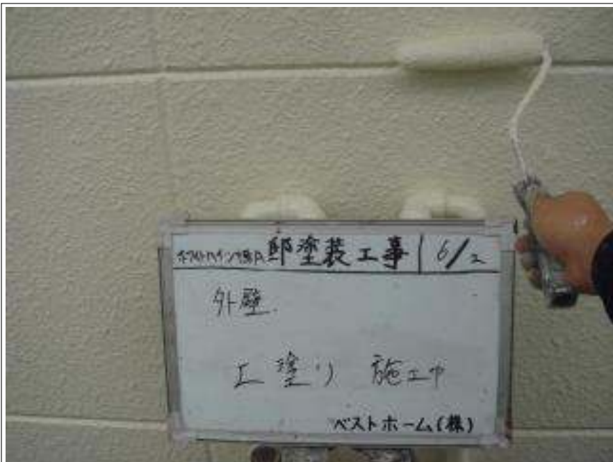
外壁上塗り施工中
