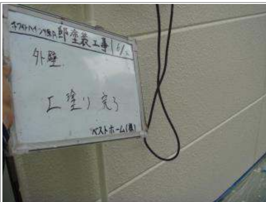
外壁上塗り施工完了
