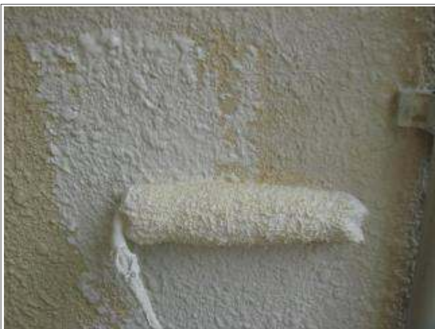
外壁下塗り施工中
