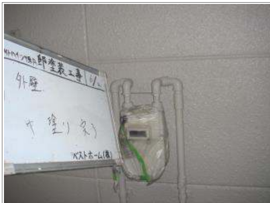
外壁中塗り施工後完了
