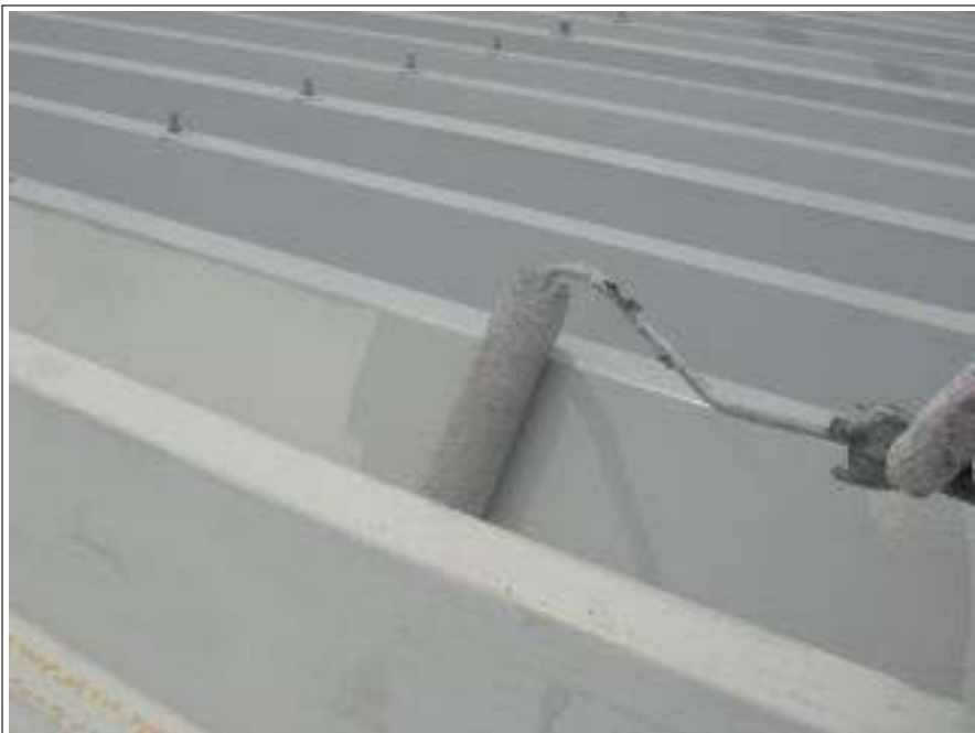
屋根下塗り施工中
