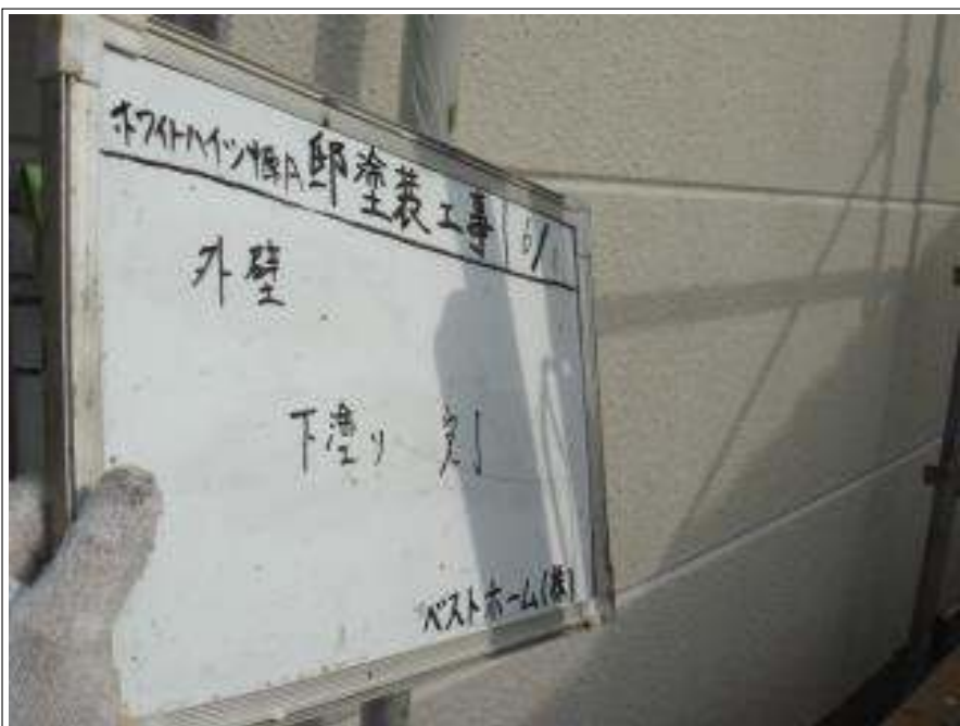
外壁下塗り施工完了
