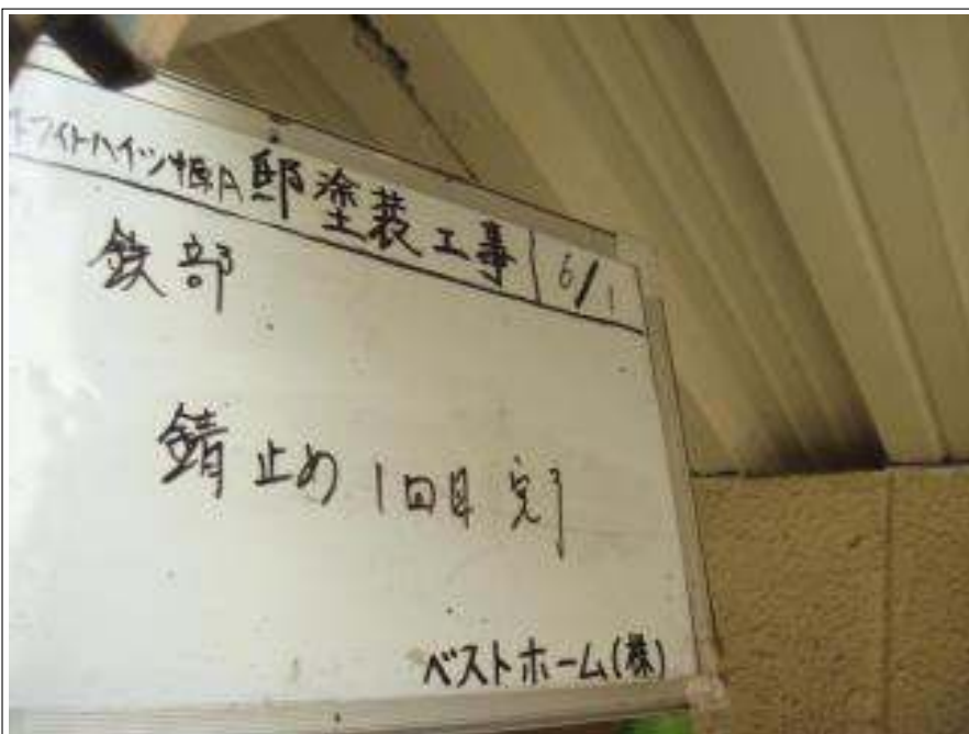
鉄部錆止め施工完了
