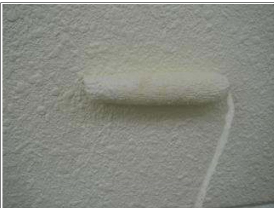
外壁上塗り施工中
