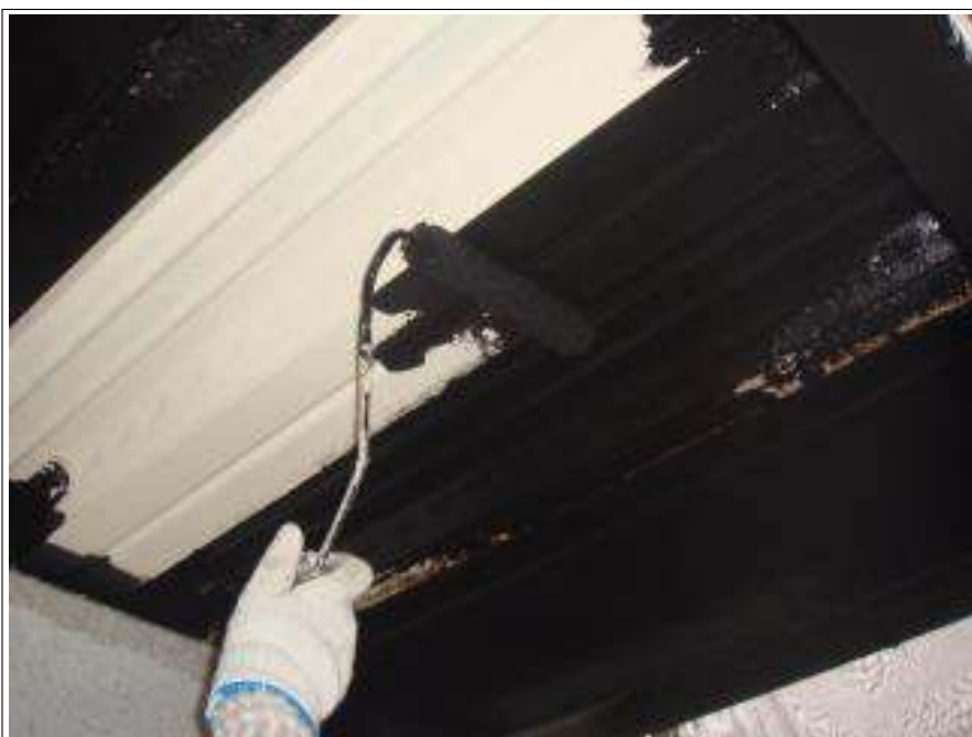
鉄部上塗り施工中
