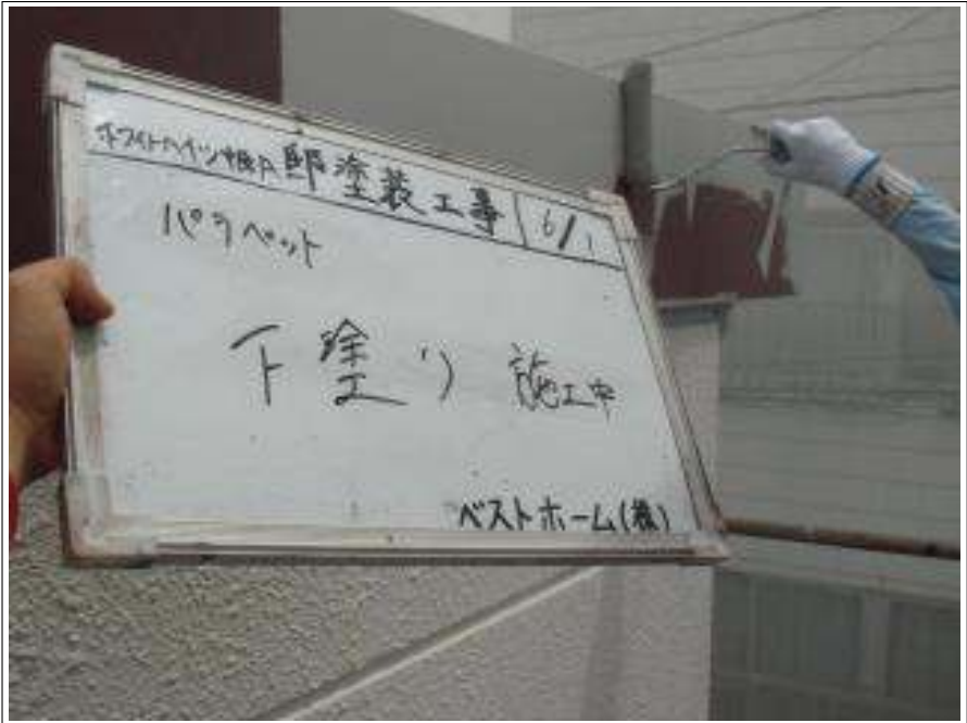
パラペット下塗り施工中
