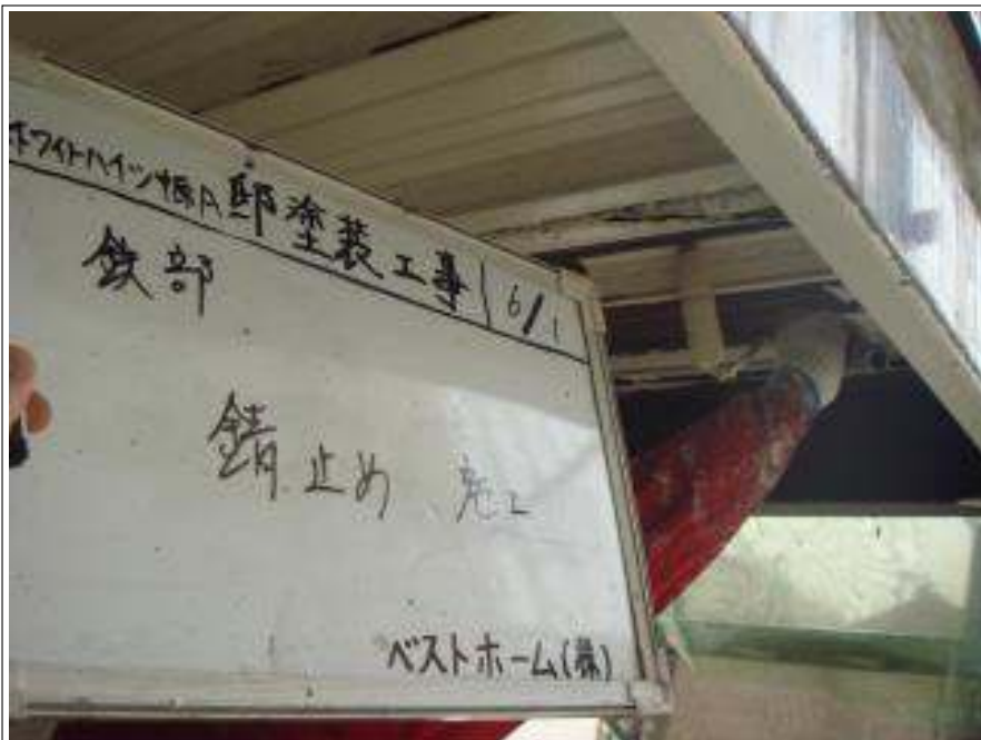
鉄部錆止め施工中
