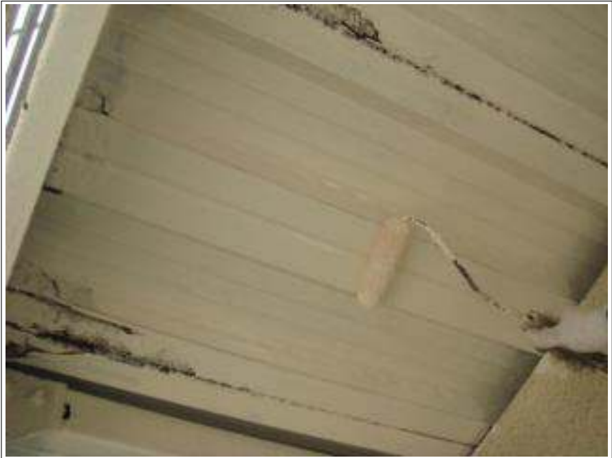
鉄部錆止め施工中（2回目）
