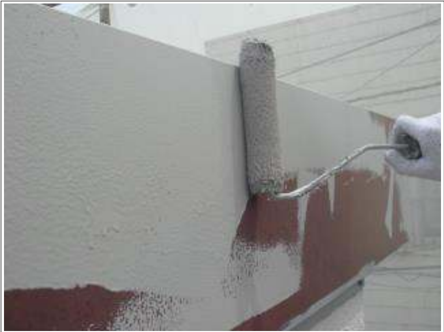
パラペット下塗り施工中
