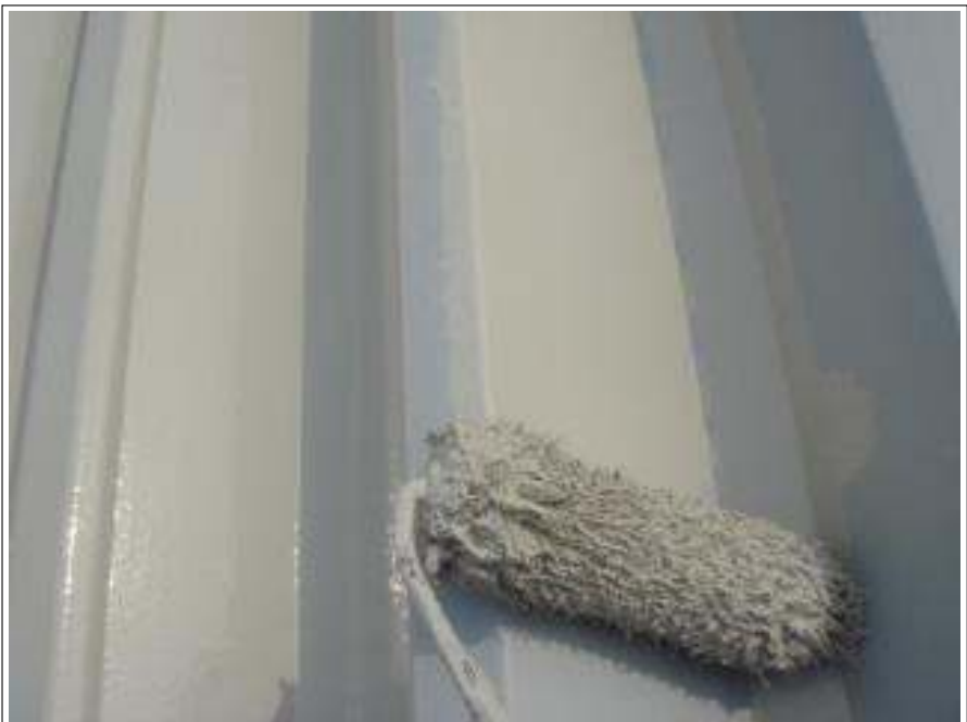
屋根中塗り施工中
