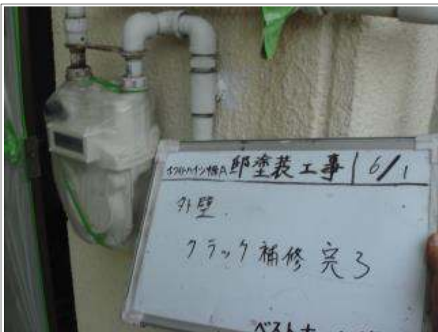
クラック補修完了
