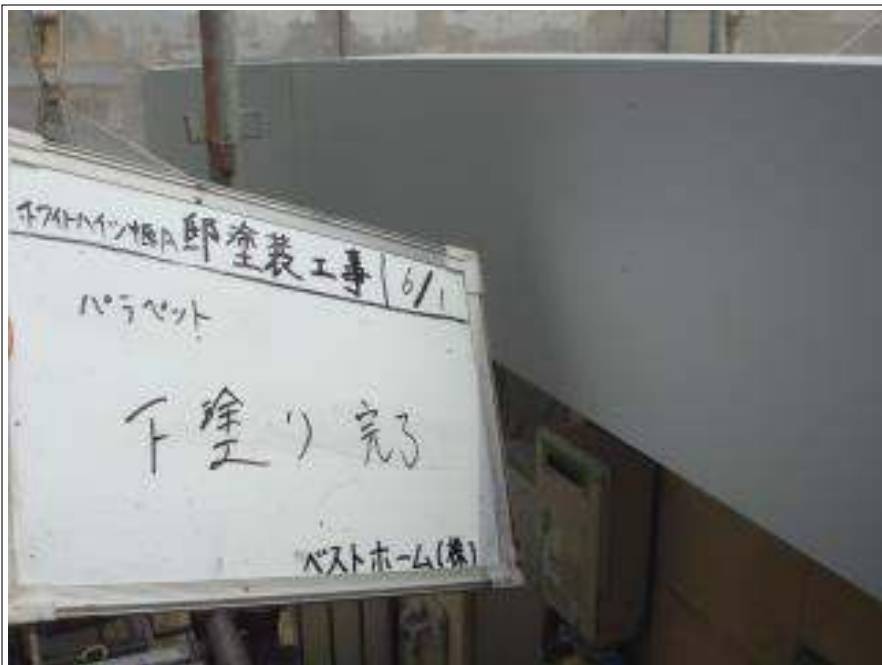
パラペット下塗り施工完了
