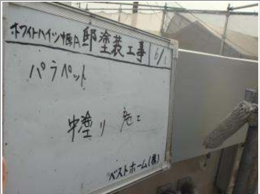
パラペット中塗り施工中
