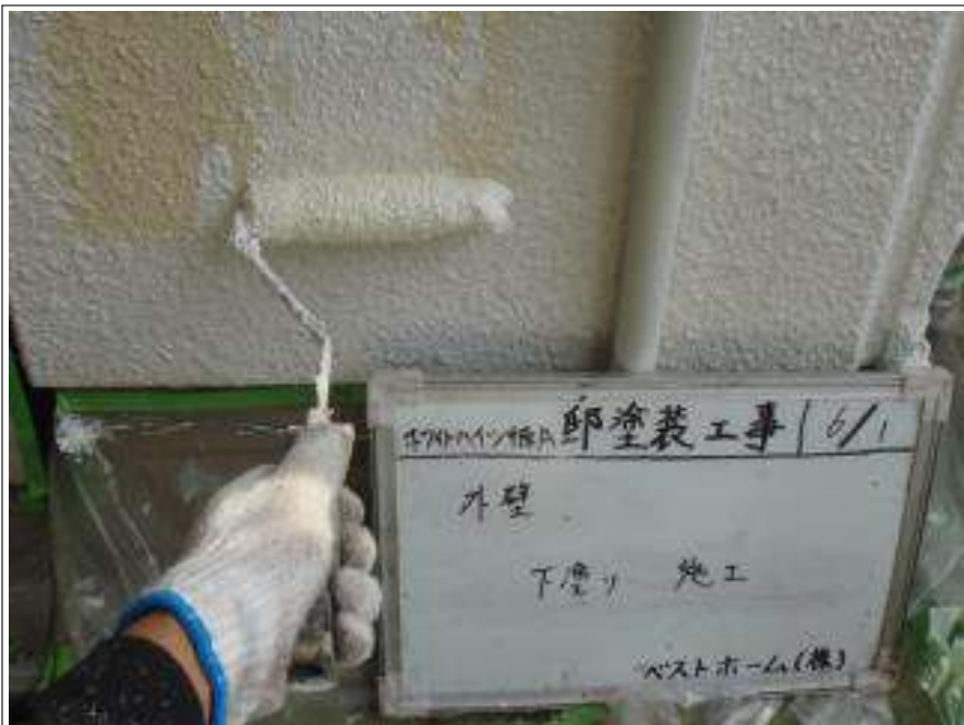
外壁下塗り施工中
