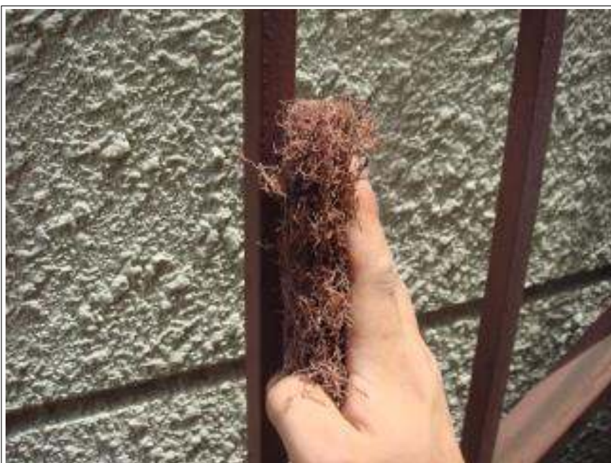
鉄部（階段）ケレン施工中
