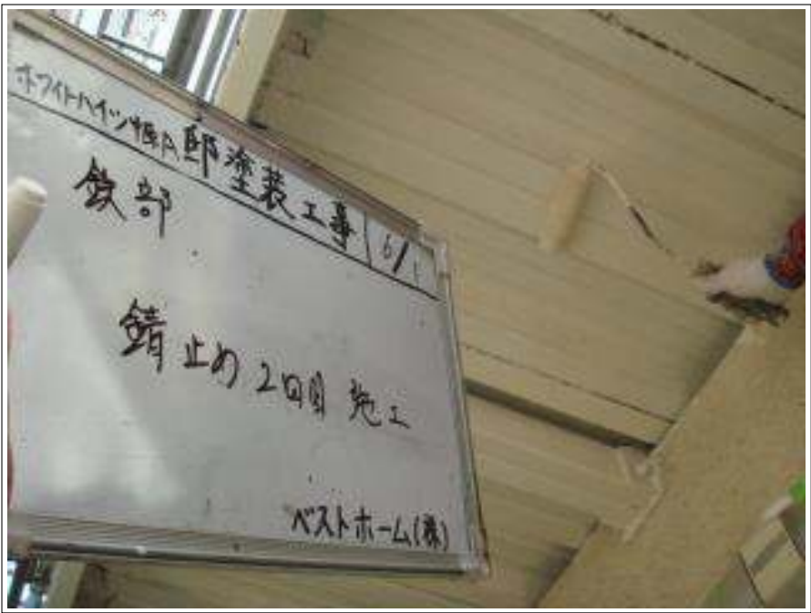
鉄部錆止め施工中（2回目）
