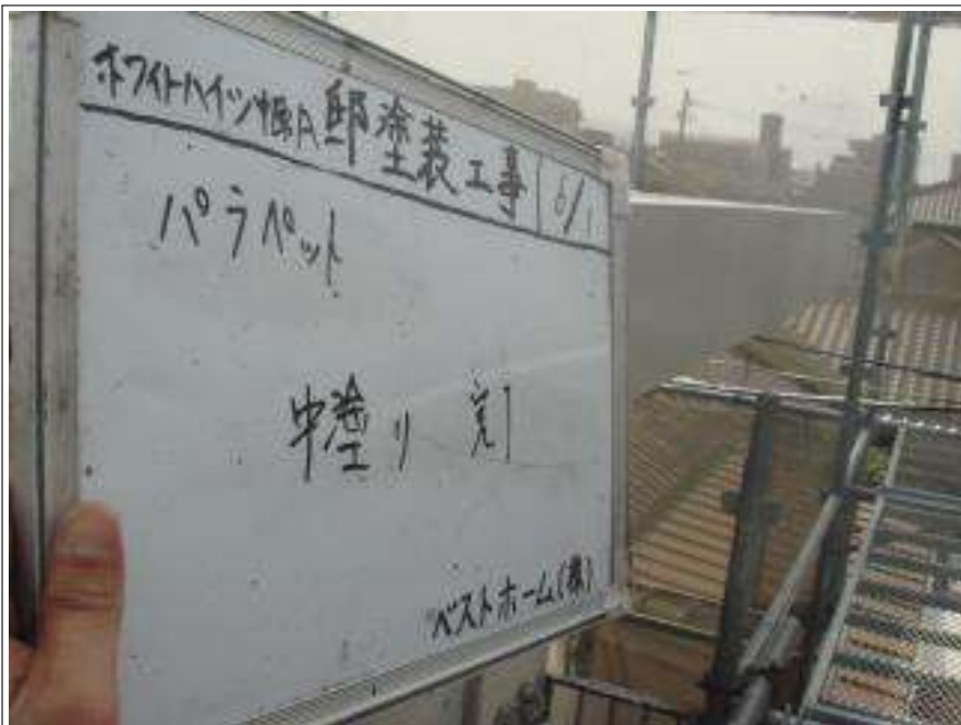
パラペット中塗り施工完了
