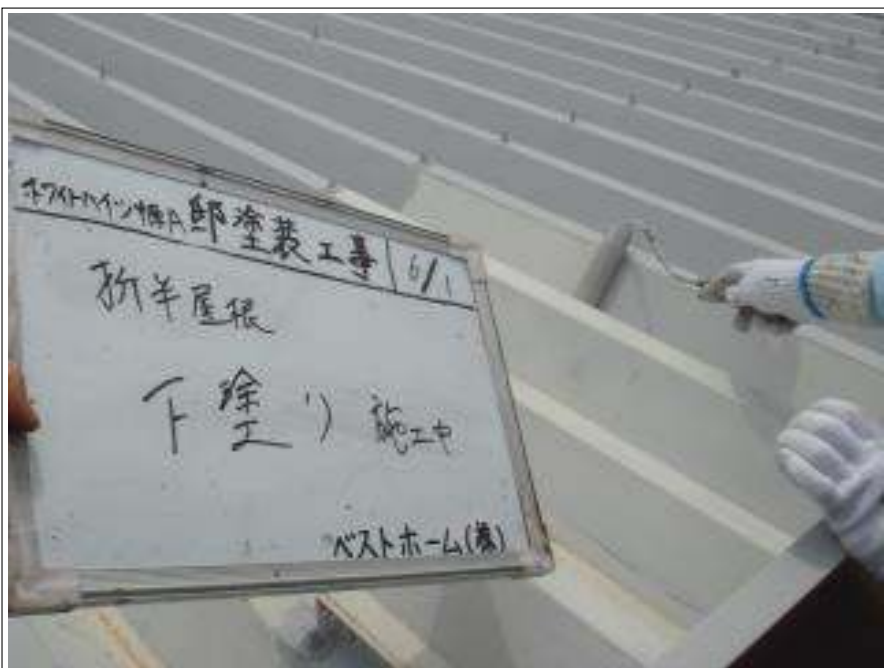
屋根下塗り施工中
