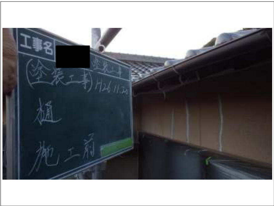
樋塗装施工前
