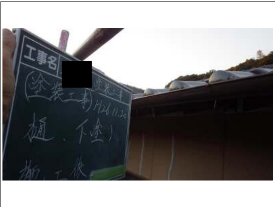
樋塗装下塗り施工完了
