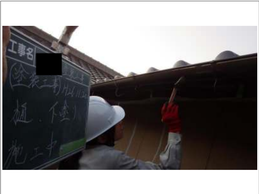
樋塗装下塗り施工中
