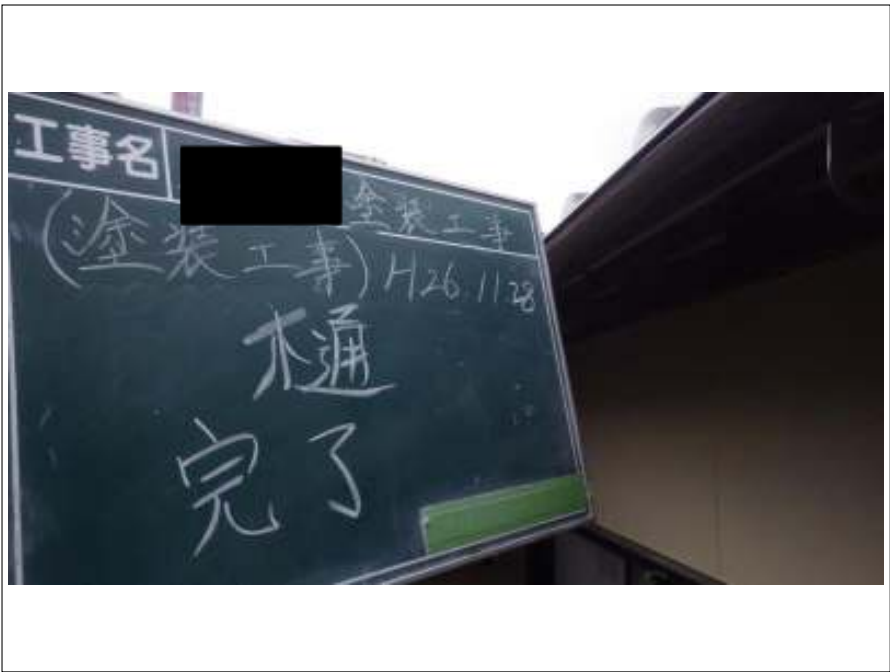
樋塗装施工完了
