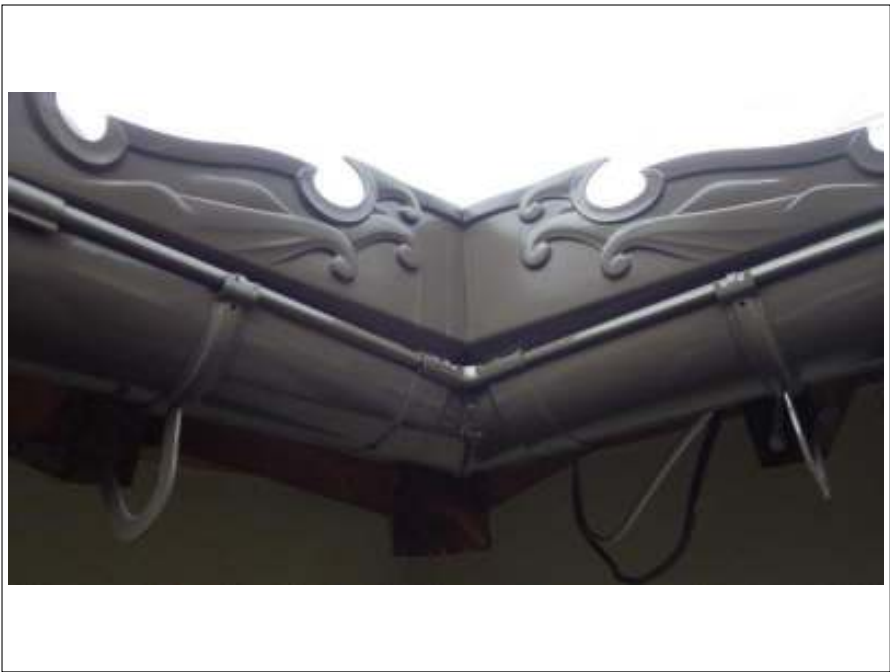
樋塗装施工完了
