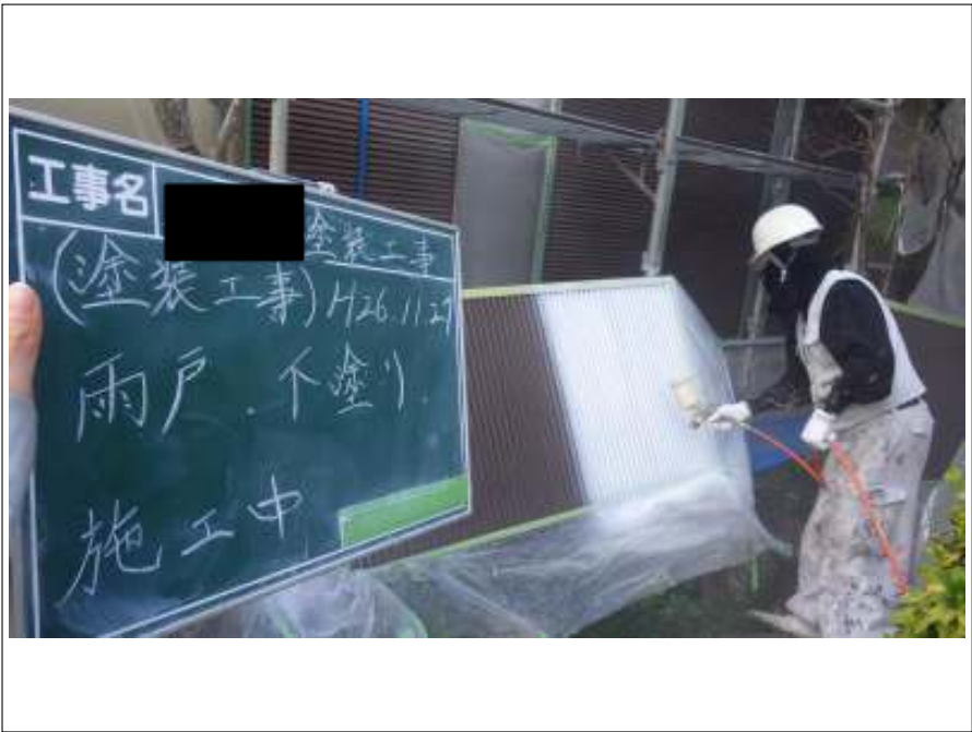
雨戸塗装下塗り施工中
