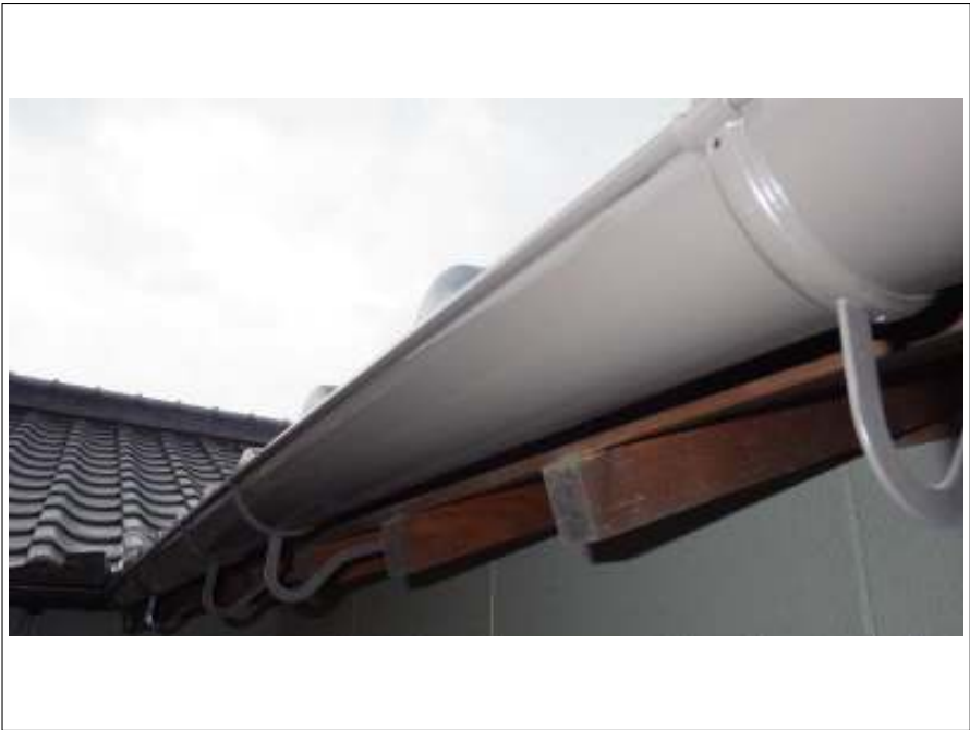
樋塗装施工完了
