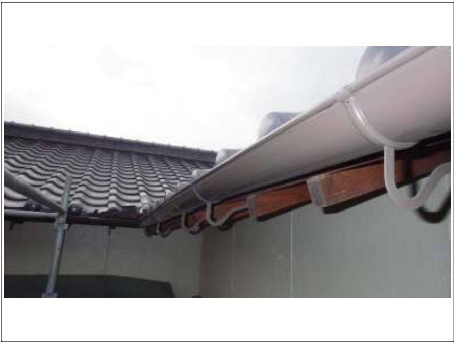
樋塗装施工完了
