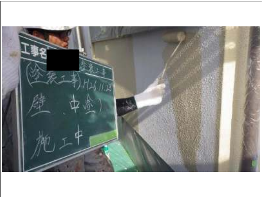
外壁塗装中塗り施工中
