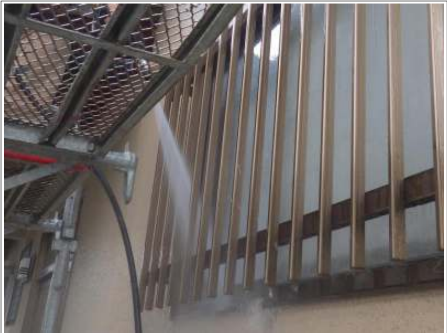
窓格子高圧洗浄施工中
