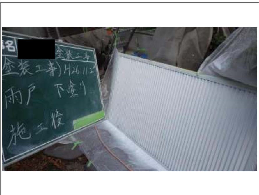
雨戸塗装下塗り施工完了
