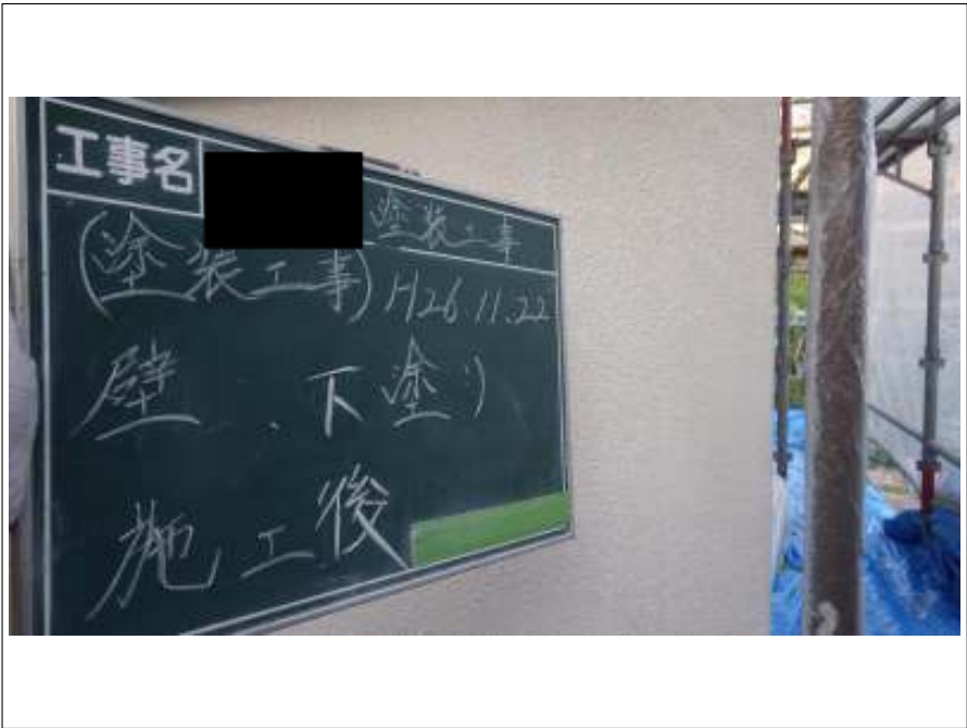
外壁塗装下塗り施工完了
