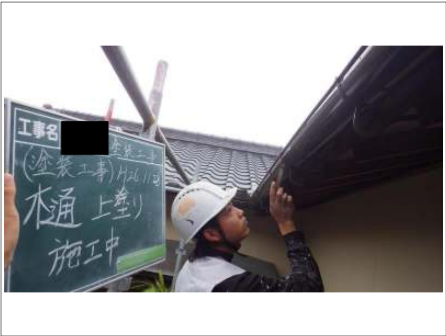
樋塗装上塗り施工中
