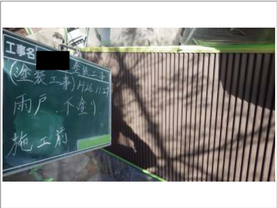
雨戸塗装下塗り施工前
