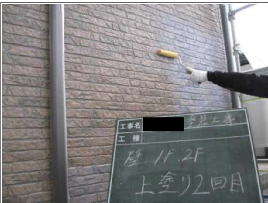
外壁塗装上塗り施工中
