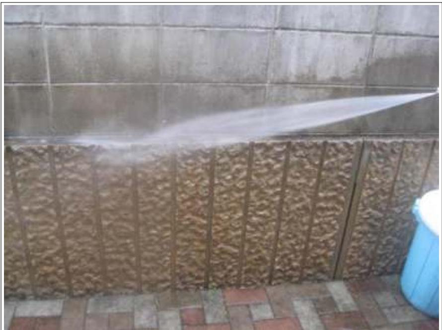
塀高压洗净施工中
