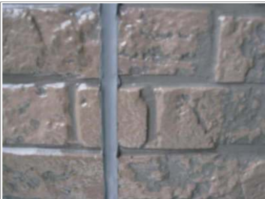
外壁シーリング補修施工完了
