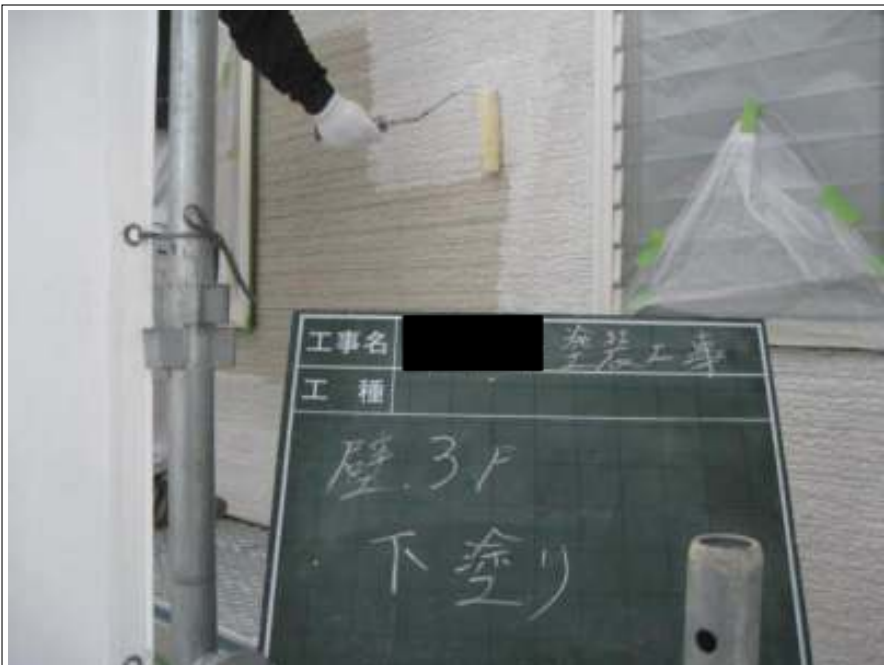
外壁塗装下塗り施工中
