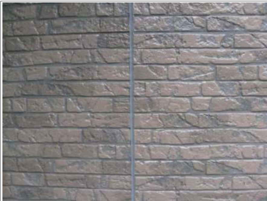
外壁シーリング補修施工完了
