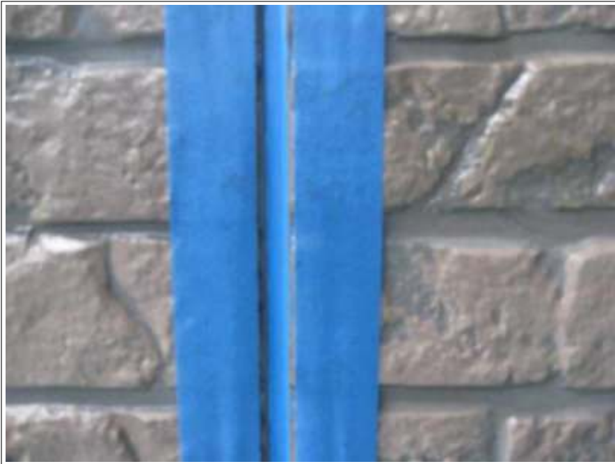
外壁シーリング撤去後
