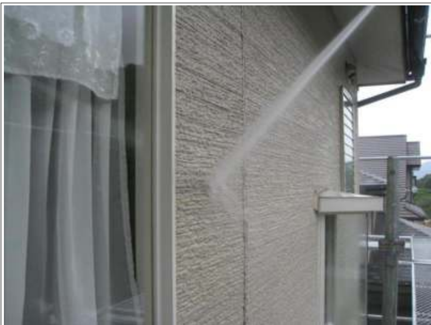
外壁高圧洗浄施工中
