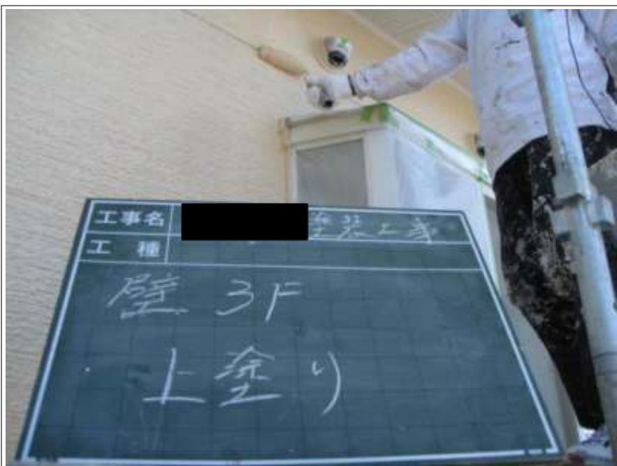
外壁塗装上塗り施工中
