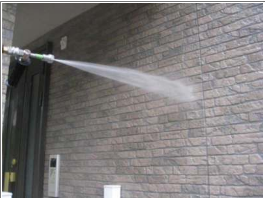
外壁高圧洗浄施工中
