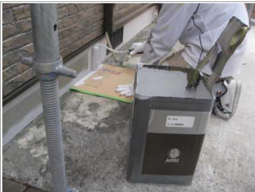
基礎塗装施工中
