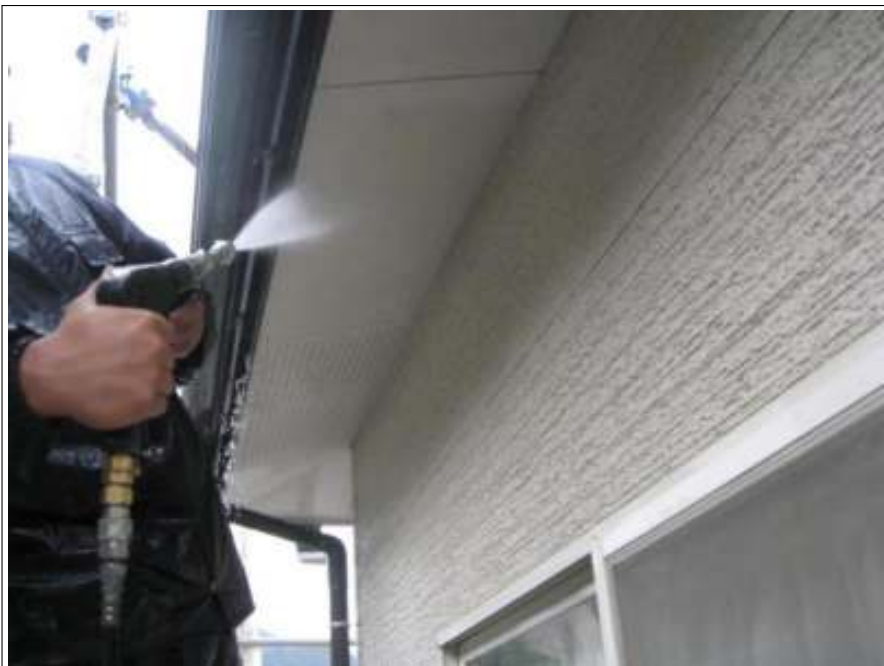
軒天高圧洗浄施工中
