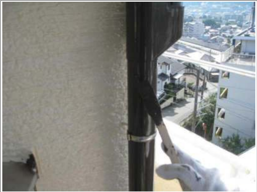
樋塗装施工中
