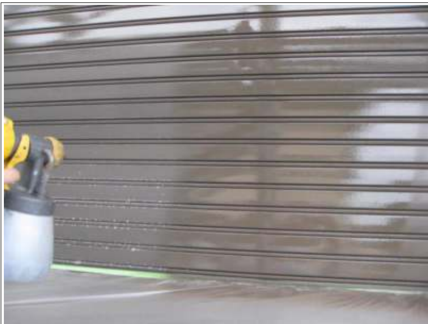
シャッター塗装 2 回目施工中
