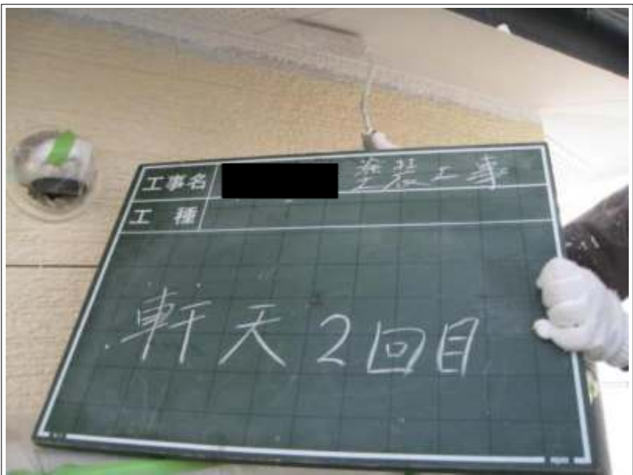
軒天塗装 2回目施工中
