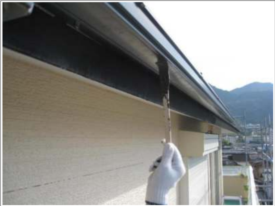
樋塗装施工中
