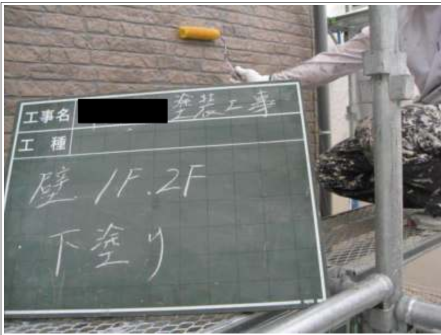
外壁塗装下塗り施工中
