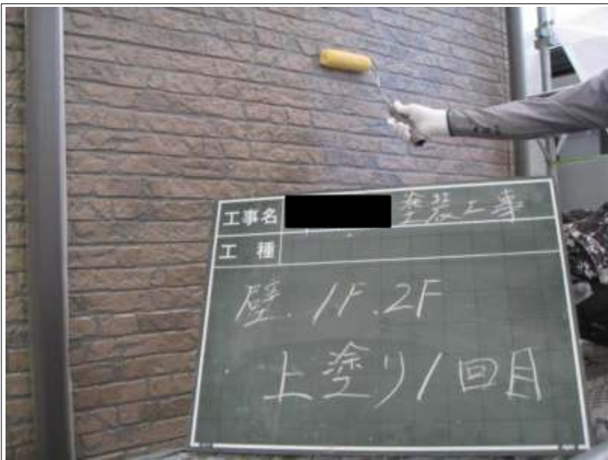
外壁塗装中塗り施工中
