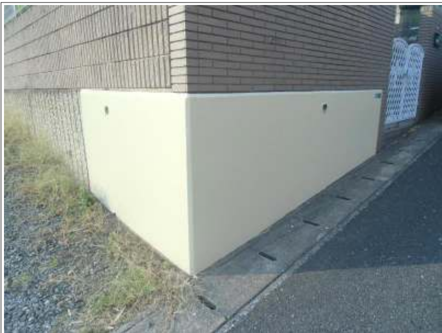
塀塗装施工完了
