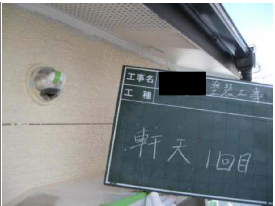
軒天塗装 1回目施工中
