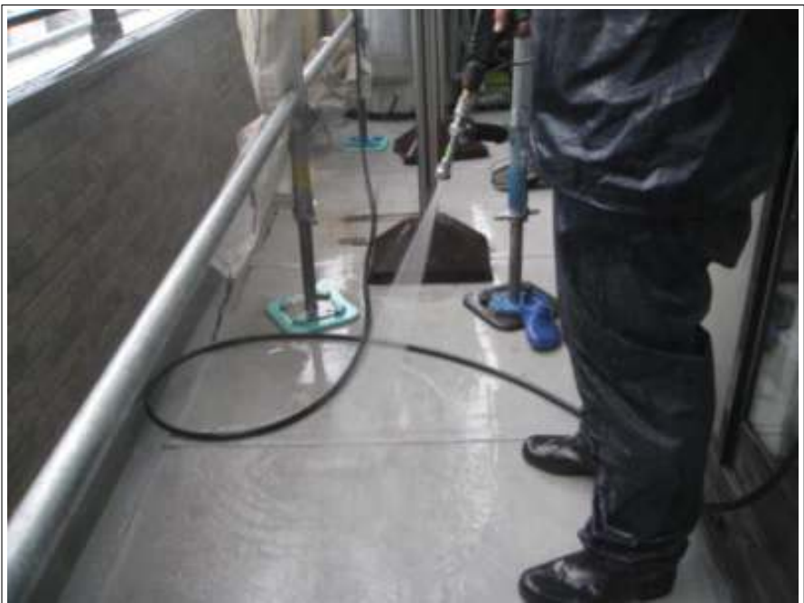
ベランダ高圧洗浄施工中
