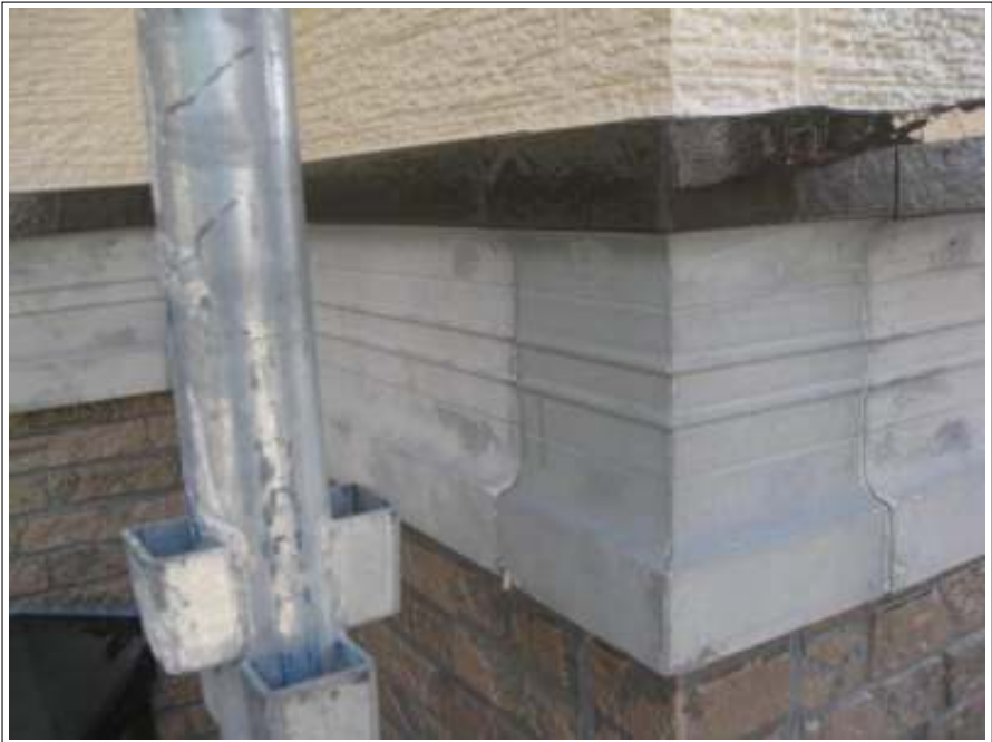
帯塗装施工中
