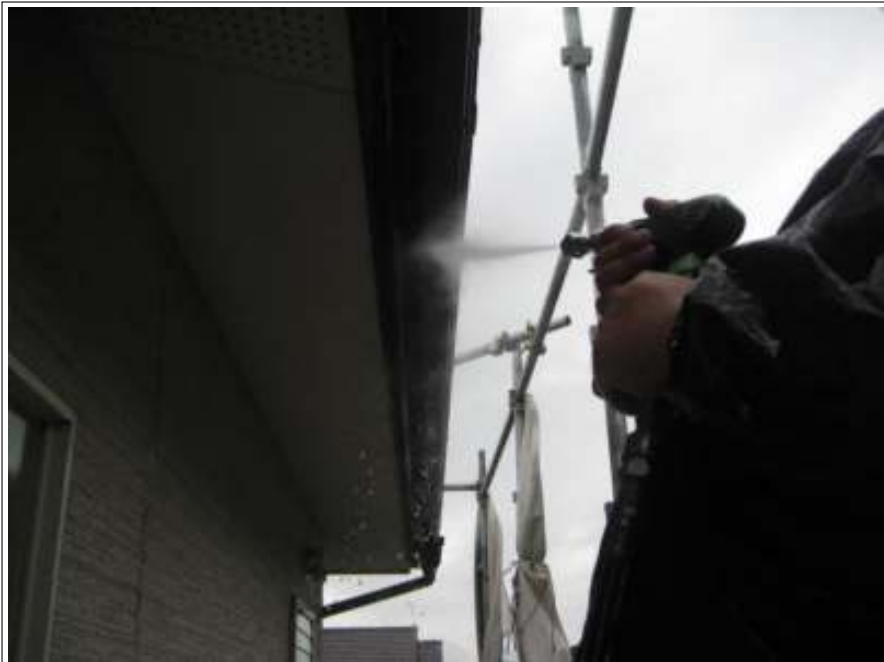
樋高圧洗浄施工中
