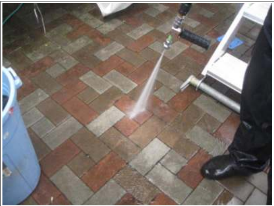
駐車場高圧洗浄施工中
