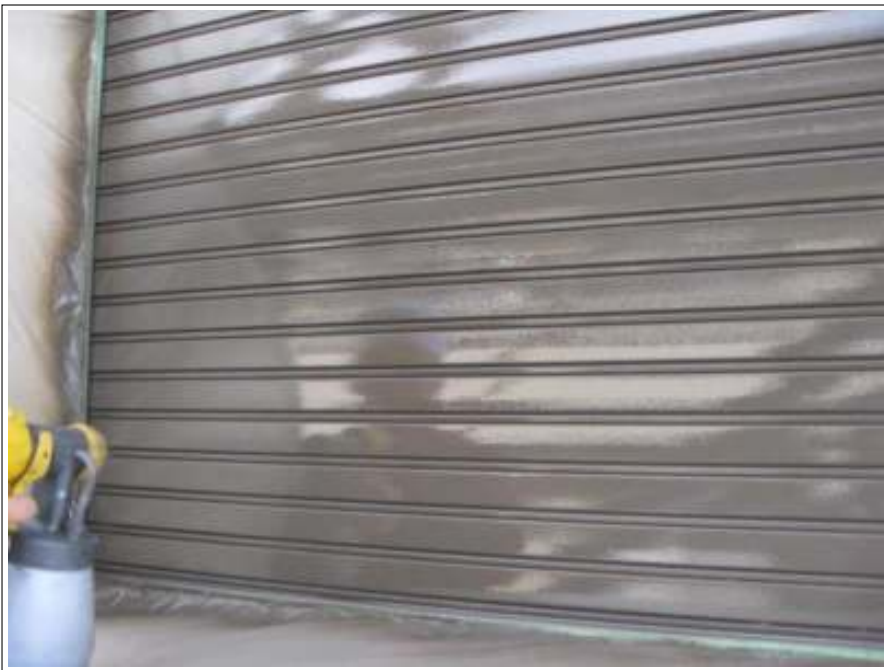
シャッター塗装 1 回目施工中
