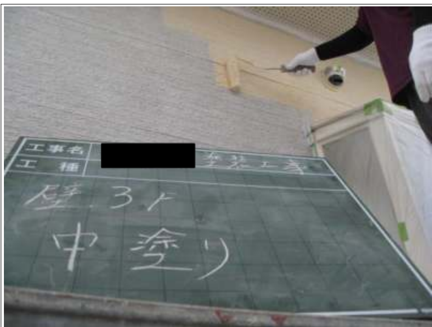
外壁塗装中塗り施工中
