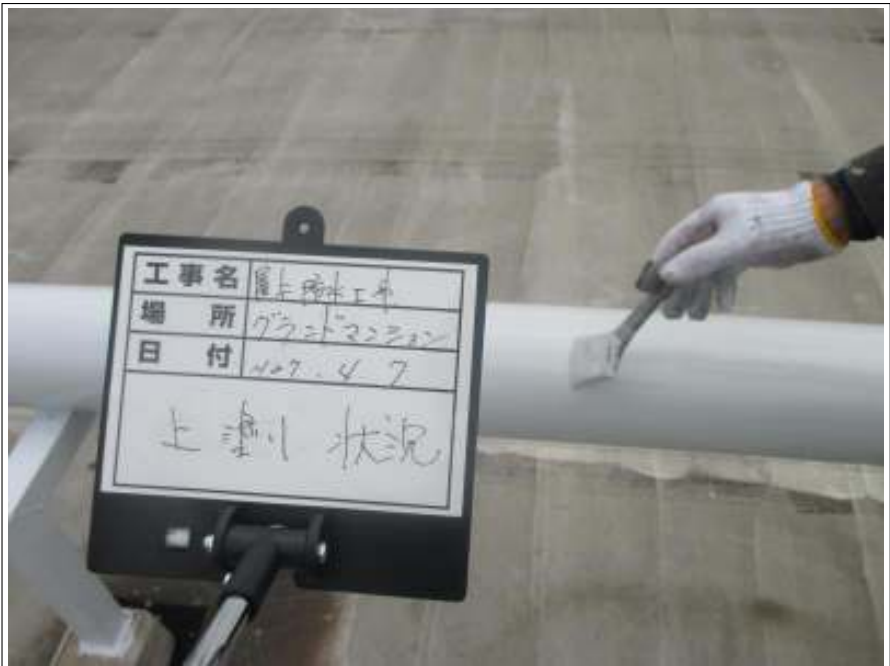
配管上塗り施工中
