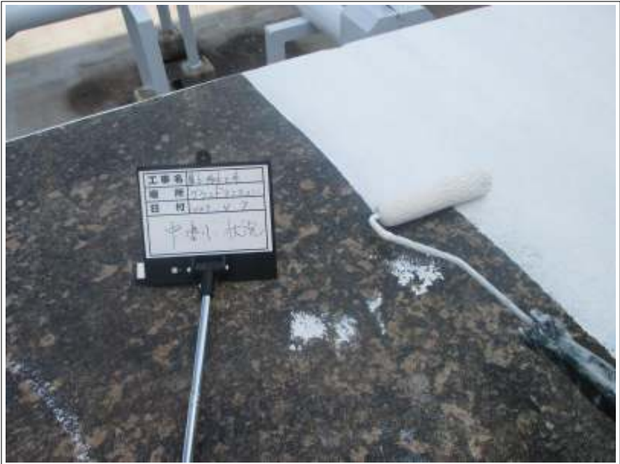
ハト小屋中塗り施工中
