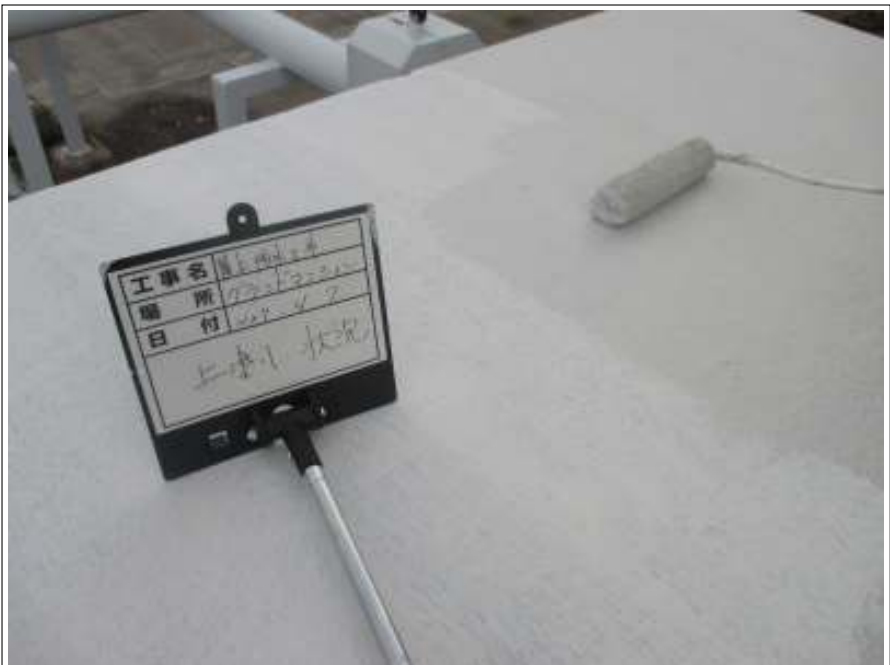
ハト小屋上塗り施工中
