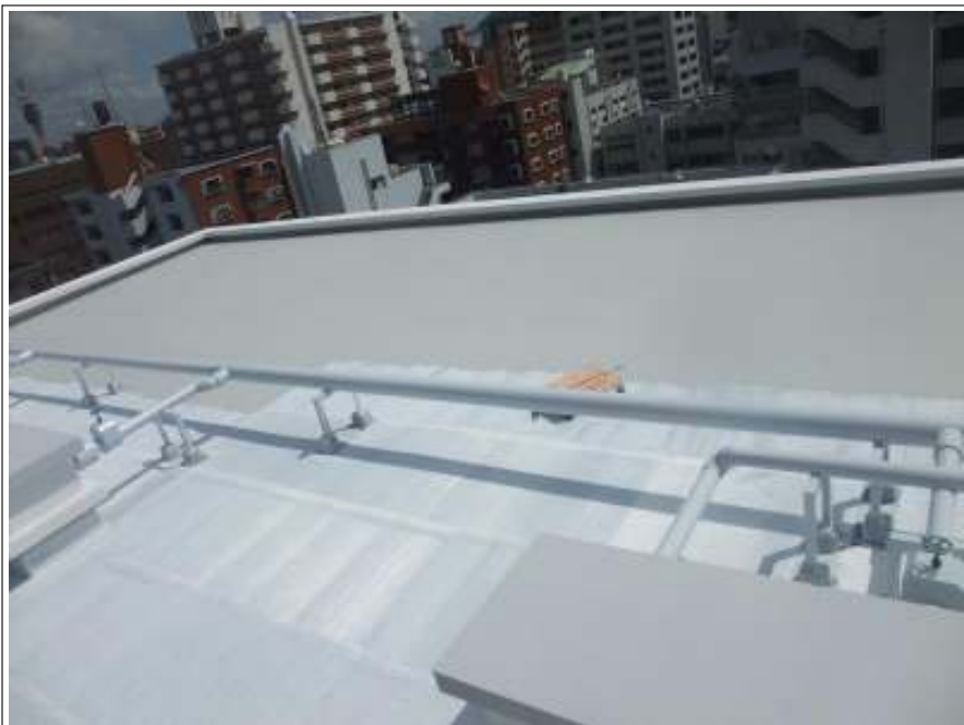
屋上中塗り施工中
