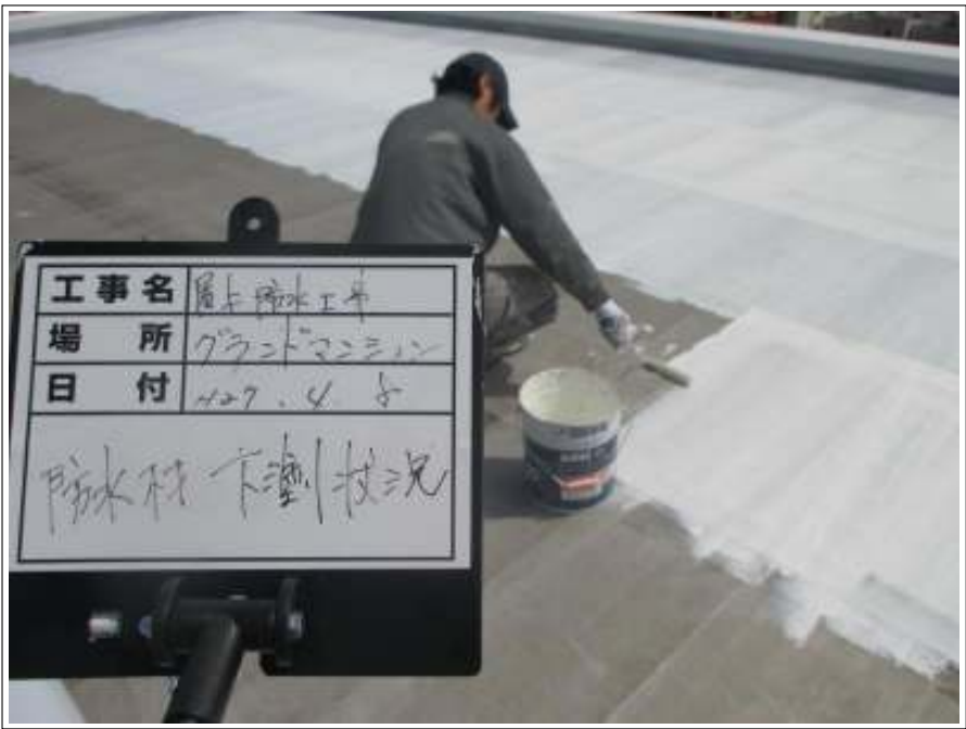
屋上下塗り施工中
