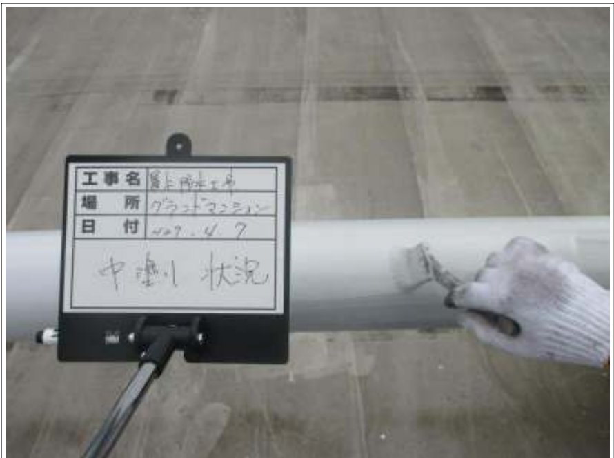
配管中塗り施工中
