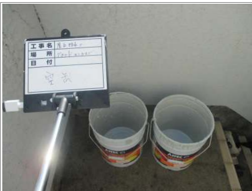
屋上中塗り・上塗り使用材料空缶
