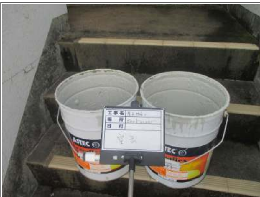
屋上中塗り・上塗り使用材料空缶
