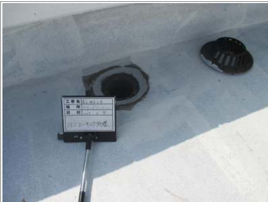
ドレンコーキング施工完了
