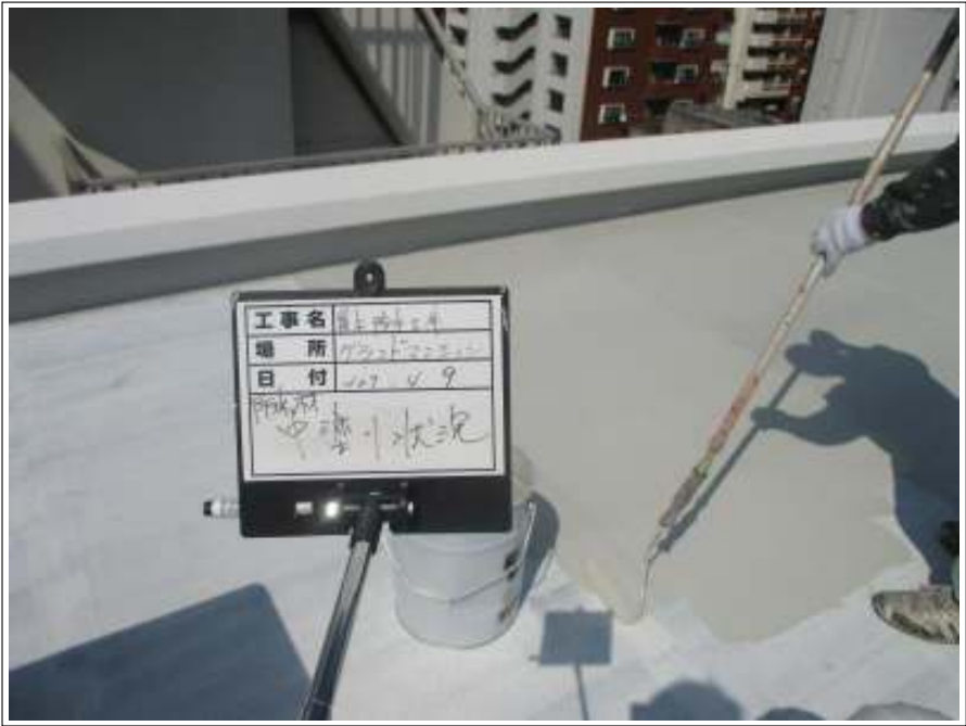
屋上中塗り施工中
