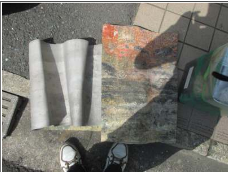
シート防水撤去後
