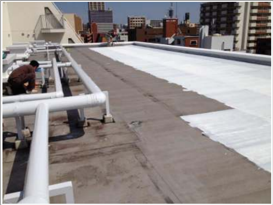
屋上下塗り施工中
