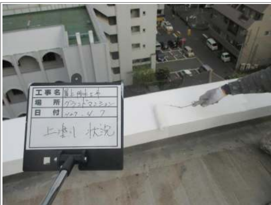
屋上パラペット上塗り施工中
