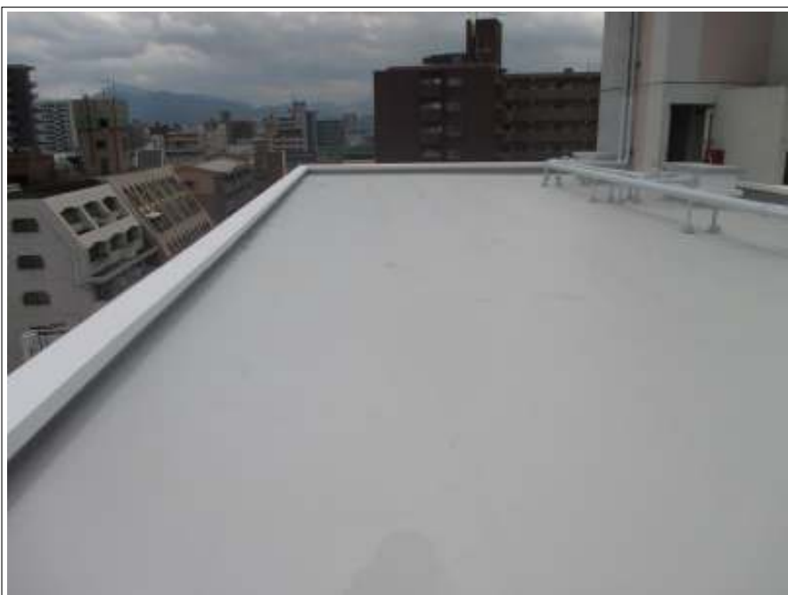
屋上上塗り施工完了
