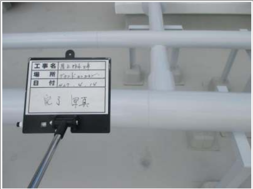
配管施工完了
