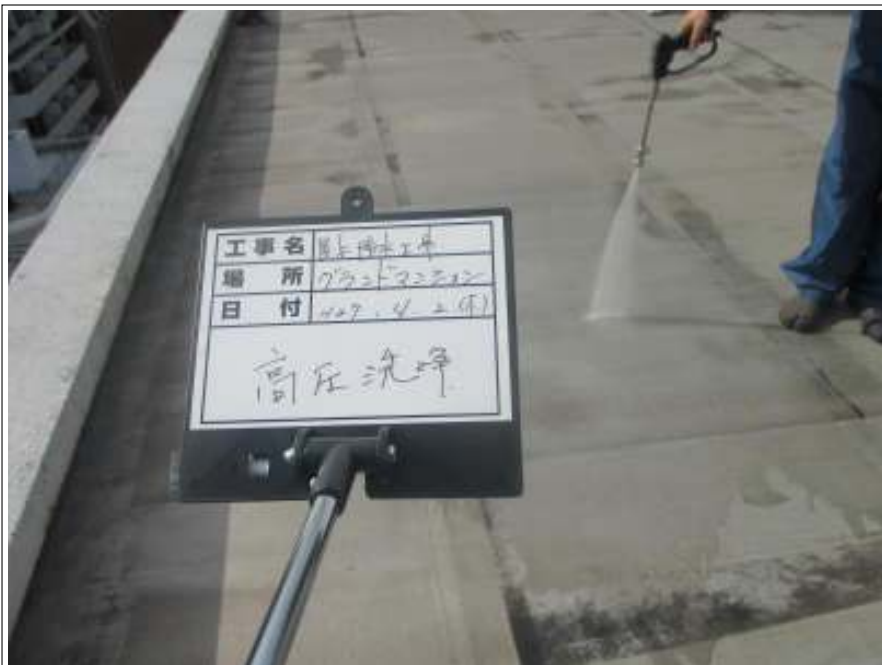
屋上高圧洗浄施工中
