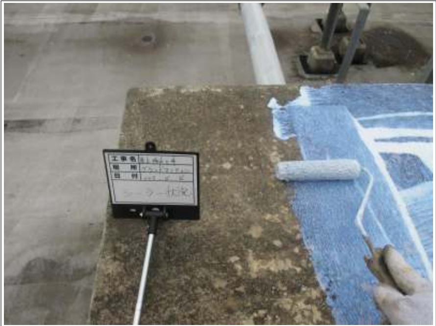
ハト小屋下塗り施工中
