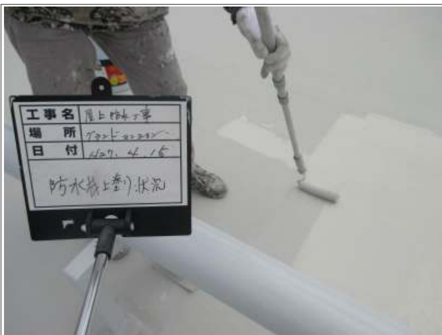
屋上上塗り施工中
