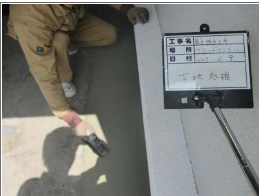
下地処理施工中
