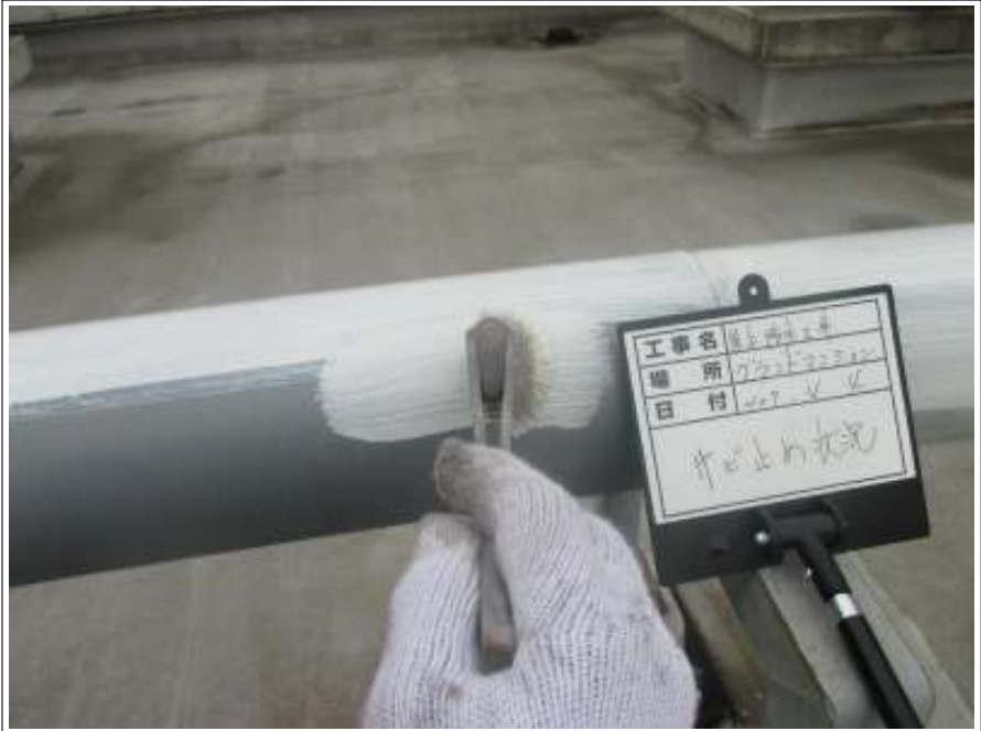
配管サビ止め施工中
