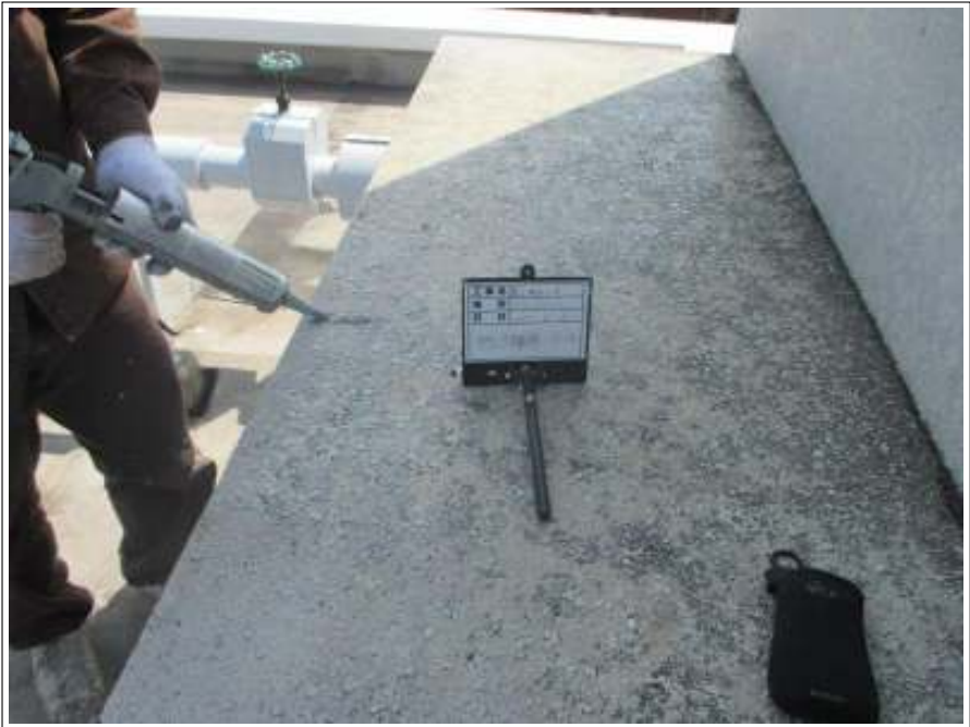
ハト小屋クラック補修施工中
