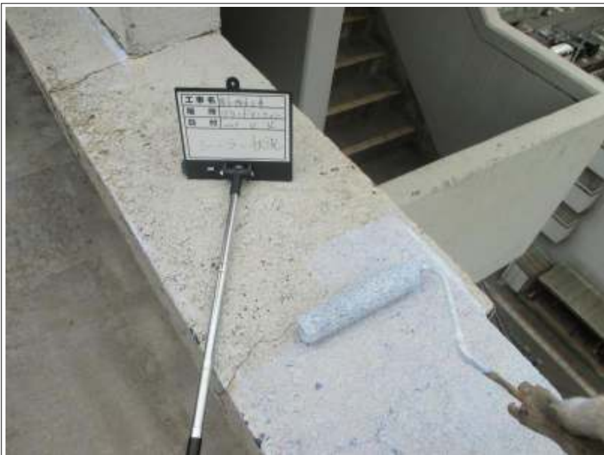
屋上パラペット下塗り施工中
