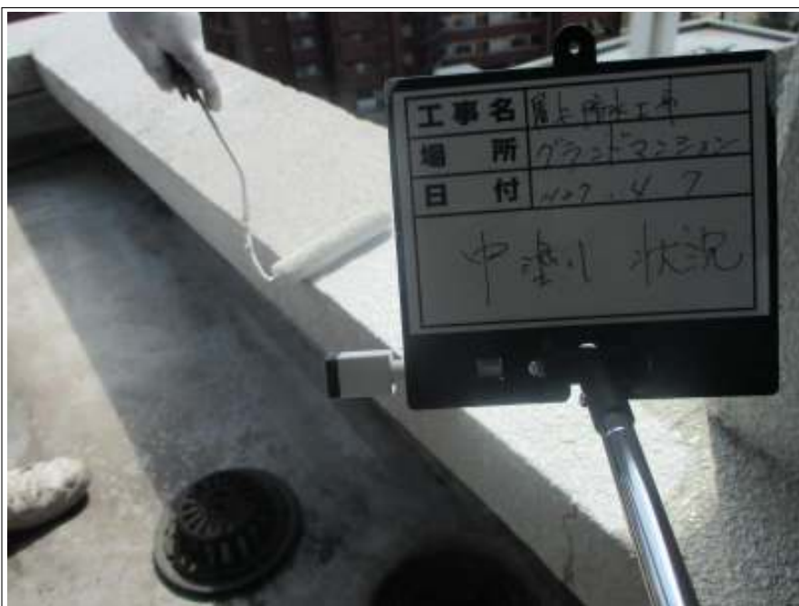
屋上パラペット中塗り施工中
