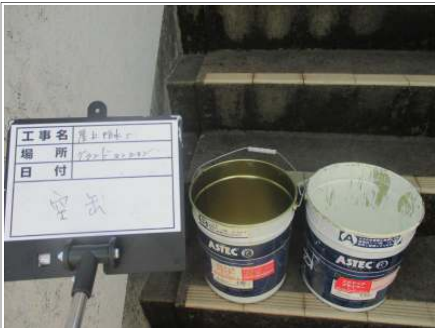
屋上下塗り使用材料空缶
