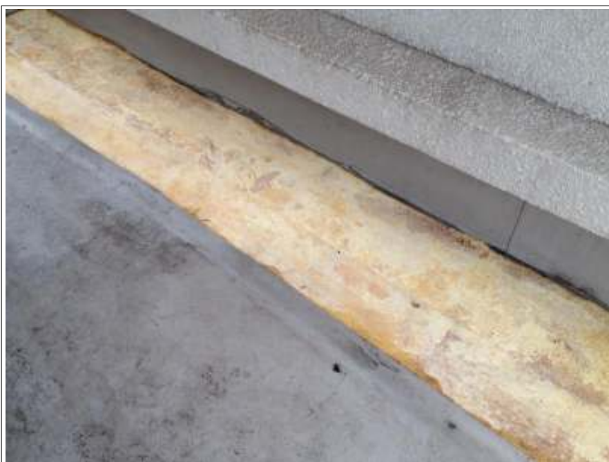
シート防水浮き部撤去後
