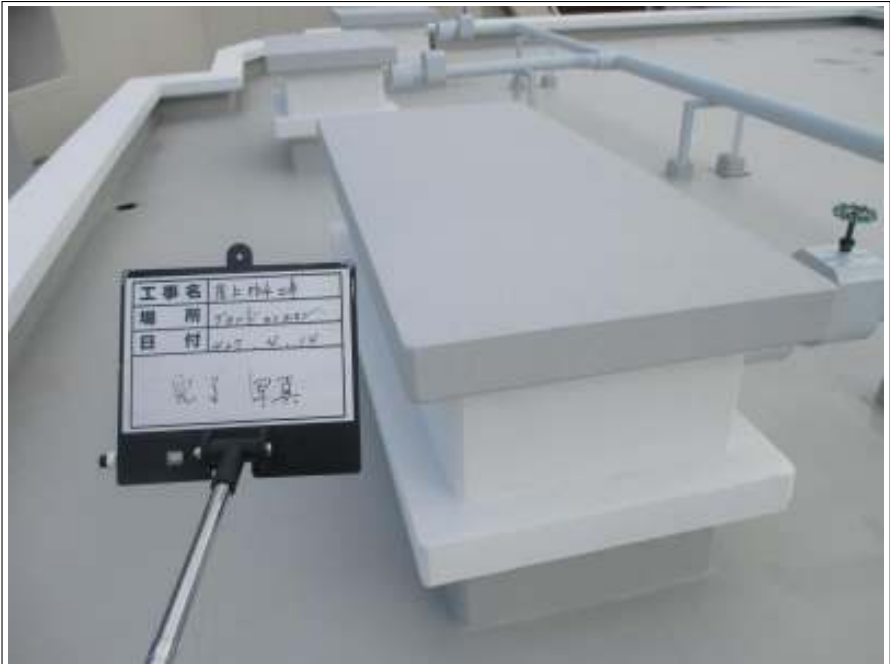
ハト小屋施工完了
