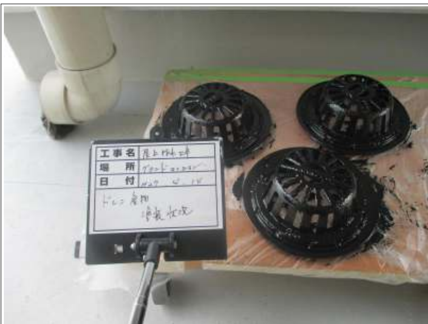
ドレン塗装施工中
