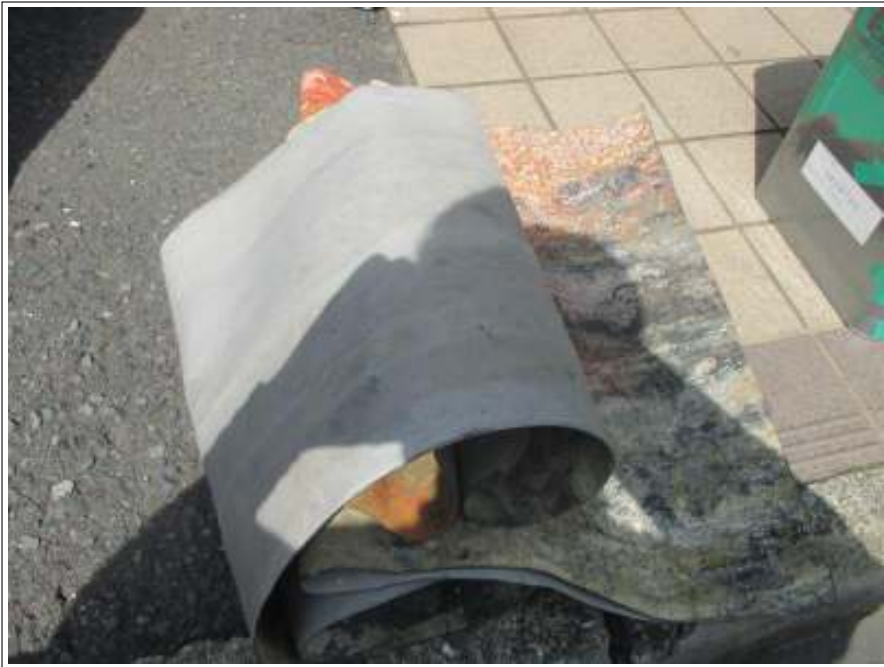
シート防水撤去後
