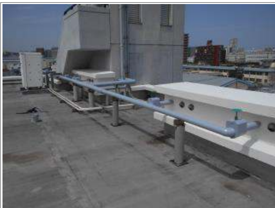
屋上 配管 施工完了
