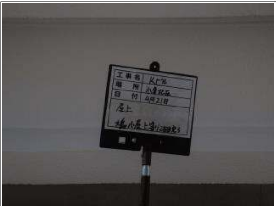
屋上 ハト小屋塗装 上塗り施工完了
