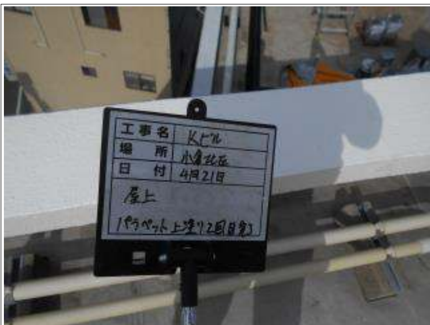
屋上 パラペット 上塗り施工完了
