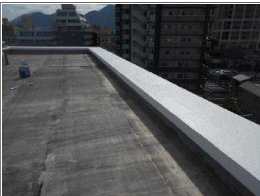
屋上 パラペット 施工完了
