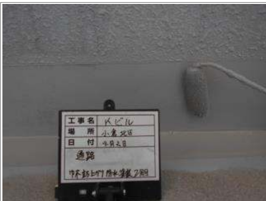
通路部 巾木 防水(2回目) 施工中
