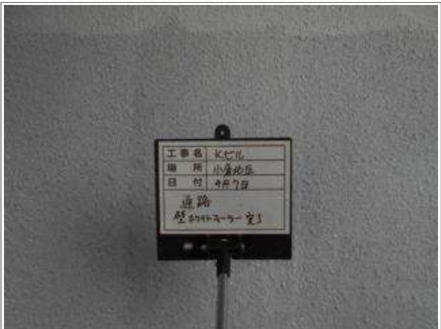
通路部 外壁 下塗り施工完了
