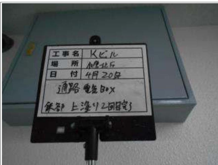
鉄部BOX 上塗り施工完了
