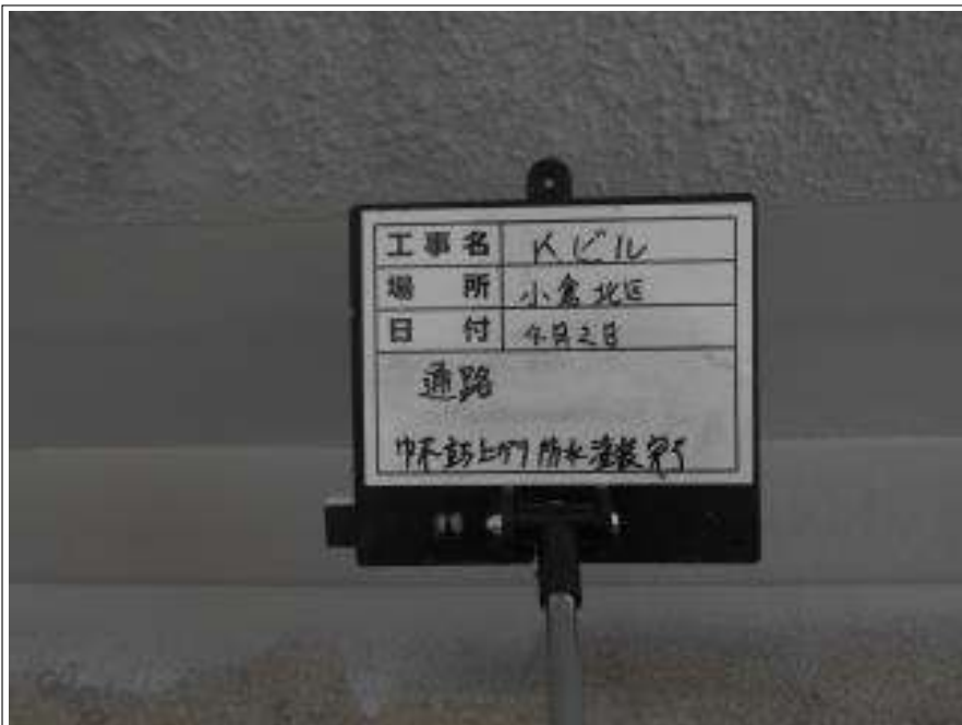
通路部 巾木 防水施工完了
