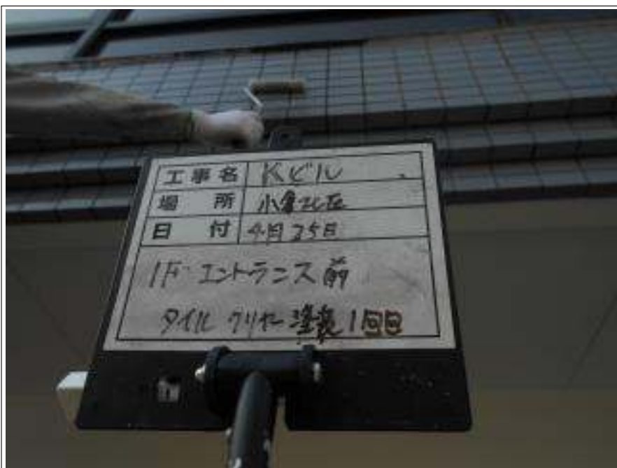
エントランス前タイル クリヤー施工前
