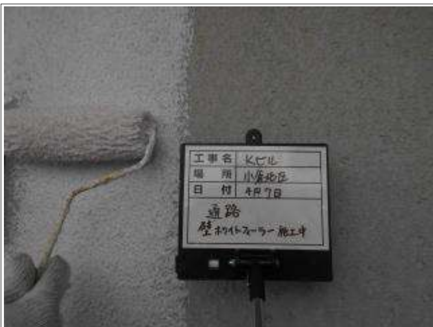
通路部 外壁 下塗り施工中
