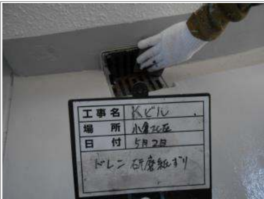
ドレン 研磨紙ずり施工中
