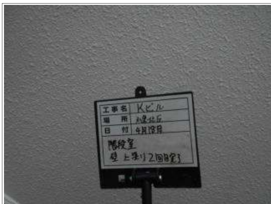
階段室外壁 上塗り施工完了
