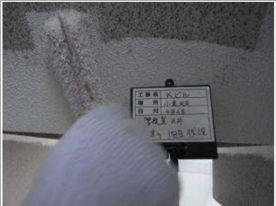
階段室軒天 上塗り(1回目) 施工中
