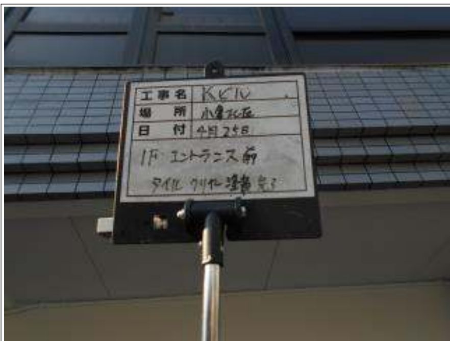
エントランス前タイル クリヤー施工完了
