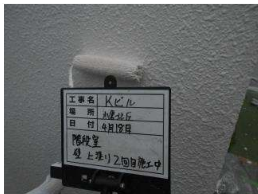
階段室外壁 上塗り施工中
