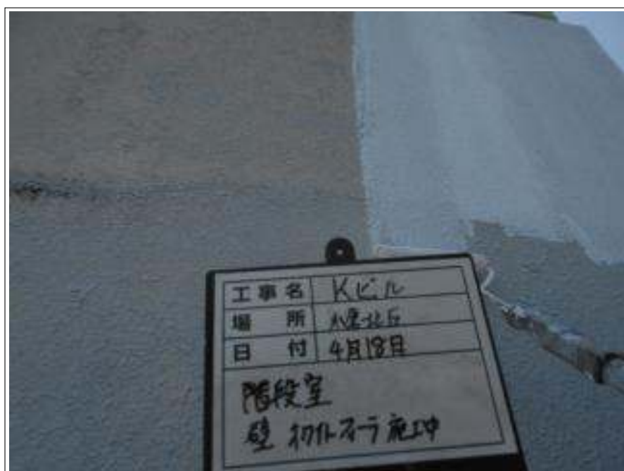
階段室外壁 下塗り施工中
