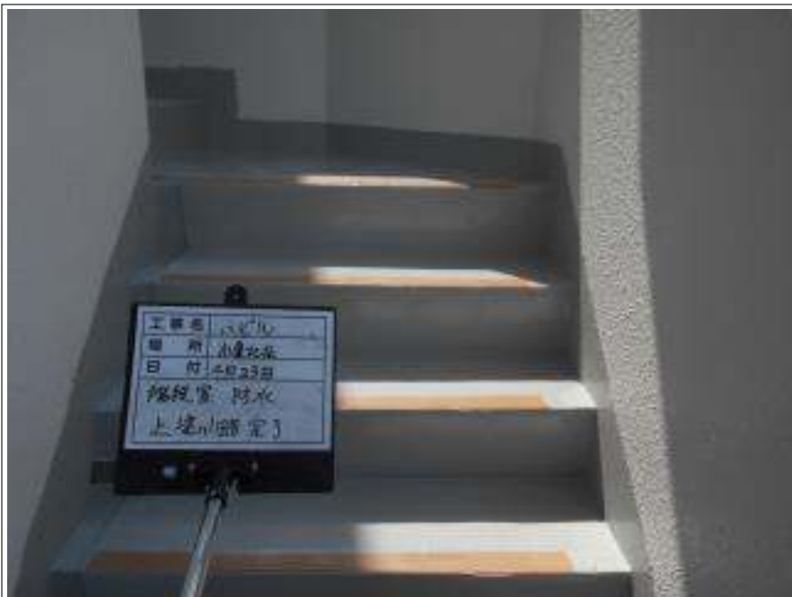
階段室防水 上塗り(1回目) 施工完了
