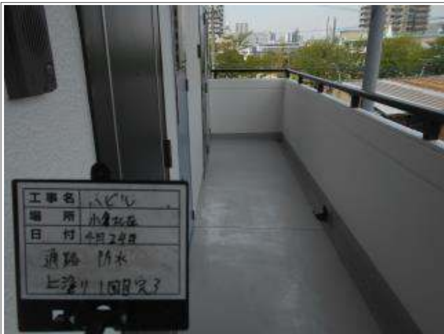
通路部 防水 上塗り(1回目) 施工完了
