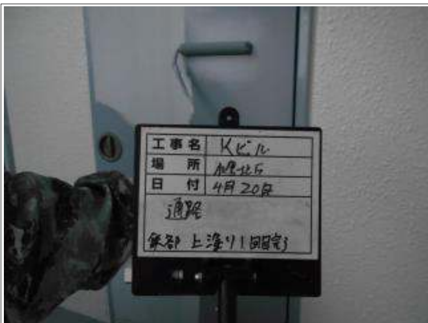
鉄部 中塗り施工中
