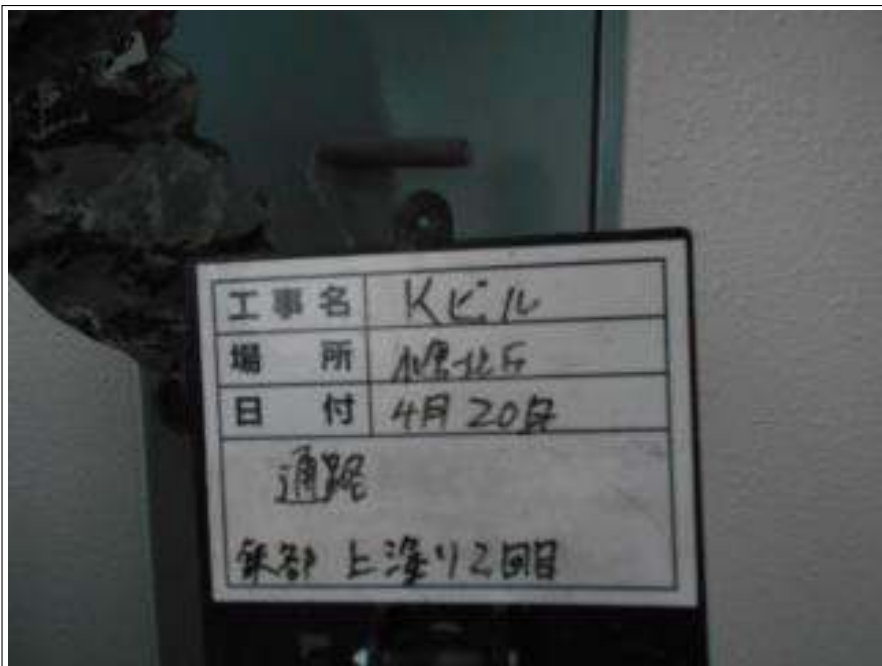
鉄部 上塗り施工中
