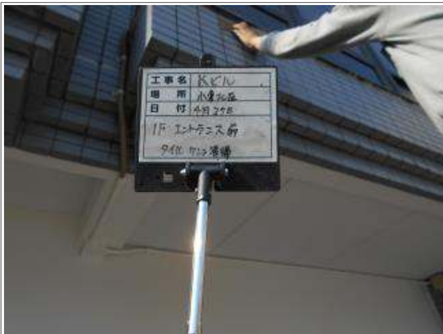
エントランス前タイル ケレン施工中
