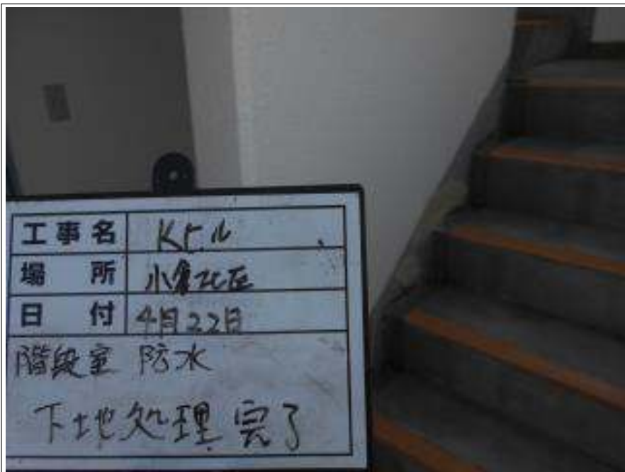
階段室防水 下地処理施工完了
