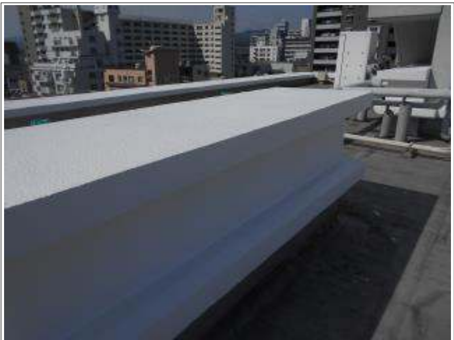
屋上 ハト小屋塗装 施工完了
