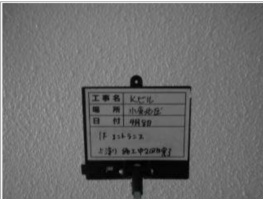
エントランス部 外壁上塗り施工完了
