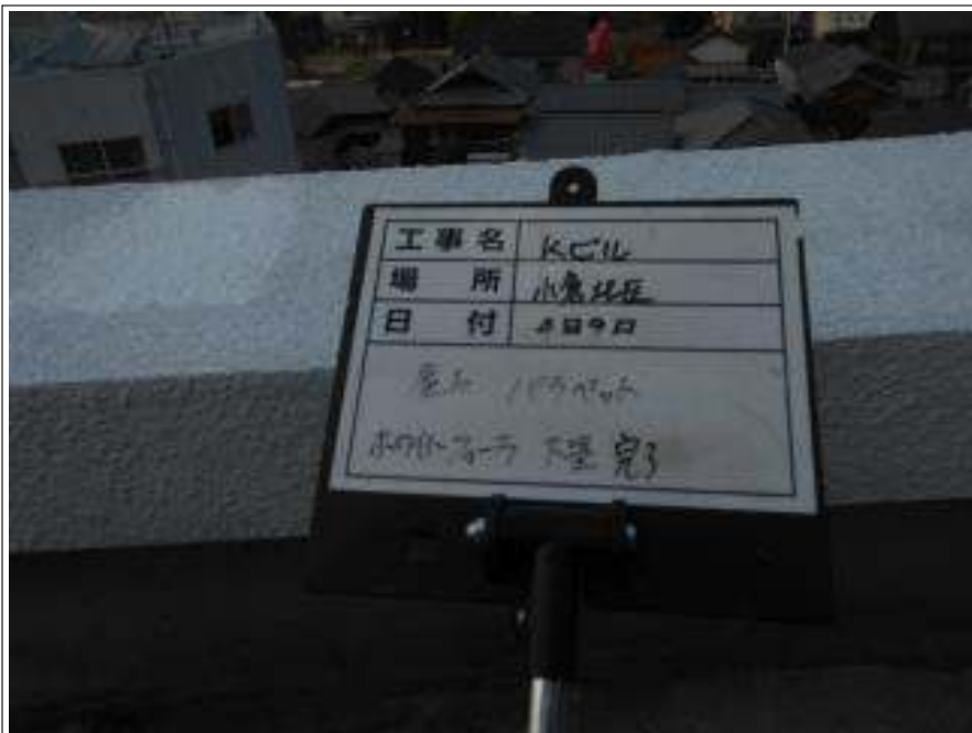
屋上 パラペット 下塗り施工完了
