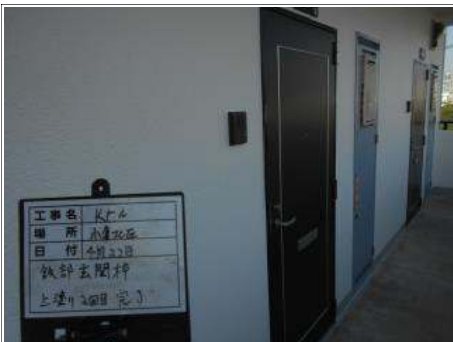
鉄部玄関枠 上塗り施工完了
