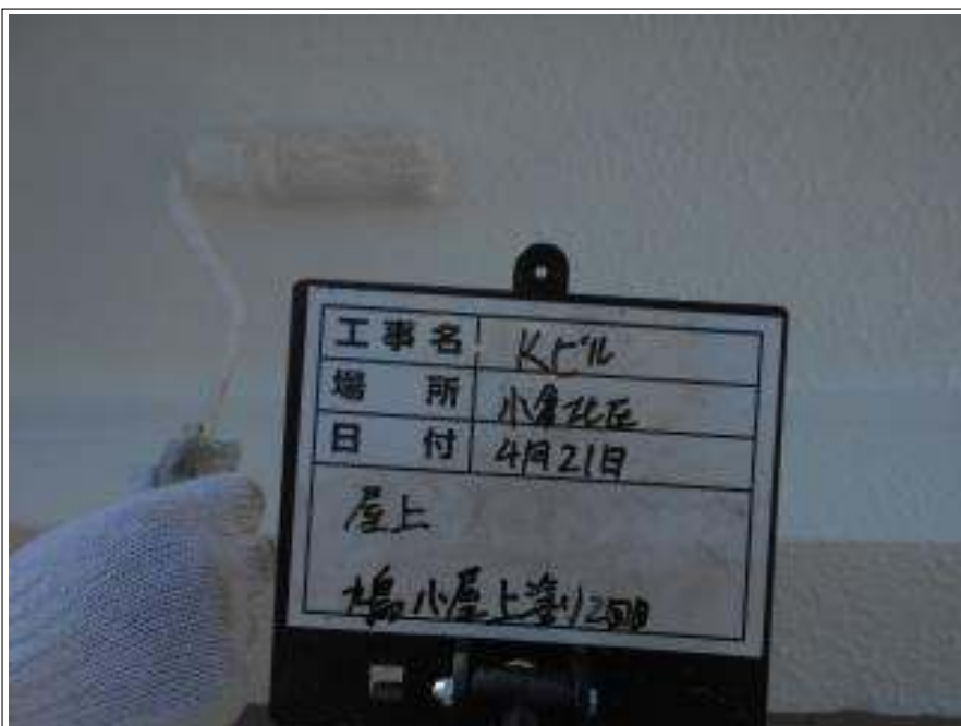
屋上 ハト小屋塗装 上塗り施工中
