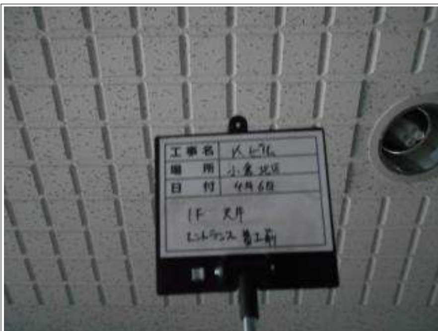
エントランス部 天井 施工前
