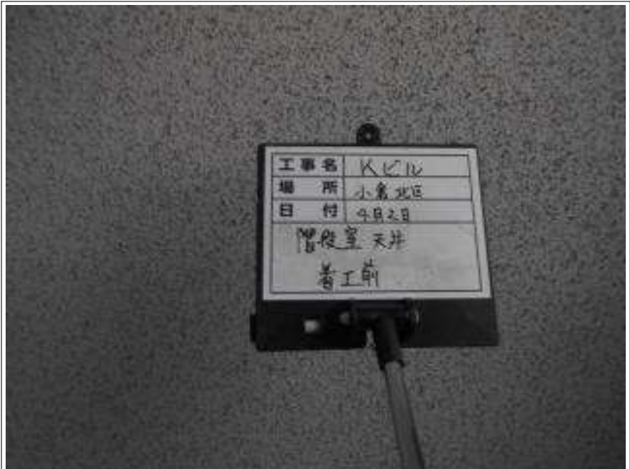
階段室軒天 施工前
