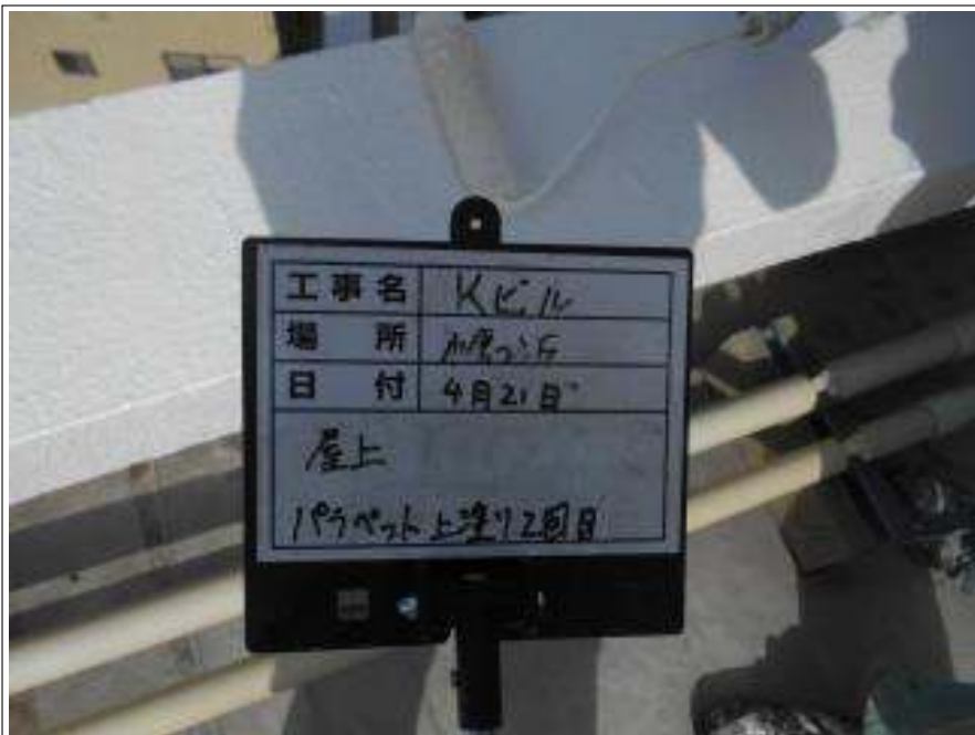
屋上 パラペット 上塗り施工中
