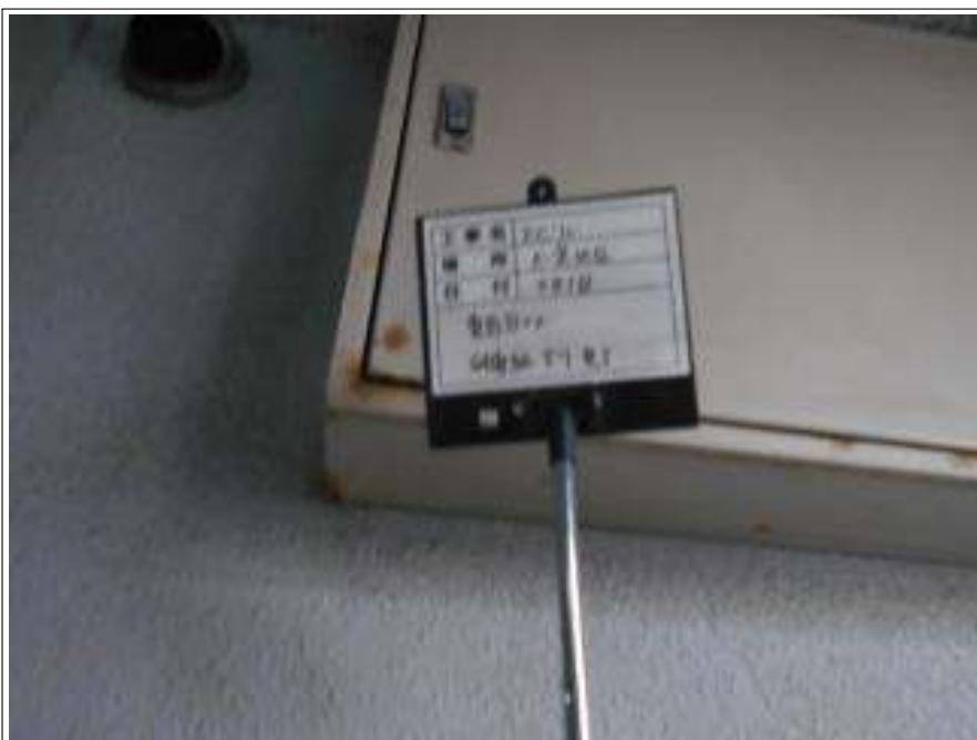
鉄部BOX 研磨紙ずり施工完了
