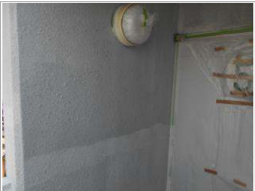
階段室外壁 下塗り施工完了
