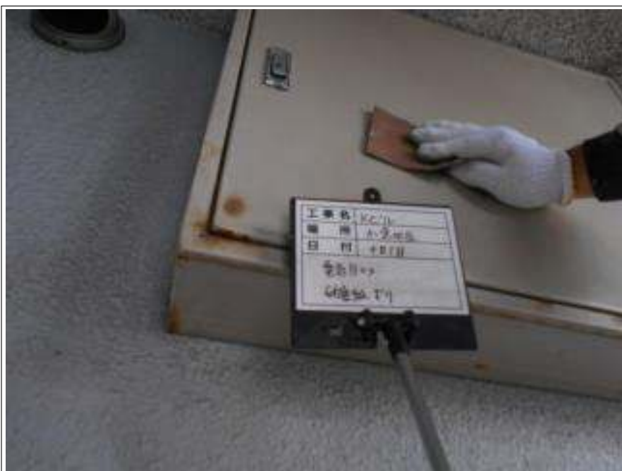
鉄部BOX 研磨紙ずり施工中
