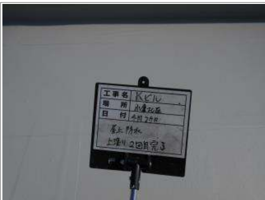
屋上 上塗り施工完了
