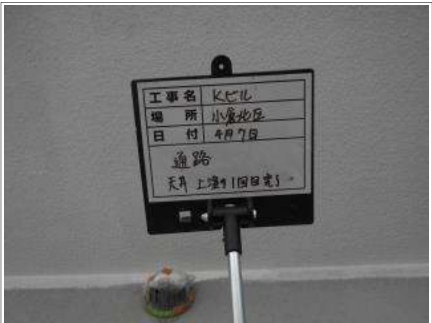
通路部 軒天 上塗り(1回目) 施工完了
