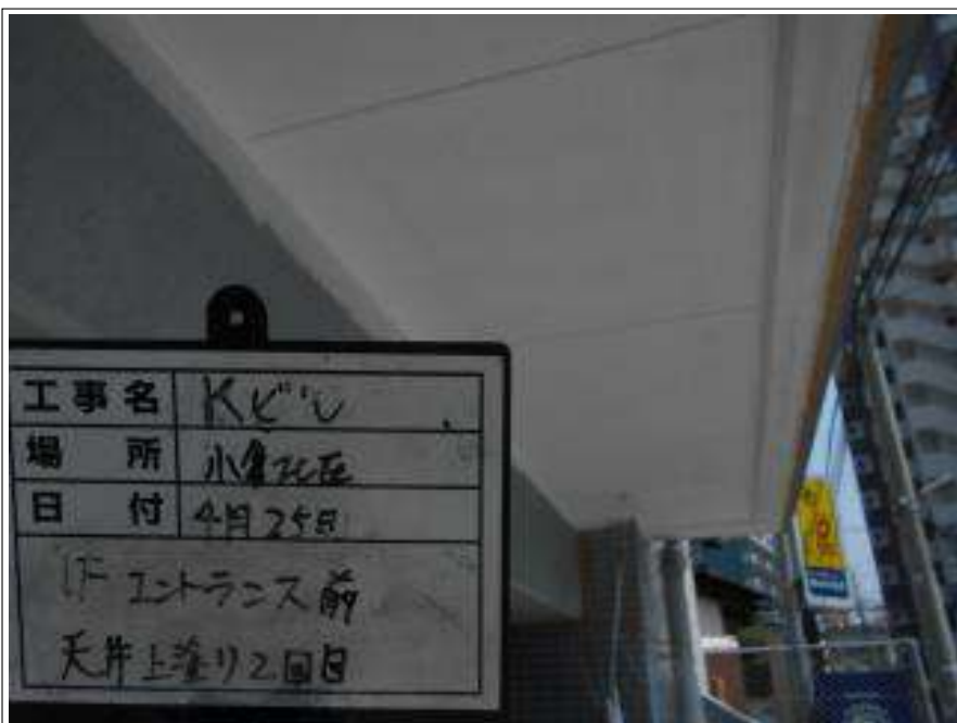
エントランス前軒天 上塗り施工中
