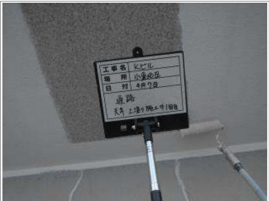
通路部 軒天 上塗り(1回目) 施工中
