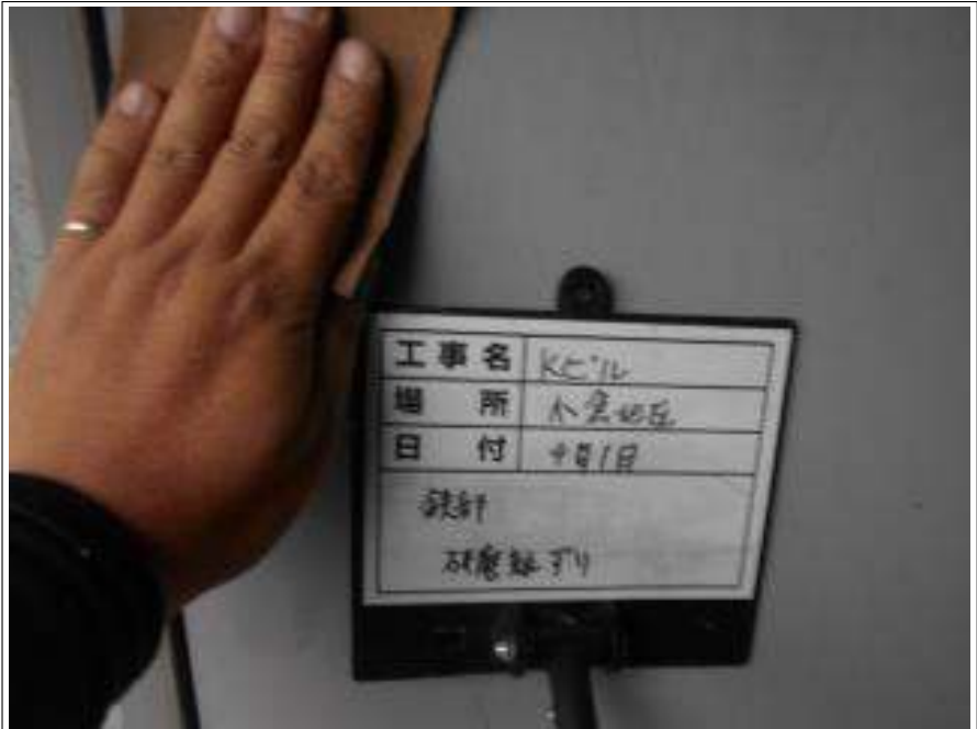
鉄部 研磨紙張り施工中
