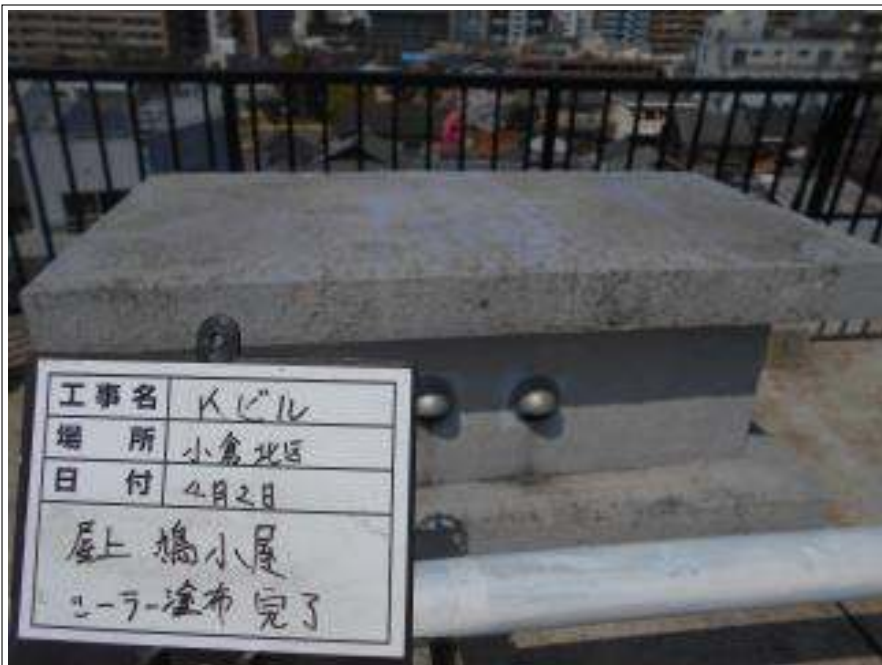
屋上 ハト小屋塗装 下塗り施工完了
