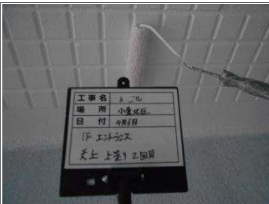
エントランス部 天井 上塗り施工中
