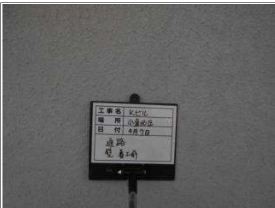
通路部 外壁 施工前
