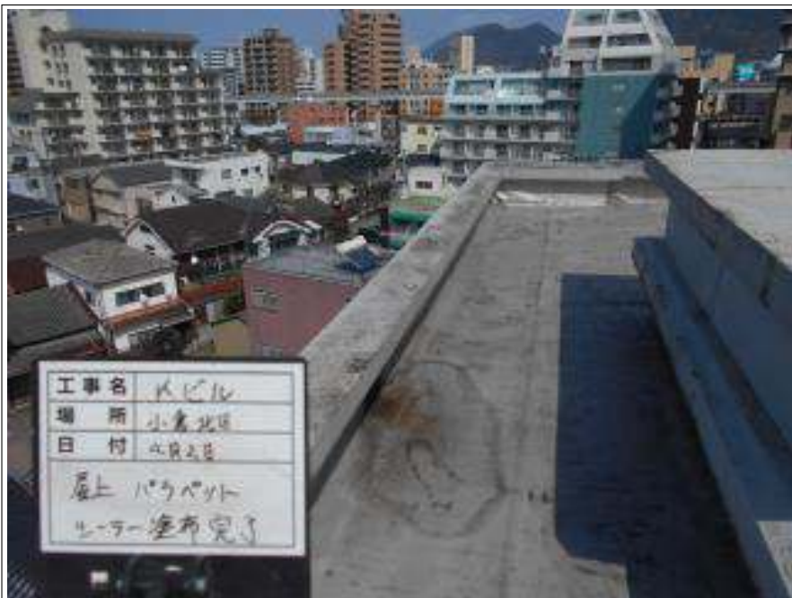
屋上 パラペット 下塗り施工完了
