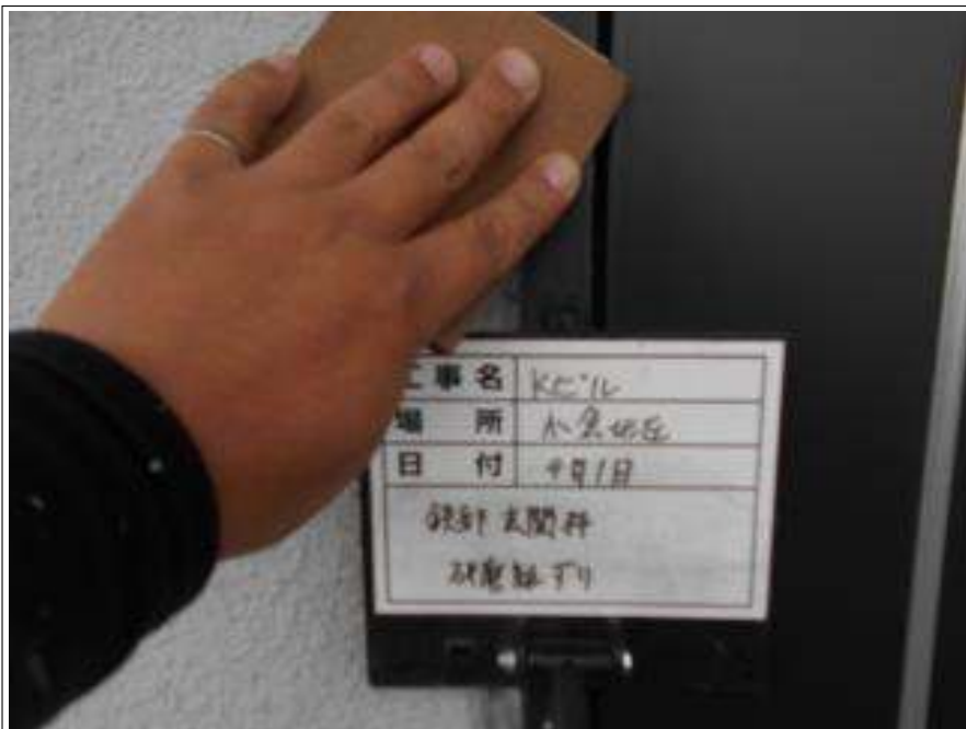
鉄部玄関枠 研磨紙ずり施工中
