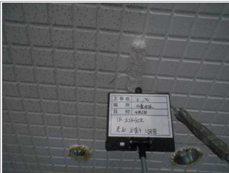
エントランス部 天井 上塗り施工中
