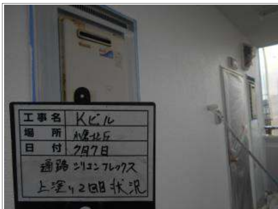
通路部 外壁 上塗り施工中
