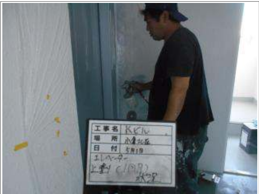
エレベーター 上塗り(1回目) 施工中
