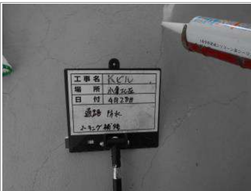
通路部 防水 コーキング施工中
