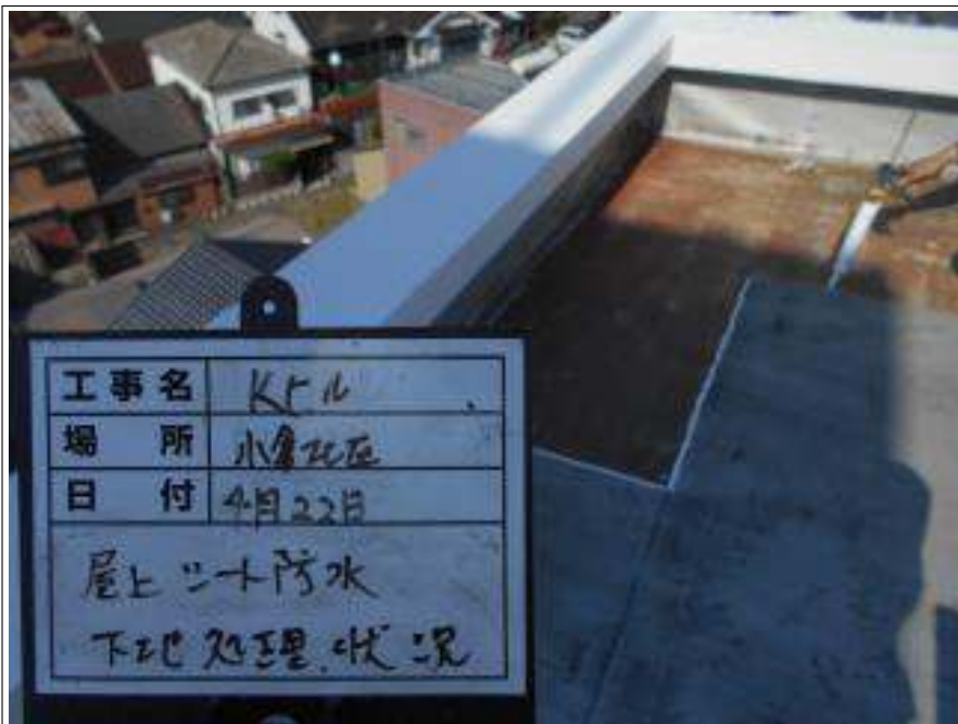
屋上 シート防水下地処理施工中
