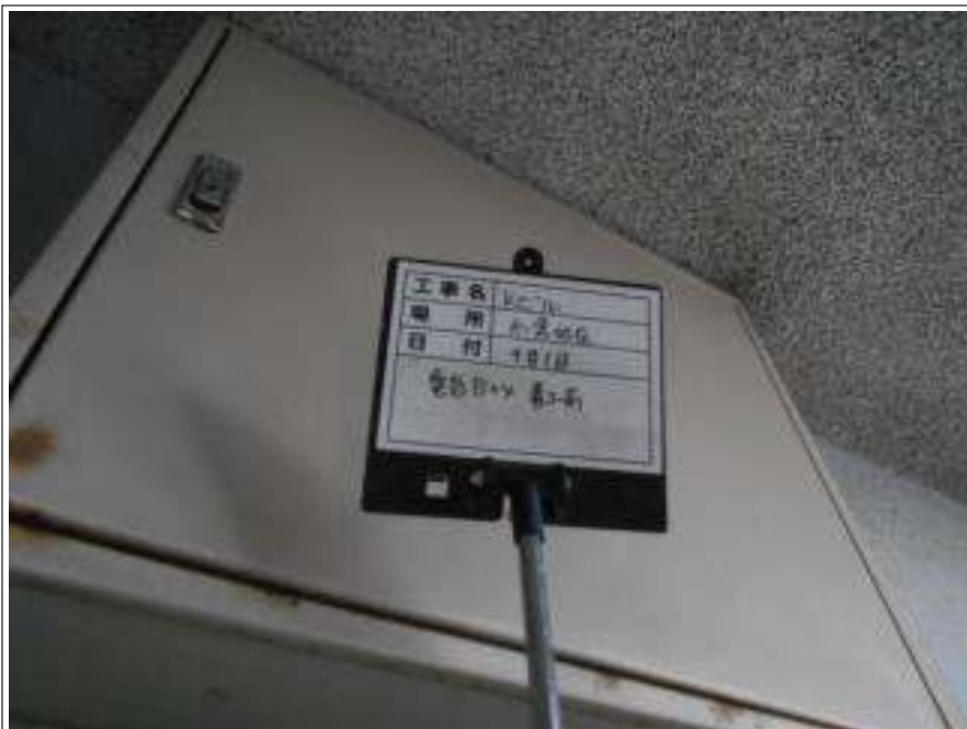
鉄部BOX 施工前
