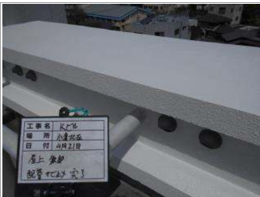
屋上 配管サビ止め施工完了
