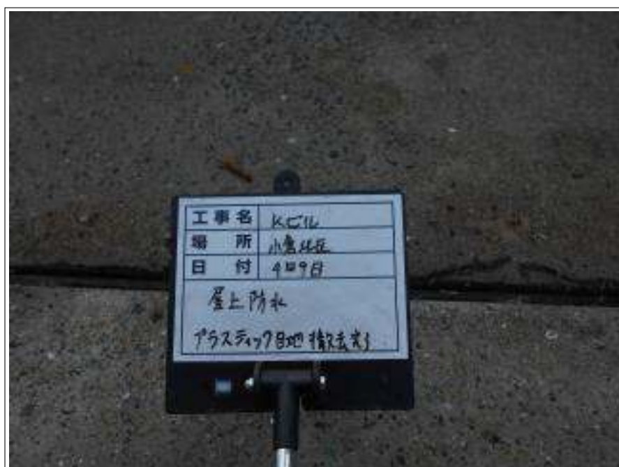
屋上 プラスチック目地撤去施工完了
