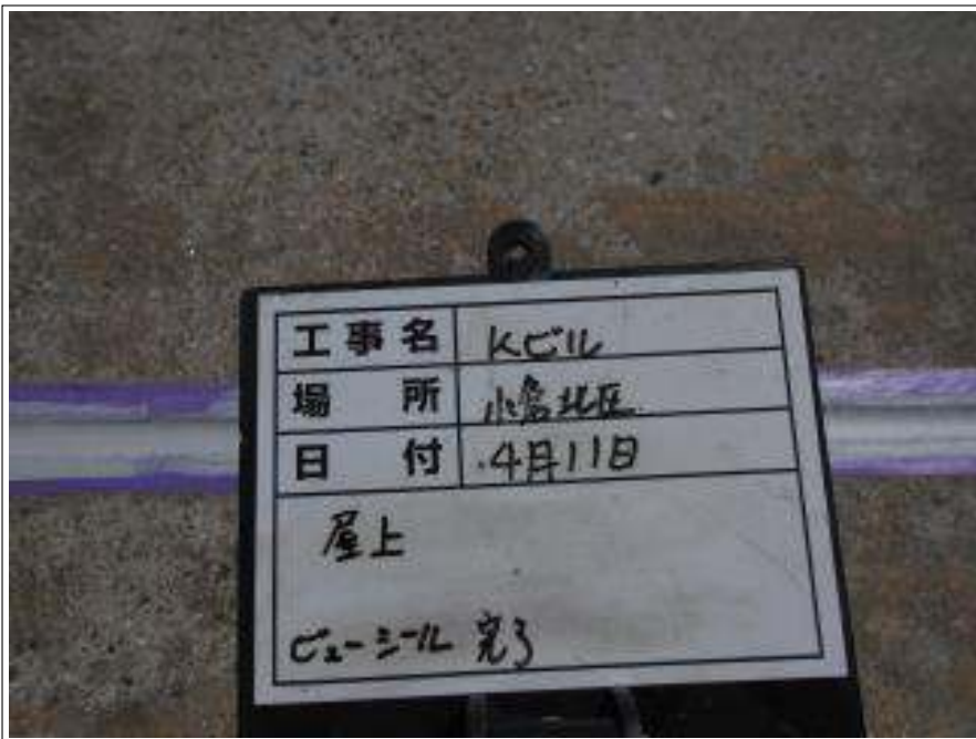
屋上 シーリング補修 施工完了
