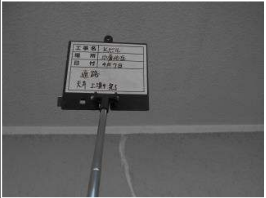
通路部 軒天 上塗り(2回目) 施工完了
