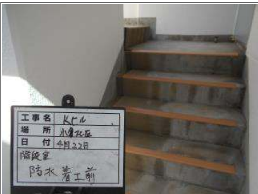
階段室防水 施工前
