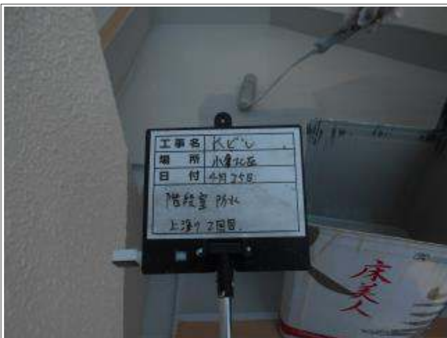
階段室防水 上塗り(2回目) 施工中
