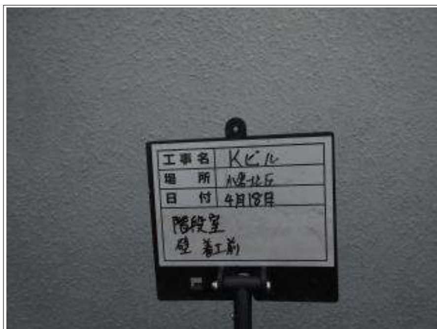
階段室外壁 施工前
