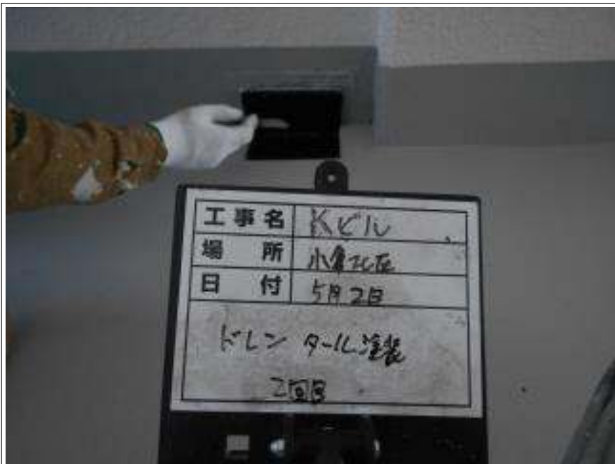
ドレン タール塗装(2回目) 施工中
