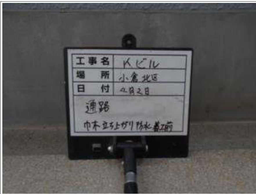
通路部 巾木 防水施工前
