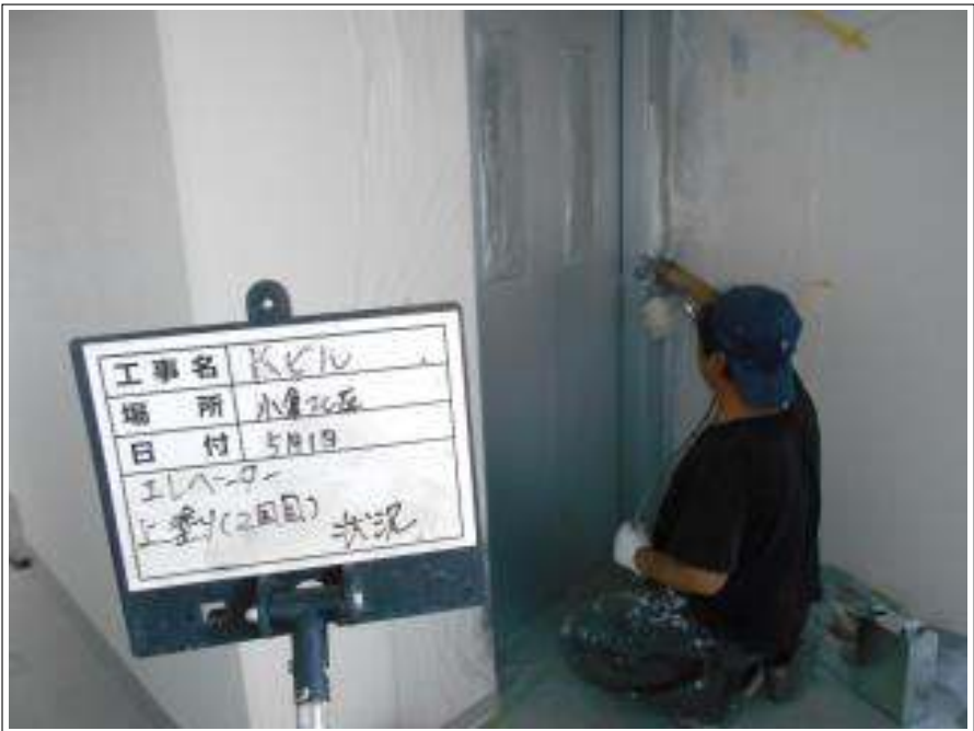
エレベーター 上塗り(2回目) 施工中
