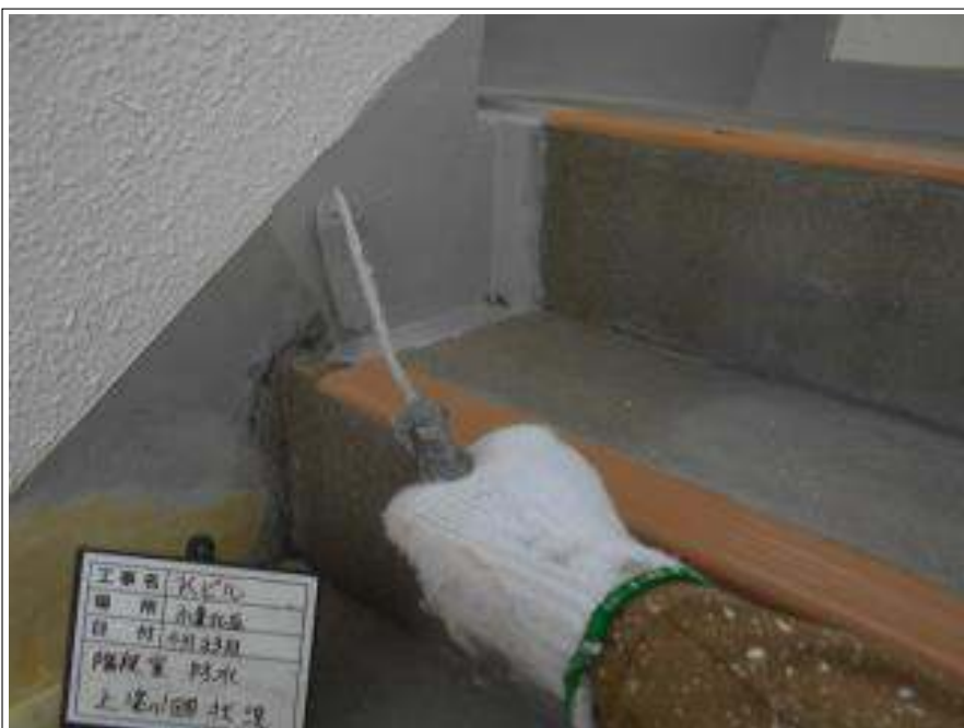
階段室防水 上塗り(1回目) 施工中
