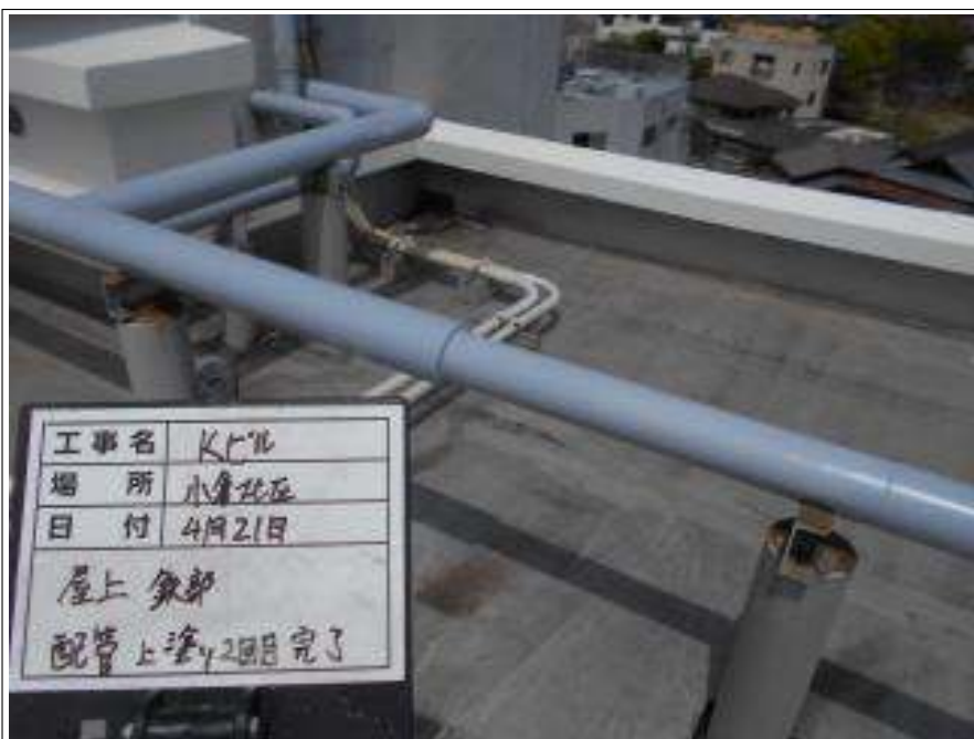
屋上 配管上塗り施工完了
