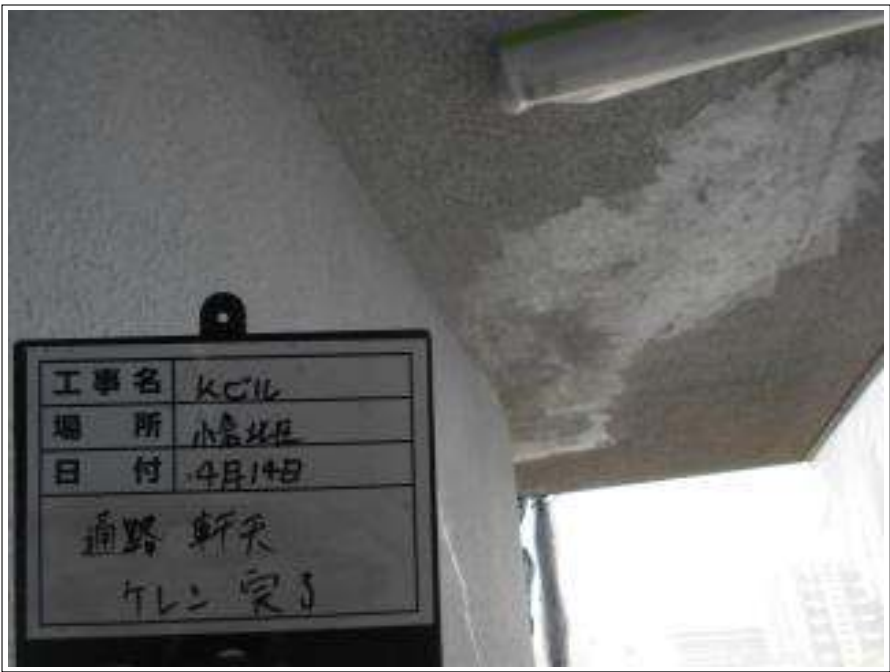
通路部 軒天 ケレン施工完了
