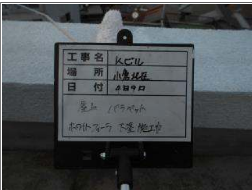
屋上 パラペット 下塗り施工中
