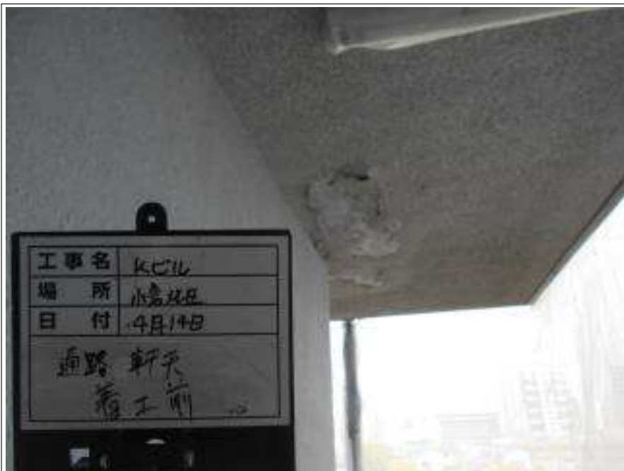
通路部 軒天 施工前
