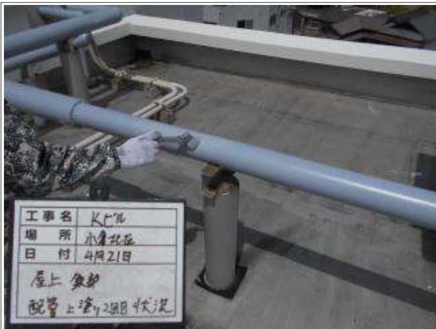
屋上 配管上塗り施工中
