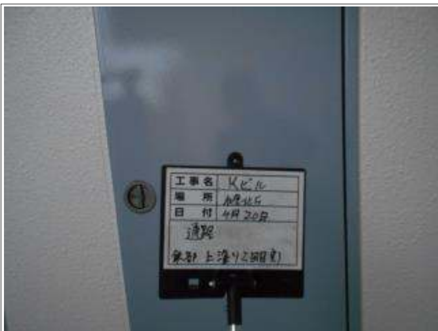
鉄部 上塗り施工完了
