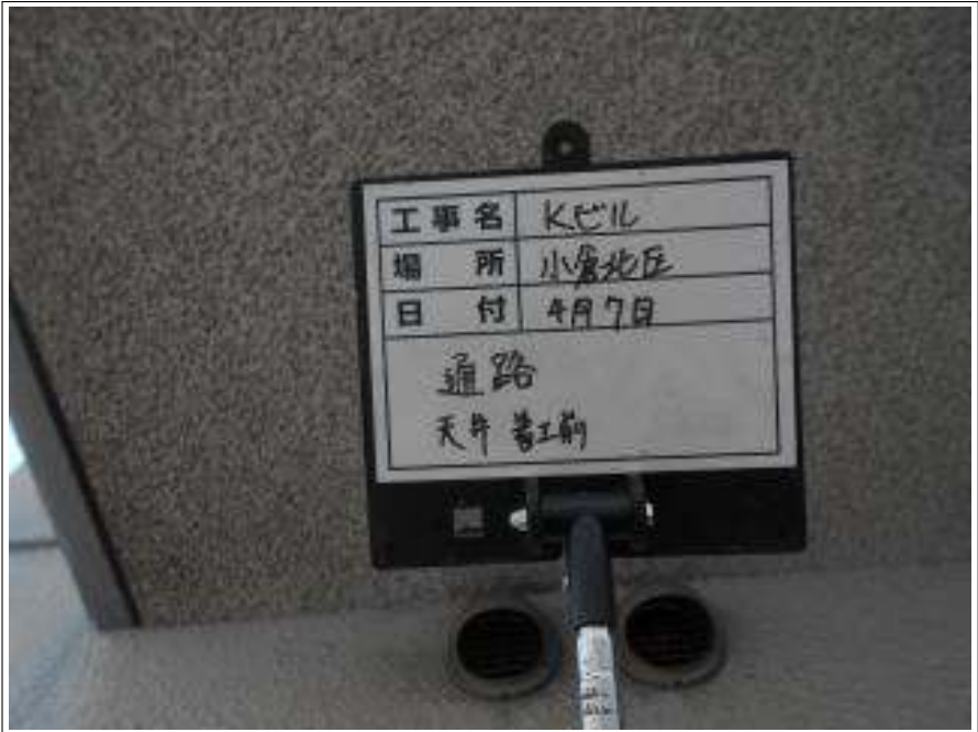
通路部 軒天 施工前
