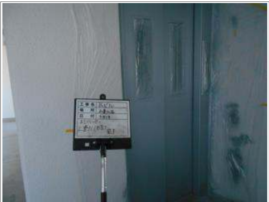
エレベーター 上塗り(1回目) 施工完了
