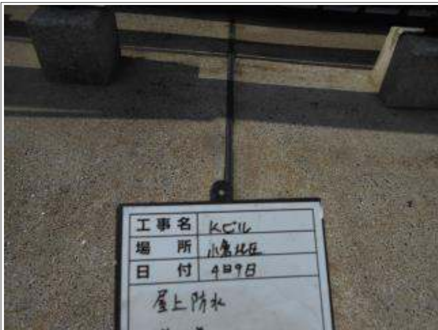
屋上 プラスチック目地撤去施工前
