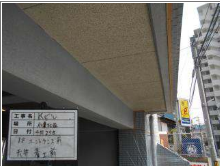
エントランス前軒天 施工前
