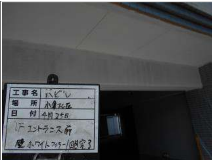
エントランス前外壁 下塗り完了
