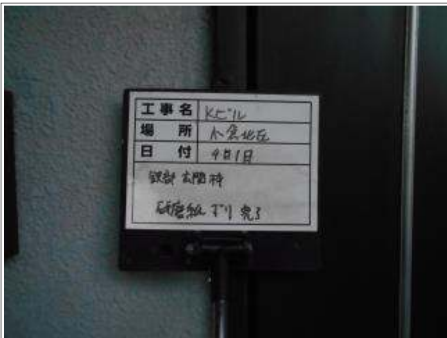
鉄部玄関枠 研磨紙ずり施工完了
