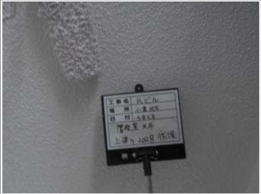
階段室軒天 上塗り(2回目) 施工中
