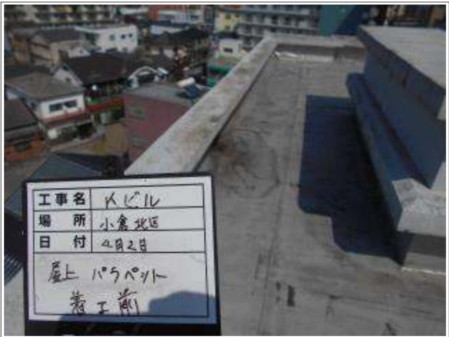
屋上 パラペット 施工前
