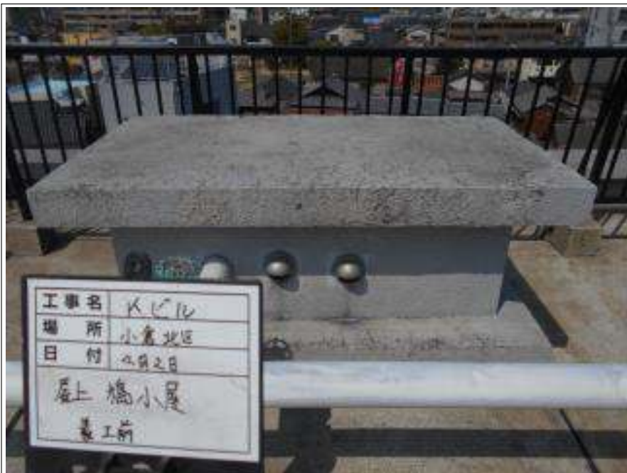
屋上 ハト小屋塗装 施工前
