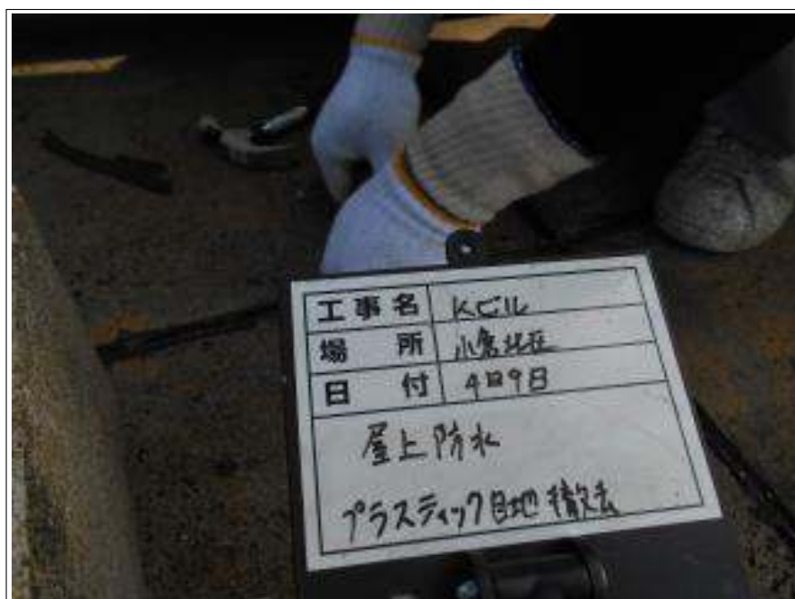
屋上 プラスチック目地撤去施工中
