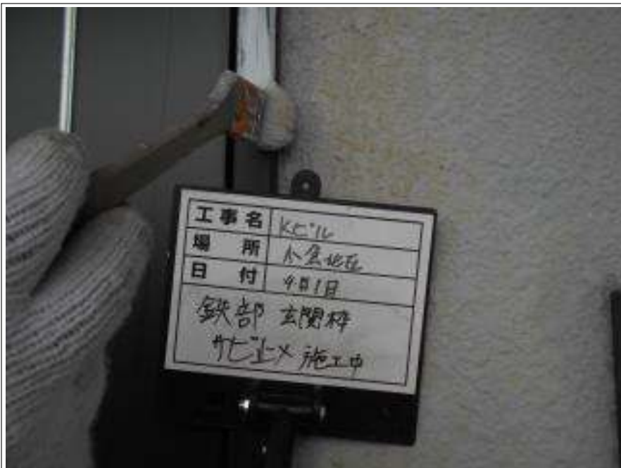
鉄部玄関枠 サビ止め施工中
