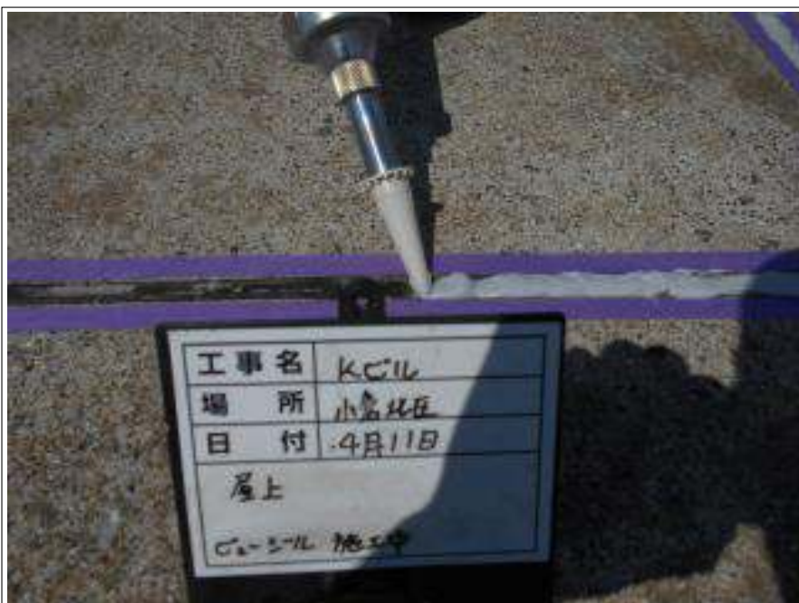
屋上 シーリング補修 施工中
