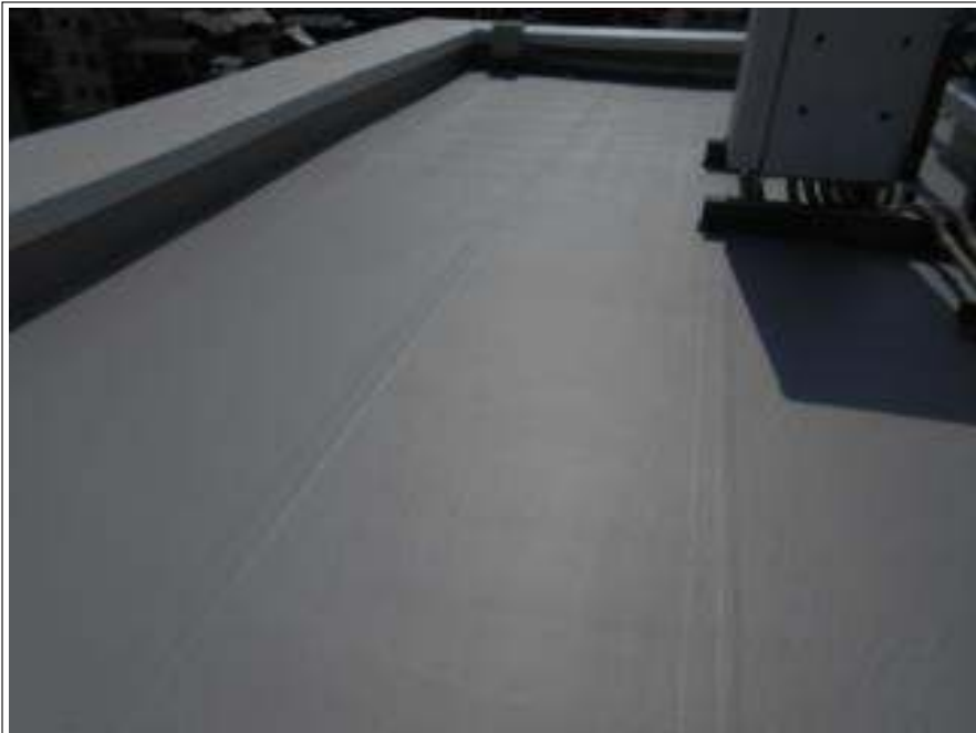
屋上 施工完了
