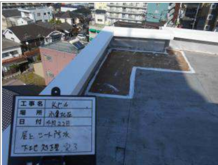
屋上 シート防水下地処理施工完了
