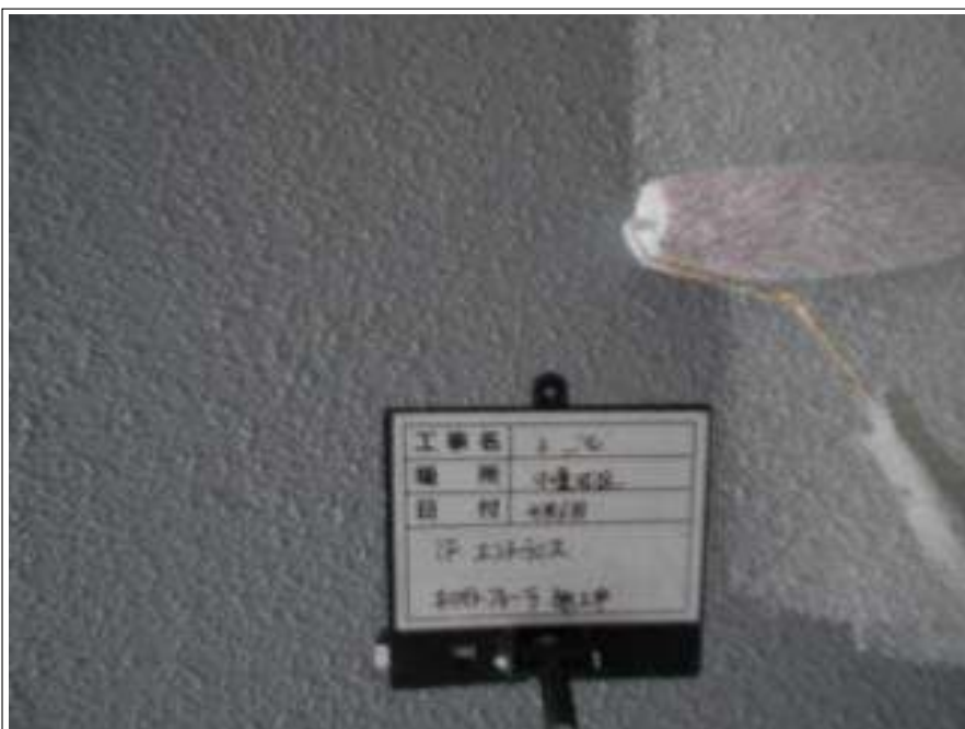
エントランス部 外壁下塗り施工中
