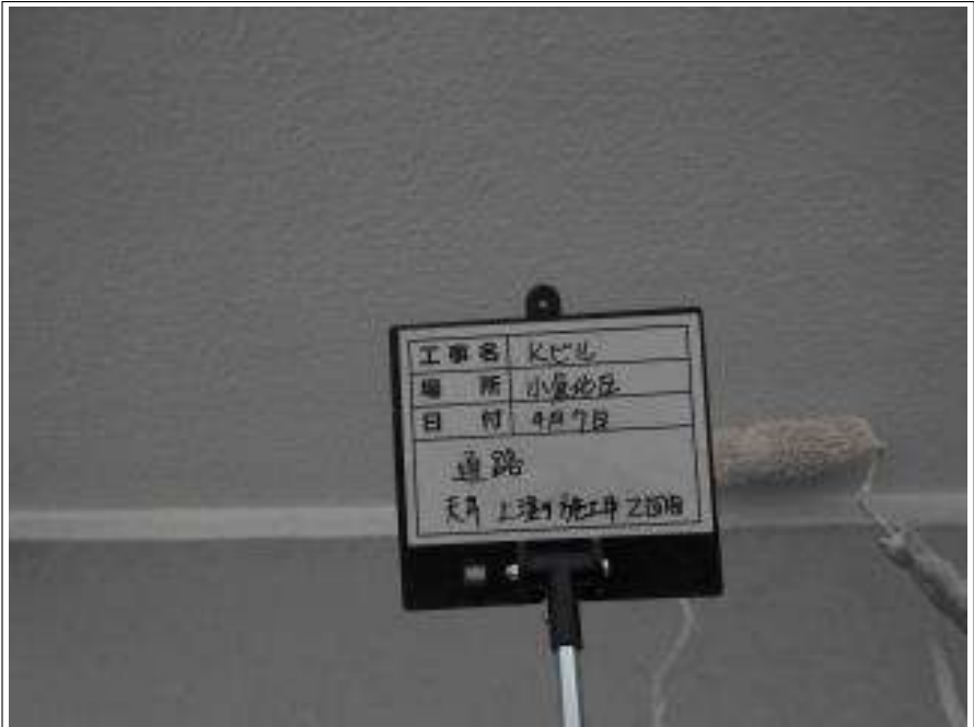
通路部 軒天 上塗り(2回目) 施工中
