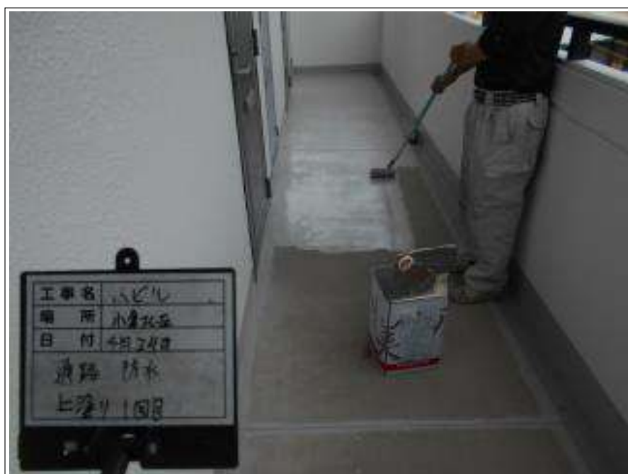
通路部 防水 上塗り(1回目) 施工中
