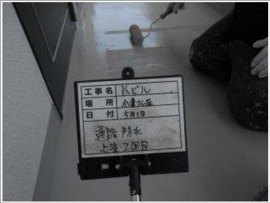
通路部 防水 上塗り(2回目) 施工中
