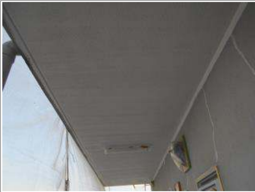
通路部 軒天 施工完了
