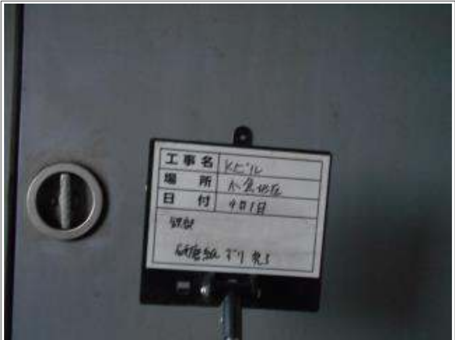
鉄部 研磨紙張り施工完了
