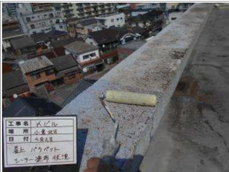
屋上 パラペット 下塗り施工中
