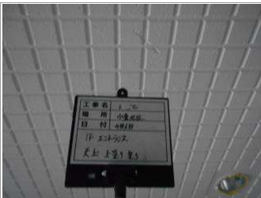
エントランス部 天井 上塗り施工完了
