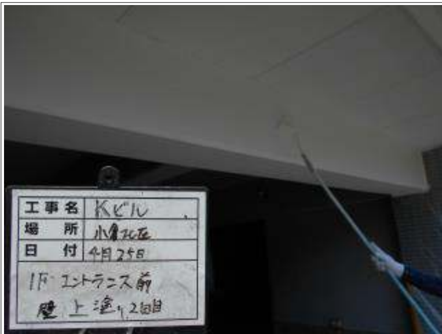
エントランス前外壁 上塗り施工中
