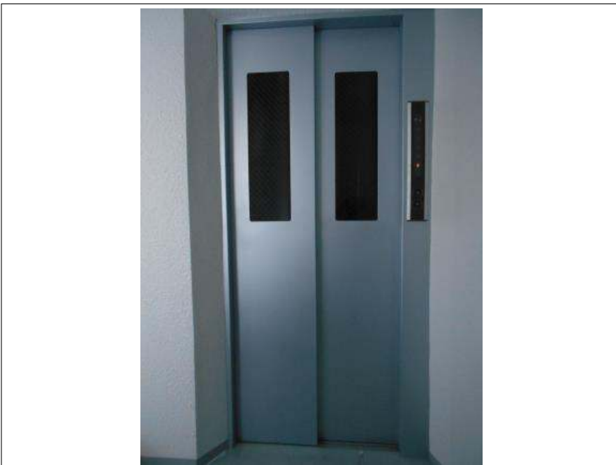
エレベーター 施工完了
