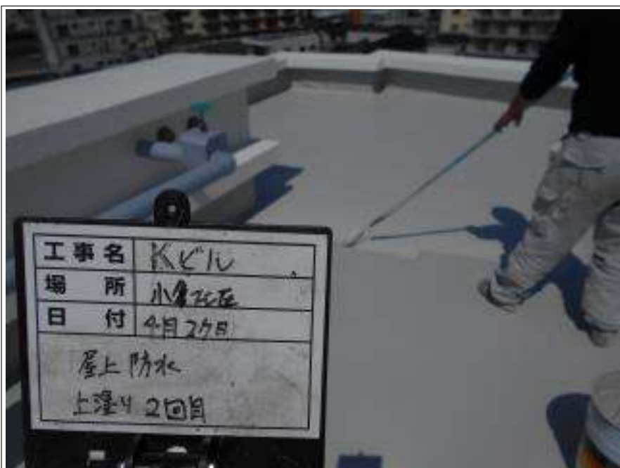
屋上 上塗り施工中
