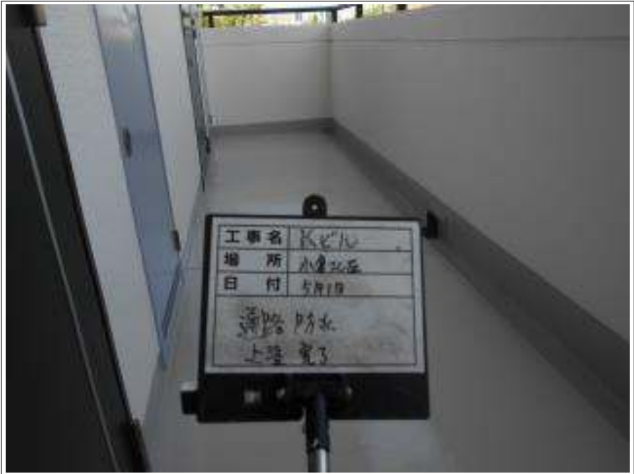
通路部 防水 上塗り(2回目) 施工完了
