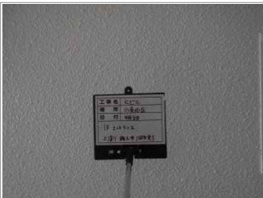
エントランス部 外壁中塗り施工完了
