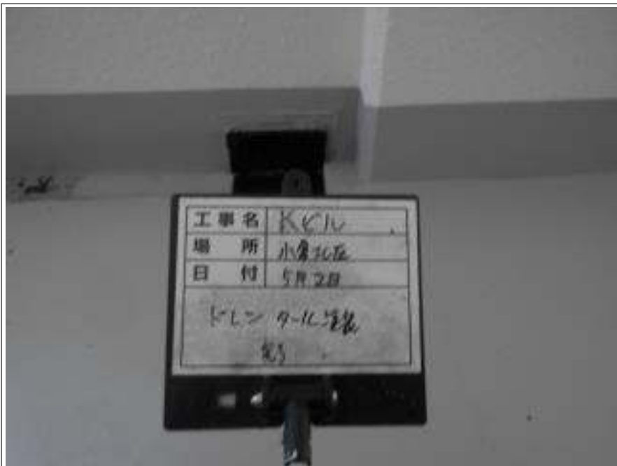
ドレン タール塗装(2回目) 施工完了
