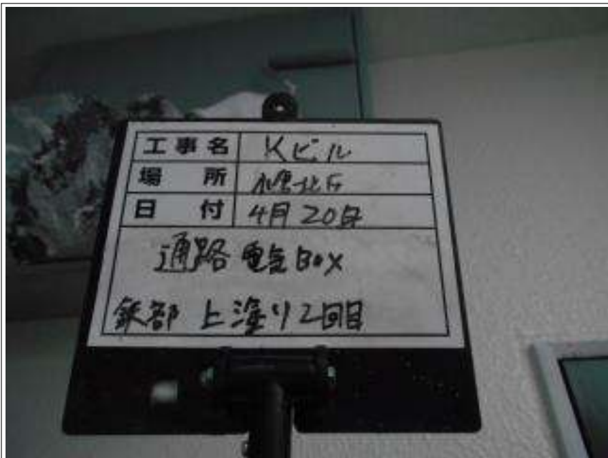
鉄部BOX 上塗り施工中
