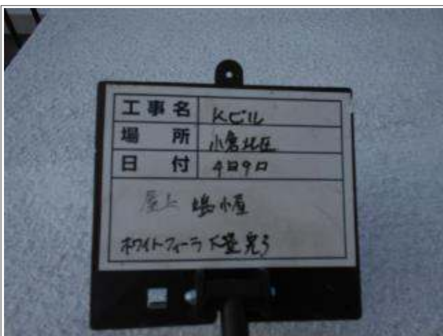
屋上 ハト小屋塗装 下塗り施工完了
