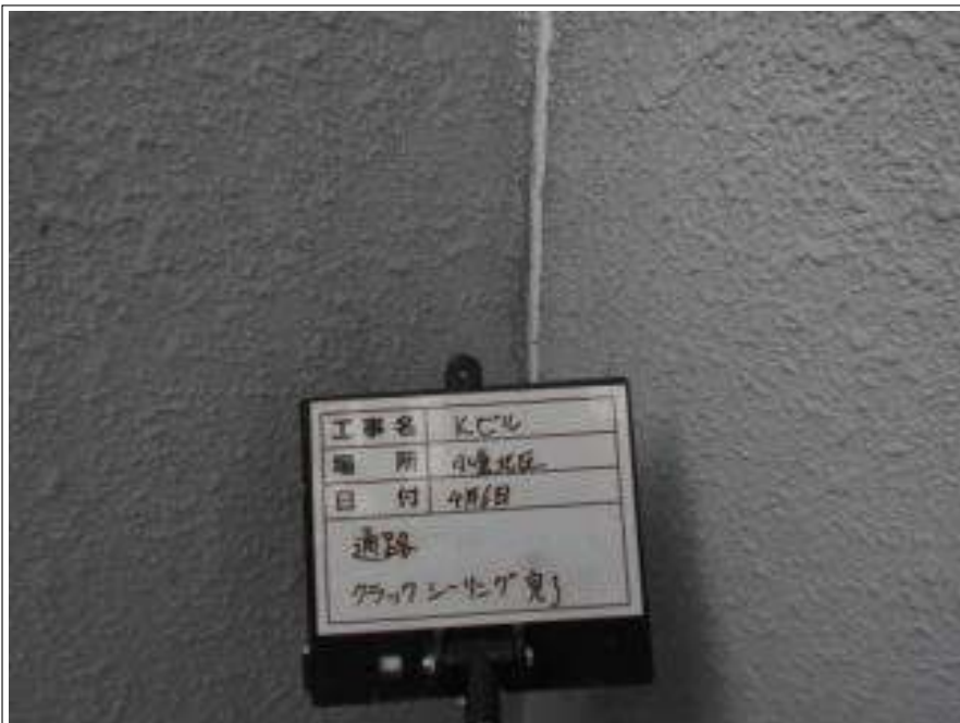
外壁 クラック補修施工完了
