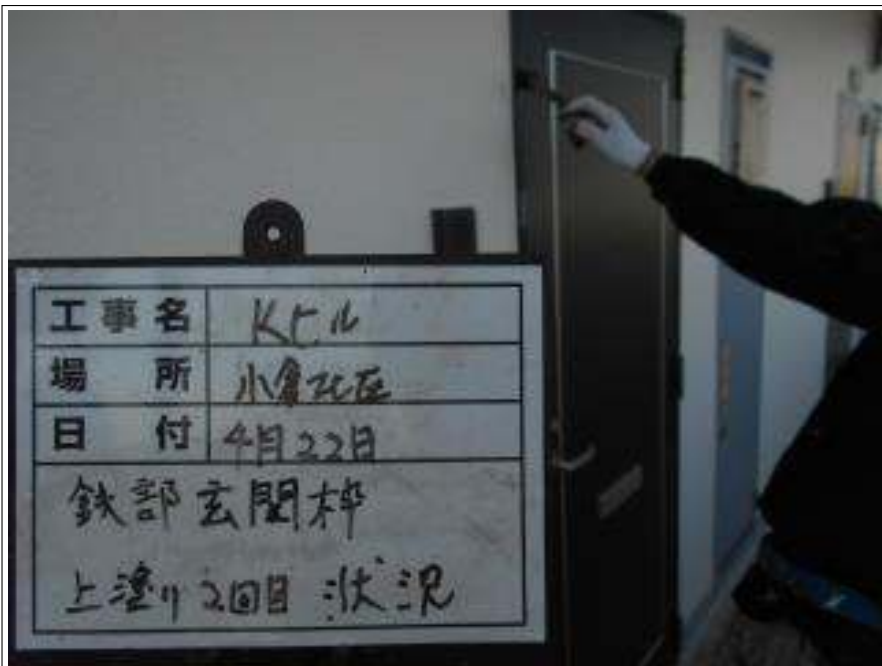
鉄部玄関枠 上塗り施工中
