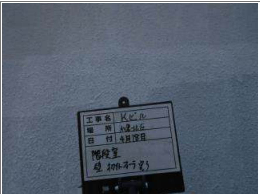
階段室外壁 下塗り施工完了
