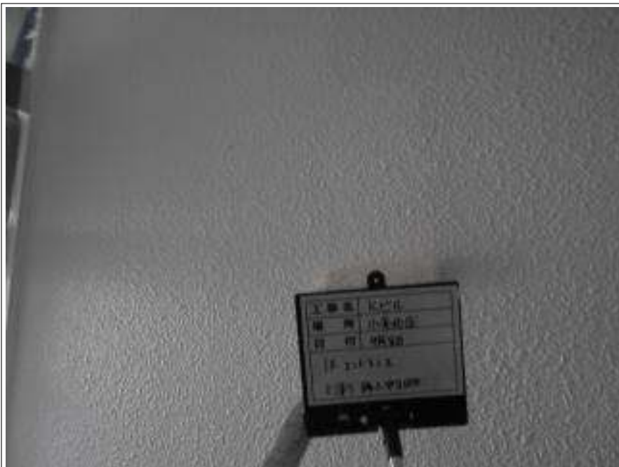
エントランス部 外壁上塗り施工中
