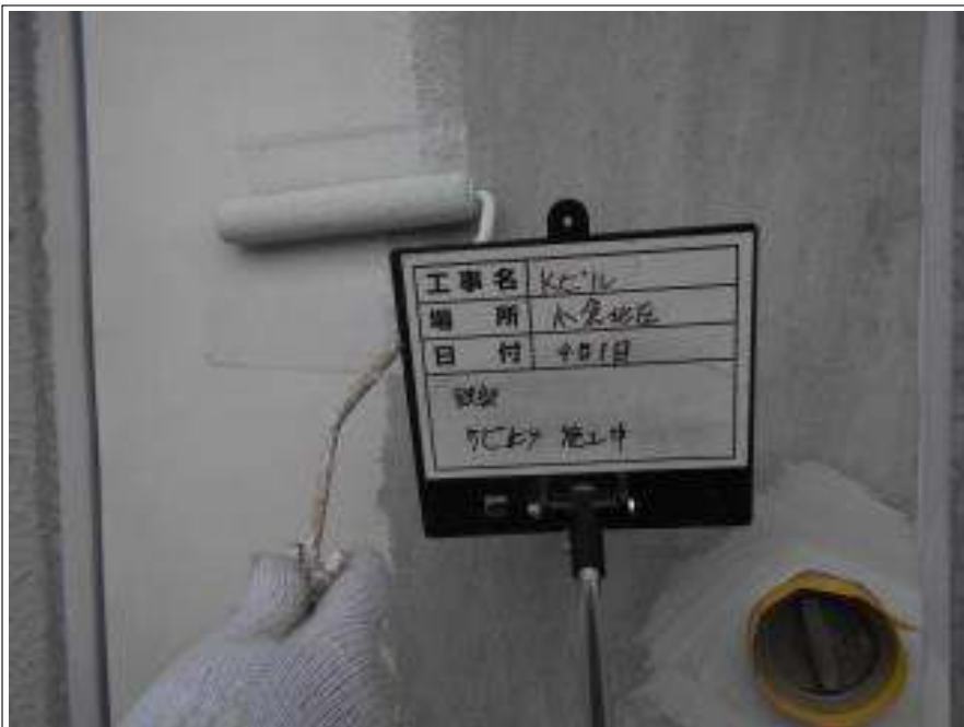
鉄部 サビ止め施工中
