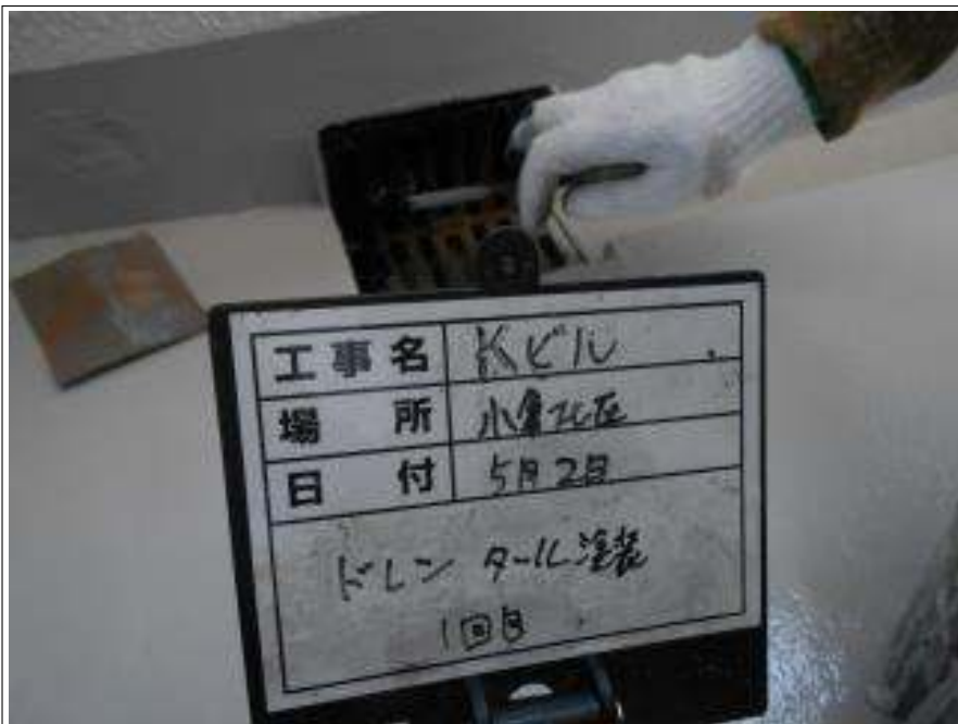
ドレン タール塗装(1回目) 施工中
