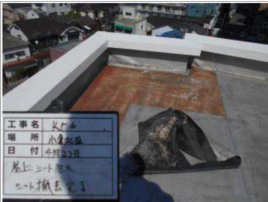
屋上 シート防水浮き部撤去完了
