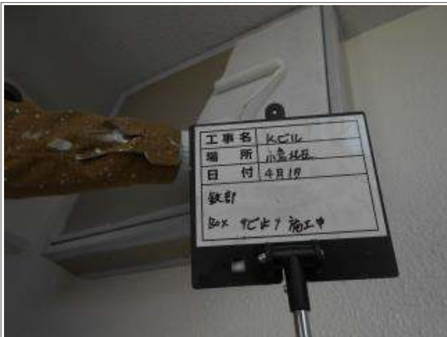
鉄部BOX 錆止め施工中
