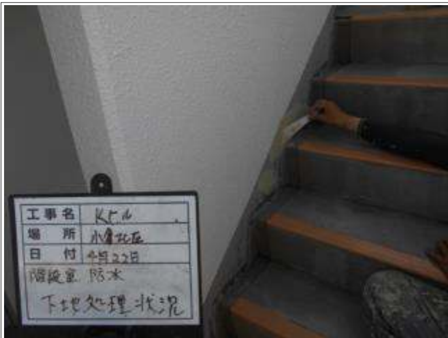
階段室防水 下地処理施工中
