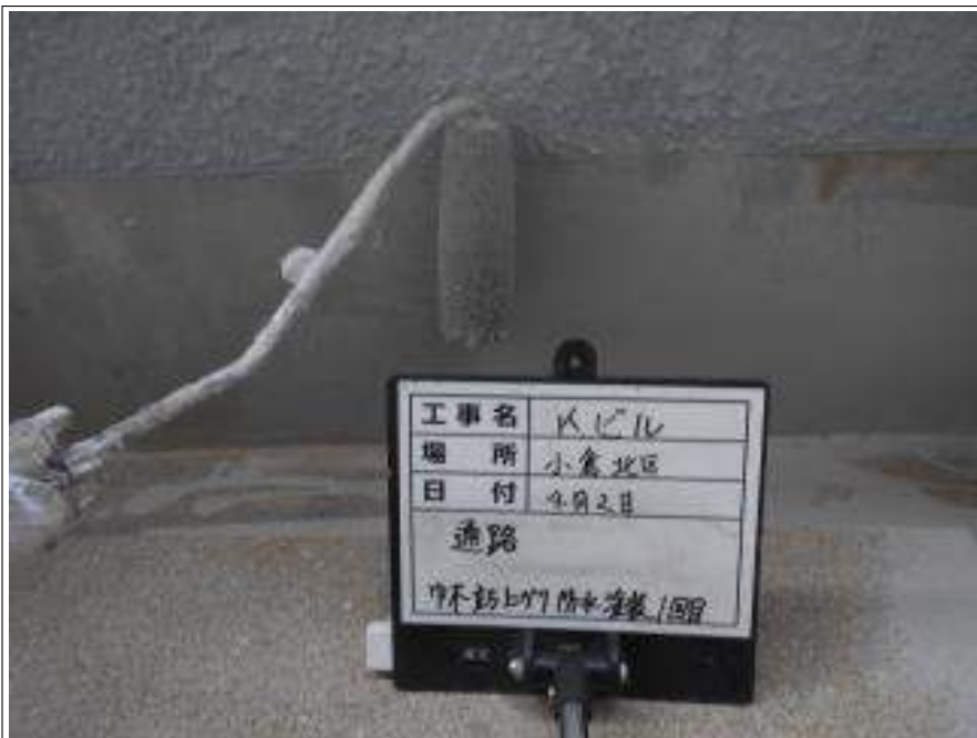
通路部 巾木 防水(1回目) 施工中
