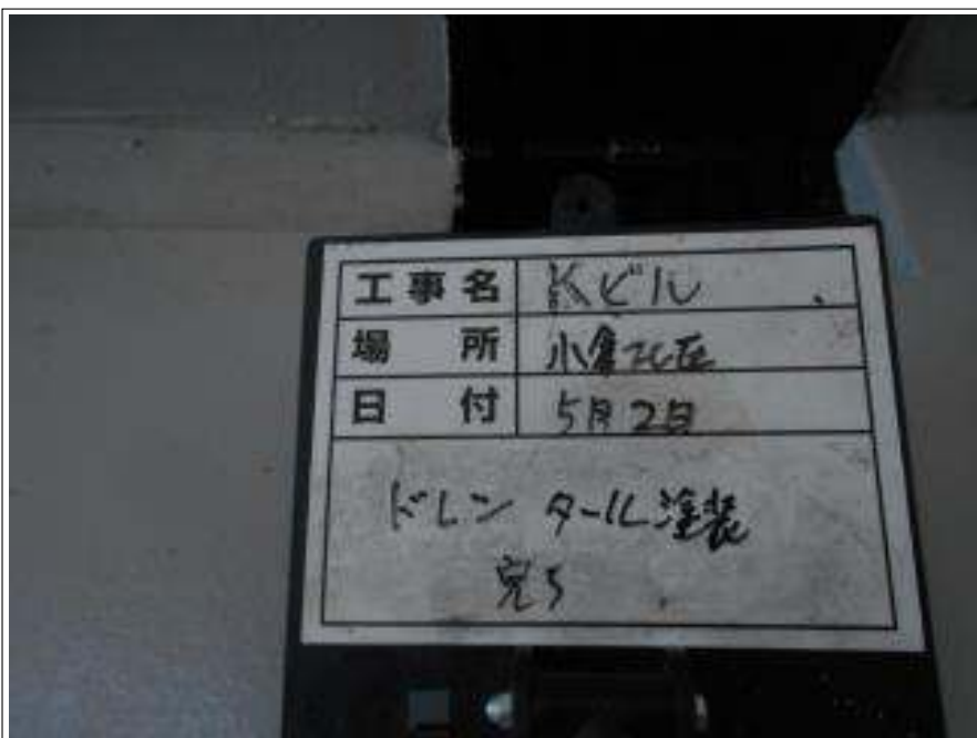
ドレン タール塗装(1回目) 施工完了
