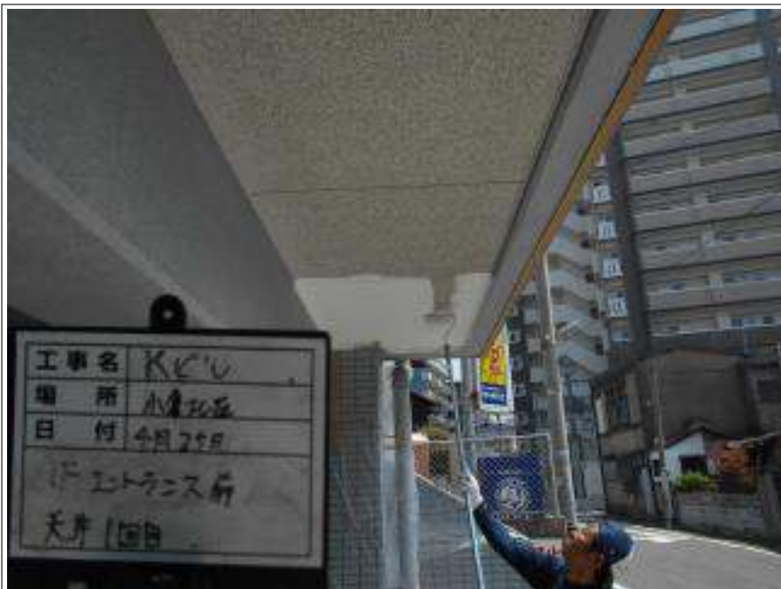
エントランス前軒天 上塗り施工中
