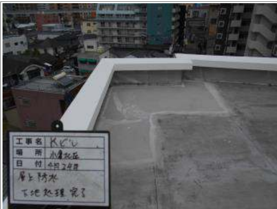
屋上 シート防水下地処理施工完了
