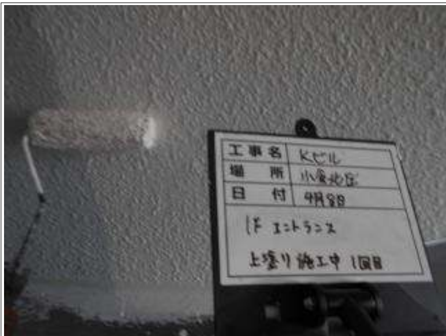
エントランス部 外壁中塗り施工中
