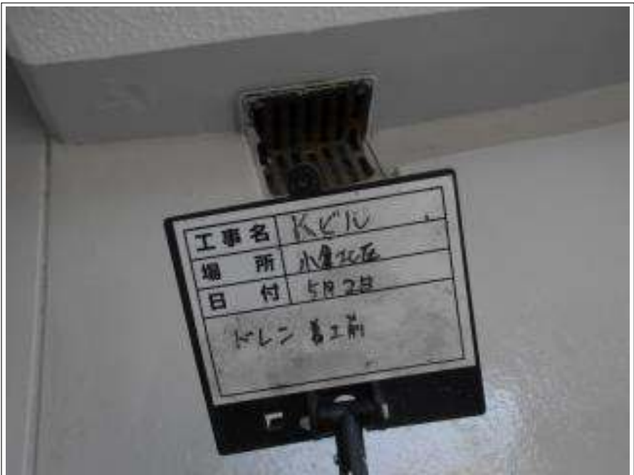
ドレン 施工前
