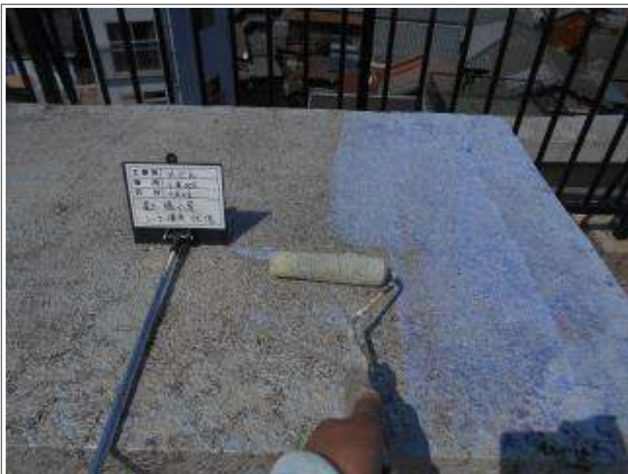
屋上 ハト小屋塗装 下塗り施工中
