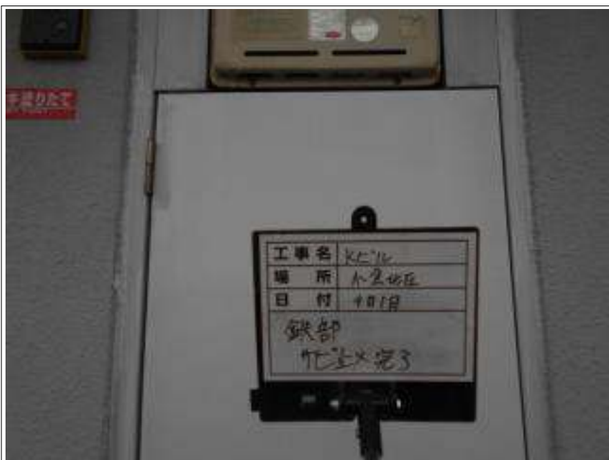
鉄部 サビ止め施工完了
