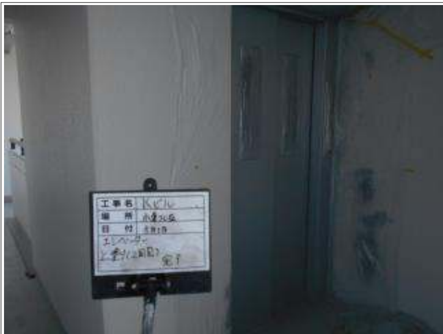
エレベーター 上塗り(2回目) 施工完了
