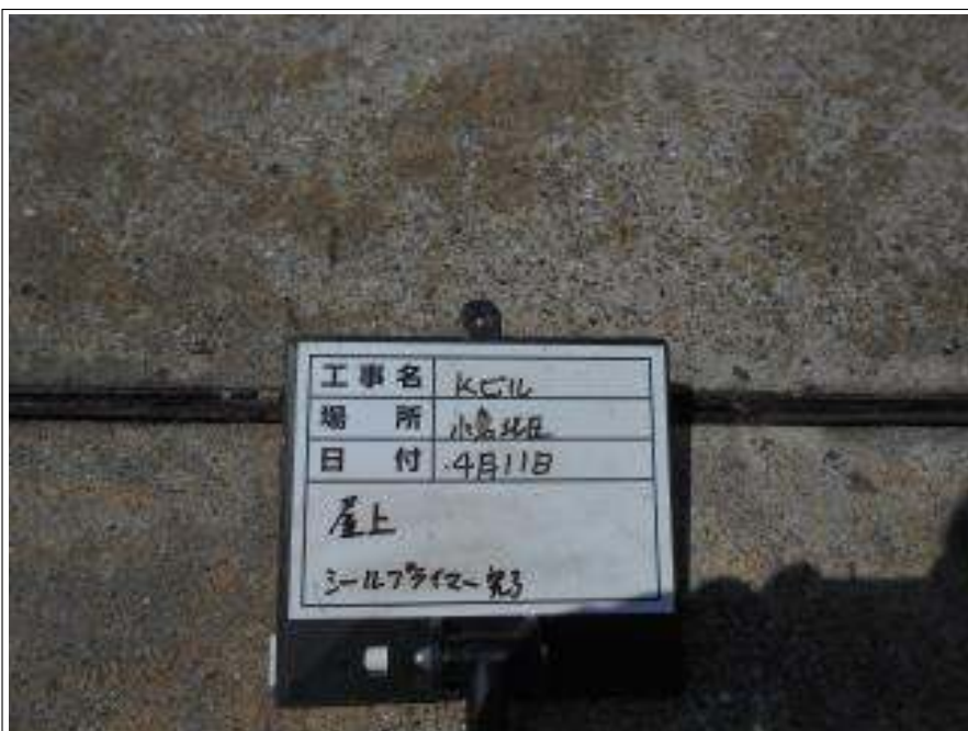
屋上 シーリング補修下塗り施工完了
