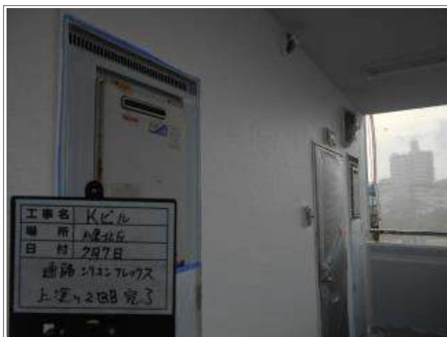
通路部 外壁 上塗り施工完了
