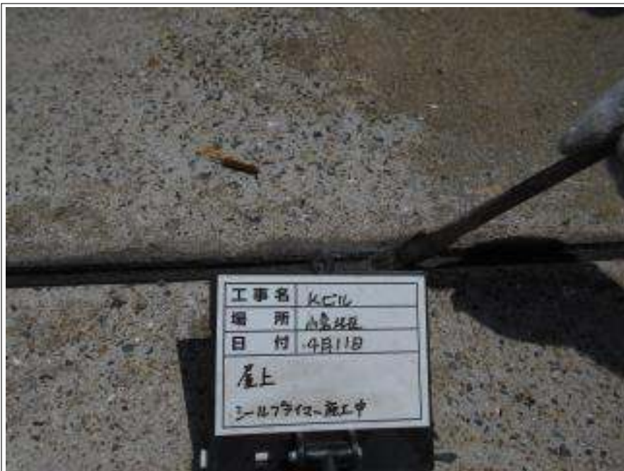
屋上 シーリング補修下塗り施工中
