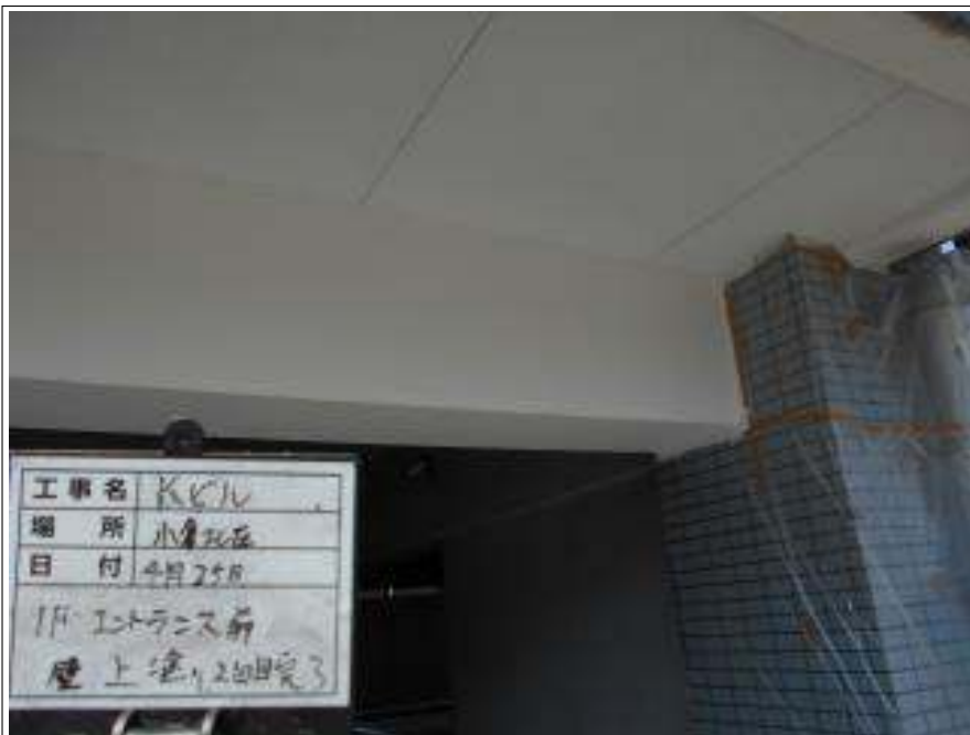
エントランス前外壁 上塗り施工完了
