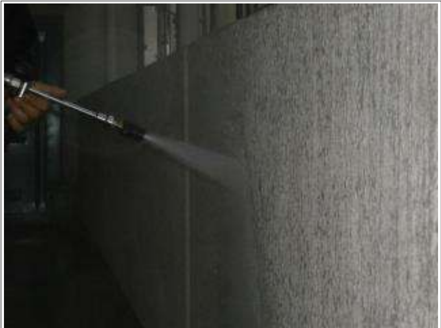
外壁高圧洗浄中
