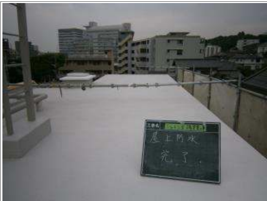
屋上 施工完了
