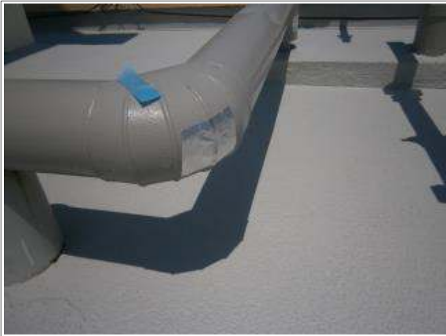
配管補修 施工中
