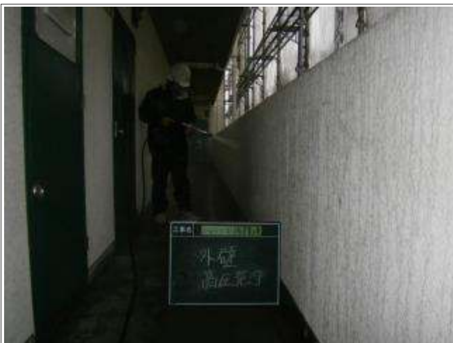
外壁高圧洗浄中
