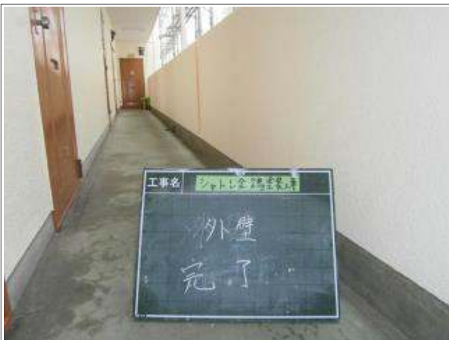
外壁 施工完了
