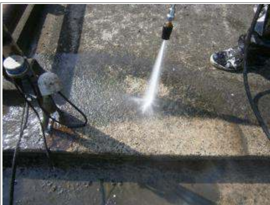
屋上高圧洗浄中
