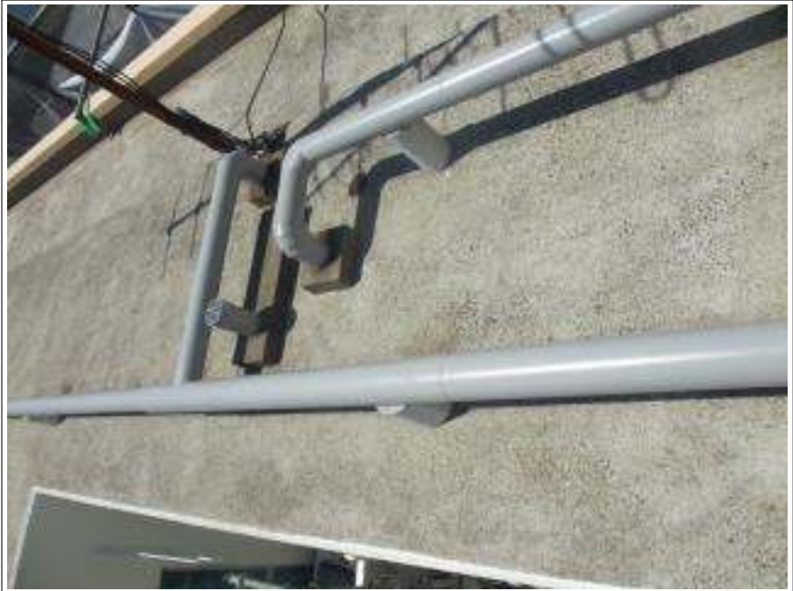
配管 施工完了
