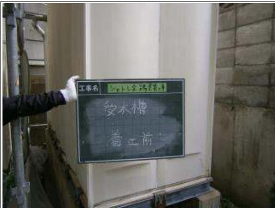
受水槽 施工前
