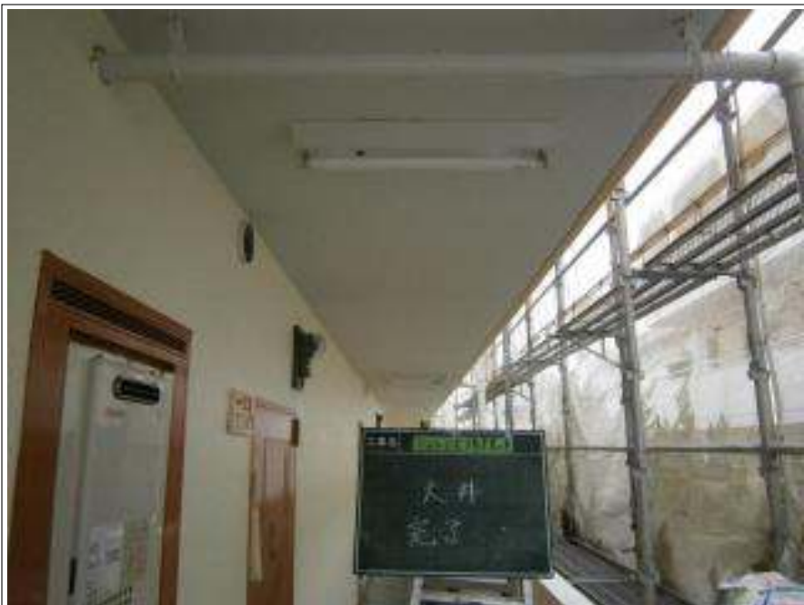
軒天 施工完了
