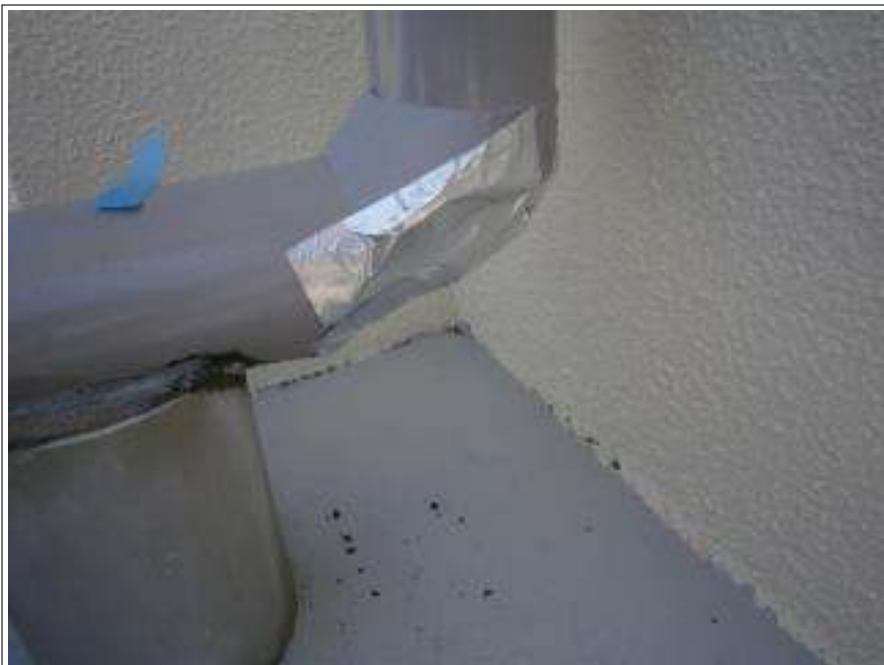
配管補修 施工中
