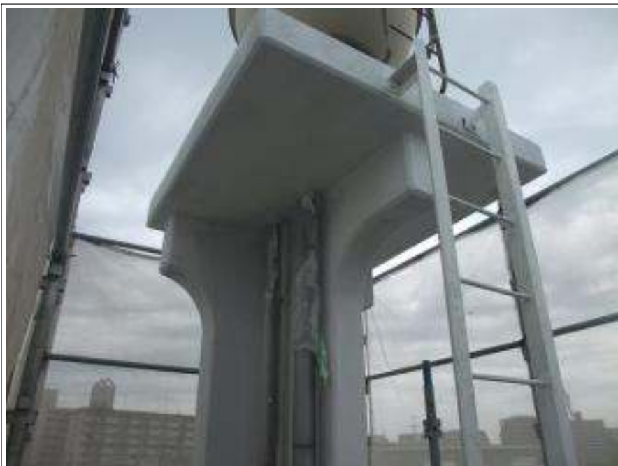
下塗り 施工完了
