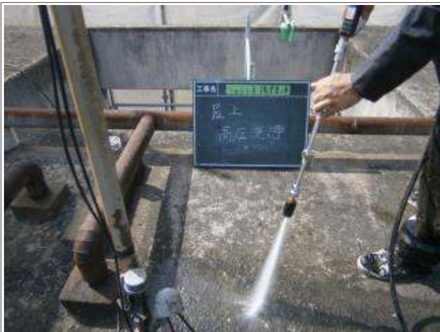
屋上高圧洗浄中
