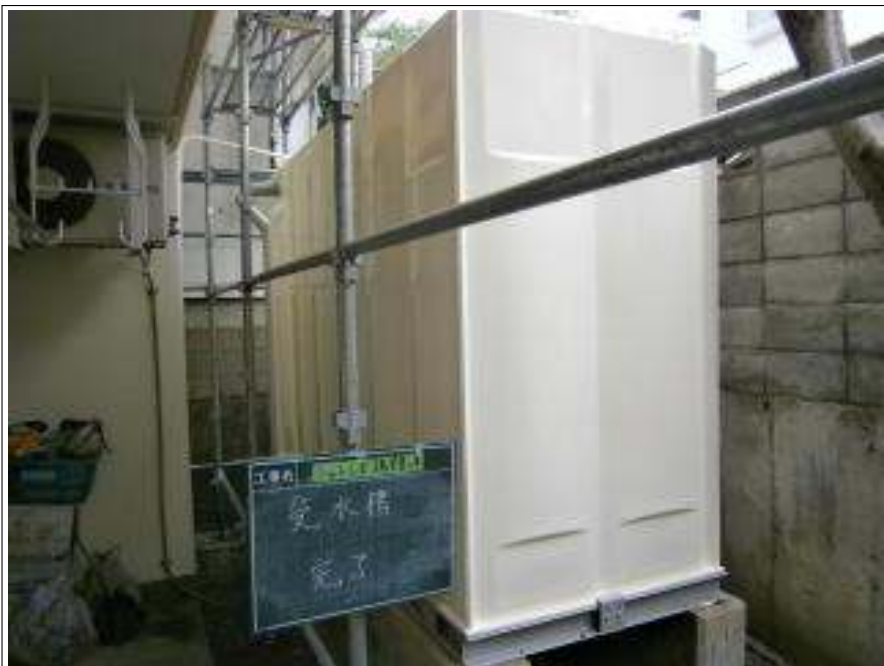
受水槽 施工完了
