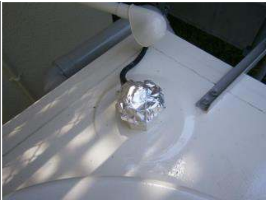
配管補修 施工中
