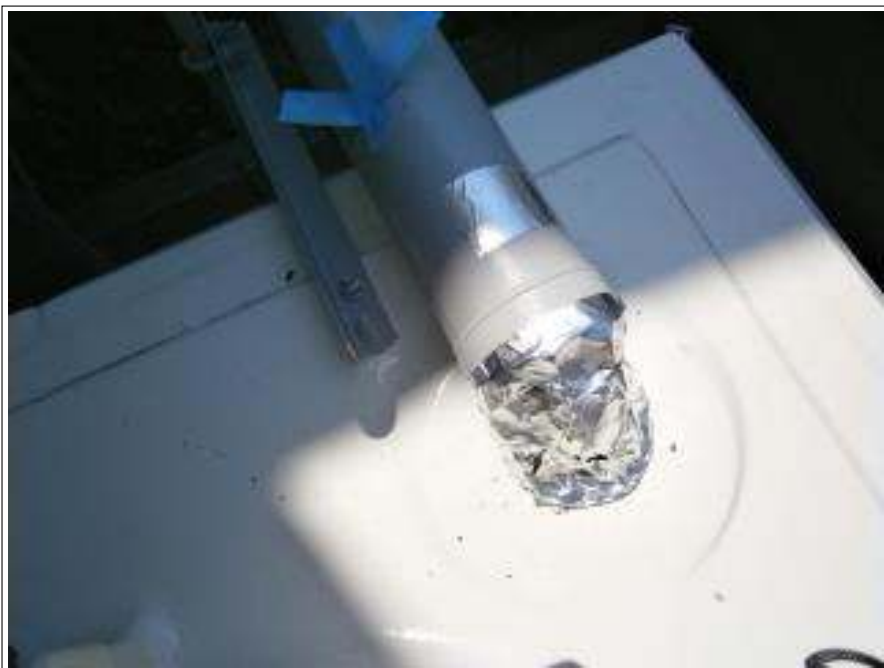
配管補修 施工中
