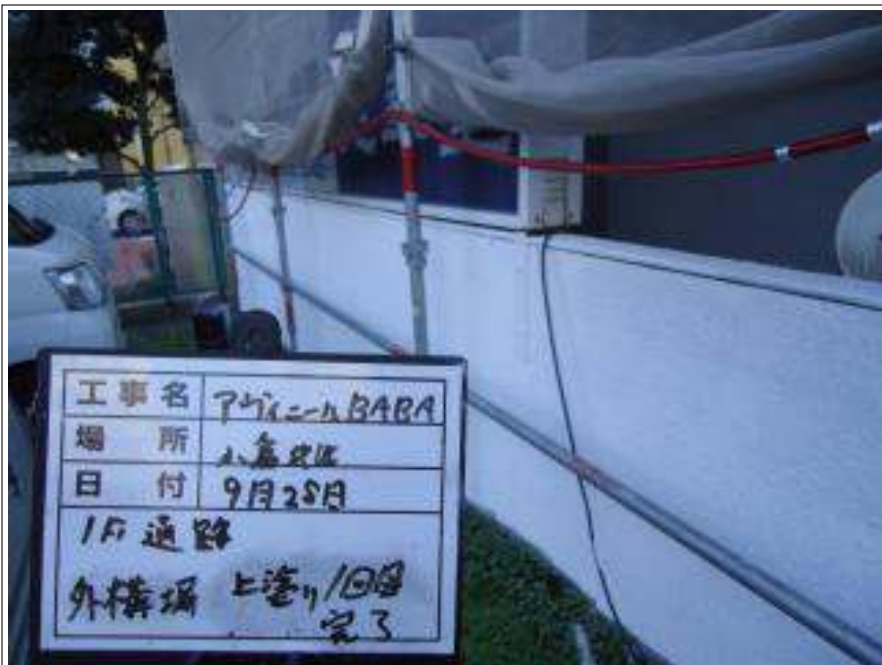
外構塀 上塗り施工完了（1回目）
