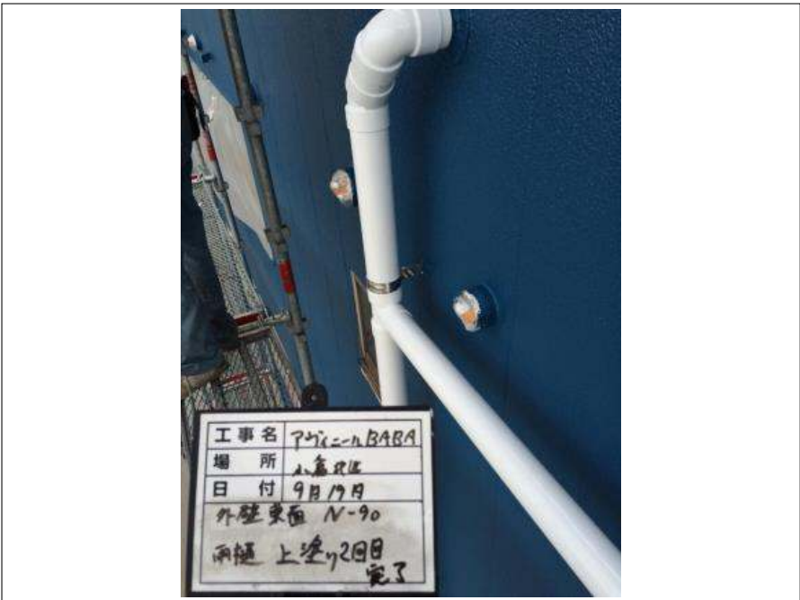
外壁東面 樋 上塗り施工完了
