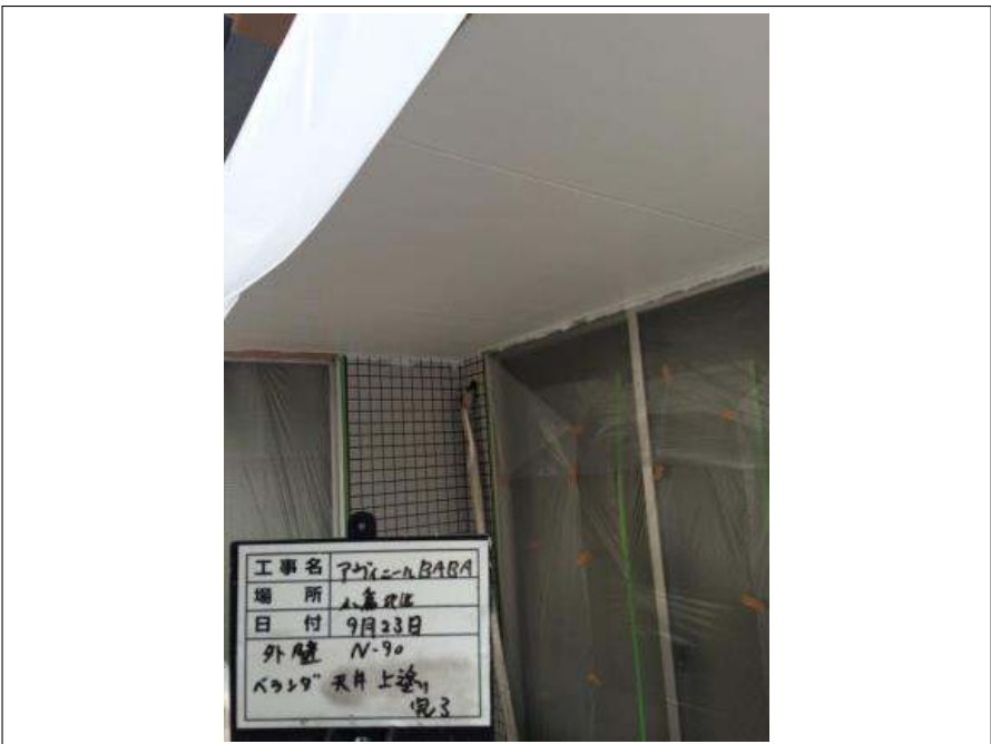
ベランダ軒天 上塗り施工完了
