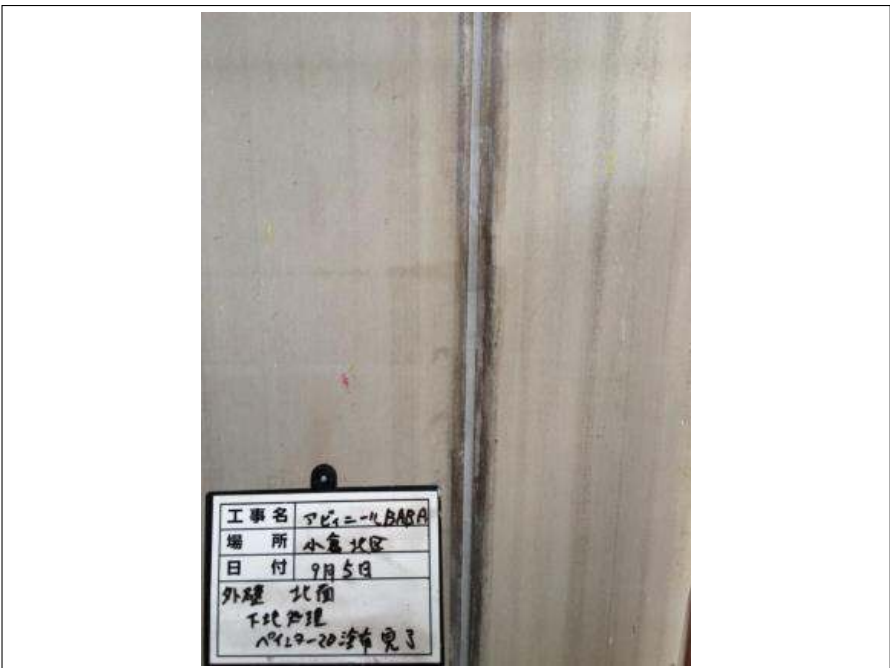
外壁北面 ペインター20 塗布完了
