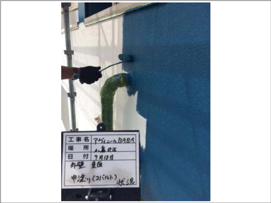
外壁東面 中塗り施工中
