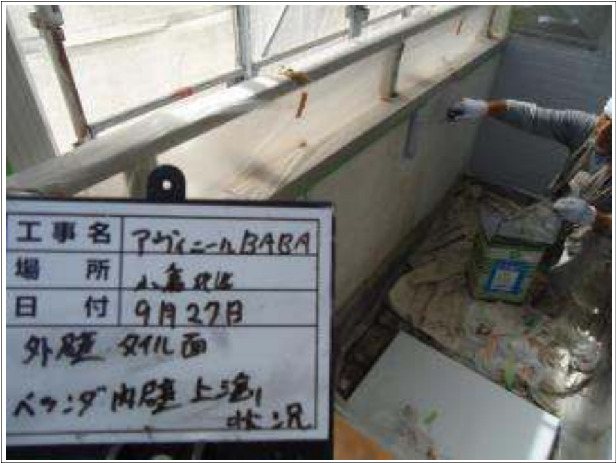
ベランダ内壁 上塗り施工中
