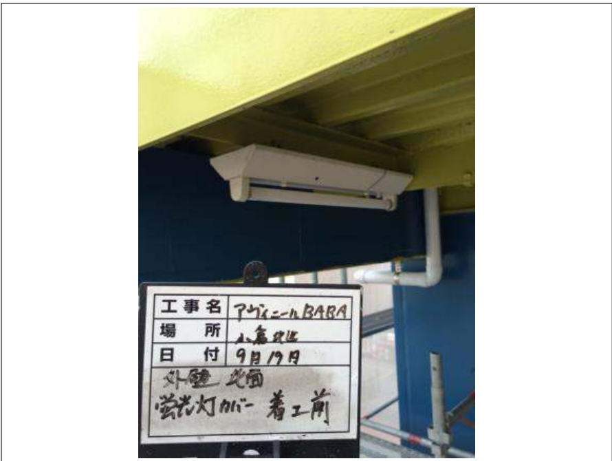
北面 蛍光灯カバー 施工前
