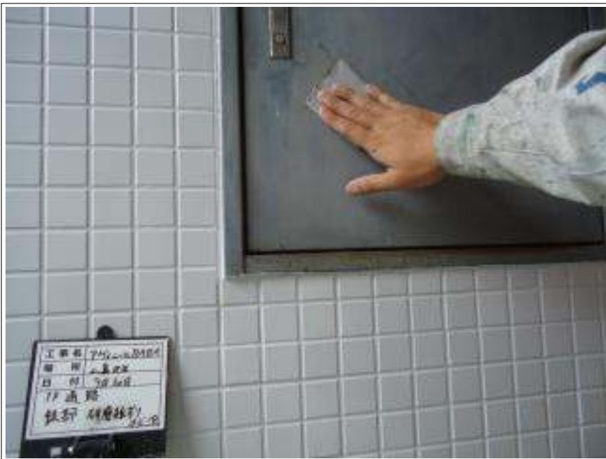
1F 通路鉄部 研磨紙ずり施工中
