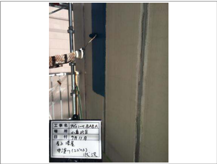
屋上塔屋 中塗り施工中
