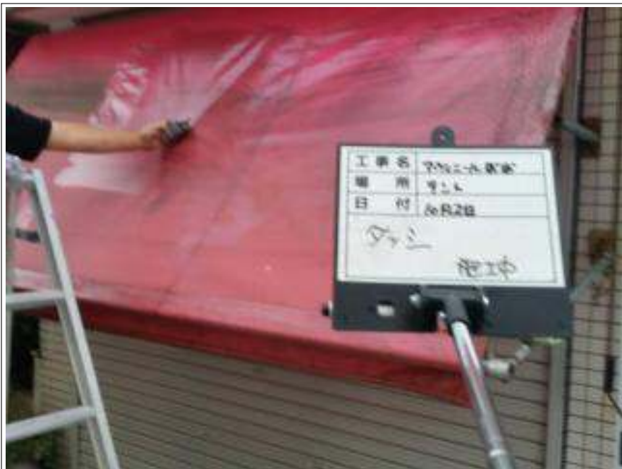
テント ダッシ施工中
