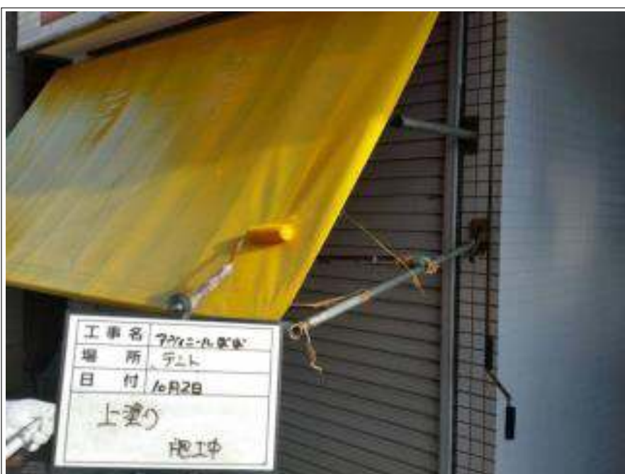
テント 上塗り施工中
