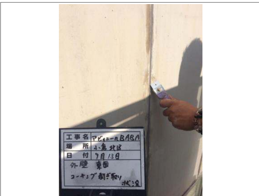
外壁東面 シーリング撤去施工中
