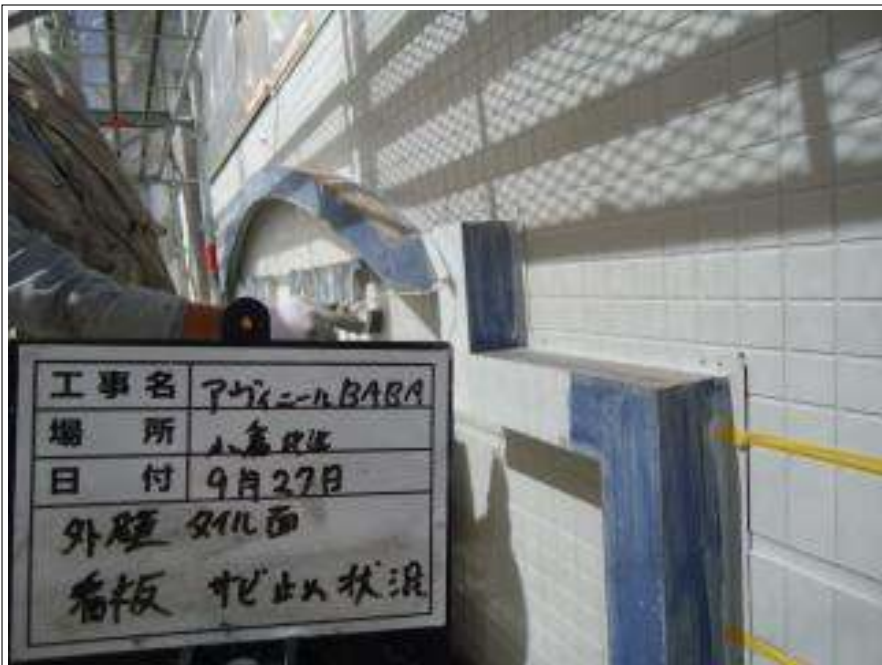
看板 サビ止め塗布施工中
