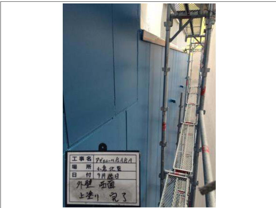
外壁西面 上塗り施工完了
