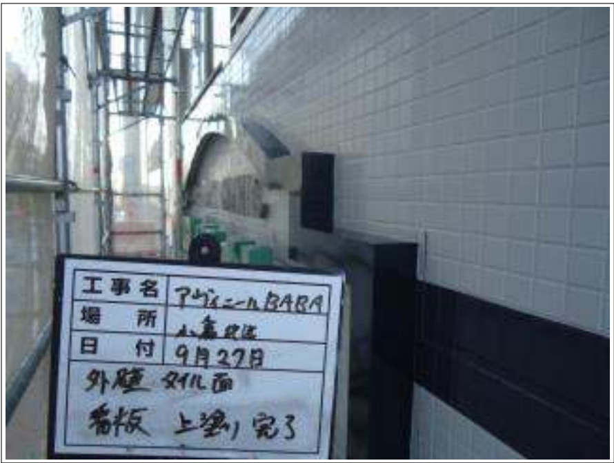
看板 上塗り施工完了
