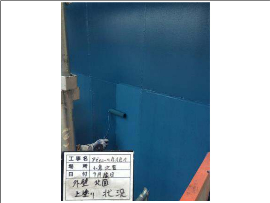
外壁北面 上塗り施工中
