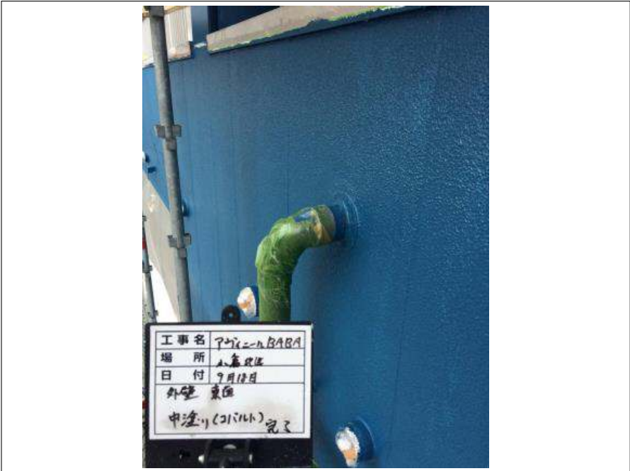
外壁東面 中塗り施工完了
