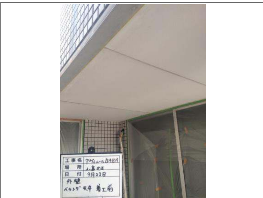
ベランダ軒天 施工前
