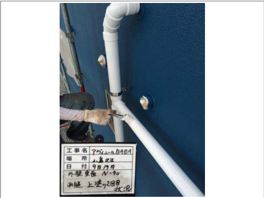
外壁東面 樋 上塗り施工中
