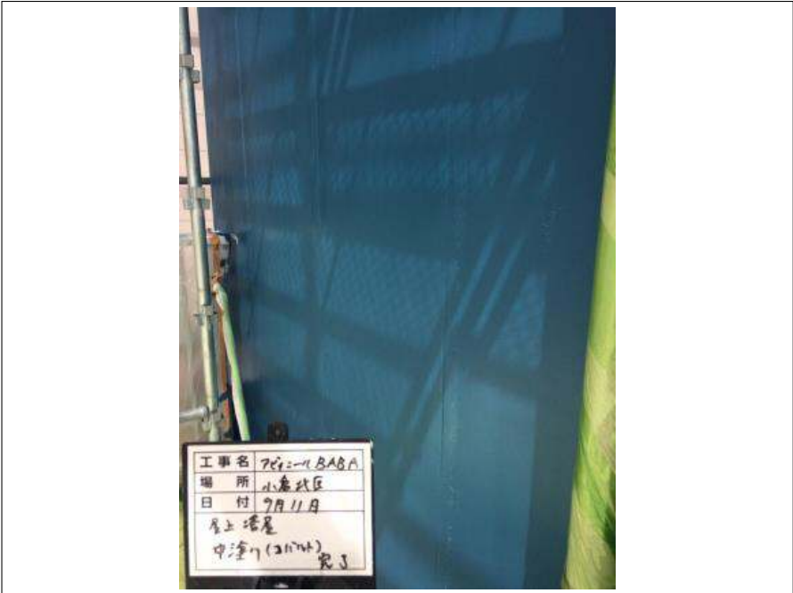
屋上塔屋 中塗り施工完了
