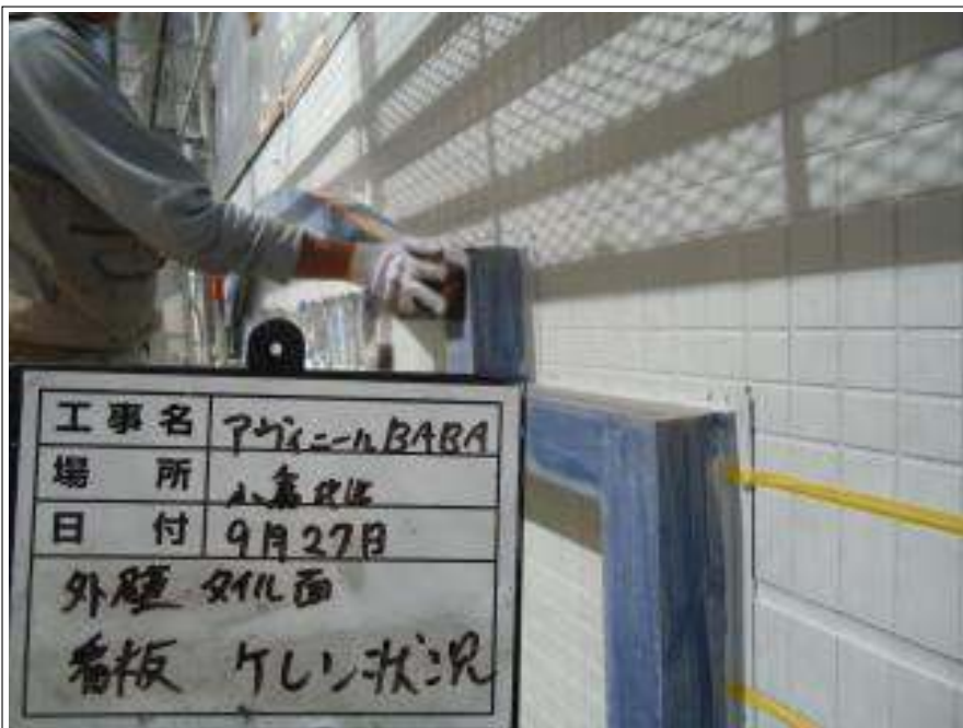
看板 ケレン施工中
