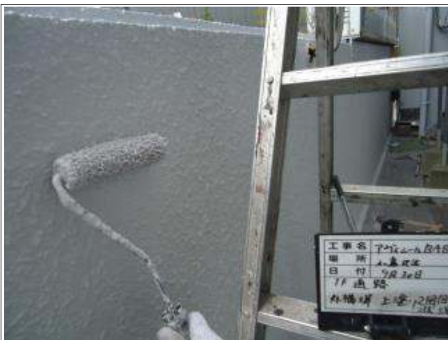
外構塀 上塗り施工中（2回目）
