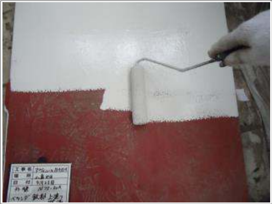
南面 鉄部 上塗り施工中
