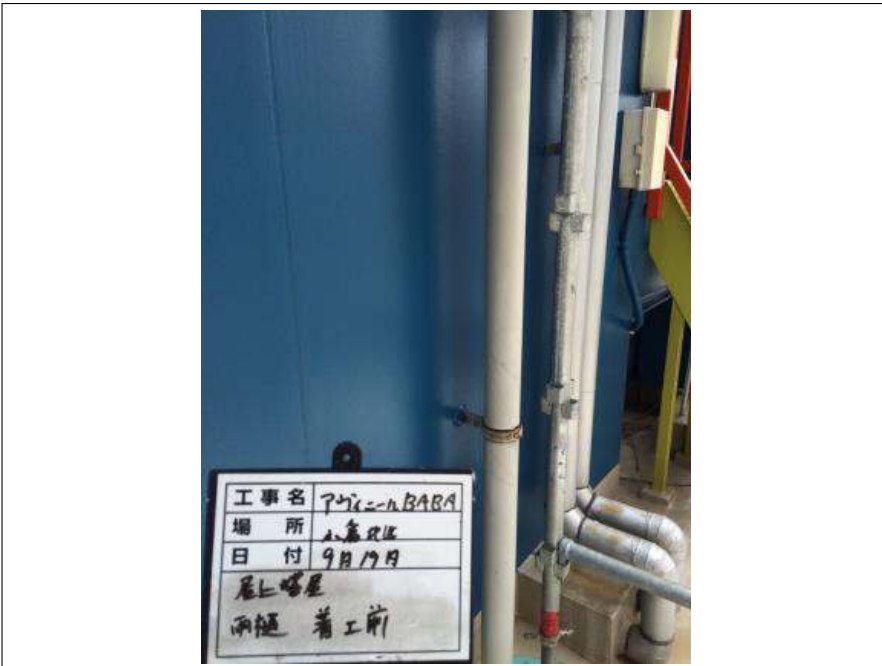
屋上搭屋 樋 施工前
