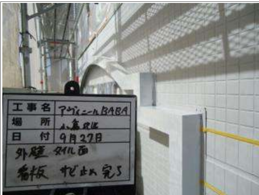
看板 サビ止め塗布施工完了
