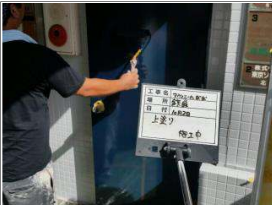
鉄扉 上塗り施工中
