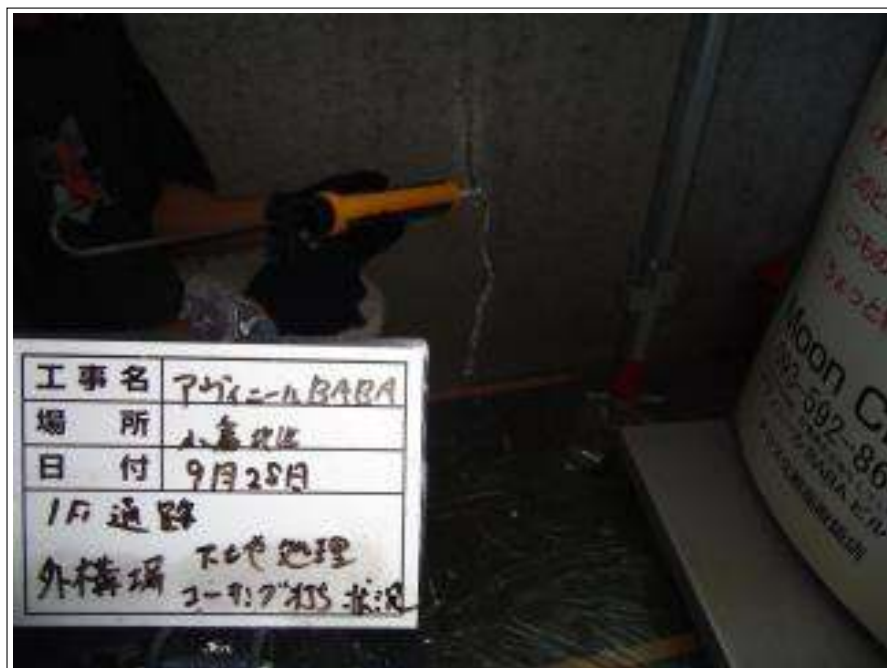
外構塀 コーキング打ち替え施工中
