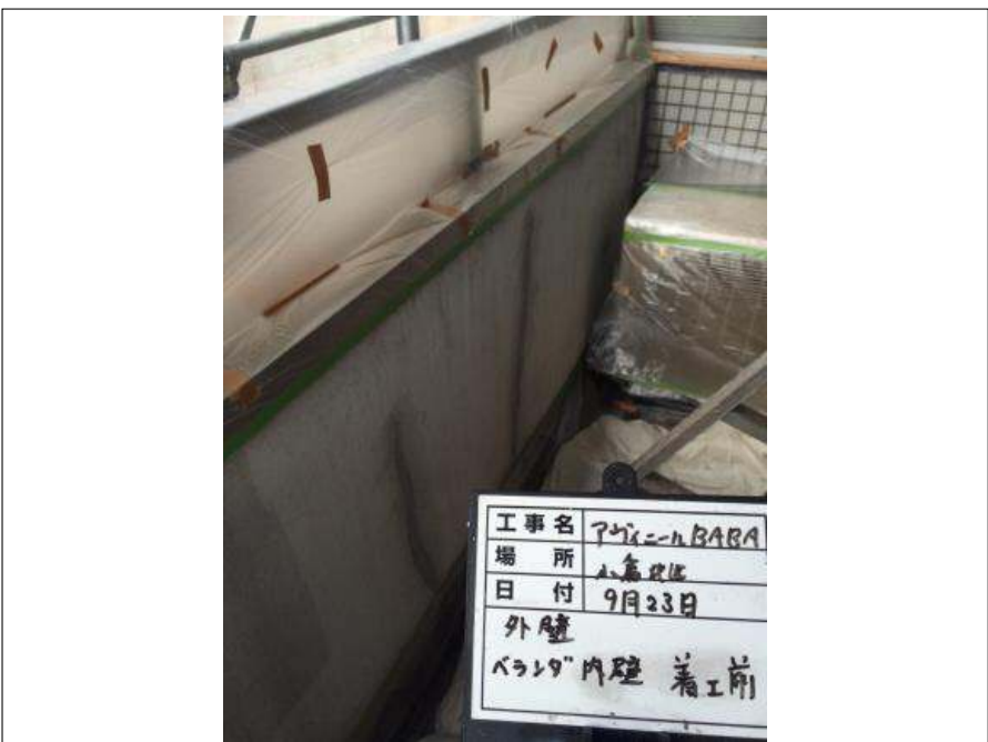
ベランダ内壁 施工前
