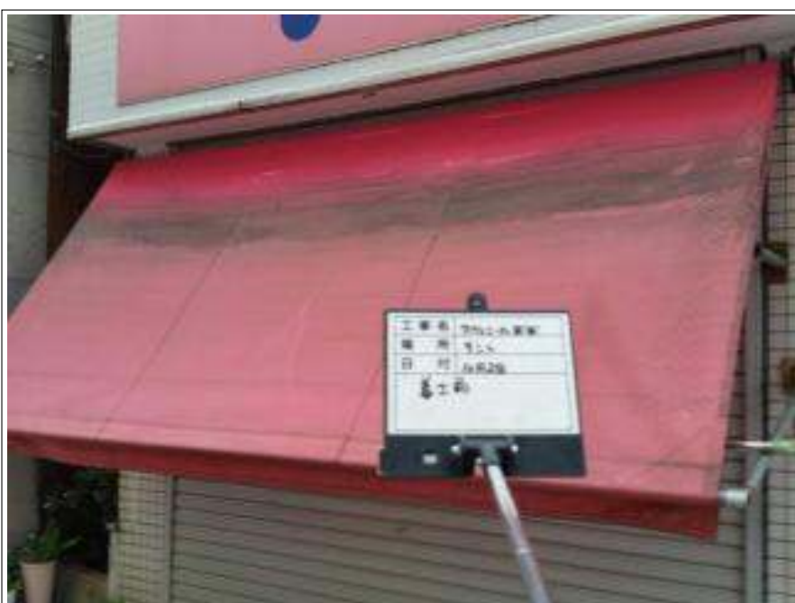
テント 施工前
