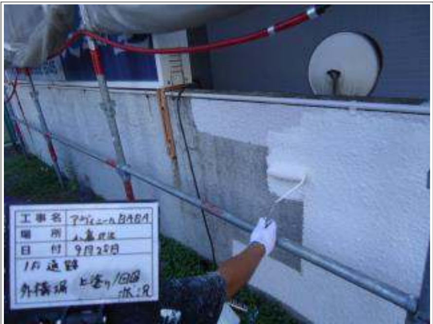
外構塀 上塗り施工中（1回目）
