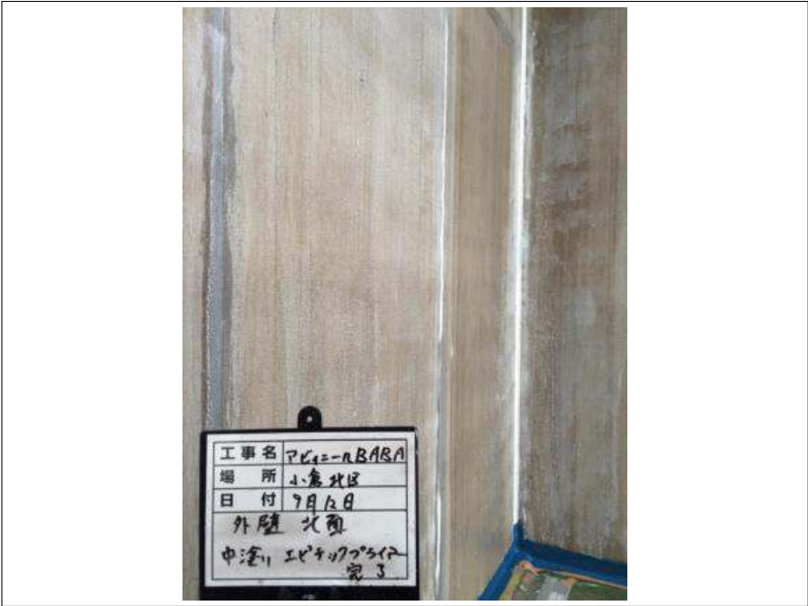
外壁北面 中塗り施工完了
