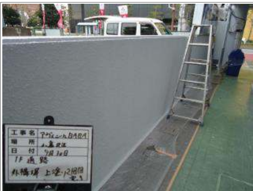
外構塀 上塗り施工完了（2回目）
