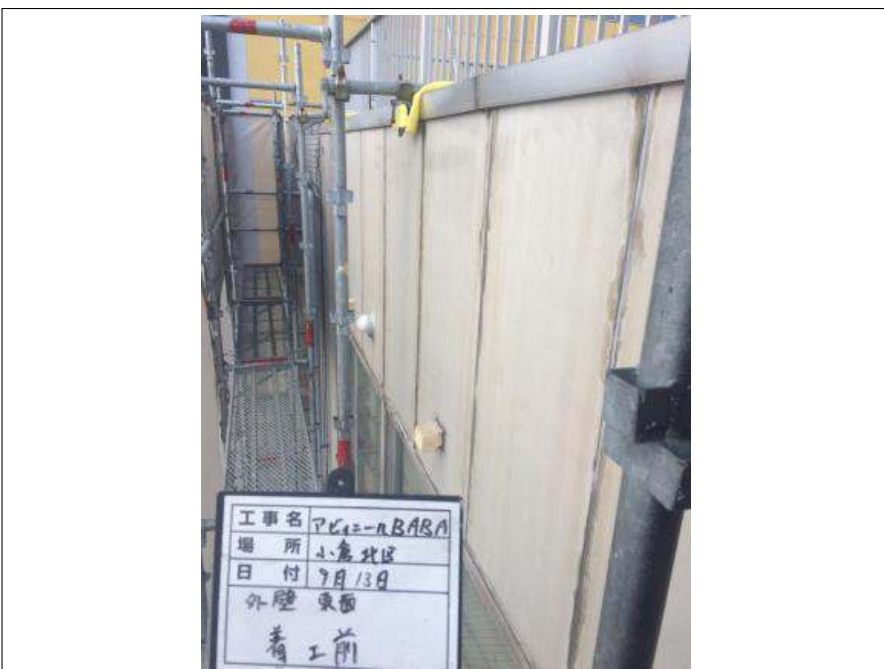
外壁東面 施工前
