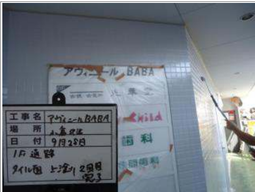
1F 通路タイル面 上塗り施工完了
