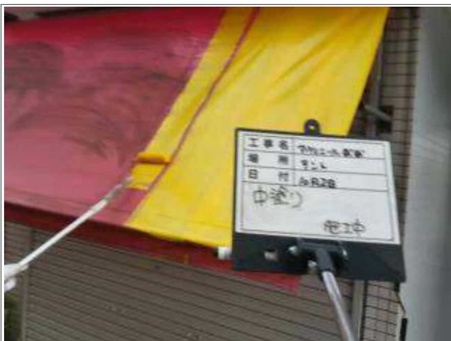
テント 中塗り施工中
