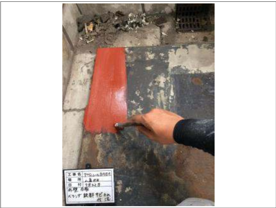
南面 鉄部 サビ止め塗布施工中
