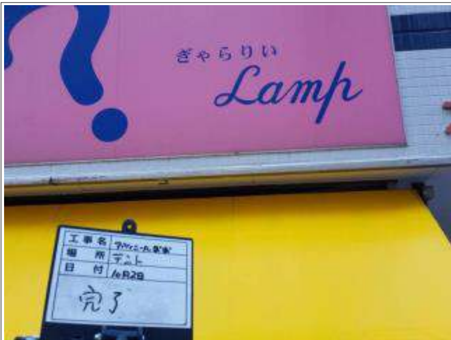
テント 施工完了
