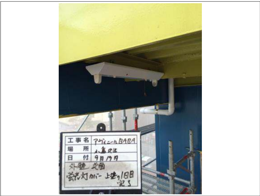
北面 蛍光灯カバー上塗り施工完了
