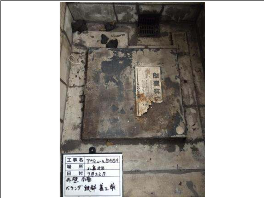
南面 鉄部 施工前
