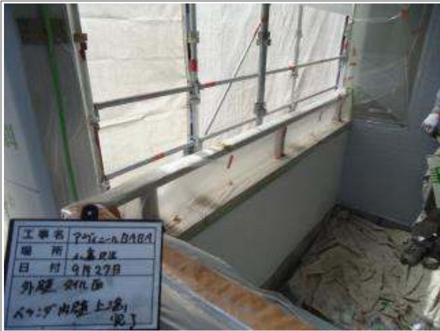
ベランダ内壁 上塗り施工完了
