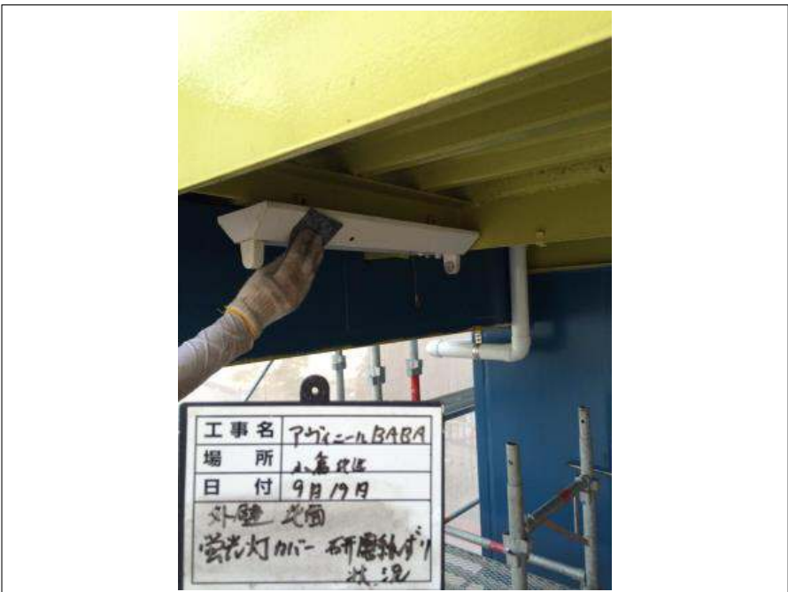
北面 蛍光灯カバー研磨紙ずり施工中
