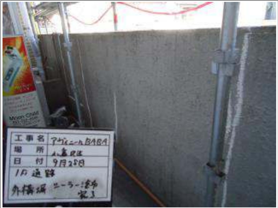
外構塀 下塗り施工完了
