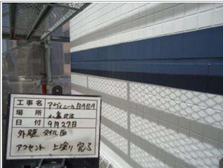
タイル面アクセント 上塗り施工完了
