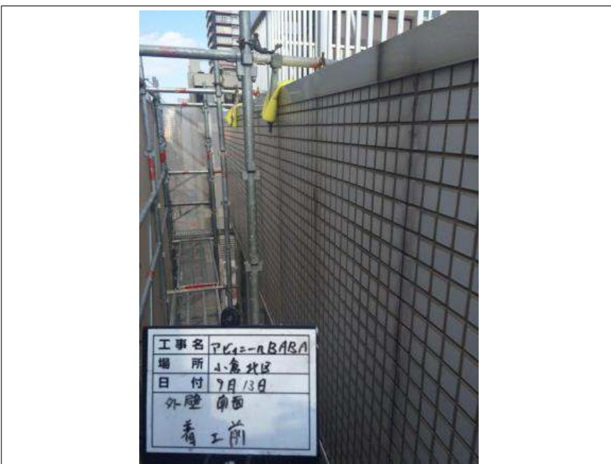
外壁南面 施工前
