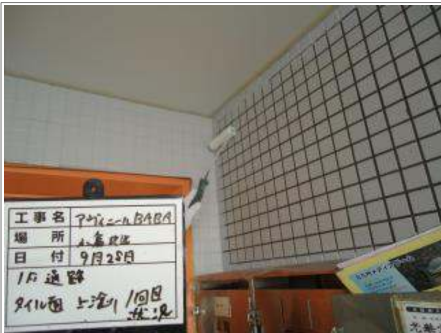
1F 通路タイル面 上塗り施工中
