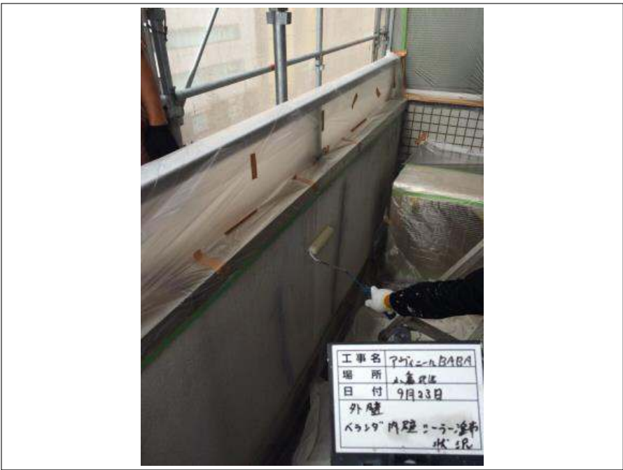
ベランダ内壁 下塗り施工中
