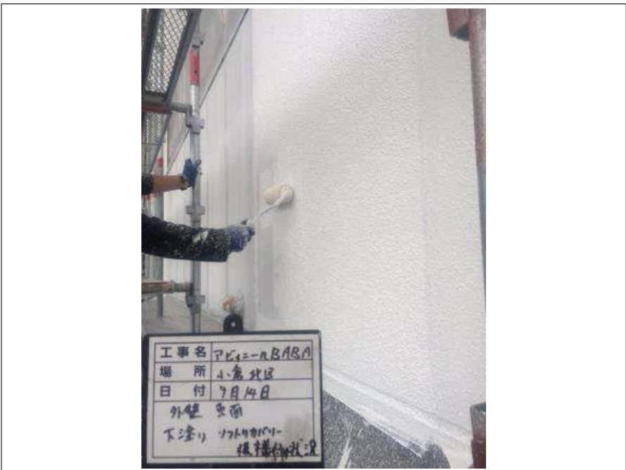
外壁東面 下塗り模様付け施工中
