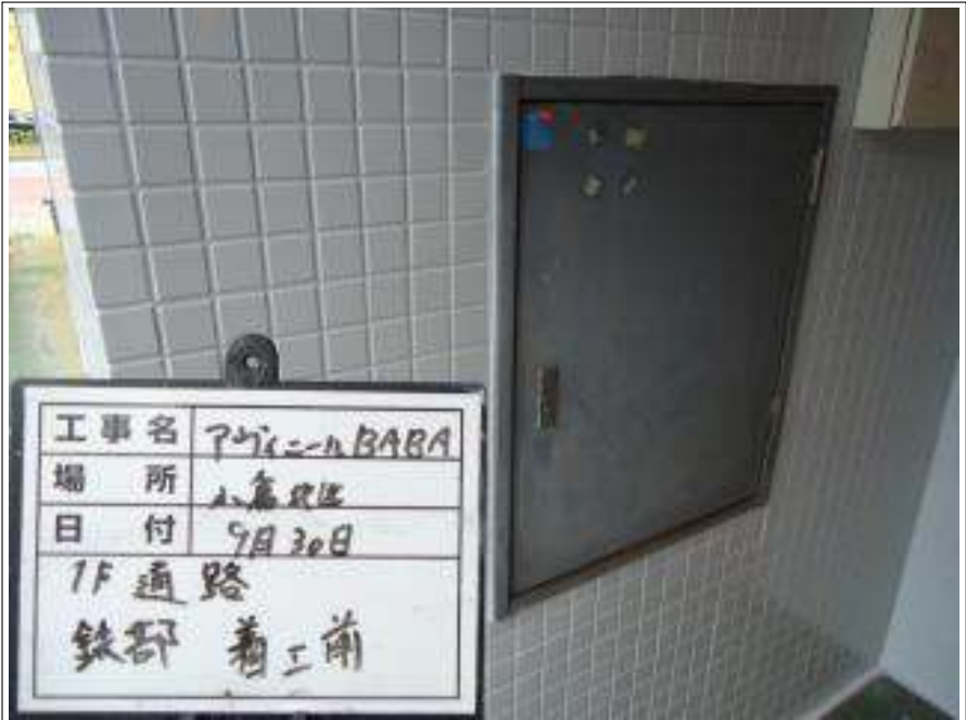
1F 通路鉄部 施工前
