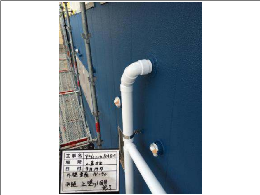
外壁東面 樋 上塗り施工完了
