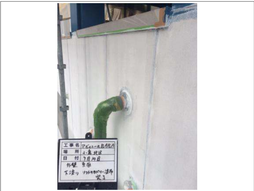
外壁東面 下塗り施工完了
