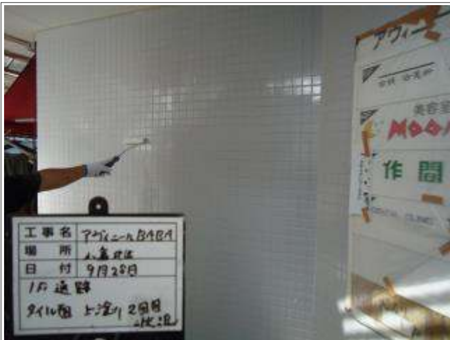
1F 通路タイル面 上塗り施工中
