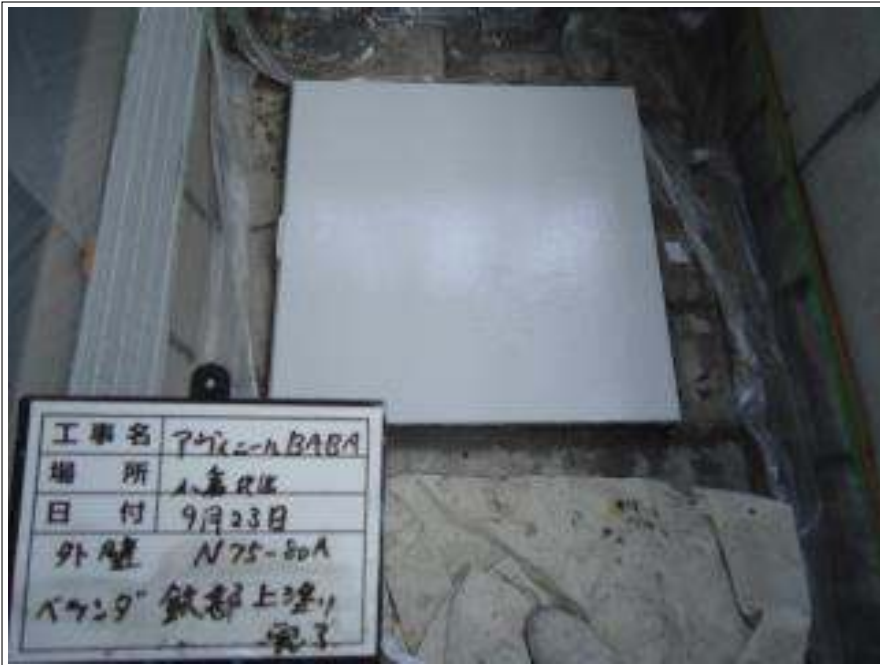
南面 鉄部 上塗り施工完了
