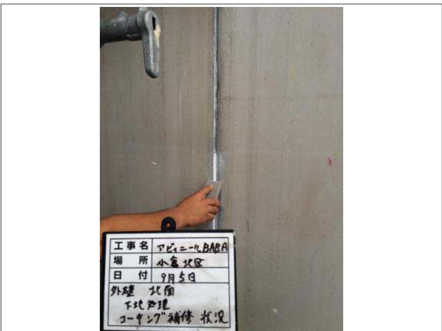
外壁北面シーリング 打ち替え施工中
