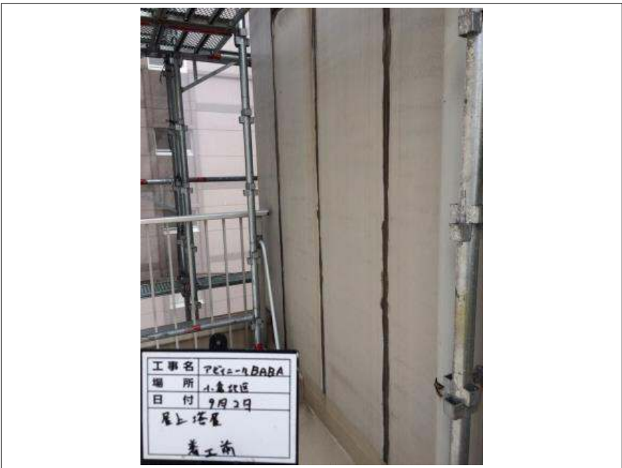
屋上塔屋 施工前
