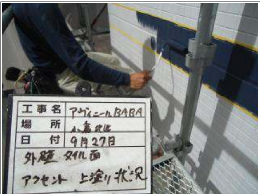
タイル面アクセント 上塗り施工中
