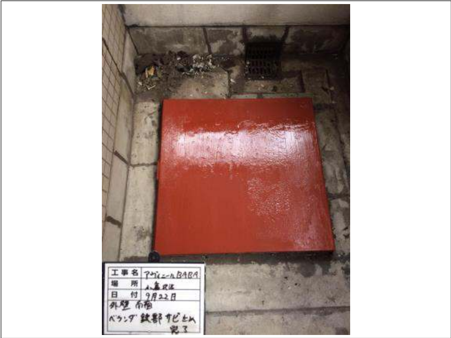
南面 鉄部 サビ止め塗布施工完了
