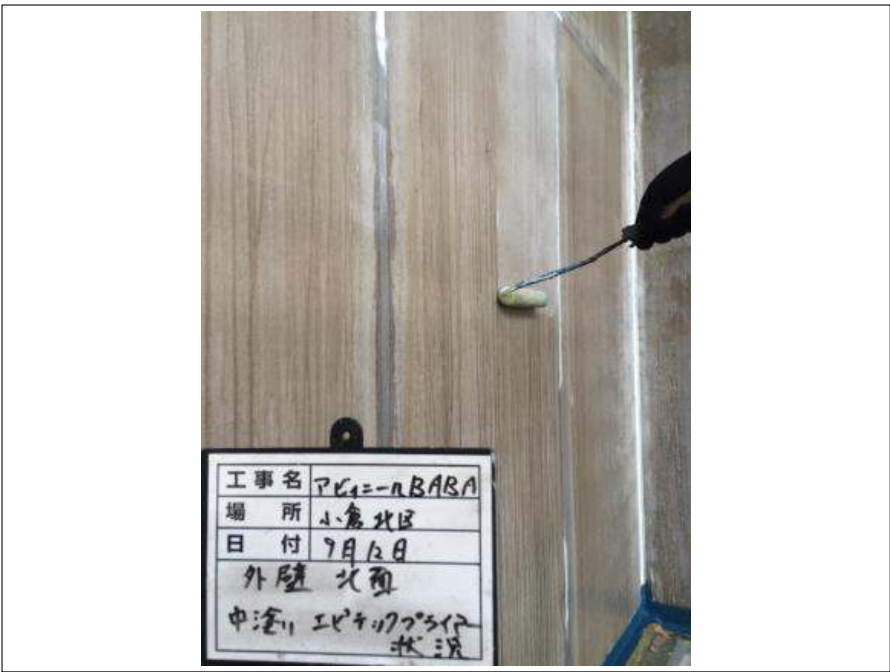
外壁北面 中塗り施工中
