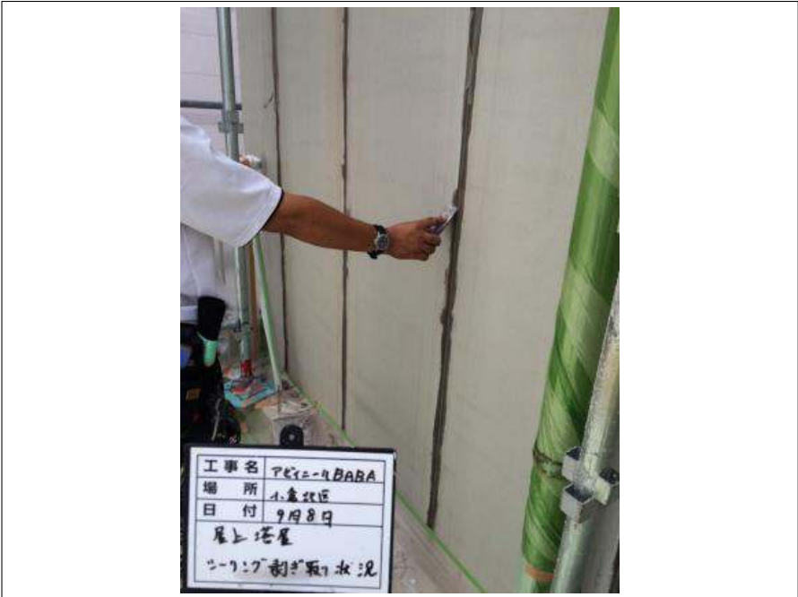
屋上塔屋 シーリング 撤去施工中
