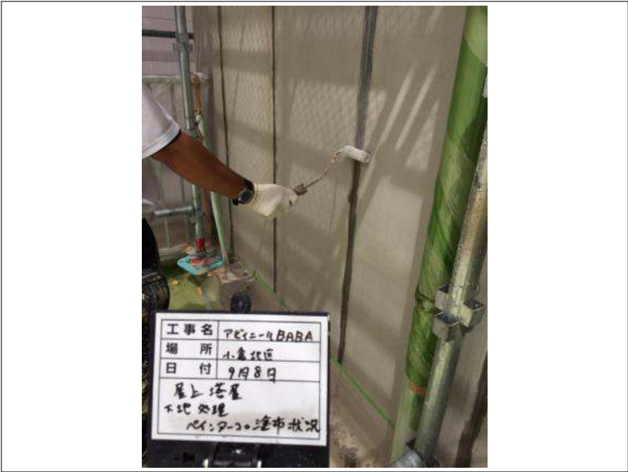
屋上塔屋 ペインター20塗布
