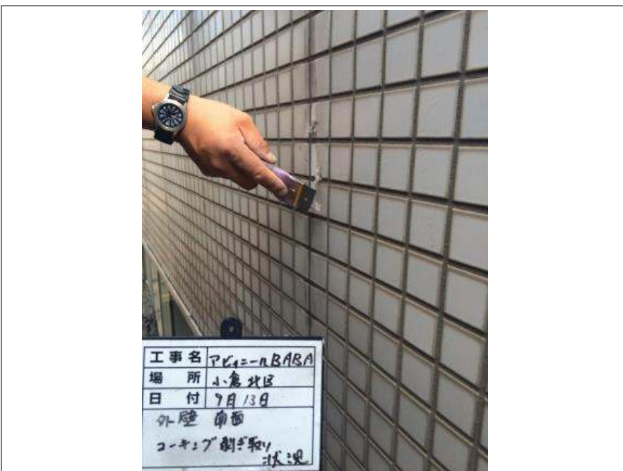
外壁南面 シーリング撤去施工中
