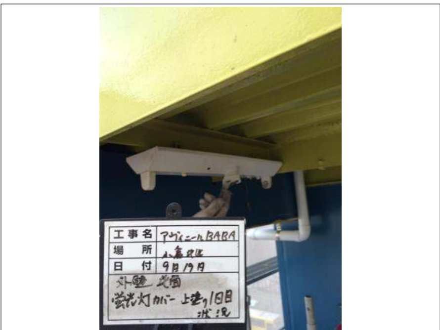
北面 蛍光灯カバー上塗り施工中
