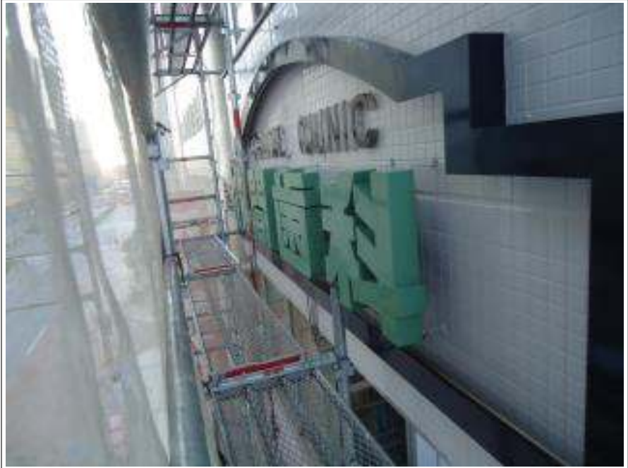
看板 施工完了
