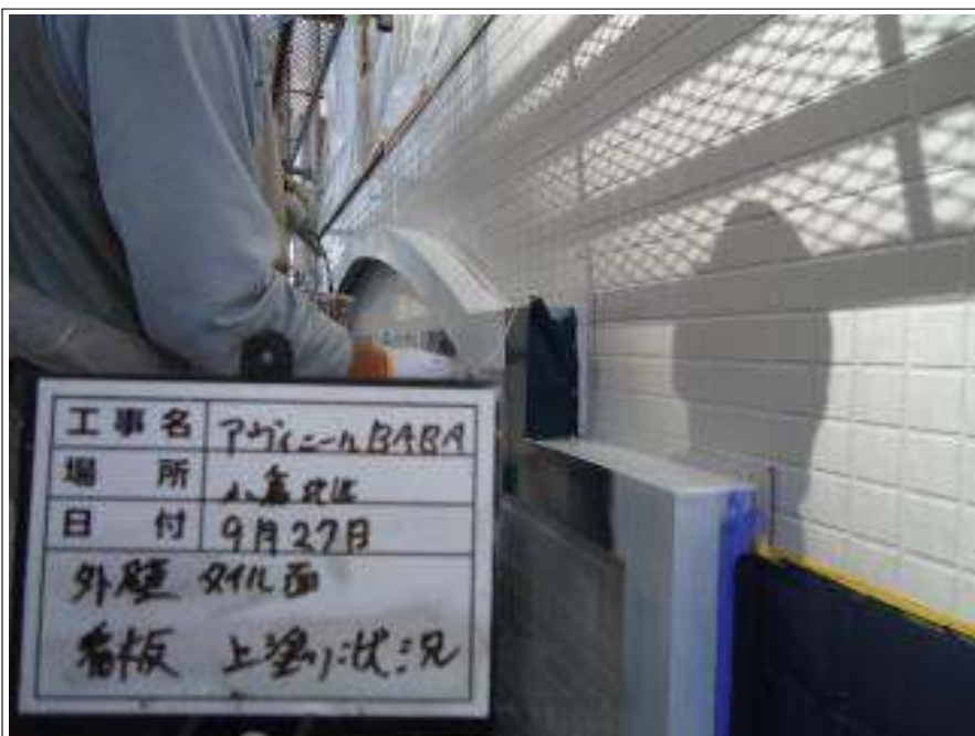
看板 上塗り施工中
