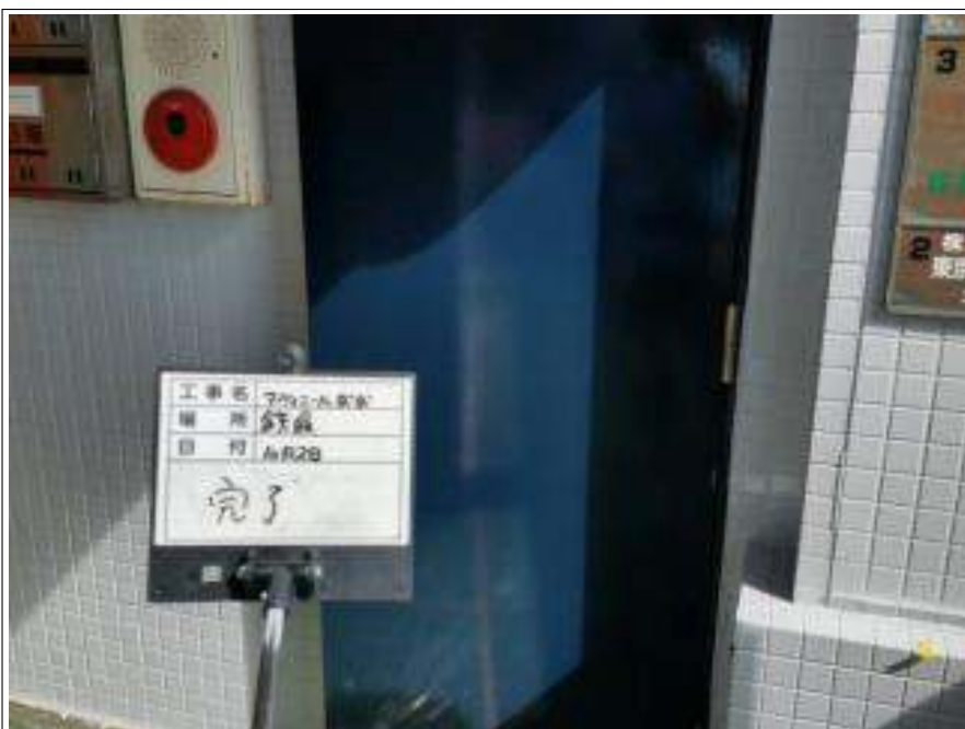
鉄扉 施工完了
