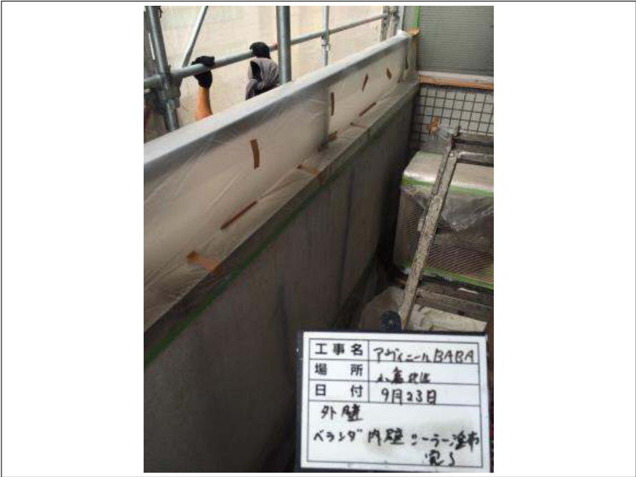
ベランダ内壁 下塗り施工完了
