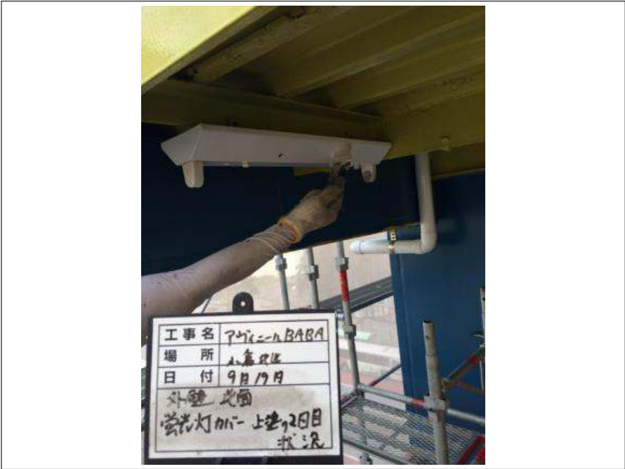
北面 蛍光灯カバー上塗り施工中
