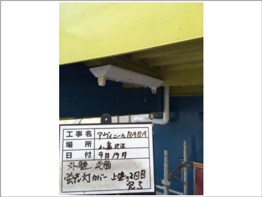
北面 蛍光灯カバー上塗り施工完了
