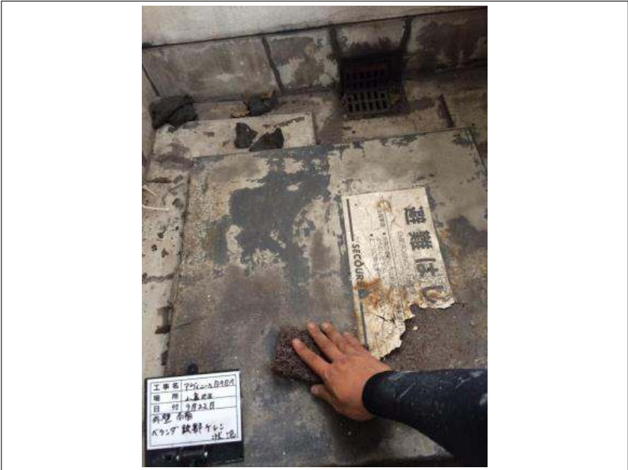
南面 鉄部 研磨紙ずり施工中
