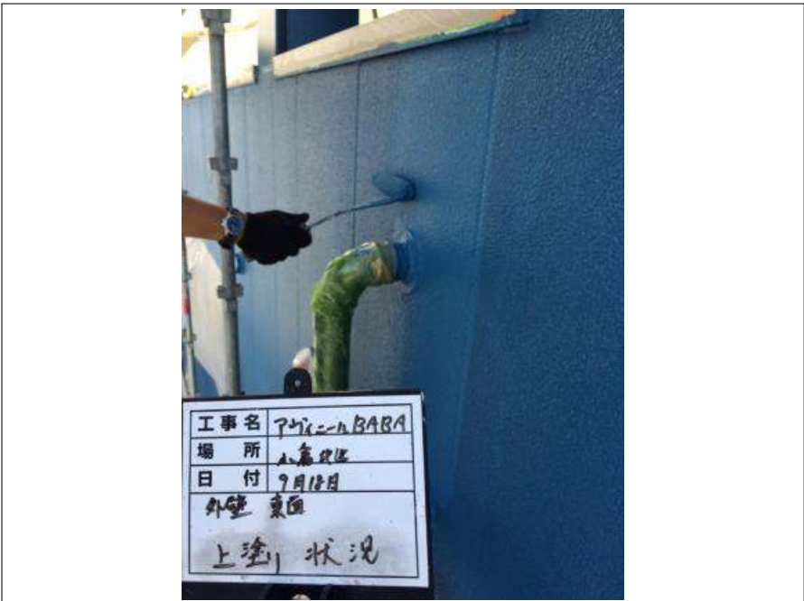
外壁東面 上塗り施工中
