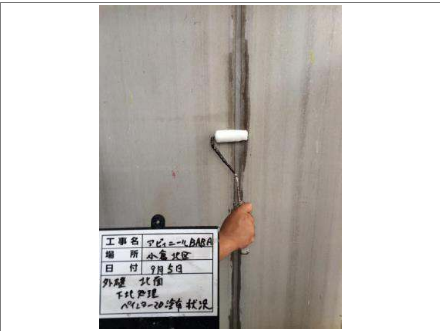
外壁北面 ペインター20 塗布
