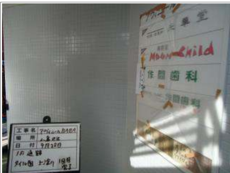
1F 通路タイル面 上塗り施工完了
