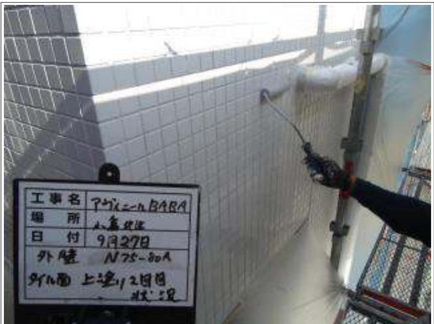
タイル面 上塗り施工中（2回目）
