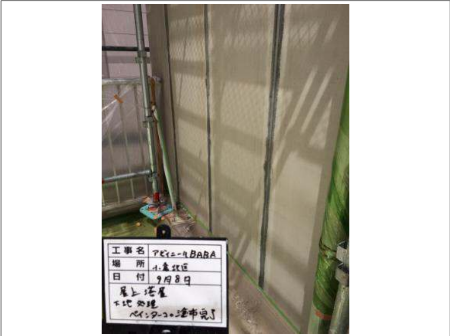
屋上塔屋 ペインター20塗布完了
