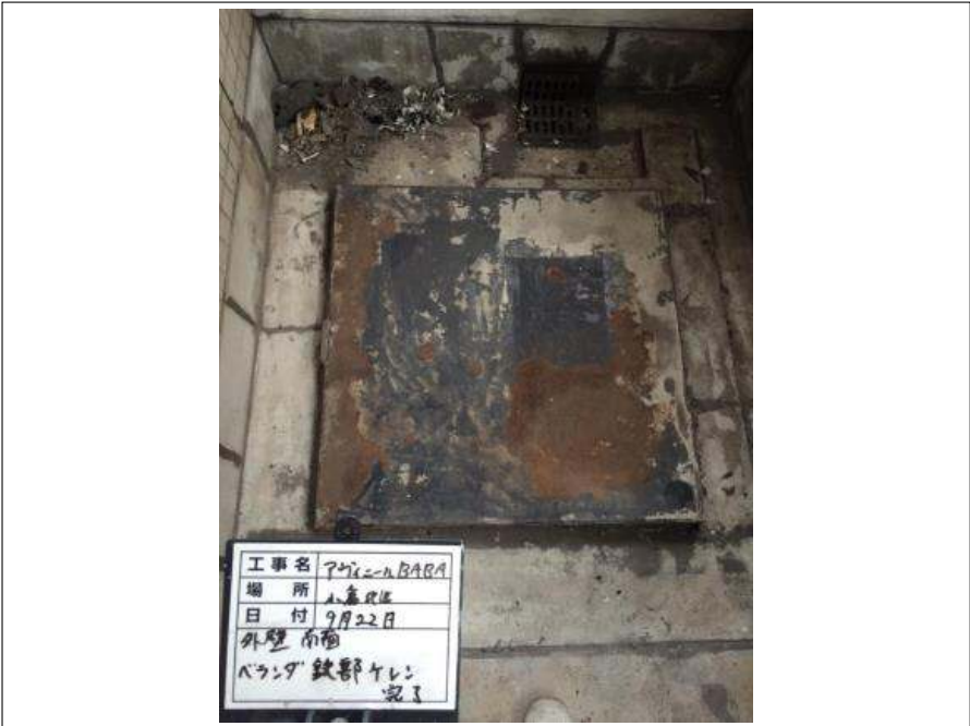
南面 鉄部 研磨紙ずり施工完了
