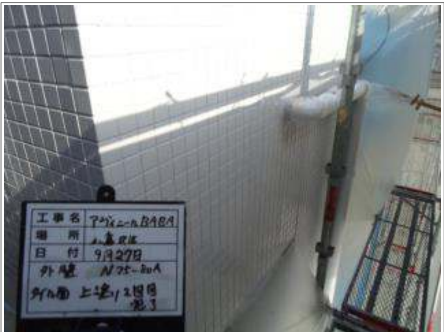
タイル面 上塗り施工完了（2回目）
