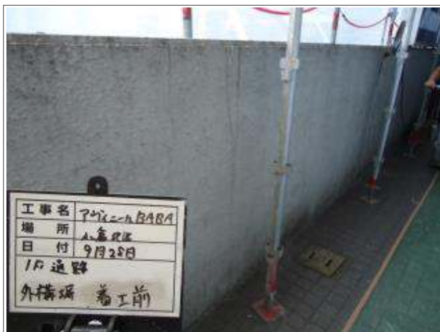
外構塀 施工前
