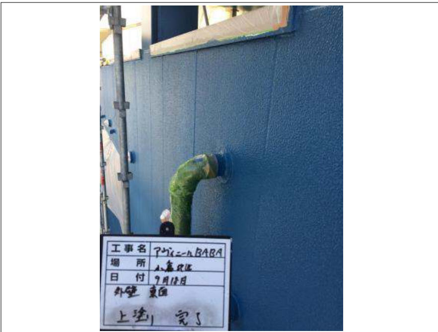
外壁東面 上塗り施工完了
