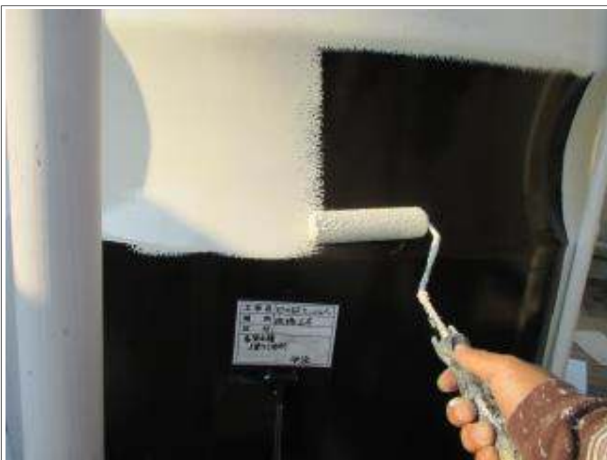
高架水槽 上塗り(1回目) 施工中
