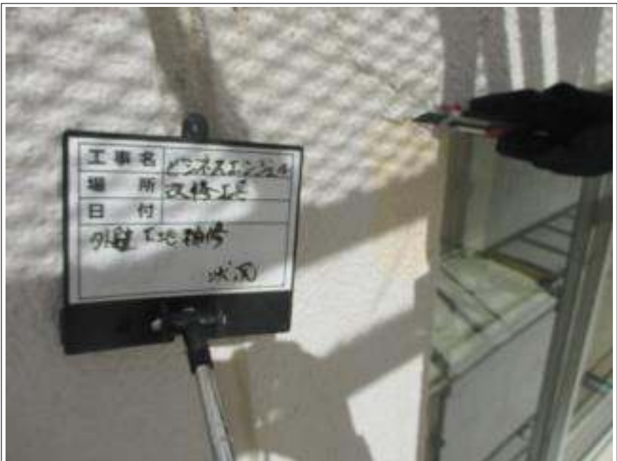
外壁 下地処理施工中
