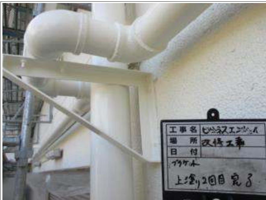
ブラケット 上塗り(2回目) 施工完了
