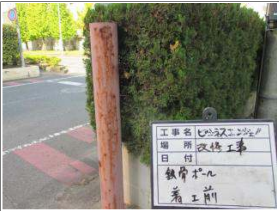
鉄骨ポール 施工前
