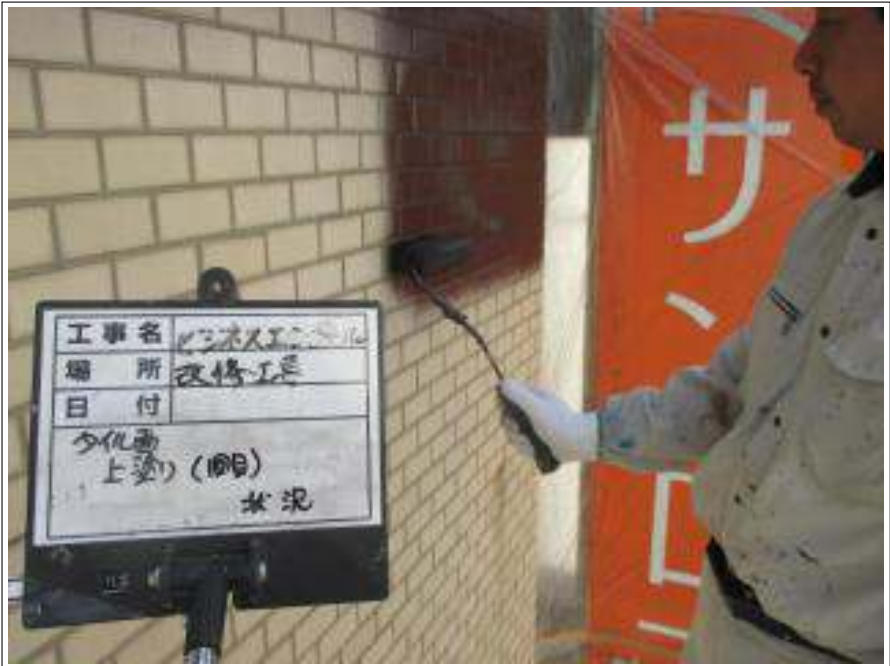
タイル面 上塗り（1回目）施工中
