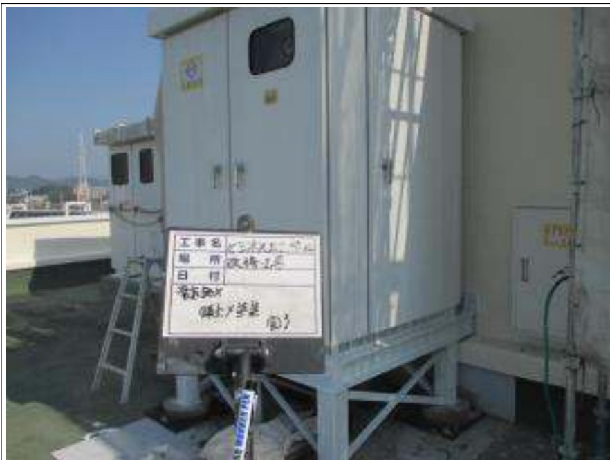
電気BOX サビ止め塗布施工完了
