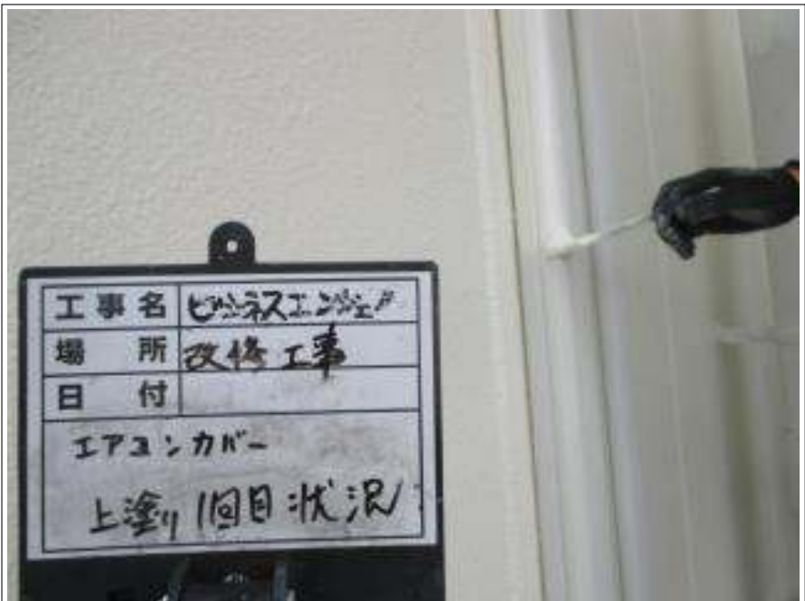
エアコンカバー - 上塗り (1回目) 施工中
