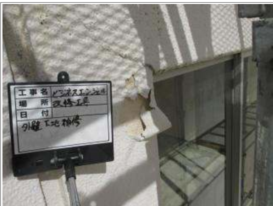
外壁 下地処理施工前
