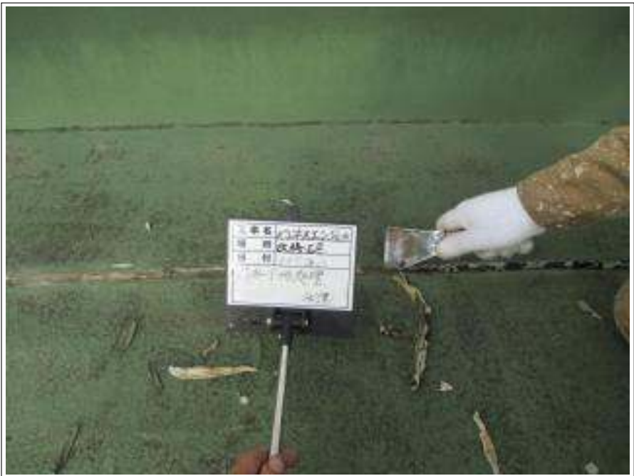
屋上 下地処理施工中
