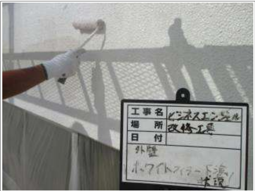
外壁 下塗り施工中
