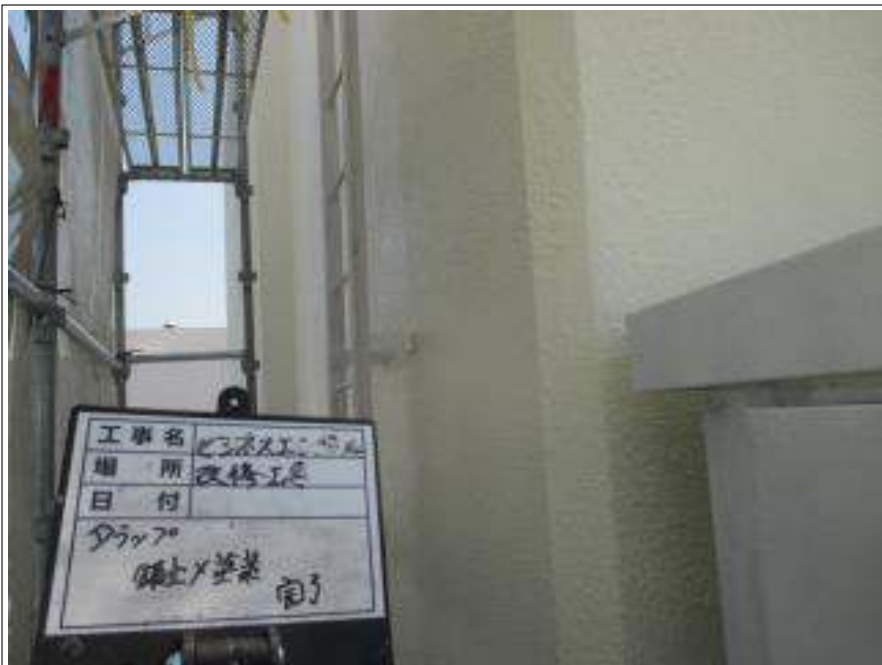
タラップ 錆止め塗布施工完了
