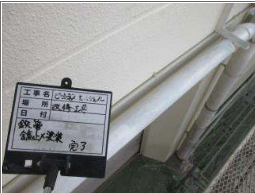
鉄管 サビ止め塗布施工完了
