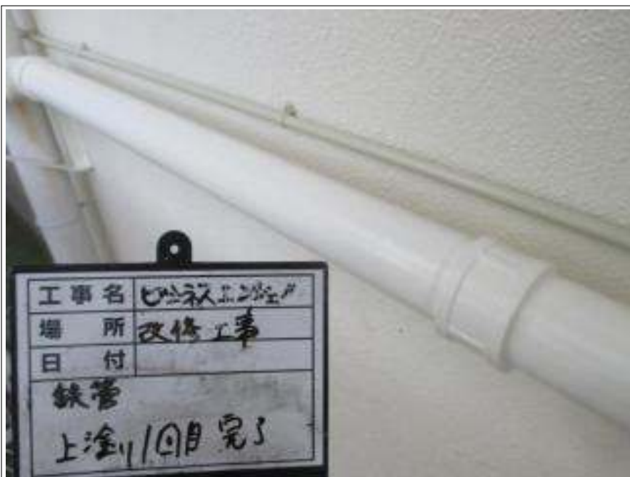
鉄管 上塗り（1回目）施工完了
