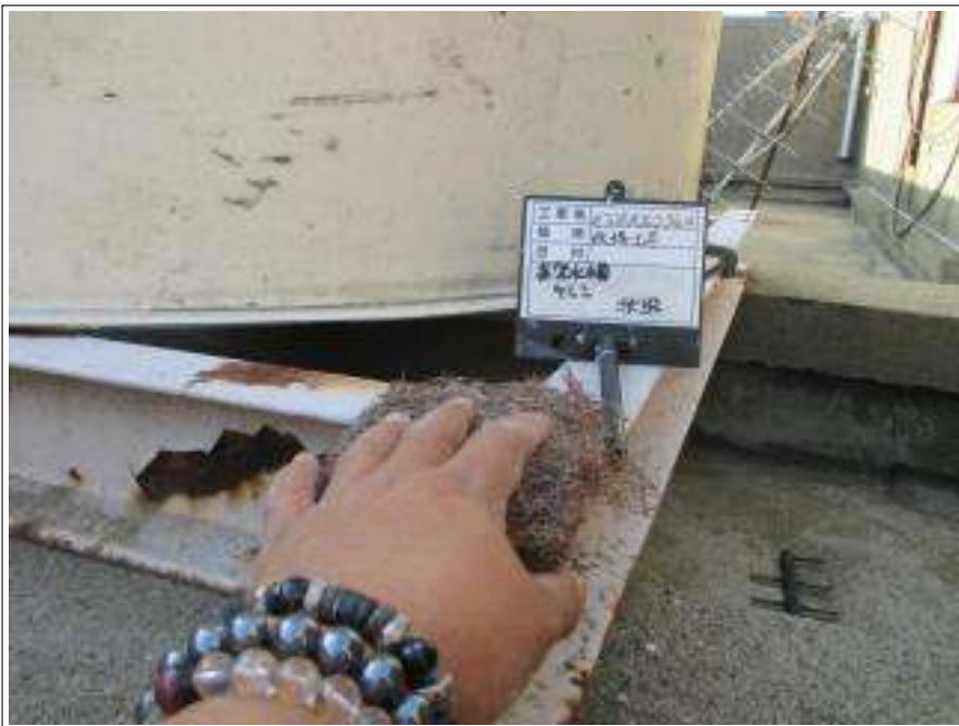
高架水槽 ケレン処理施工中
