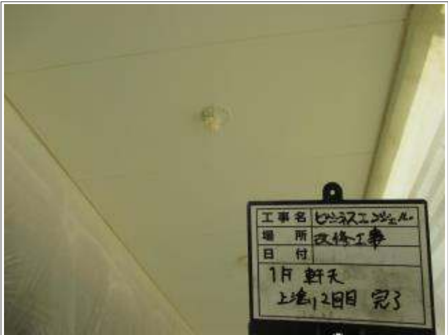
軒天 上塗り（2回目）施工完了
