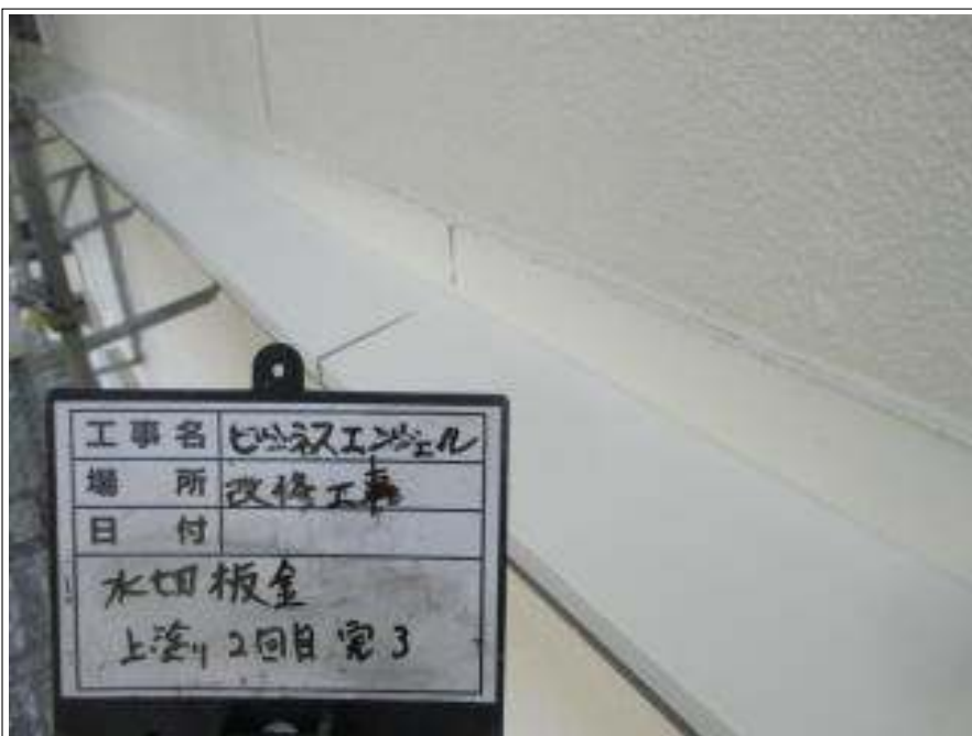
水切り板金 上塗り(2回目)施工完了
