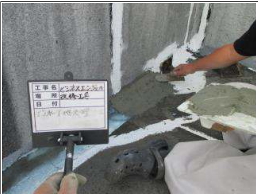
屋上 下地処理施工中
