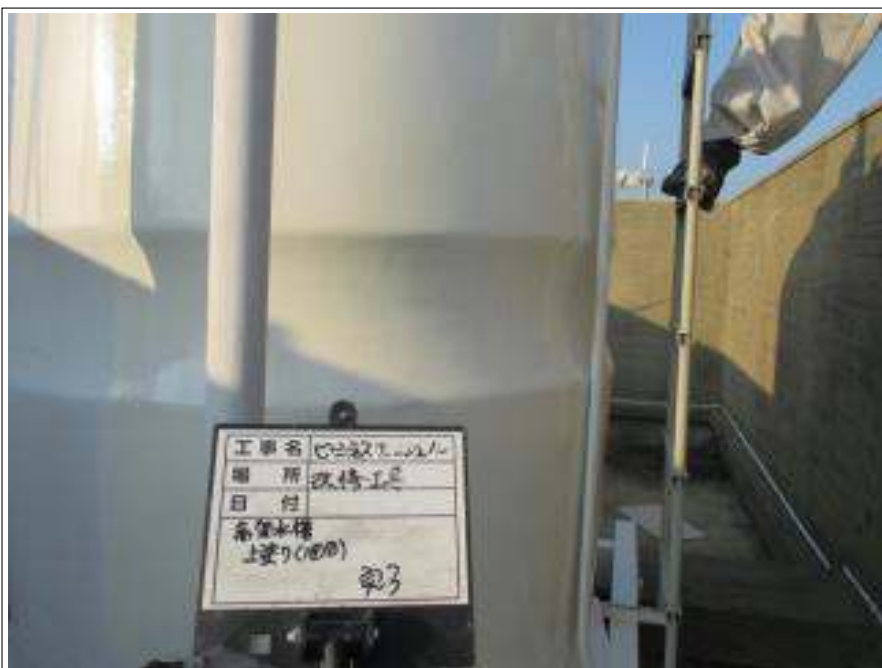
高架水槽 上塗り(1回目) 施工完了
