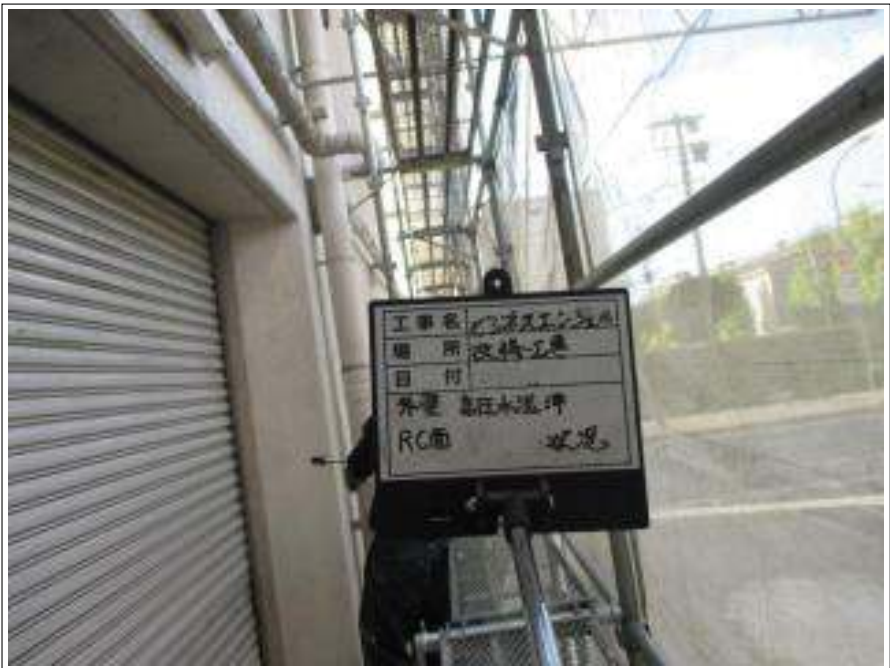
外壁 高圧洗浄中
