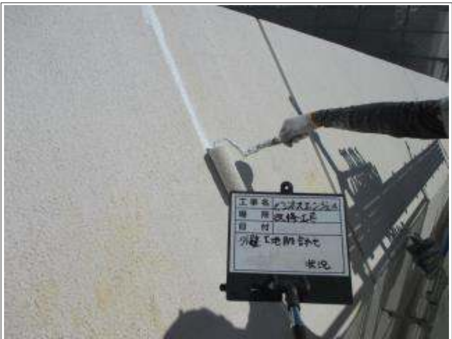
外壁 下地肌合わせ 施工中
