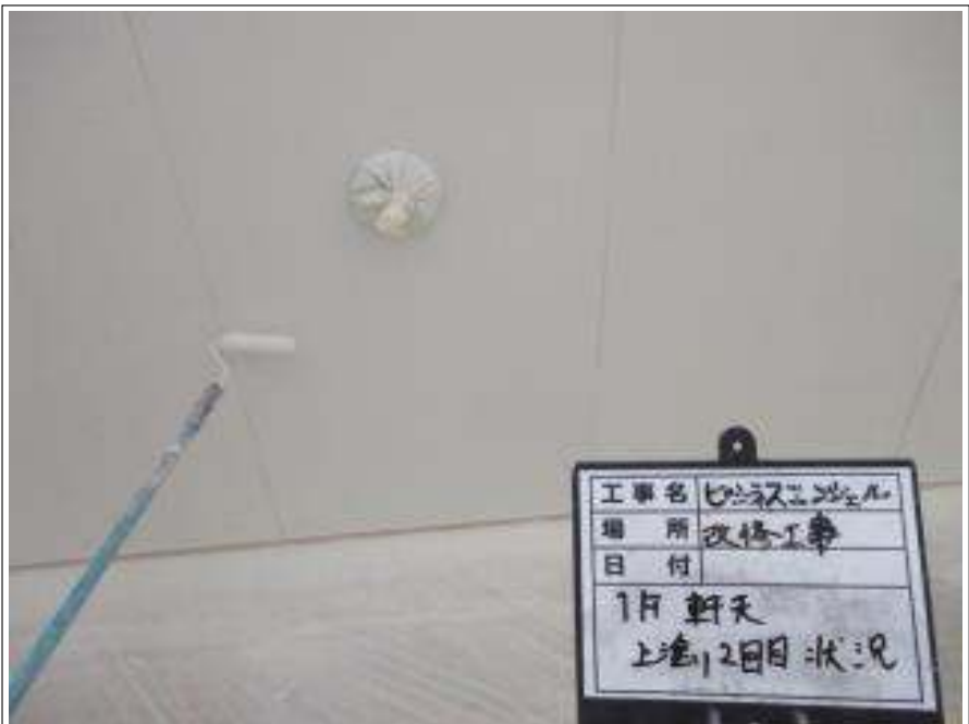
軒天 上塗り（2回目）施工中
