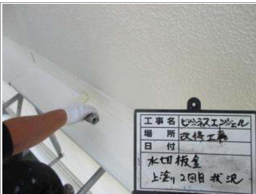
水切り板金 上塗り(2回目)施工中
