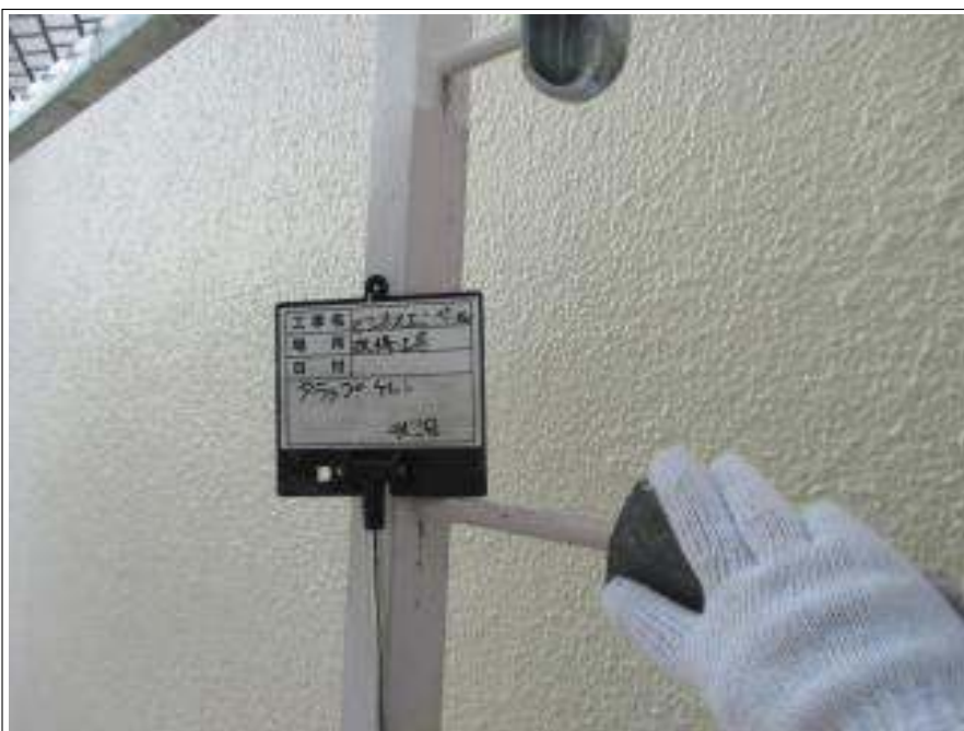
タラップ ケレン処理施工中
