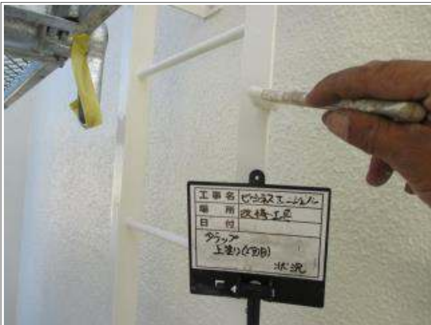
タラップ 上塗り(2回目) 施工中
