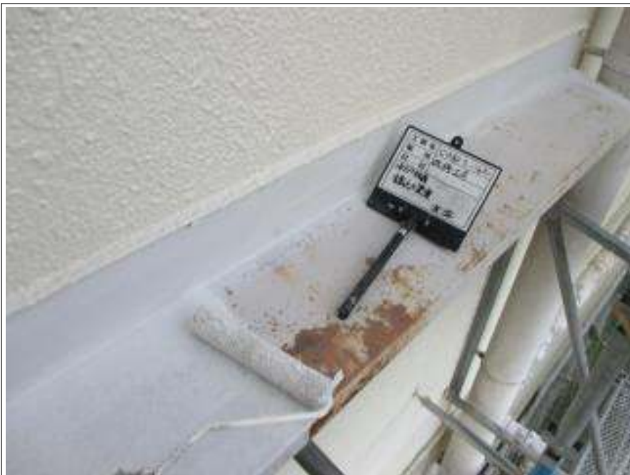
水切り板金 サビ止め塗布施工中
