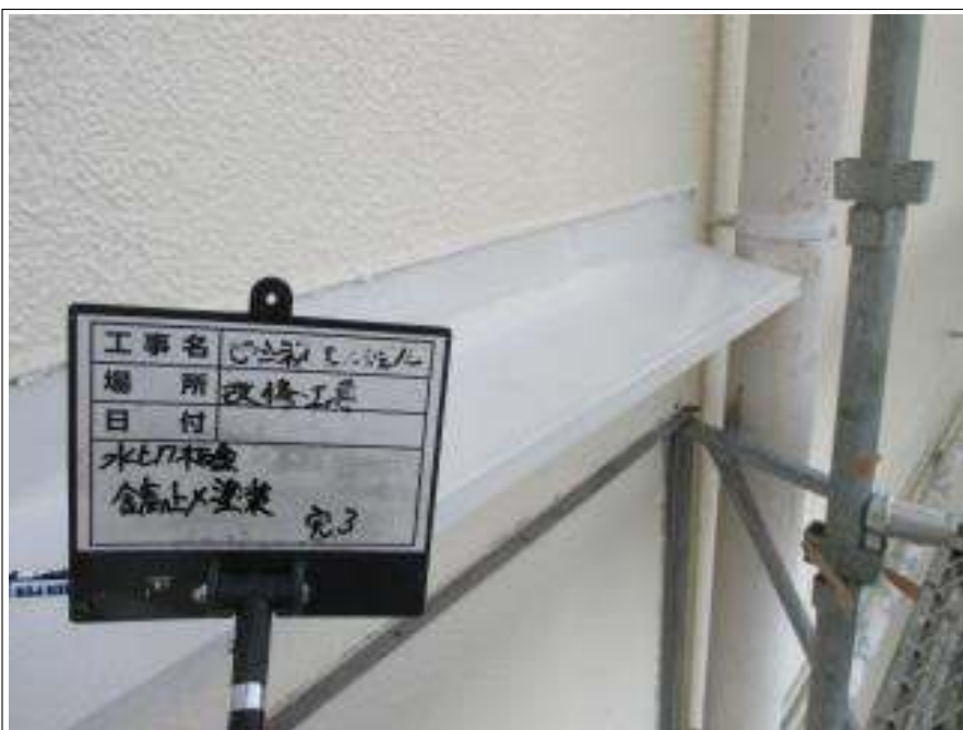
水切り板金 サビ止め塗布施工完了
