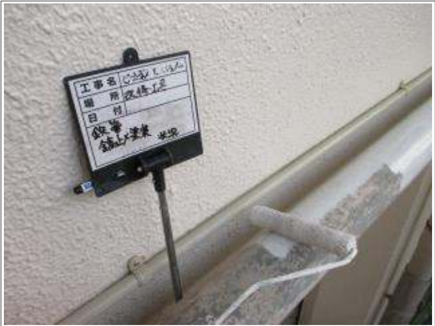
鉄管 サビ止め塗布施工中
