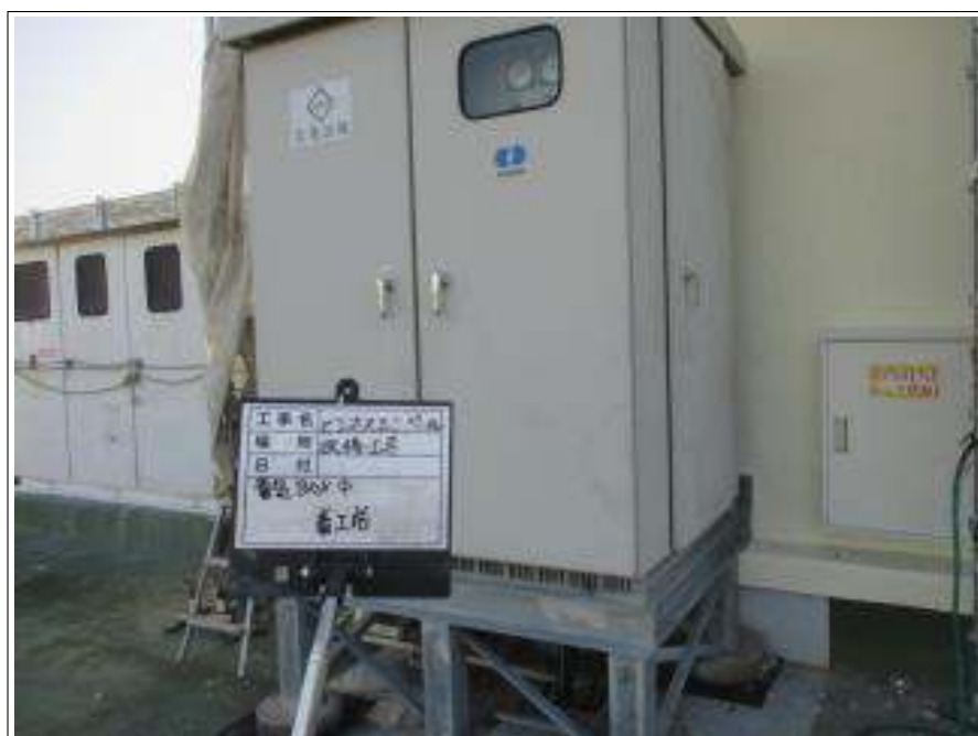
電気BOx 施工前
