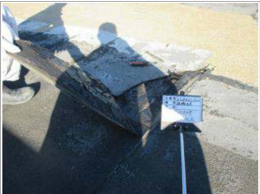
屋上 下地処理施工中
