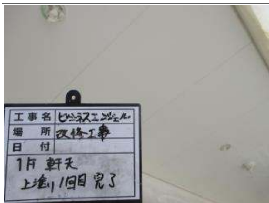
軒天 上塗り（1回目）施工完了
