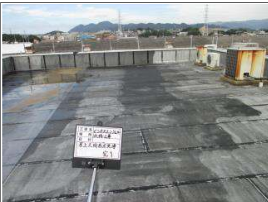
屋上 高圧洗浄完了
