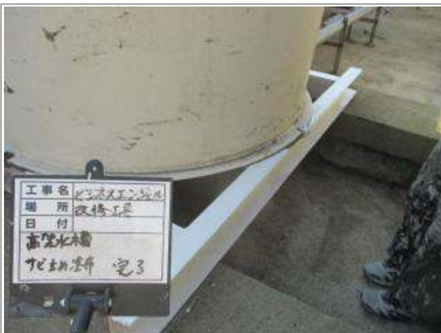
高架水槽 サビ止め塗布施工完了
