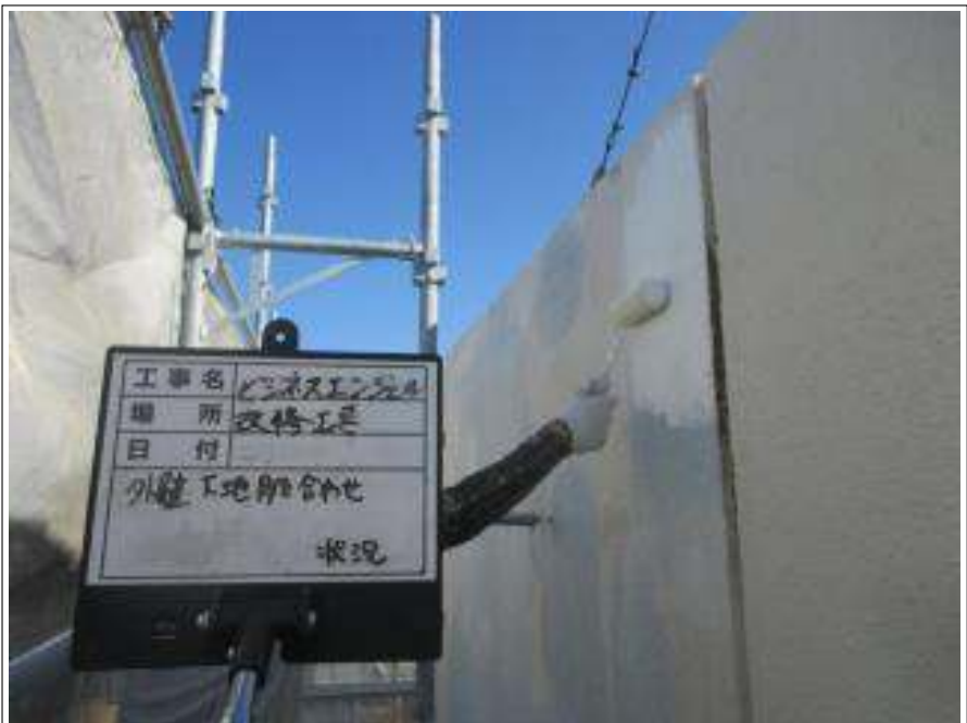
外壁 下地肌合わせ 施工中
