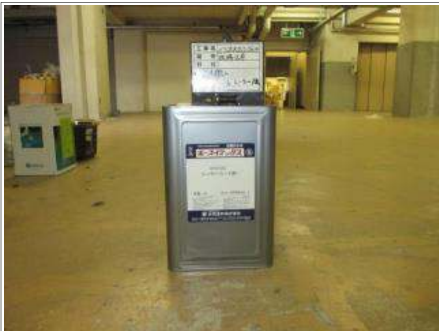
屋上(シート部) 下塗り使用材料
