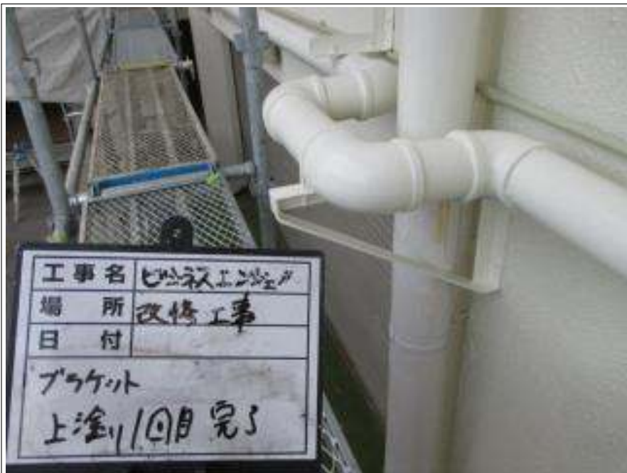
ブラケット 上塗り(1回目)施工完了
