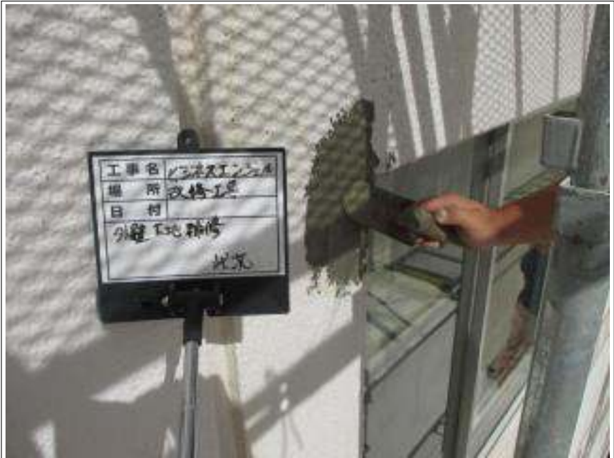
外壁 下地処理施工中
