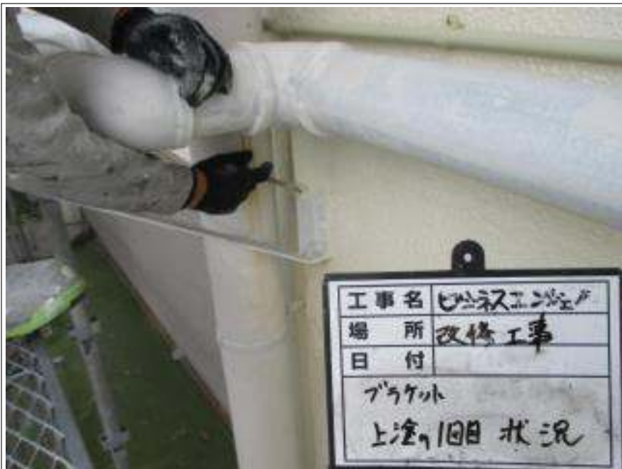
ブラケット 上塗り(1回目)施工中
