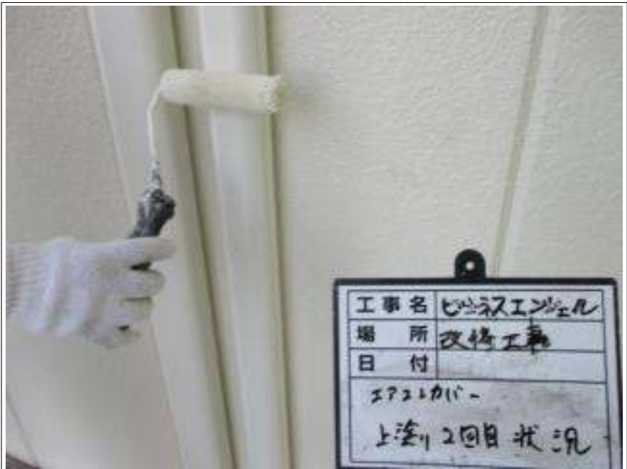
エアコンカバー - 上塗り (2回目) 施工中
