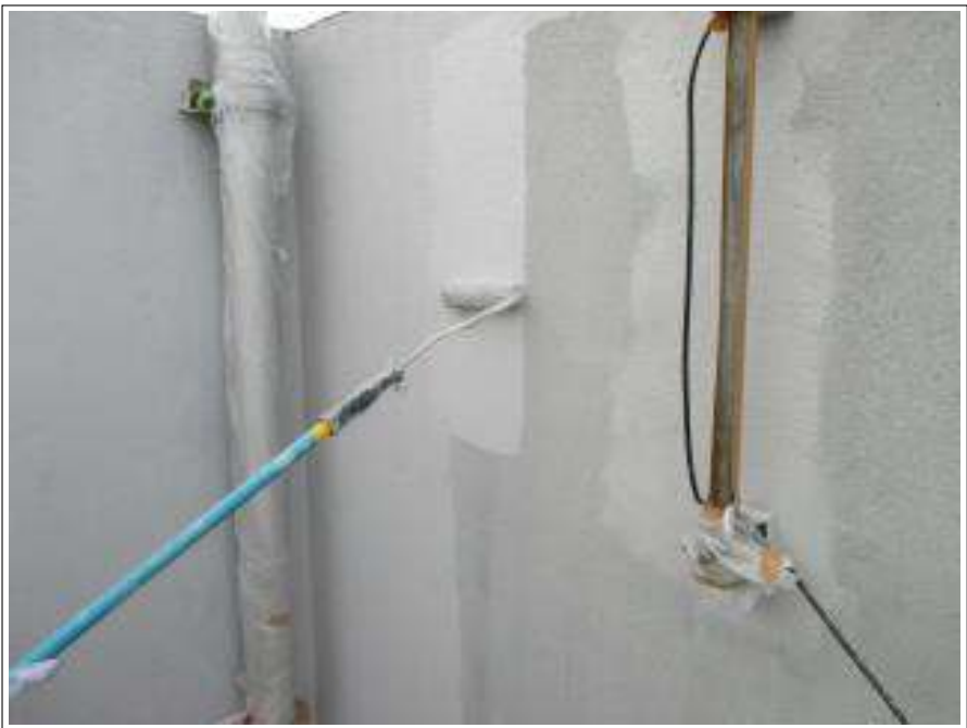
屋上内壁 中塗り施工中
