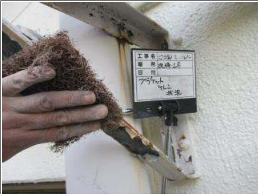
ブラケット ケレン処理施工中
