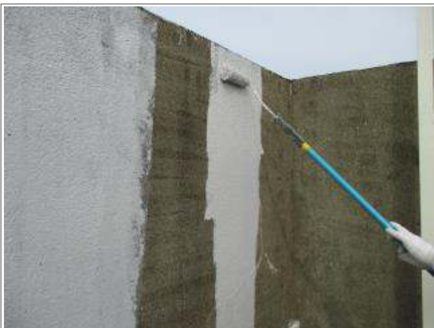
屋上内壁 下塗り施工中
