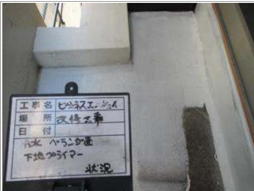
ベランダ 下塗り施工中
