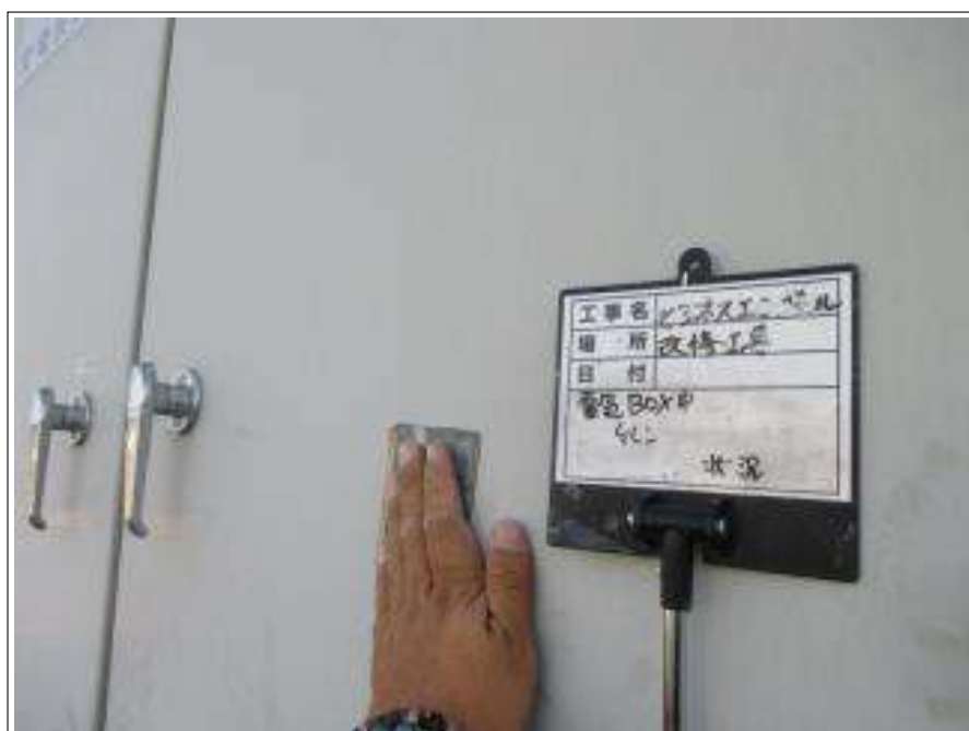
電気BOx ケレン処理施工中
