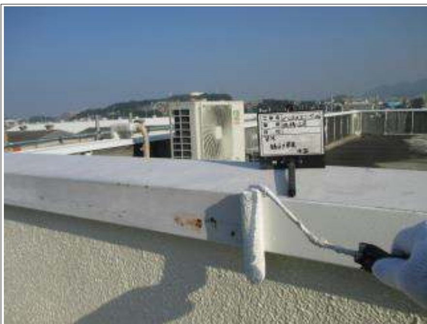
笠木 下塗り施工中
