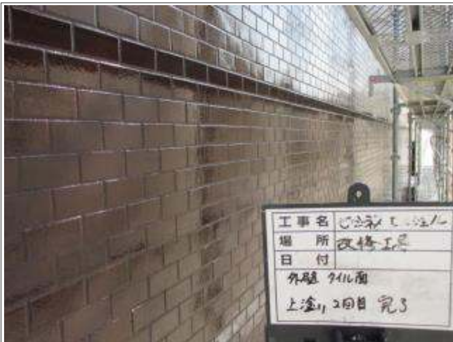
タイル面 施工完了
