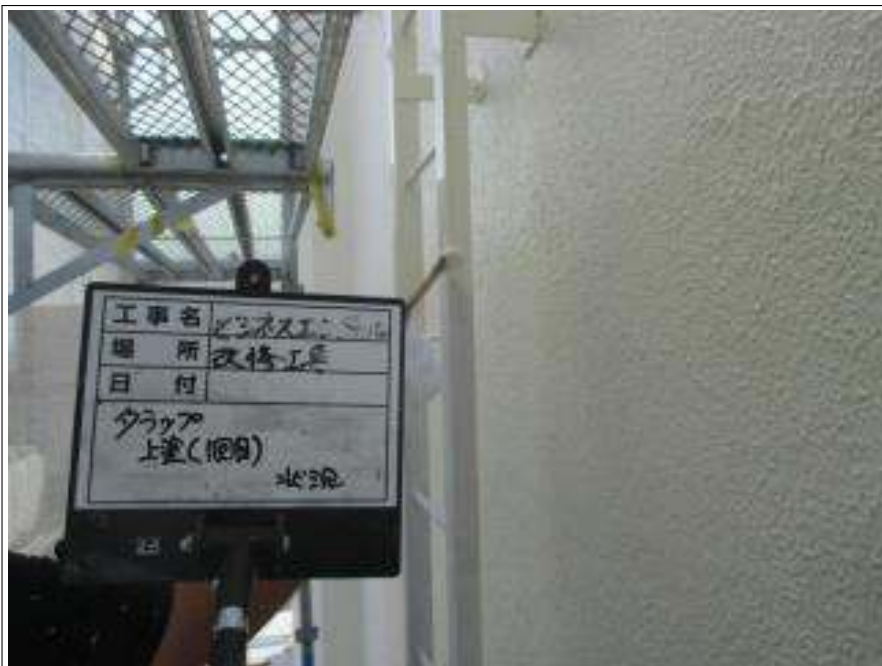
タラップ 上塗り(1回目) 施工中
