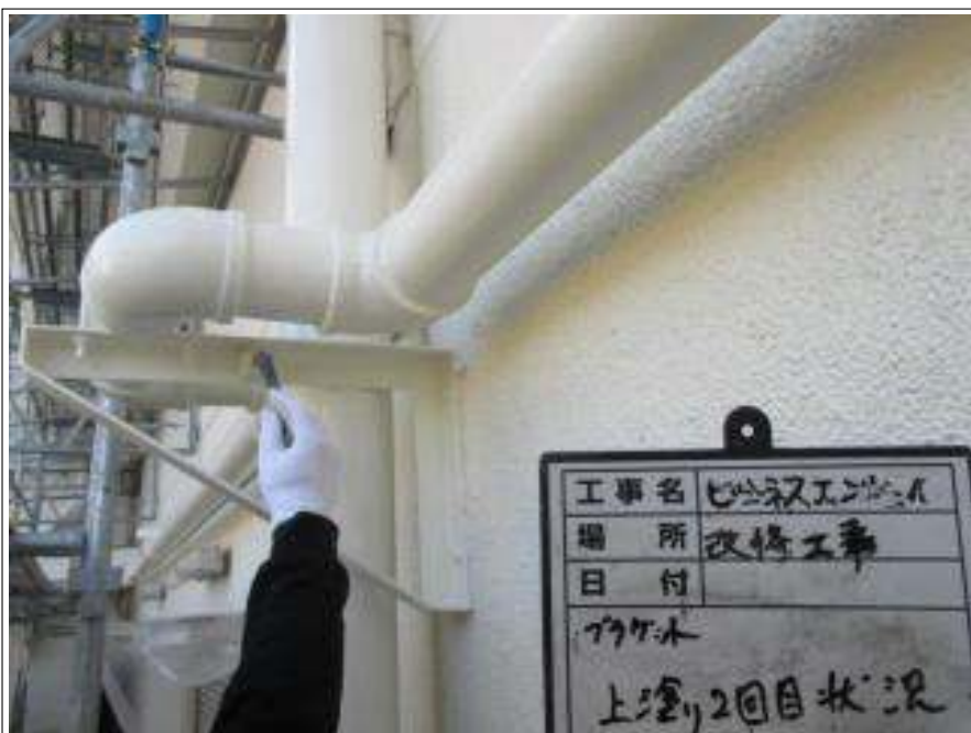
ブラケット 上塗り(2回目)施工中
