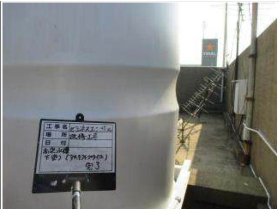
高架水槽 下塗り施工完了
