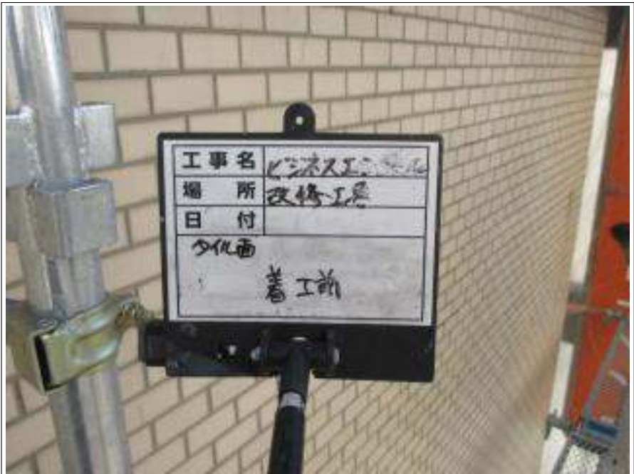
外壁タイル面 施工前
