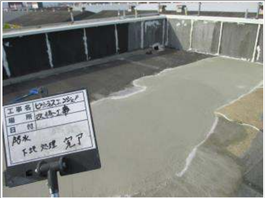
屋上 下地処理施工完了
