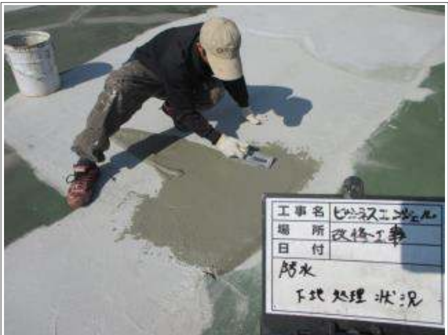
屋上 下地処理施工中
