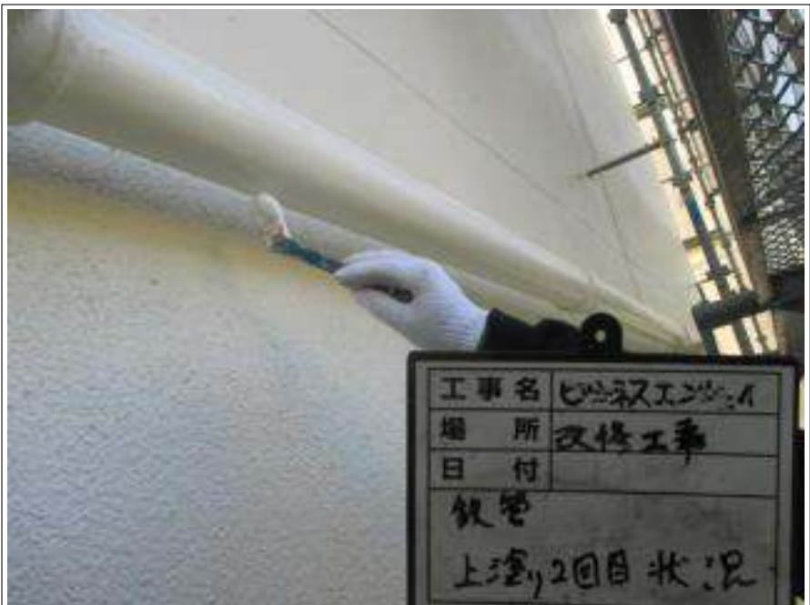
鉄管 上塗り（2回目）施工中
