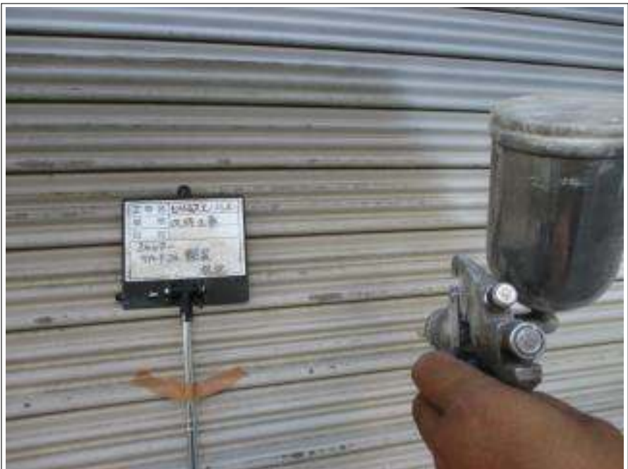
シャッター 下塗り施工中
