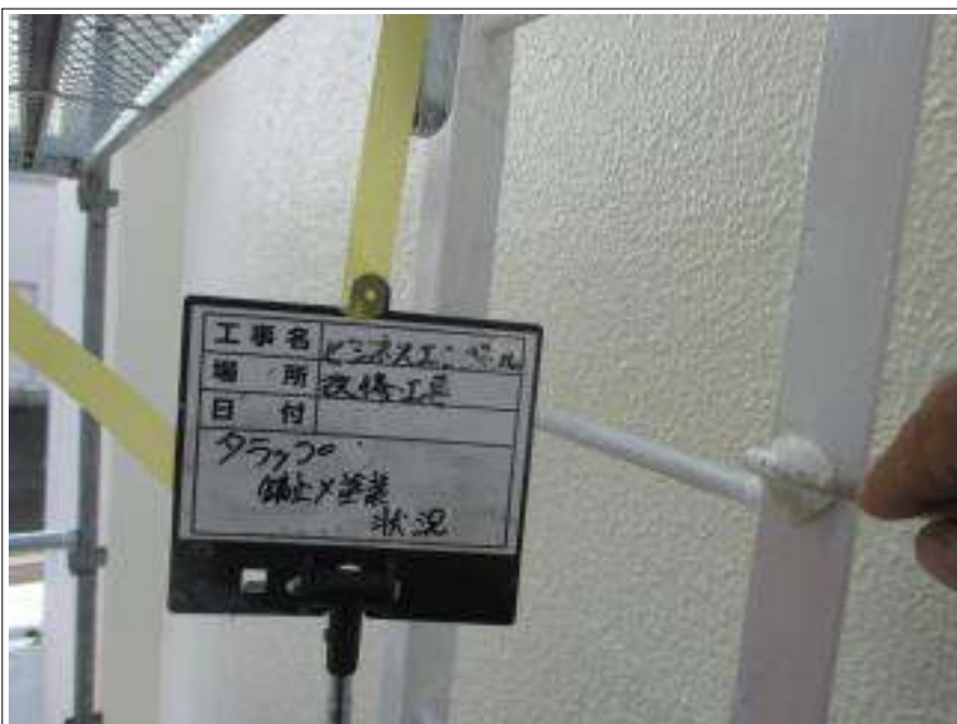
タラップ サビ止め塗布施工中
