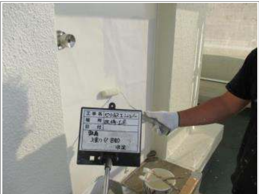
鉄扉 上塗り（1回目）施工中
