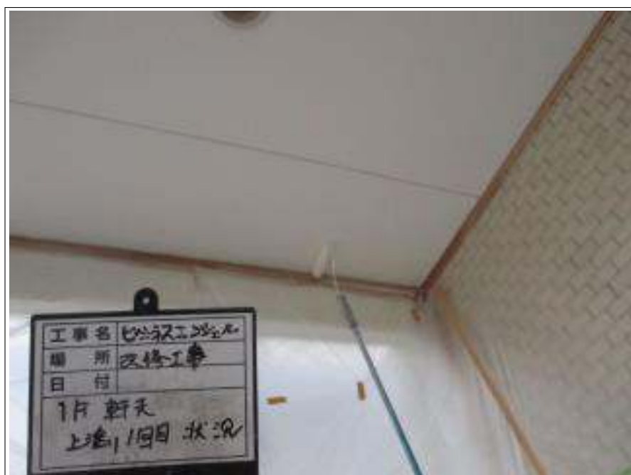
軒天 上塗り（1回目）施工中
