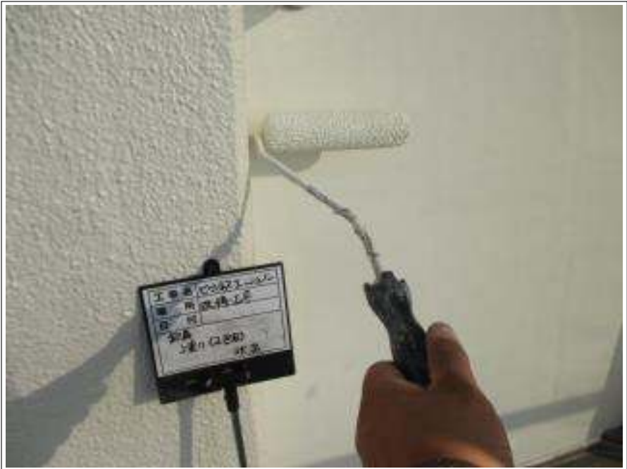
鉄扉 上塗り（2回目）施工中
