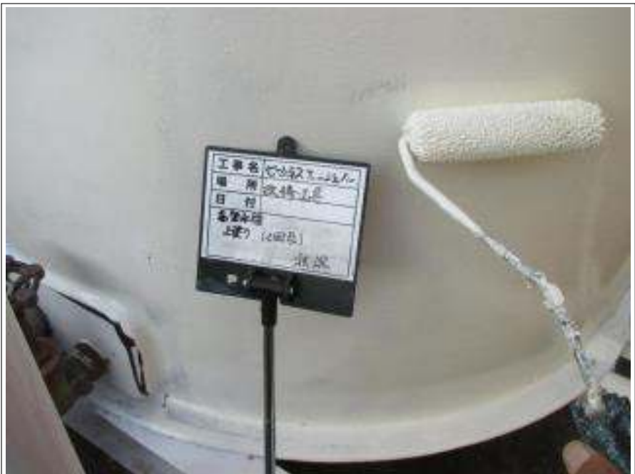
高架水槽 上塗り(2回目) 施工中
