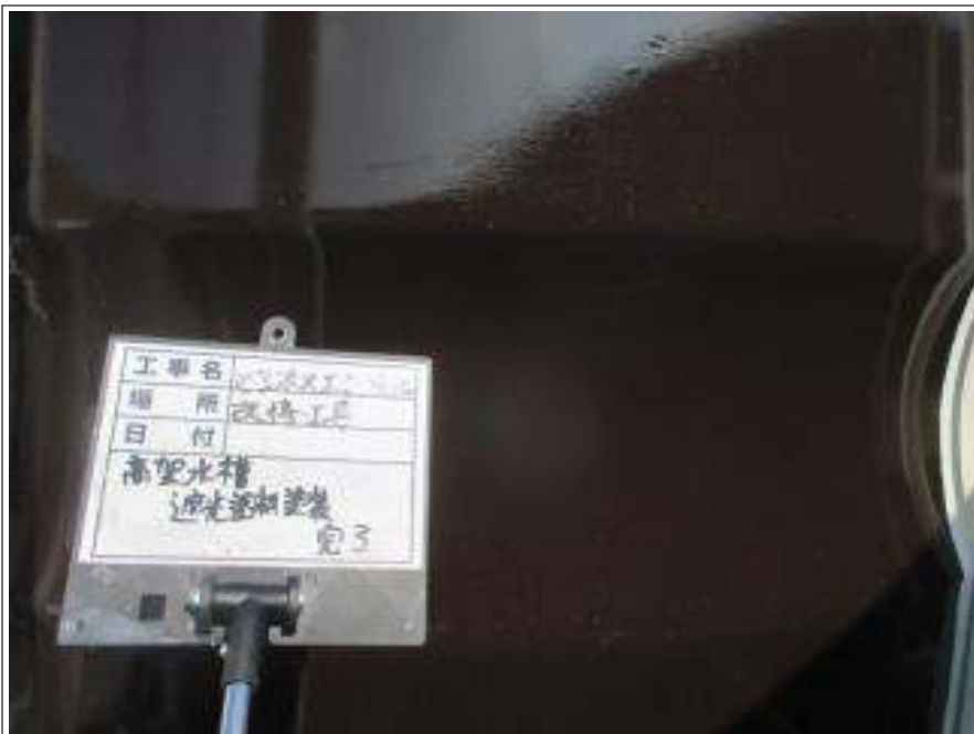
高架水槽 遮熱塗料塗布施工完了
