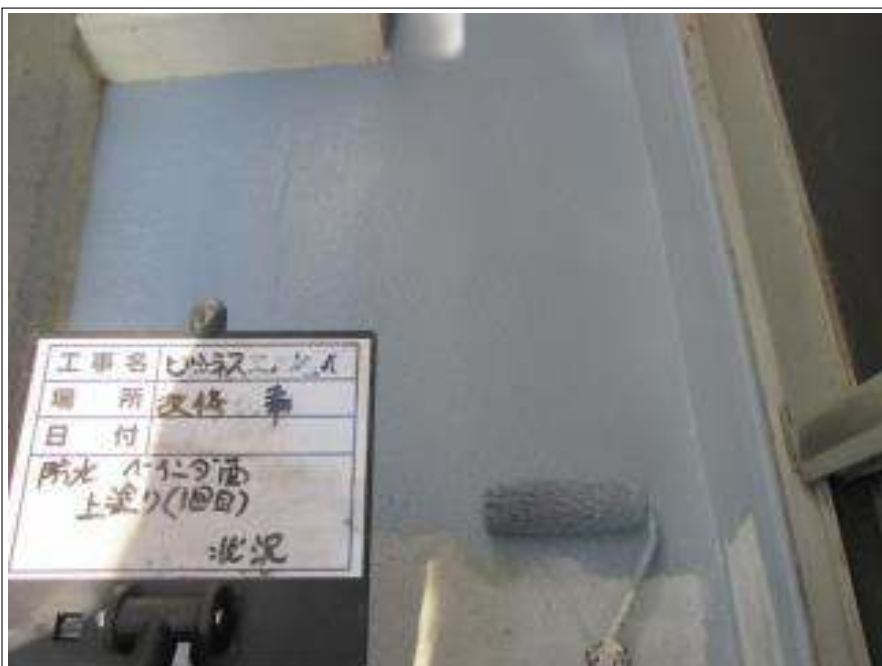
ベランダ 上塗り(1回目) 施工中
