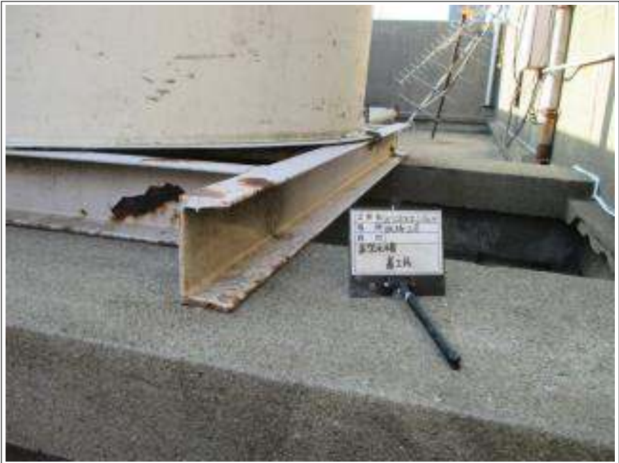
高架水槽 施工前
