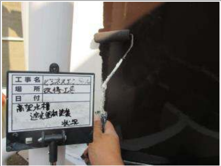
高架水槽 遮熱塗料塗布施工中
