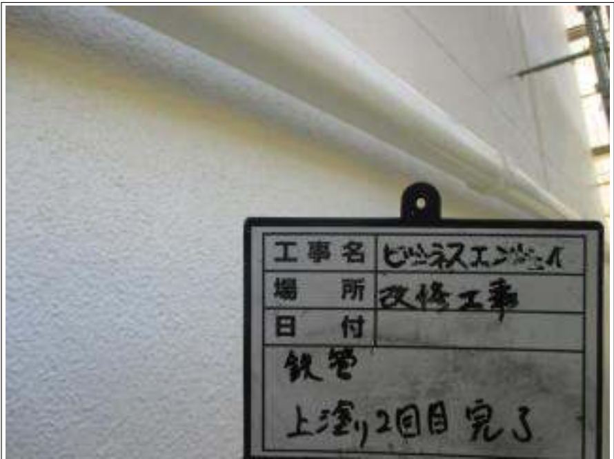
鉄管 上塗り（2回目）施工完了
