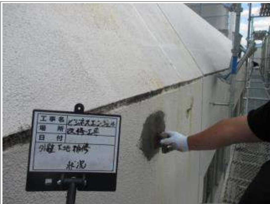
外壁 下地処理施工中
