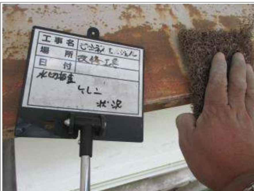
水切り板金 ケレン処理施工中
