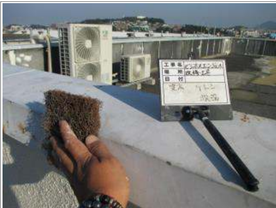
笠木 ケレン処理施工中
