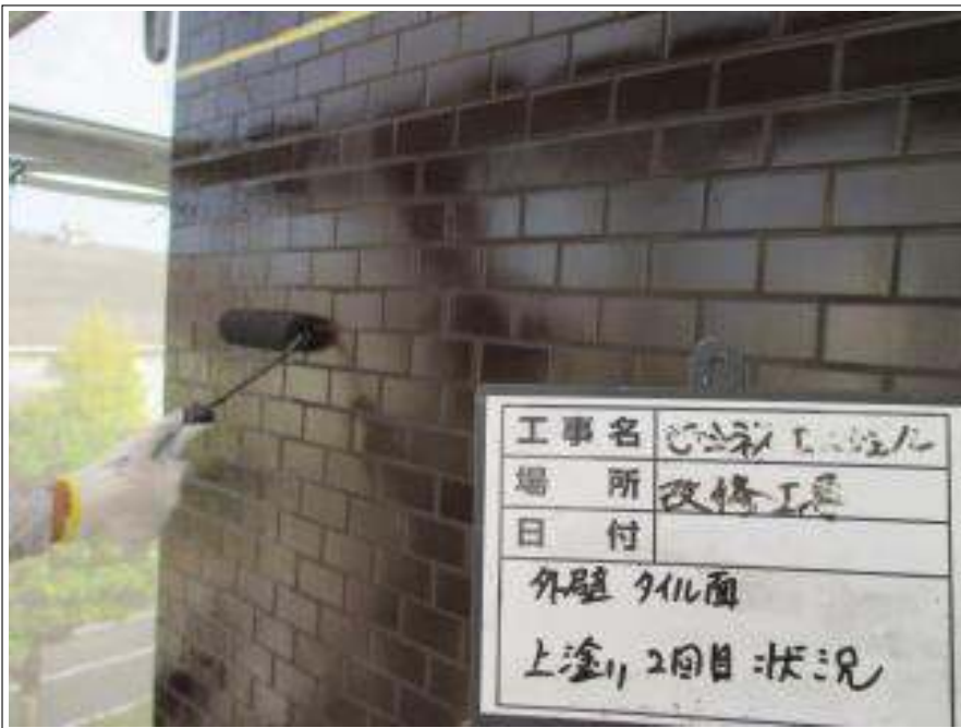
タイル面 上塗り（2回目）施工中
