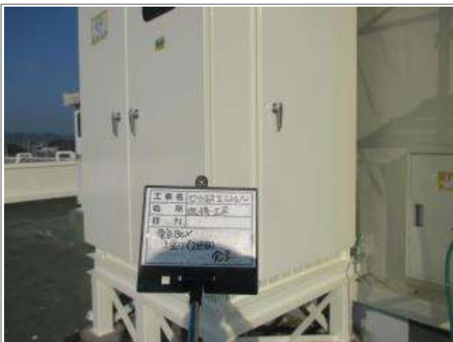
電気BOX 上塗り(2回目) 施工完了
