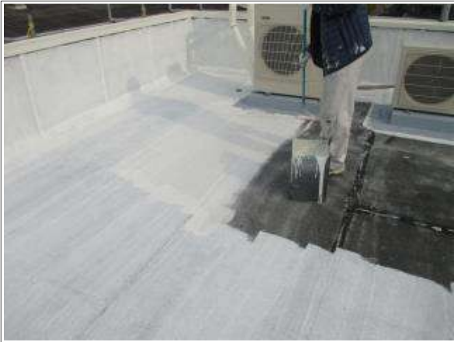
屋上 下塗り施工中
