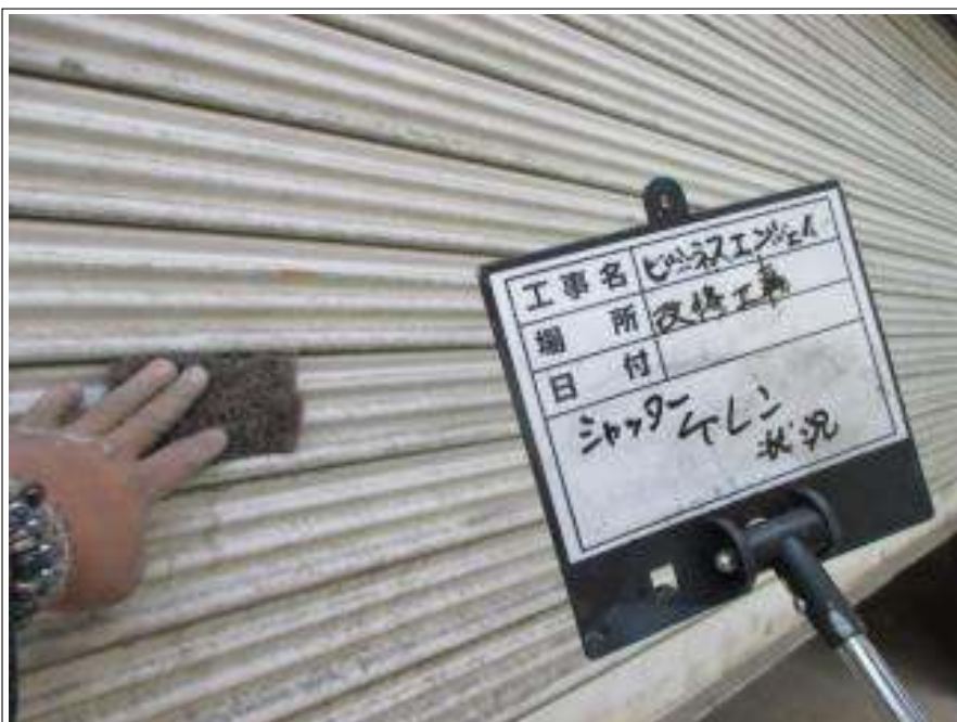
シャッター ケレン処理施工中
