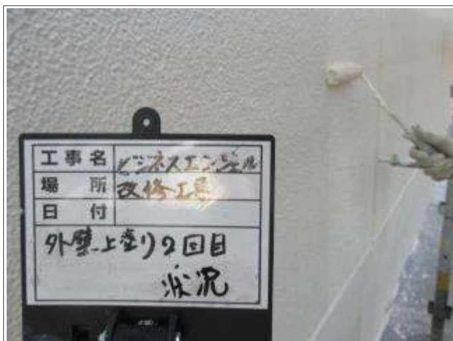
外壁 上塗り（2回目）施工中
