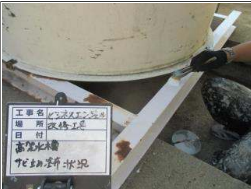
高架水槽 サビ止め塗布施工中
