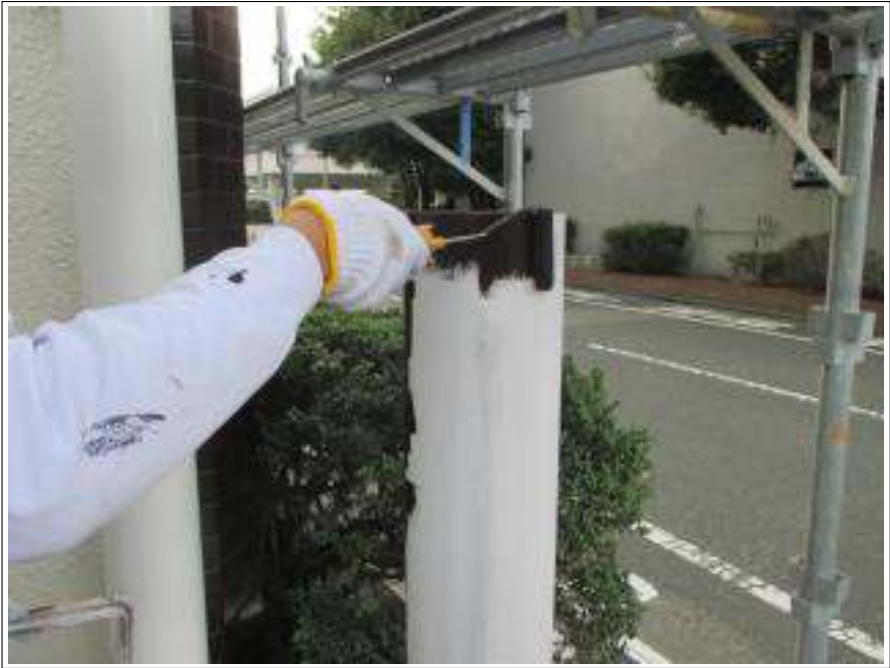
鉄骨ポール 上塗り施工中
