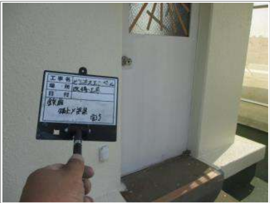
鉄扉 サビ止め塗布施工完了
