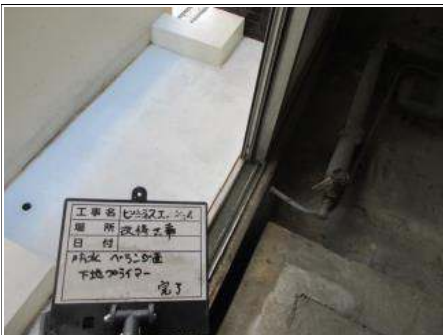
ベランダ 下塗り施工完了
