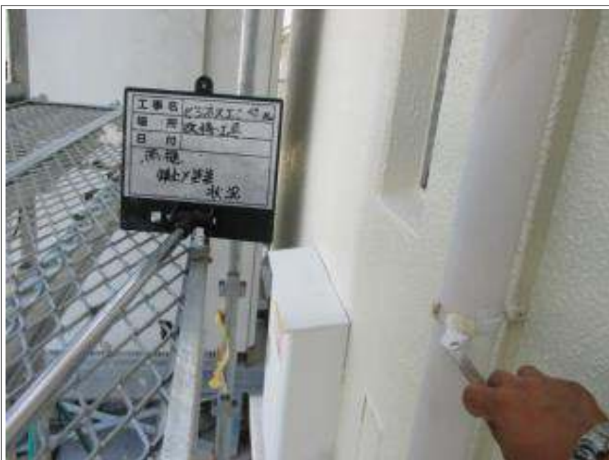
樋 サビ止め塗布施工中
