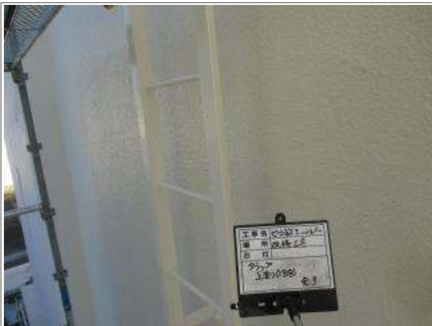
タラップ 上塗り(2回目) 施工完了
