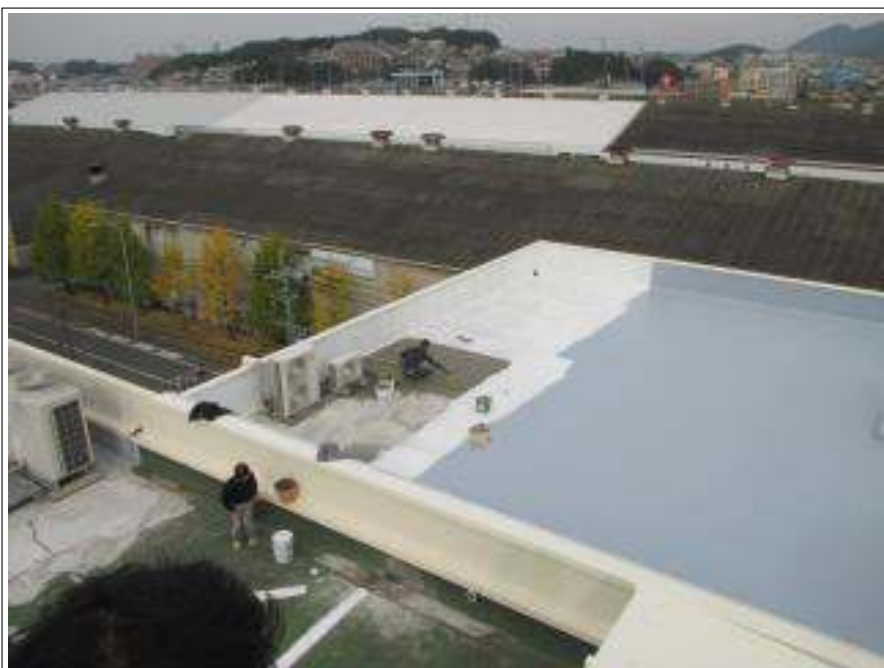
屋上 中塗り施工中
