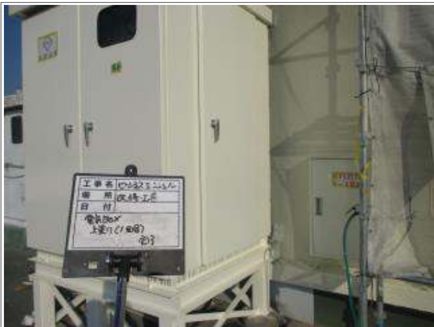
電気BOX 上塗り(1回目) 施工完了
