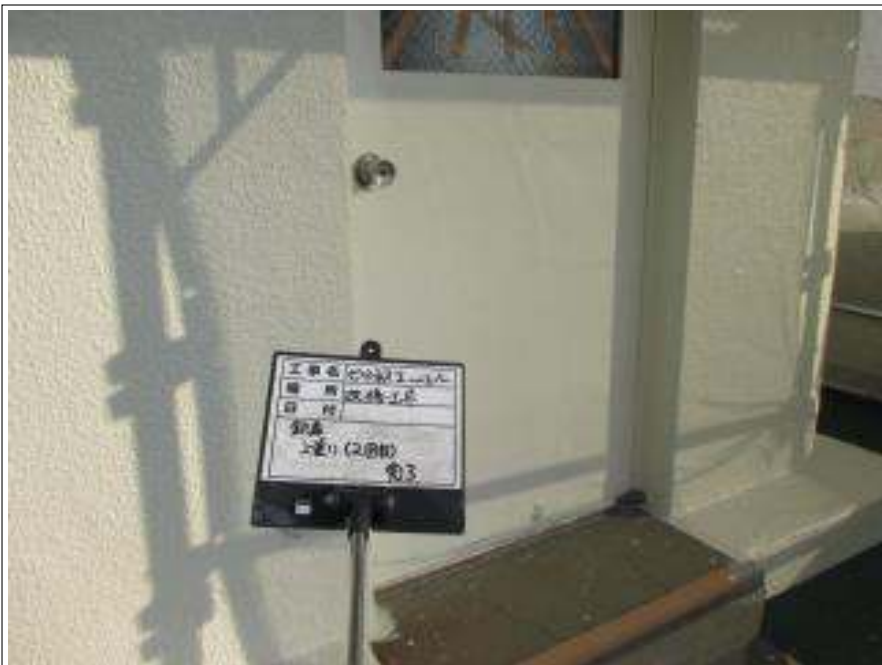
鉄扉 上塗り（2回目）施工完了
