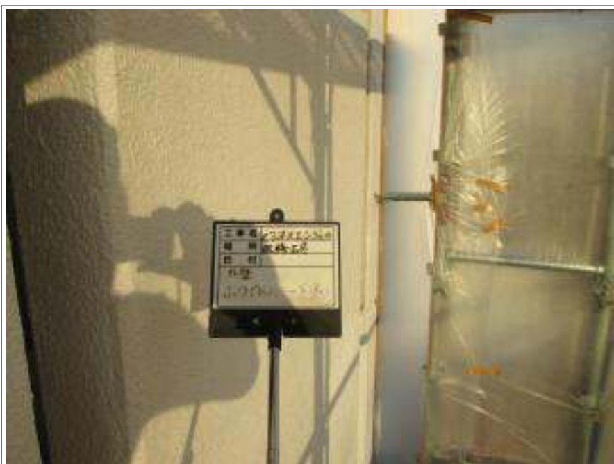
外壁 中塗り施工完了
