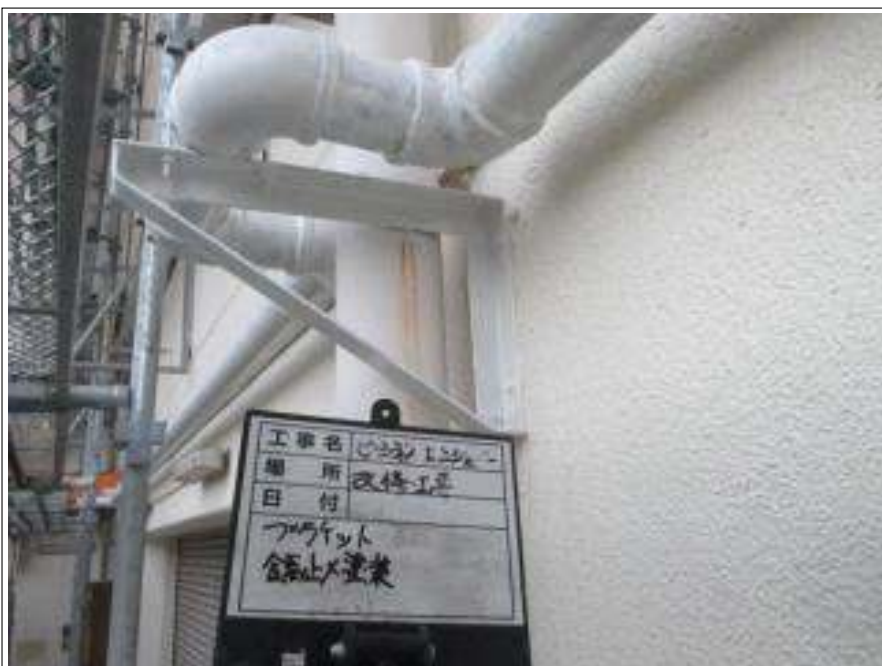
ブラケット サビ止め塗布施工完了
