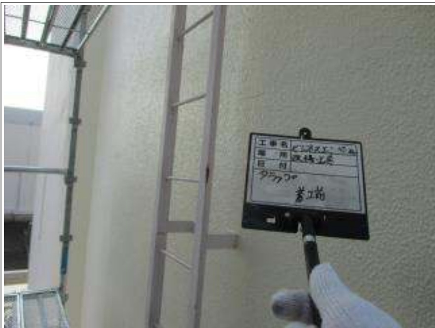
タラップ 施工前
