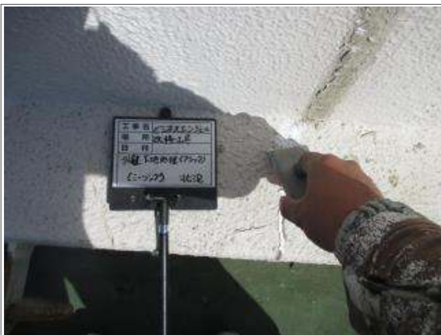
外壁 クラック補修施工中
