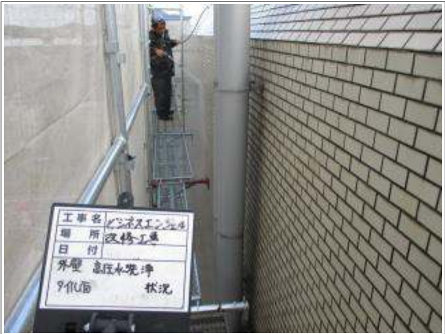
外壁 高圧洗浄中
