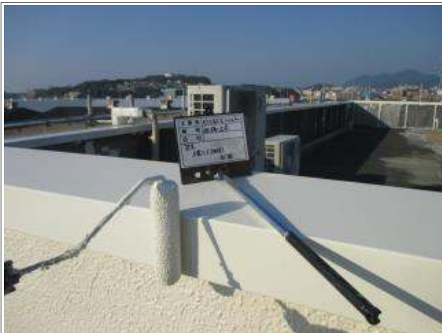
笠木 上塗り施工中
