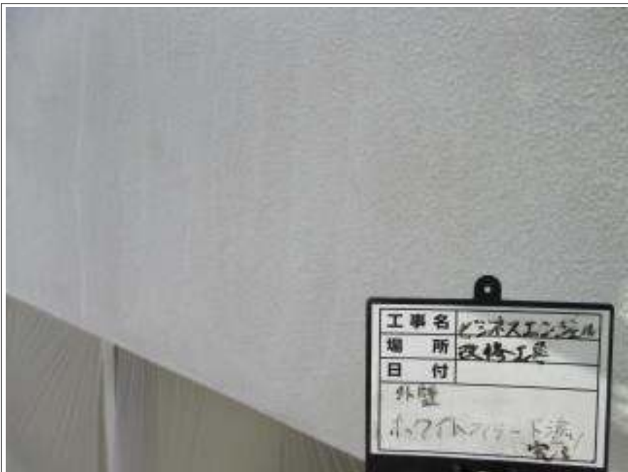
外壁 下塗り施工完了
