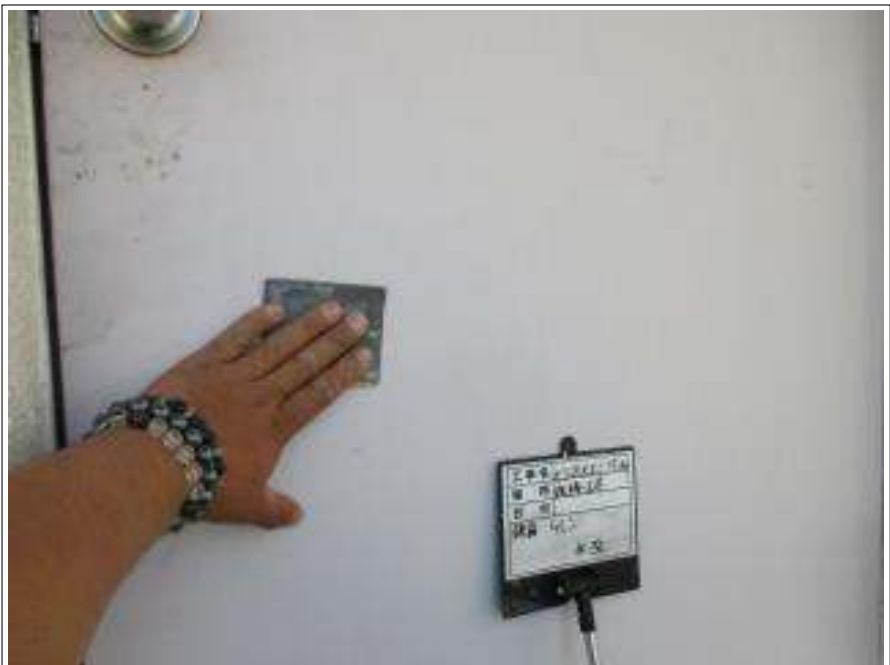
鉄扉 ケレン処理施工中
