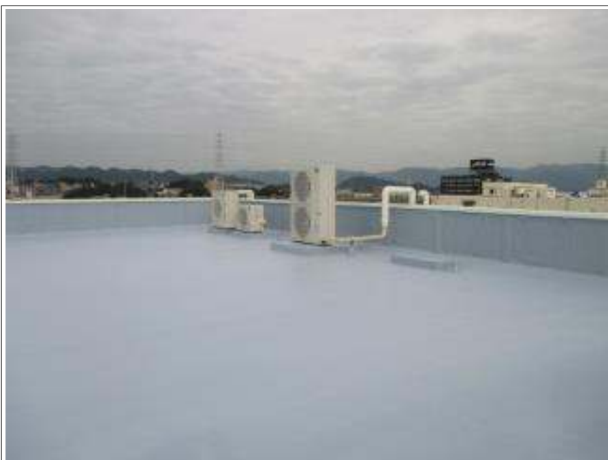
屋上 上塗り施工完了
