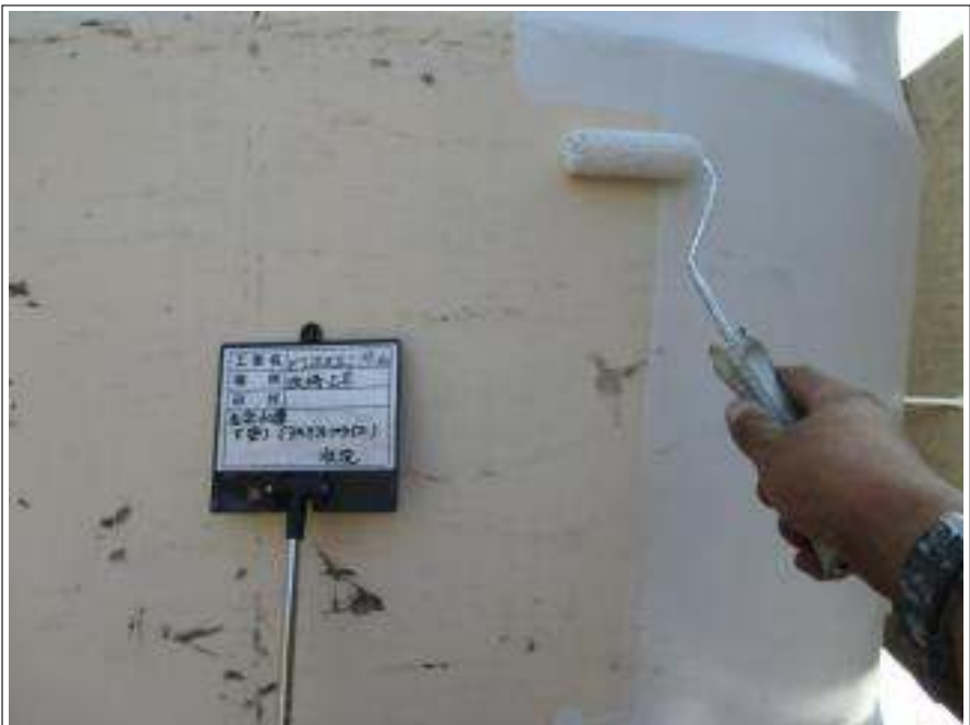
高架水槽 下塗り施工中
