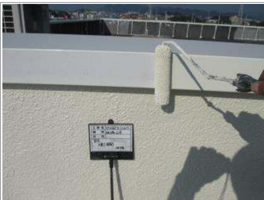
笠木 中塗り施工中
