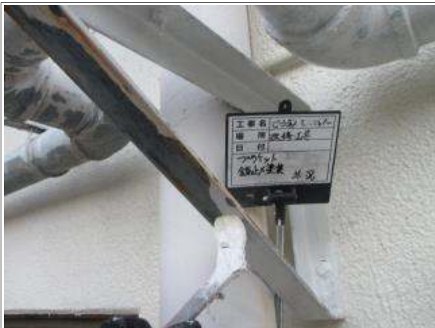
ブラケット サビ止め塗布施工中
