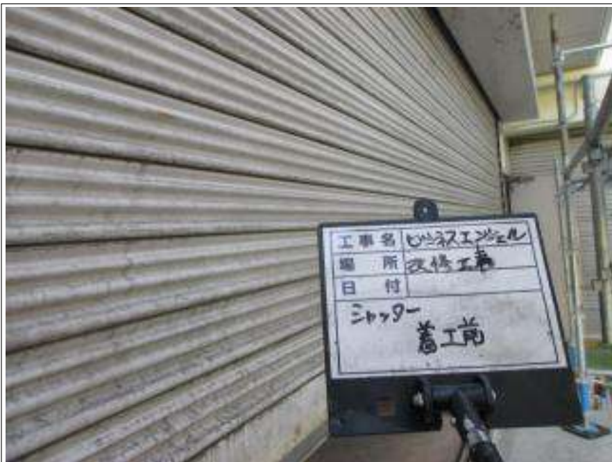
シャッター 施工前
