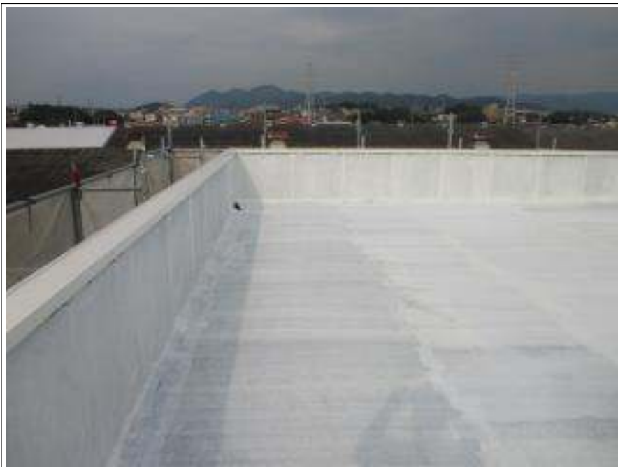
屋上 下塗り施工完了
