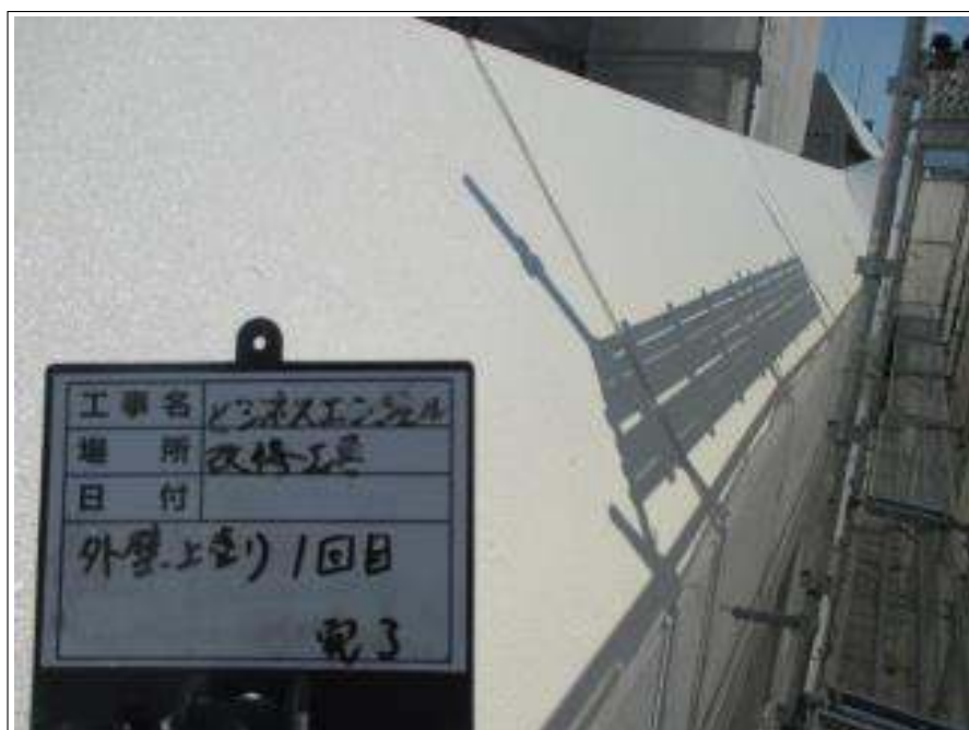
外壁 上塗り（1回目）施工完了
