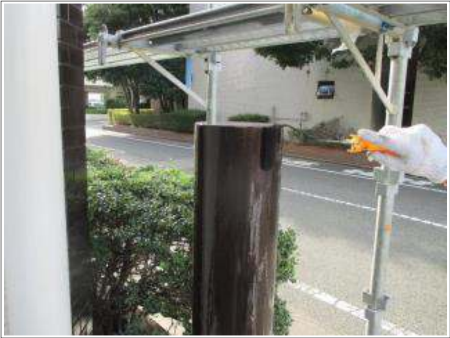
鉄骨ポール 上塗り施工完了
