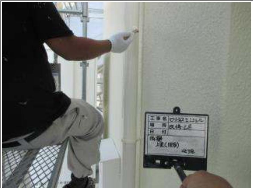
樋 上塗り（1回目）施工中
