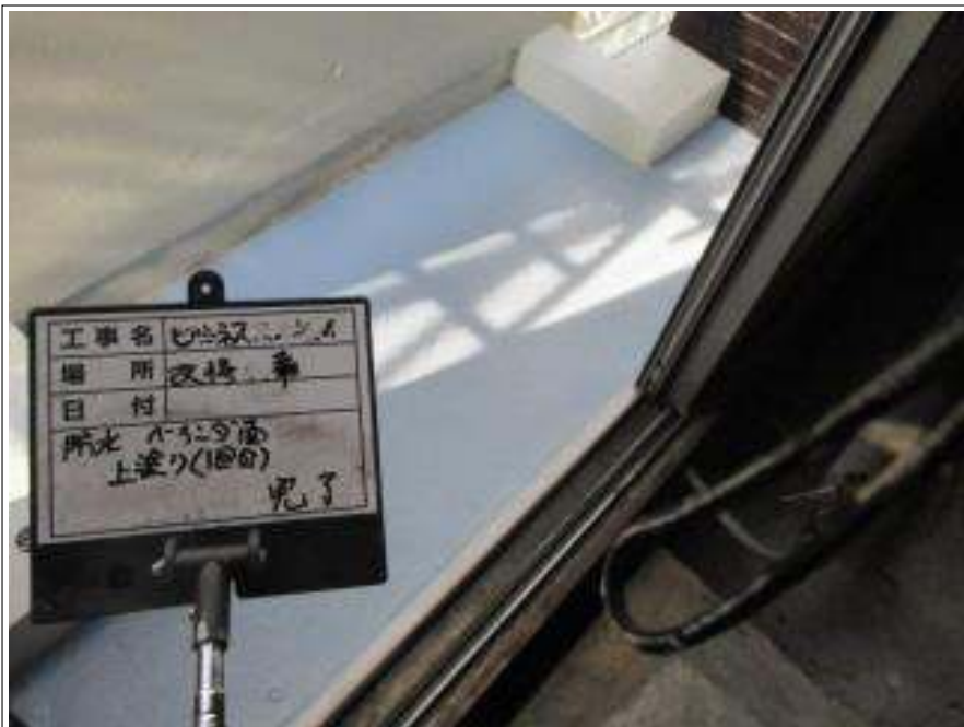
ベランダ 上塗り(1回目) 施工完了
