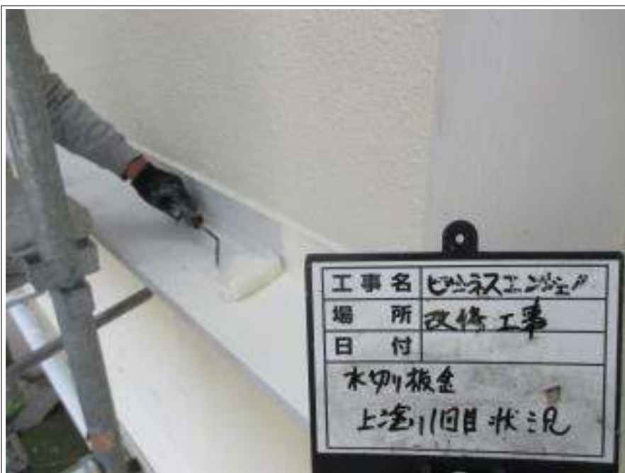
水切り板金 上塗り(1回目)施工中
