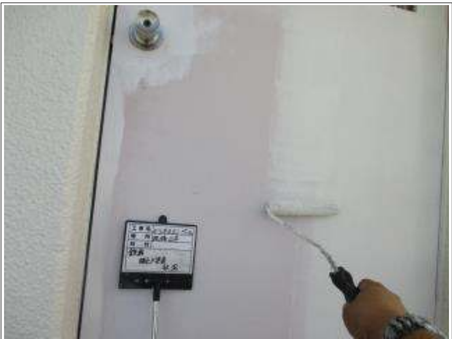
鉄扉 サビ止め塗布施工中
