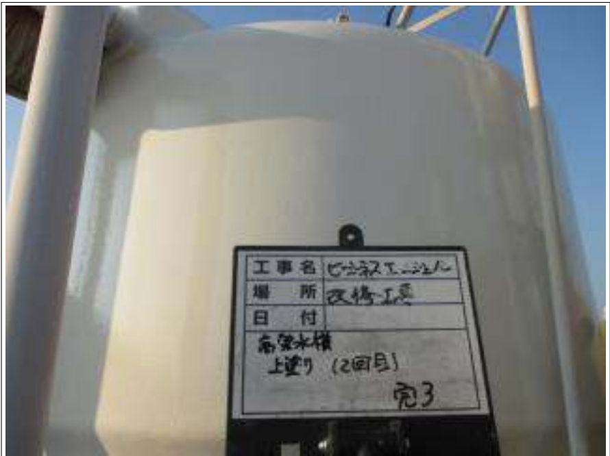
高架水槽 上塗り(2回目) 施工完了
