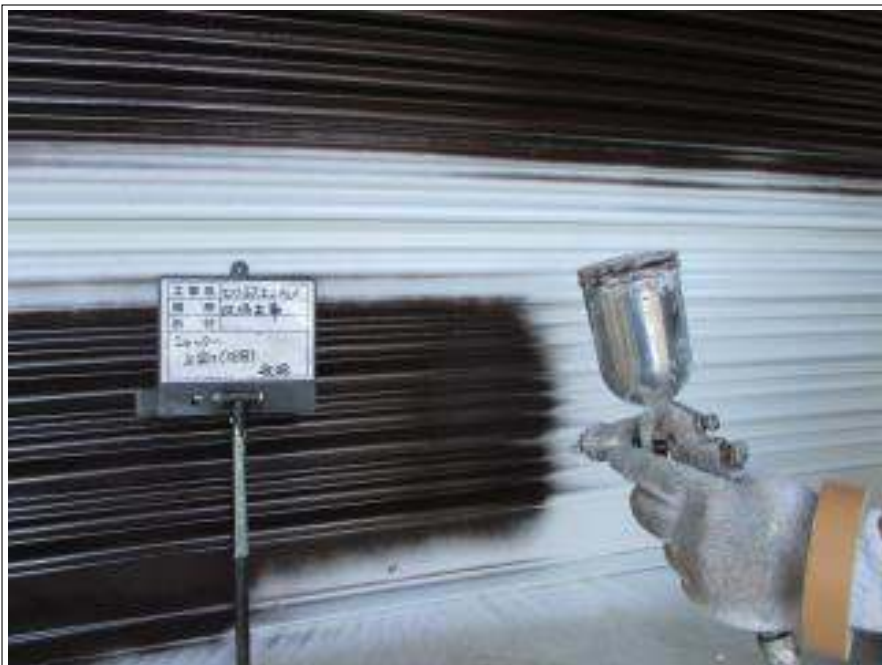
シャッター 上塗り(1回目) 施工完了
