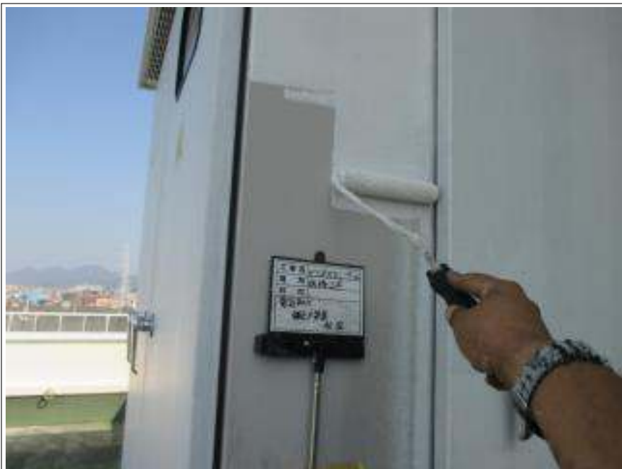
電気BOX サビ止め塗布施工中
