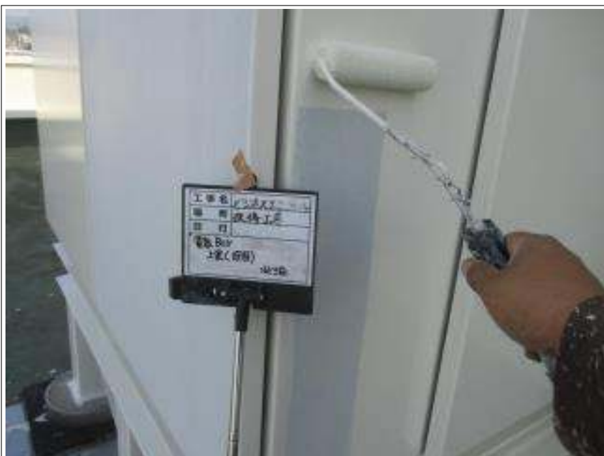
電気BOX 上塗り(1回目) 施工中
