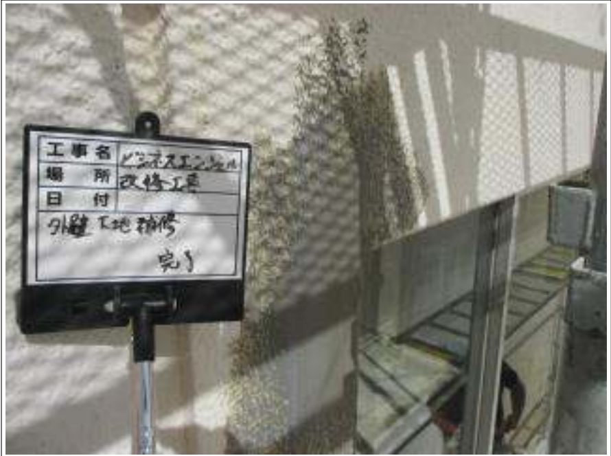
外壁 下地処理施工完了
