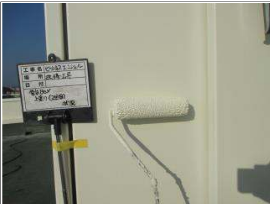
電気BOX 上塗り(2回目) 施工中
