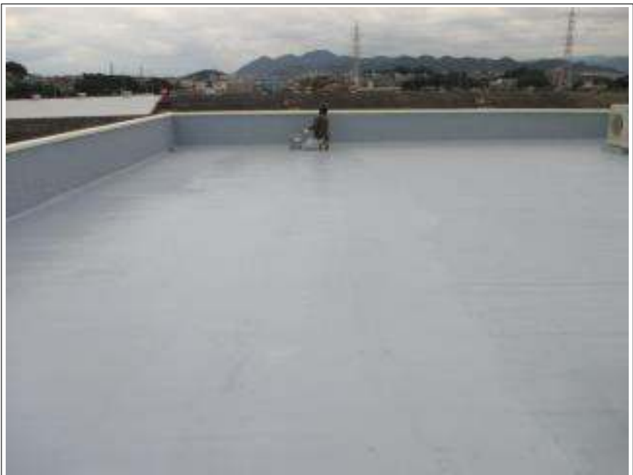
屋上内壁 上塗り施工中
