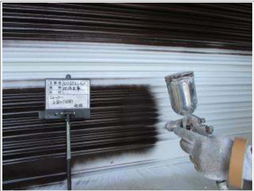
シャッター 上塗り(1回目)施工中
