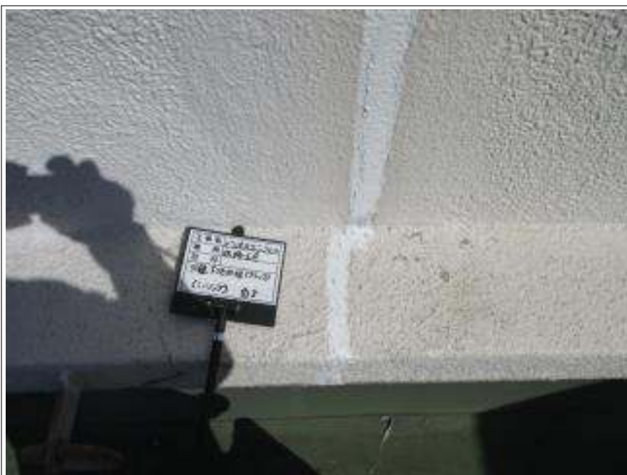
外壁 クラック補修施工完了
