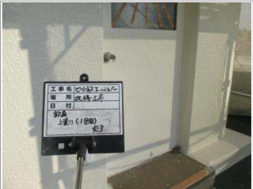
鉄扉 上塗り（1回目）施工完了
