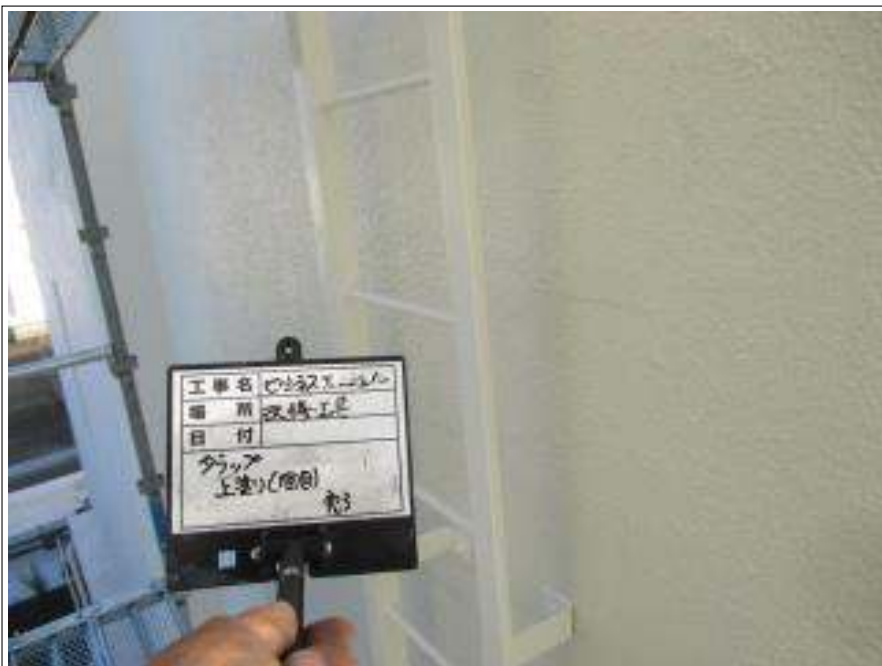
タラップ 上塗り(1回目) 施工完了
