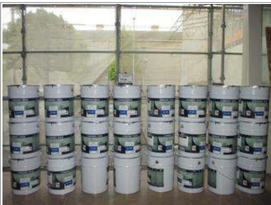
屋上 上塗り使用材料
