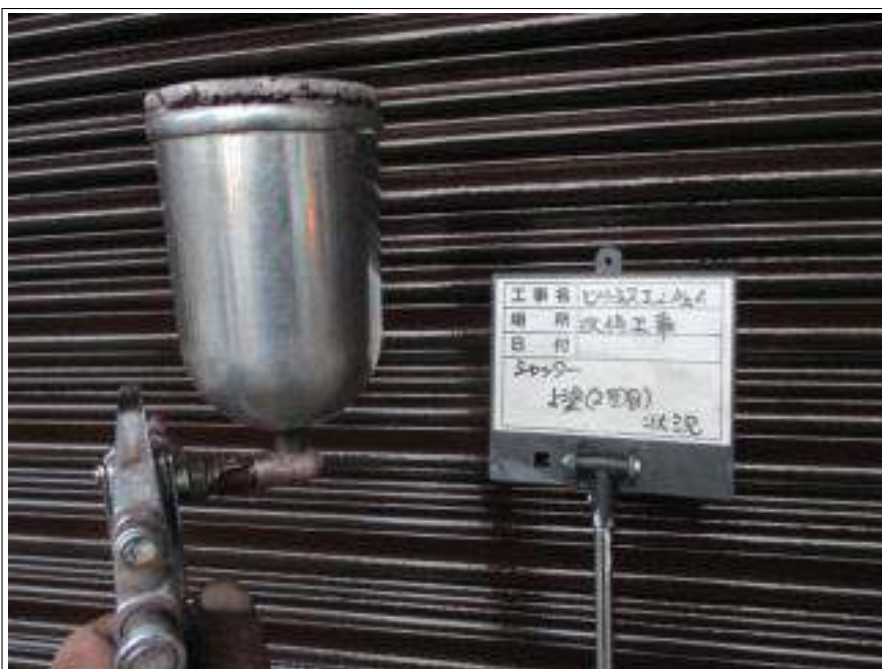
シャッター 上塗り(2回目) 施工中
