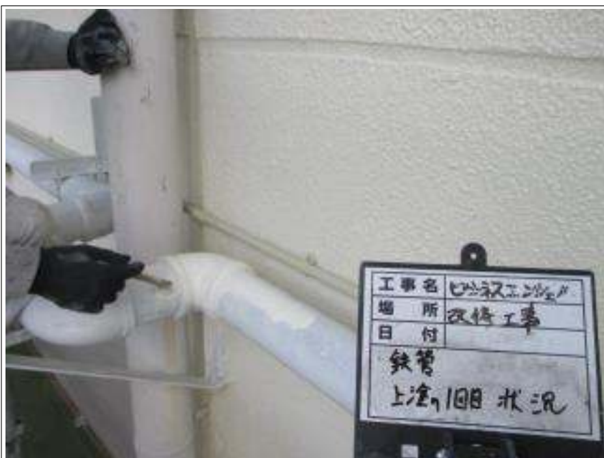
鉄管 上塗り（1回目）施工中
