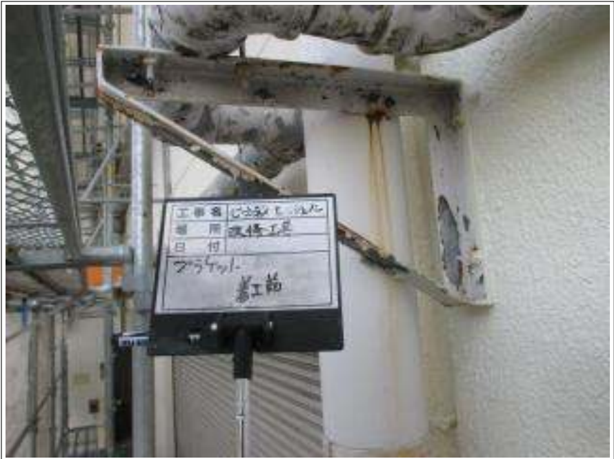
ブラケット 施工前
