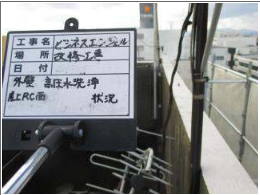
外壁 高圧洗浄中
