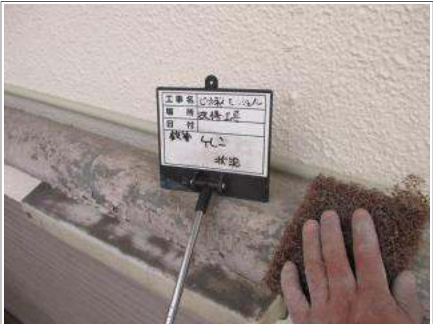
鉄管 ケレン処理施工中
