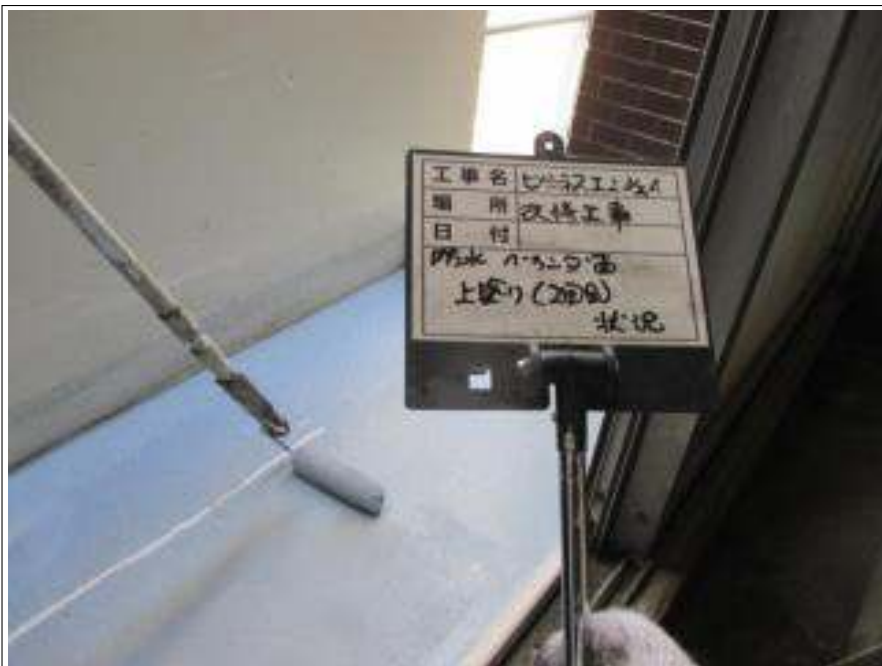
ベランダ 上塗り(2回目) 施工中
