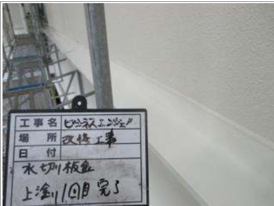
水切り板金 上塗り(1回目)施工完了
