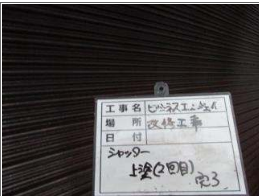
シャッター 上塗り(2回目) 施工完了
