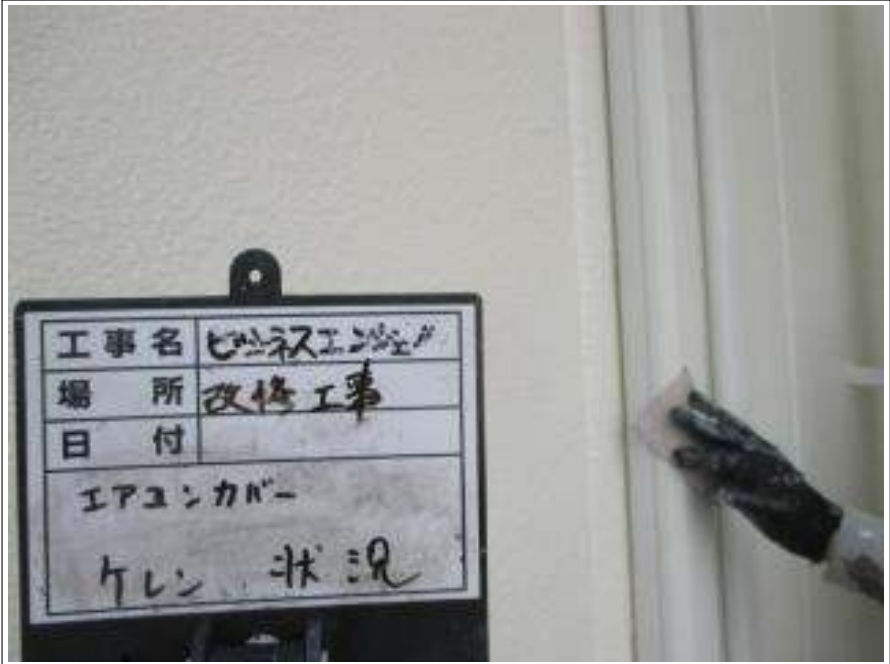
エアコンカバー ケレン処理施工中
