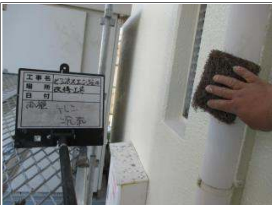
樋 ケレン処理施工中
