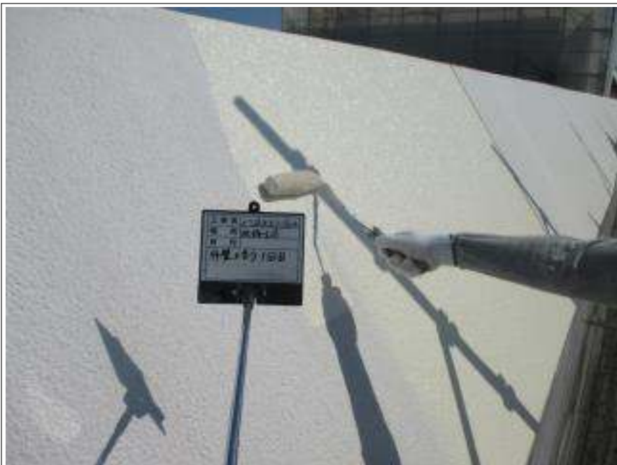
外壁 上塗り（1回目）施工中
