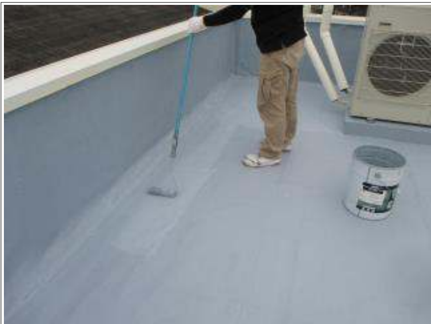
屋上 上塗り施工中
