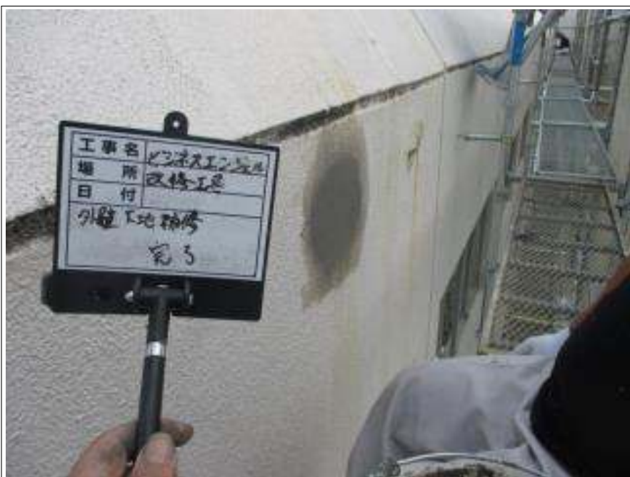
外壁 下地処理施工完了
