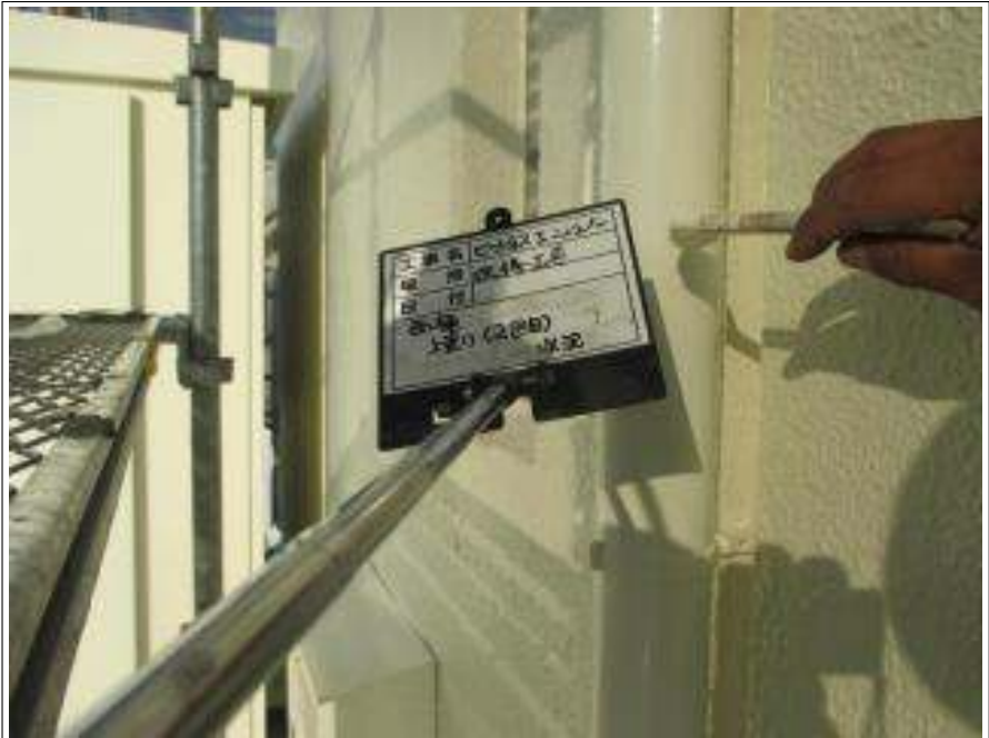
樋 上塗り（2回目）施工中
