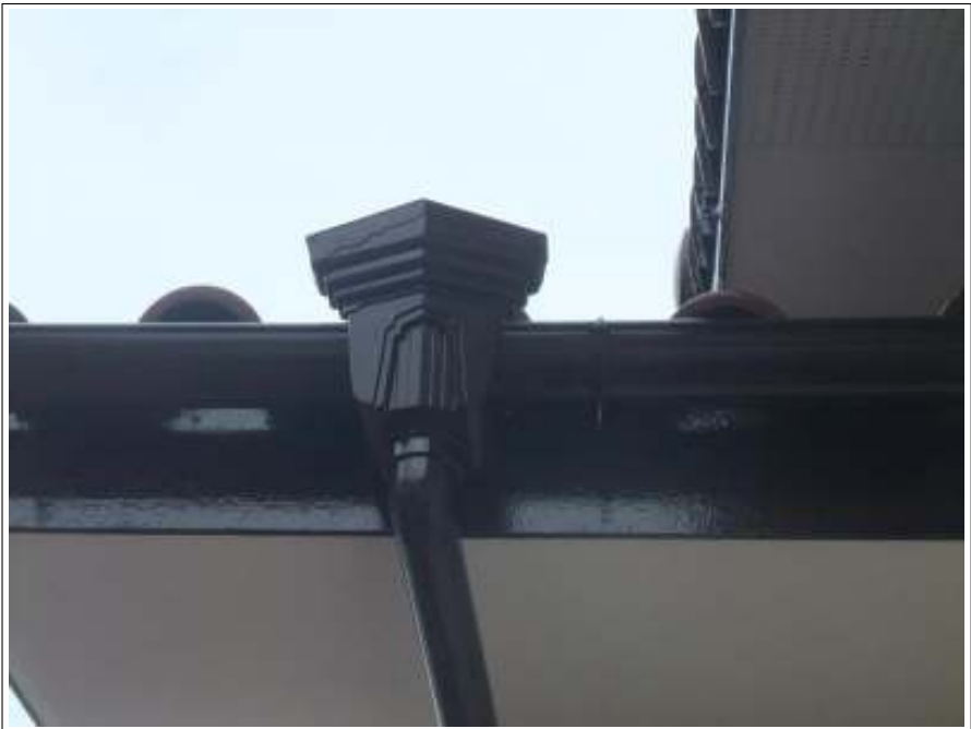
雨樋 施工完了
