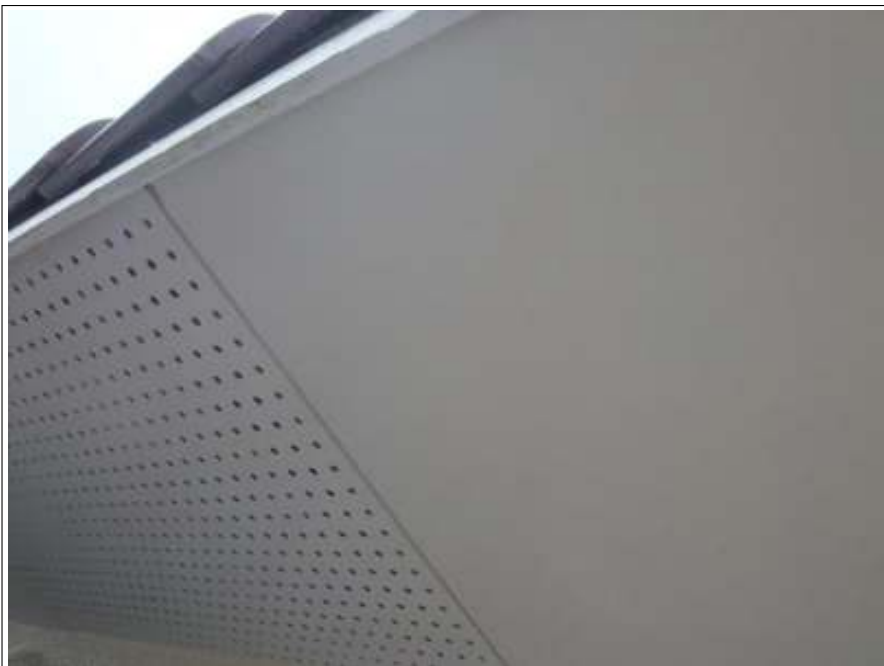
軒天 施工完了
