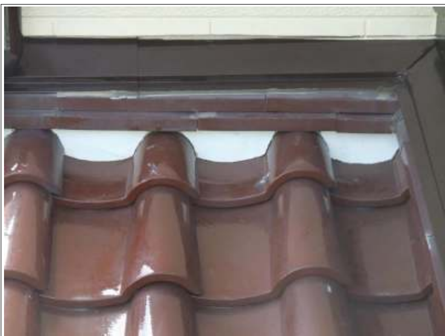
しっくい補修 施工完了
