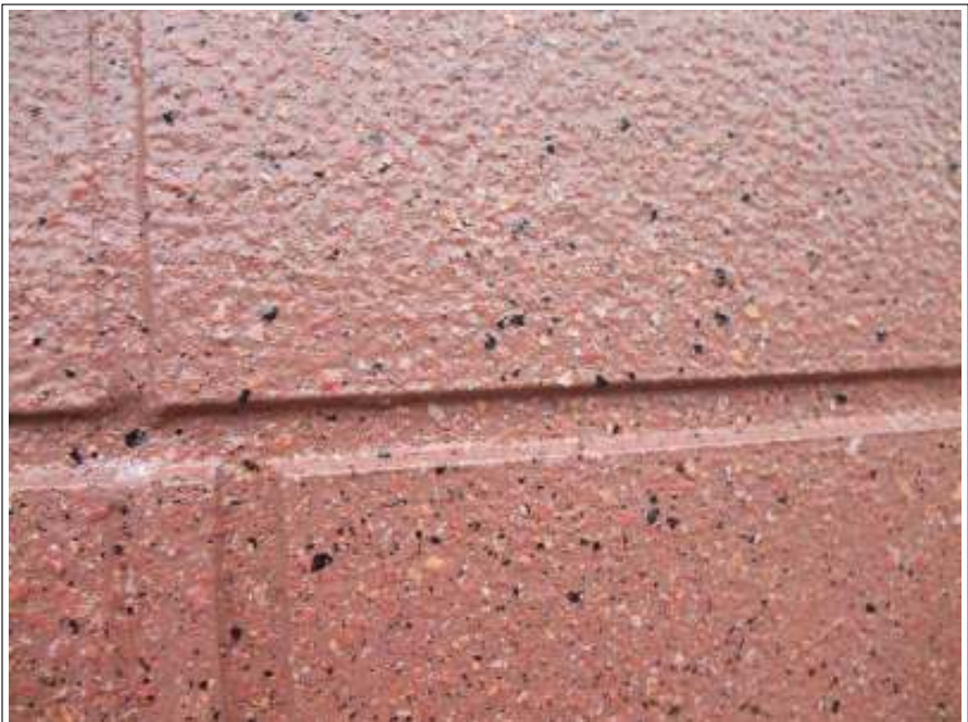
外壁（1F）上塗り施工完了
