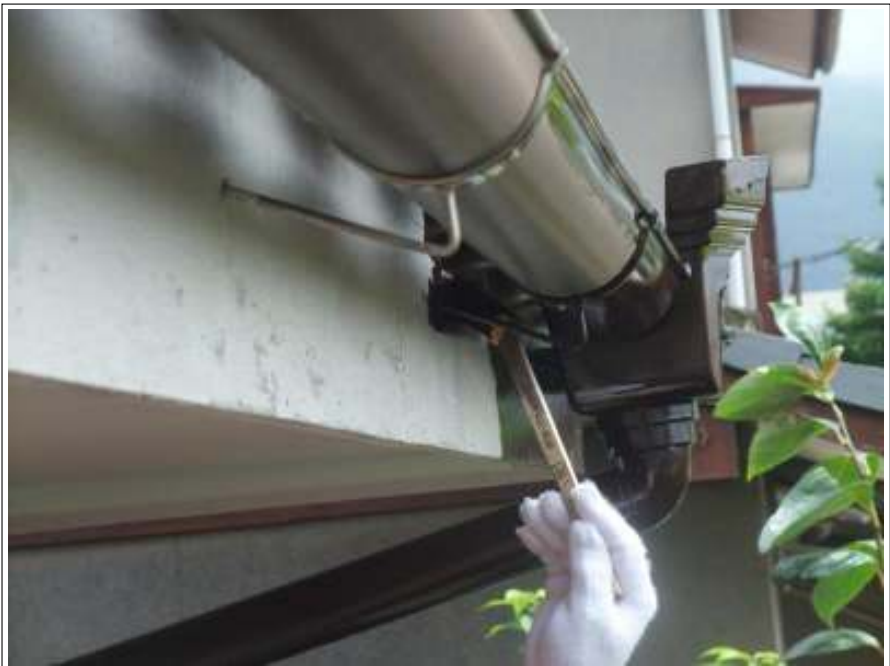
破風板 施工中
