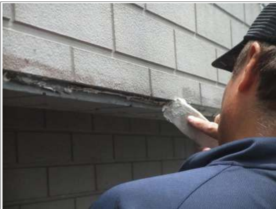
外壁 シーリング打ち替え施工中
