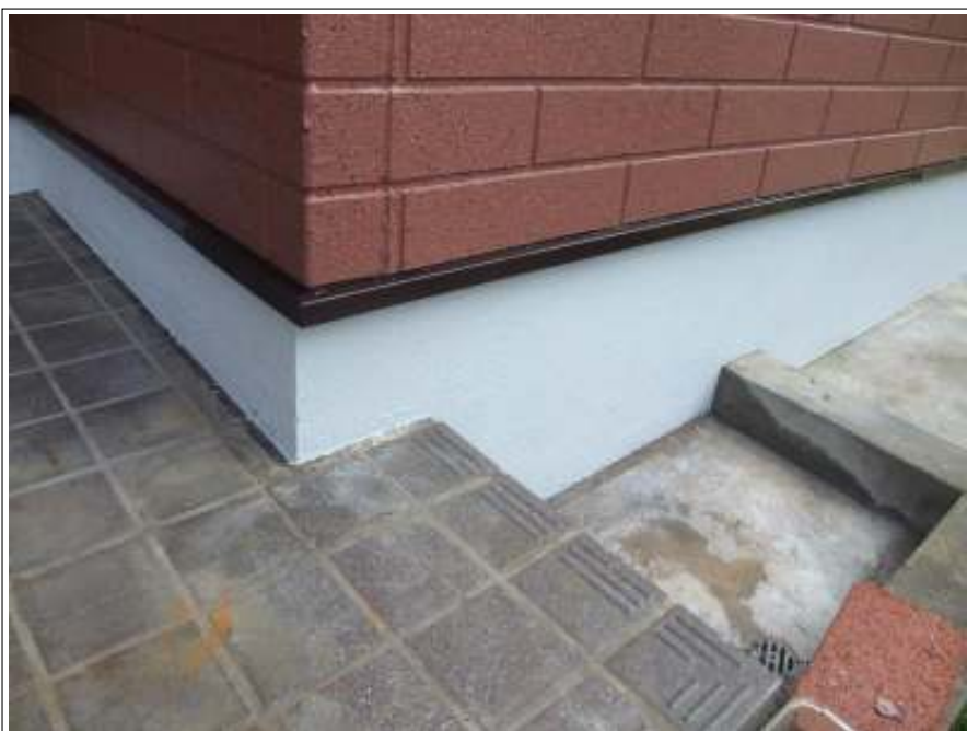
基礎 施工完了
