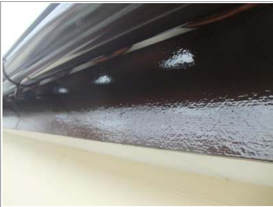
破風板 施工完了
