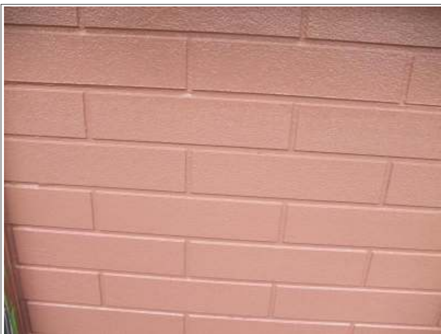
外壁（1F） 中塗り施工完了
