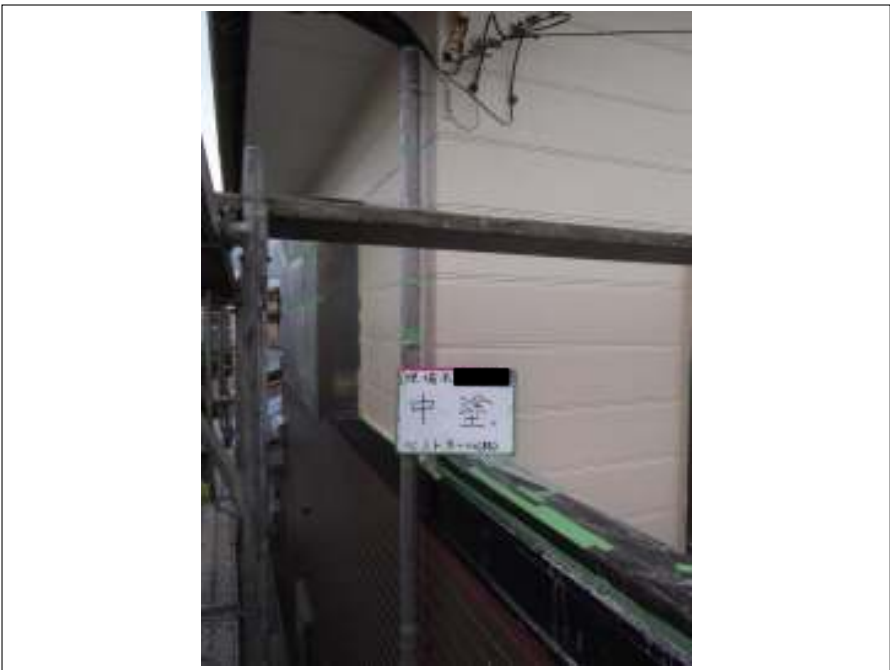
外壁（2F）中塗り施工後
