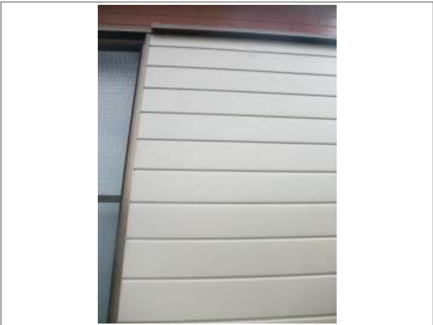
雨戸 施工完了
