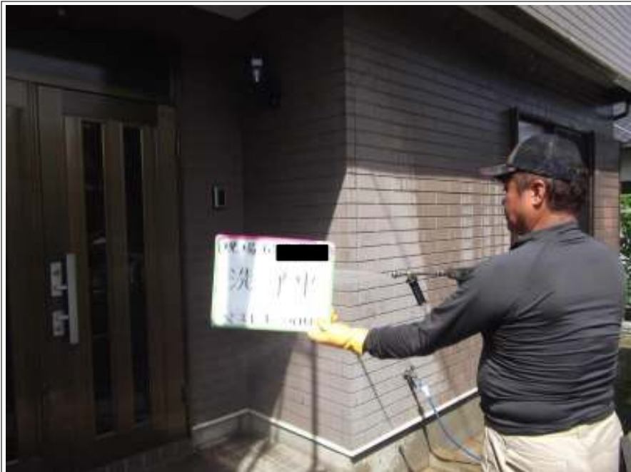
外壁 高圧洗浄中
