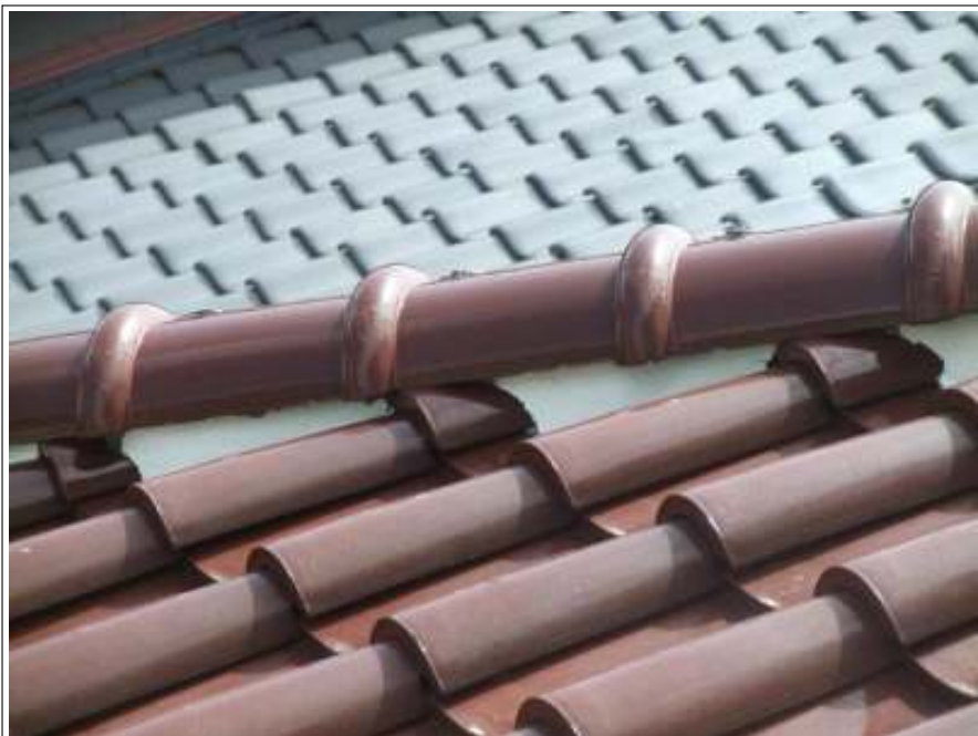
しっくい補修 施工完了
