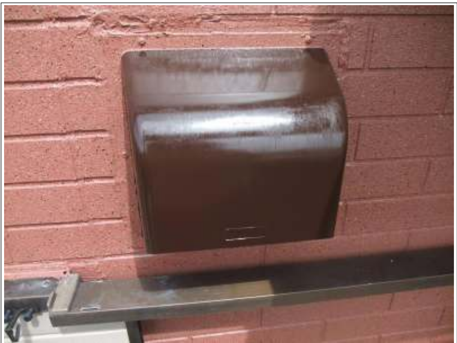
換気フード 施工完了
