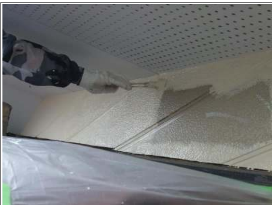
外壁（2F） 中塗り施工後
