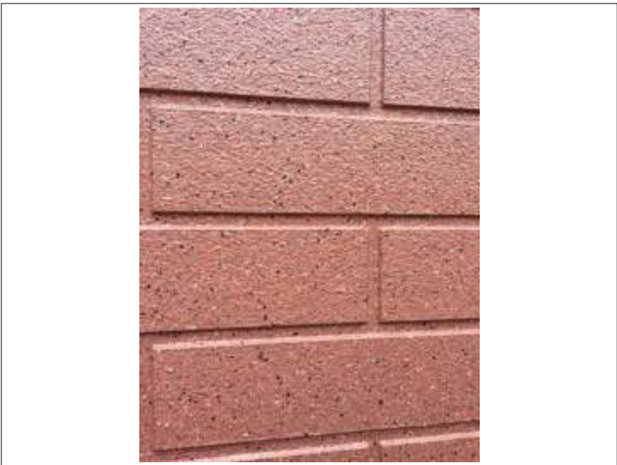
外壁（1F）上塗り施工完了
