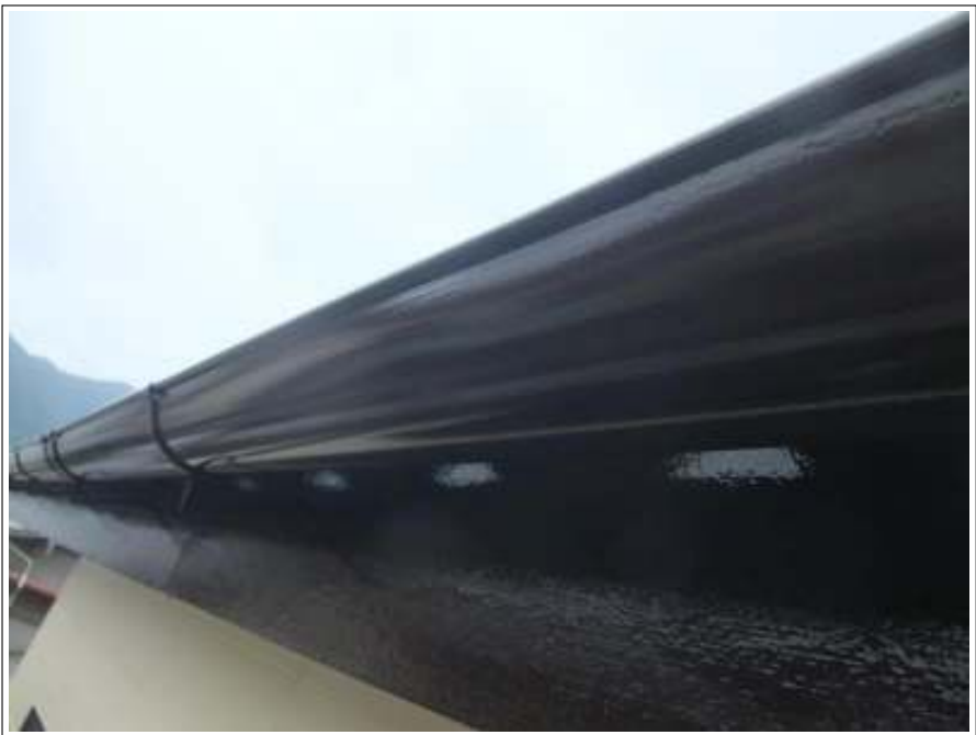
雨樋 施工完了
