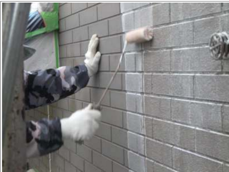
外壁 下塗り施工中
