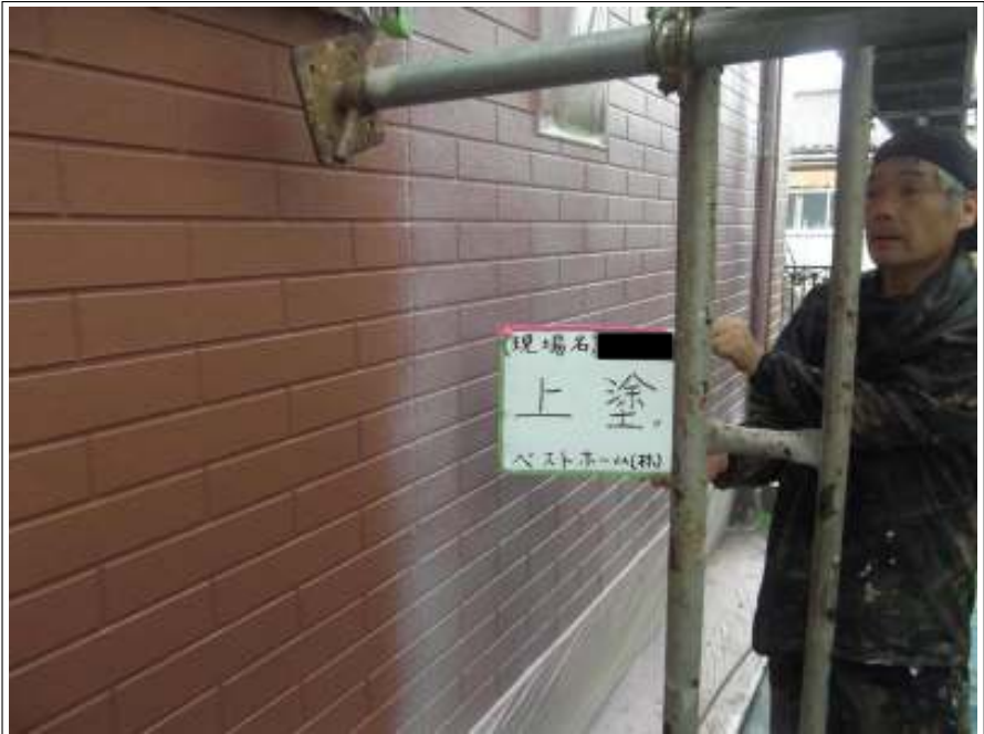
外壁（1F）上塗り施工中
