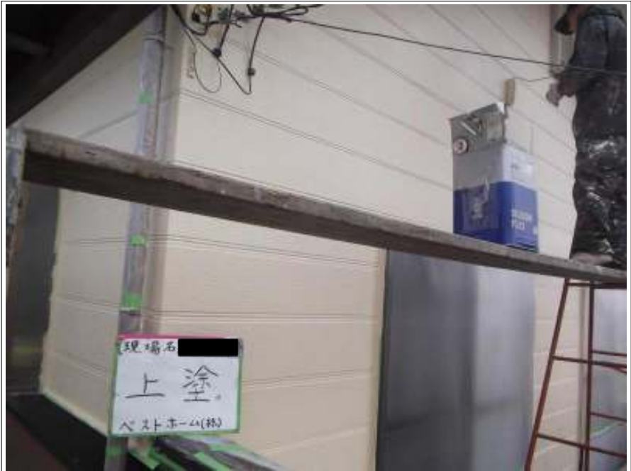
外壁（2F）上塗り施工中
