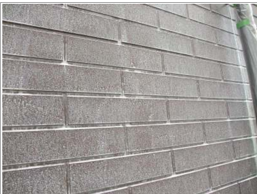
外壁 下塗り施工完了
