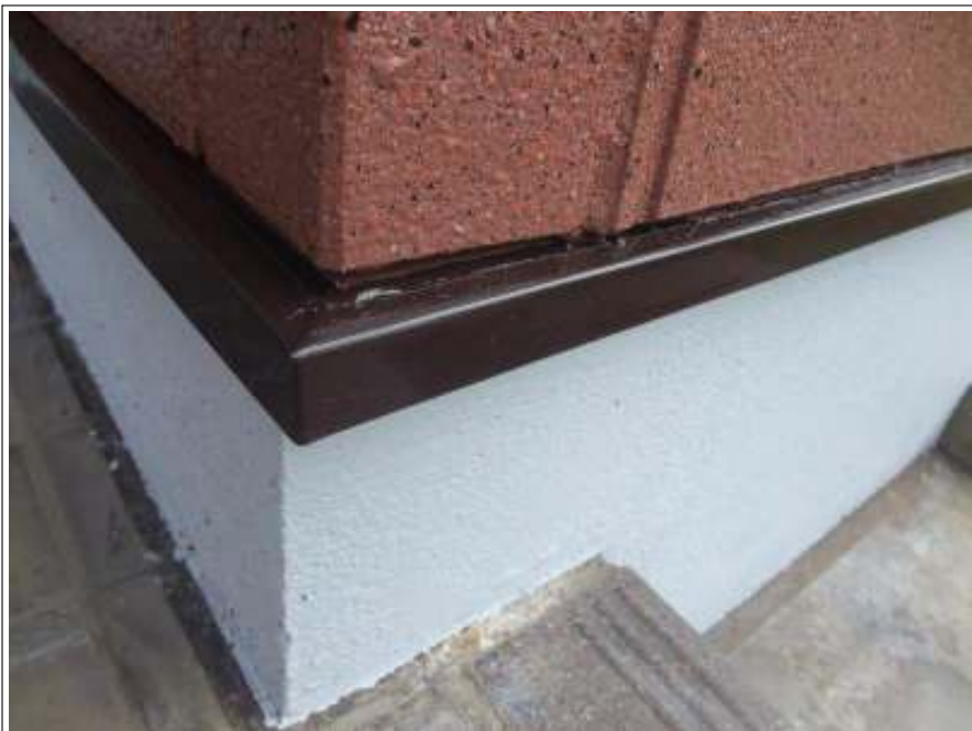
水切り 施工完了
