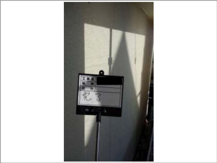
外壁 施工完了
