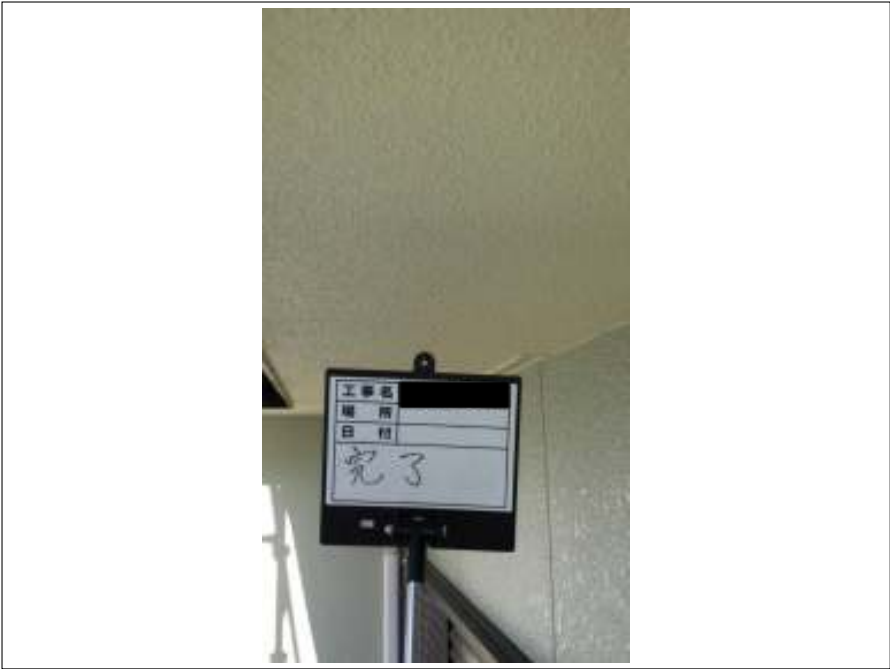
軒天 施工完了
