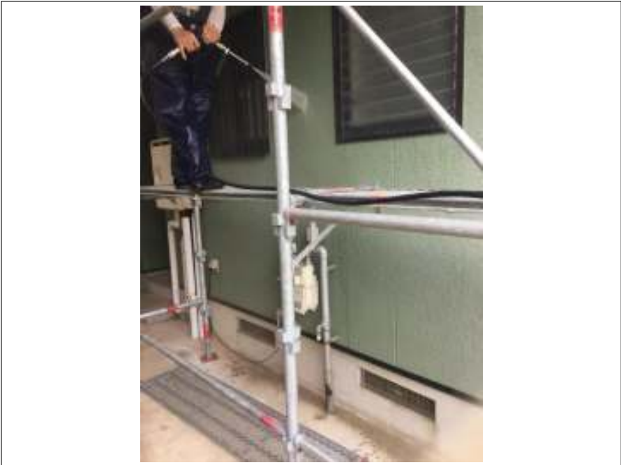
外壁 高圧洗浄中
