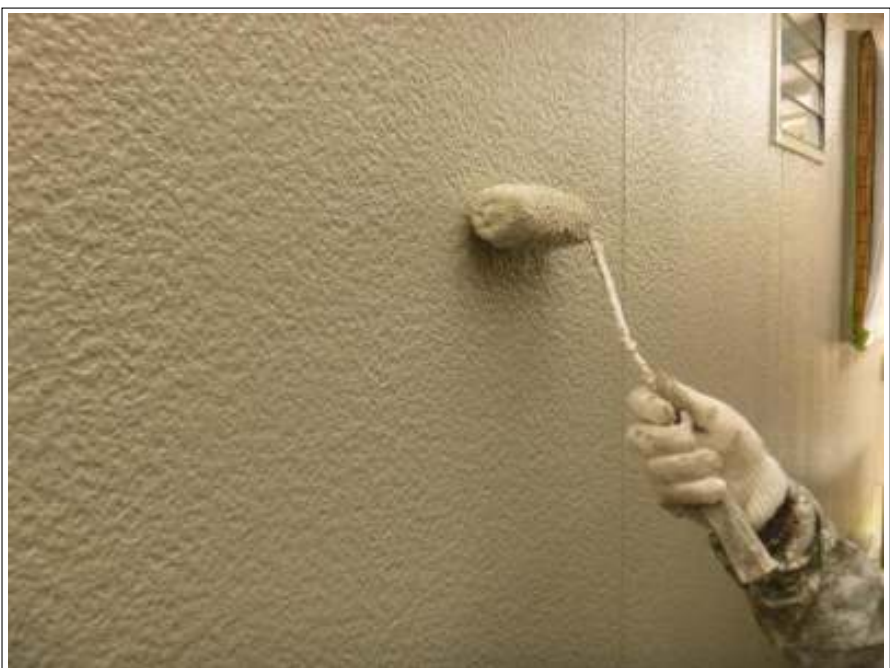
外壁上塗り(2回目) 施工中
