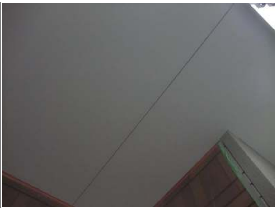
軒天塗装施工完了
