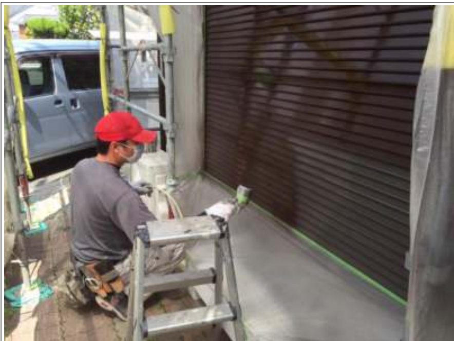
シャッター塗装施工中
