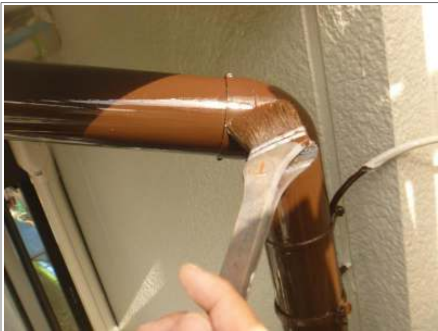
雨樋塗装 上塗り(2回目) 施工中
