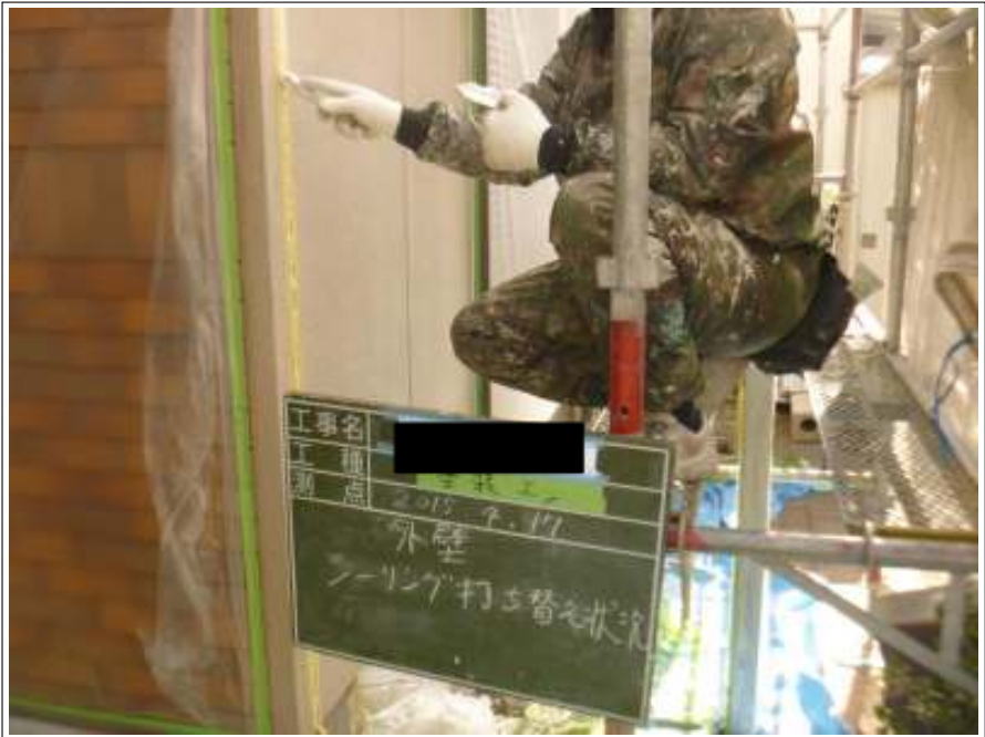
外壁シーリング打ち替え施工中
