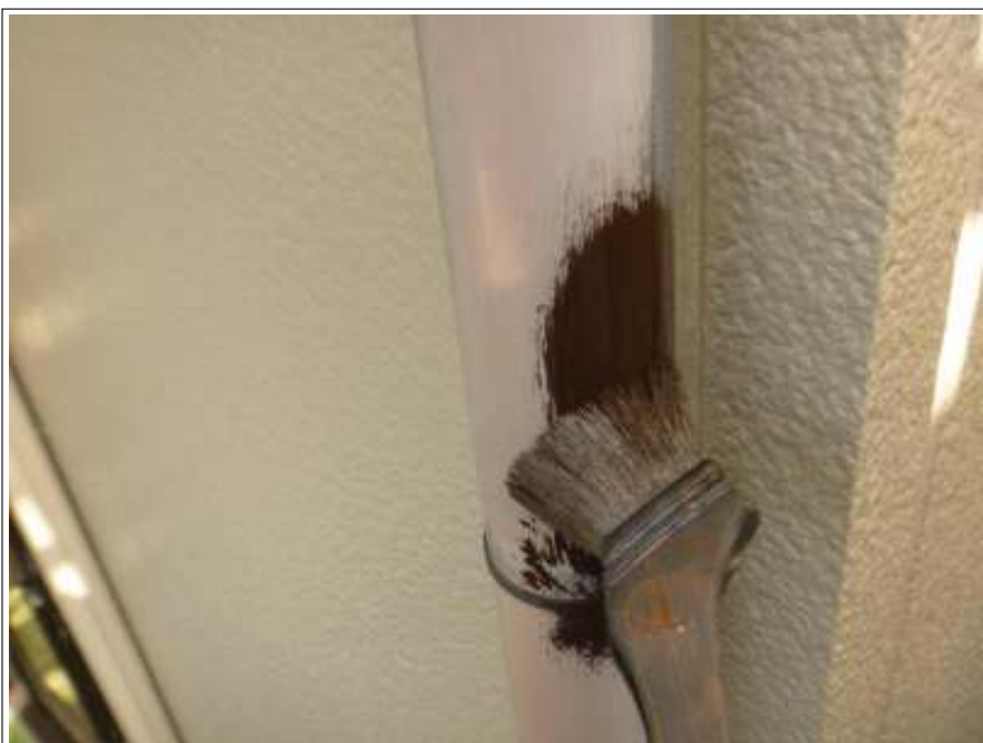
雨樋塗装 上塗り(1回目) 施工中
