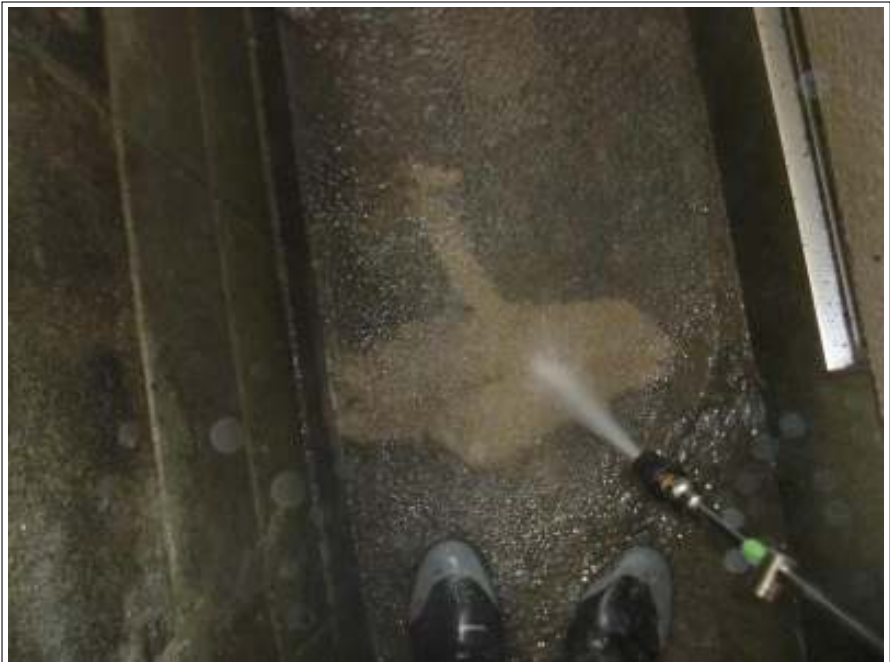
土間高圧洗浄施工中
