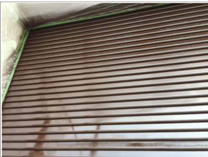
シャッター塗装施工完了
