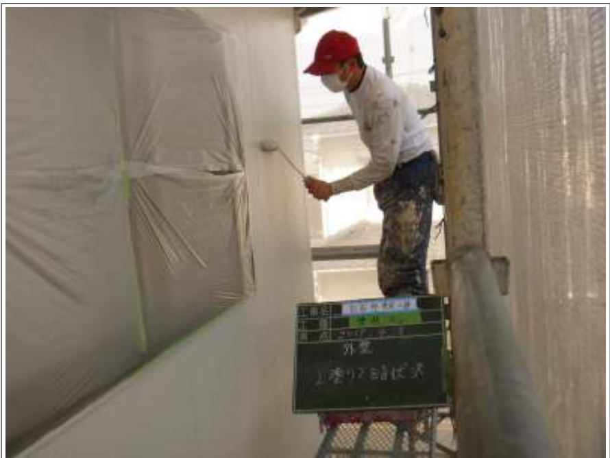
外壁上塗り(2回目) 施工中
