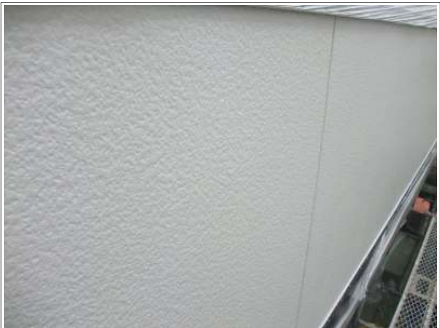
外壁上塗り施工完了
