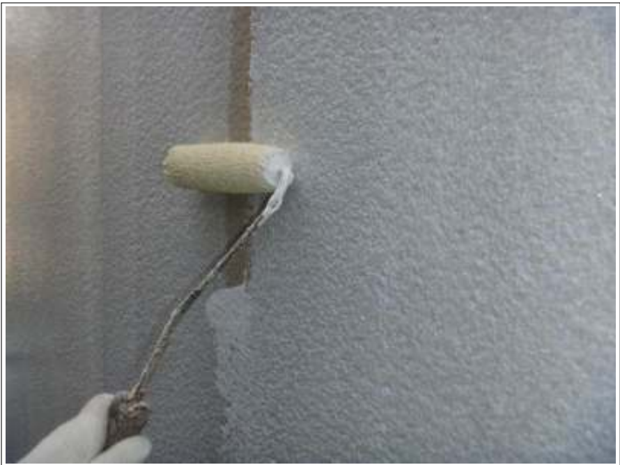
外壁下塗り施工中
