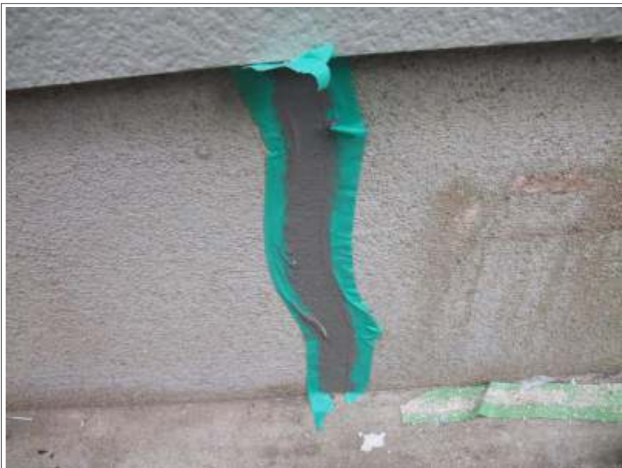
基礎クラック補修施工中
