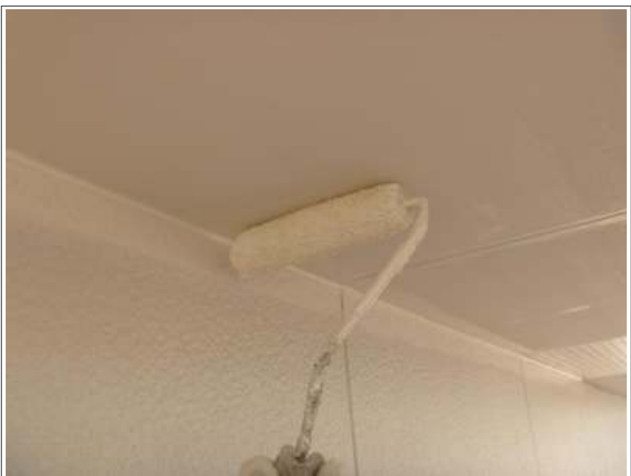
軒天塗装上塗り(2回目) 施工中
