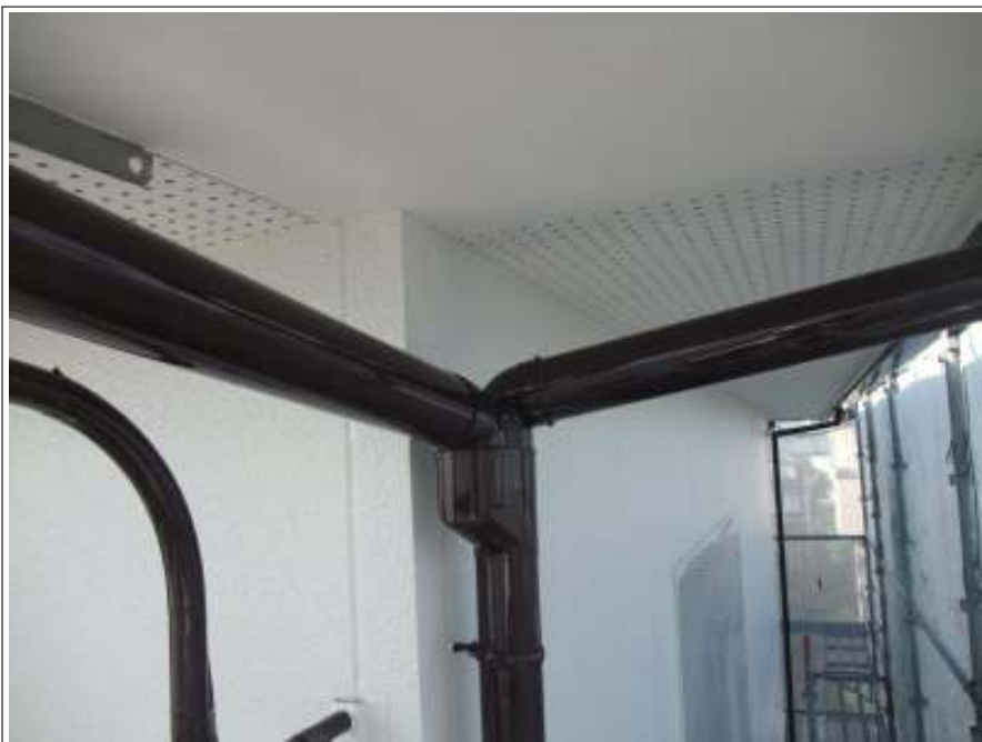
雨樋塗装 上塗り完了
