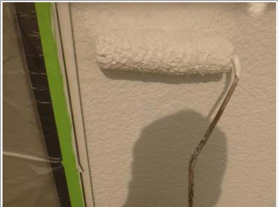
外壁上塗り(1回目) 施工中
