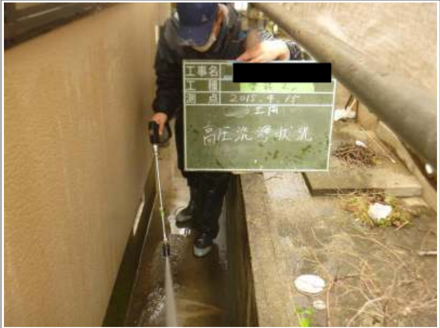
土間高圧洗浄施工中
