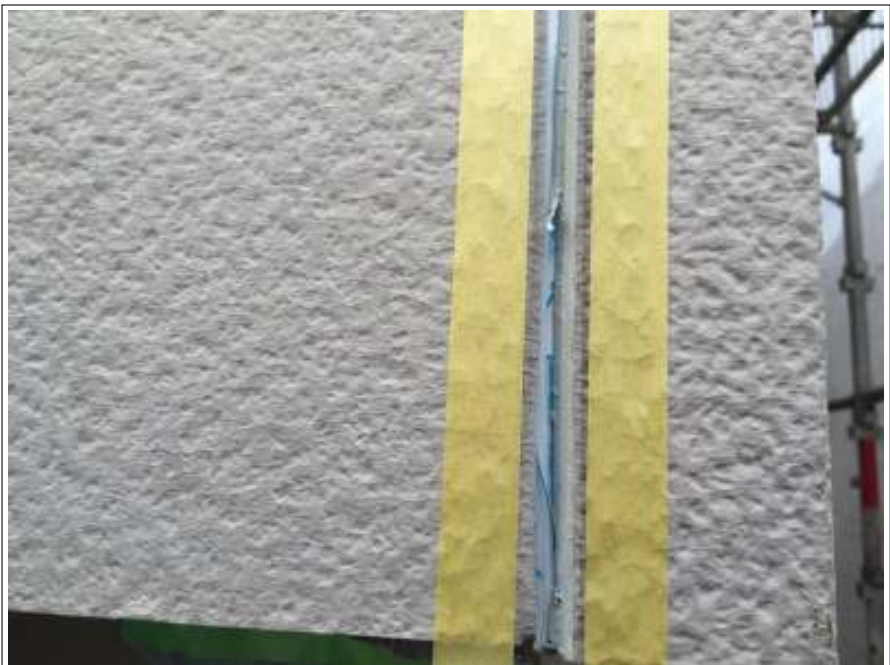
外壁シーリング撤去完了
