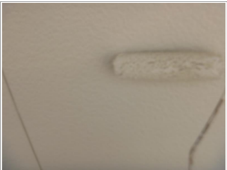
外壁上塗り(2回目) 施工中
