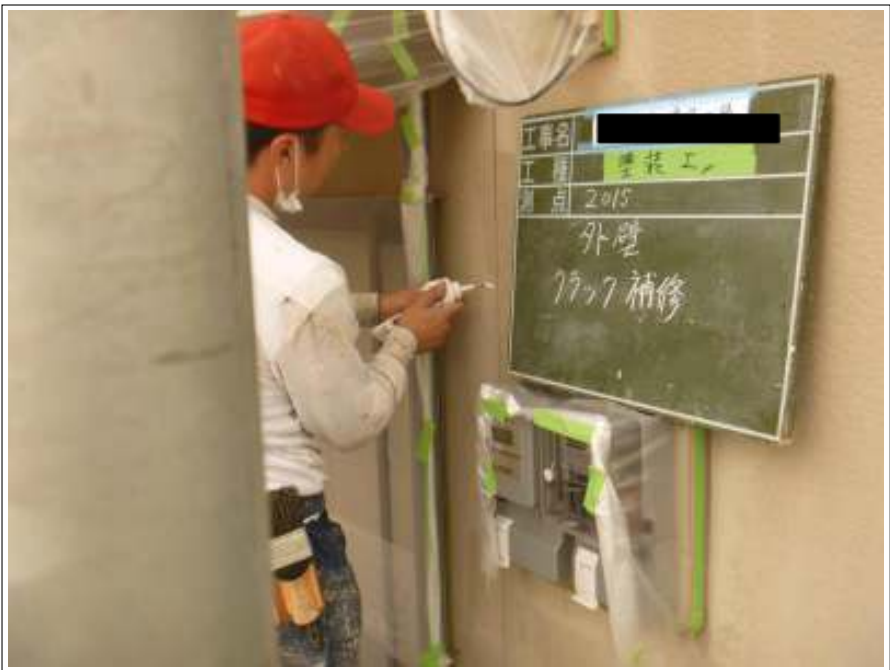
外壁クラック補修施工中
