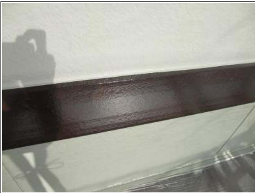
帯塗装施工完了
