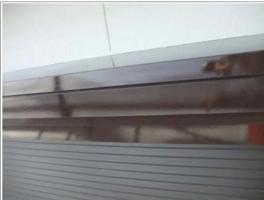
シャッターBOX 施工完了
