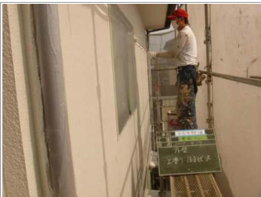
外壁上塗り(1回目) 施工中
