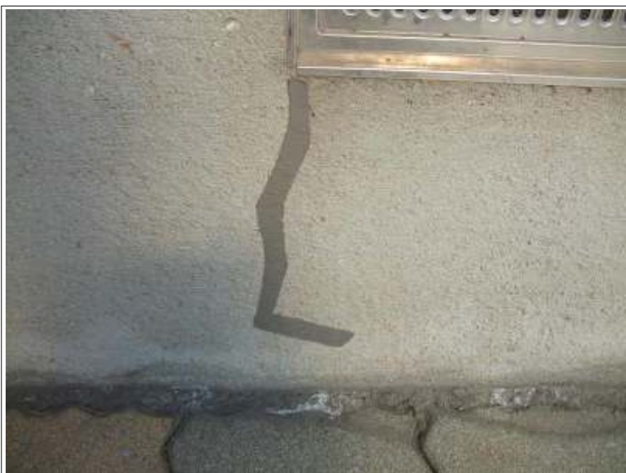
基礎クラック補修施工完了
