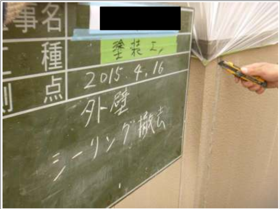
外壁シーリング撤去施工中
