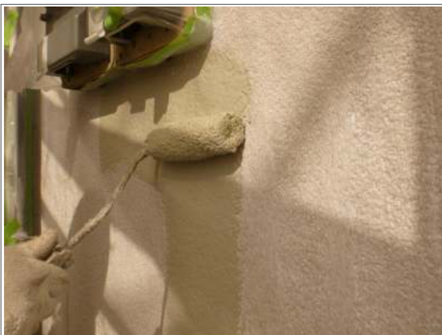
外壁中塗り施工中
