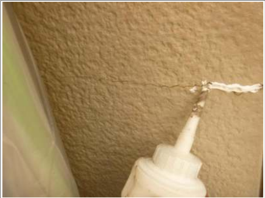
外壁クラック補修施工中
