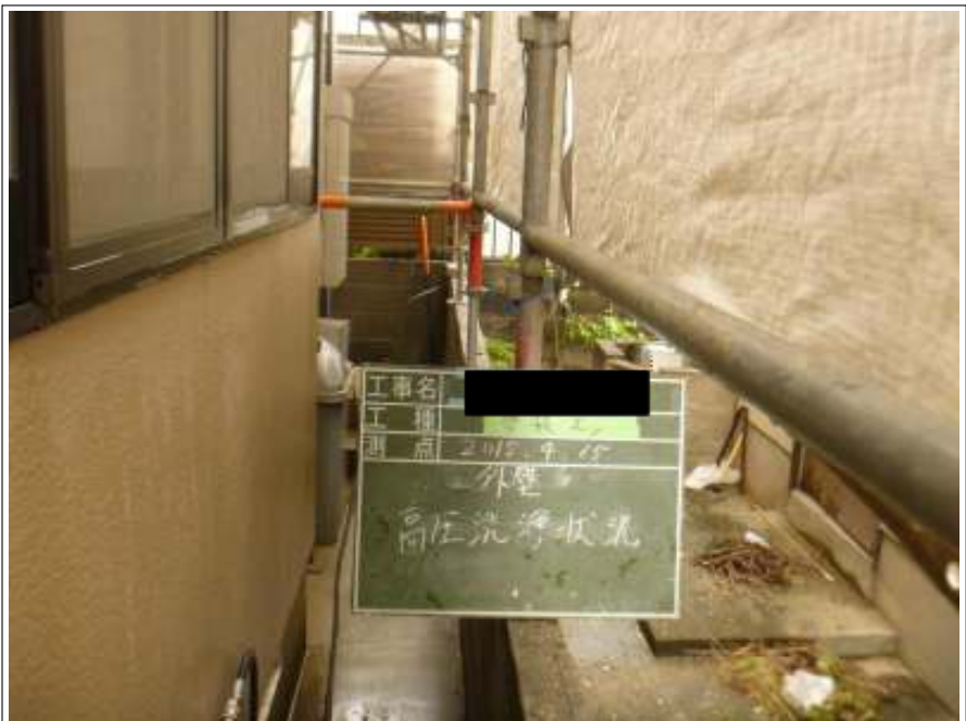
外壁高圧洗浄施工中
