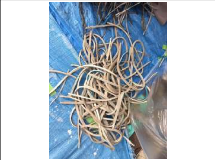
外壁シーリング撤去後
