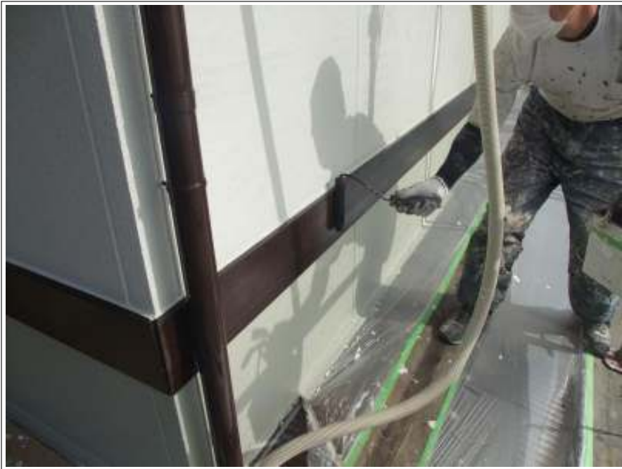
帯塗装施工中
