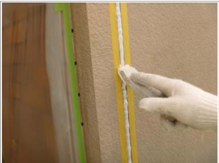
外壁シーリング打ち替え施工中
