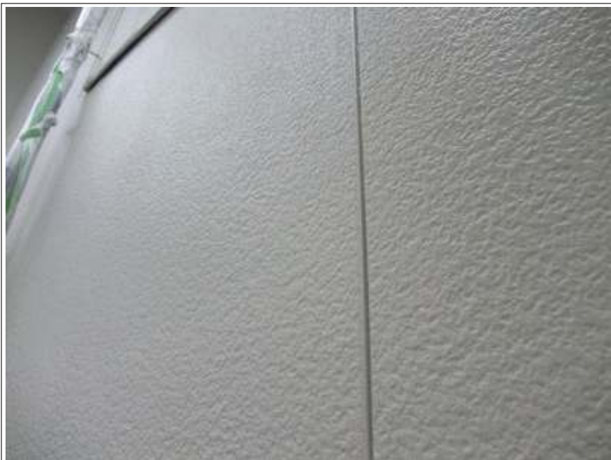
外壁上塗り施工完了
