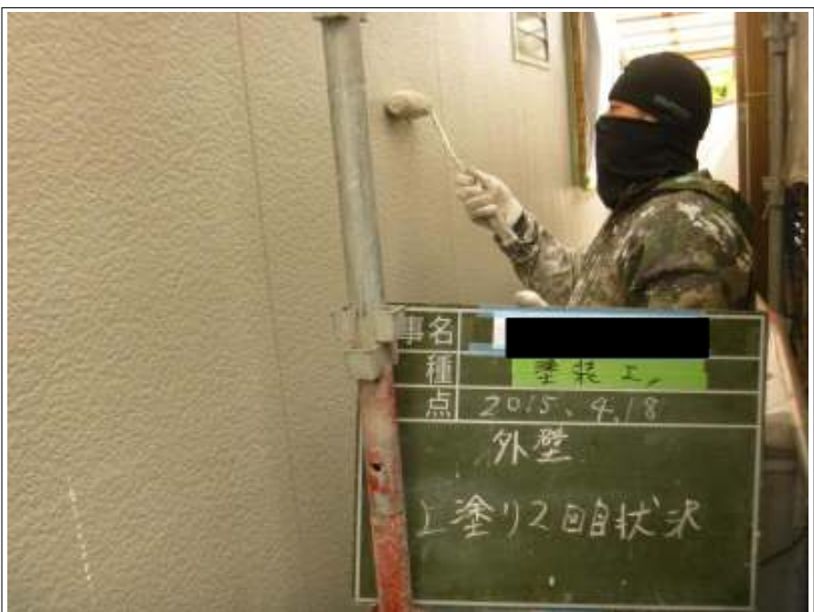
外壁上塗り(2回目) 施工中
