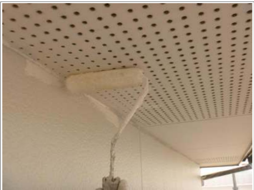
軒天塗装上塗り(1回目)施工中
