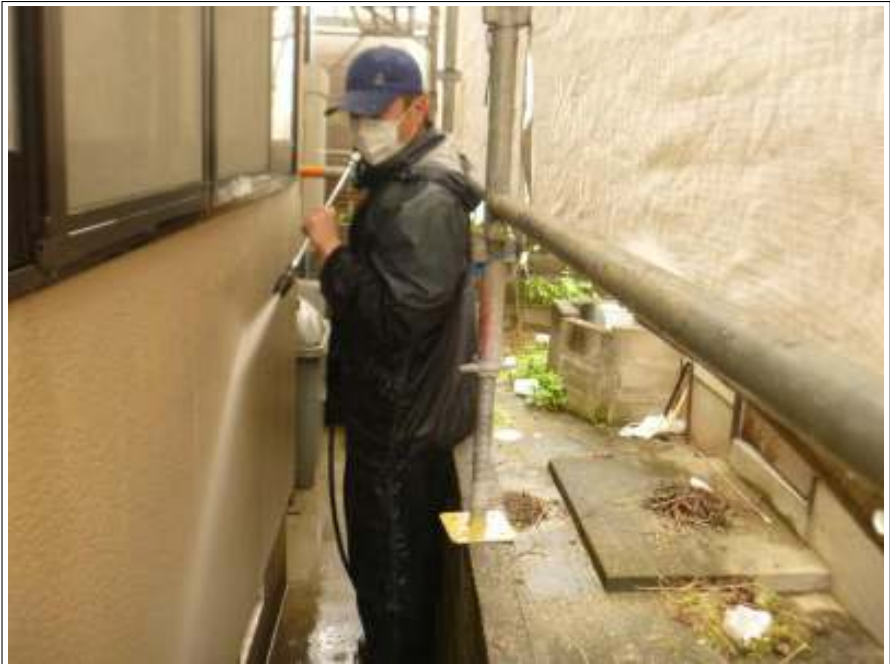
外壁高圧洗浄施工中
