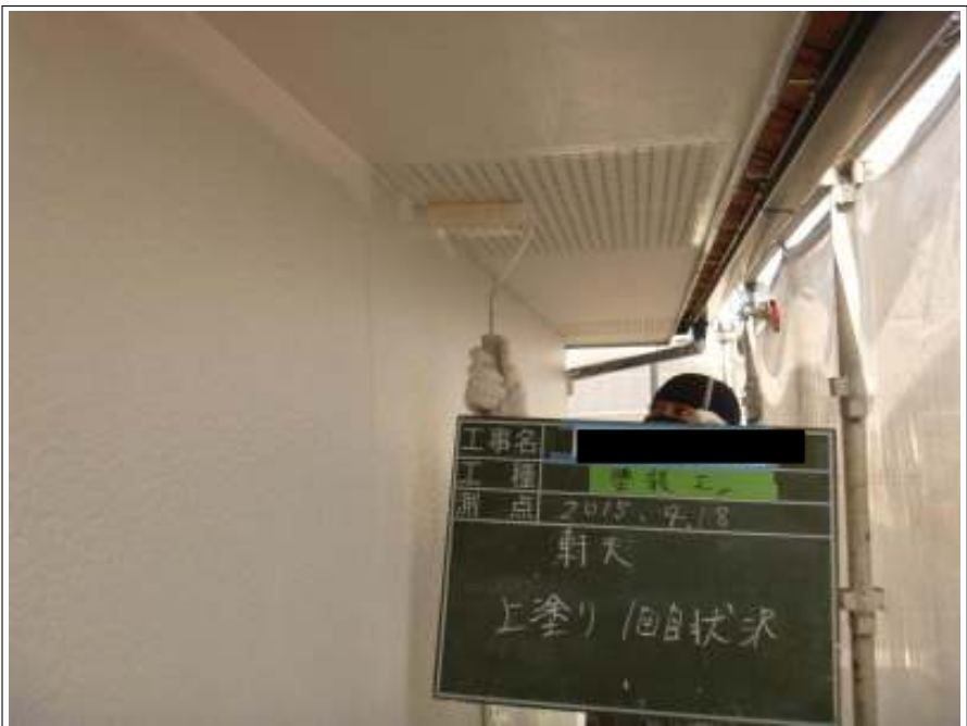
軒天塗装上塗り(1回目)施工中
