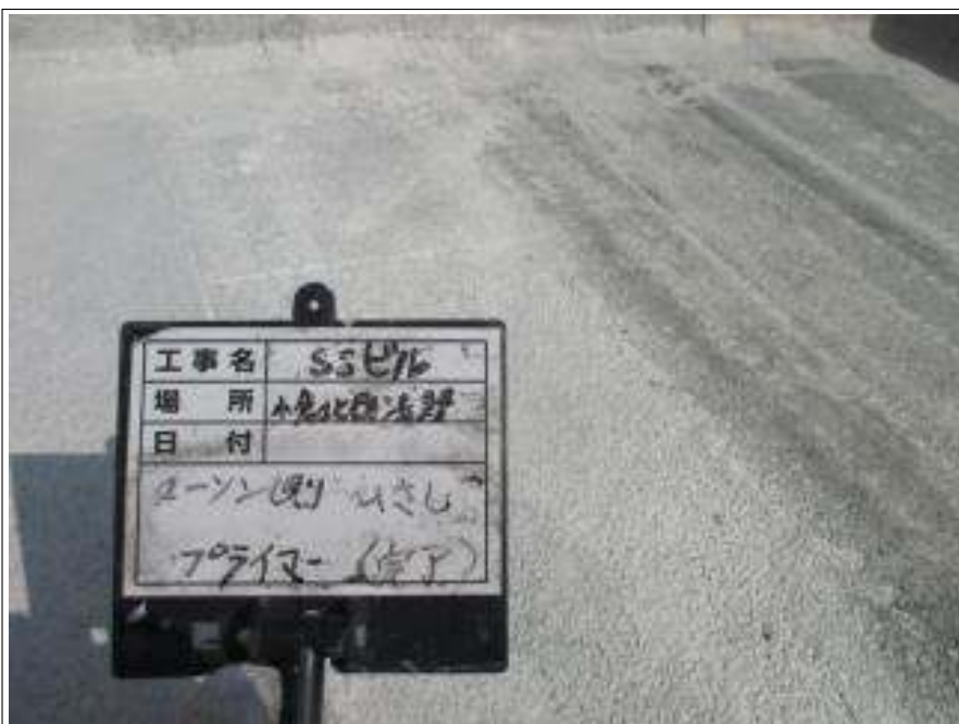
防水部 下塗り施工後
