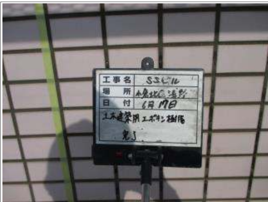
タイル部 エポキシ樹脂注入 施工後
