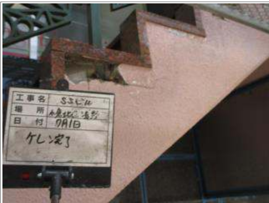
ケレン処理施工後
