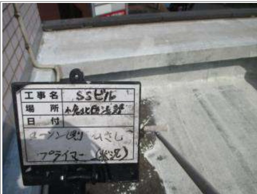
防水部 下塗り施工中
