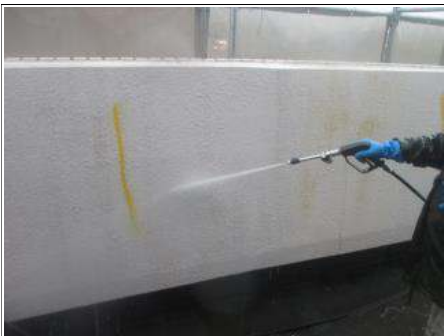
外壁 高压洗浄中
