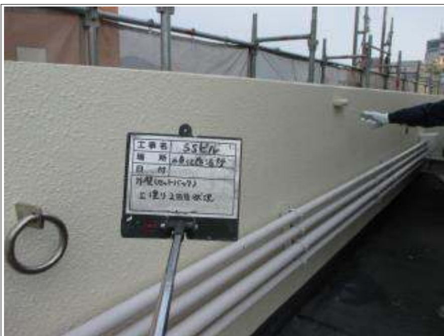
外壁 上塗り施工中
