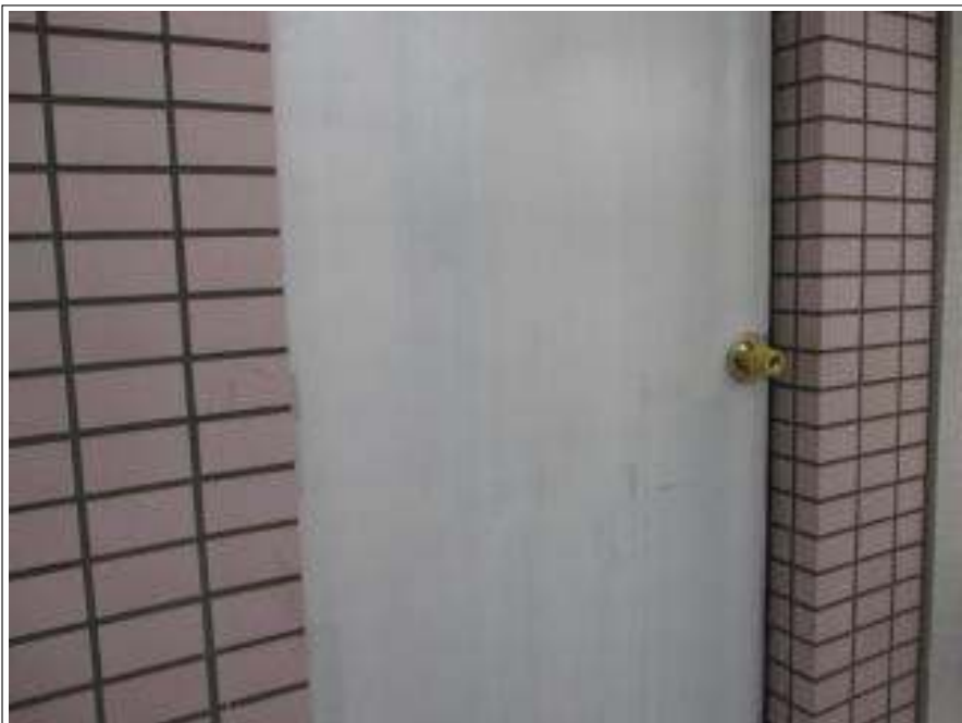
鉄扉 サビ止め塗布施工後
