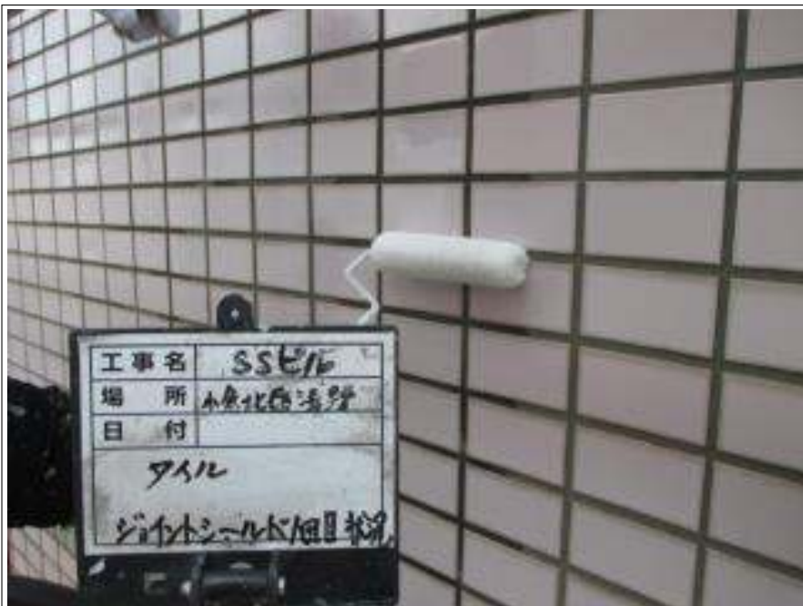
タイル部 上塗り(1回目) 施工中
