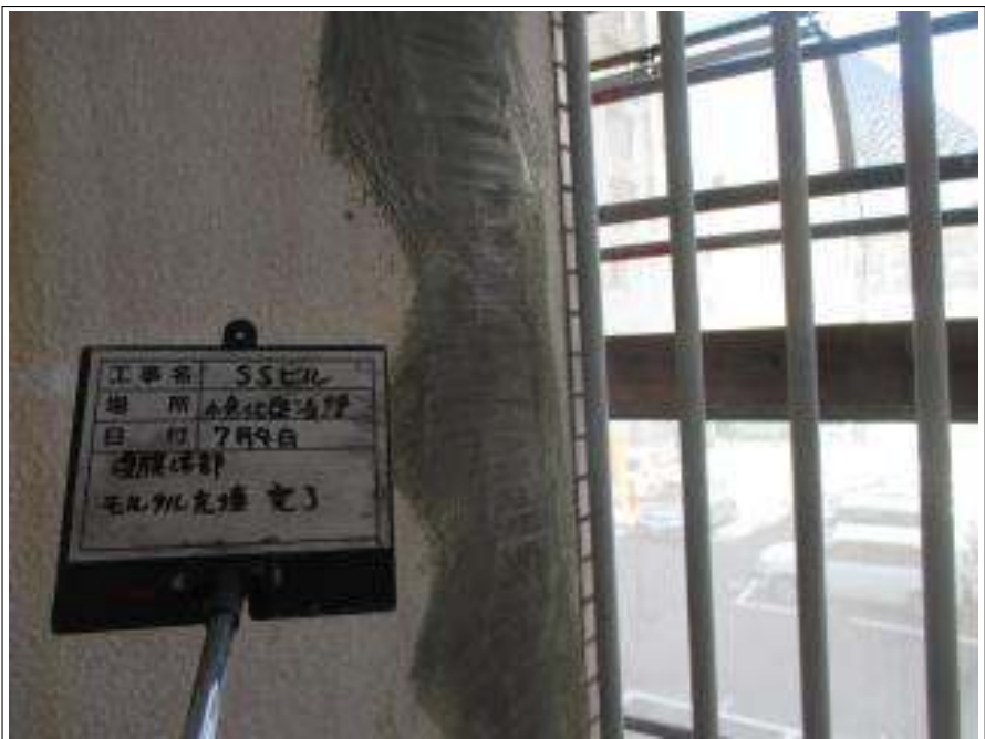
外壁 モルタル充填 施工後
