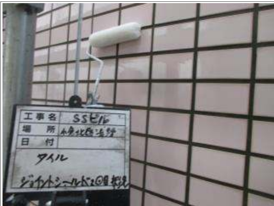
タイル部 上塗り(2回目) 施工中
