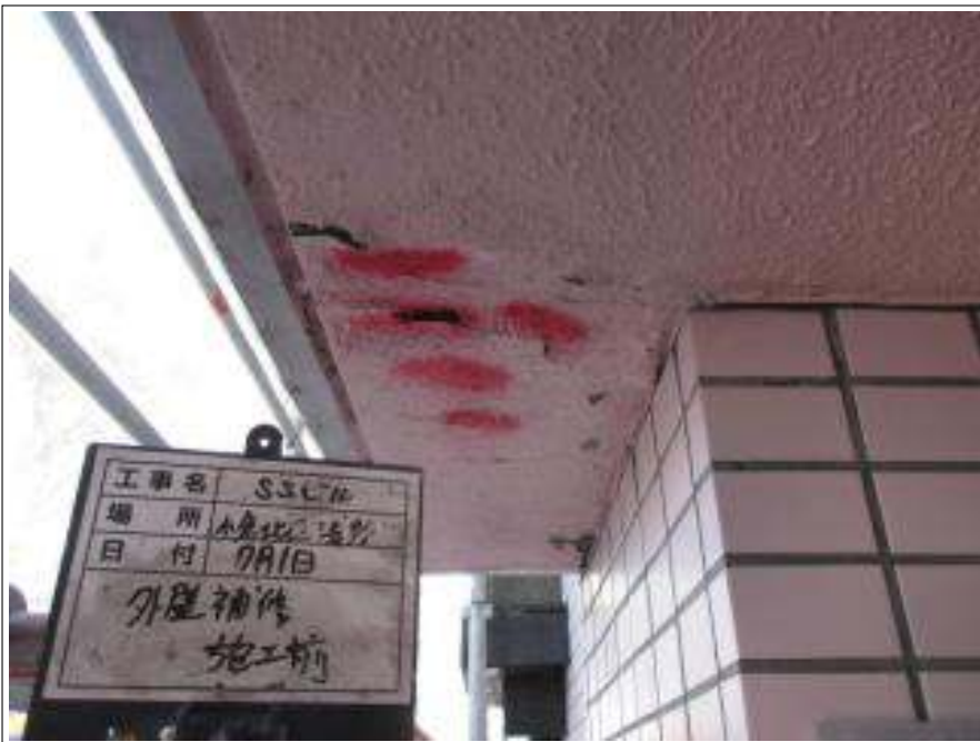
外壁補修 施工前
