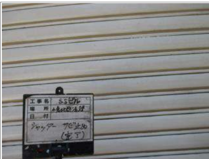
シャッター 錆止め塗布施工後
