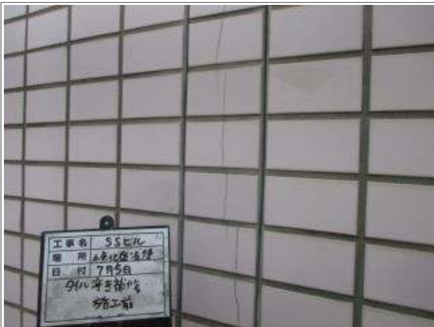
タイル部補修 施工前
