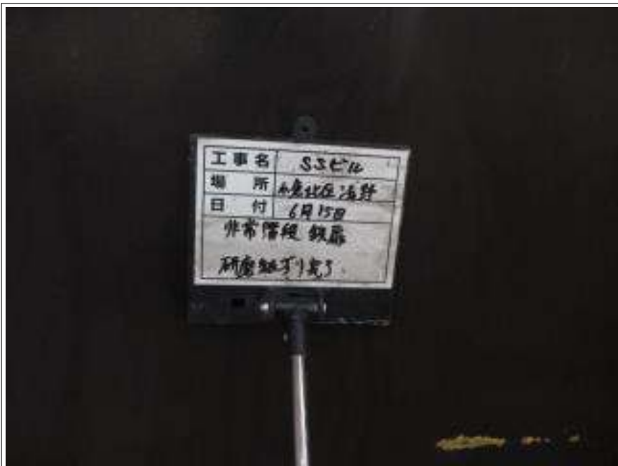
鉄扉 研磨紙ずり施工後
