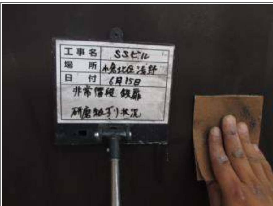
鉄扉 研磨紙ずり施工中
