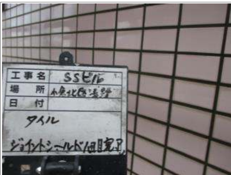
タイル部 上塗り(1回目) 施工後
