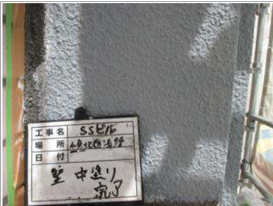
外壁 中塗り施工後
