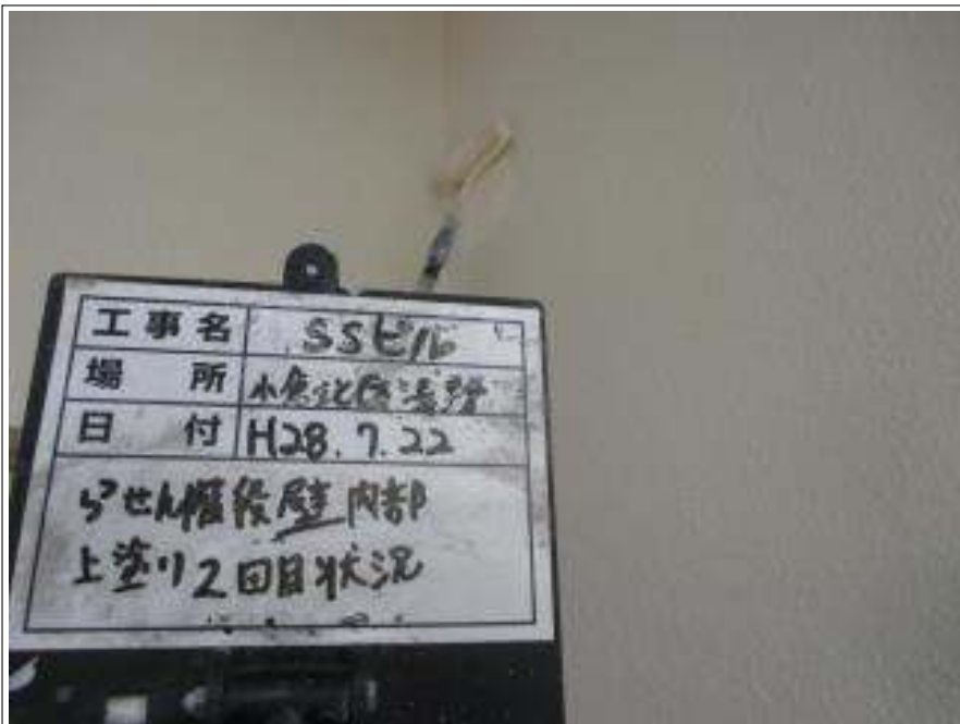
螺旋階段内部 外壁 上塗り施工中
