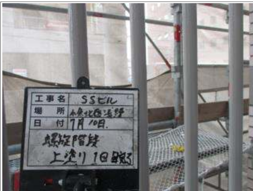
螺旋階段 上塗り（1回目）施工後
