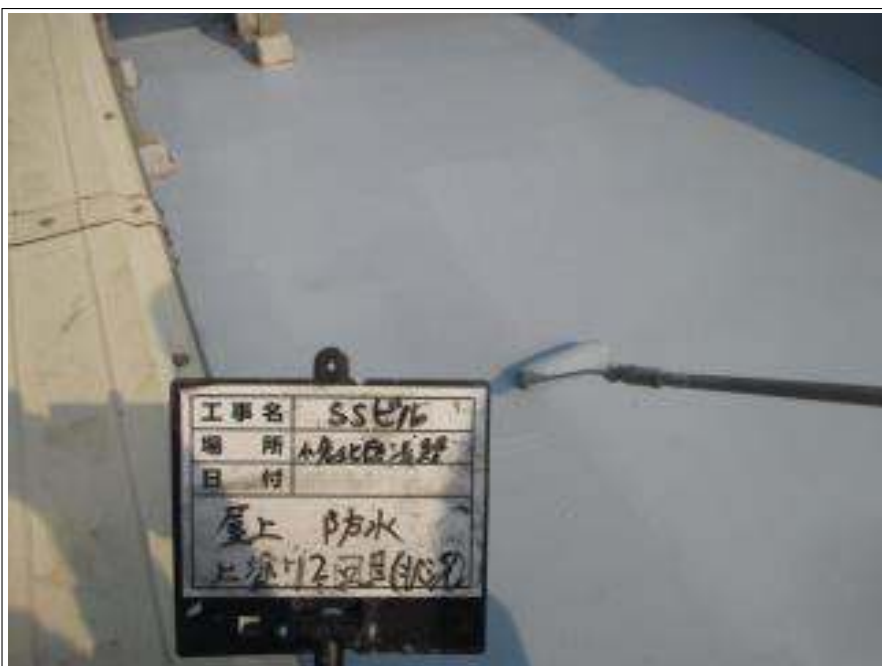
屋上防水部 上塗り施工中
