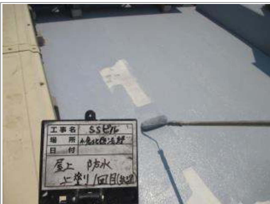
屋上防水部 中塗り施工中
