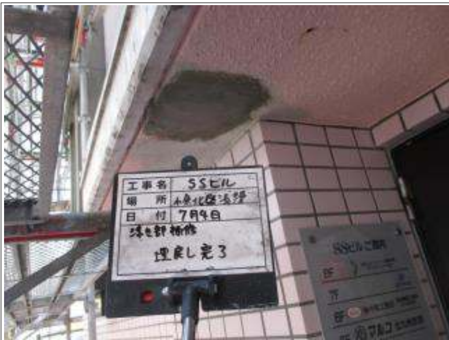
爆裂部補修 埋戻し 施工後
