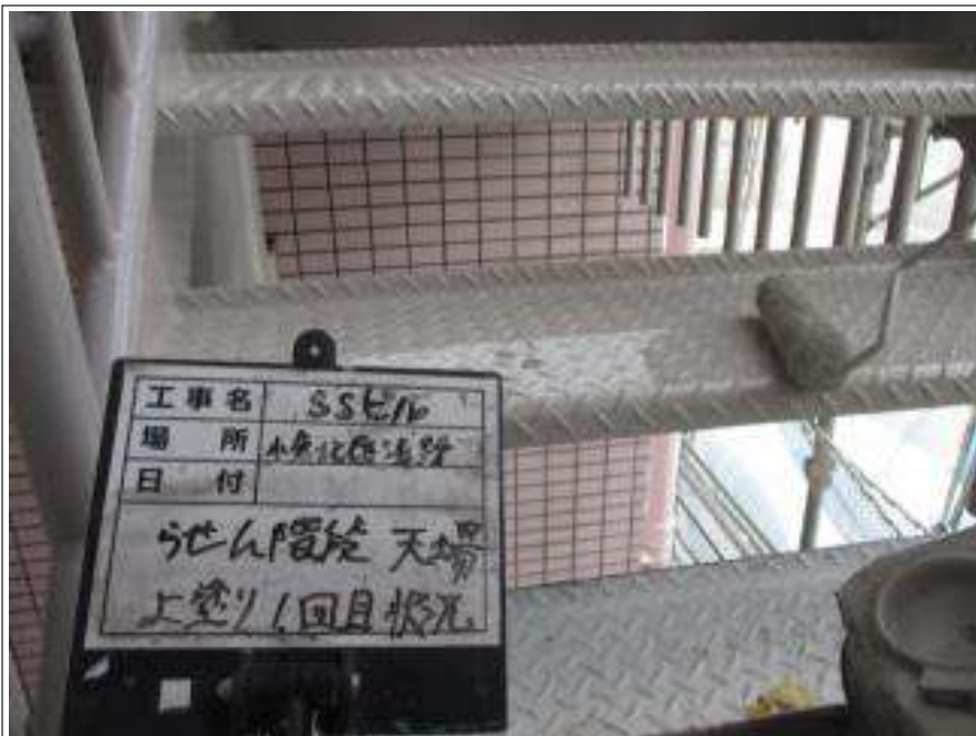
螺旋階段 上塗り（1回目）施工中
