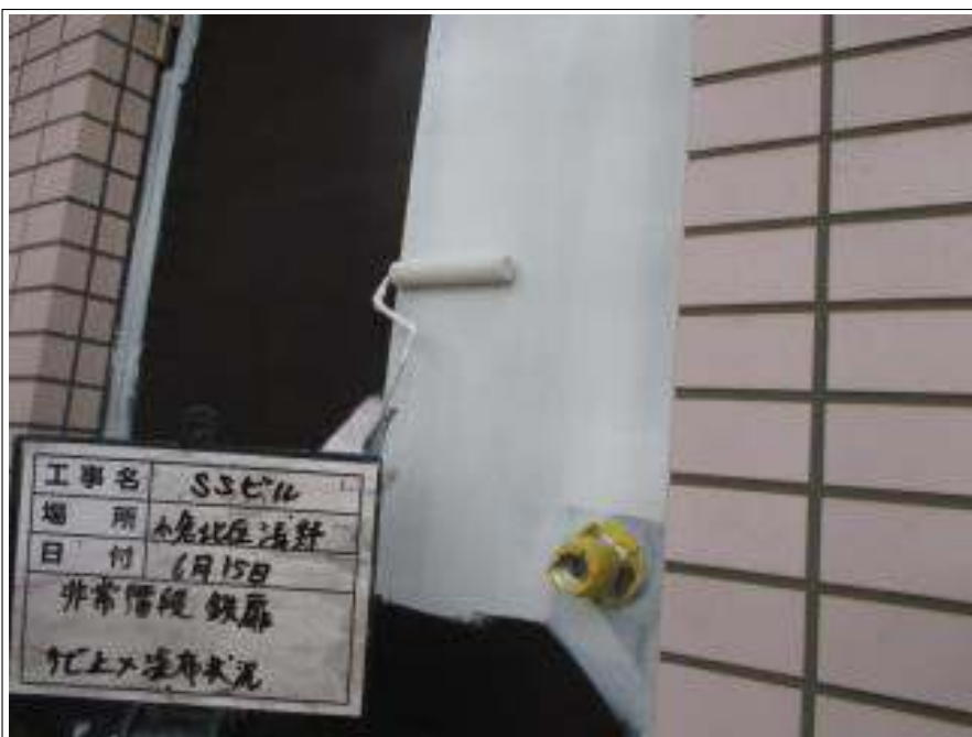
鉄扉 サビ止め塗布施工中
