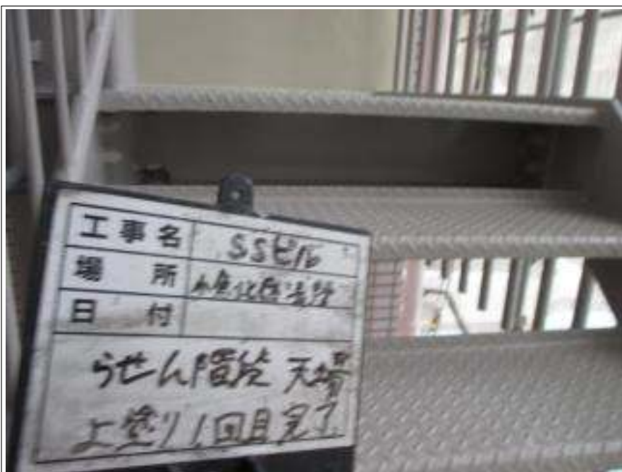
螺旋階段 上塗り（1回目）施工後
