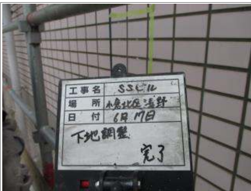
タイル部 下地調整施工後
