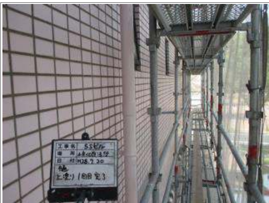
樋 上塗り（1回目）施工後
