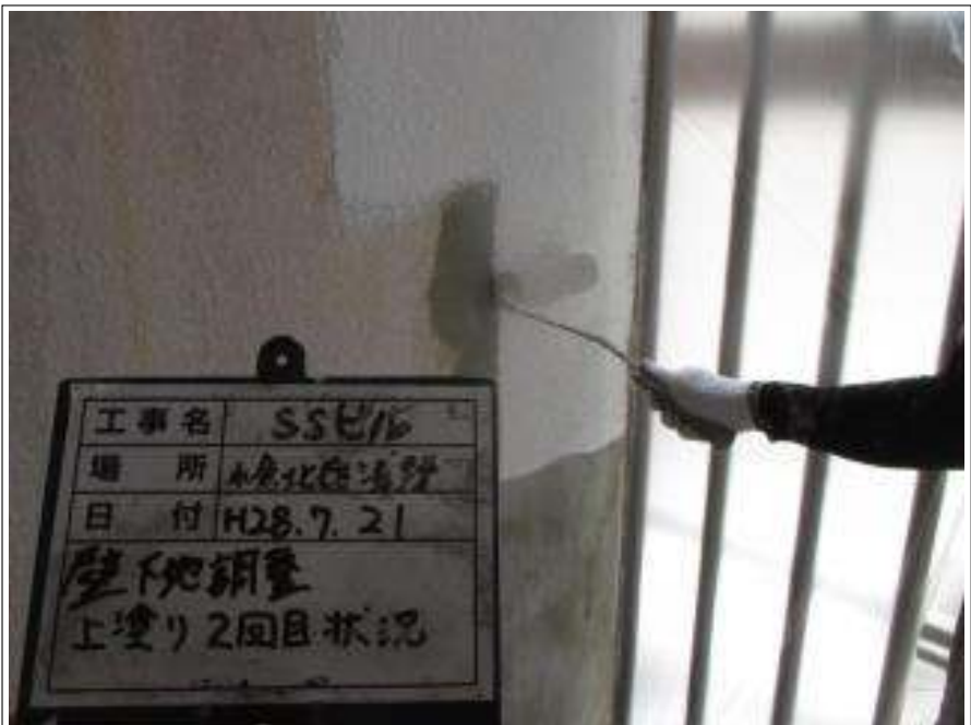
外壁 下地調整 上塗り施工中
