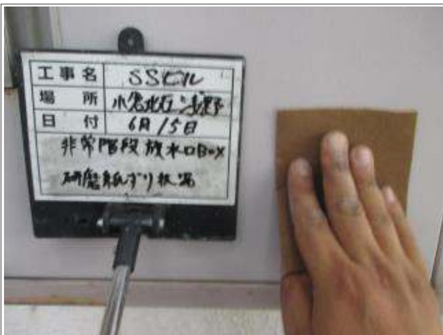
放水口BOX 研磨紙ずり施工中
