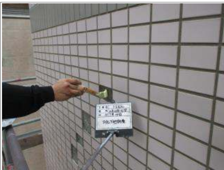
タイル部補修 施工中
