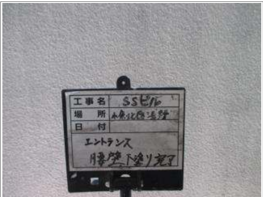
エントランス腰壁 下塗り施工後
