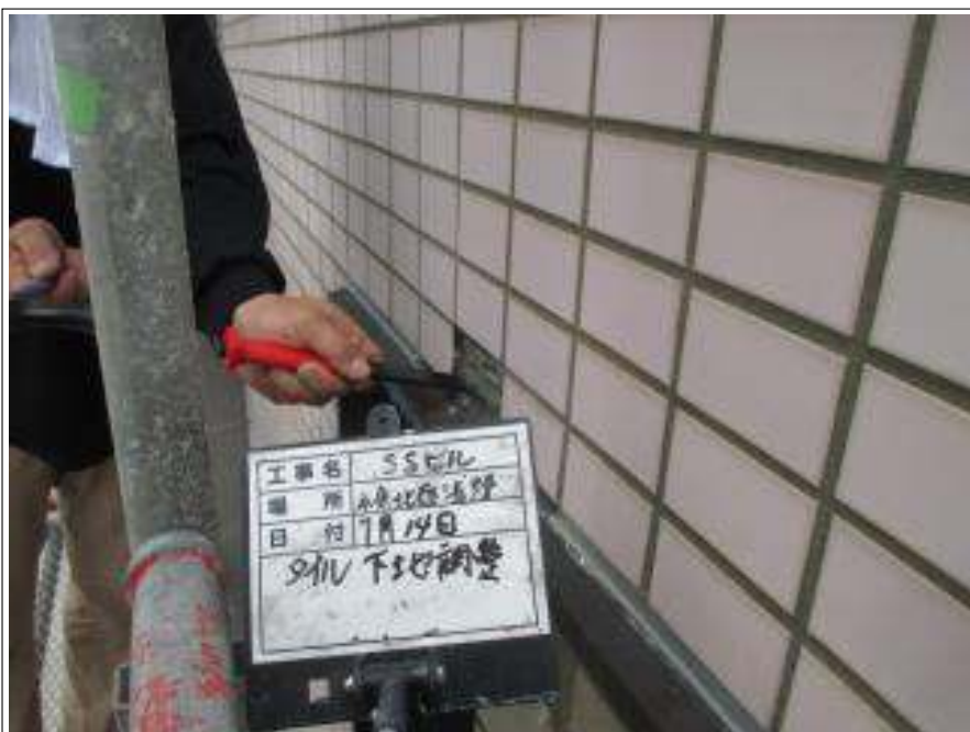
タイル部補修 施工中
