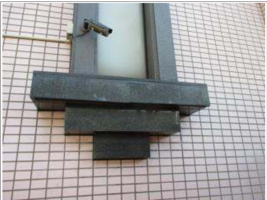
コーキング打ち替え 施工後
