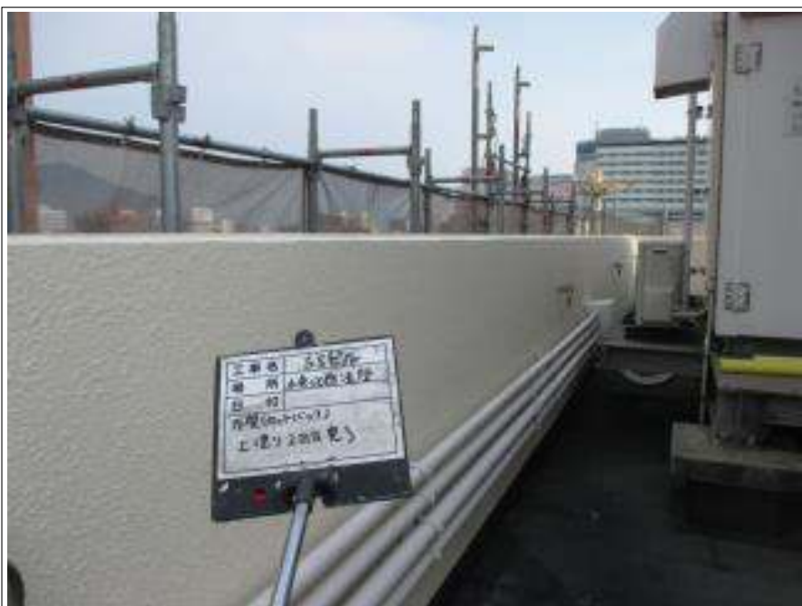
外壁 上塗り施工後
