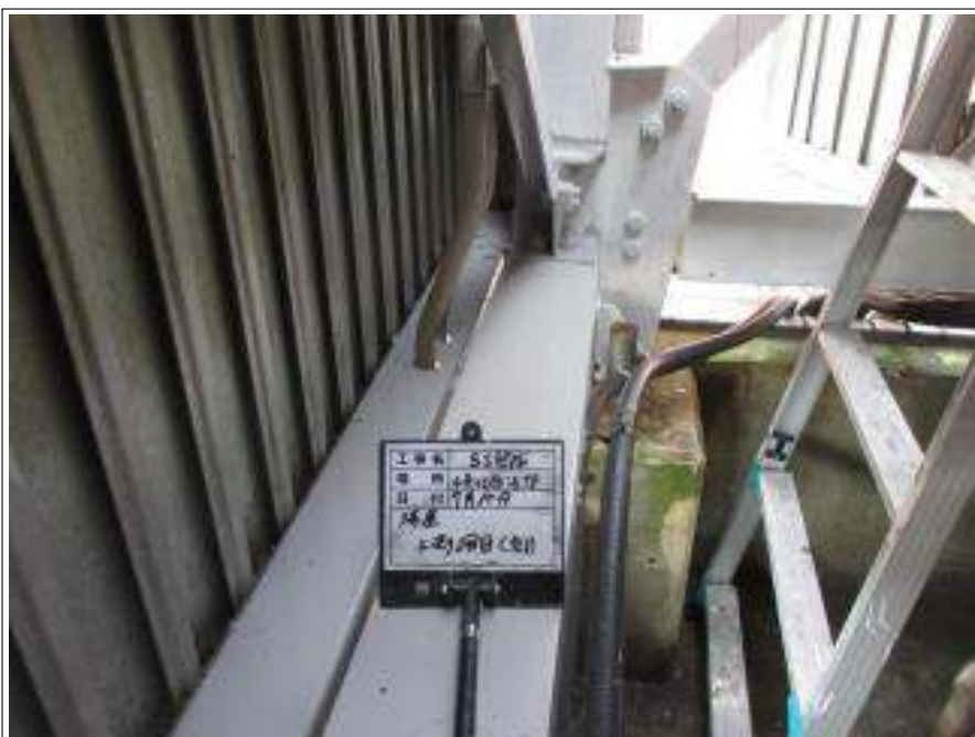
塔屋 上塗り（2回目）施工後
