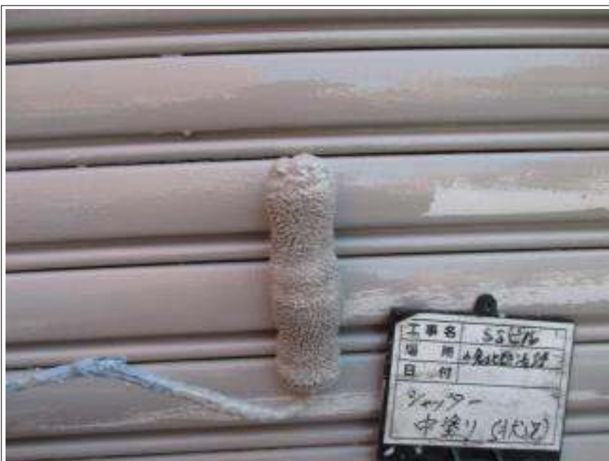
シャッター 中塗り施工中
