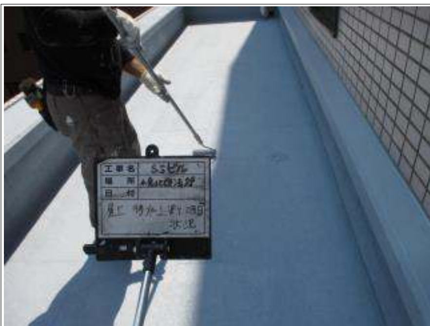
屋上防水部 上塗り施工中
