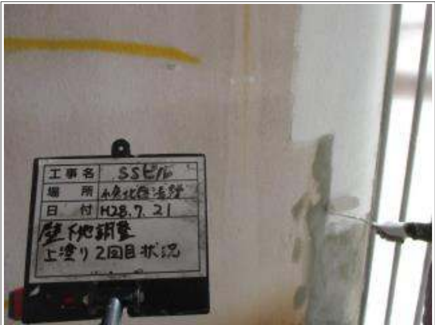
外壁 下地調整 上塗り施工中
