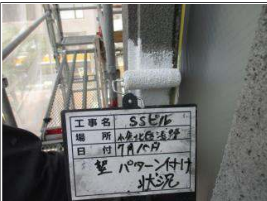
外壁 パターン付け 施工中
