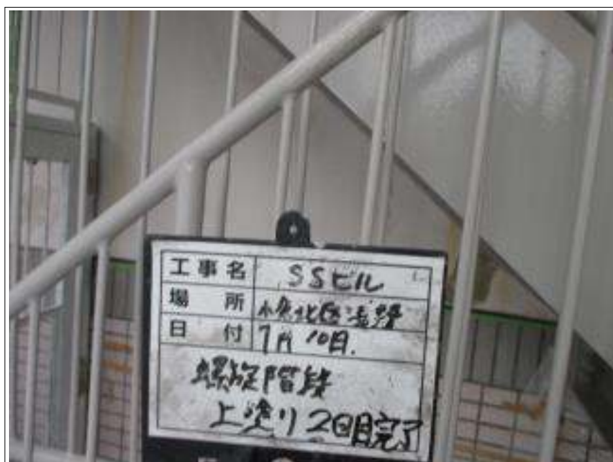
螺旋階段 上塗り（2回目）施工後
