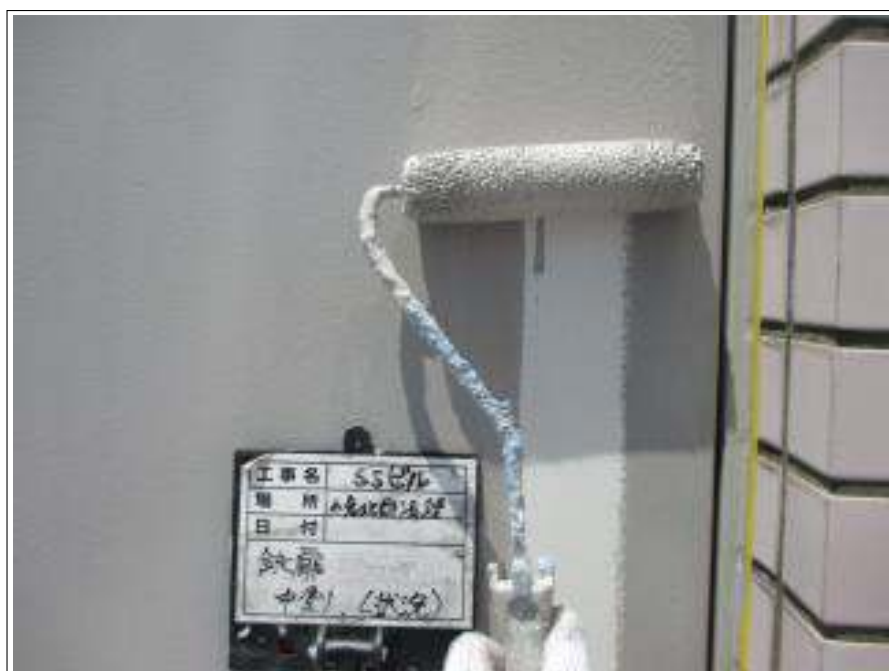
鉄扉 中塗り施工中
