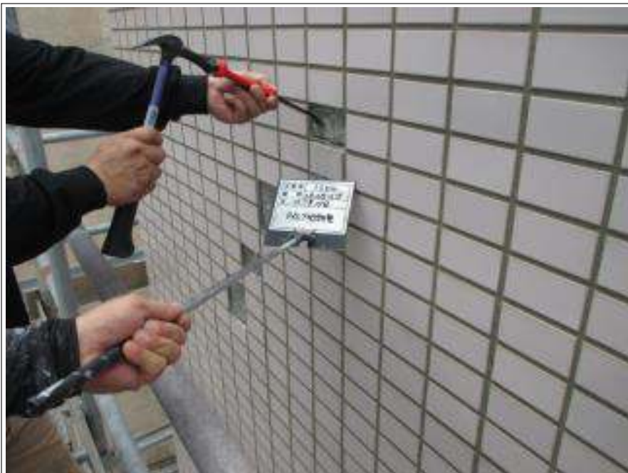
タイル部補修 施工中
