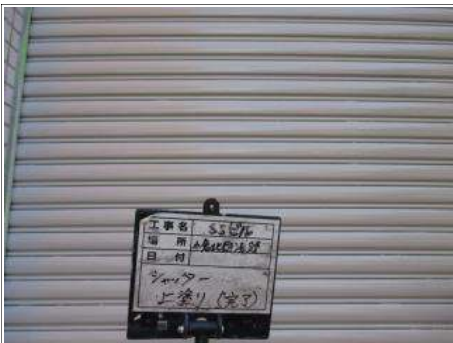
シャッター 上塗り施工後
