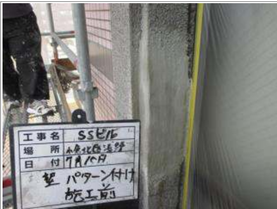
外壁 パターン付け 施工前
