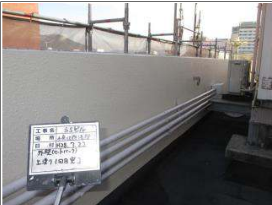
外壁 中塗り施工後
