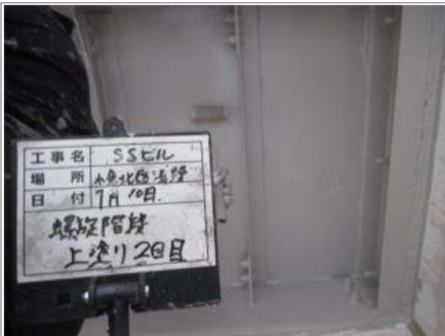
螺旋階段 上塗り（2回目）施工中
