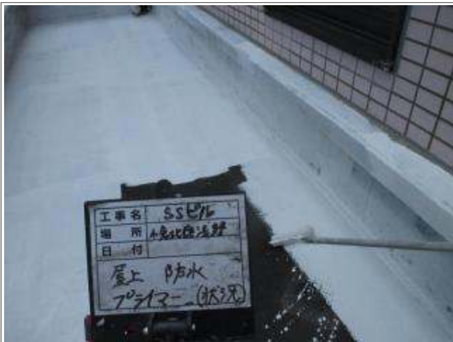
屋上防水部 下塗り施工中
