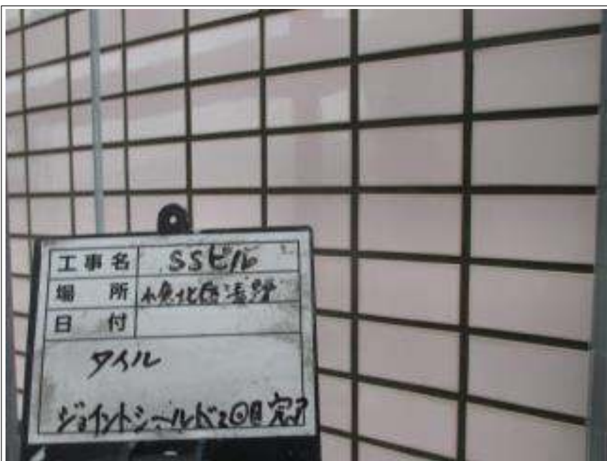
タイル部 上塗り(2回目) 施工後
