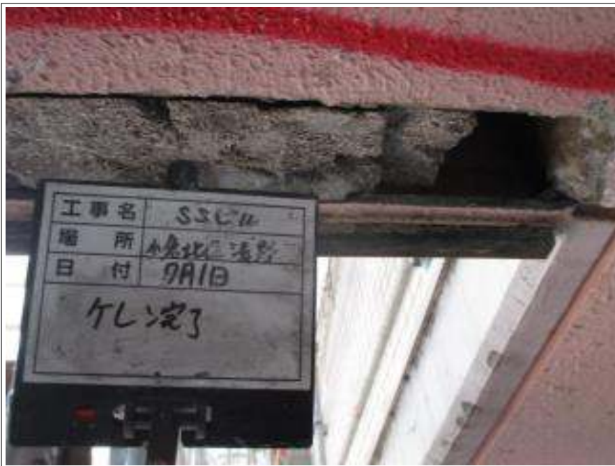
ケレン処理施工後
