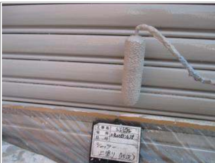
シャッター 上塗り施工中
