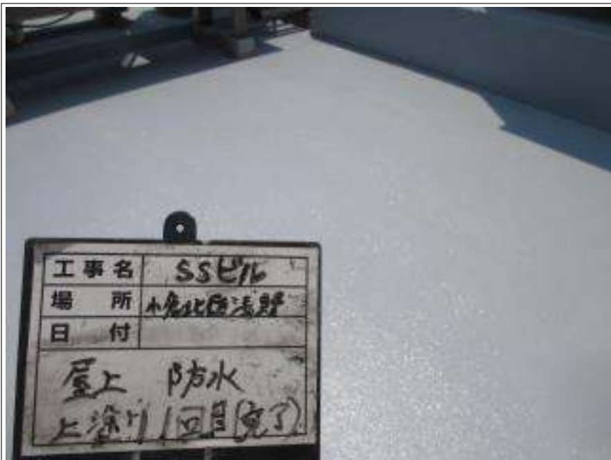
屋上防水部 中塗り施工後
