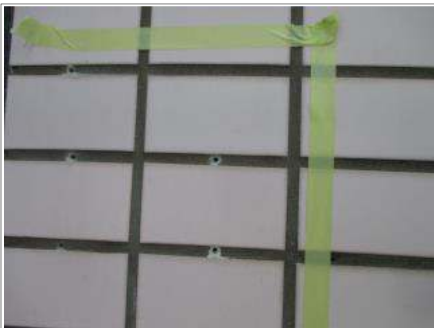
タイル部 下地調整施工中
