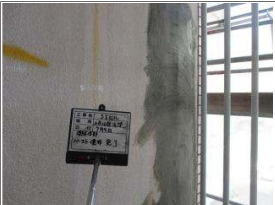
外壁 ペースト塗布 施工後
