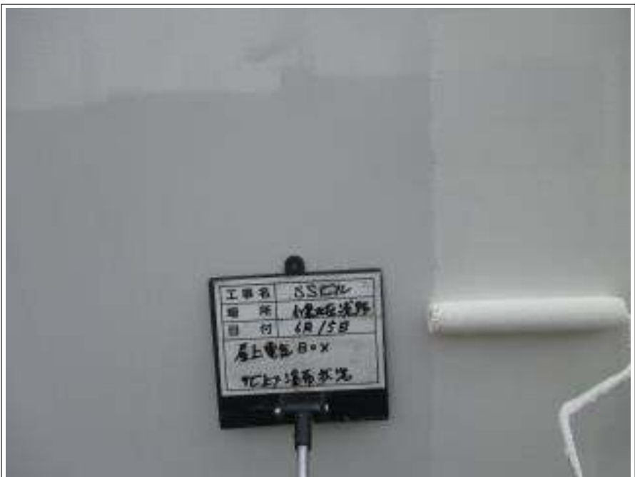
電気BOX サビ止め塗布施工中
