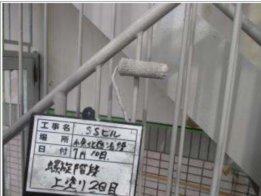
螺旋階段 上塗り（2回目）施工中
