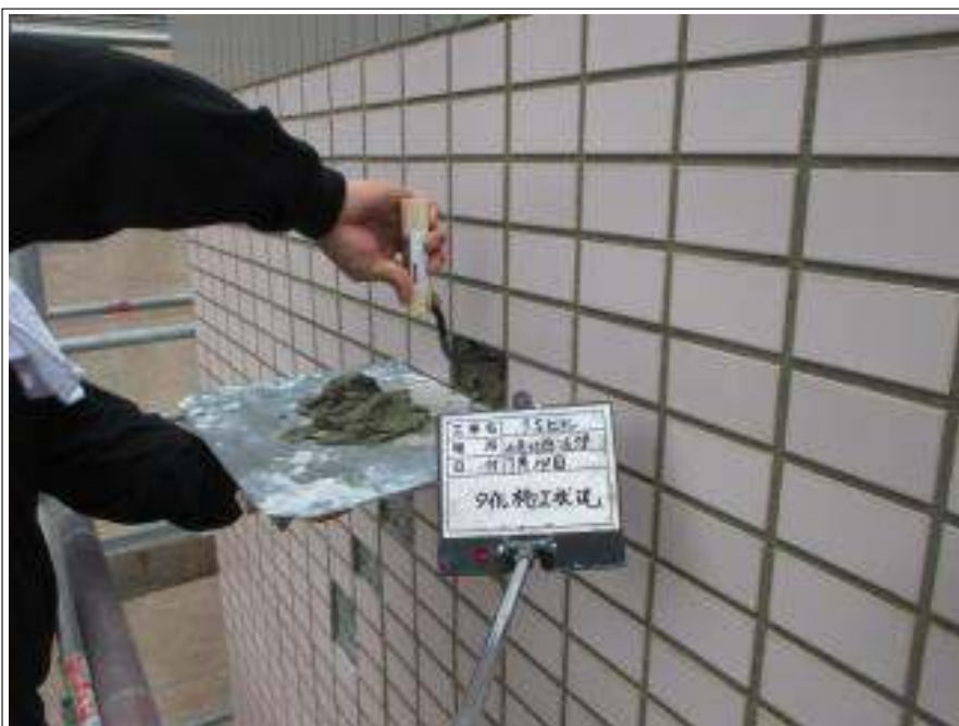
タイル部補修 施工中
