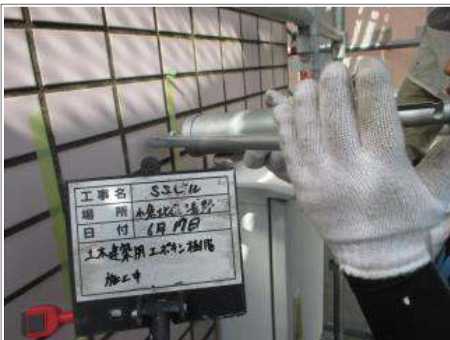
タイル部 エポキシ樹脂注入
