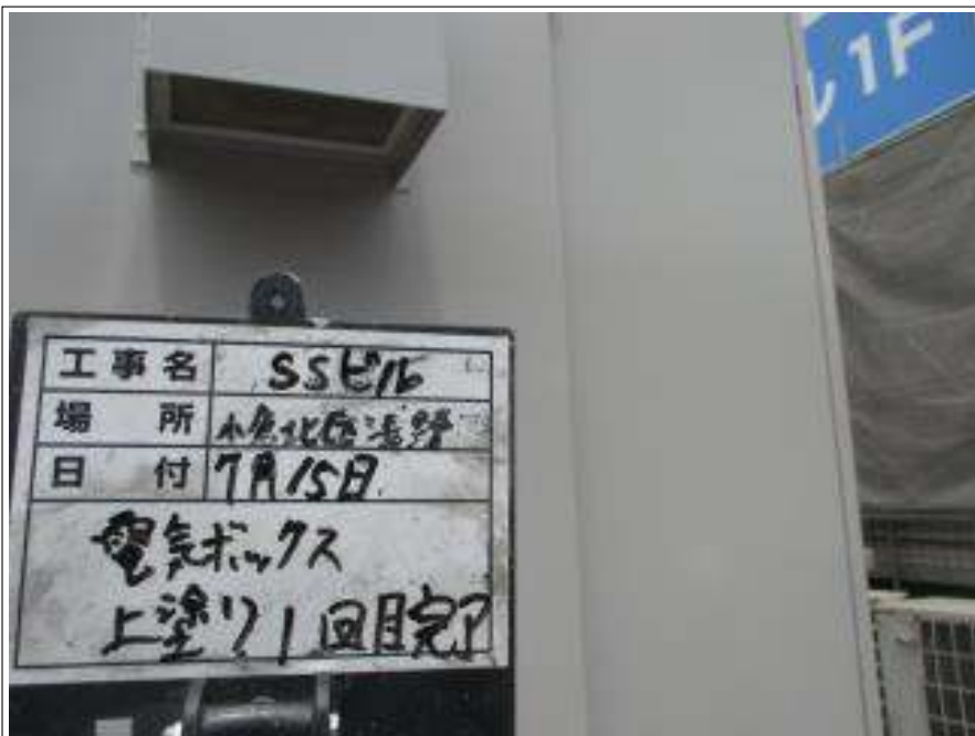
電気BOX 上塗り（1回目）施工後
