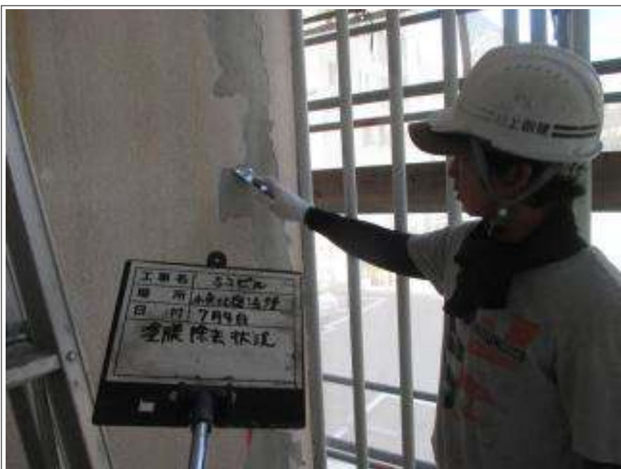
塗膜除去 施工中
