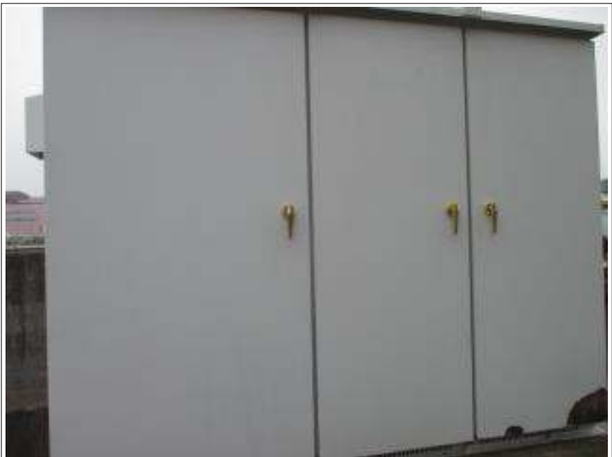
電気BOX 施工前
