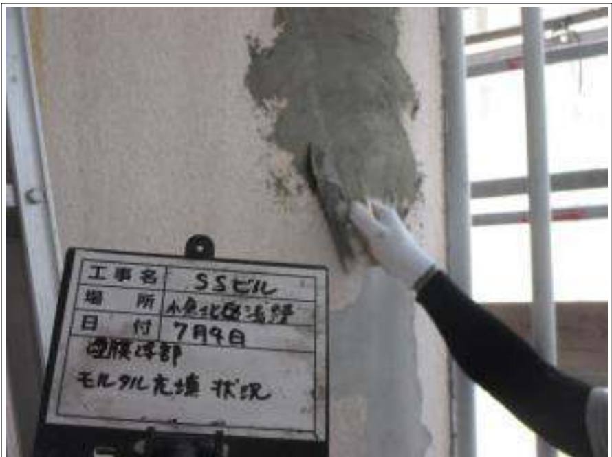
外壁 モルタル充填 施工中
