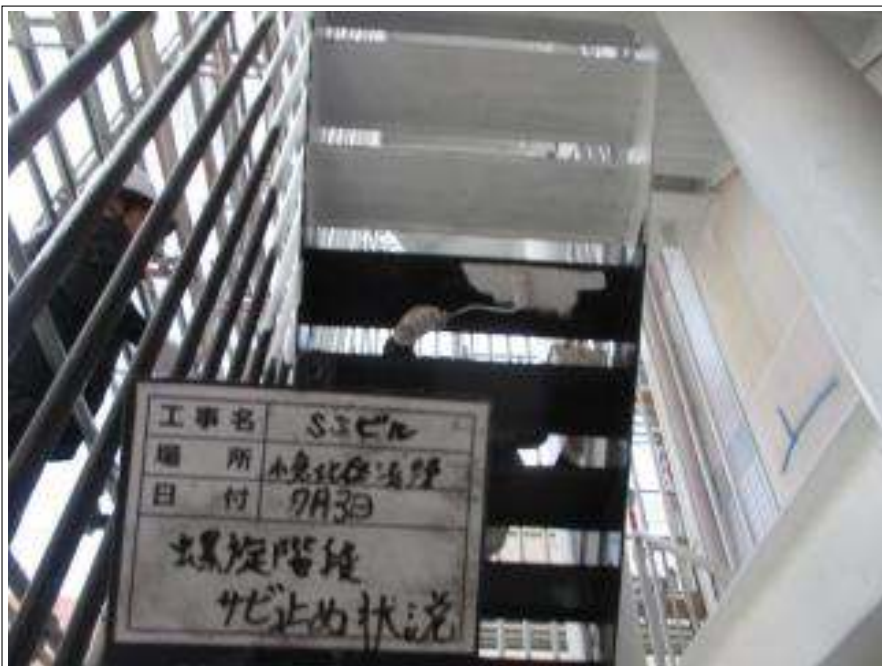
螺旋階段 サビ止め塗布施工中
