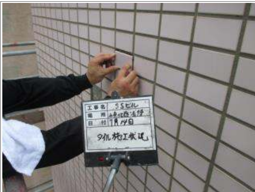
タイル部補修 施工中
