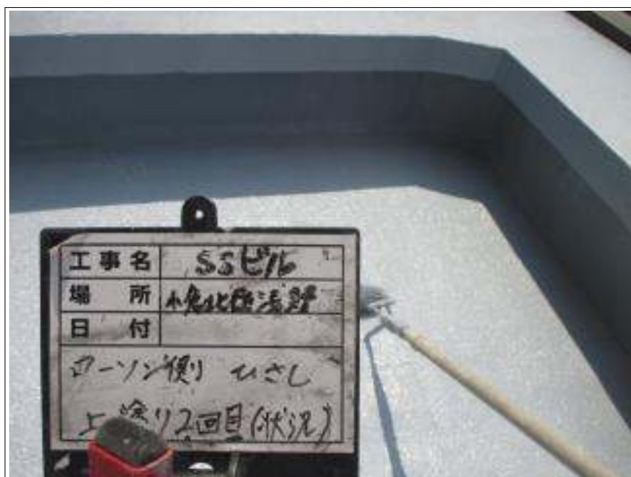
防水部 上塗り施工中
