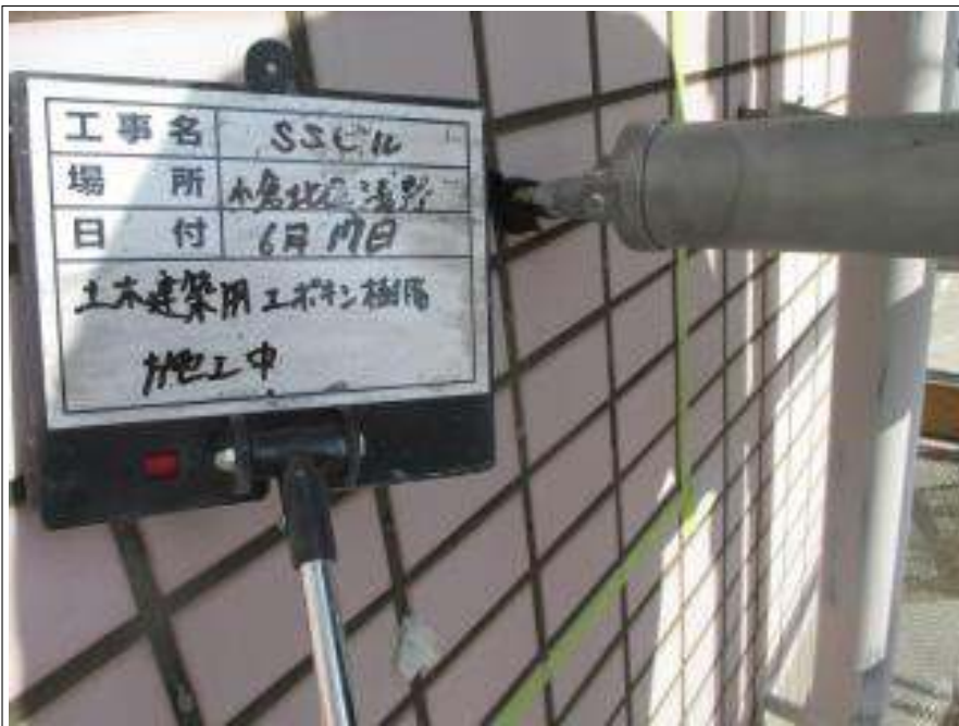
タイル部 エポキシ樹脂注入
