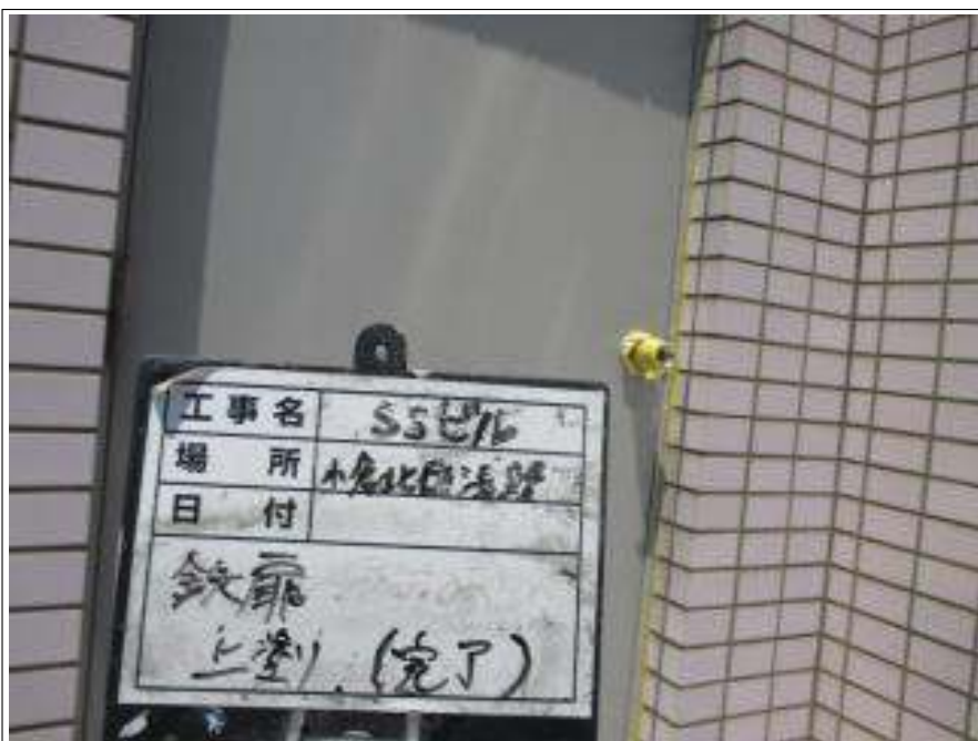
鉄扉 上塗り施工後
