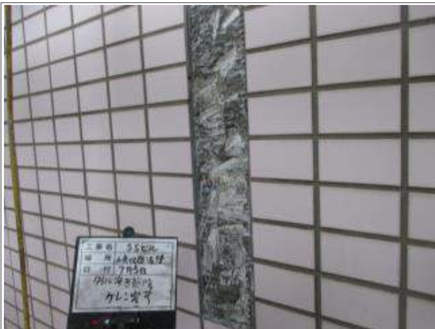
タイル部補修 施工中
