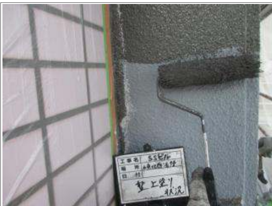
外壁 上塗り施工中
