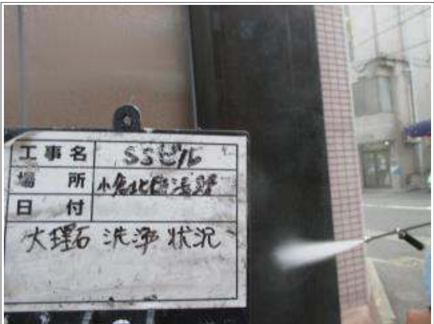
大理石部 高压洗浄中
