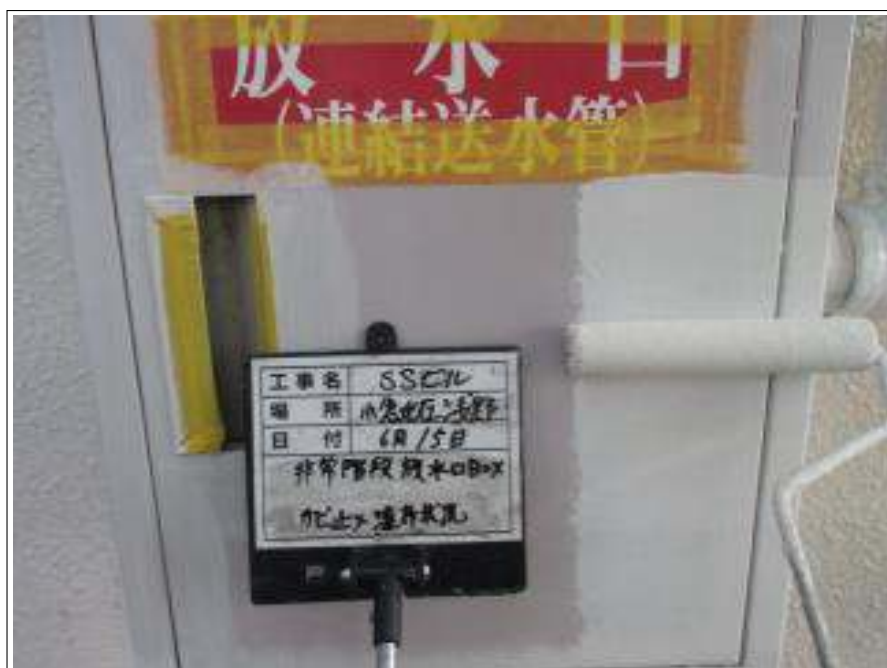
放水口BOX サビ止め塗布施工中
