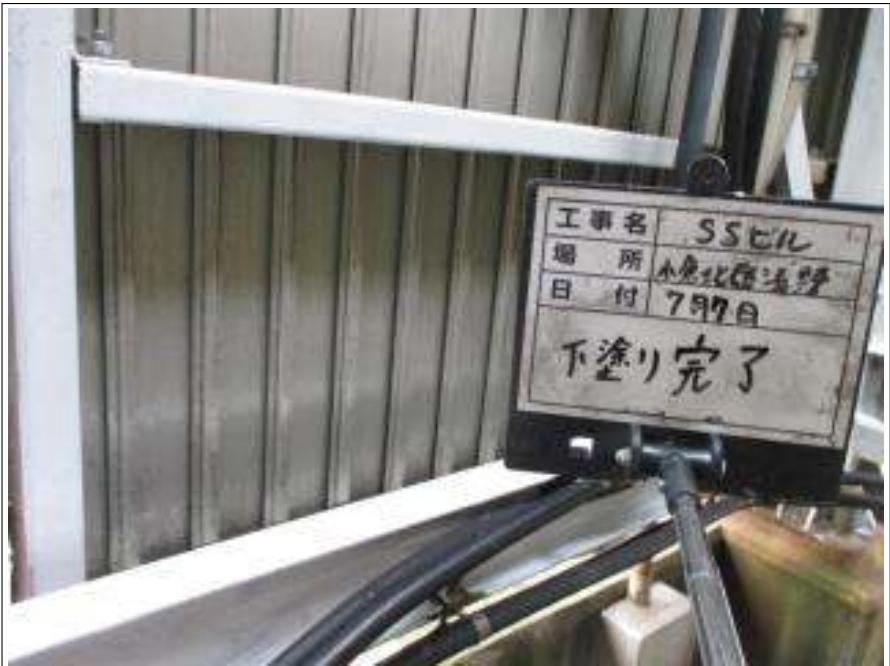
塔屋 サビ止め施工後
