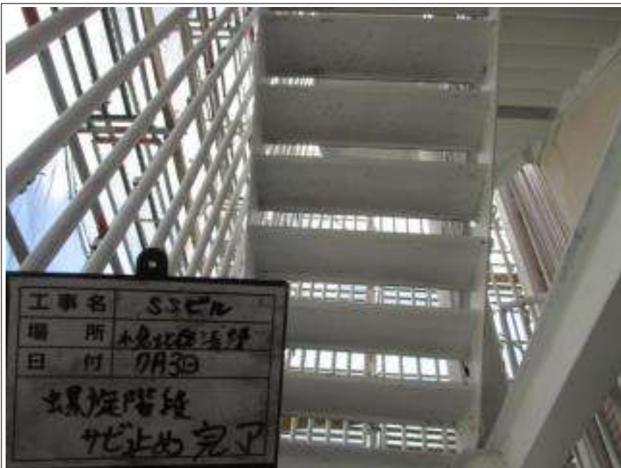
螺旋階段 サビ止め塗布施工後
