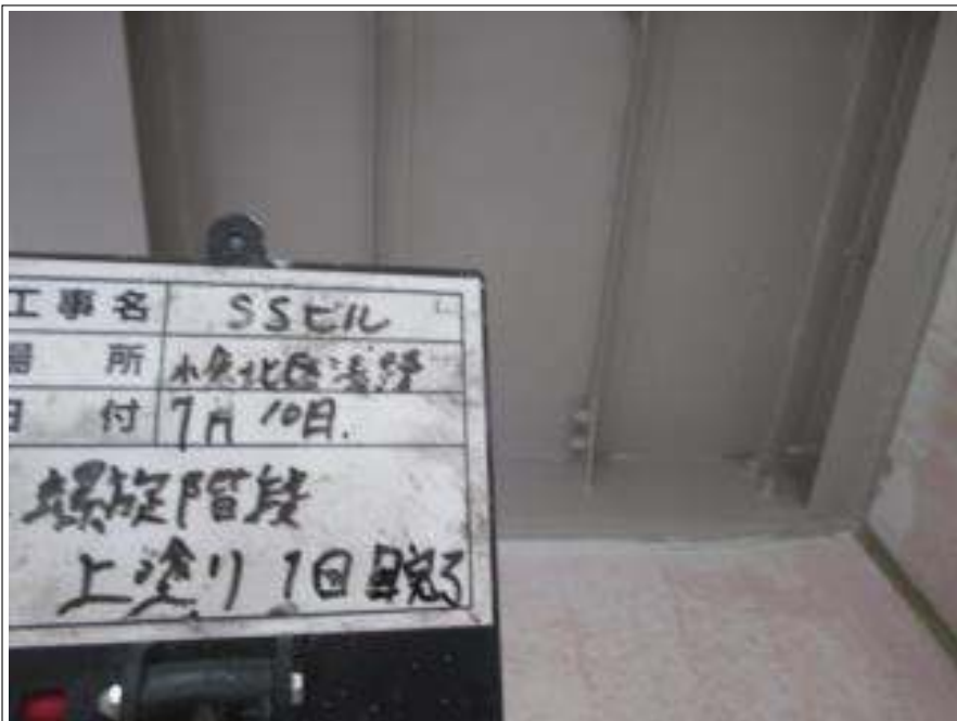
螺旋階段 上塗り（1回目）施工後
