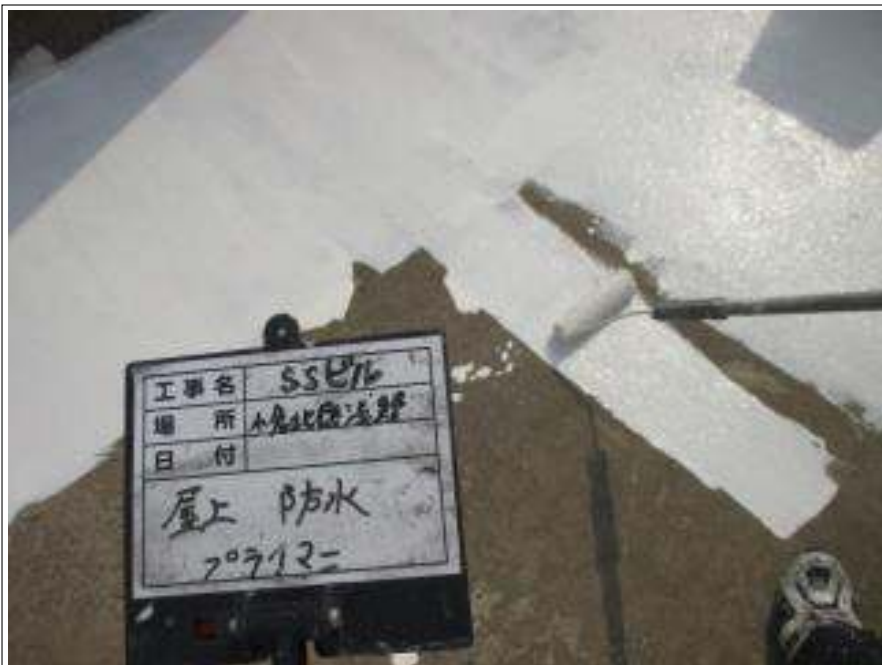
屋上防水部 下塗り施工中
