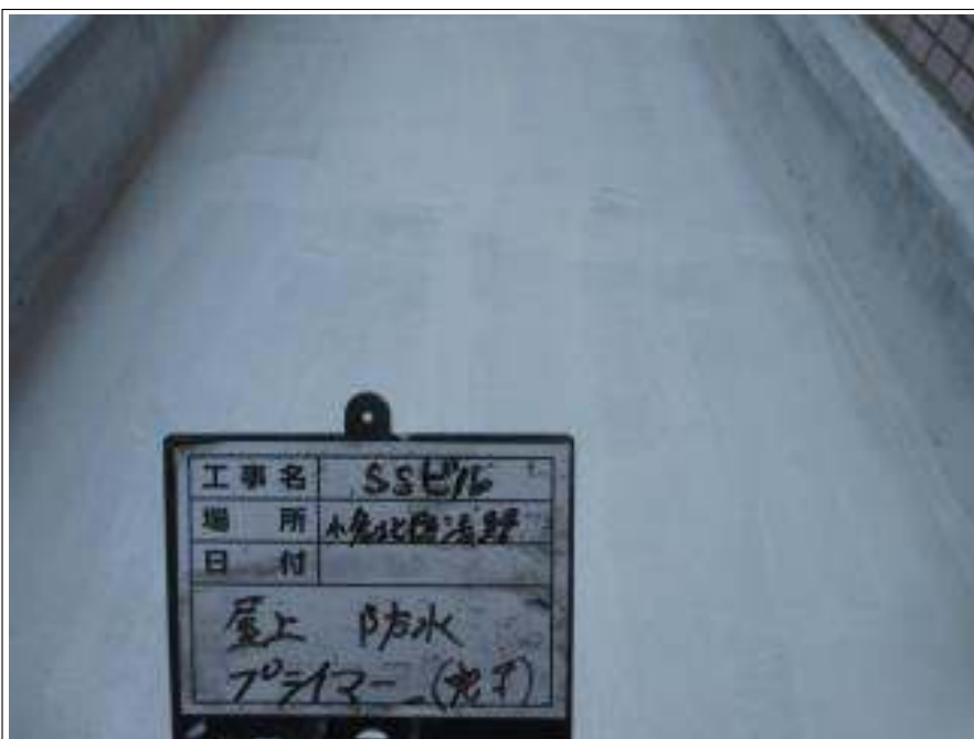
屋上防水部 下塗り施工後
