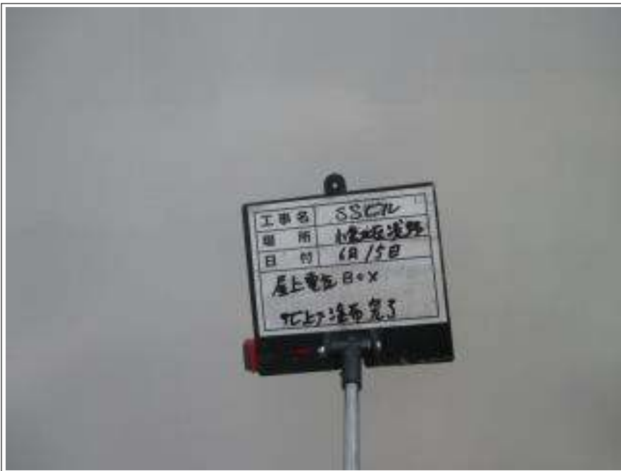
電気BOX サビ止め塗布施工後
