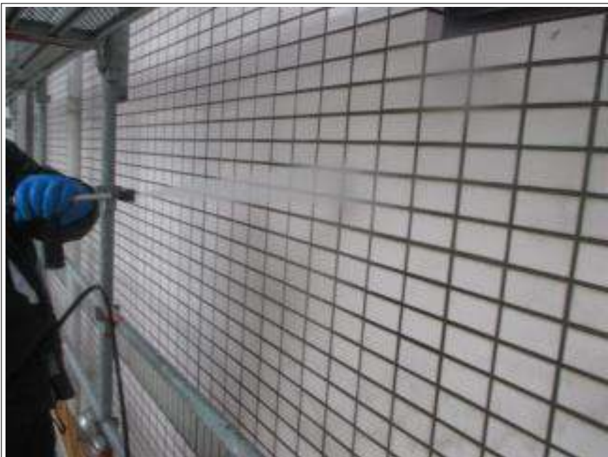
タイル部 高圧洗浄中
