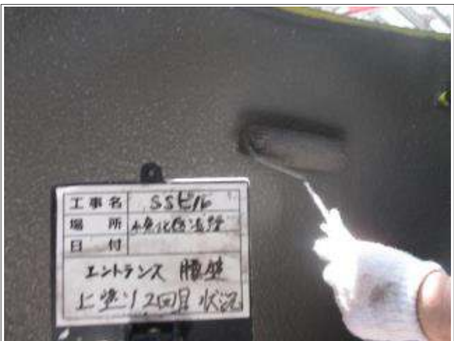
エントランス腰壁 上塗り施工中
