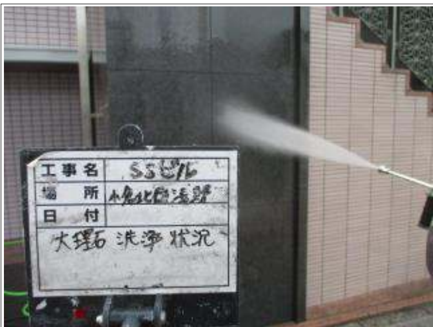
大理石部 高压洗浄中
