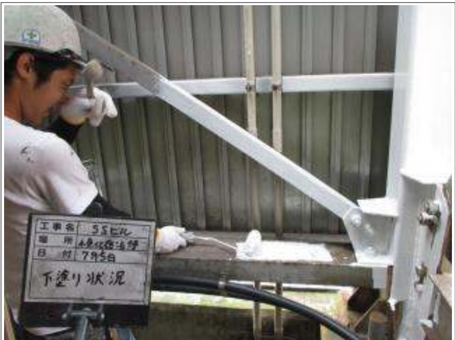
塔屋 サビ止め施工中
