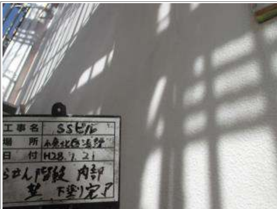
螺旋階段内部 外壁 下塗り施工後
