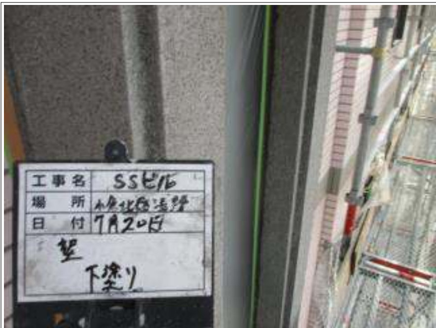
外壁 下塗り施工前
