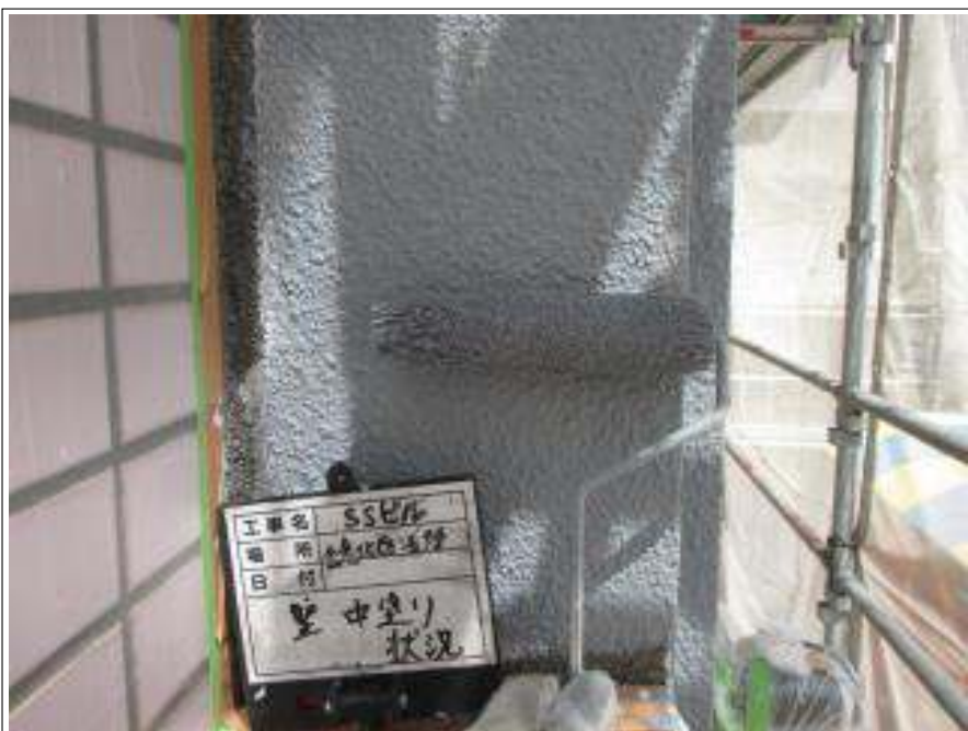
外壁 中塗り施工中
