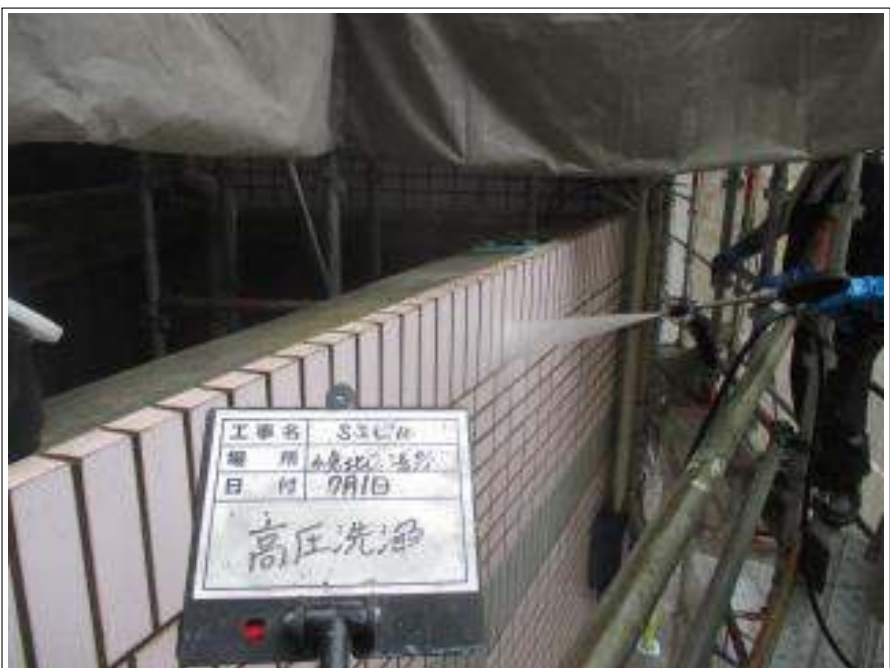
タイル部 高压洗浄中
