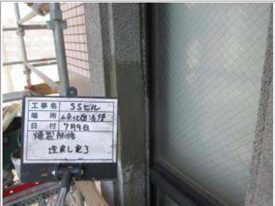
爆裂部補修 埋戻し 施工後
