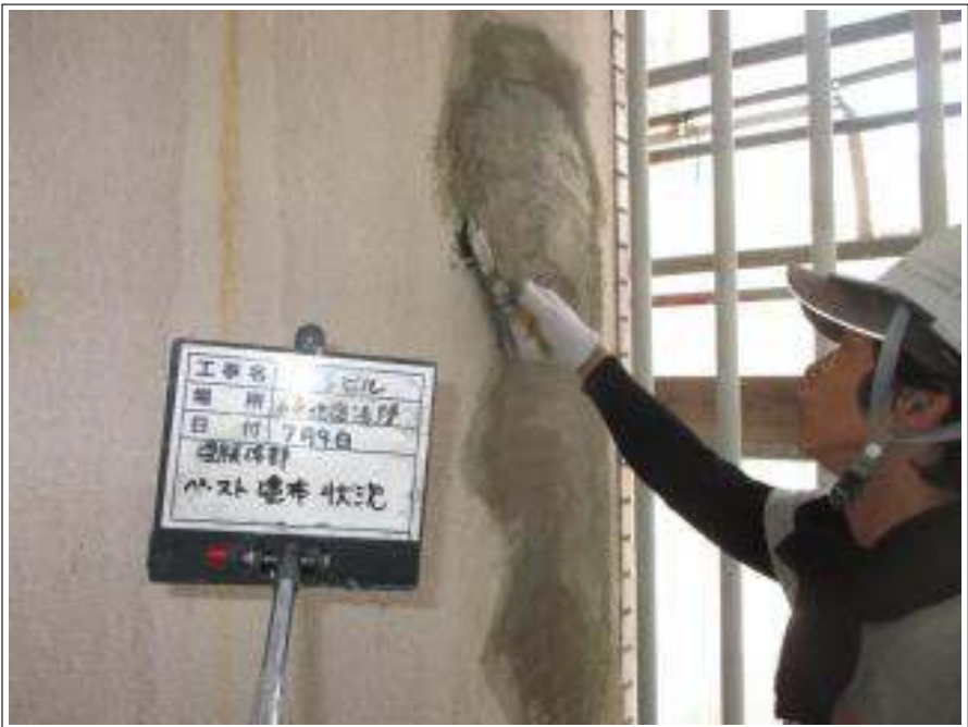
外壁 パースト塗布 施工中
