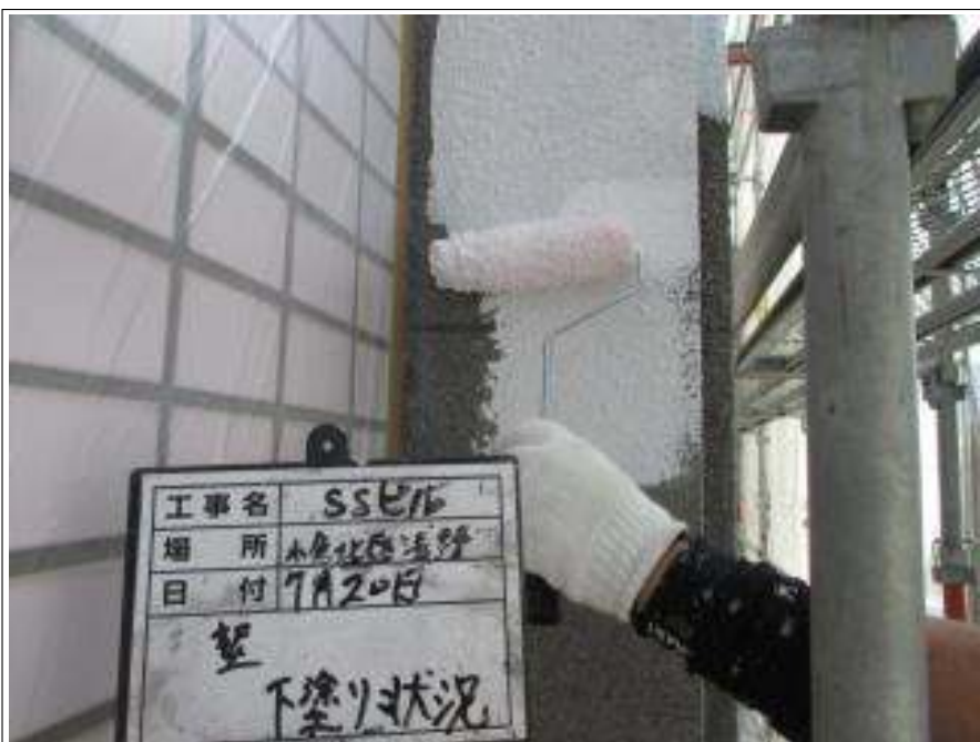
外壁 下塗り施工中
