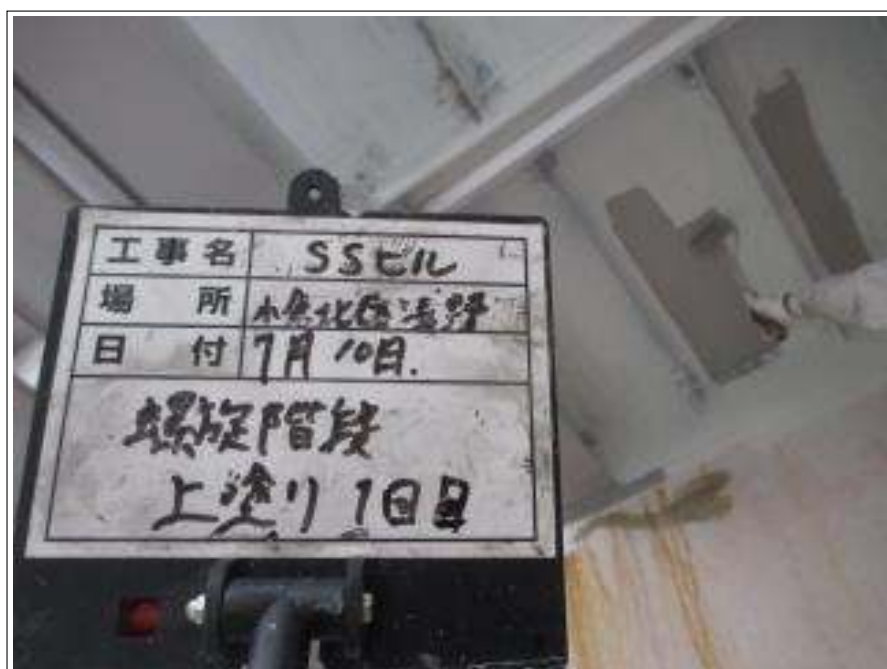
螺旋階段 上塗り（1回目）施工中
