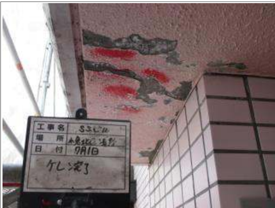
外壁 ケレン処理施工後
