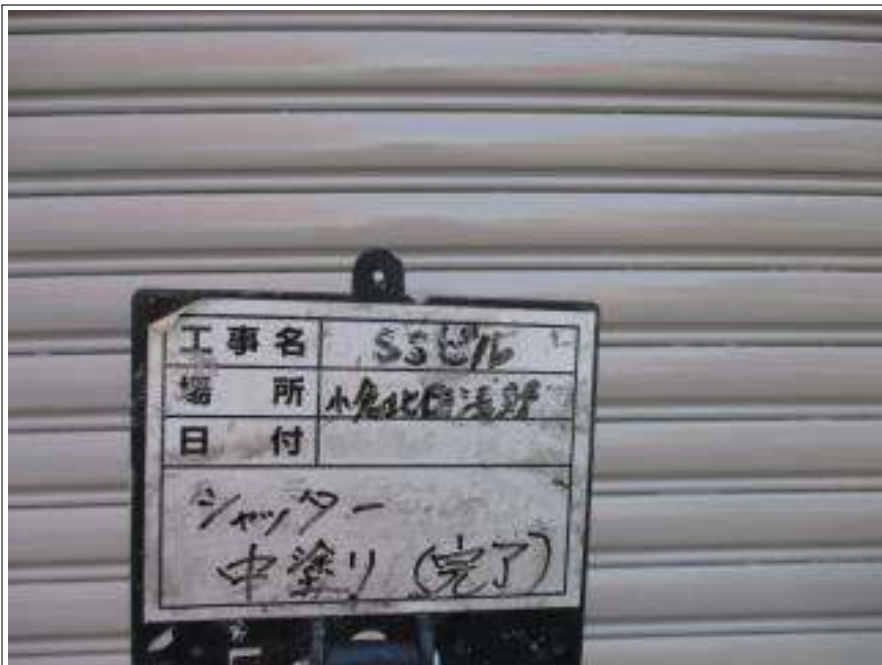
シャッター 中塗り施工後
