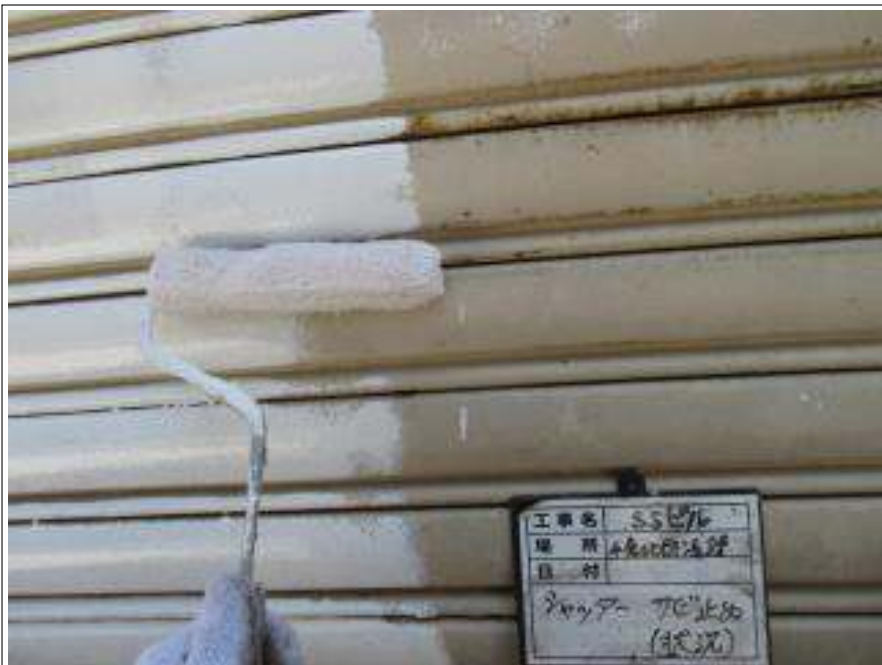
シャッター 錆止め塗布施工中
