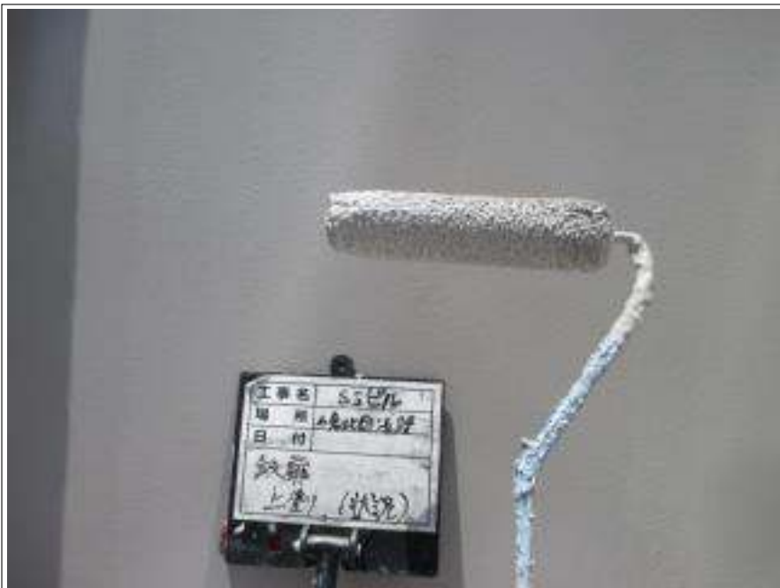
鉄扉 上塗り施工中
