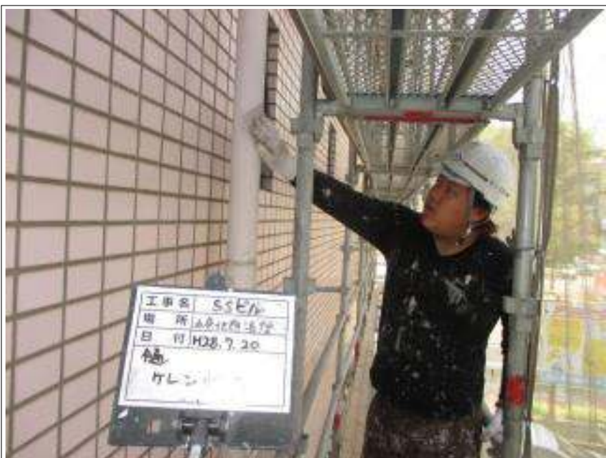
樋 ケレン処理施工中
