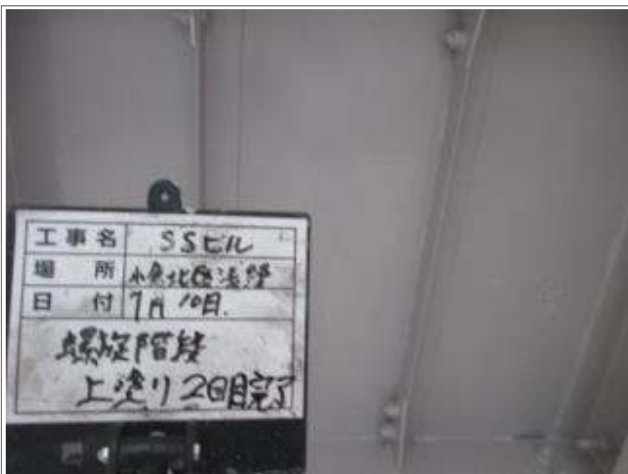
螺旋階段 上塗り（2回目）施工後
