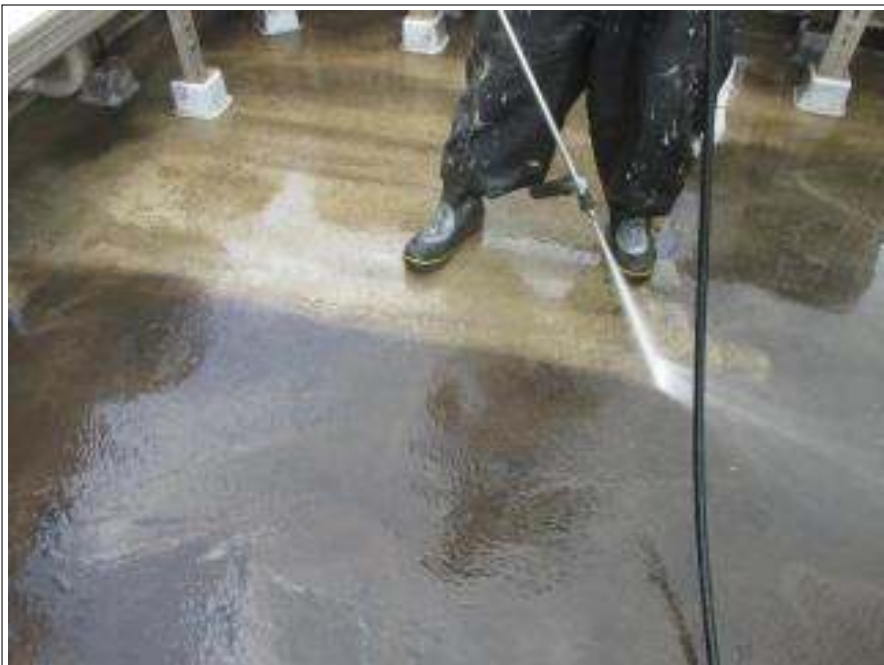
防水部 高压洗浄中
