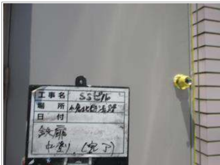
鉄扉 中塗り施工後
