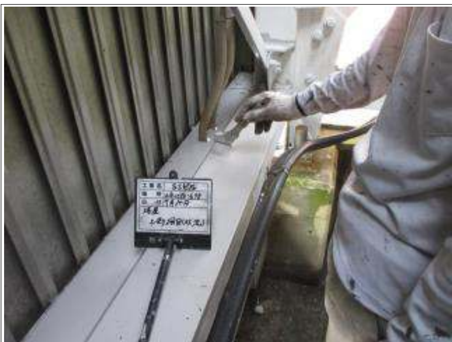
塔屋 上塗り（2回目）施工中
