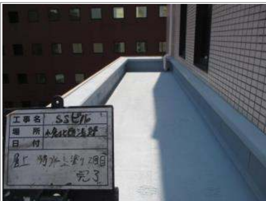
屋上防水部 上塗り施工後
