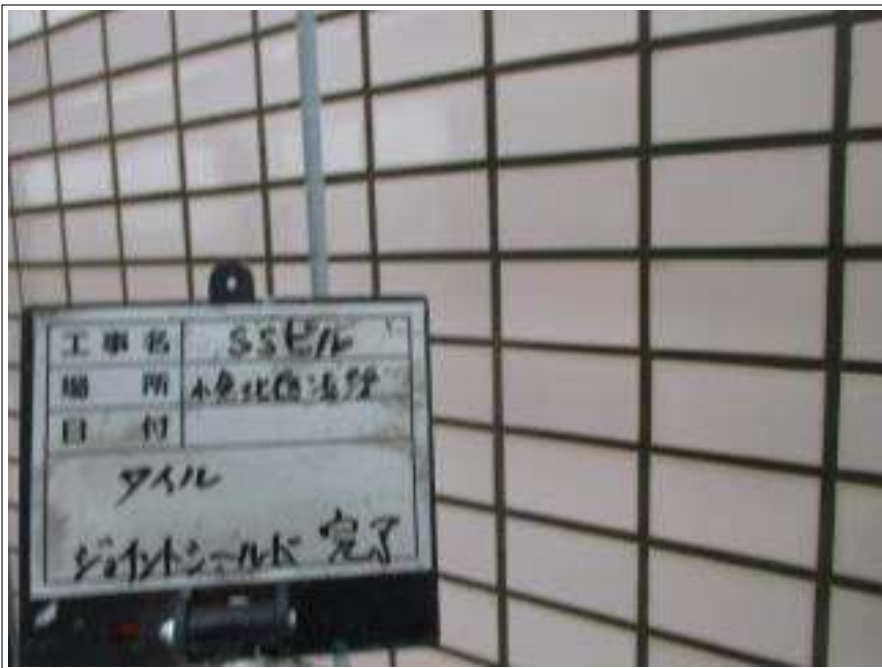
タイル部 上塗り(3回目)施工後
