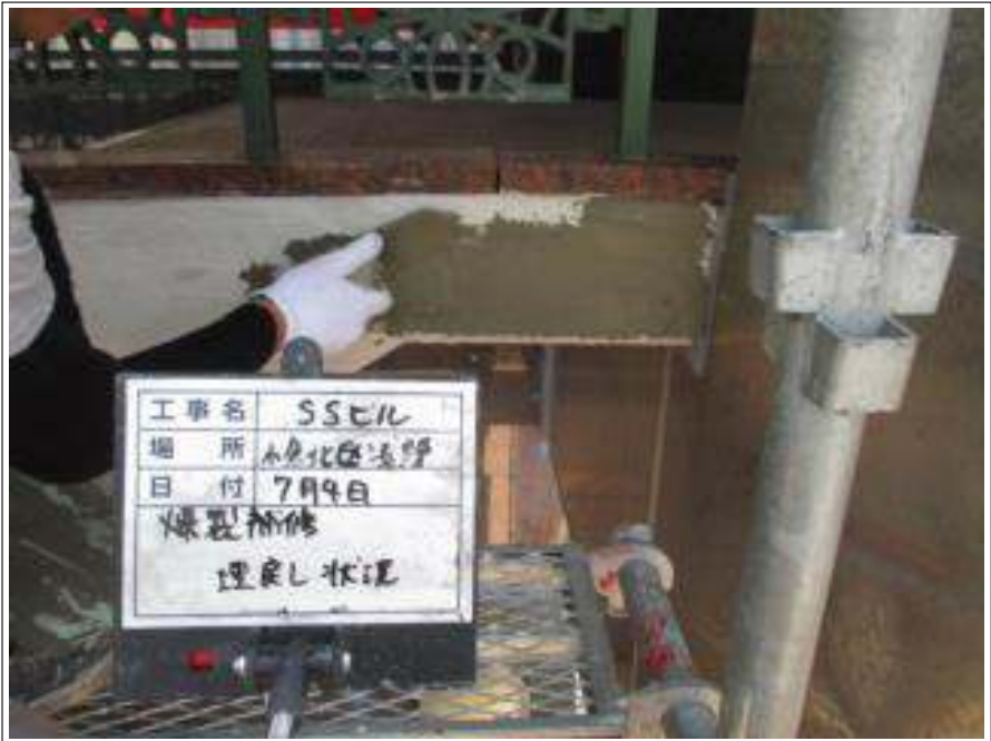
爆裂部補修 埋戻し 施工中
