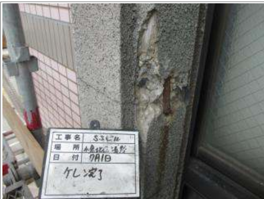
ケレン処理施工後
