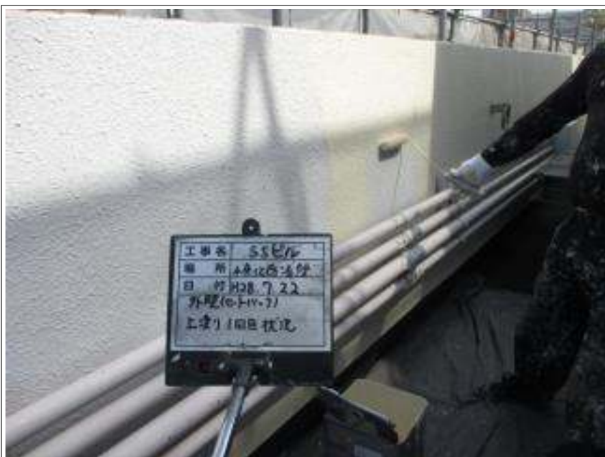
外壁 中塗り施工中
