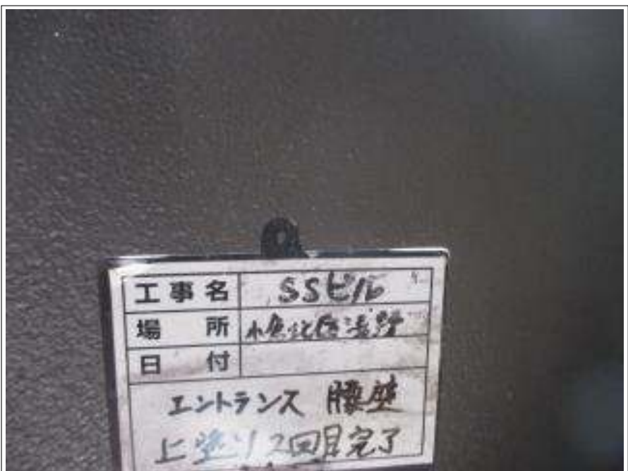
エントランス腰壁 上塗り施工後
