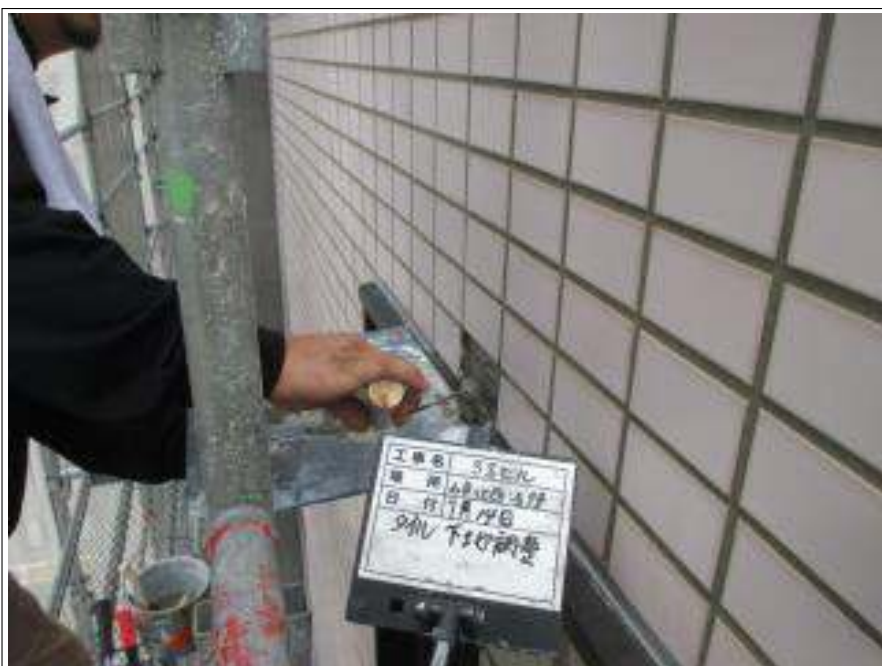
タイル部補修 施工中
