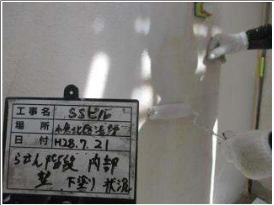
螺旋階段内部 外壁下塗り施工中
