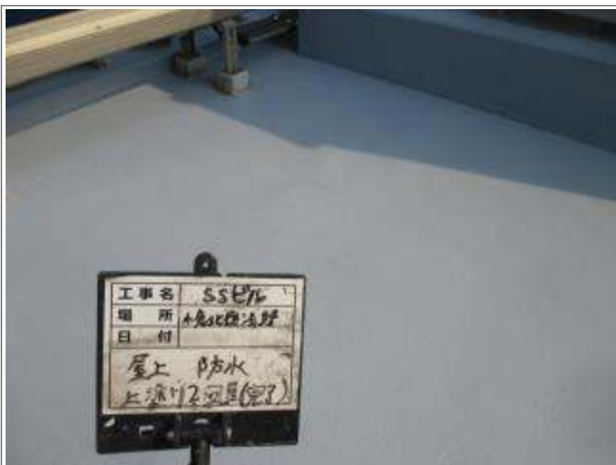
屋上防水部 上塗り施工後
