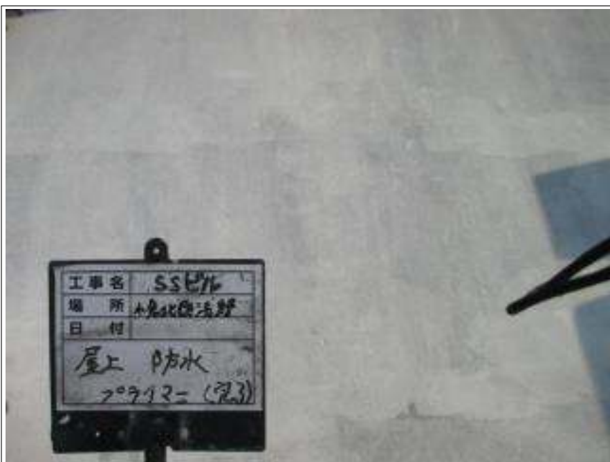
屋上防水部 下塗り施工後
