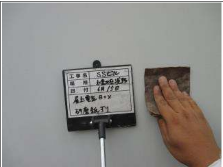
電気BOX 研磨紙ずり施工中
