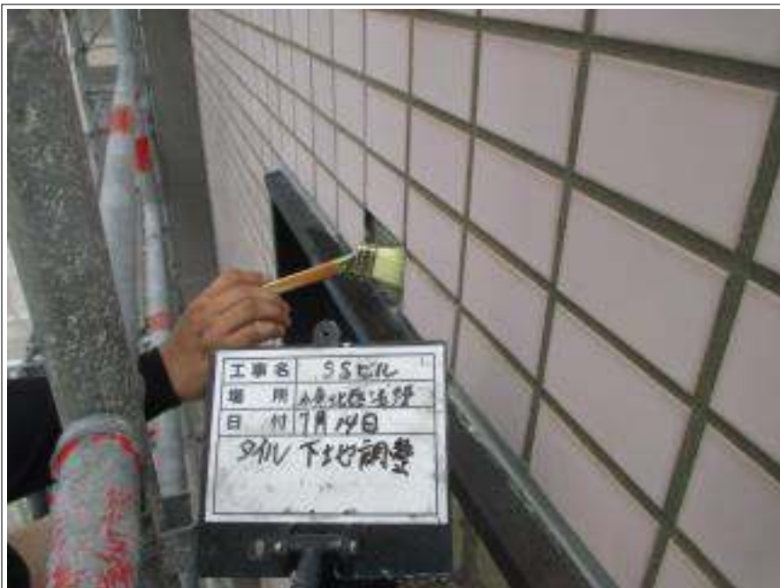
タイル部補修 施工中
