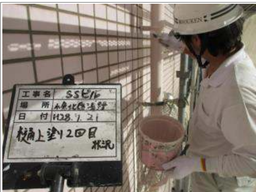
樋 上塗り（2回目）施工中
