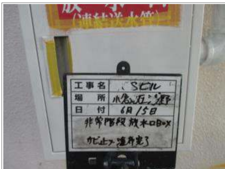
放水口BOX サビ止め塗布施工後
