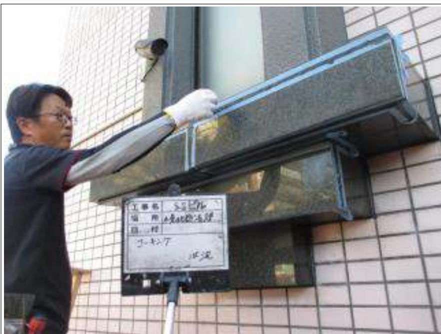
コーキング打ち替え 施工中
