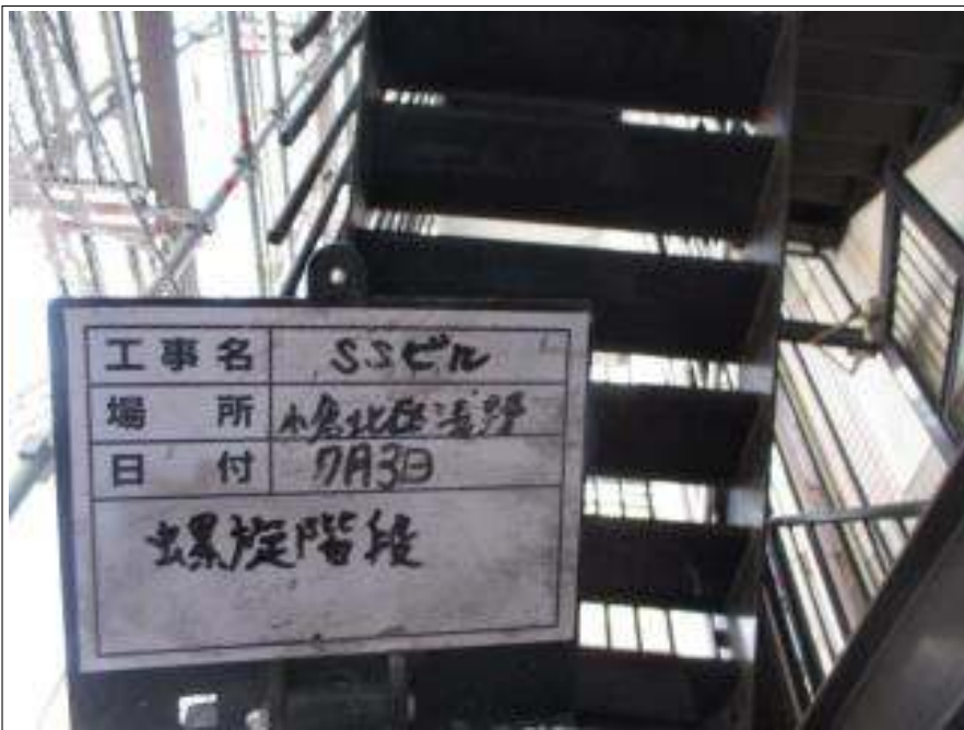
螺旋階段 施工前
