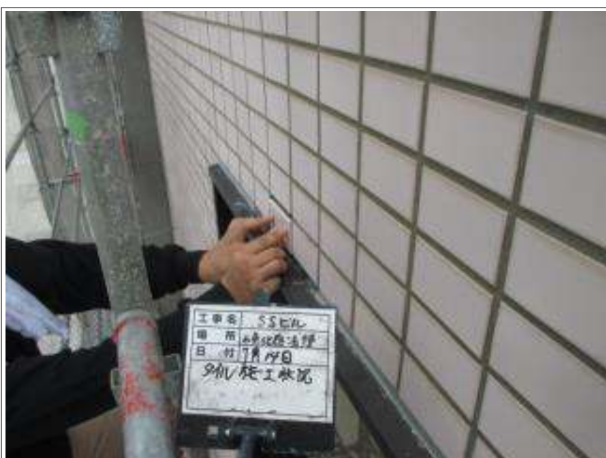
タイル部補修 施工中
