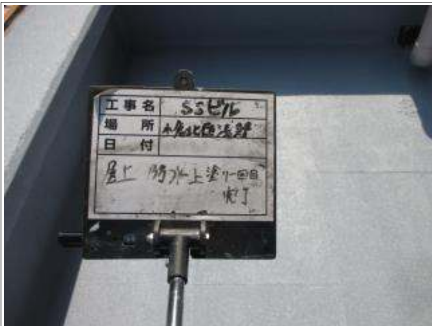
屋上防水部 中塗り施工後
