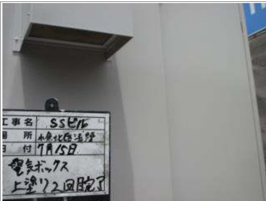
電気BOX 上塗り（2回目）施工後
