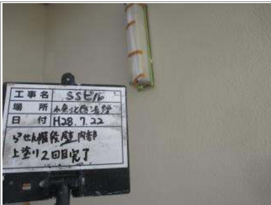
螺旋階段内部 外壁 上塗り施工後
