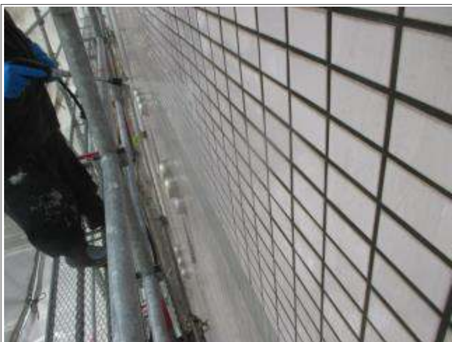
タイル部 高圧洗浄中
