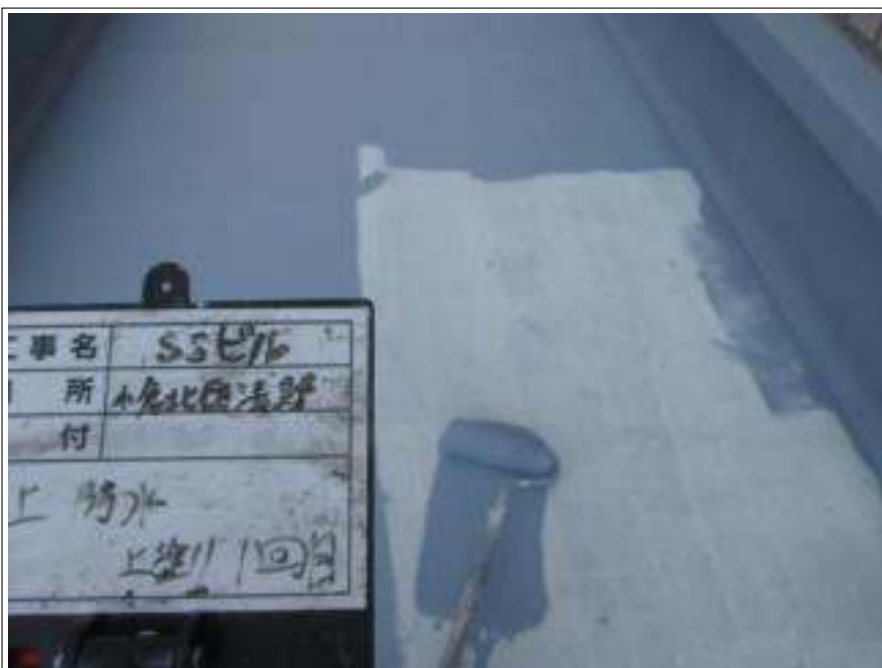
屋上防水部 中塗り施工中
