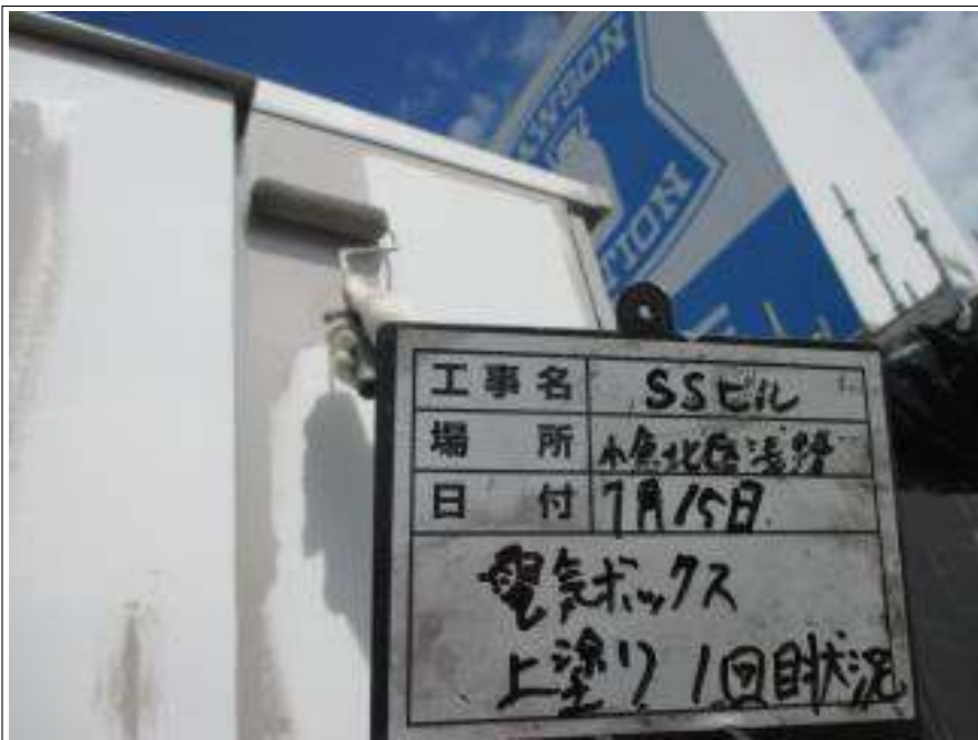
電気BOX 上塗り（1回目）施工中
