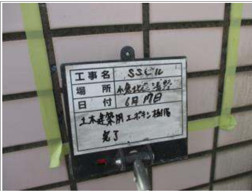
タイル部 エポキシ樹脂注入 施工後
