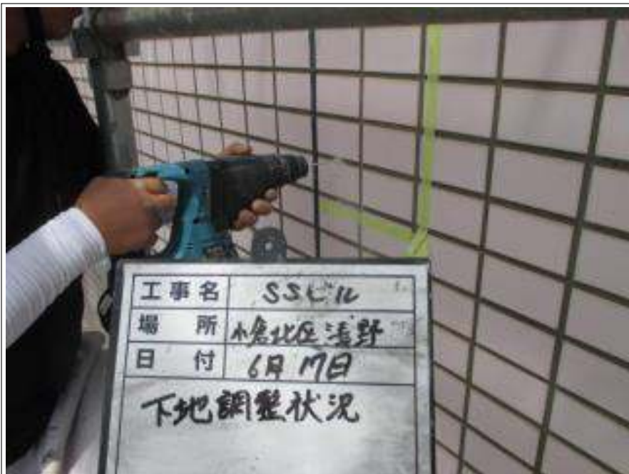
タイル部 下地調整施工中
