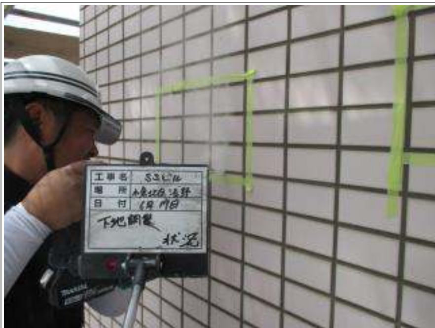
タイル部 下地調整施工中
