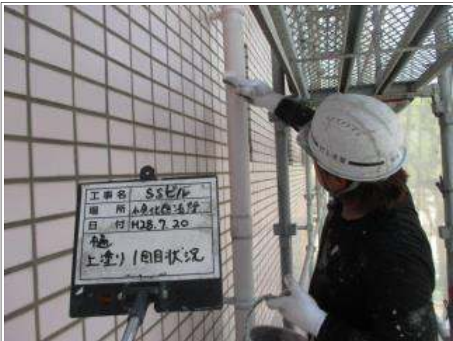
樋 上塗り（1回目）施工中
