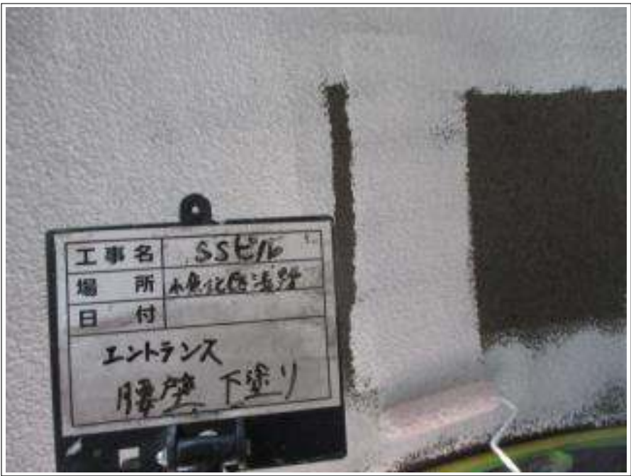
エントランス腰壁 下塗り施工中
