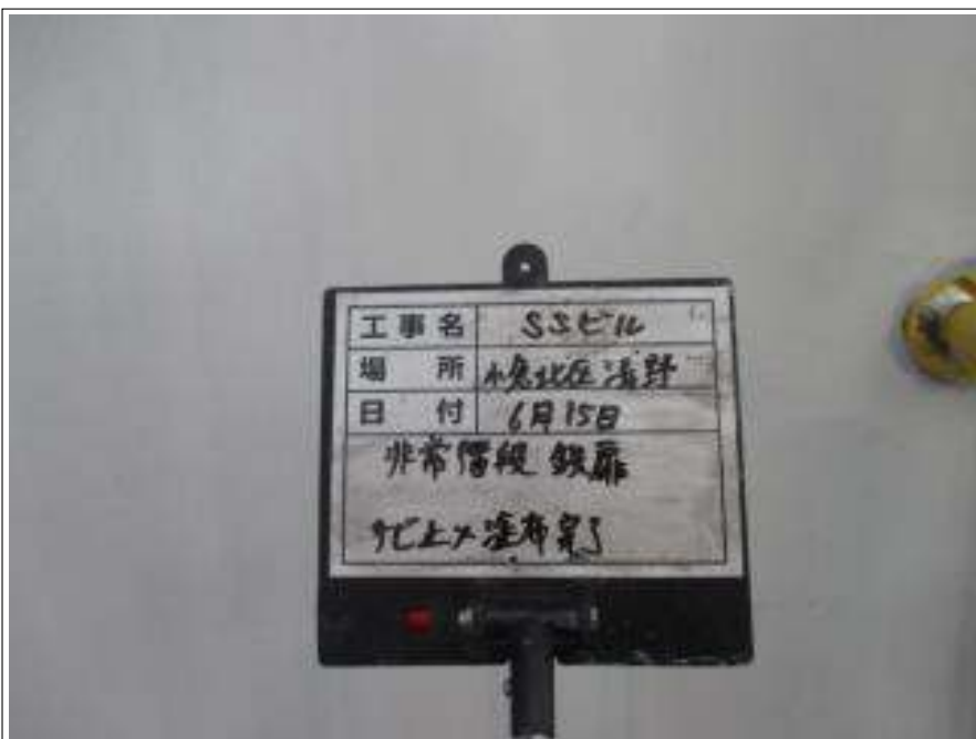
鉄扉 サビ止め塗布施工後
