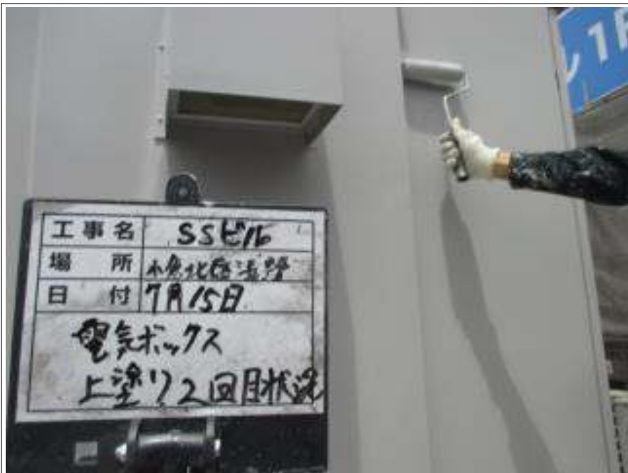
電気BOX 上塗り（2回目）施工中
