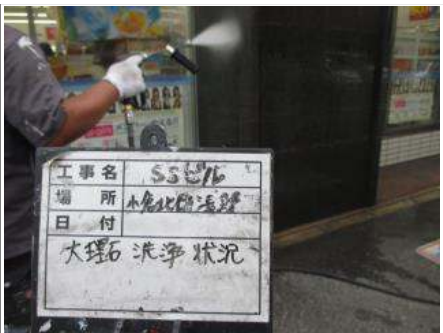
大理石部 高压洗浄中
