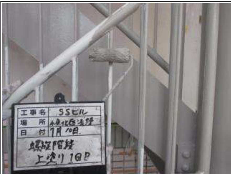
螺旋階段 上塗り（1回目）施工中
