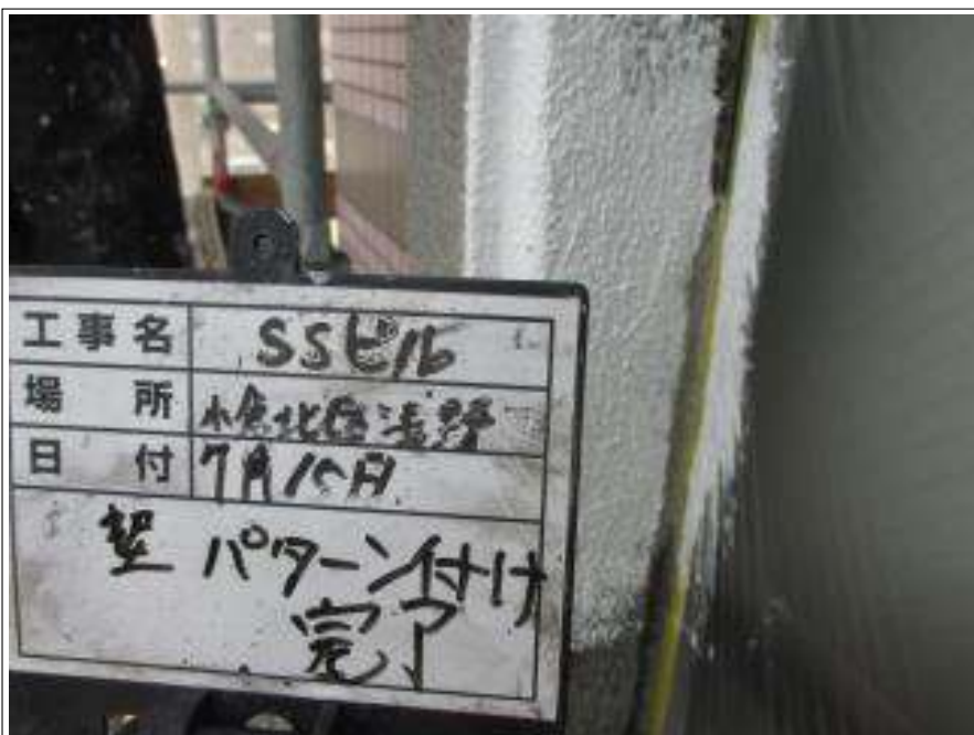
外壁 パターン付け 施工後
