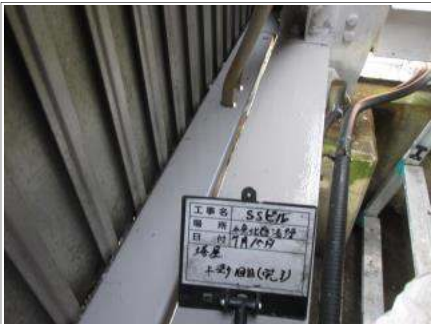
塔屋 上塗り（1回目）施工後
