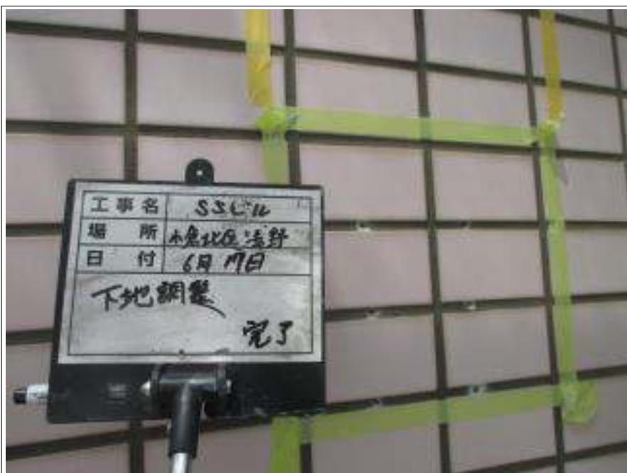
タイル部 下地調整施工後
