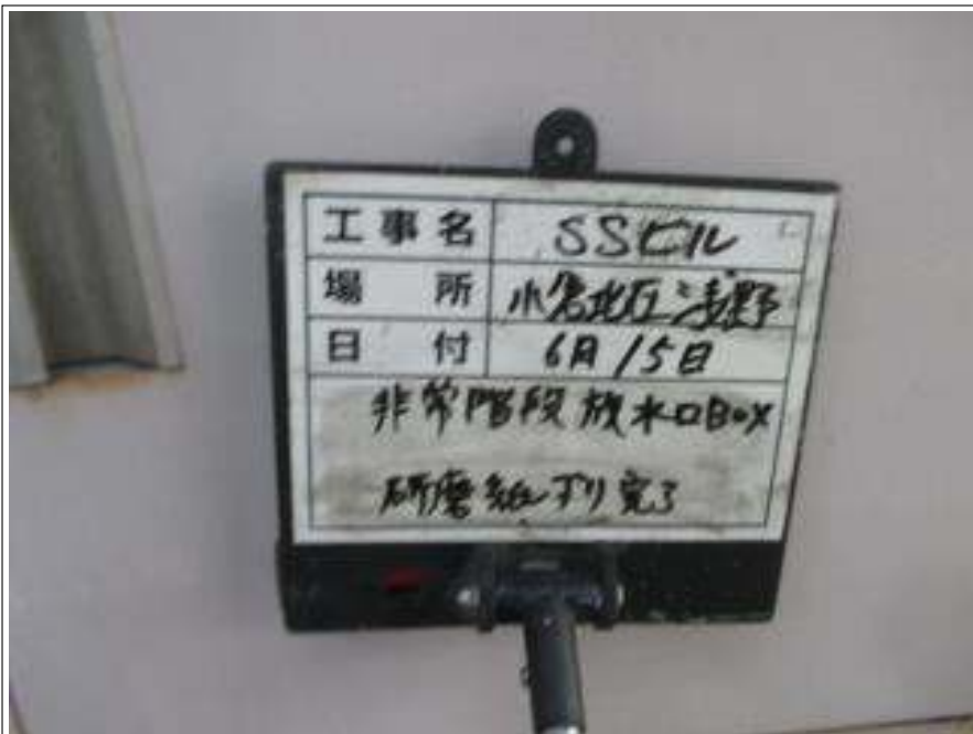
放水口BOX 研磨紙ずり施工後
