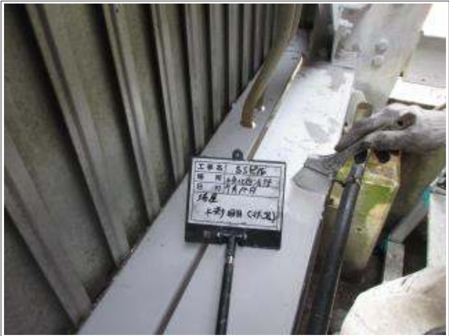
塔屋 上塗り（1回目）施工中
