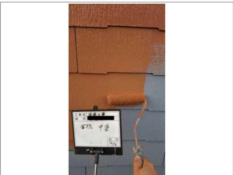
屋根 中塗り施工中
