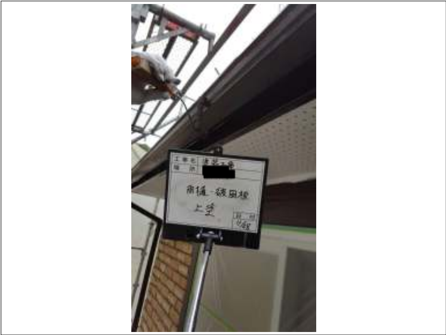
破風板・樋 上塗り施工中
