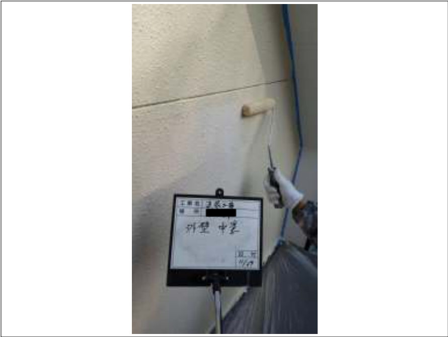
外壁 中塗り施工中
