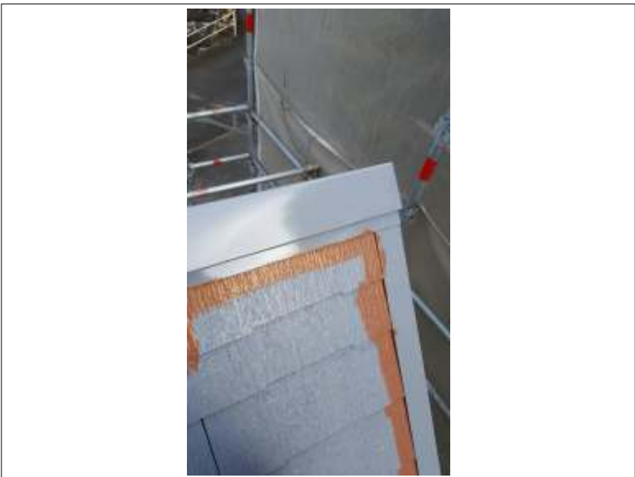
屋根 中塗り施工中
