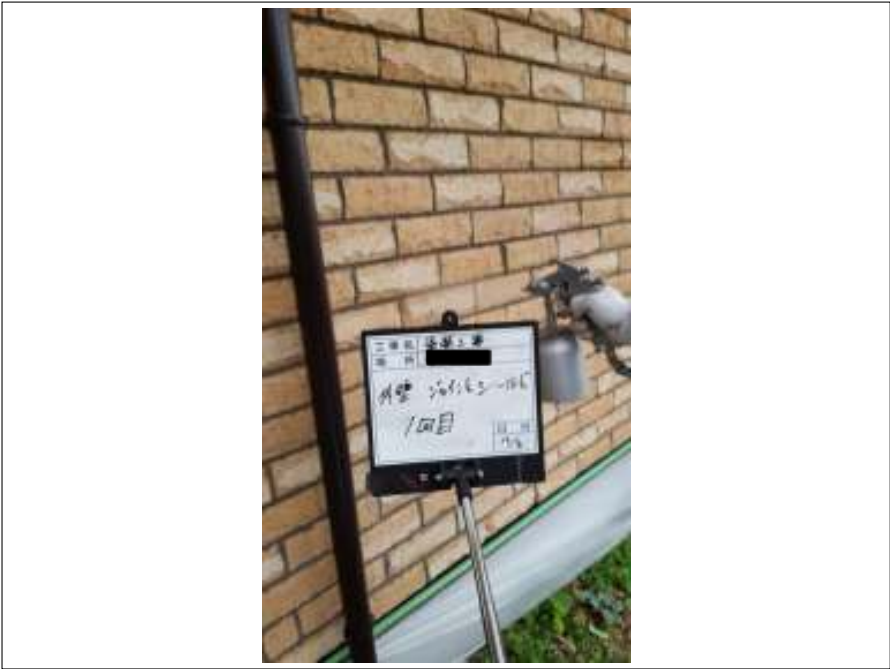
外壁 上塗り（1回目）施工中
