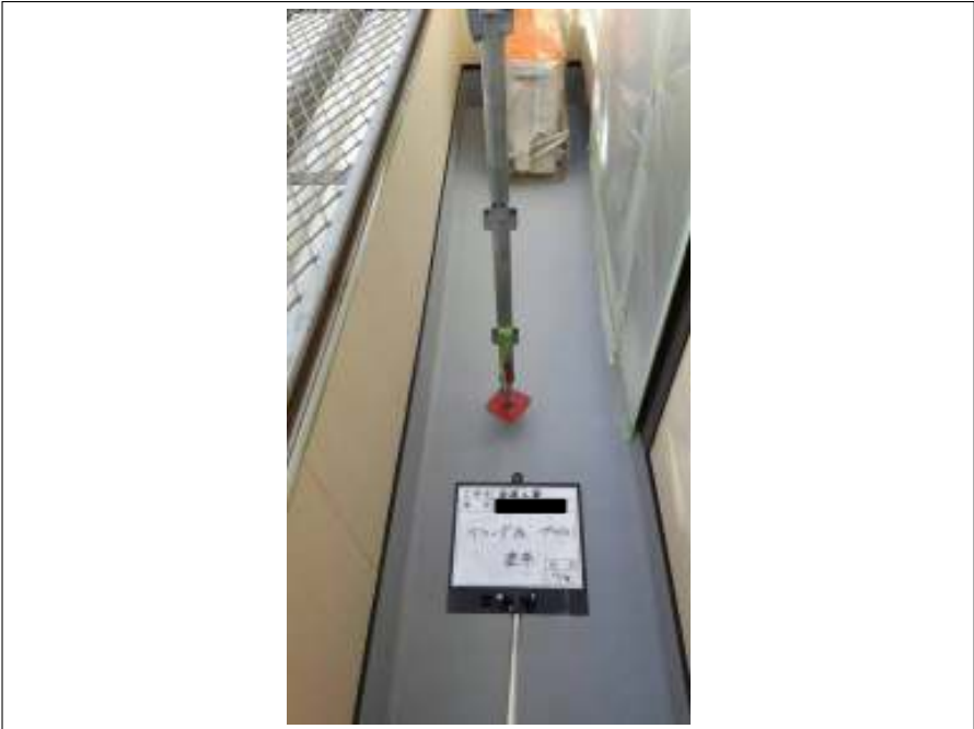
ベランダ 下塗り施工中
