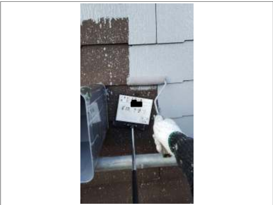
屋根 下塗り施工中
