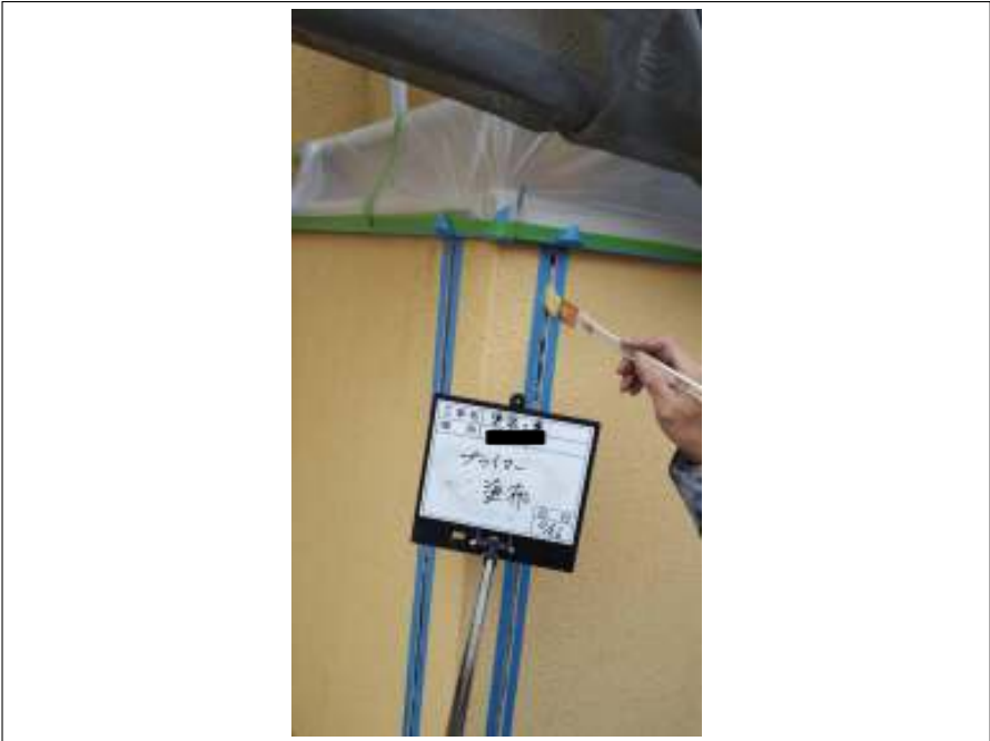
プライマー塗布
