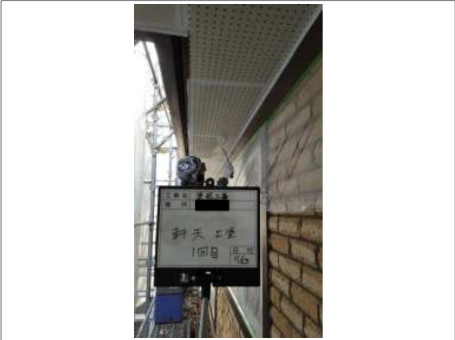
軒天 上塗り（1回目）施工中
