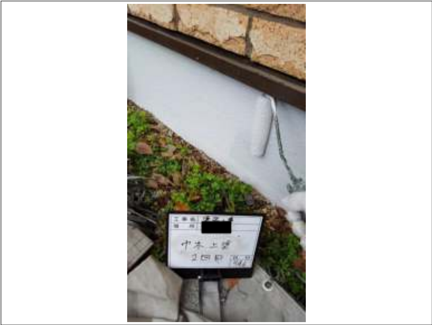
基礎 上塗り（2回目）施工中
