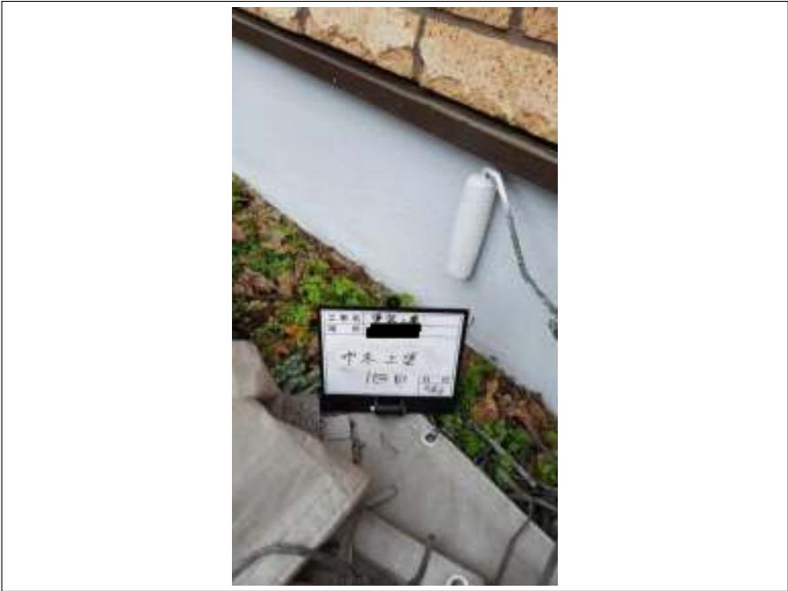
基礎 上塗り（1回目）施工中
