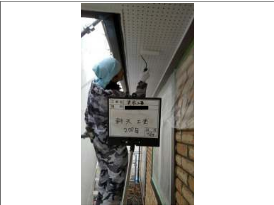
軒天 上塗り（2回目）施工中
