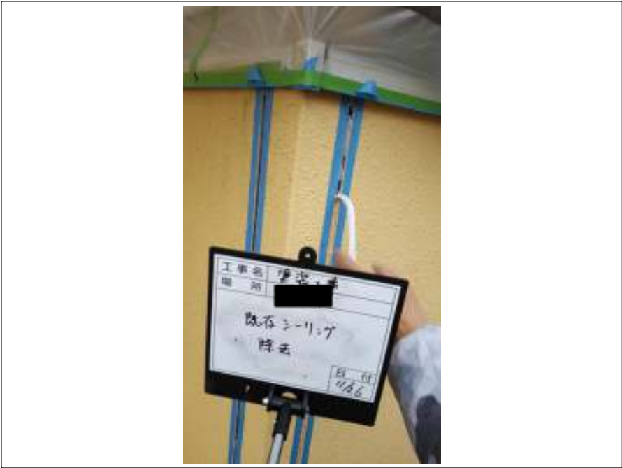
既存シーリング撤去
