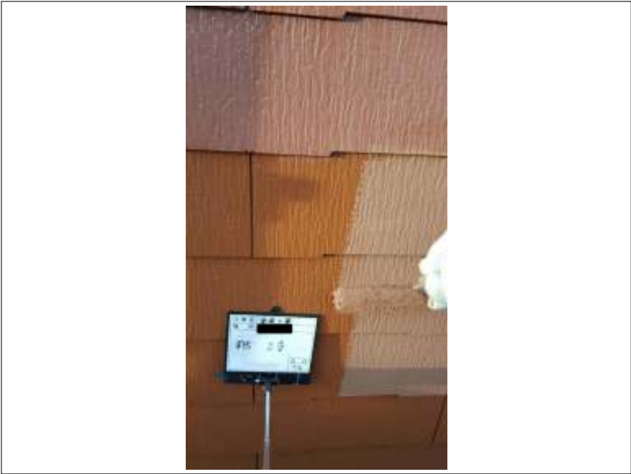
屋根 上塗り施工中
