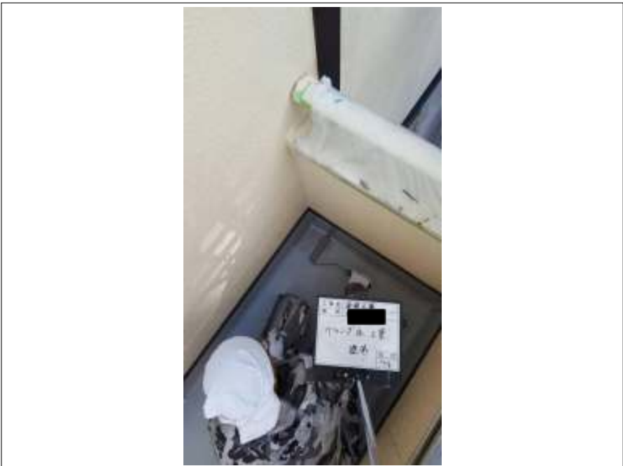
ベランダ 上塗り施工中
