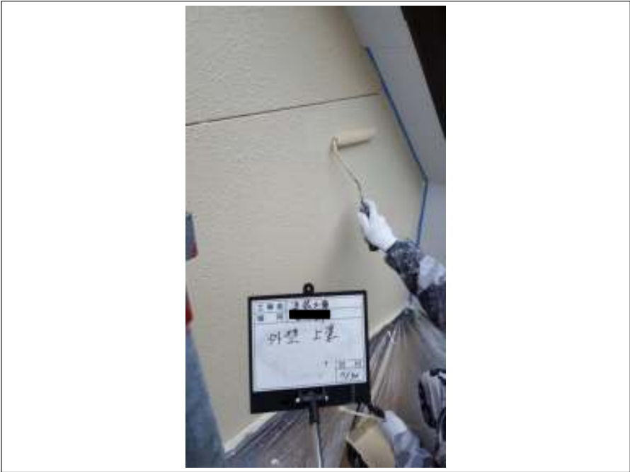
外壁 上塗り施工中
