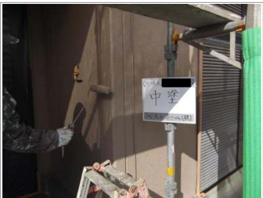
外壁 中塗り施工中
