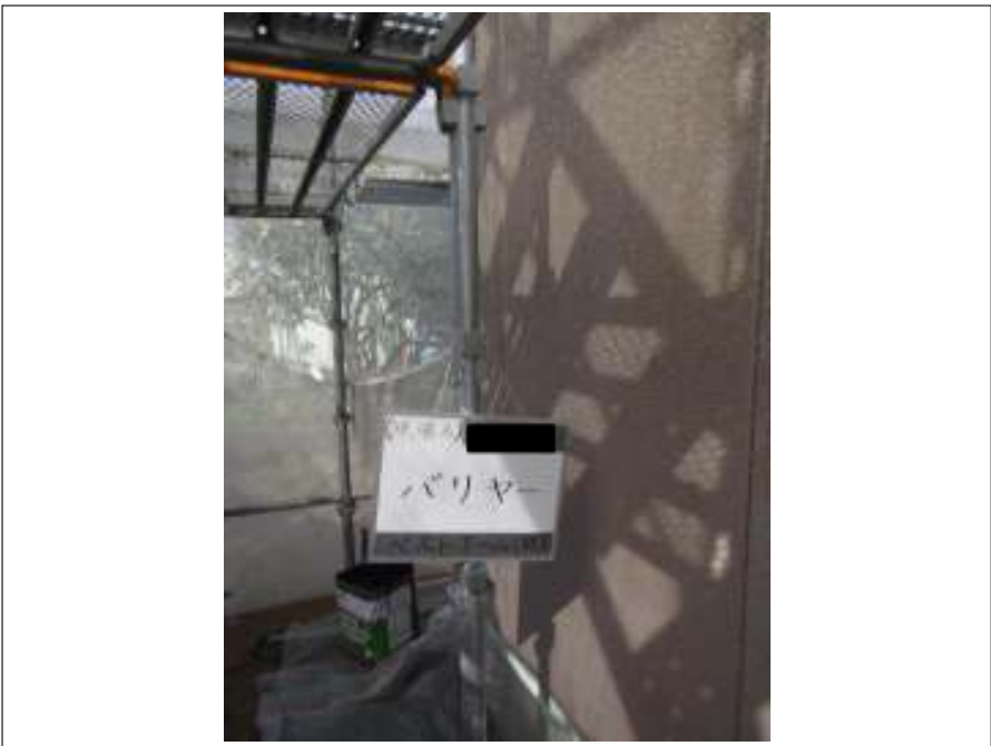
外壁 バリヤー塗布施工中
