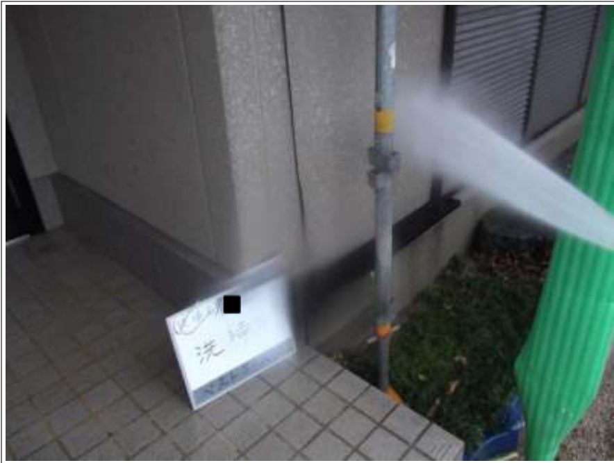
外壁 高圧洗浄中
