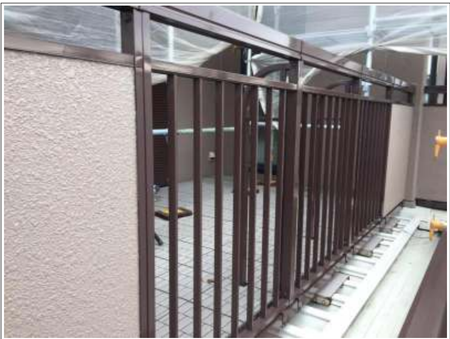
ベランダ手摺 施工完了
