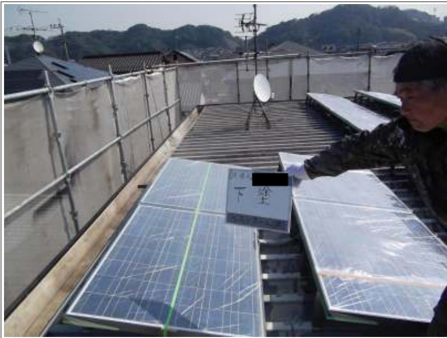
屋根 下塗り施工中
