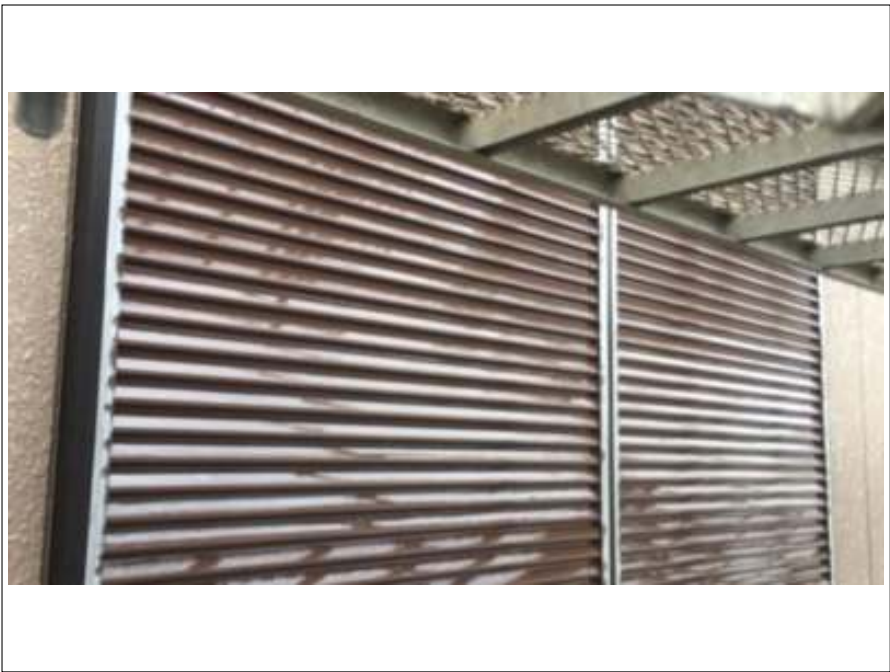
雨戸 施工完了
