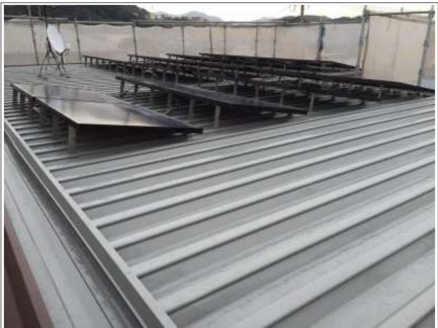
屋根 施工完了
