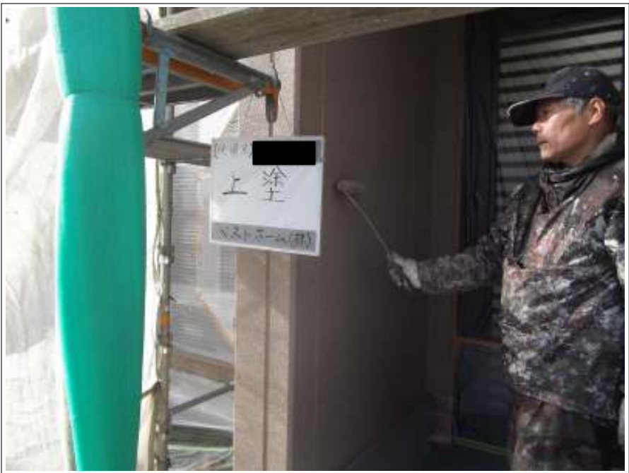
外壁 上塗り施工中
