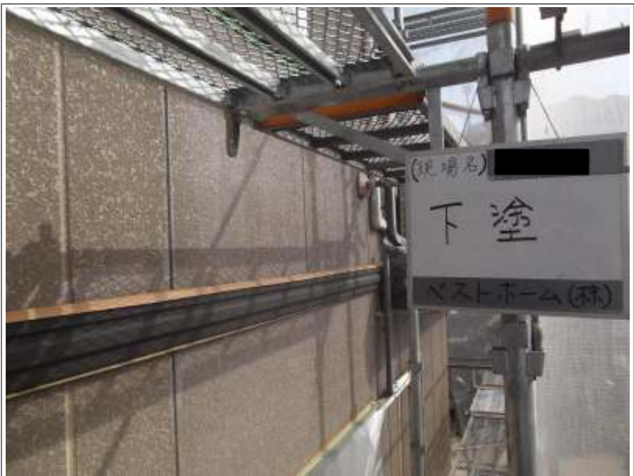
外壁 下塗り施工中
