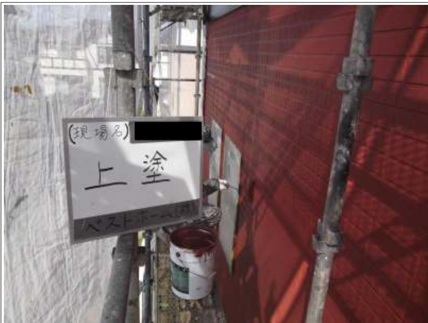
外壁 上塗り施工中
