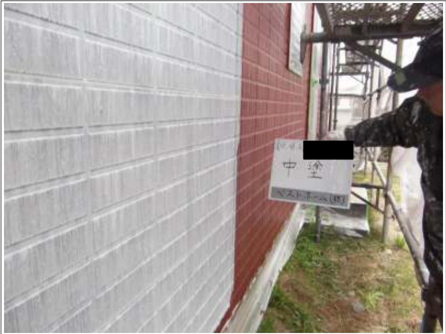
外壁 中塗り施工中
