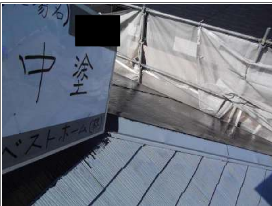
屋根 中塗り施工後
