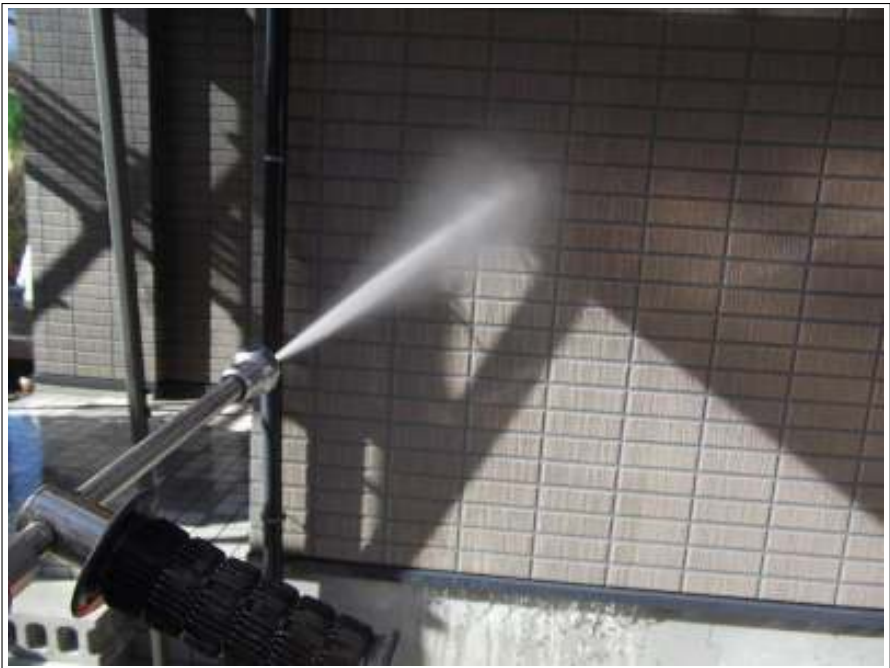
外壁 高圧洗浄中
