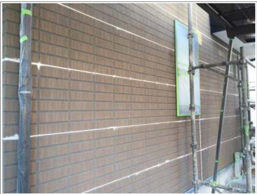
シーリング打ち替え施工完了
