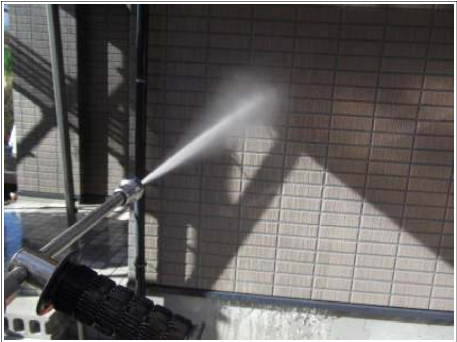
外壁 高圧洗浄中
