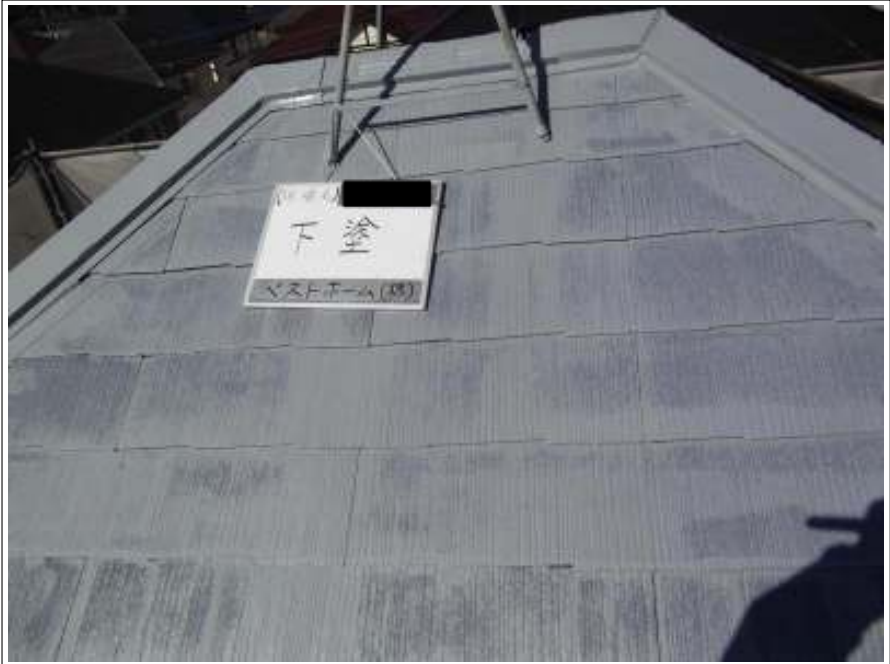
屋根 下塗り施工中
