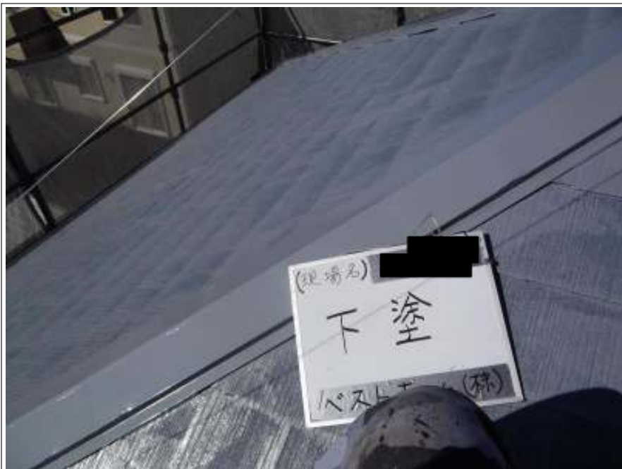
屋根 下塗り施工後
