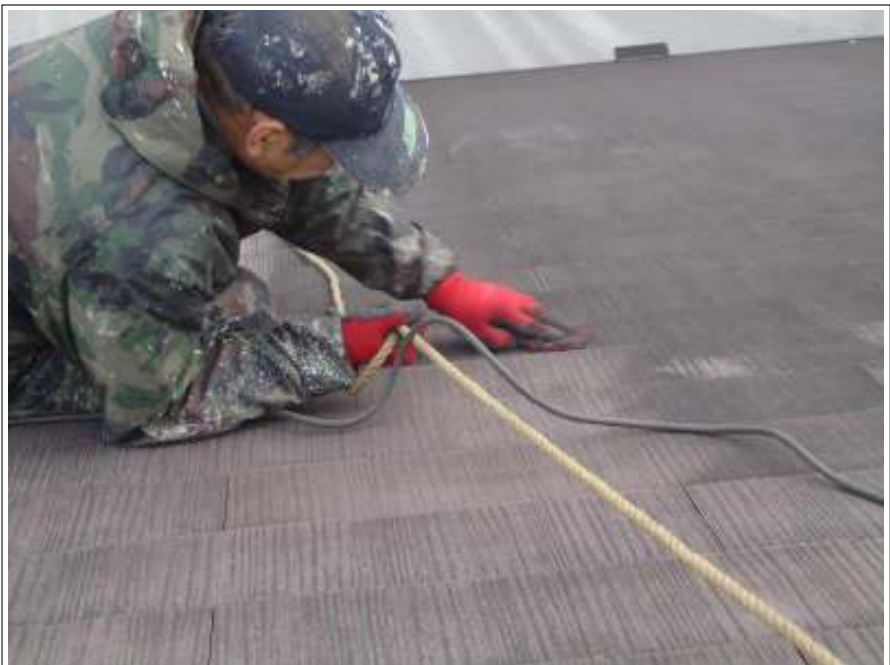
屋根 ケレン施工中
