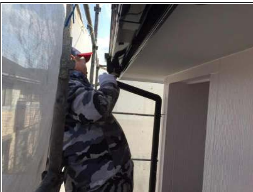
樋・破風板 上塗り施工中
