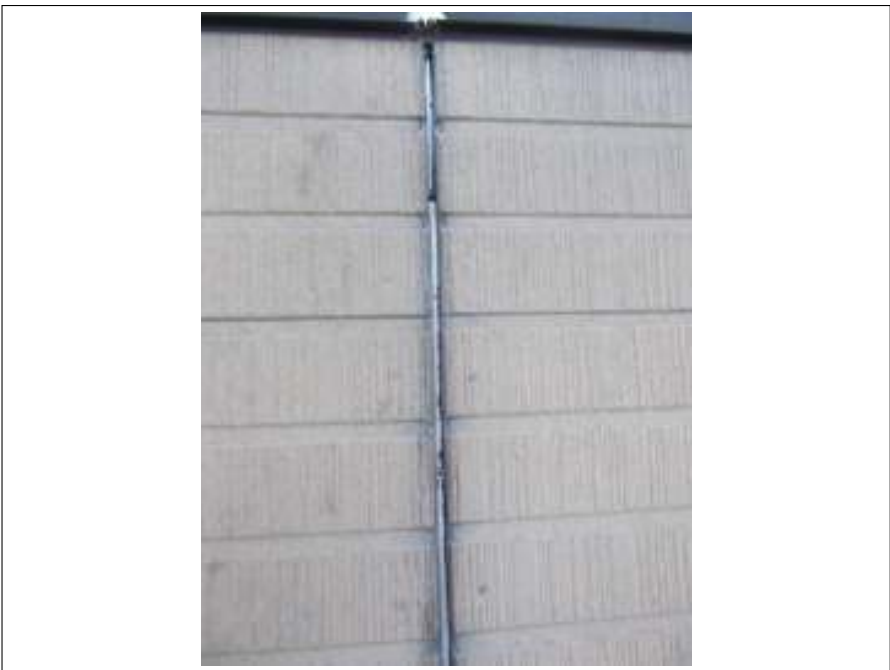
シーリング打ち替え施工中
