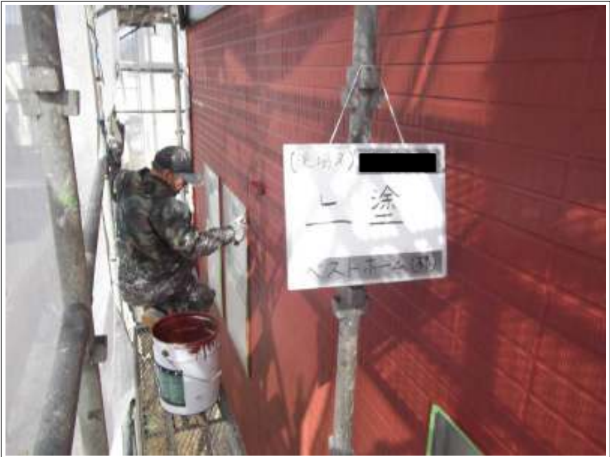
外壁 上塗り施工中
