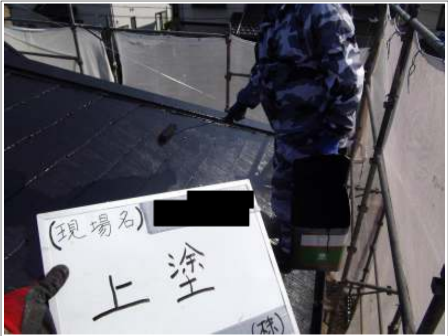
屋根 上塗り施工中
