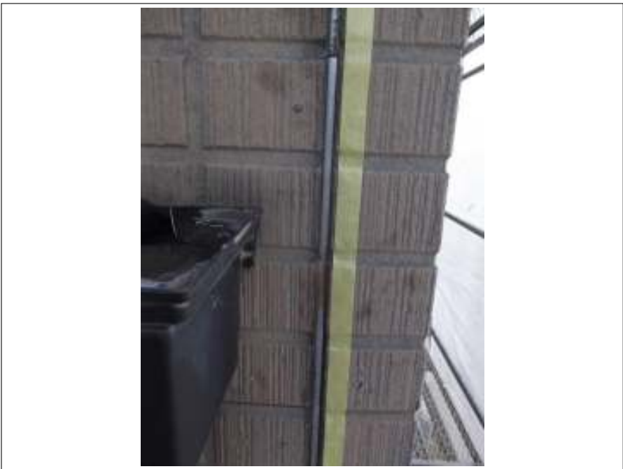
シーリング打ち替え施工中
