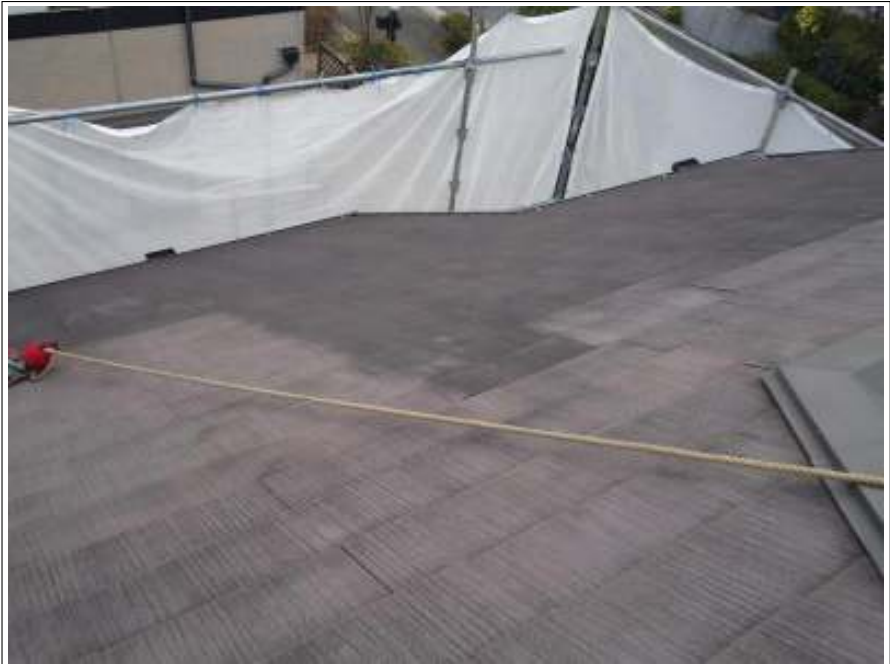
屋根 ケレン施工中
