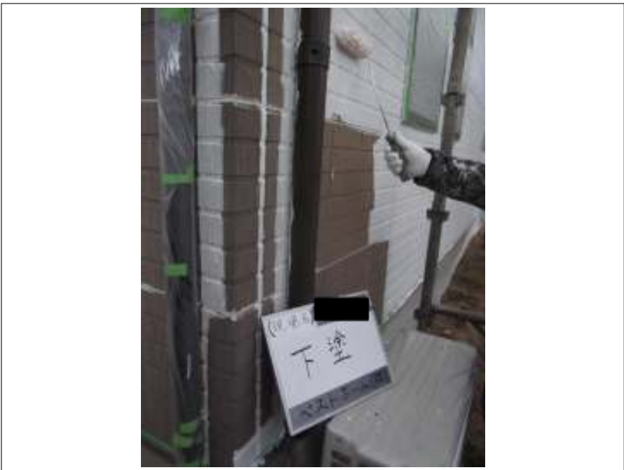
外壁 下塗り施工中
