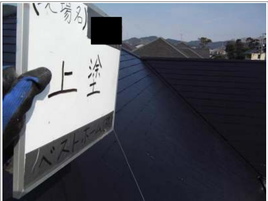
屋根 上塗り施工後
