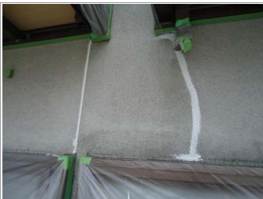
外壁 クラック補修施工後
