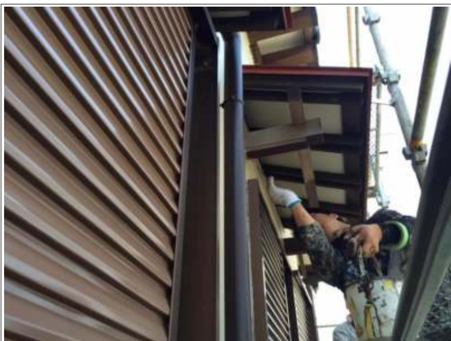
木部塗装 施工中
