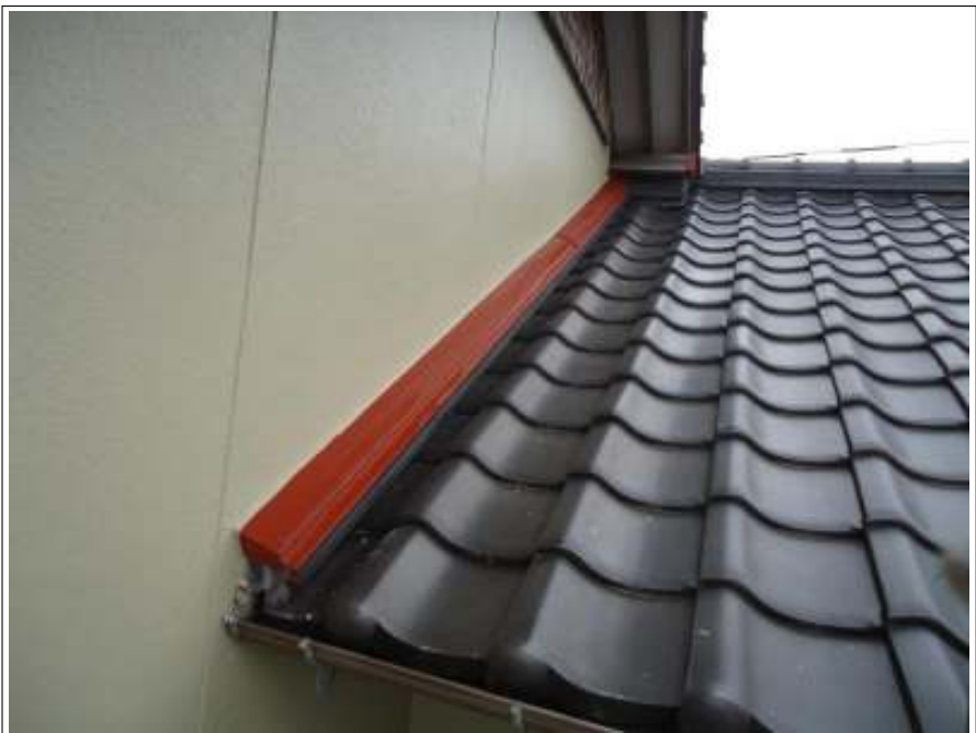
鉄部 サビ止め塗布施工後
