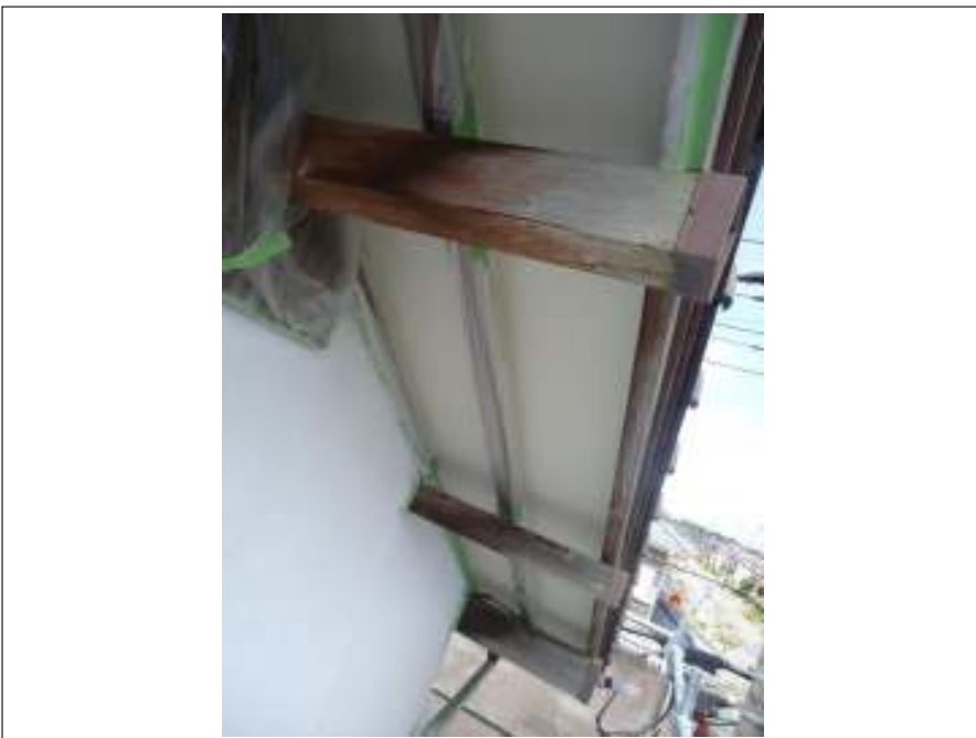
軒天 上塗り（2回目）施工後
