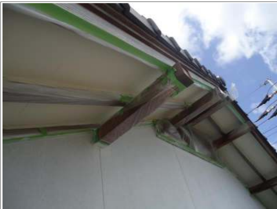
軒天 上塗り（1回目）施工後
