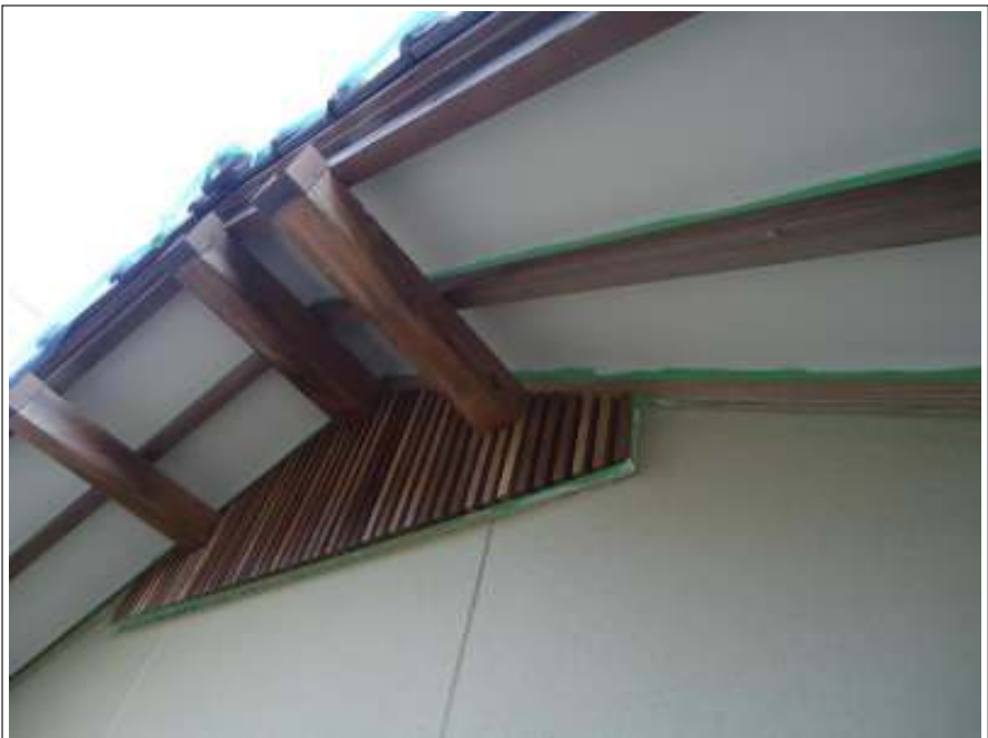
軒天 施工完了
