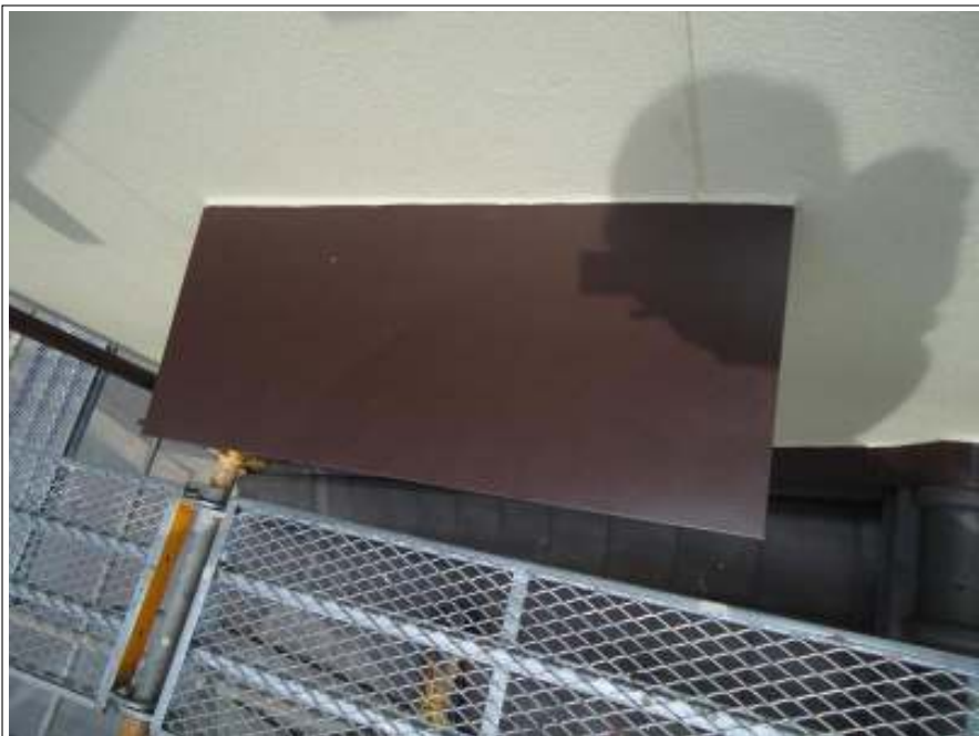
小庇 施工完了
