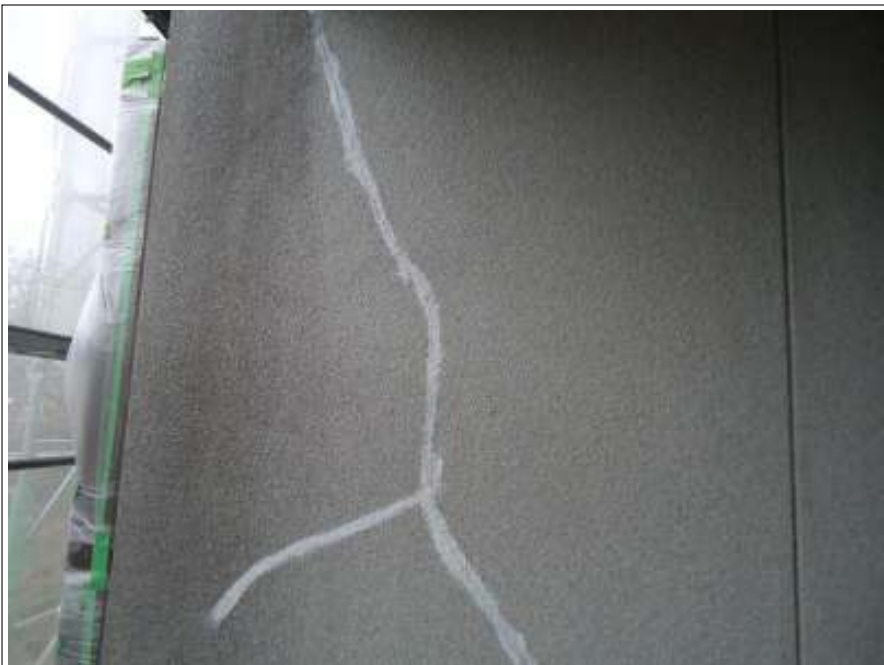
外壁 クラック補修施工後
