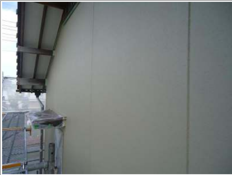
外壁 上塗り施工後
