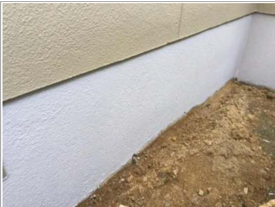
基礎 施工完了
