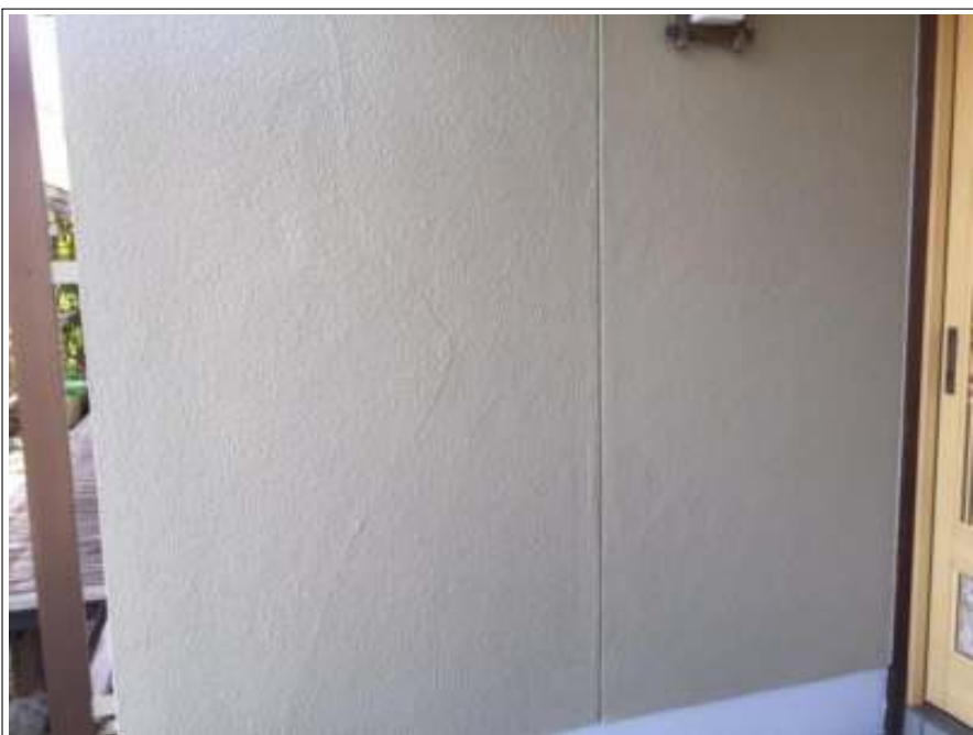
外壁 上塗り施工後
