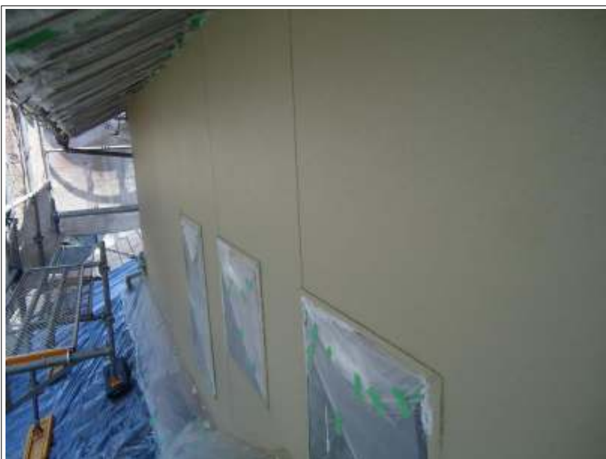
外壁 中塗り施工後
