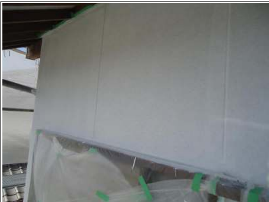
外壁 下塗り施工後
