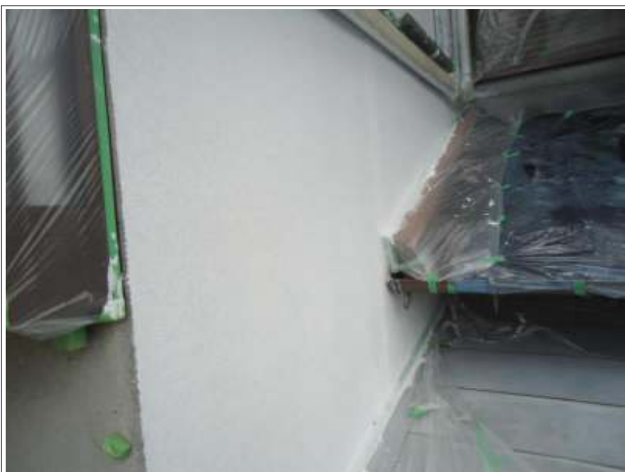
外壁 下塗り施工後
