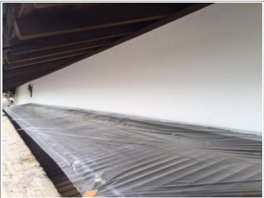
外壁 塗装 施工後
