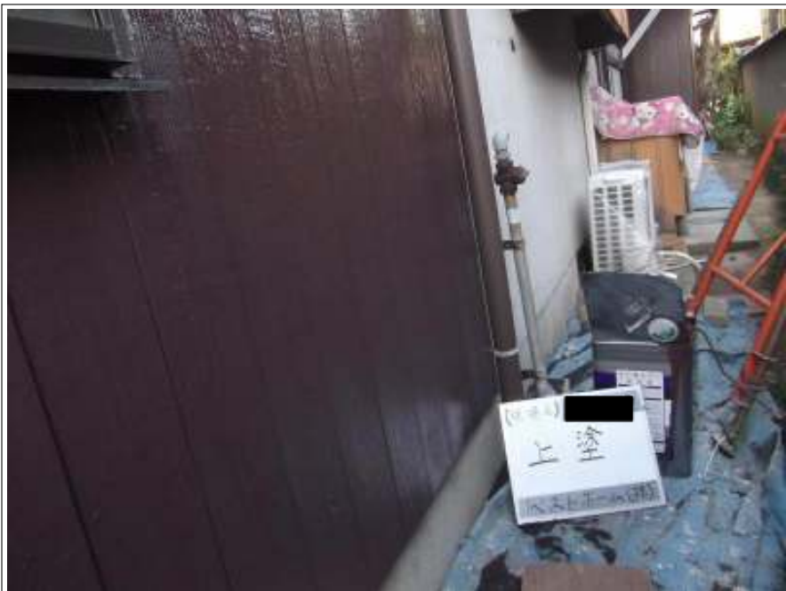
外壁 塗装 施工中
