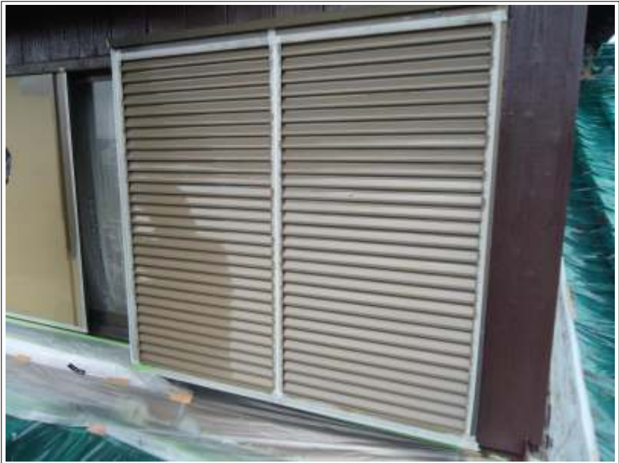
シャッター 施工後
