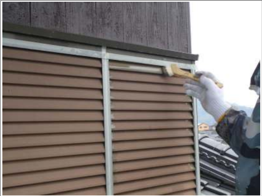
シャッター 上塗り施工中
