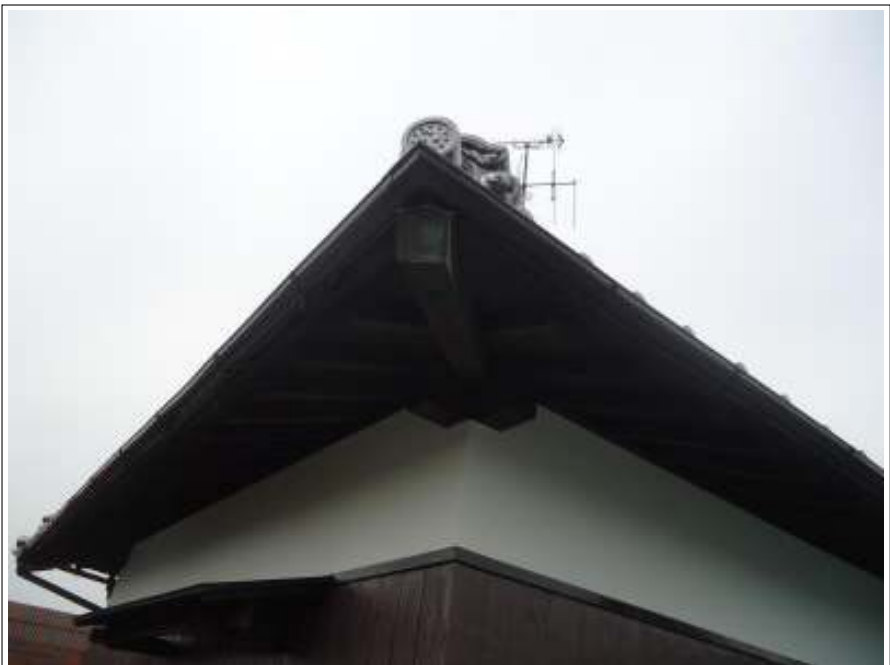
樋・木部 施工後
