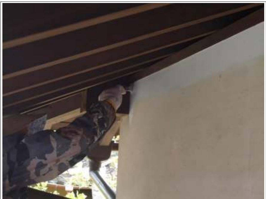
外壁 塗装 施工中
