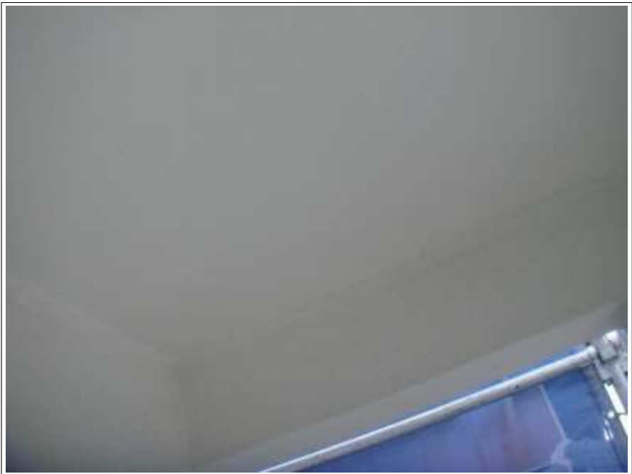
軒天 上塗り（1回目）施工後
