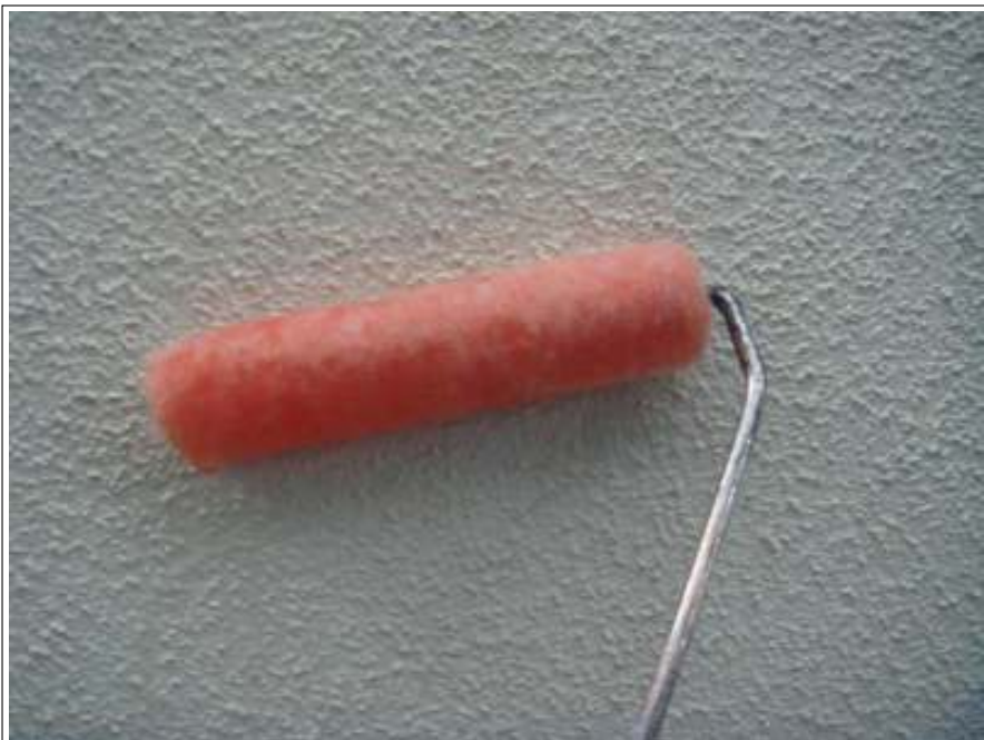
外壁 下塗り施工中
