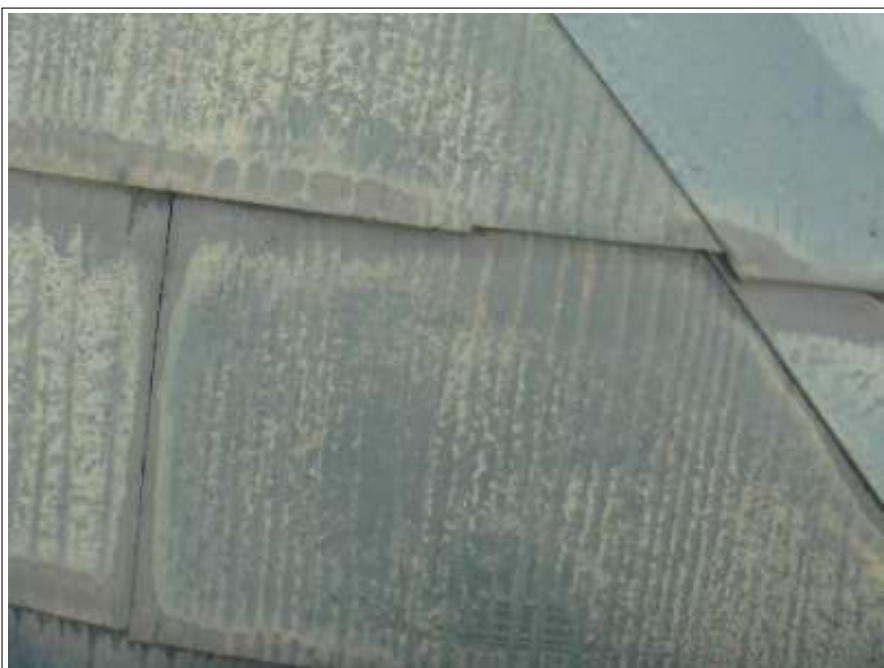
屋根 ケレン処理施工後
