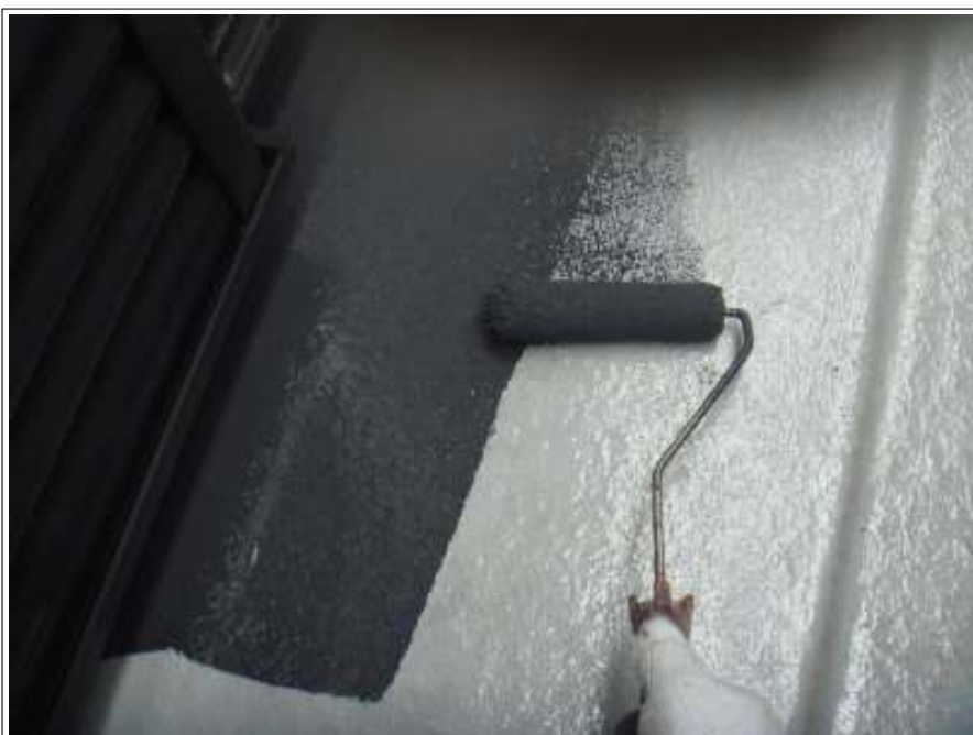
ベランダ 中塗り施工後
