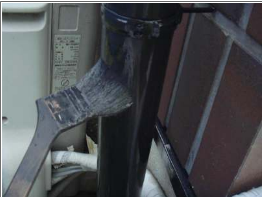
樋 上塗り施工中
