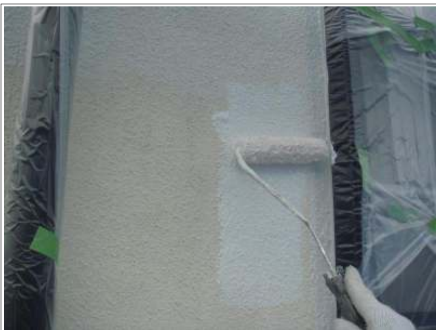
外壁 下塗り施工中
