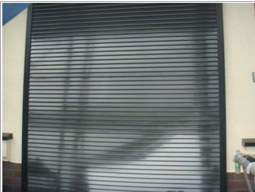
シャッター 施工後
