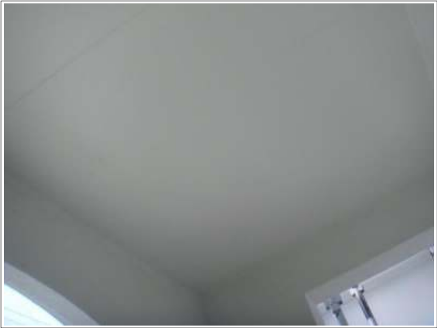
軒天 上塗り（2回目）施工後
