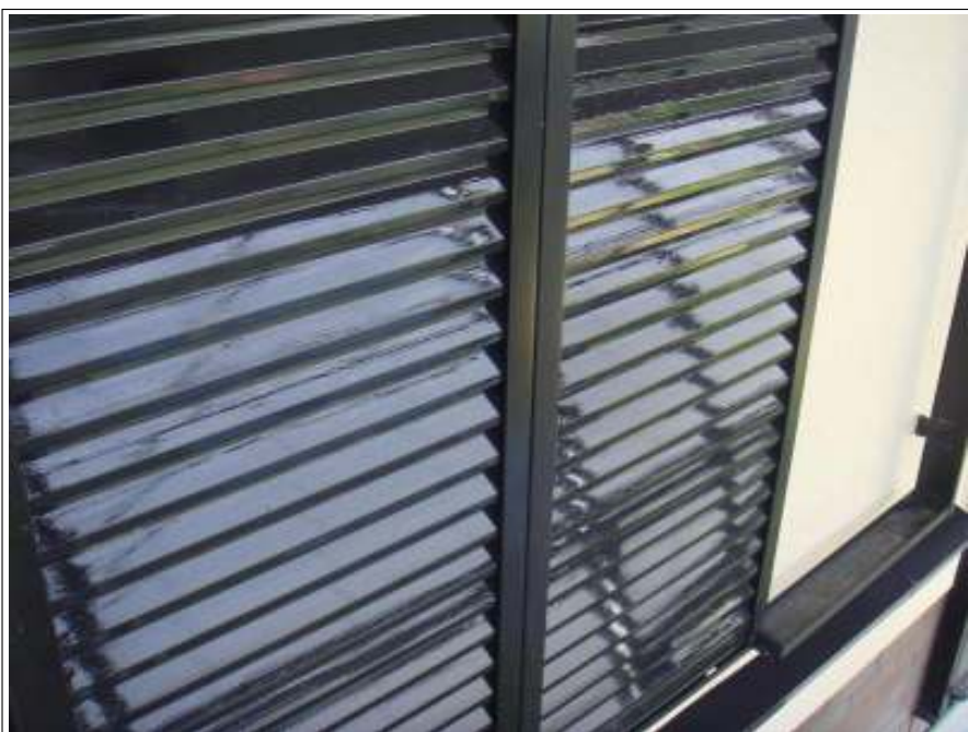
シャッター 上塗り（1回目）施工後
