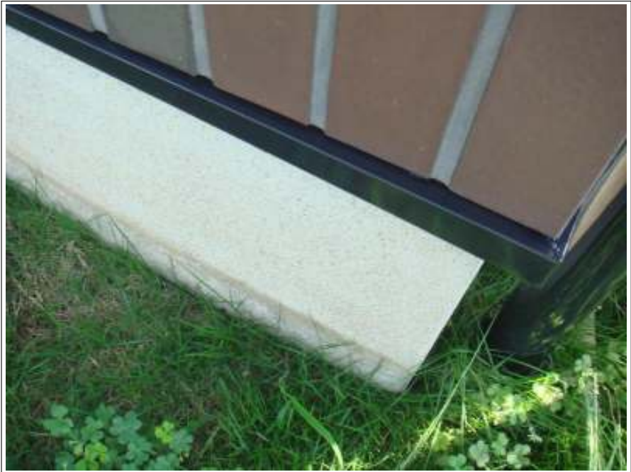
土台水切り 施工後
