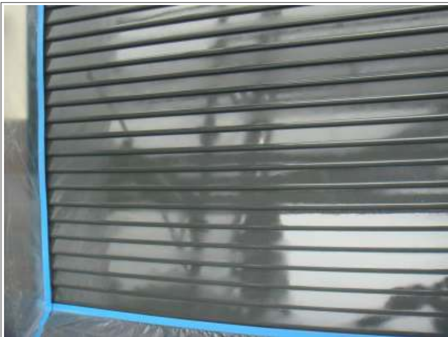
シャッター 上塗り（2回目）施工後
