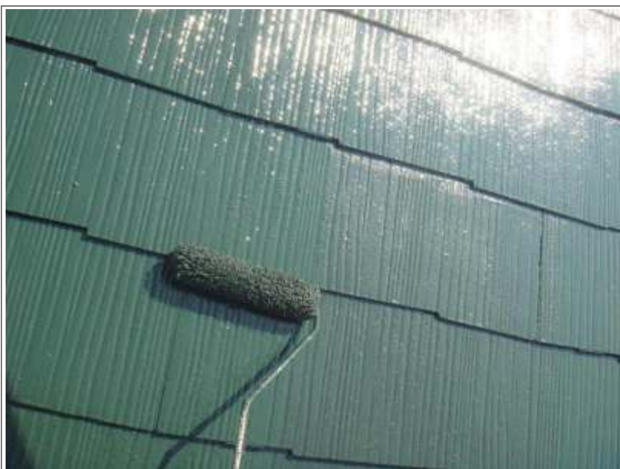
屋根 上塗り施工中
