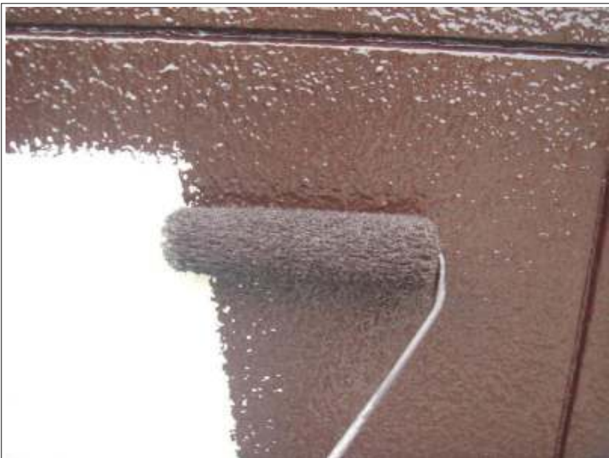
塀 上塗り（1回目）施工中
