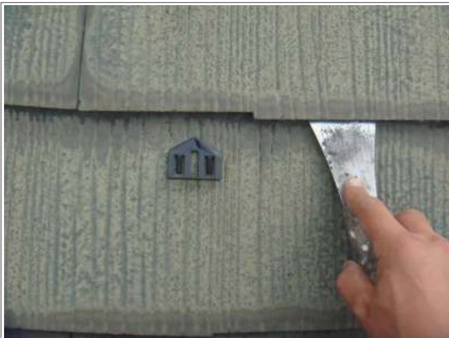
屋根 タスペーサー取付施工中
