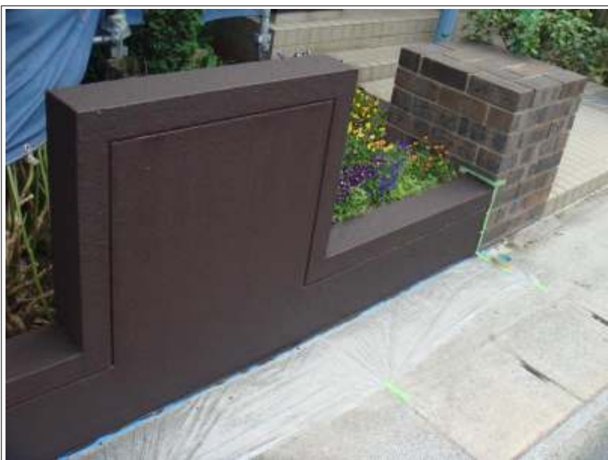
塀 上塗り（1回目）施工後
