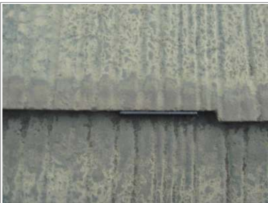
屋根 タスペーサー取付施工後
