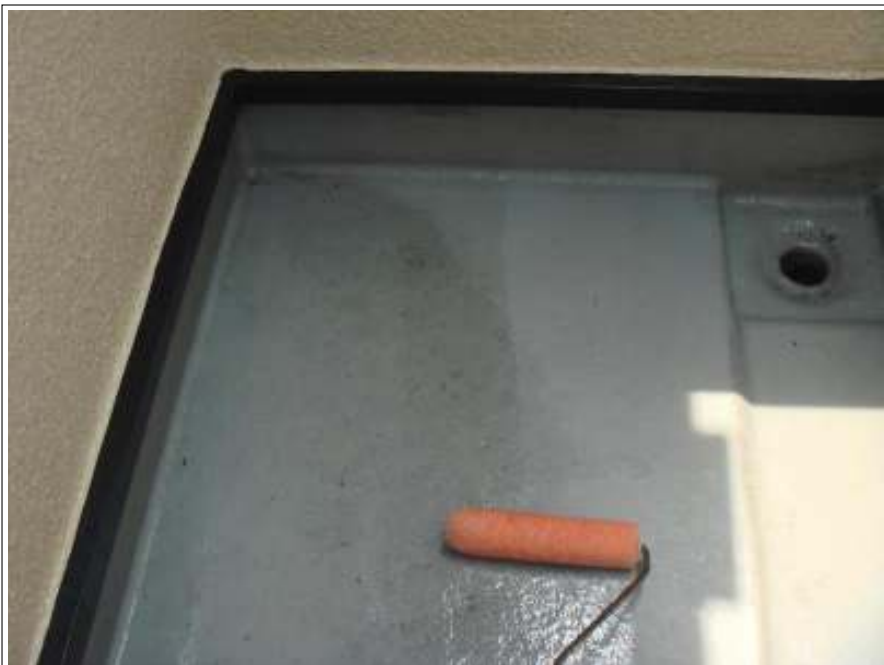
ベランダ 下塗り施工中
