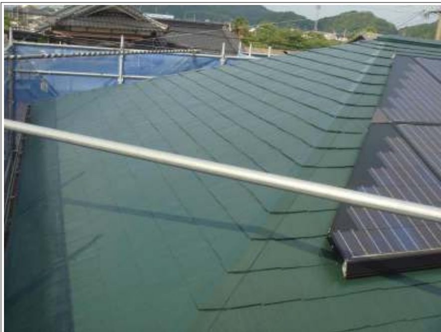
屋根 中塗り施工後
