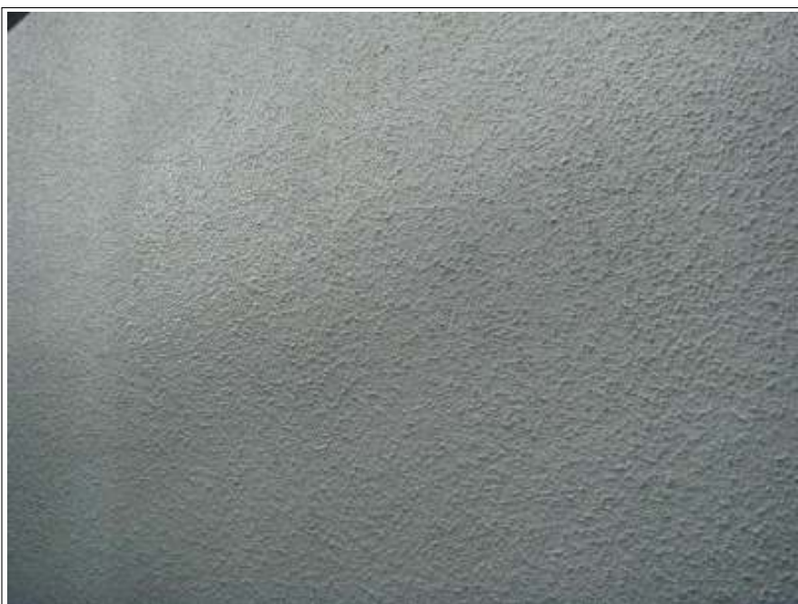
外壁 下塗り施工後
