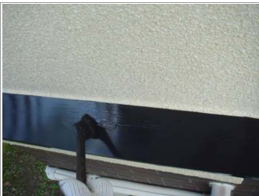
帯 上塗り施工中
