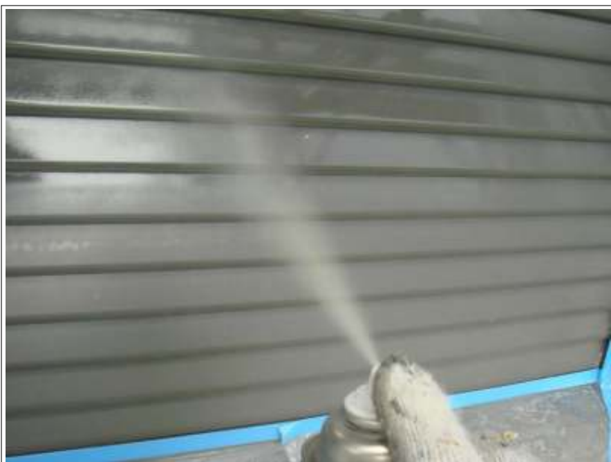
シャッター 上塗り（2回目）施工中
