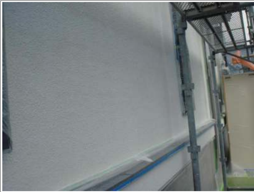
外壁 下塗り施工後
