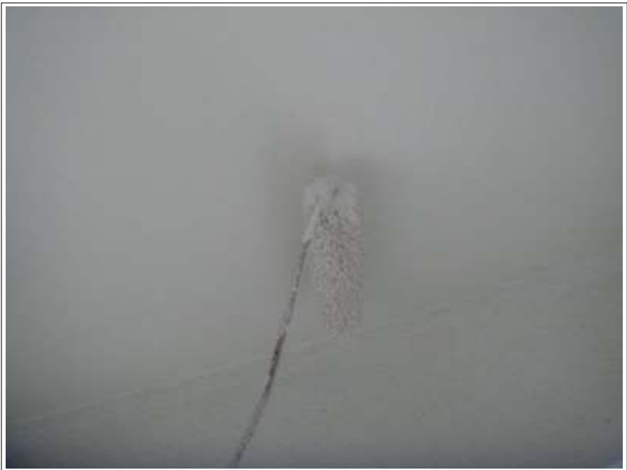
軒天 上塗り（2回目）施工中
