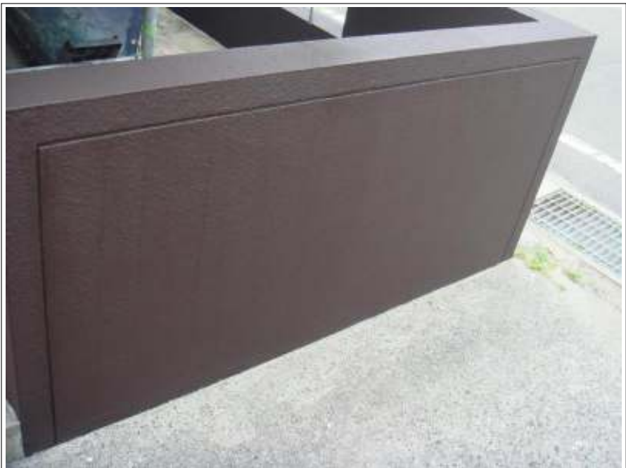
塀 上塗り（2回目）施工後
