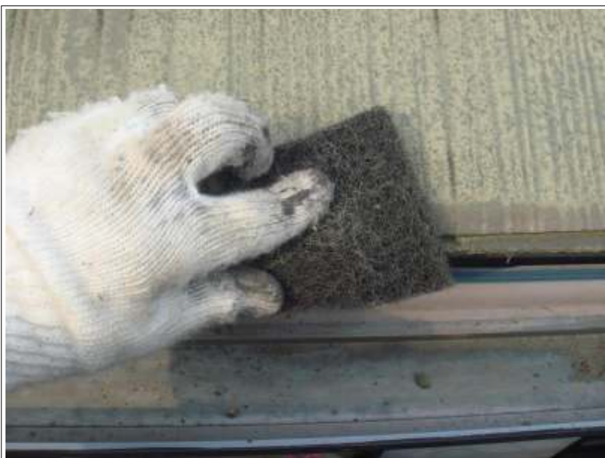
屋根 ケレン処理施工中
