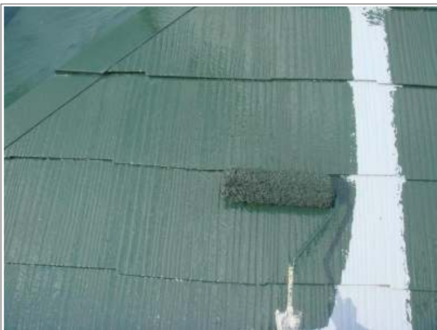
屋根 中塗り施工中
