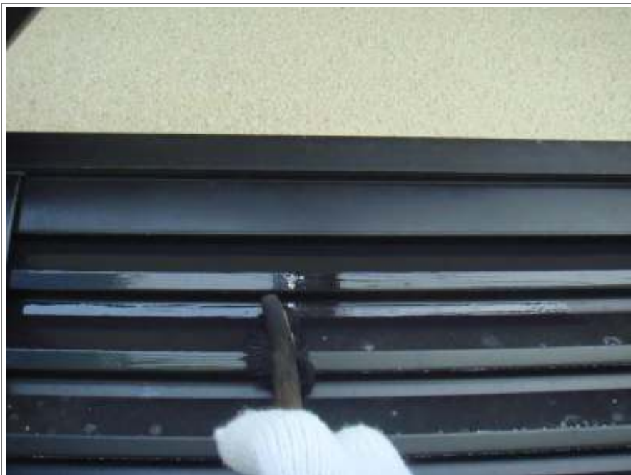
シャッター 上塗り（1回目）施工中
