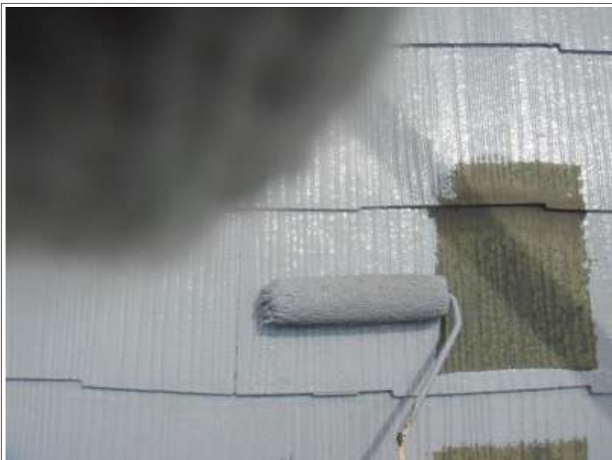
屋根 下塗り施工中
