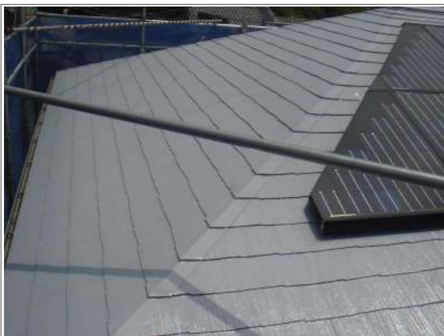
屋根 下塗り施工後
