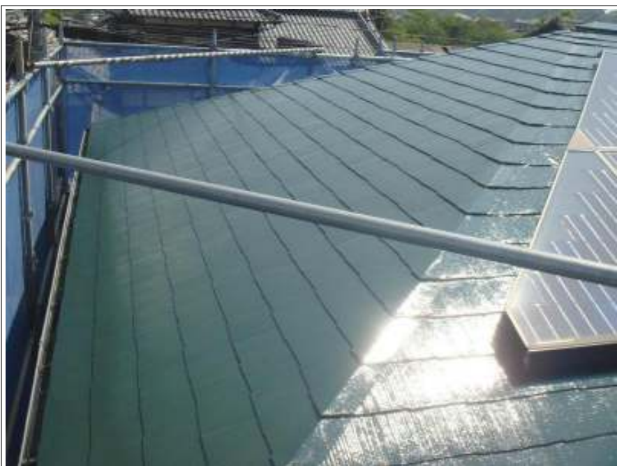
屋根 上塗り施工後
