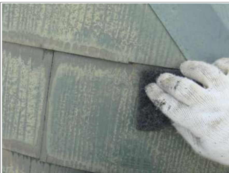
屋根 ケレン処理施工中
