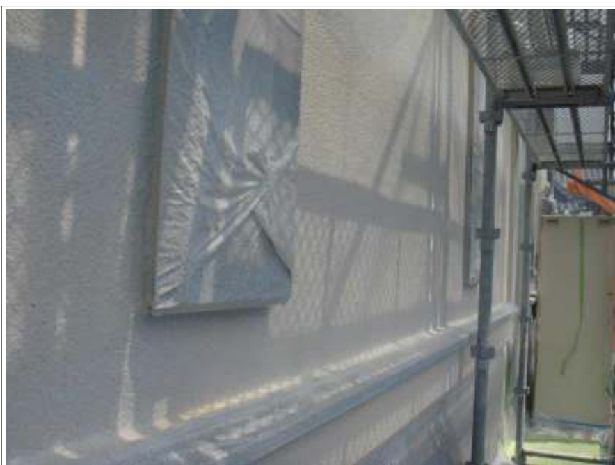
外壁 上塗り施工後
