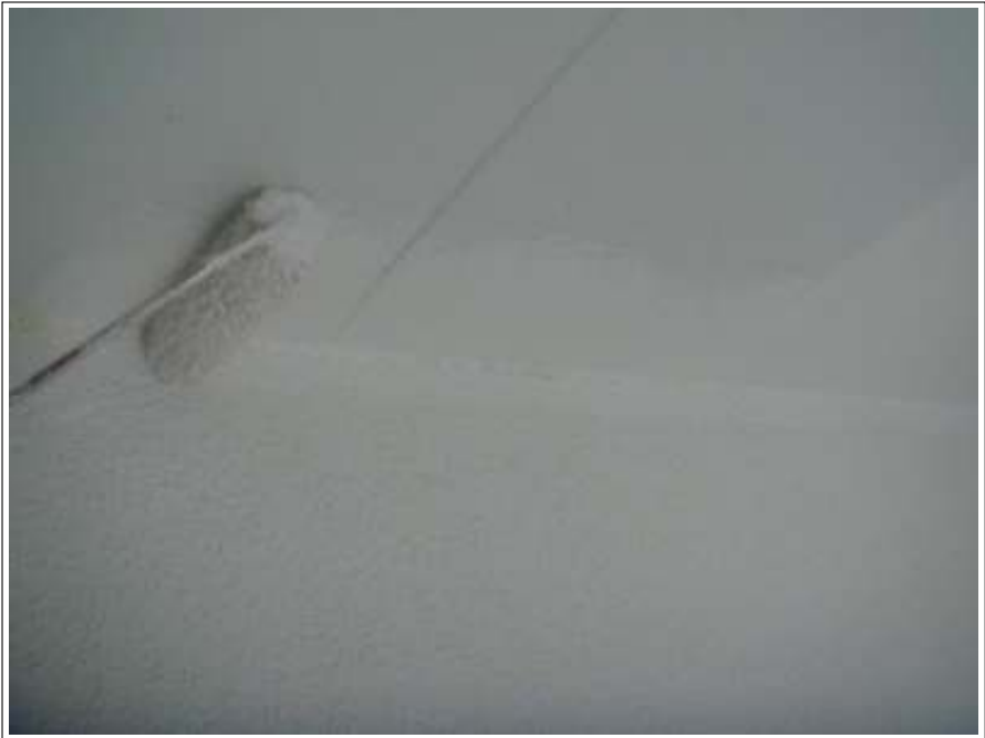
軒天 上塗り（1回目）施工中
