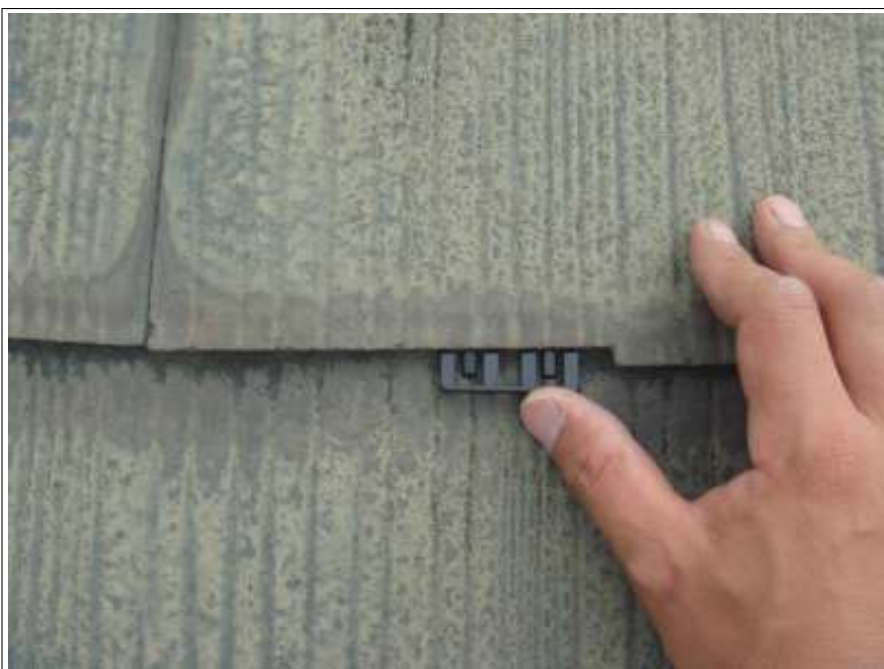
屋根 タスペーサー取付施工中
