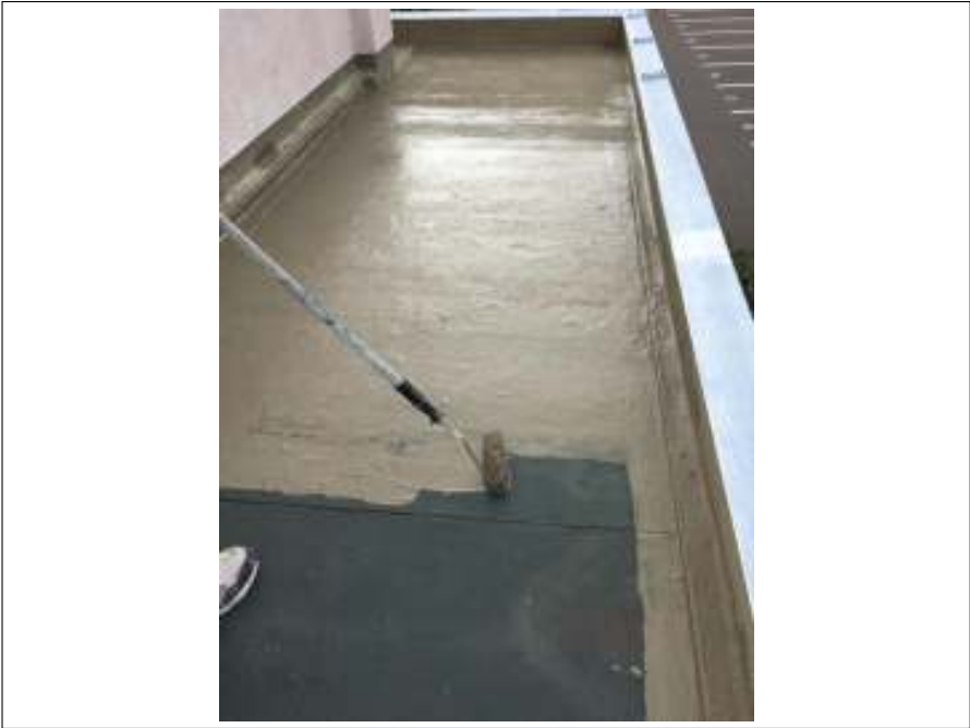
屋上 下地処理
