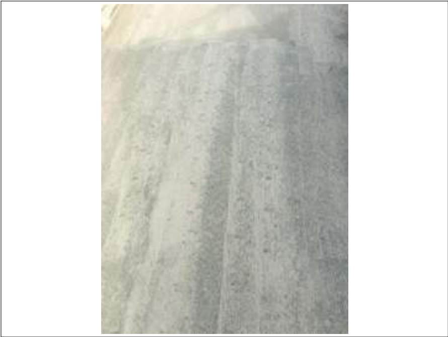
屋上 下地処理
