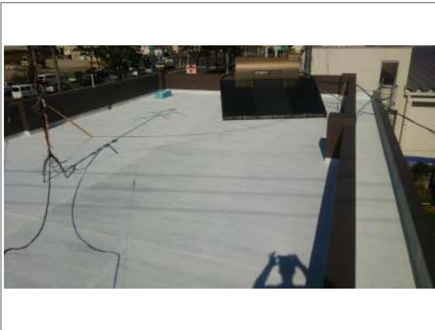
屋上 下塗り施工後
