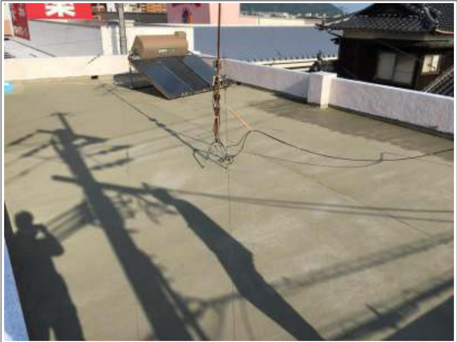
屋上 下地処理 完了
