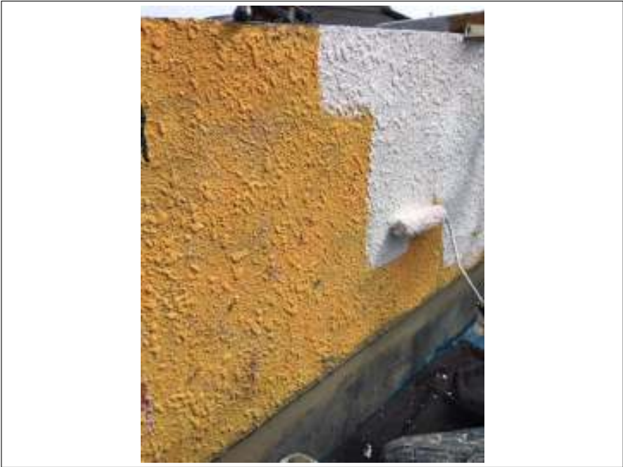
屋上外壁部 下塗り施工中
