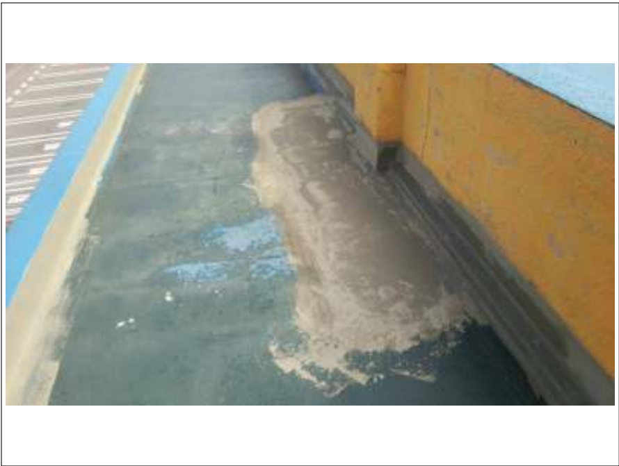
屋上 下地処理
