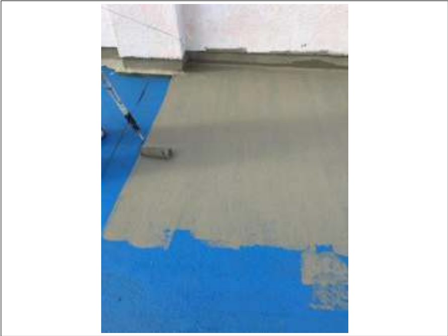
屋上 下地処理
