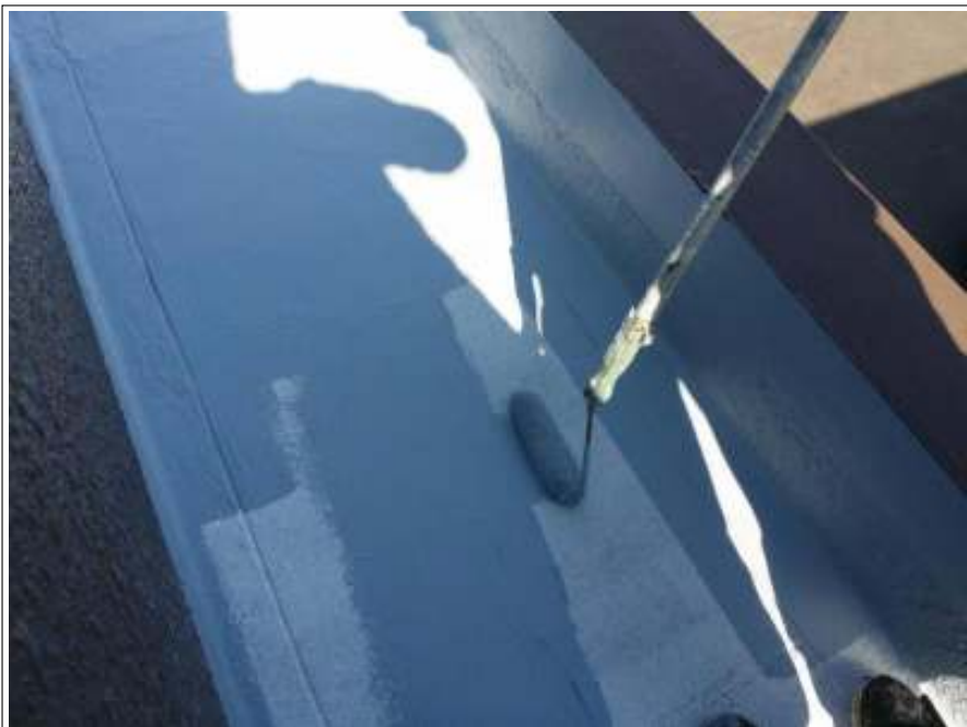
屋上 中塗り施工中
