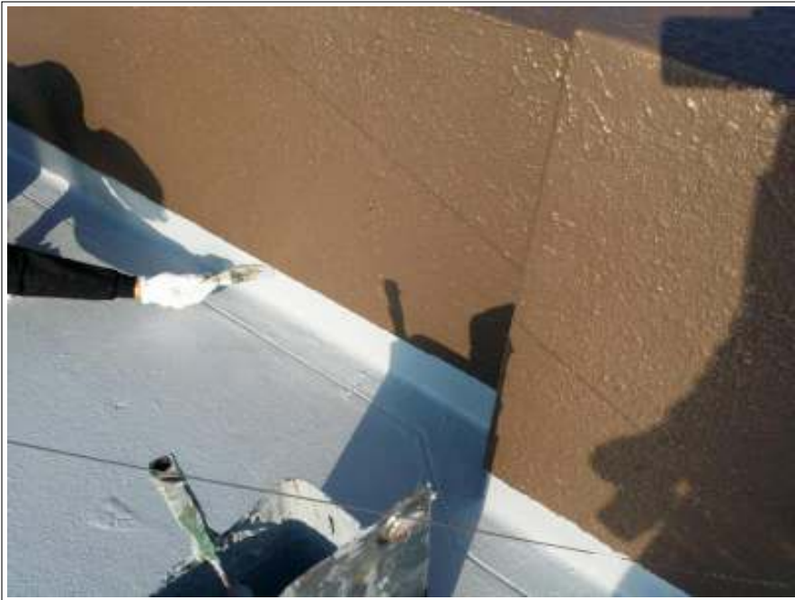
屋上 下塗り施工中
