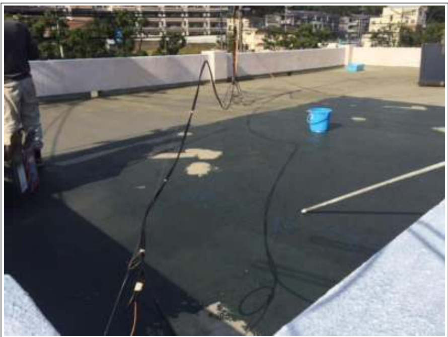
屋上 高圧洗浄後
