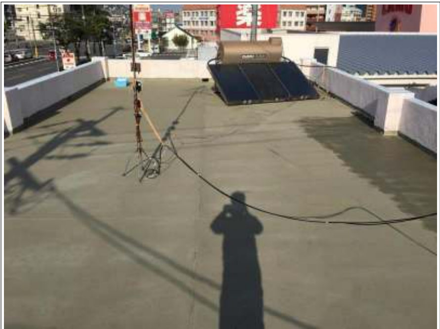
屋上 下地処理 完了
