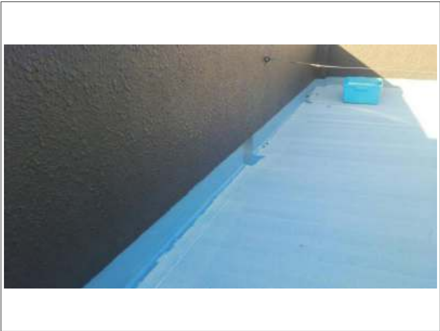
屋上外壁部 上塗り施工中
