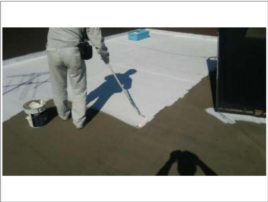
屋上 下塗り施工中
