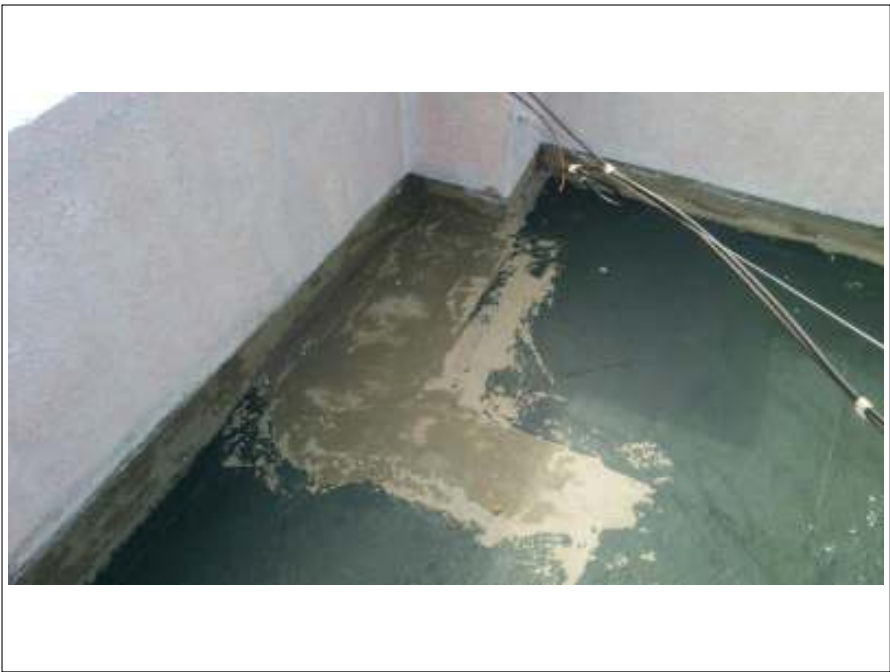
屋上 下地処理
