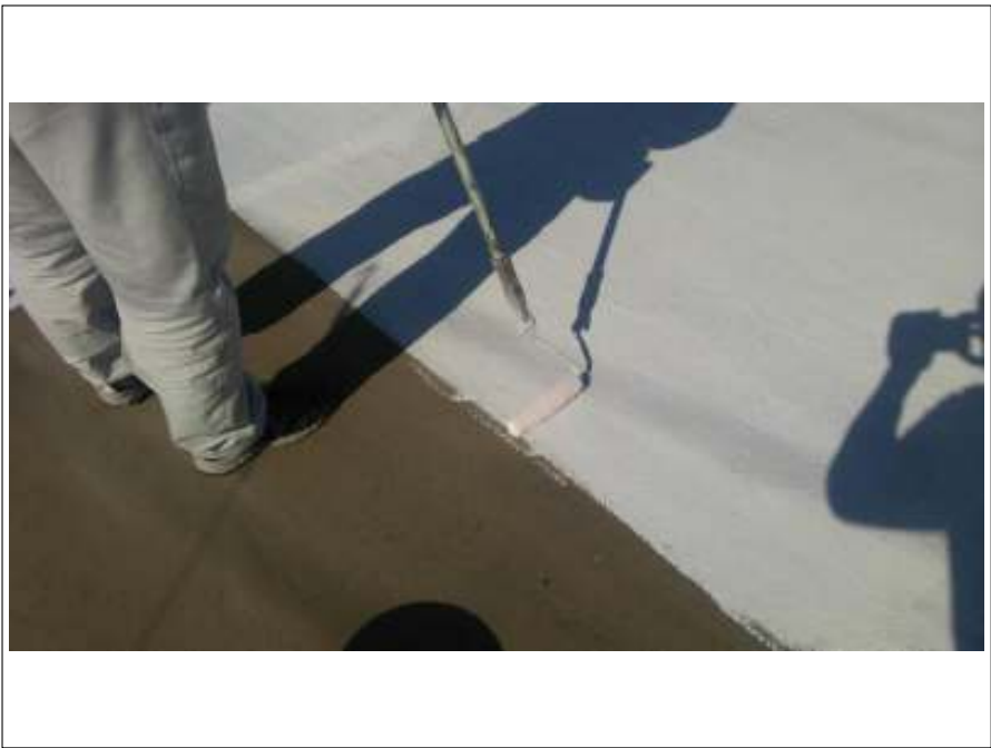
屋上 下塗り施工中
