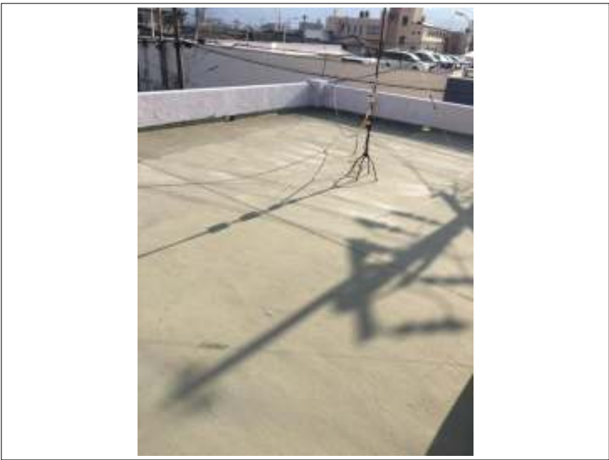
屋上 下地処理 完了
