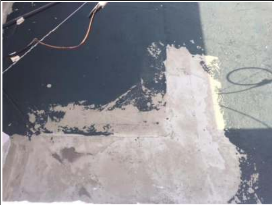
屋上 下地処理
