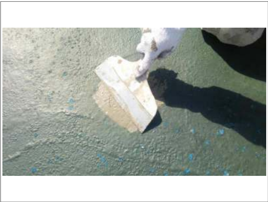
屋上 下地処理
