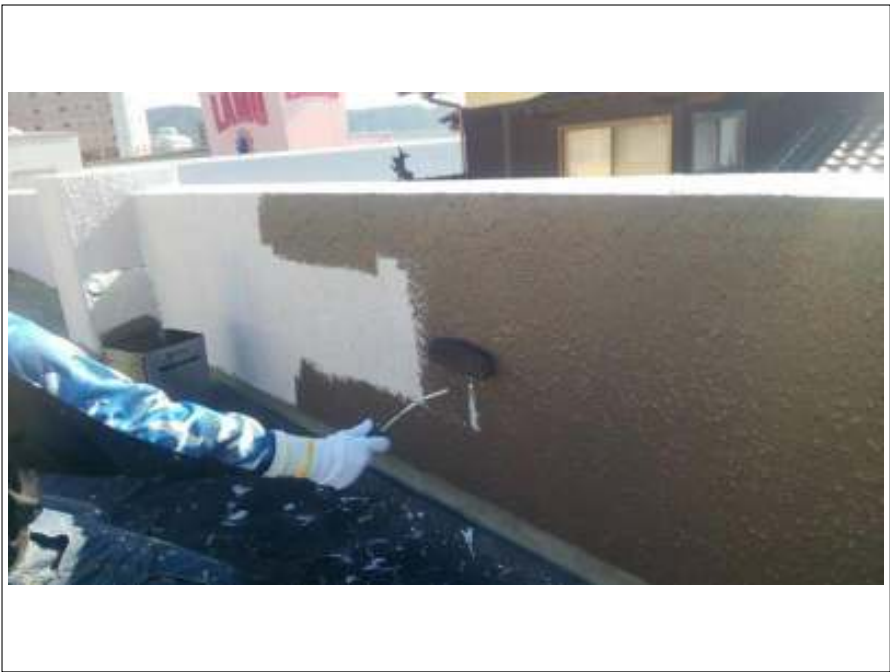
屋上外壁部 中塗り施工中
