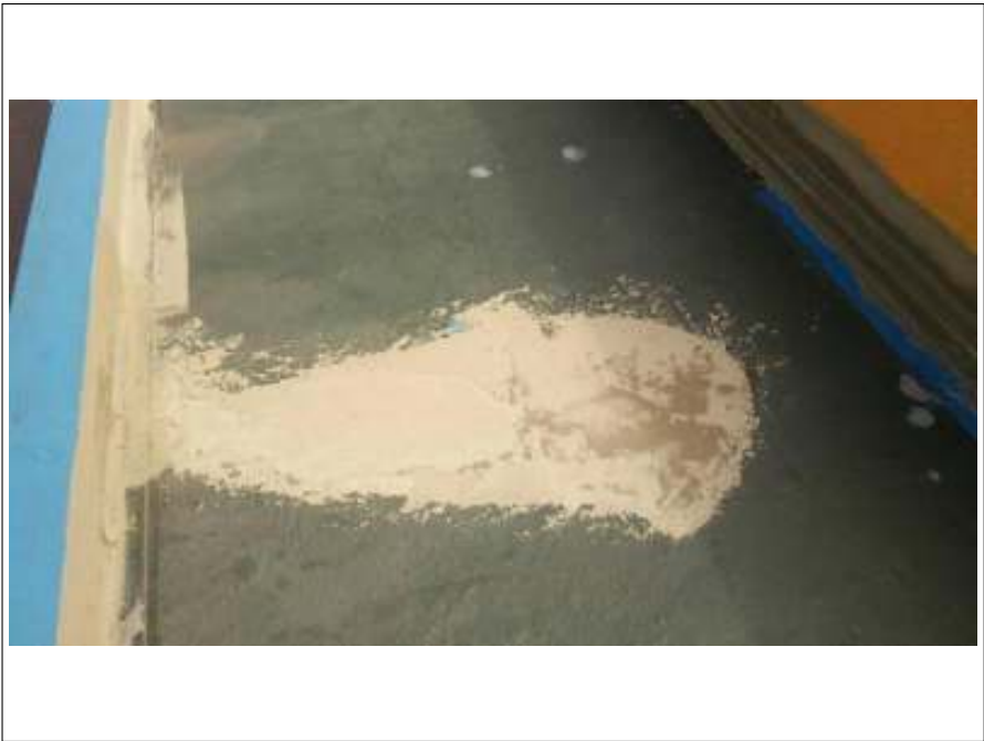
屋上 下地処理
