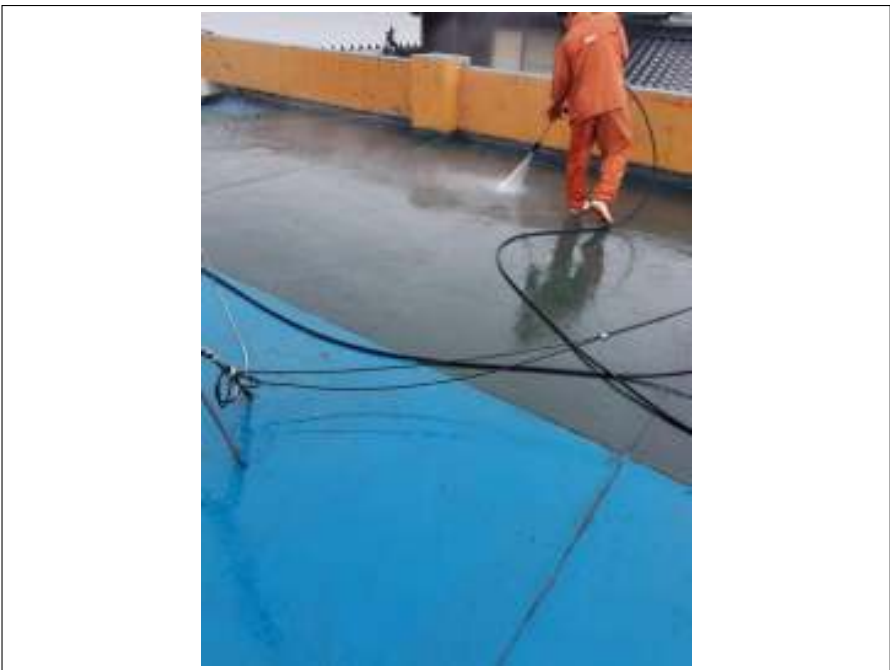
屋上 高圧洗浄中
