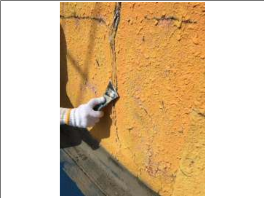
屋上外壁部 下地処理
