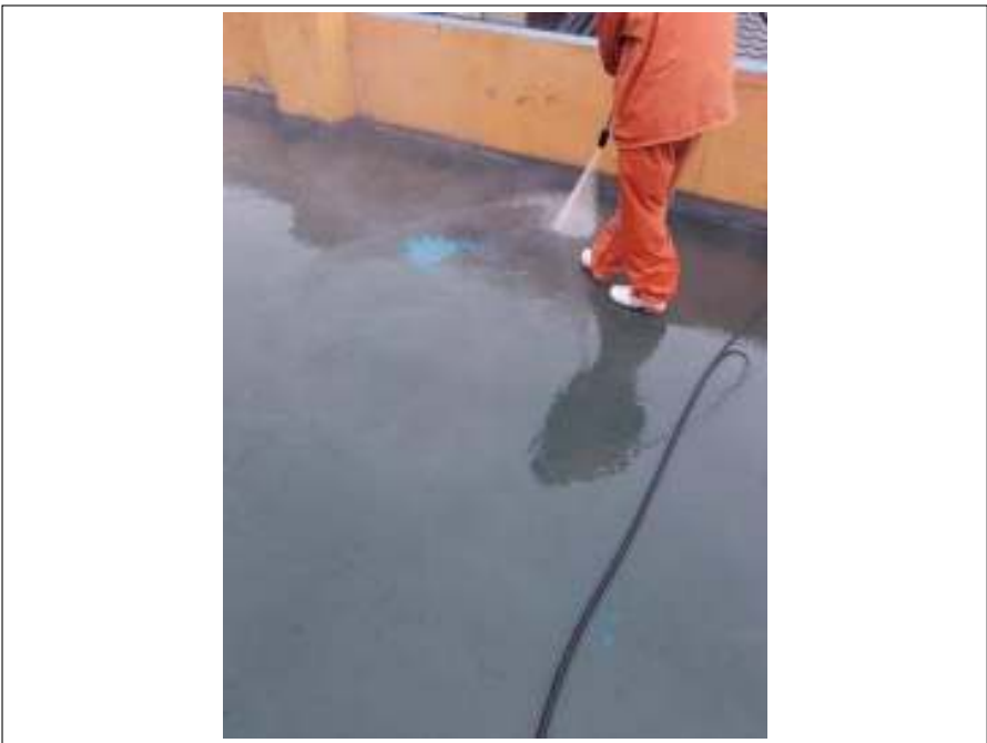
屋上 高圧洗浄中
