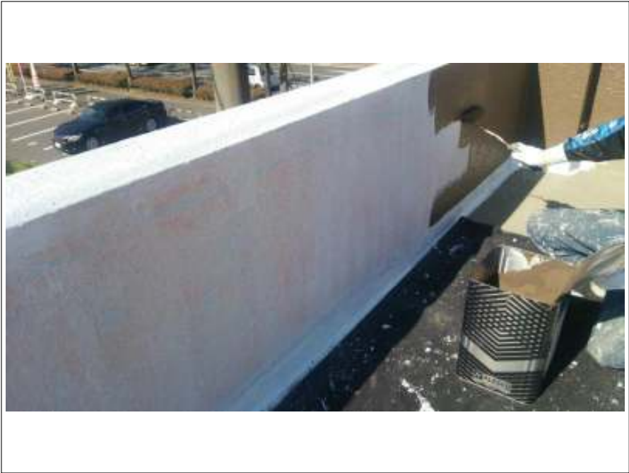
屋上外壁部 中塗り施工中
