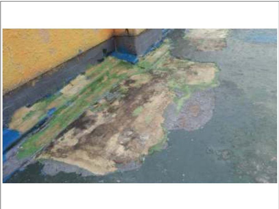
屋上 下地処理
