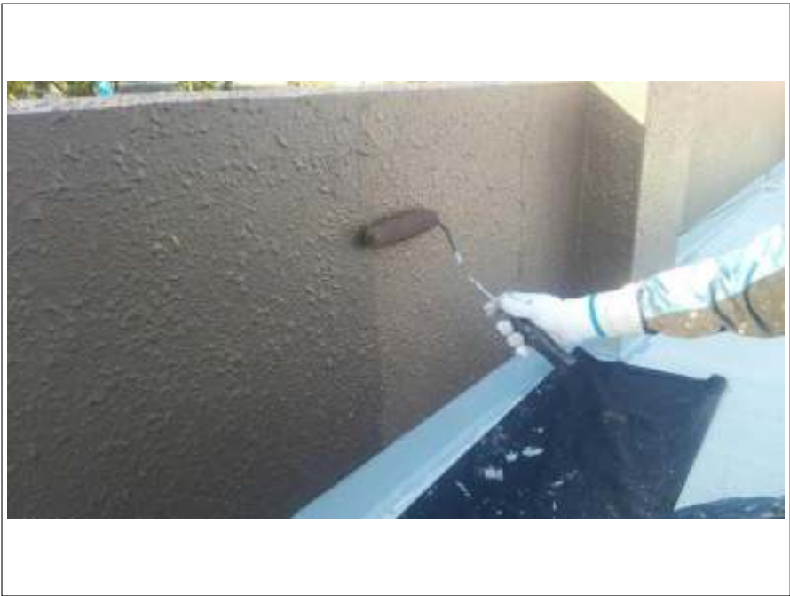
屋上外壁部 上塗り施工中
