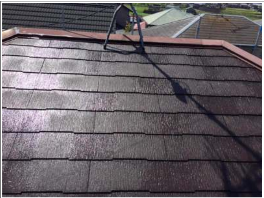
屋根 高圧洗浄中
