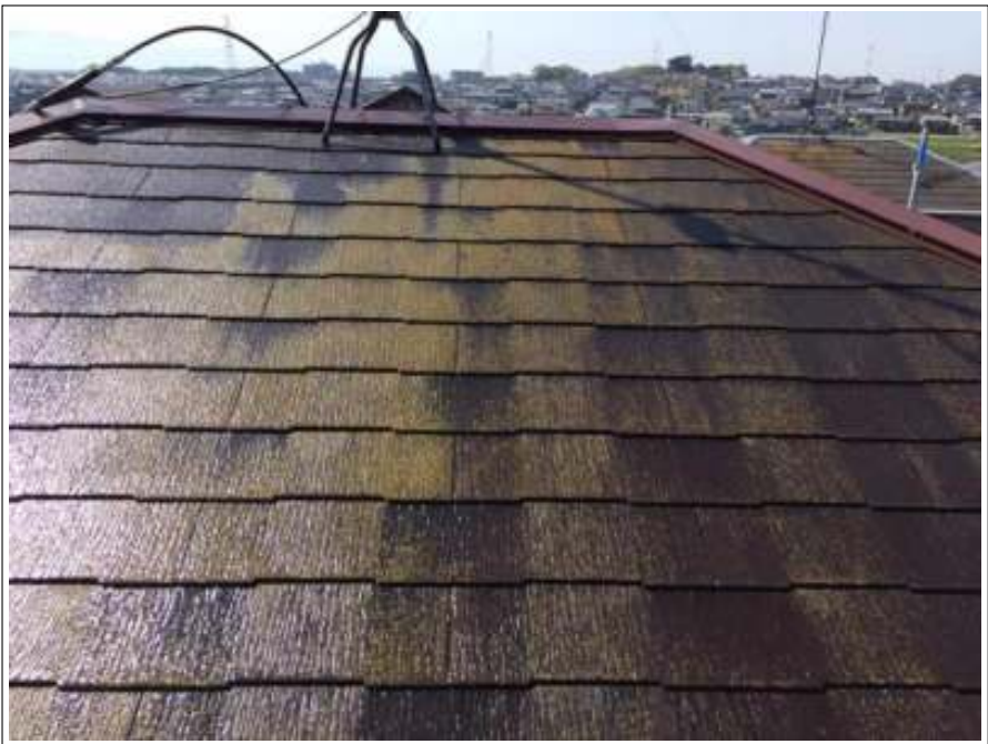
屋根 高圧洗浄中
