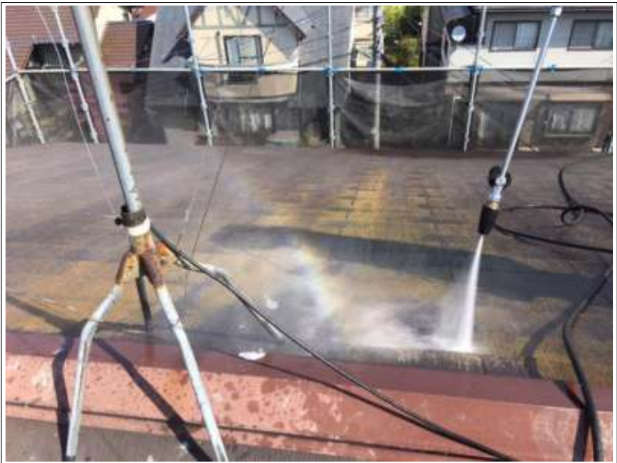
屋根 高圧洗浄中
