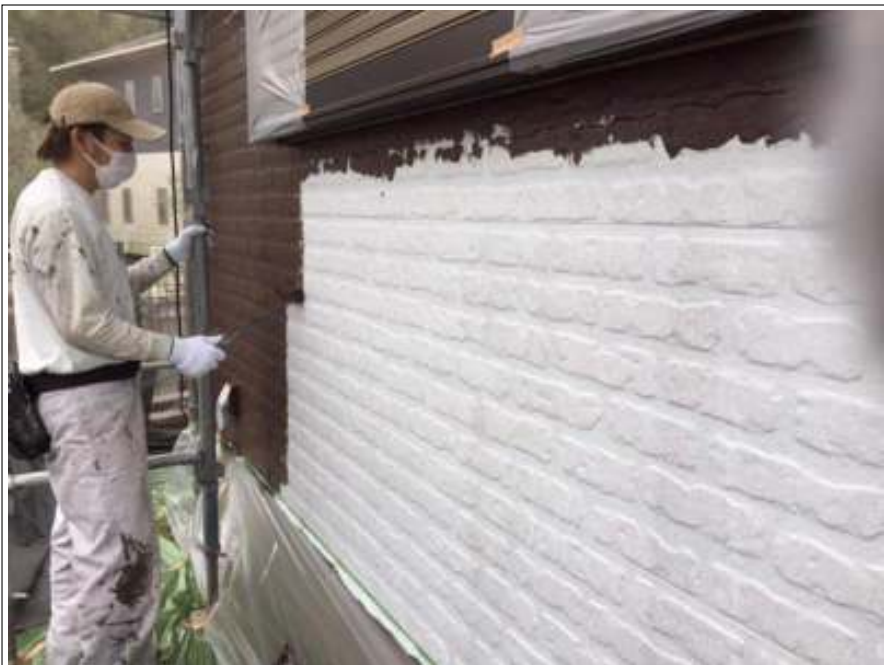
外壁 中塗り施工中
