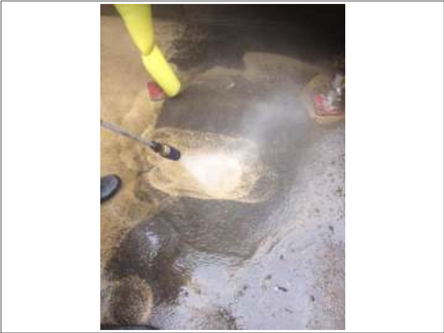
土間 高圧洗浄中
