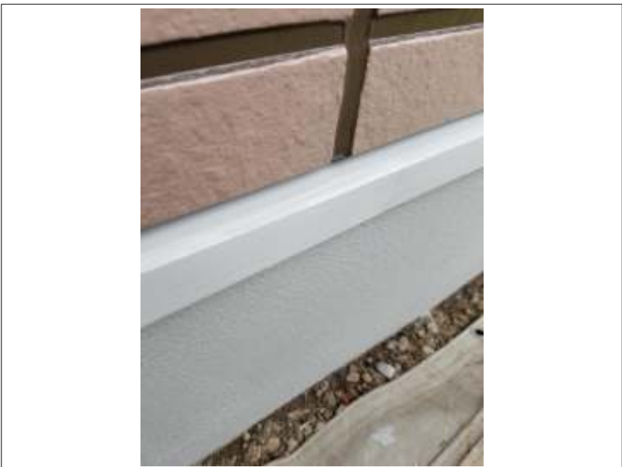
土台水切り 上塗り(1回目) 施工後
