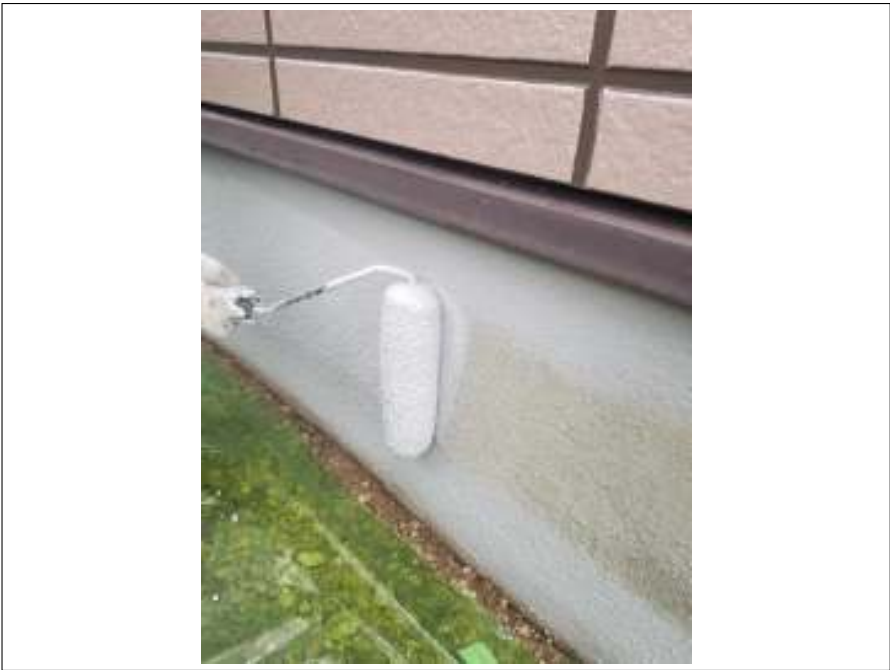
基礎 上塗り（1回目）施工中
