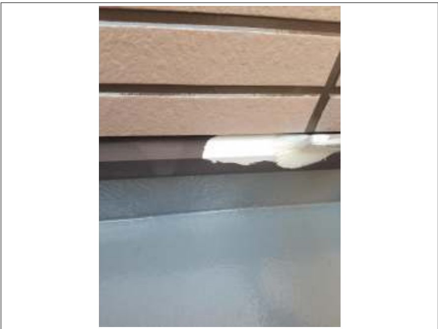
土台水切り 上塗り(1回目) 施工中
