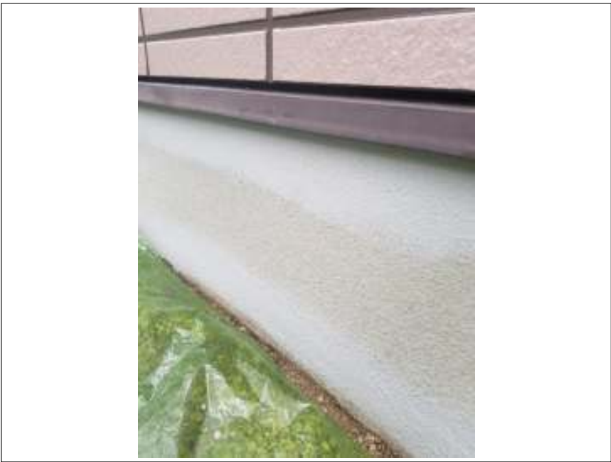
基礎 上塗り（1回目）施工中
