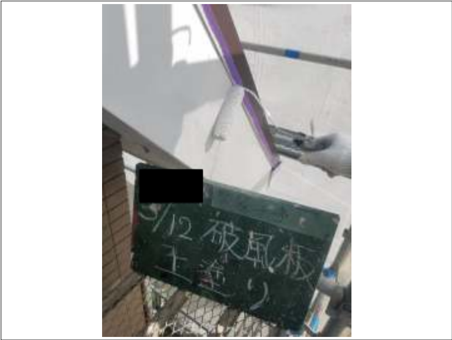
破風板 上塗り（2回目）施工中
