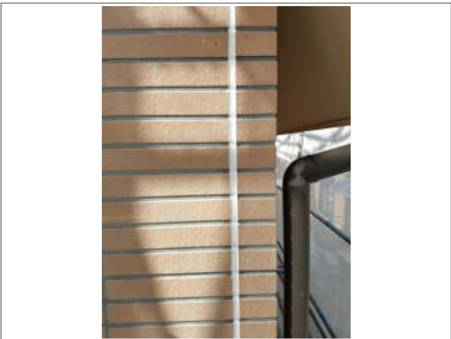
外壁 シーリング打ち替え施工後
