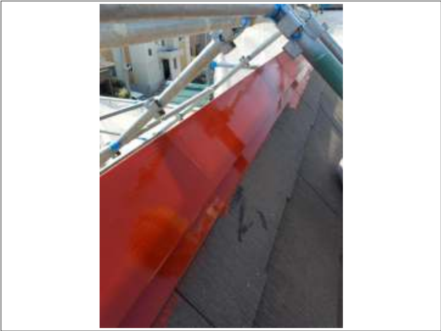
屋根板金 錆止め塗布施工後
