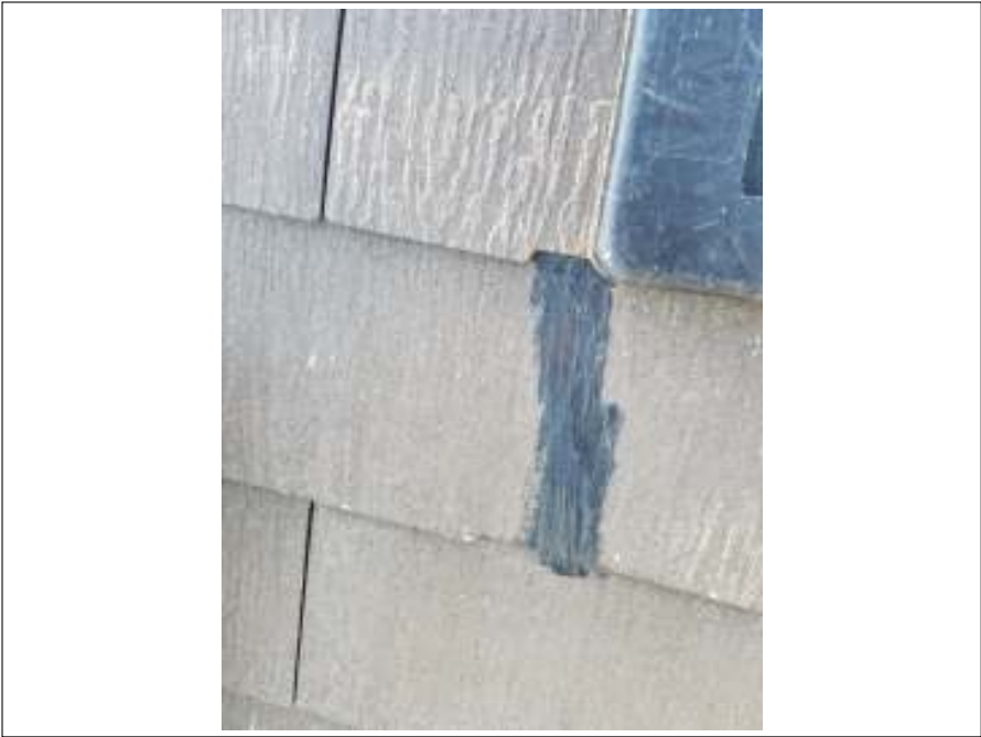
屋根 クラック補修施工後
