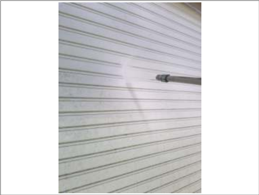
シャッター 高圧洗浄中
