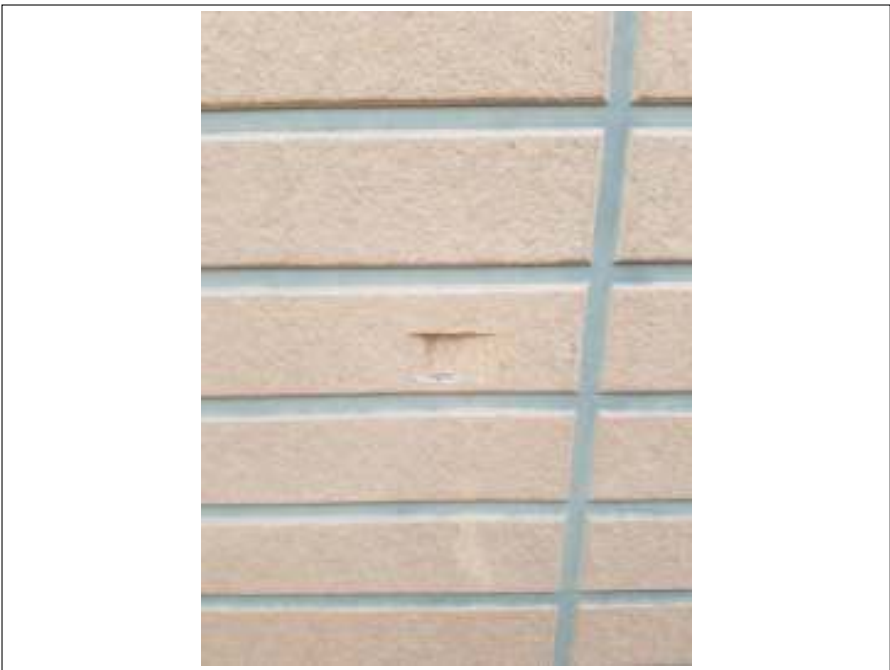
外壁 欠損部補修 施工前
