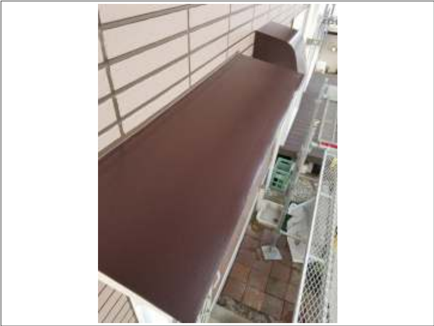
小庇 施工完了
