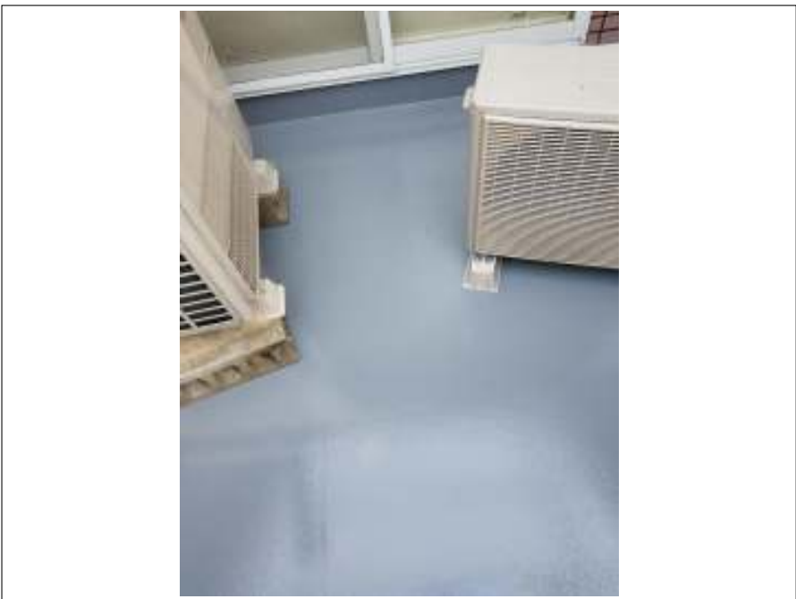
ベランダ 施工後
