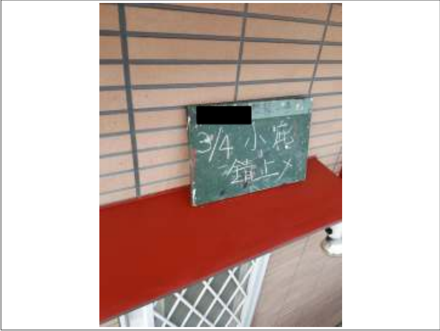
小庇 錆止め塗布施工後
