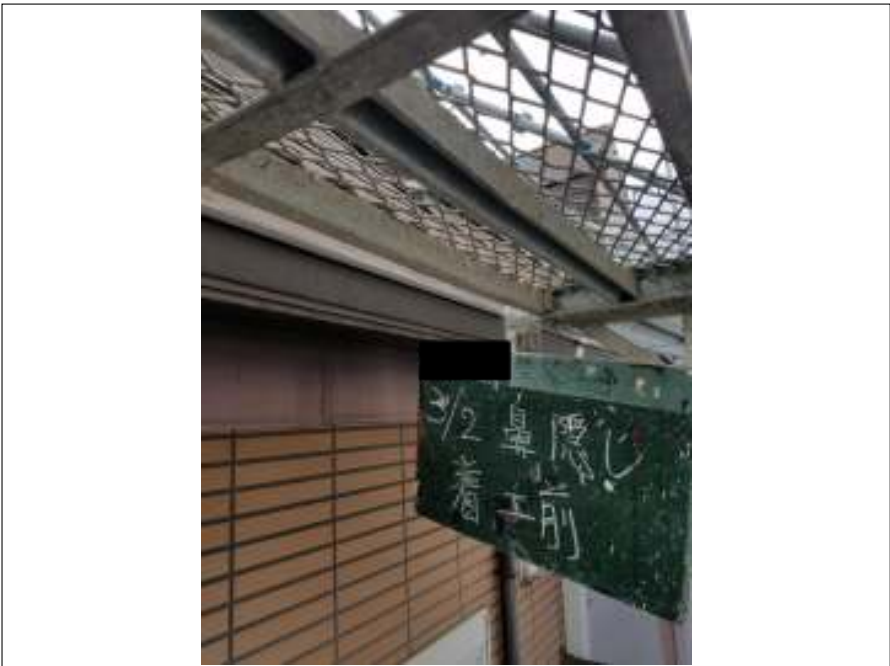
鼻隠し 施工前
