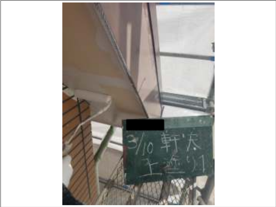
軒天 上塗り（1回目）施工中
