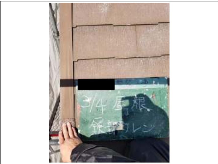
屋根板金 ケレン処理施工中
