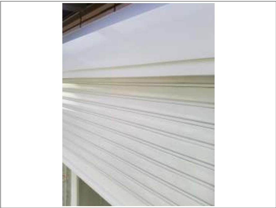
シャッター 施工完了
