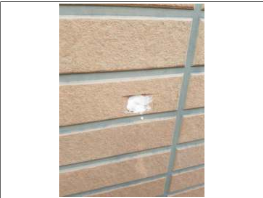
外壁 欠損部補修 施工中
