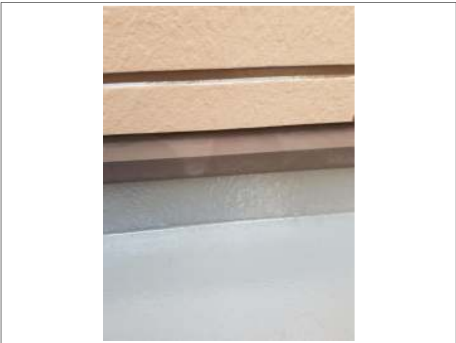
土台水切り 施工前
