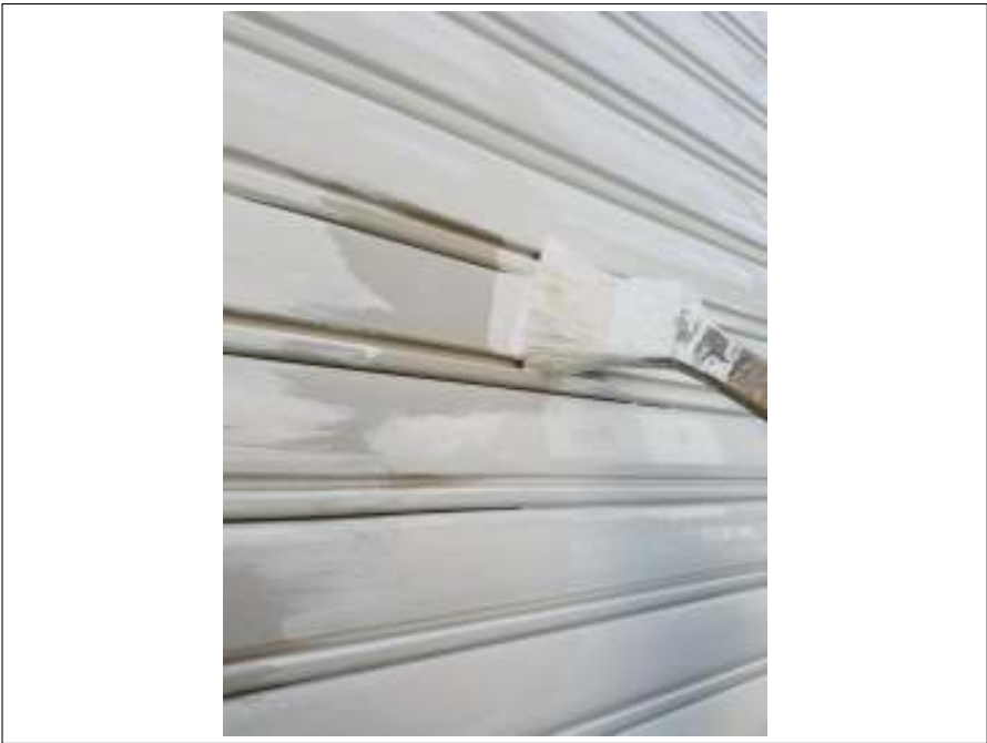
シャッター 上塗り(2回目) 施工中
