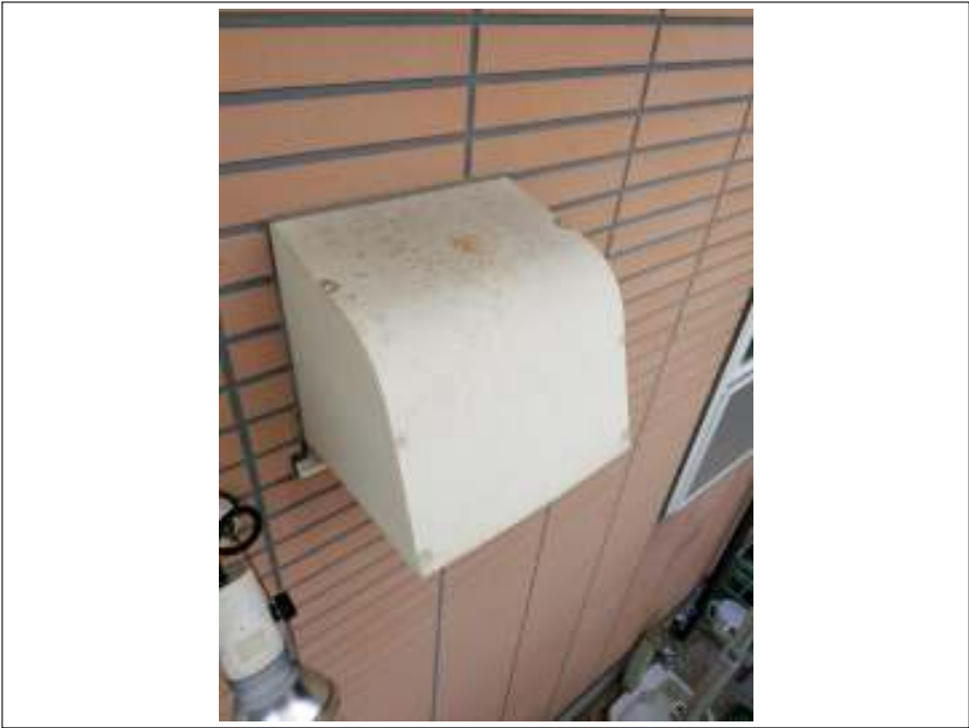
換気フード 施工前
