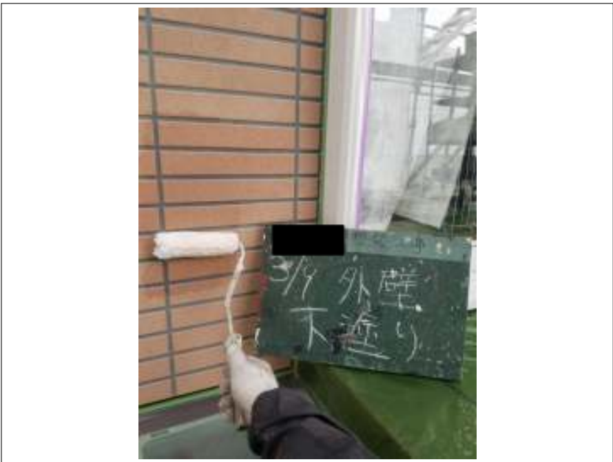
外壁 下塗り施工中
