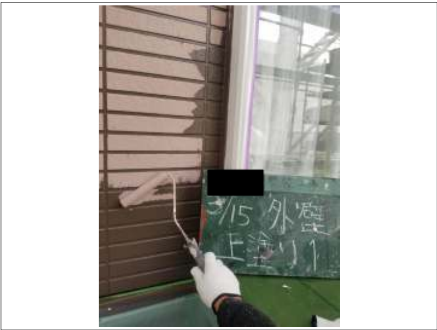
外壁 上塗り（1回目）施工中
