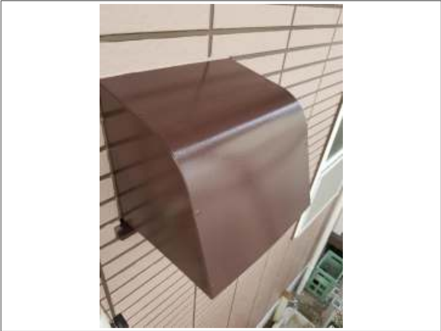
換気フード 施工完了
