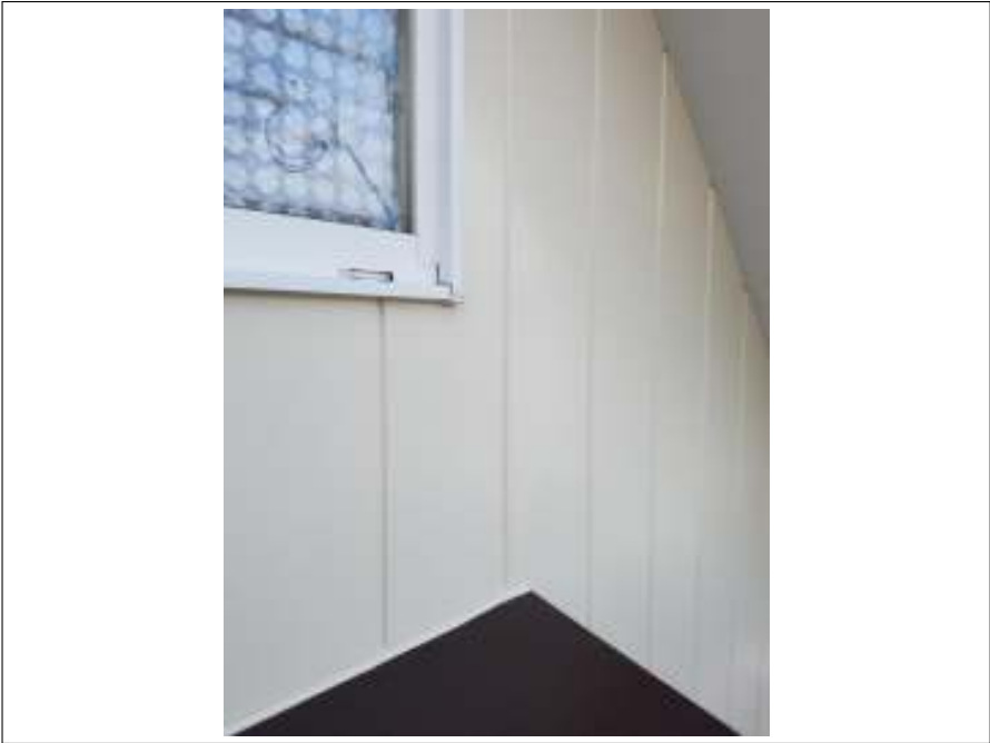
外壁 施工完了
