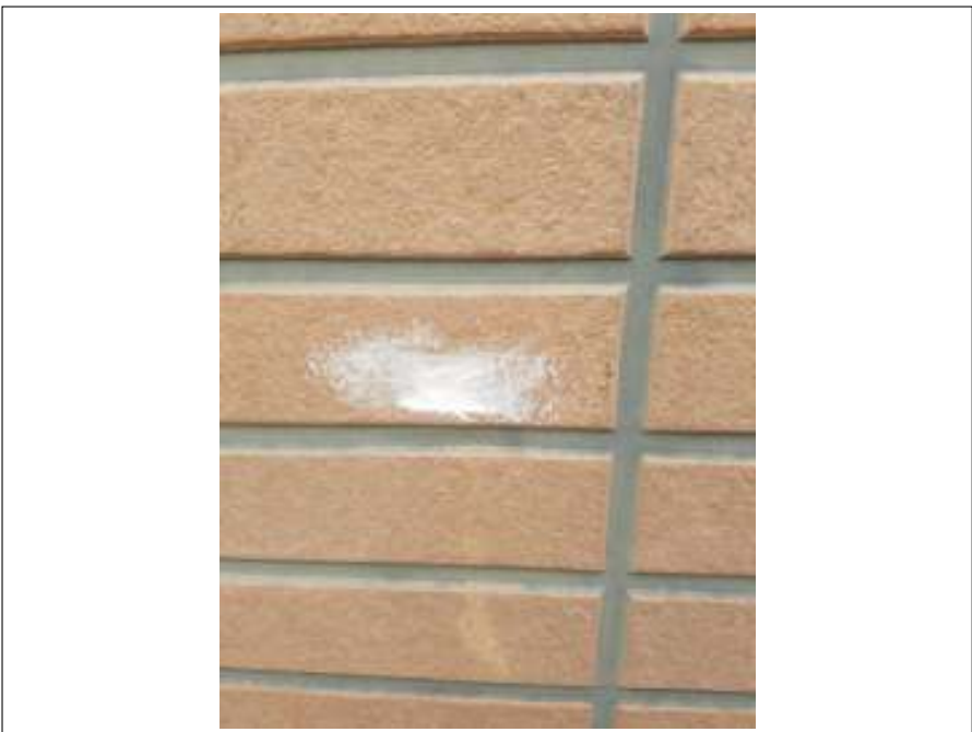
外壁 欠損部補修 施工後
