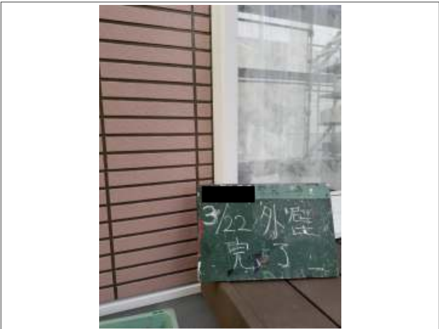
外壁 施工完了
