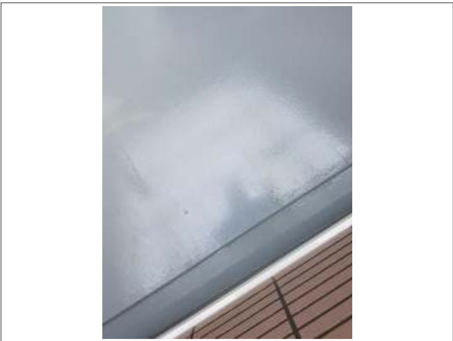
ベランダ 施工後
