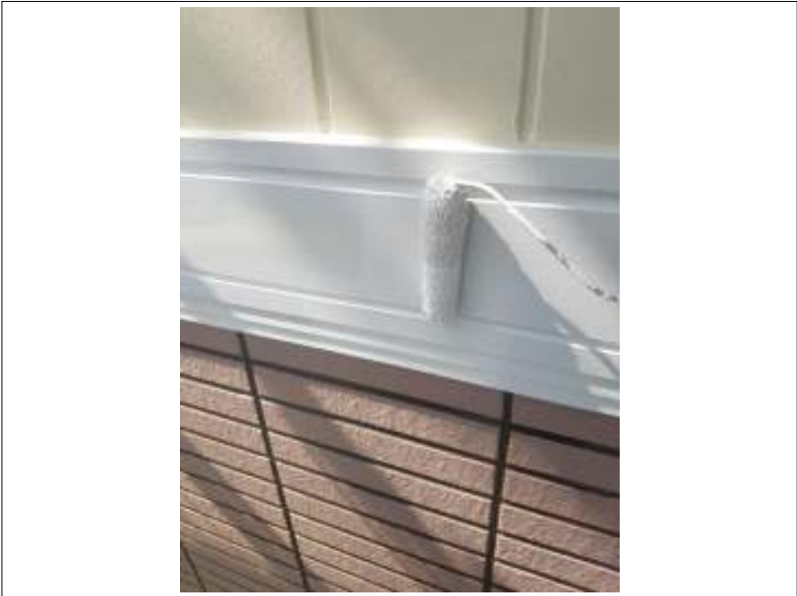
帯 上塗り（2回目）施工中
