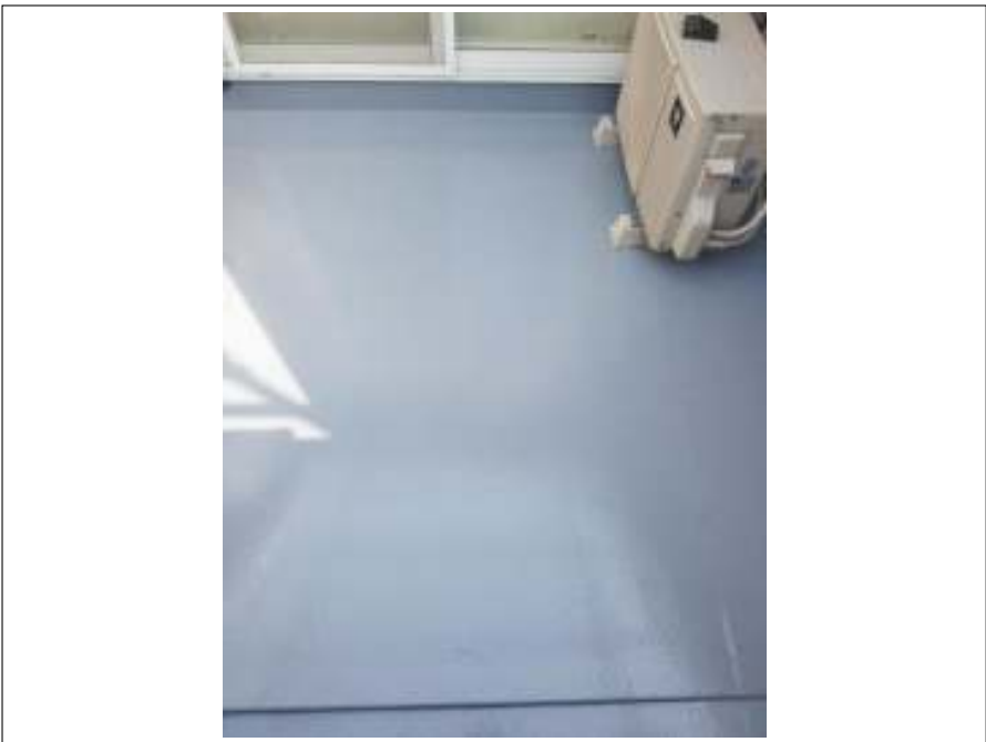
ベランダ 施工後
