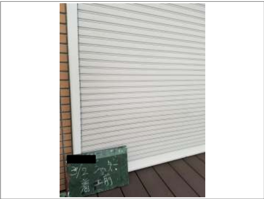
シャッター 施工前
