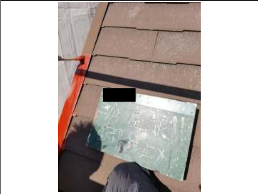
屋根板金 錆止め塗布施工中
