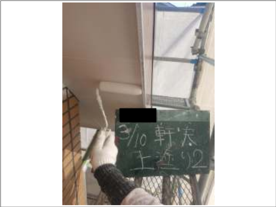
軒天 上塗り（2回目）施工中
