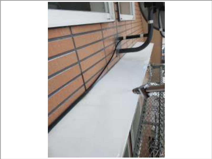
小庇 高圧洗浄中
