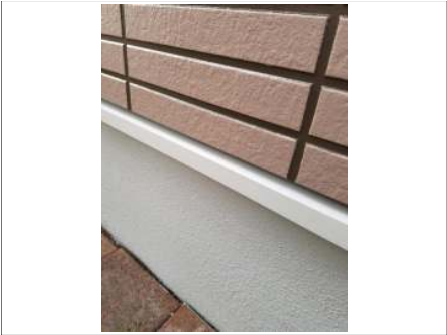
土台水切り 上塗り(2回目) 施工後
