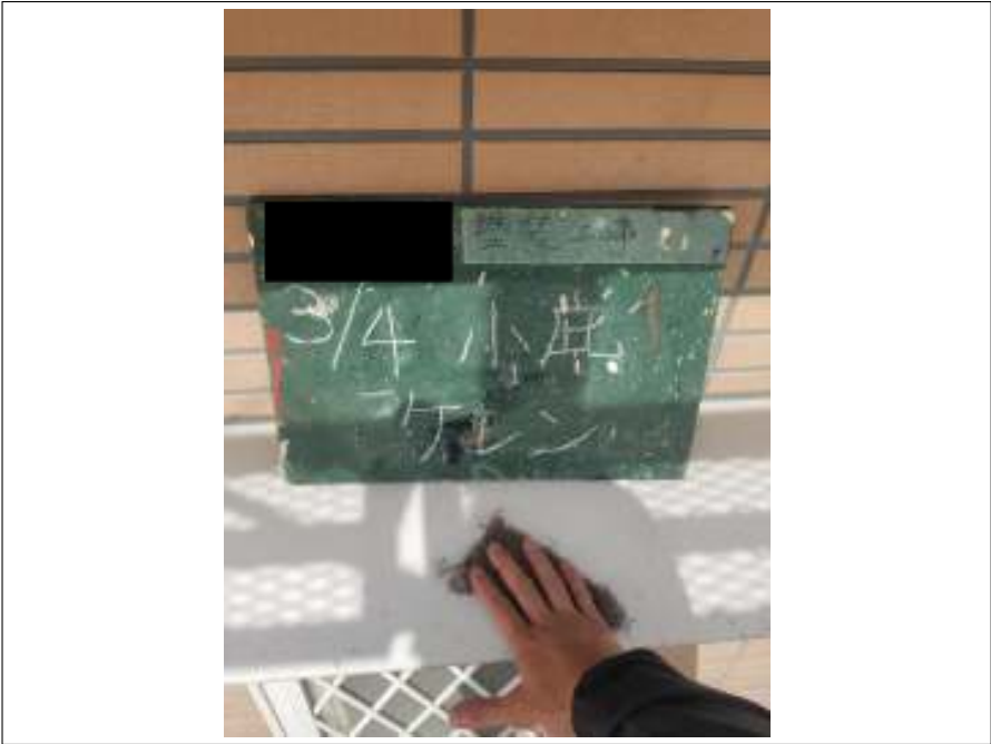
小庇 ケレン処理施工中
