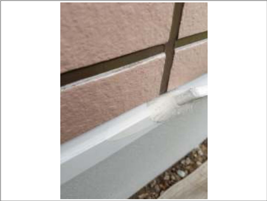
土台水切り 上塗り(2回目) 施工中
