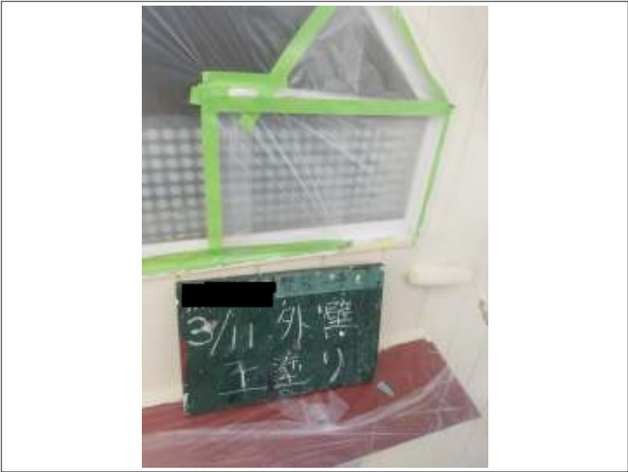
外壁 上塗り施工中
