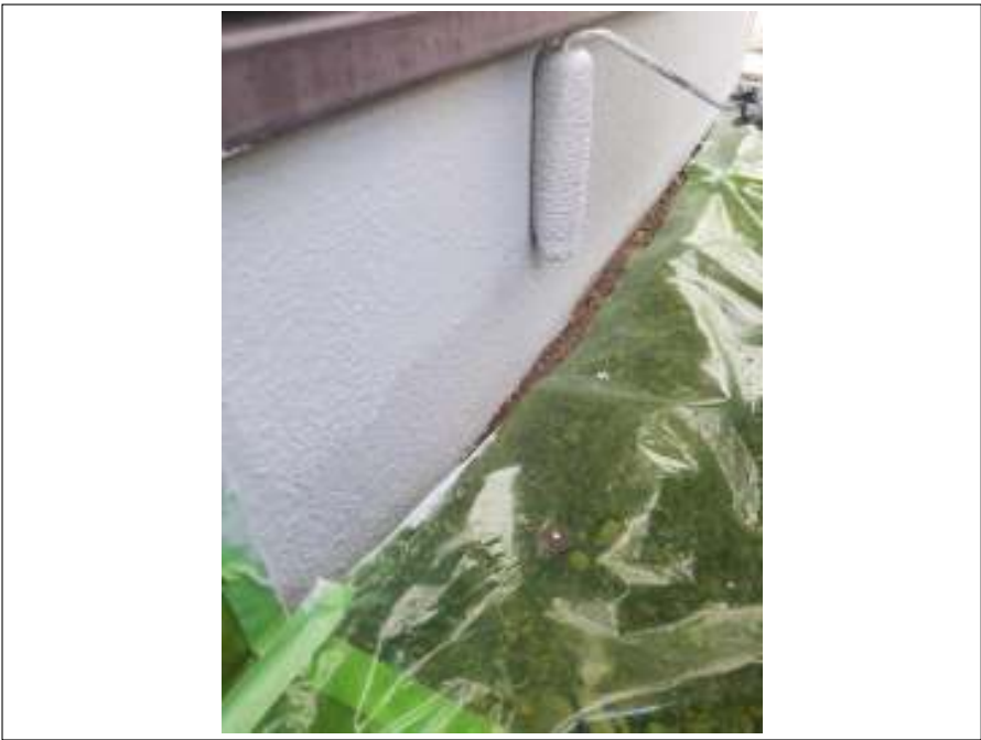
基礎 上塗り（2回目）施工中
