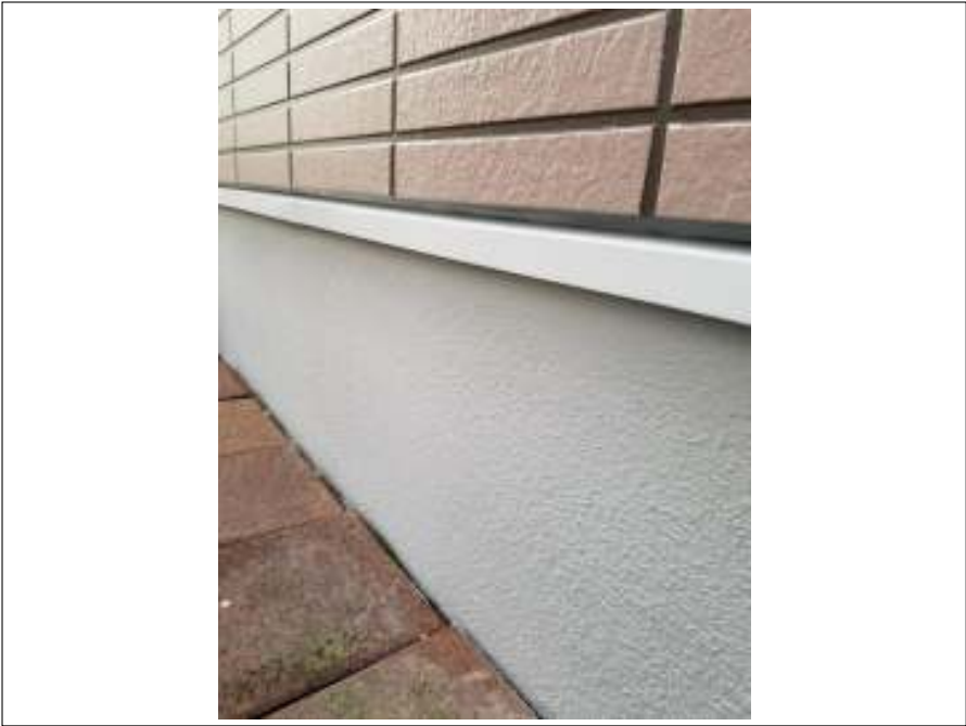
基礎 施工完了
