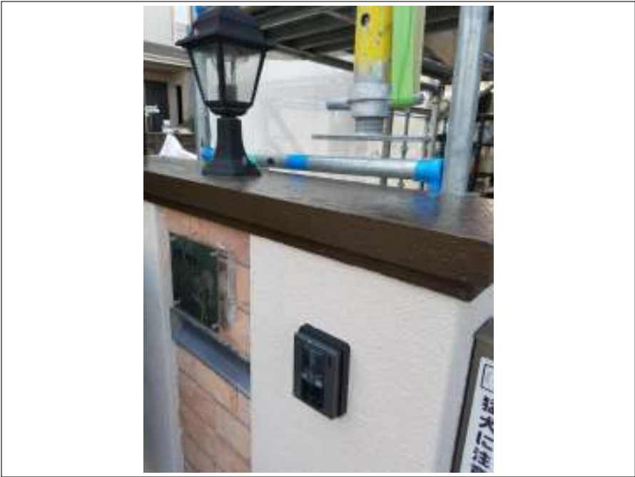
笠木 施工完了
