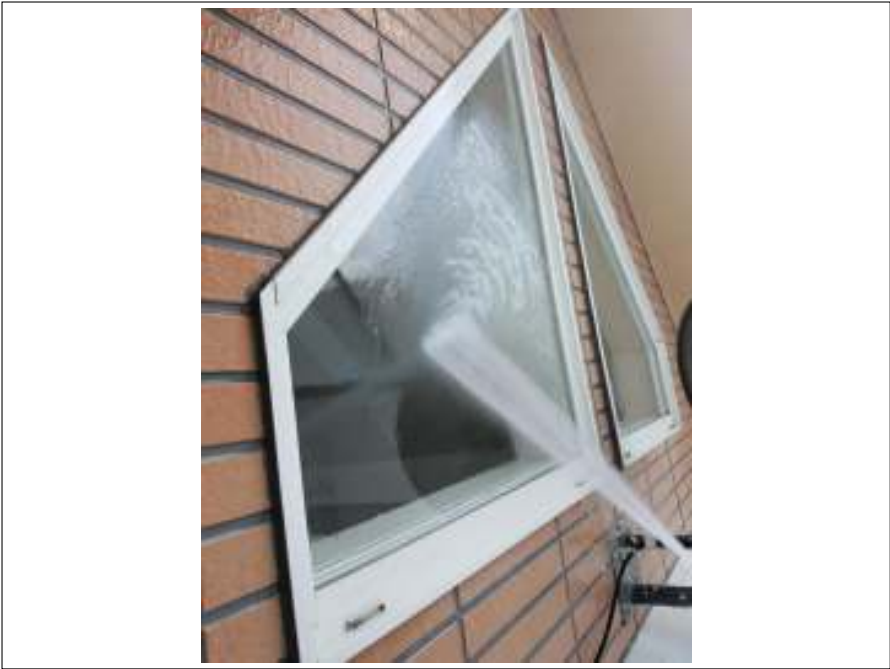
窓 高圧洗浄中
