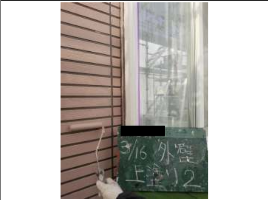
外壁 上塗り（2回目）施工中
