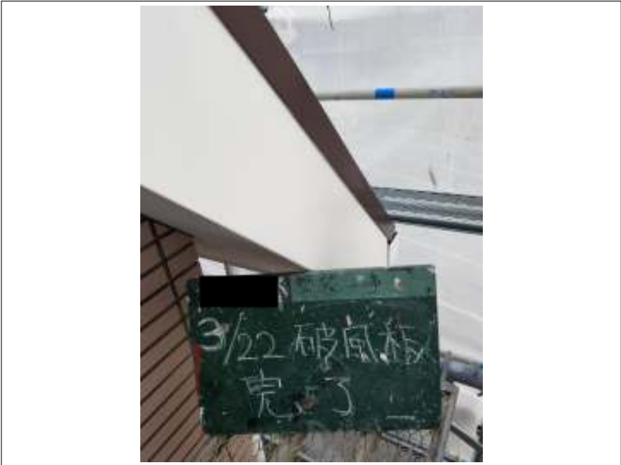
破風板 施工完了
