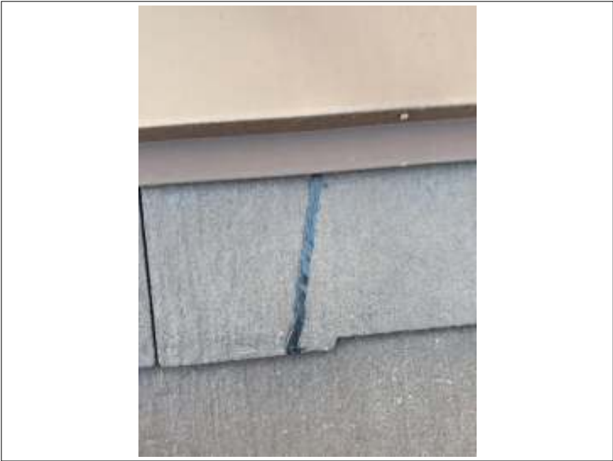
屋根 クラック補修施工中
