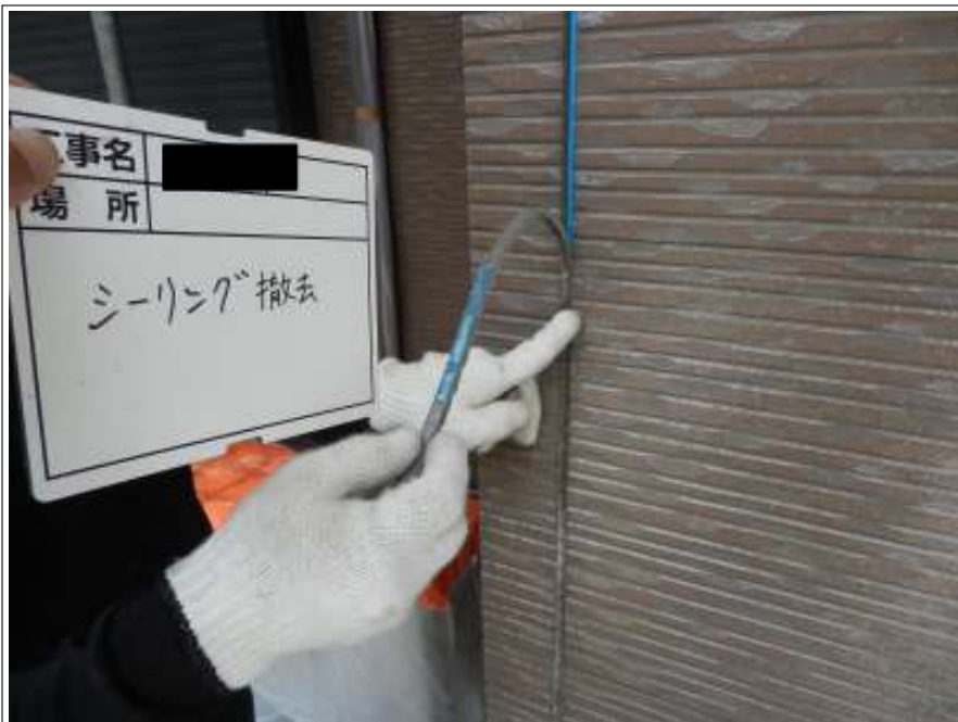
外壁 既存シーリング撤去
