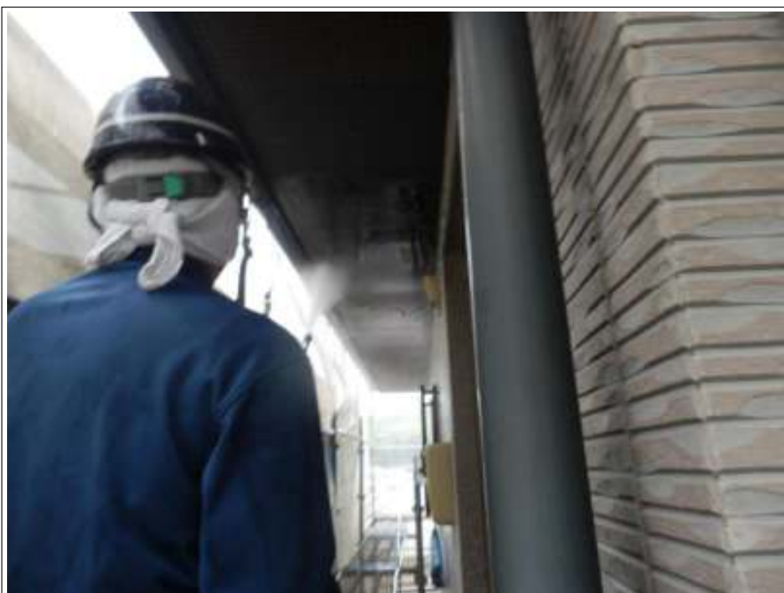
軒天 高圧洗浄中
