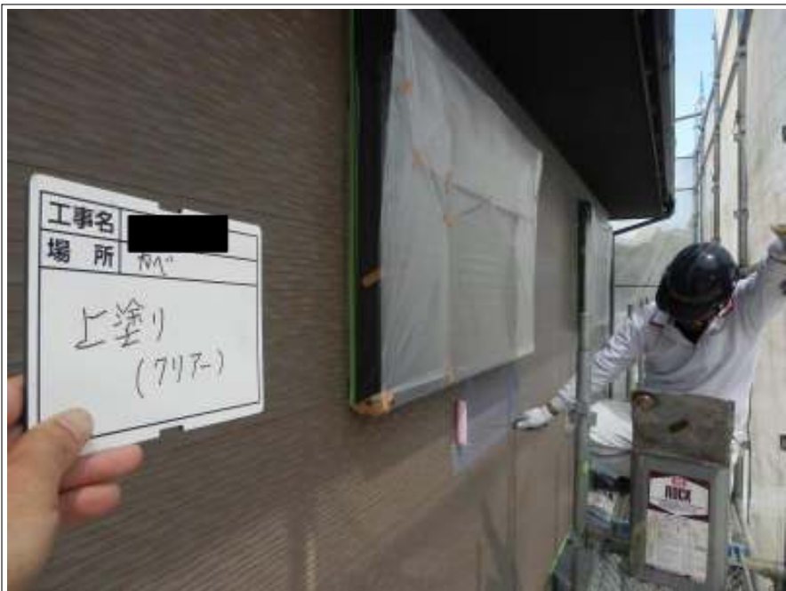
外壁 上塗り施工中
