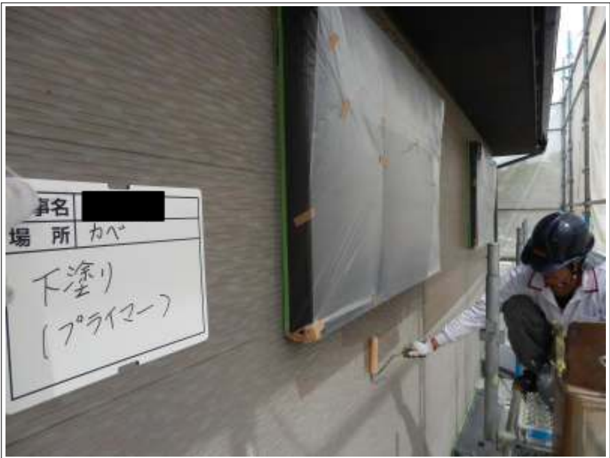
外壁 下塗り 施工中
