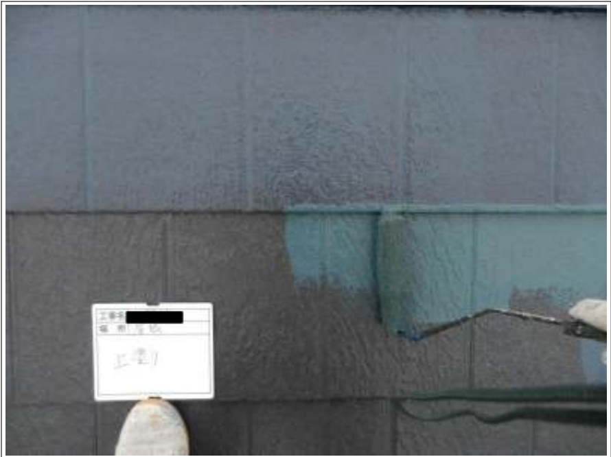
屋根 上塗り施工中
