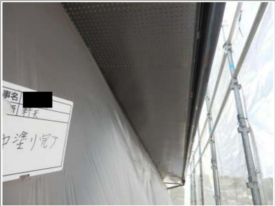
軒天 上塗り（1回目）施工後
