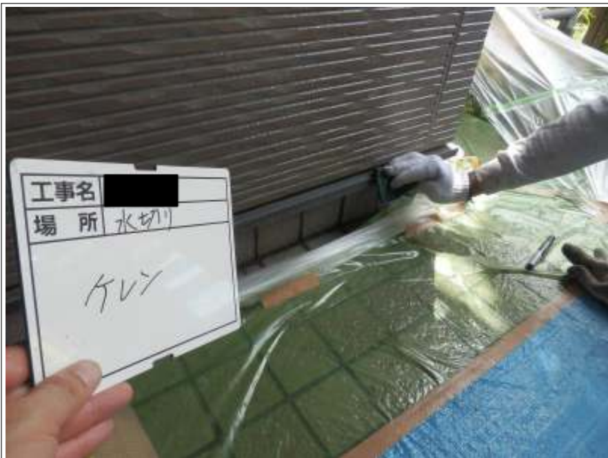
土台水切り ケレン処理施工中
