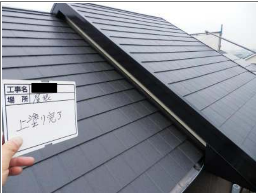
屋根 上塗り施工後
