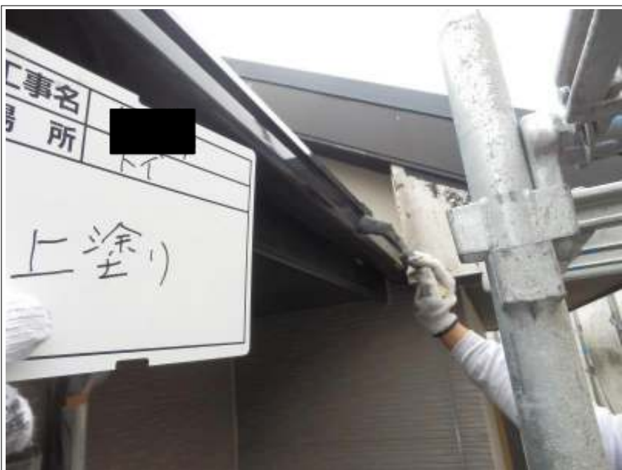
樋 上塗り（2回目）施工中
