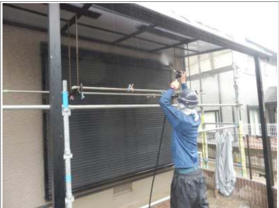
外壁 高圧洗浄中
