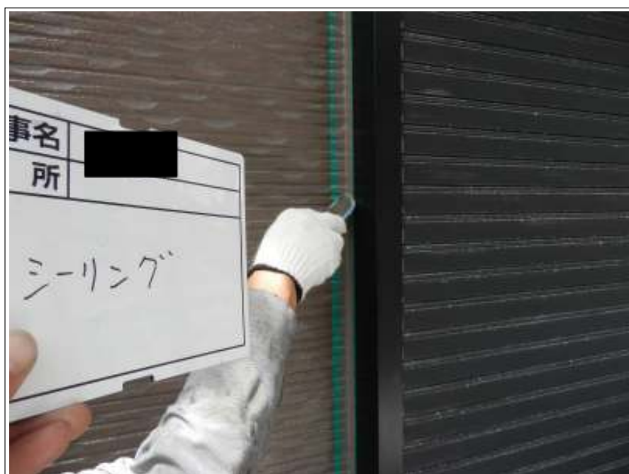
外壁 シーリング ヘラ押え
