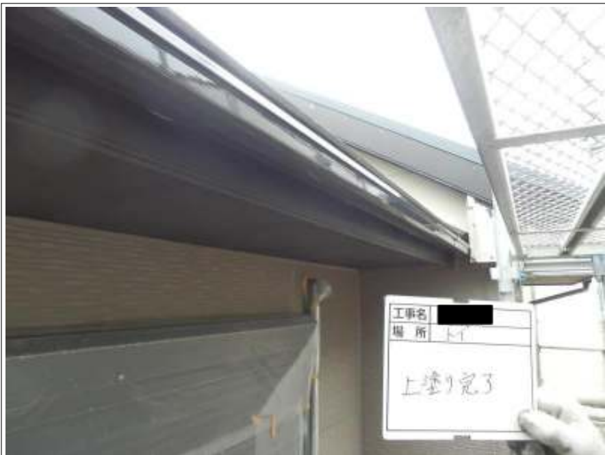
樋 上塗り（2回目）施工後
