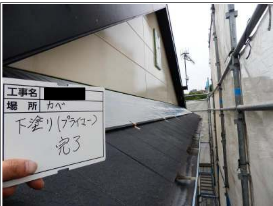
外壁 下塗り施工後
