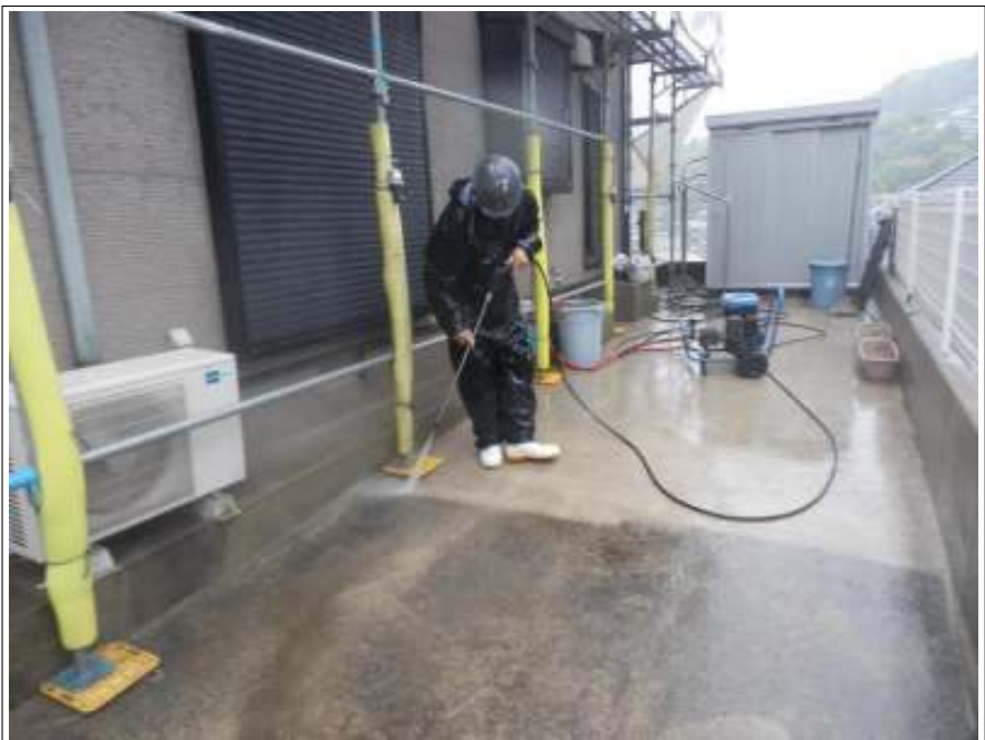
土間 高圧洗浄中
