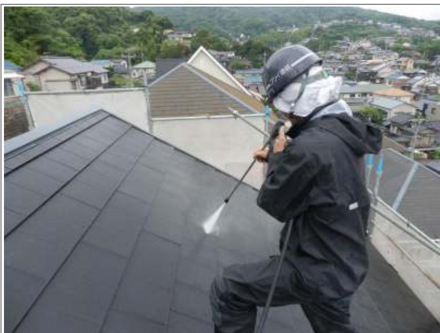
屋根 高圧洗浄中
