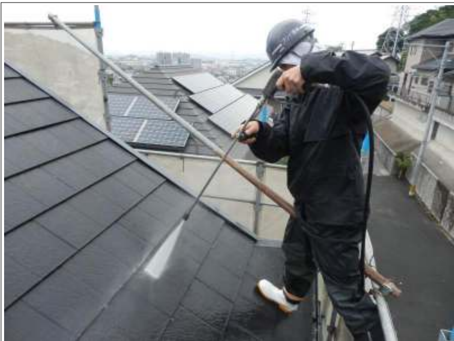
屋根 高圧洗浄中
