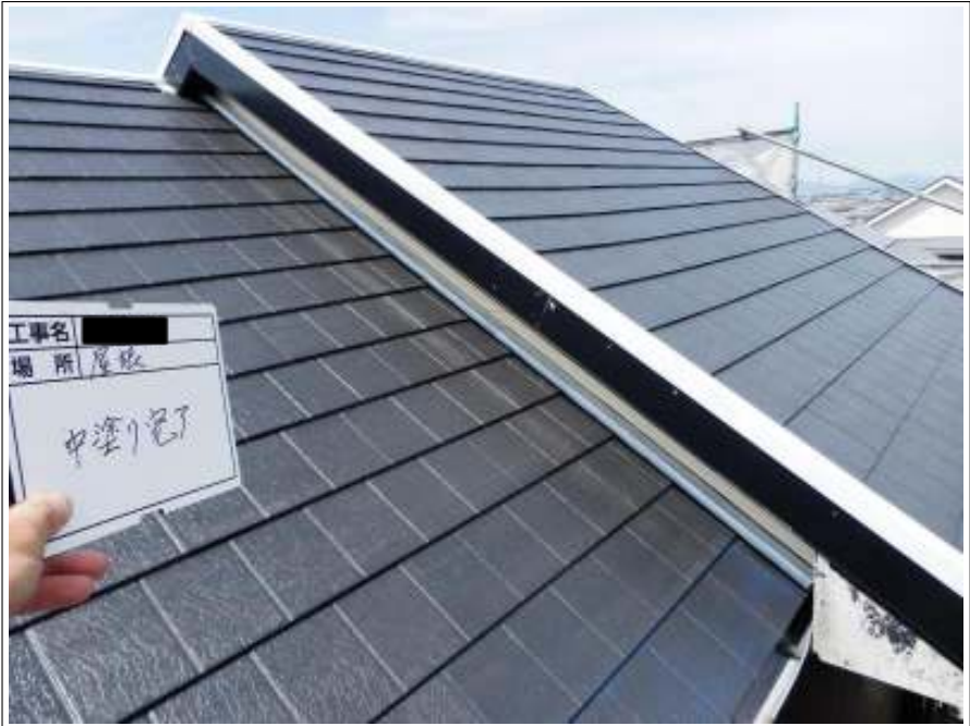
屋根 中塗り施工後
