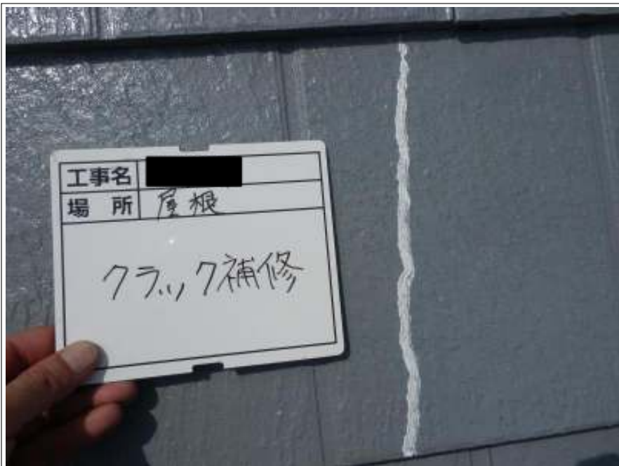
屋根 クラック補修 施工後
