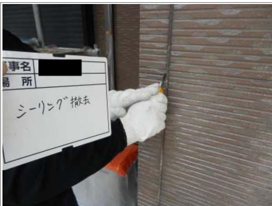
外壁 既存シーリング撤去
