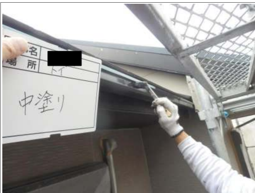
樋 上塗り（1回目）施工中
