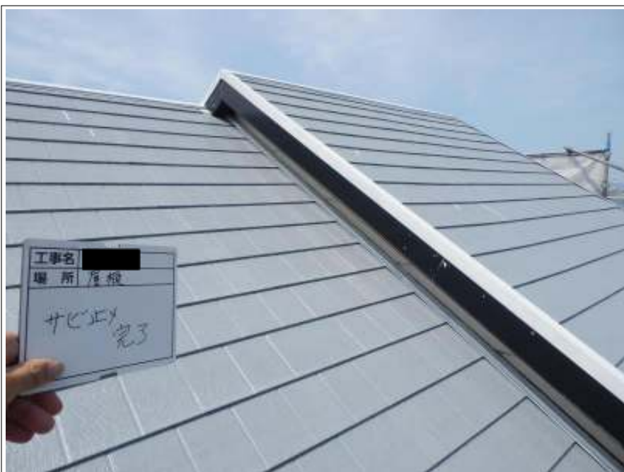
屋根板金 サビ止め塗布施工後
