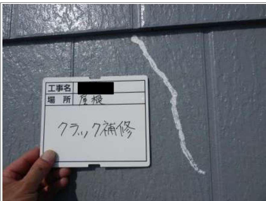
屋根 クラック補修 施工後
