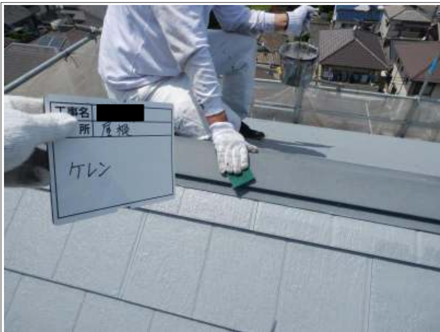
屋根板金 ケレン処理施工中
