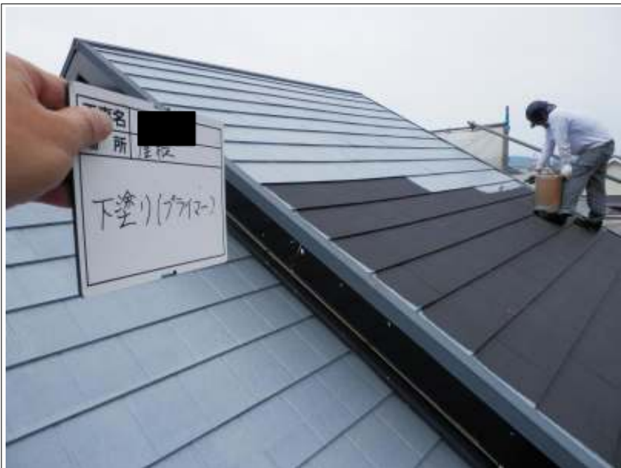
屋根 下塗り施工中
