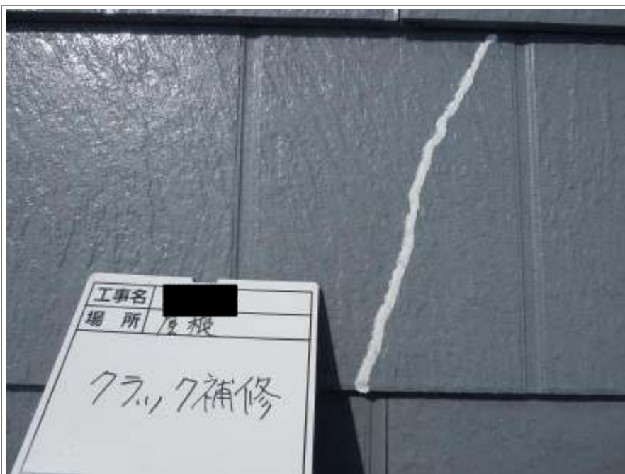
屋根 クラック補修 施工後
