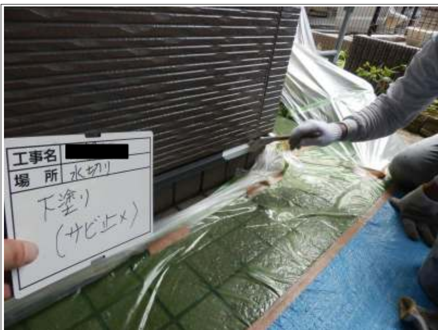
土台水切り 下塗り施工中
