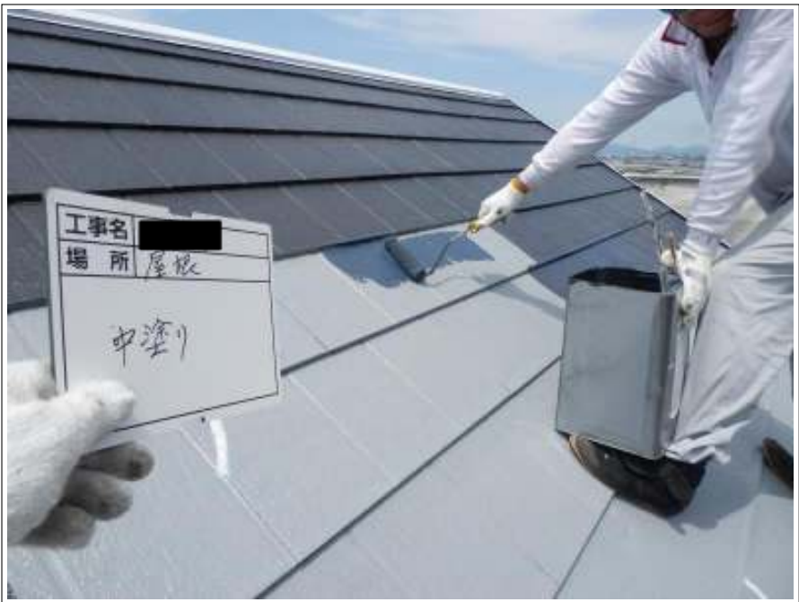
屋根 中塗り施工中
