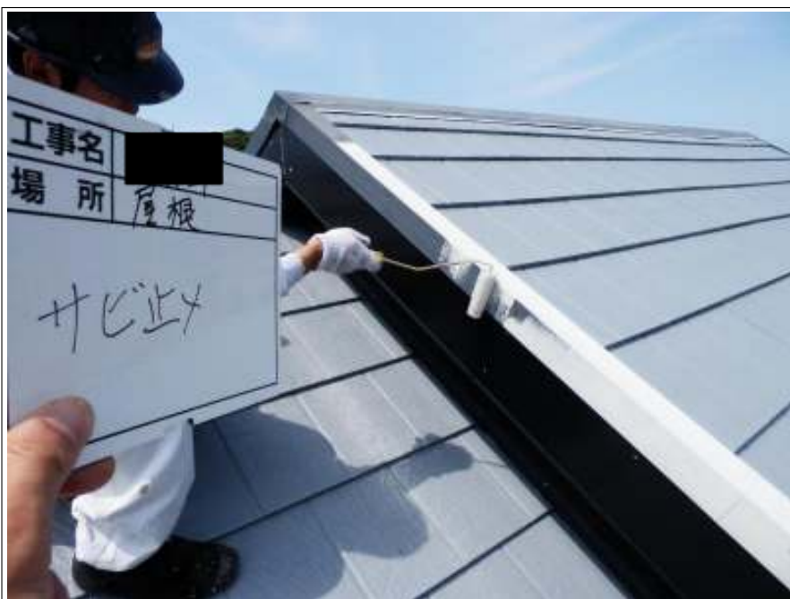
屋根板金 サビ止め塗布施工中
