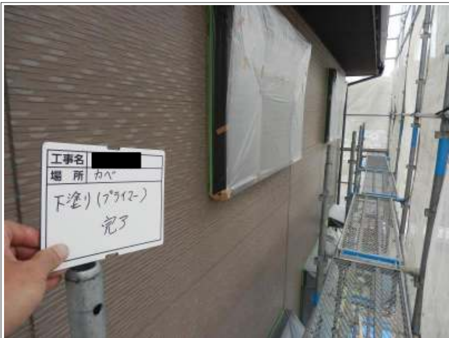
外壁 下塗り施工後
