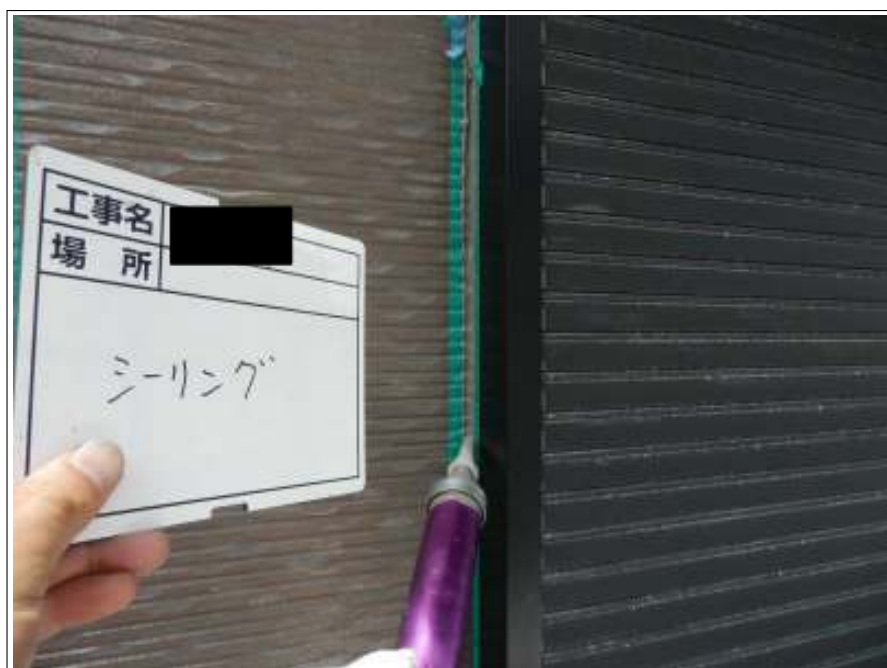
外壁 シーリング充填
