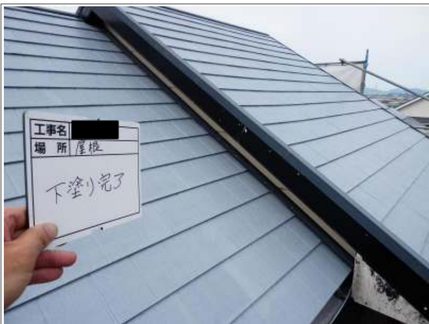
屋根 下塗り施工後
