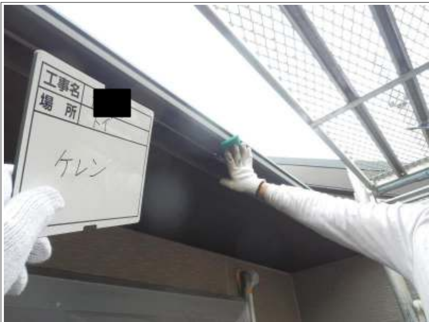
樋 ケレン処理 施工中
