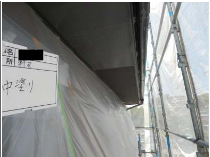
軒天 上塗り（1回目）施工中
