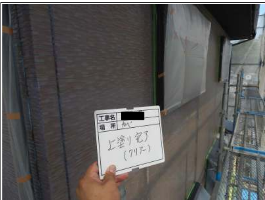
外壁 上塗り施工後
