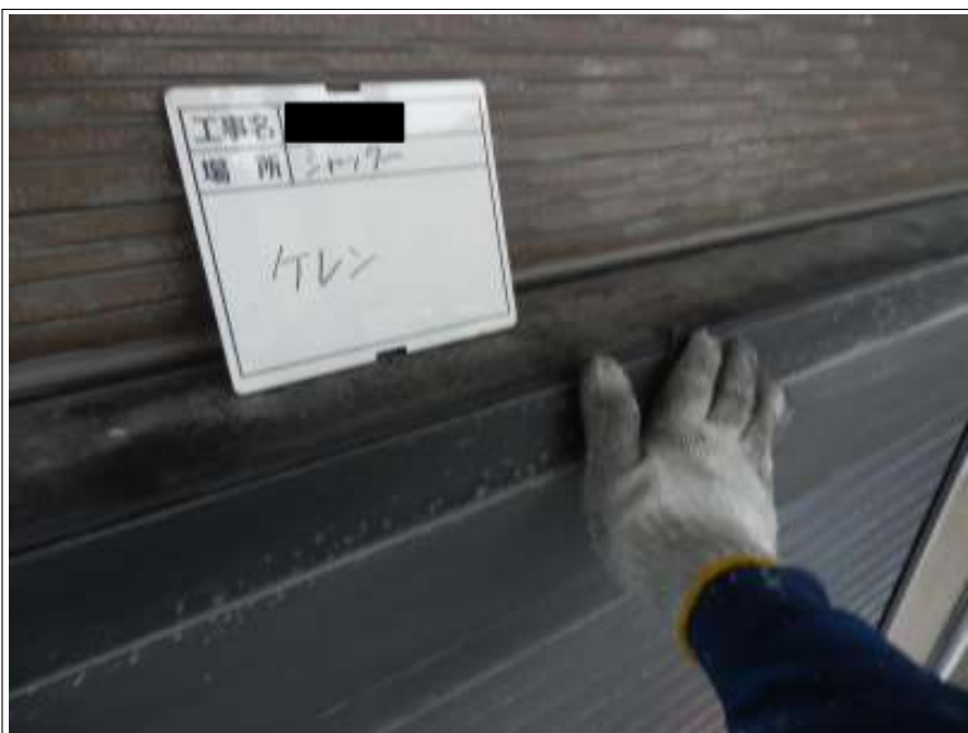
シャッター ケレン処理施工中
