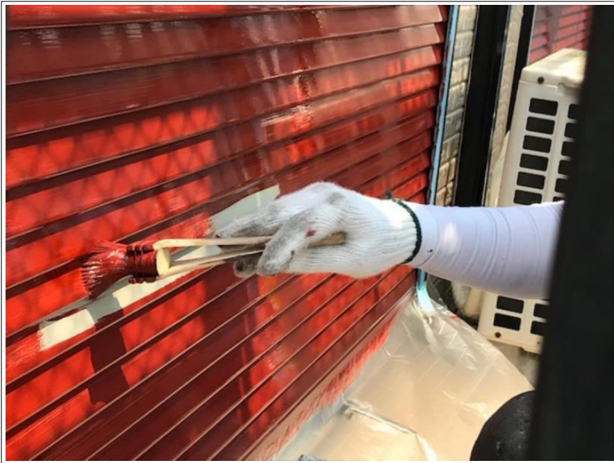
シャッター サビ止め 施工中
