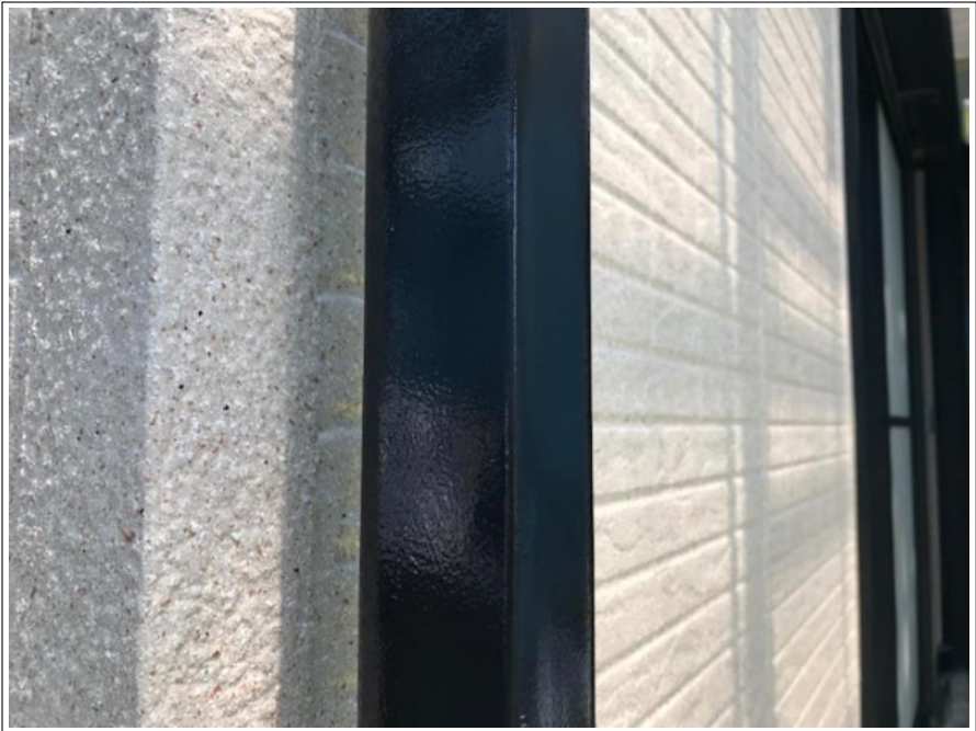
雨樋 施工完了
