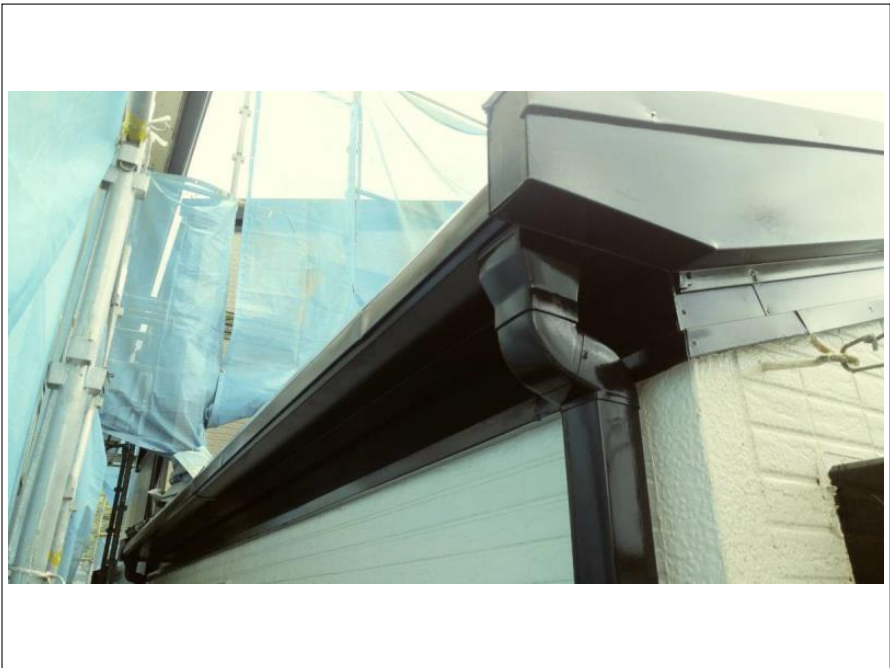
雨樋 施工完了
