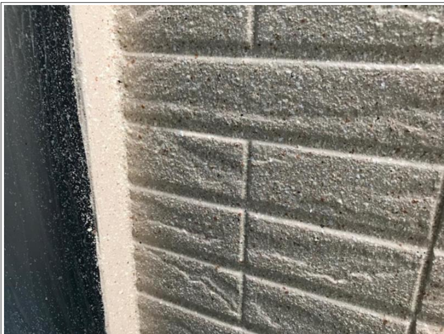
外壁 上塗り (グラナート) 完了
