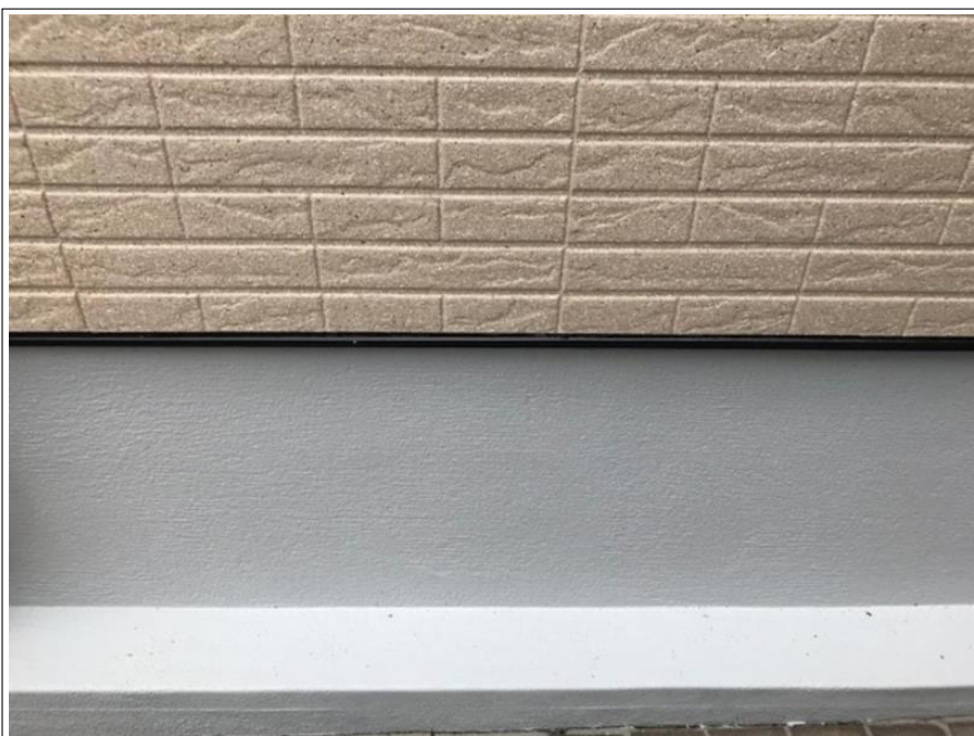
土台水切り 施工中
