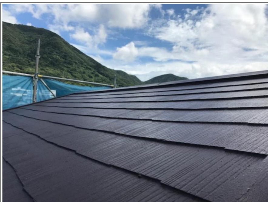
屋根 上塗り 完了
