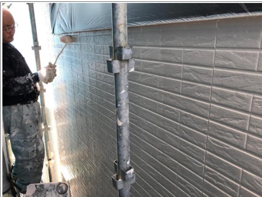
外壁 上塗り 施工中
