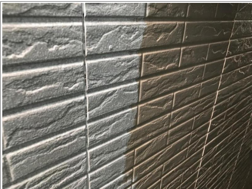
外壁 中塗り 施工中
