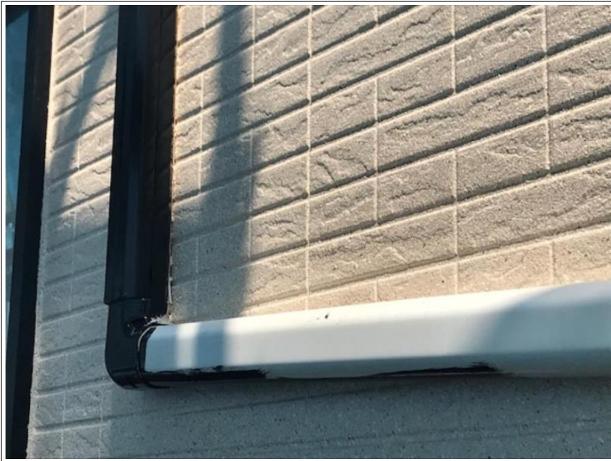
ダクトカバー 施工中
