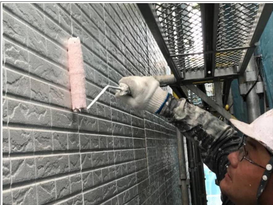
外壁 下塗り 施工中
