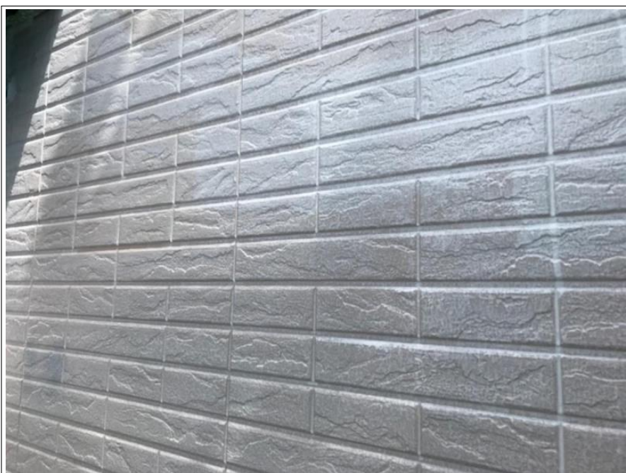
外壁 下塗り 完了
