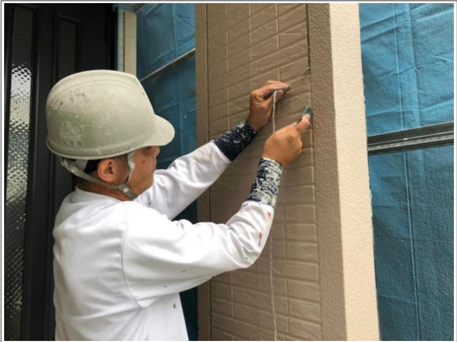
外壁 シーリング撤去
