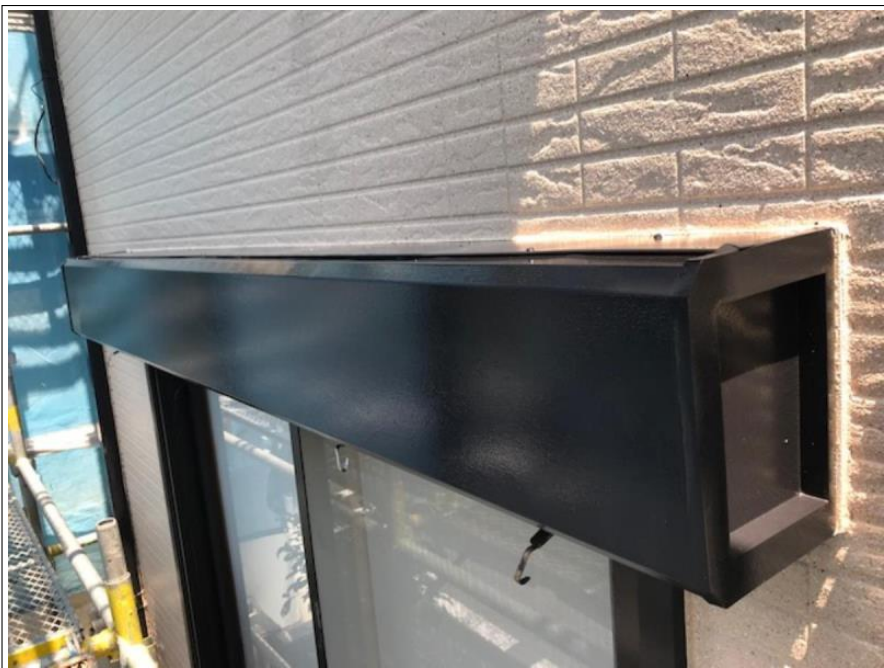
シャッターBOX 施工完了
