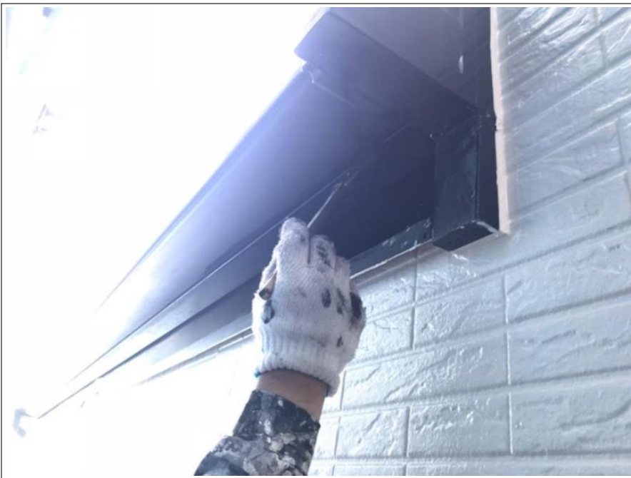
シャッターBOX 施工中
