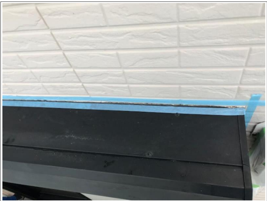
外壁 シーリング撤去
