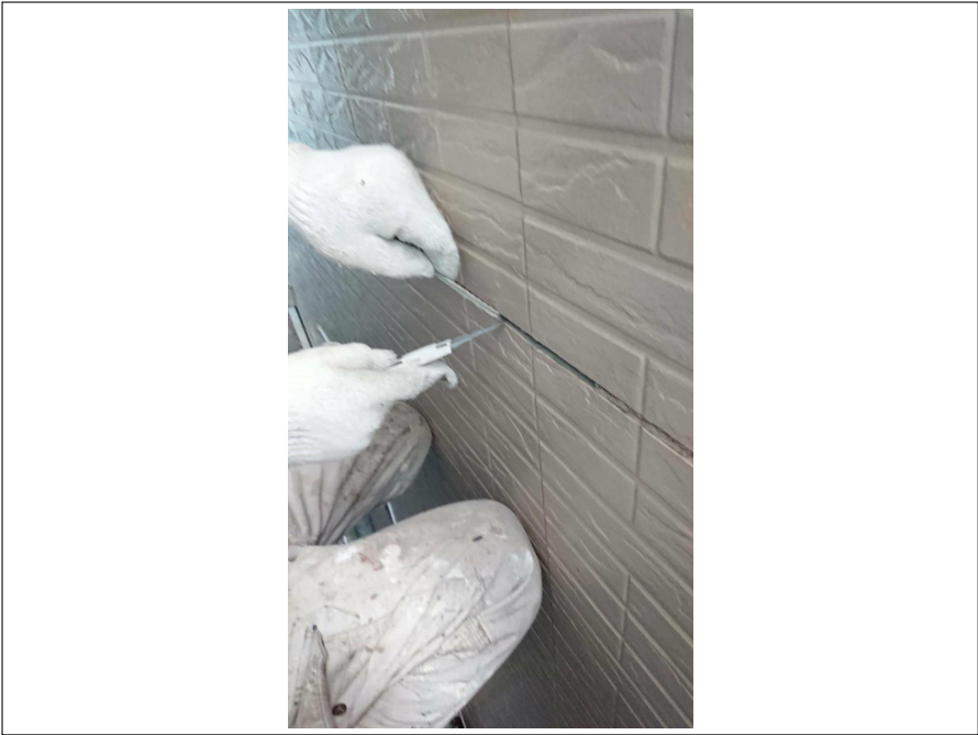
外壁 シーリング撤去
