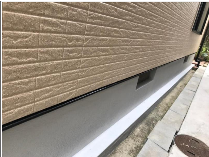
土台水切り 施工完了
