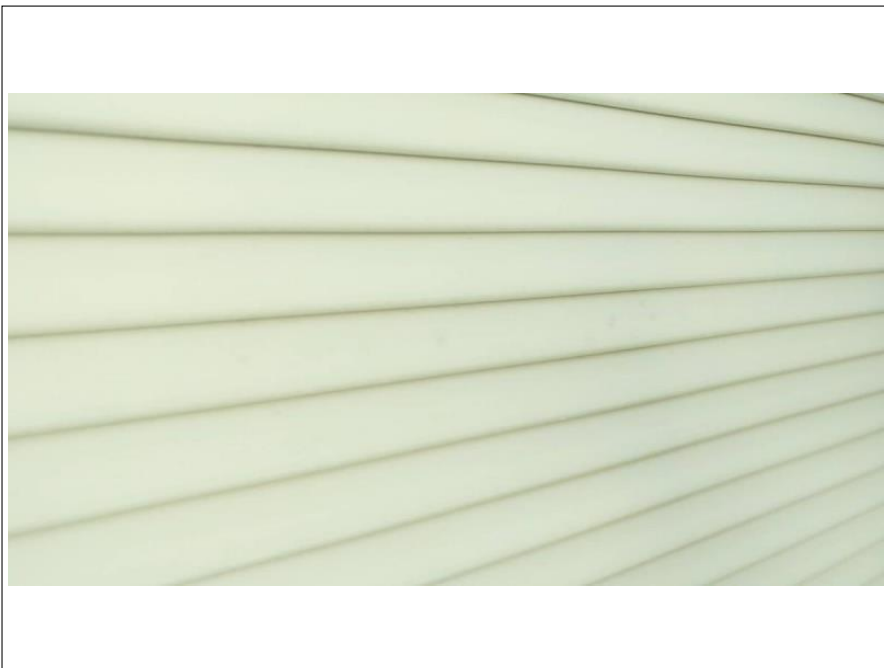
シャッター ケレン完了
