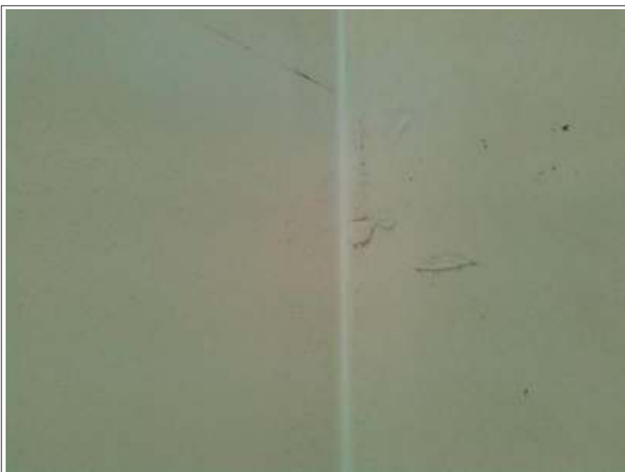
シーリング補修施工後
