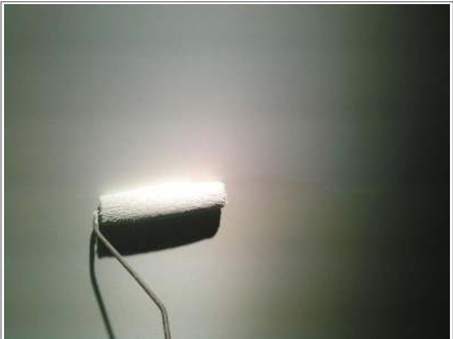
下塗り施工中
