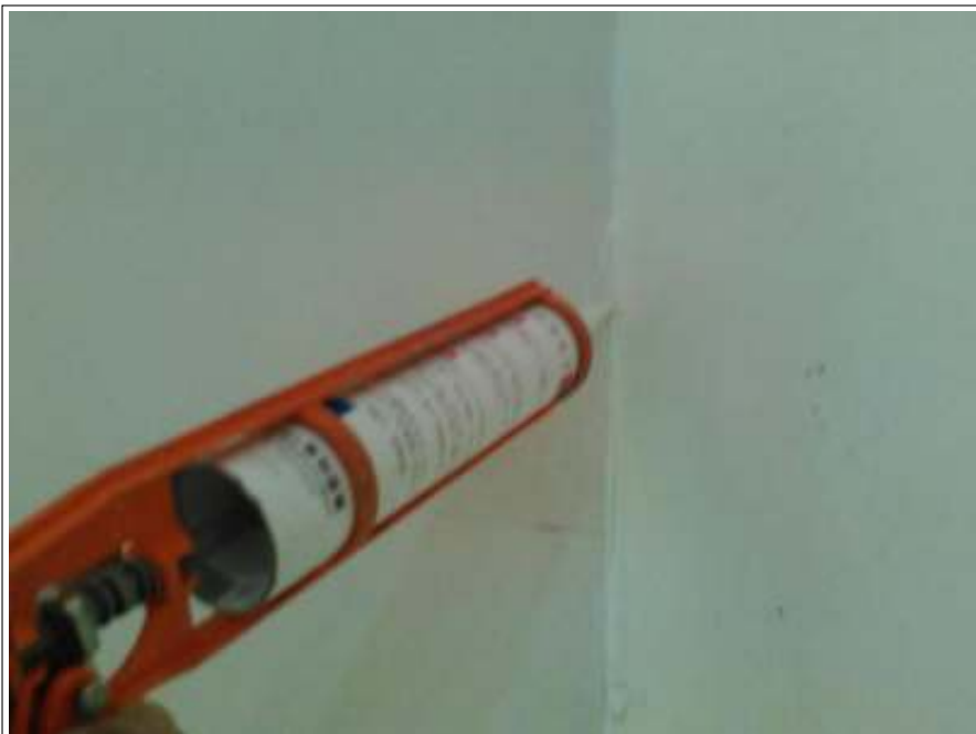
シーリング補修施工中
