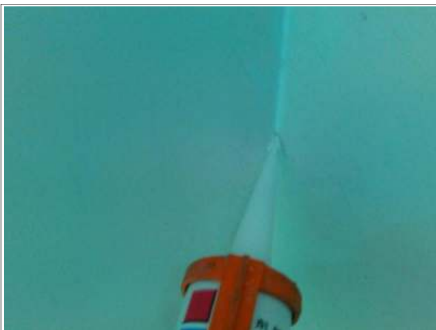
シーリング補修施工中
