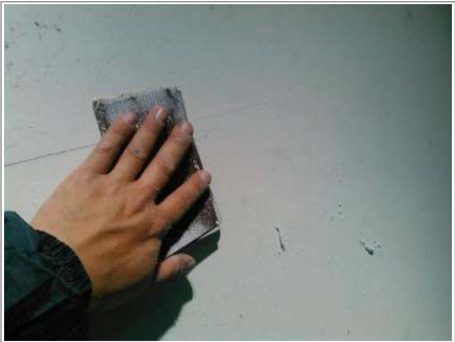
ケレン処理施工中
