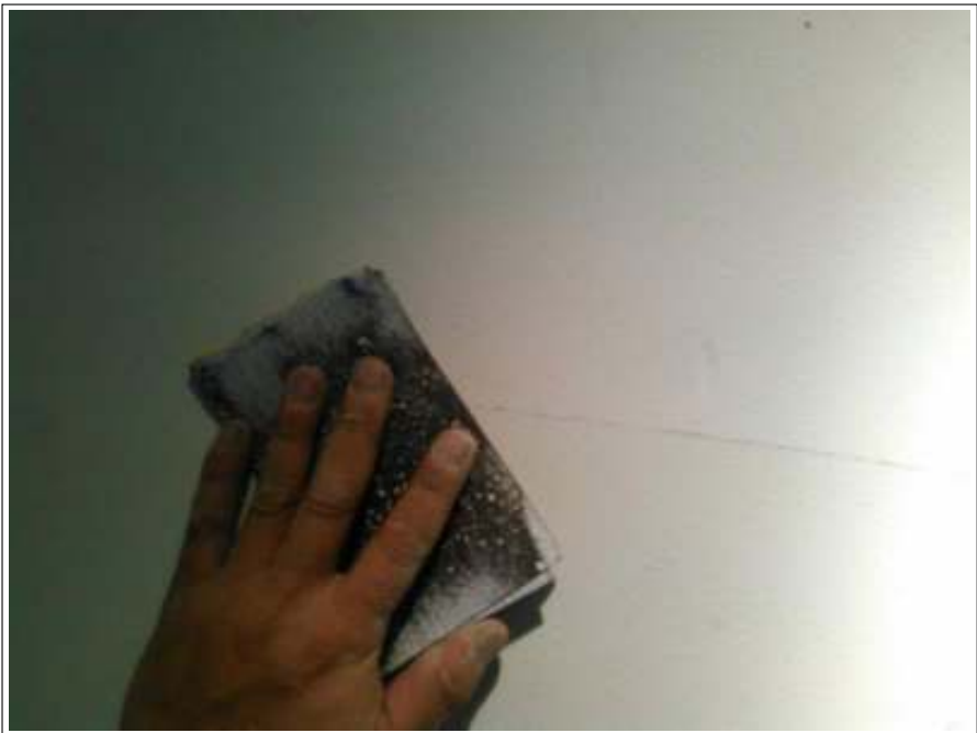
ケレン処理施工中
