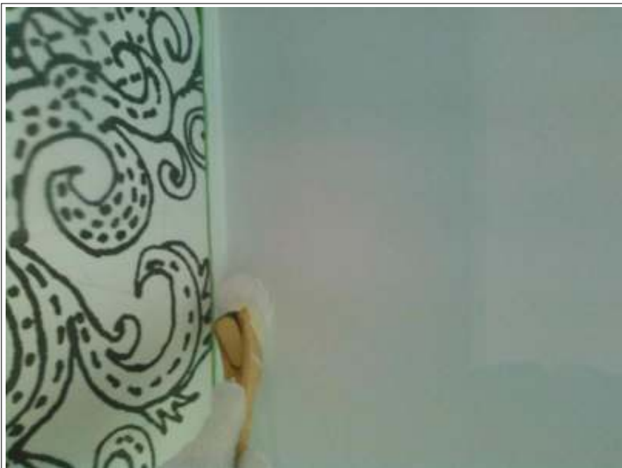
上塗り施工中
