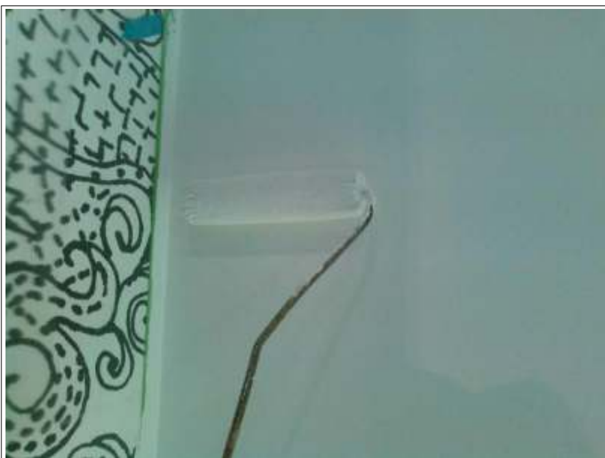
上塗り施工中
