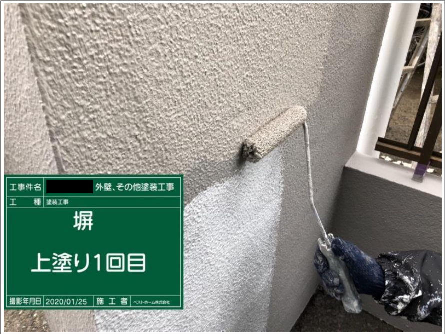
工事件名 ████████ 外壁、その他塗装工事 工 種 塗装工事 塀 上塗り1回目 撮影年月日 2020/01/25 施 工 者 ベストホーム株式会社
