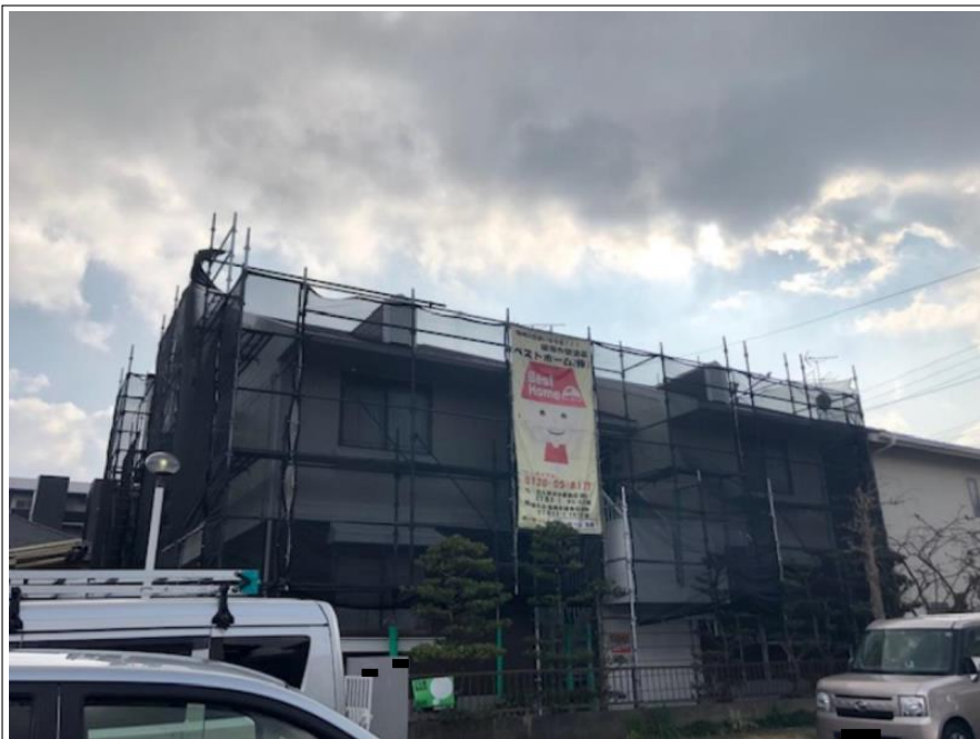
足場組立完了
