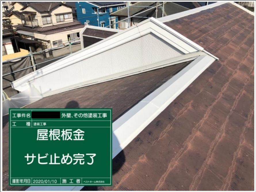
工事件名 [ ] 外壁、その他塗装工事 工種 塗装工事 屋根板金 サビ止め 撮影年月日 2020/01/10 施工者 [ ]
