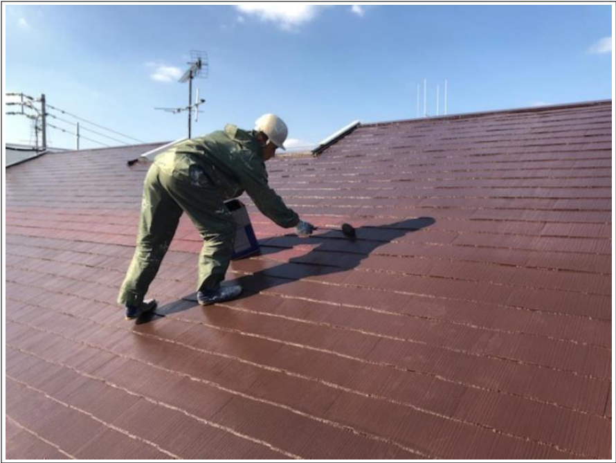
工 事 名 外壁、その他塗装工事 工 種 塗装工事 屋根 上塗り2回目 撮影年月日 2020/01/21 施 工 者 ベストホーム株式会社
