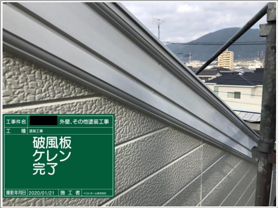
工 事 名 外壁、その他塗装工事 工 種 塗装工事 破風板 ケレン 撮影年月日 2020/01/21 施 工 者 ベストホーム株式会社
