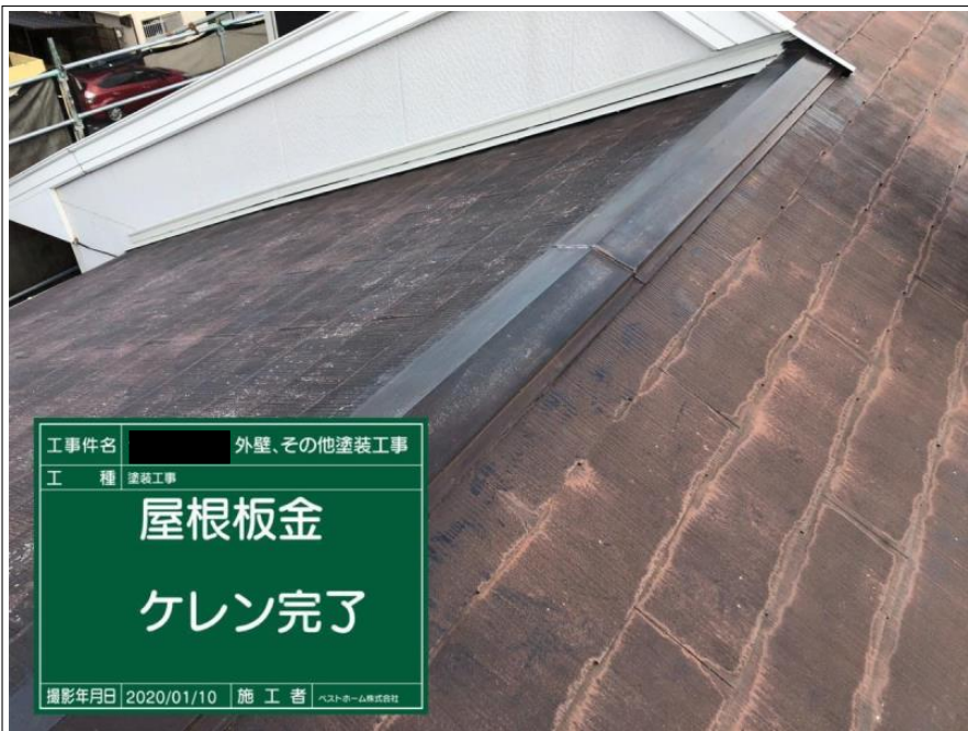
工事件名 外壁、その他塗装工事 工種 塗装工事 屋根板金 ケレン 撮影年月日 2020/01/10 施工者 ベストホーム株式会社
