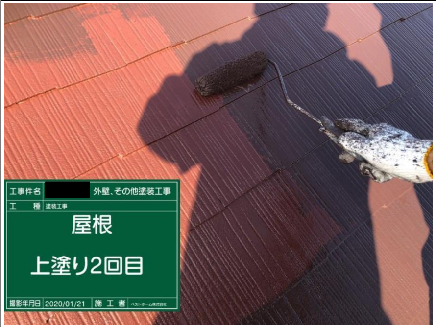
工 事 名 外壁、その他塗装工事 工 種 塗装工事 屋根 上塗り2回目 撮影年月日 2020/01/21 施 工 者 ベストホーム株式会社
