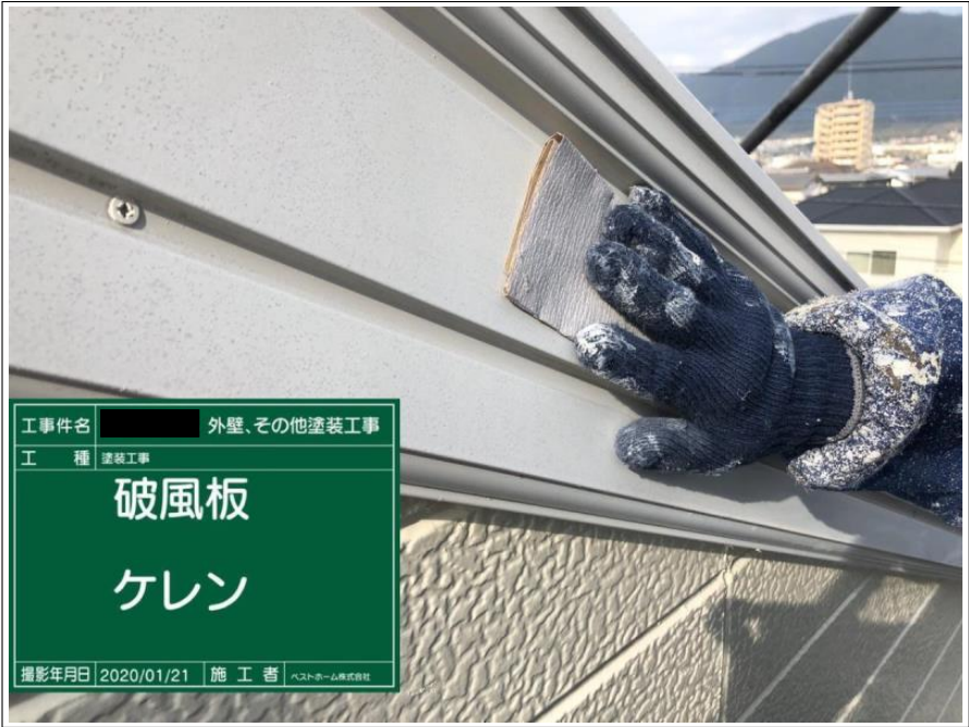
工 事 名 外壁、その他塗装工事 工 種 塗装工事 破風板 ケレン 撮影年月日 2020/01/21 施 工 者 ベストホーム株式会社
